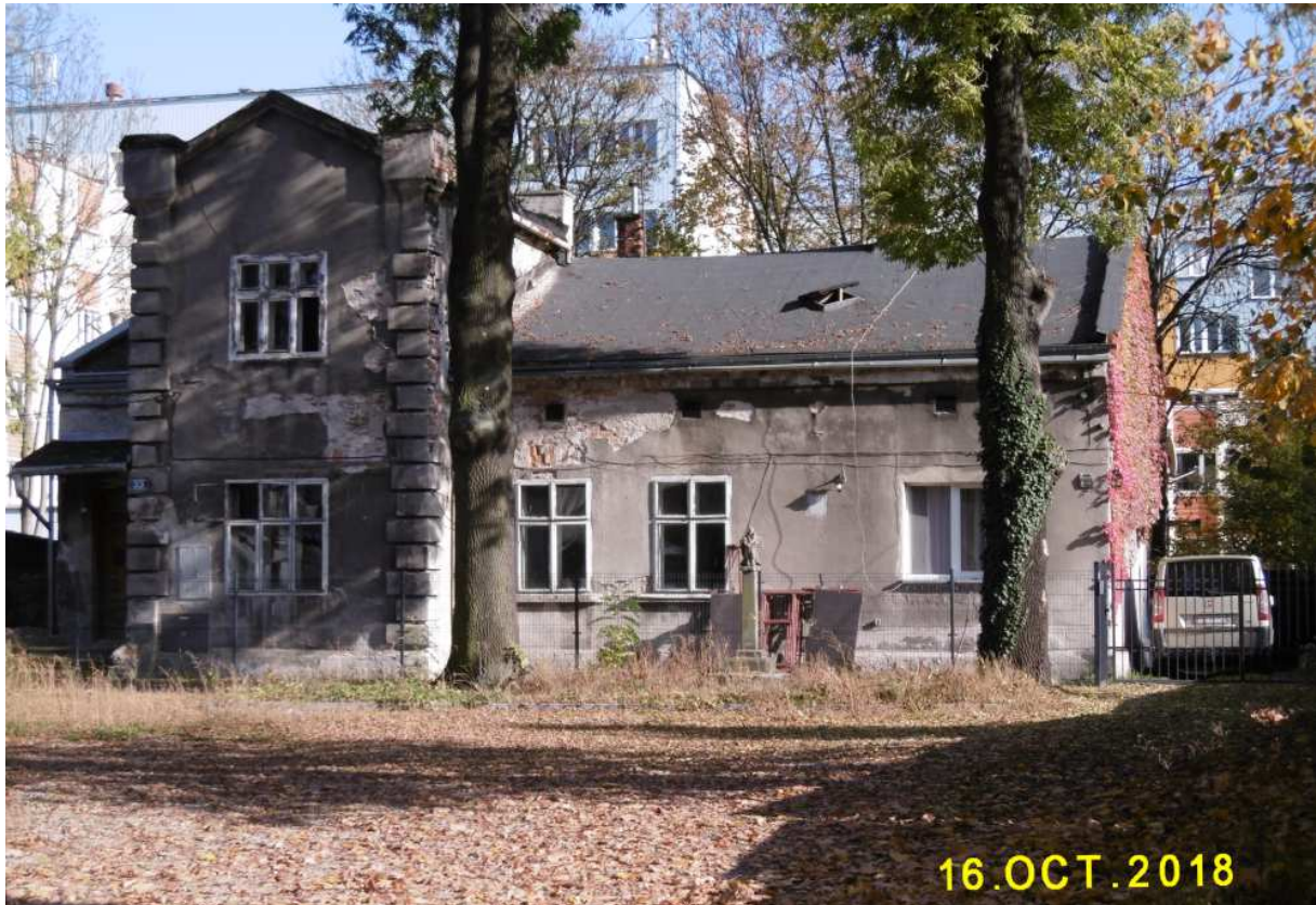
Fot. nr 2 (2-4). Willa dawnego ogrodnika cmentarnego przy ulicy Rakowickiej 33, relikw dawnej zabudowy Olszy z końca XIX wieku.
