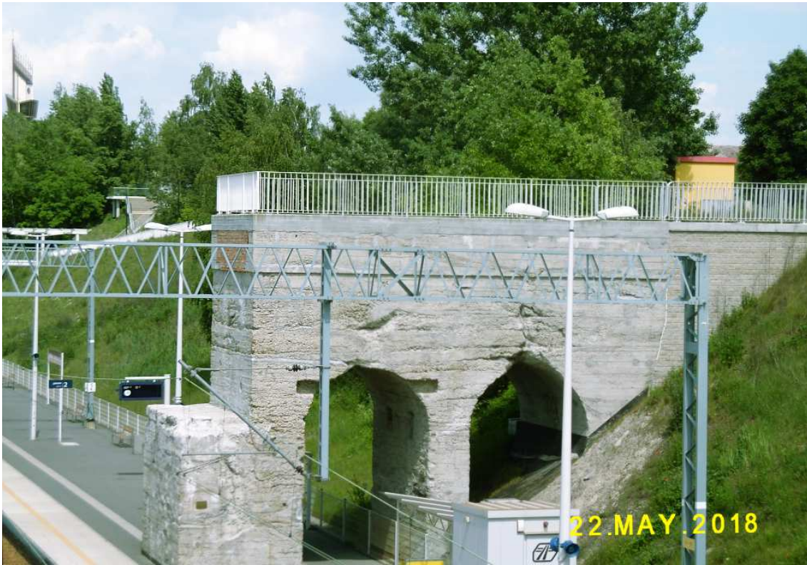
Fot. nr 335. Fragment dawnego mostu, który stanowił połączenie KZS ze stawem osadowym – widok z kładki na ulicy Korbońskiego.
