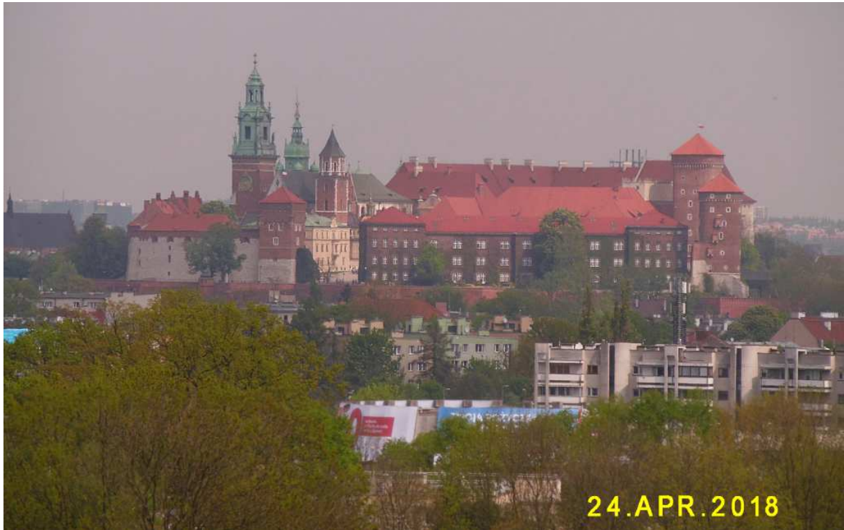
Fot. nr 54. Zamek królewski na Wawelu.
