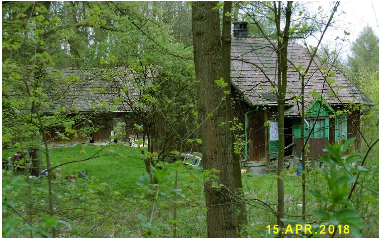
Fot. nr 22 (22-26). Leśniczówka z ulicy Do Groty 105, której trwanie jest zagrożone.
