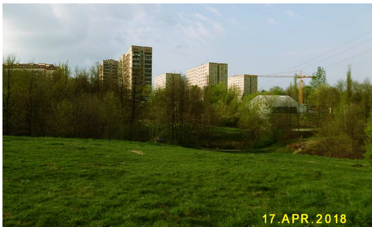
Fot. nr 258. Widok z sąsiedztwa ulicy Szpakowej na fragment osiedla Na Kozłowce w końcowym fragmencie ulicy Spółdzielców, gdzie trwa budowa basenu.
