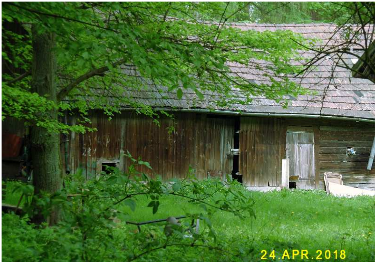
Fot. nr 23. Stodoła na zapleczu domu.
