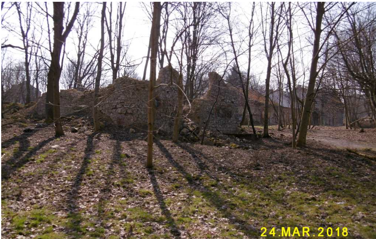
Fot. nr 149. Ruina pomieszczenia gospodarczego dawnego dworu w sąsiedztwie ulicy Albańskiej.
