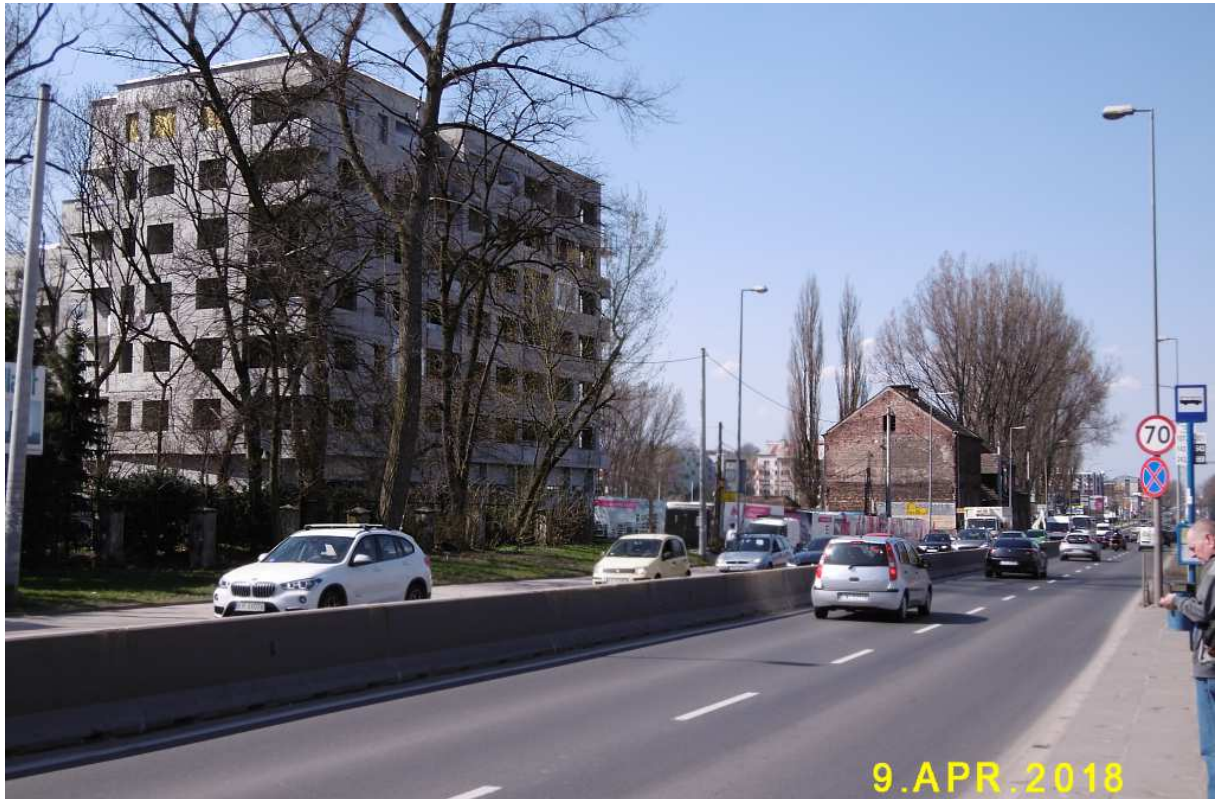
Fot. nr 131 (131-133). Fragment ulicy Wielickiej z wyburzoną już zabudową pod nr: 107-113. Co się stanie z ostatą ruiną pod nr 105?
