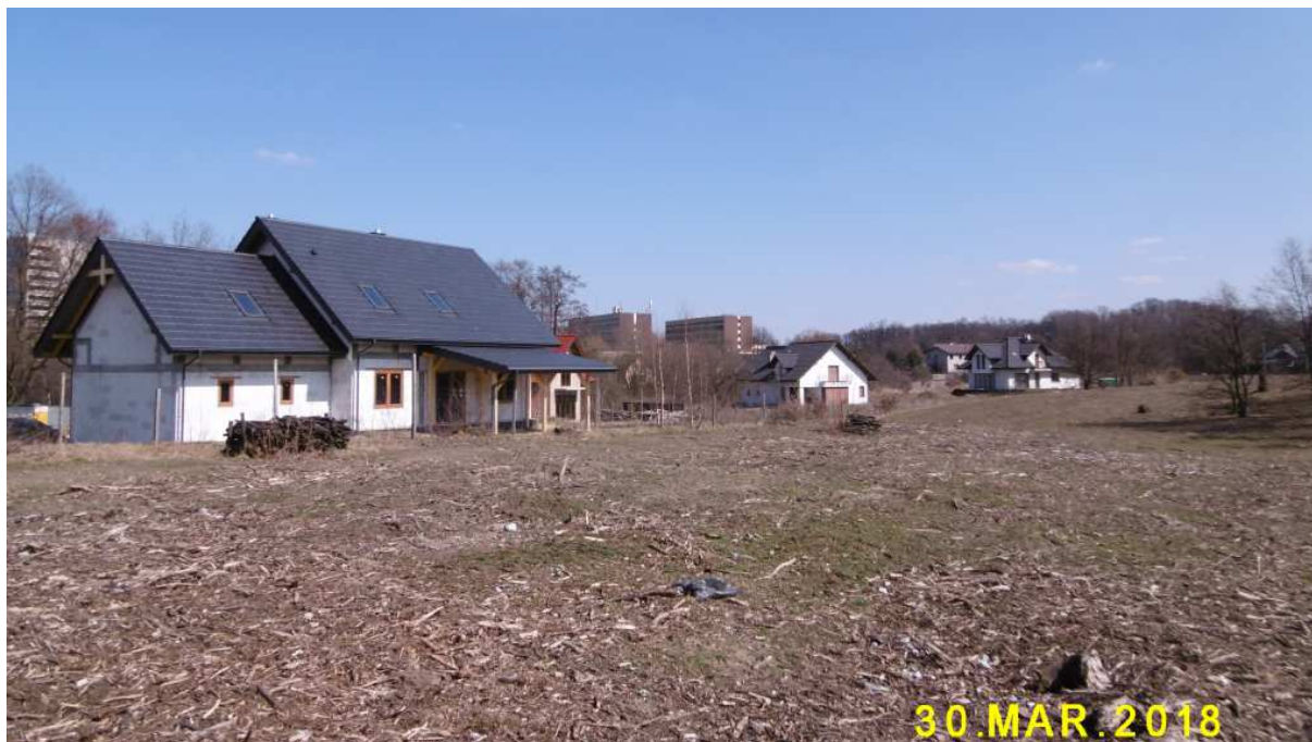
Fot. nr 269. Nowa zabudowa wokół ulicy Obronnej. Ujęcie od strony ulicy Czajnej w stronę ulicy Kostaneckiego.
