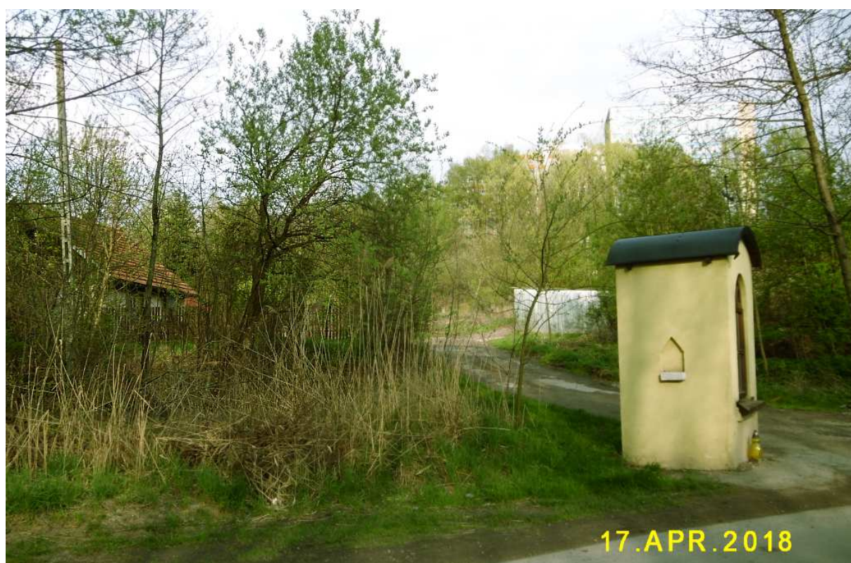
Fot. nr 262 (262-264). Kiedyś stała tu krzywa kapliczka, która na skutek wielkiego odchylenia od pionu i groźby zawalenia została rozebrana w roku 2014. Wkrótce jednak została wiernie odbudowana, ale niestety i ona na tym podmokłym gruncie powoli traci pion.
