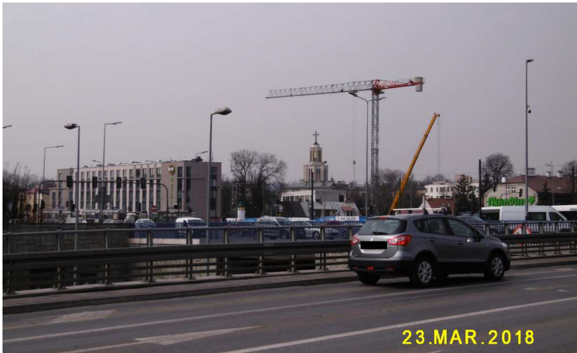
Fot. nr 2 (2-4). Trwa zabudowa zielonego cypla na styku ulic: Konopnickiej, Monte Cassino i Barskiej.
