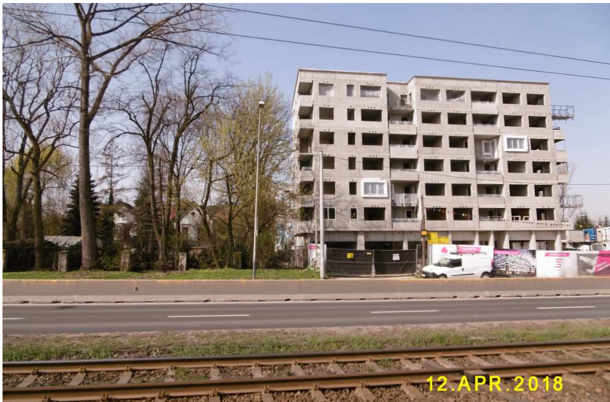
Fot. nr 132. Nowy blok mieszkalny przy posesji pod nr 113.
