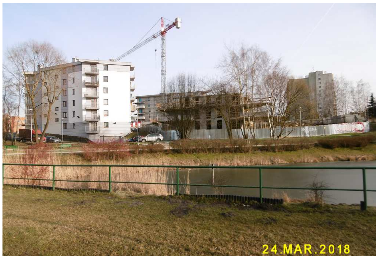
Fot. nr 332 (332-334). Nowa zabudowa zaczyna się dosłownie wlewać do wąskiego pasa parku.
