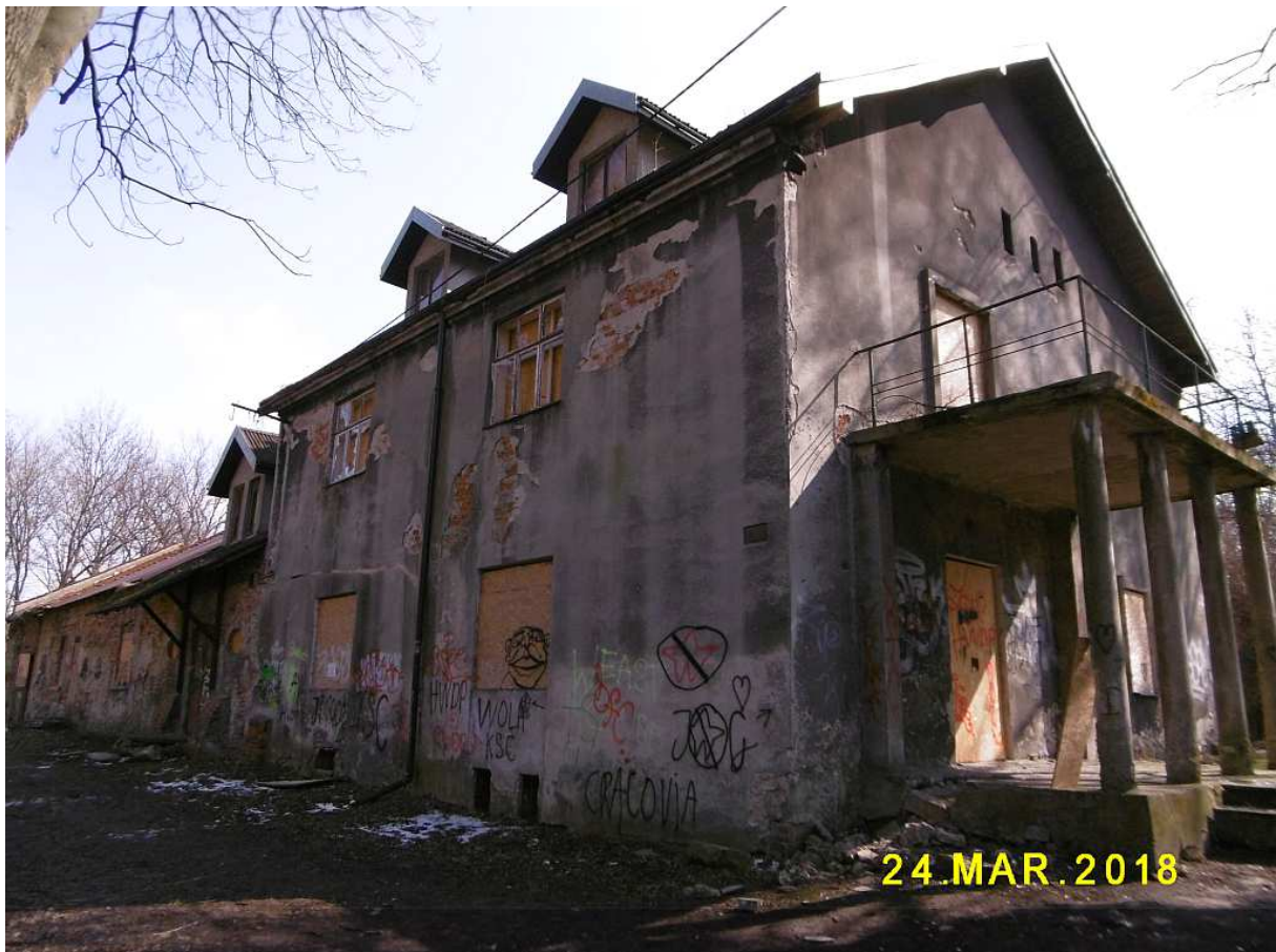
Fot. nr 151 (151-152). Widok dworu od strony ulicy Estońskiej.
