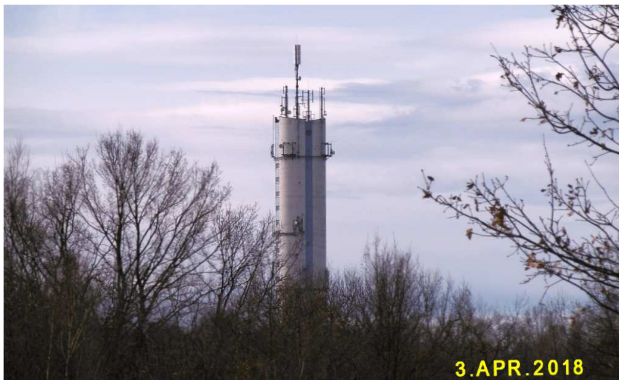
Fot. nr 277. Wieża rurociągu Raba w sąsiedztwie ulicy Hallera.
