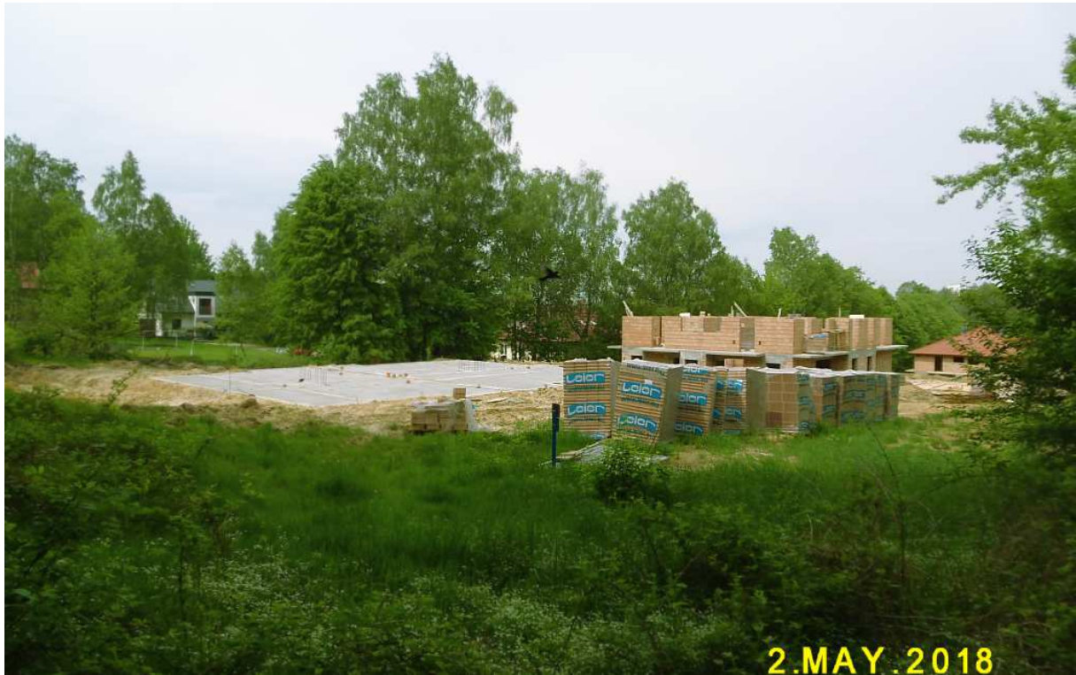
Fot. nr 359 (359-360). Trwa zabudowa terenu na zboczu nad ulicą Wyżynną, poniżej ulicy Miarowej.
