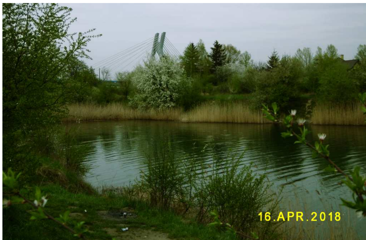
Fot. nr 244. Z przęsłem estakady tramwajowej w tle.
