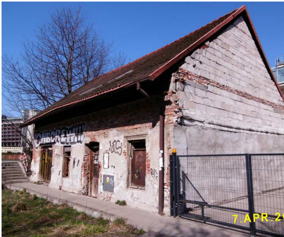
Fot. nr 114. Co pozostanie po domu spod nr 6?
