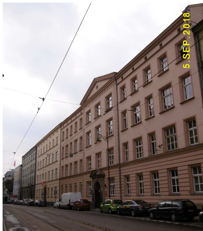
Fot. nr 96. Fragment zabudowy ulicy Starowiślnej o numerach: 3-11 z zabudowaniami sióstr Urszulanek na pierwszym planie.
