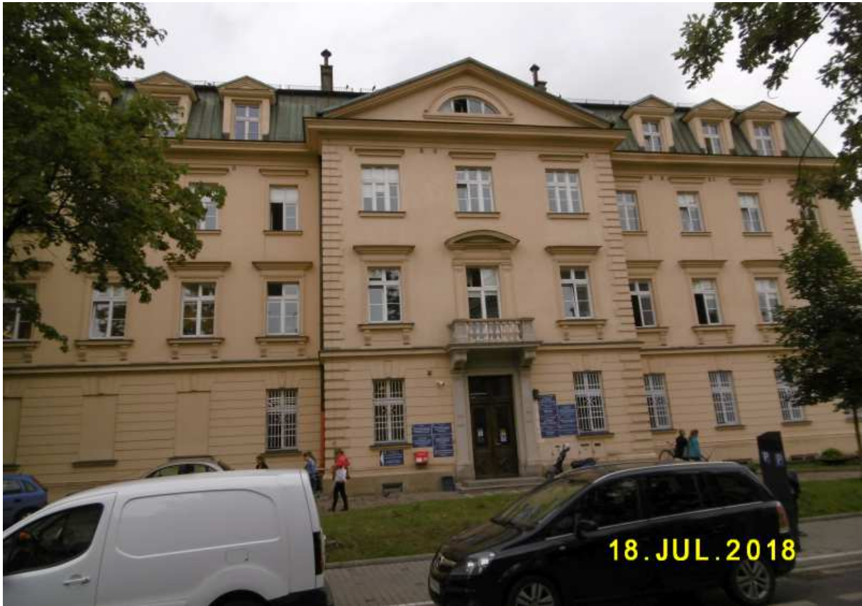
Fot. nr 113. Budynek szpitalny dawnego zespołu św. Łazarza pod nr 17.
