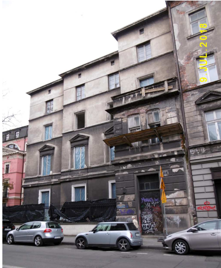
Fot. nr 68. Kamienica z ulicy Krupniczej 18 ciągle na etapie remontu.
