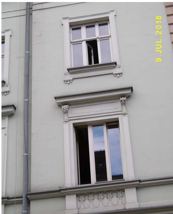
Fot. nr 74. Przykład wyjątkowego niechlujstwa ze strony wykonawców i dozoru.
