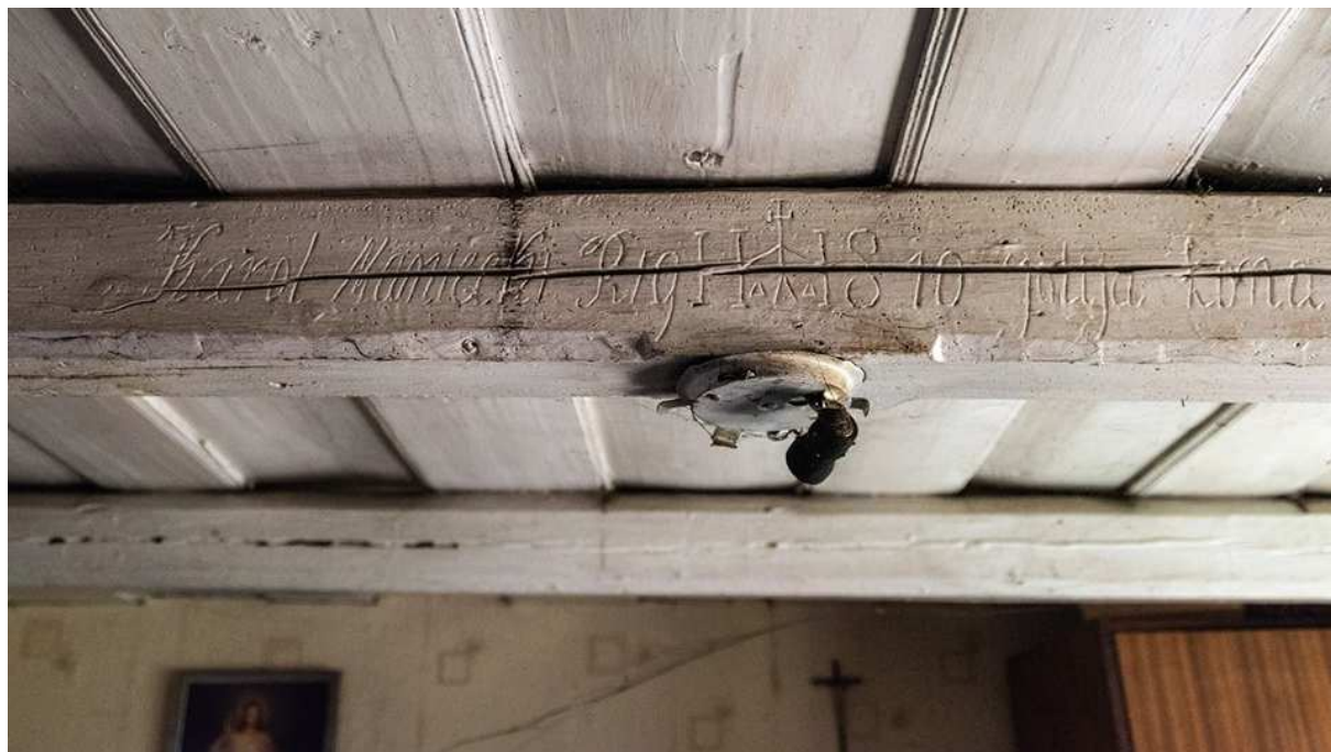
Fot. nr 293. Data zakończenia budowy wyryta na belce dźwigara 19 IHS 10. (fot. Adam Gryczyński)
