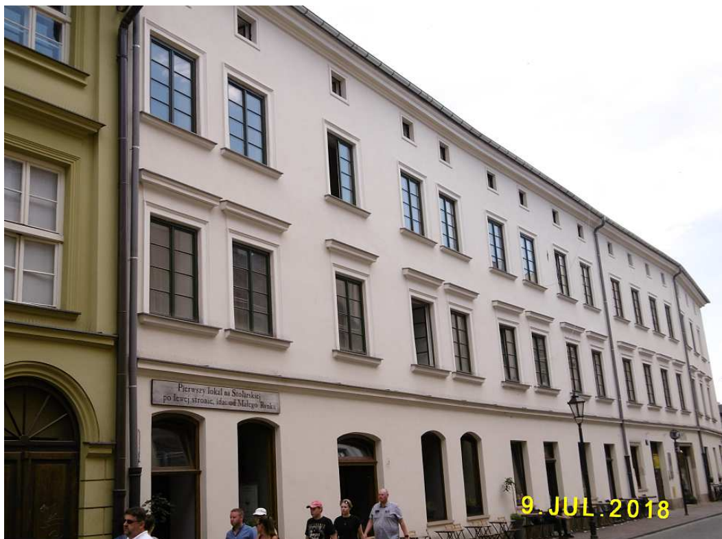
Fot. nr 43. Kamienica z ulicy Stolarskiej 4, gdzie po remoncie niestety zniknęły oryginalne okna, kiedyś drewniane, dwukwaterowe, otwierane na zewnątrz.
