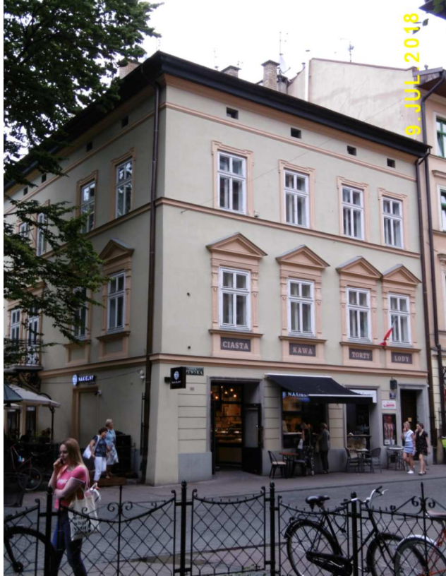
Fot. nr 32. Widok z Plant na kamienicę z ulicy Szewskiej 27.
