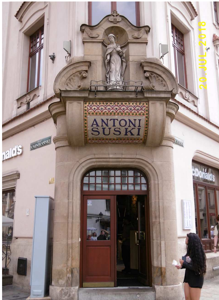
Fot. nr 38 (38-39). Narożnik dawnej kamienicy Suskiego z ulicy Grodzkiej 24-26.
