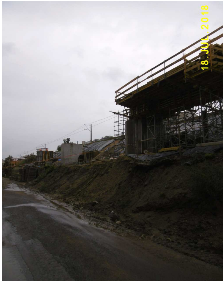
Fot. nr 117 (117-120). Trwa przebudowa nasypu kolejowego wzdłuż ulicy Blich.
