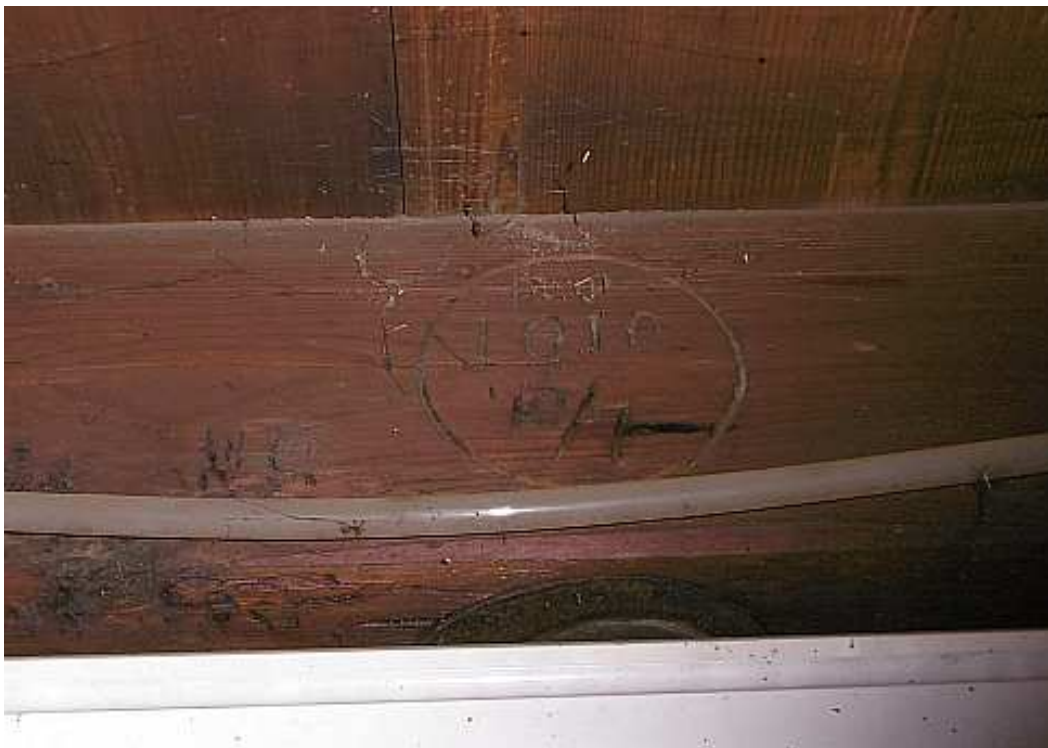
Fot. nr 252. Data zakończenia budowy wyryta na dźwigarze.
