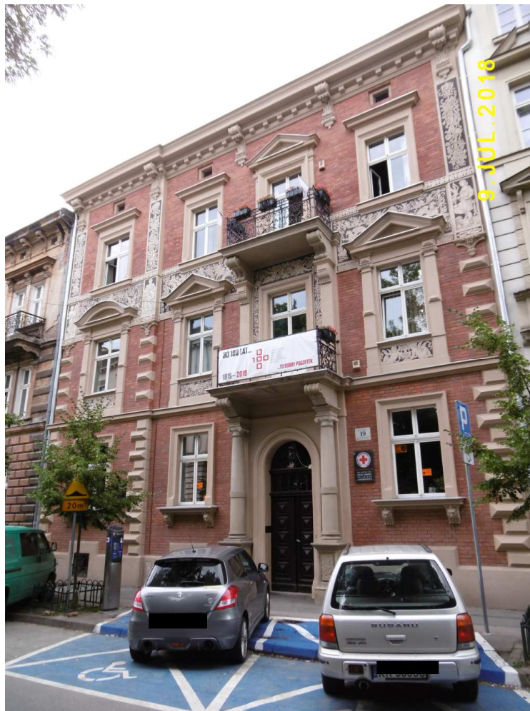
Fot. nr 77. Kamienica własna Sławomira Odrzywolskiego spod nr 19, która stanowi nieczęsty jeszcze wzorzec efektownej i fachowej rekonstrukcji fasady.
