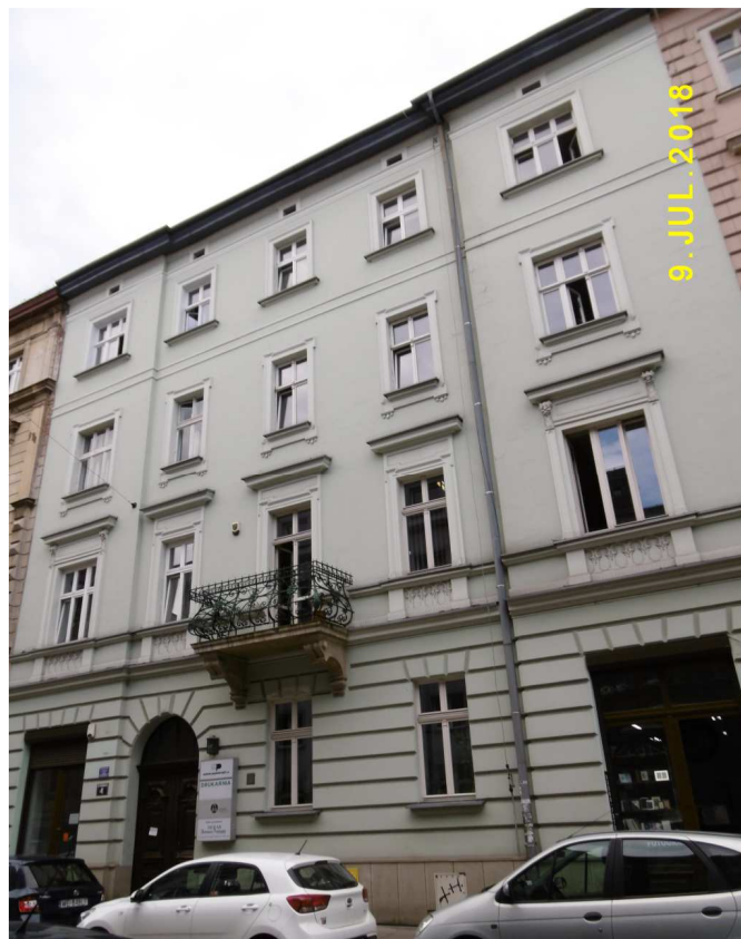
Fot. nr 73 (73-74). Świeżo odnowiona elewacja kamienicy z ulicy Studenckiej 4.
