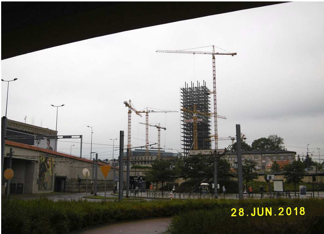
Fot. nr 121 (121-123). Po dekadach marazmu trwa rozbudowa otoczenia „szkieletora”, po którym pozostał tylko stalowy szkielet. Ujęcia z ronda Mogilskiego.
