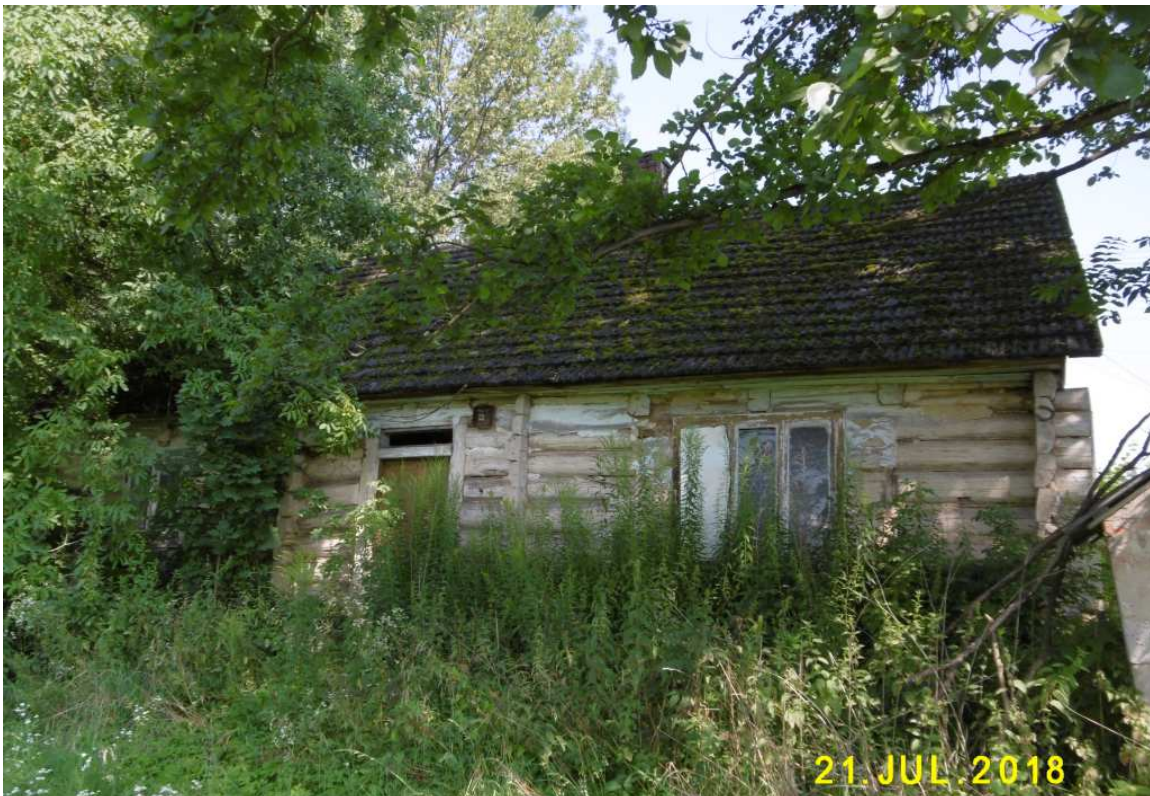
Fot. nr 290. Widok od strony ogrodu.
