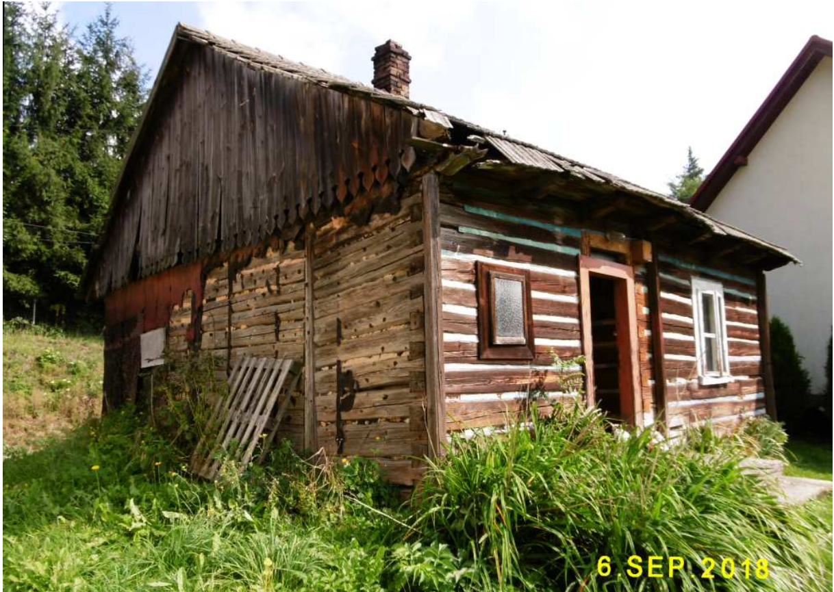
Fot. nr 140. Chałupa spod nr 38 w ujęciu od podwórka.
