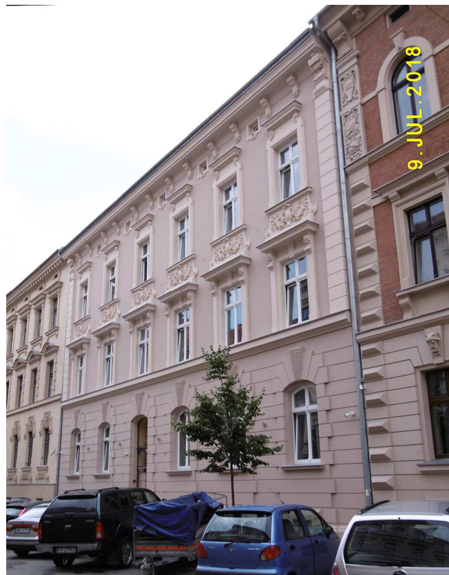
Fot. nr 79 (79-80). Kolejny przykład wzorcowej wręcz odnowy elewacji, ale też wnętrza. To dawna kamienica Zollów z ulicy Studenckiej 25 po przeróbce na apartamentowce.
