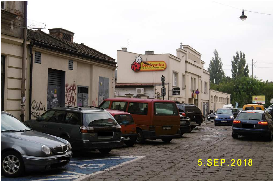
Fot. nr 126 (126-127). Ciągłe niska zabudowa w końcowym fragmencie ulicy Berka Joselewicza. Tu fragment o numerach: 26-28.
