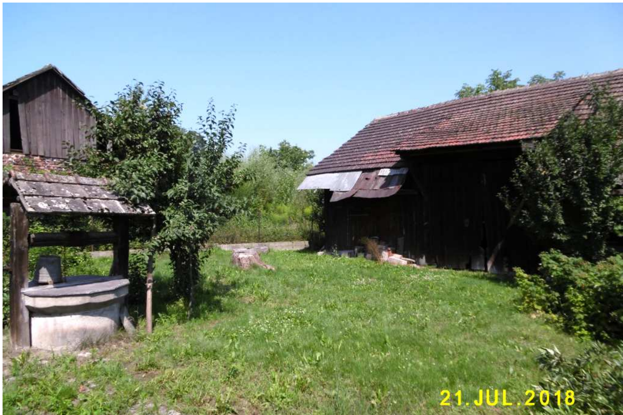
Fot. nr 276. Zabudowa dziedzińca domu z ulicy Kopaniec 5.
