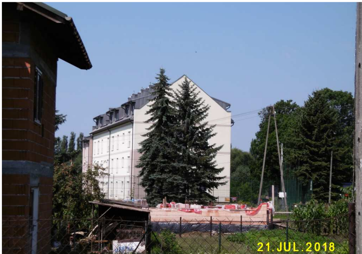
Fot. nr 274 (274-275). Przebudowany na blokowisko mieszkalne, ciągle niezamieszkałe, blisko 100-letni młyn - „gwoździarnia” - z ulicy Bardosa 38.
