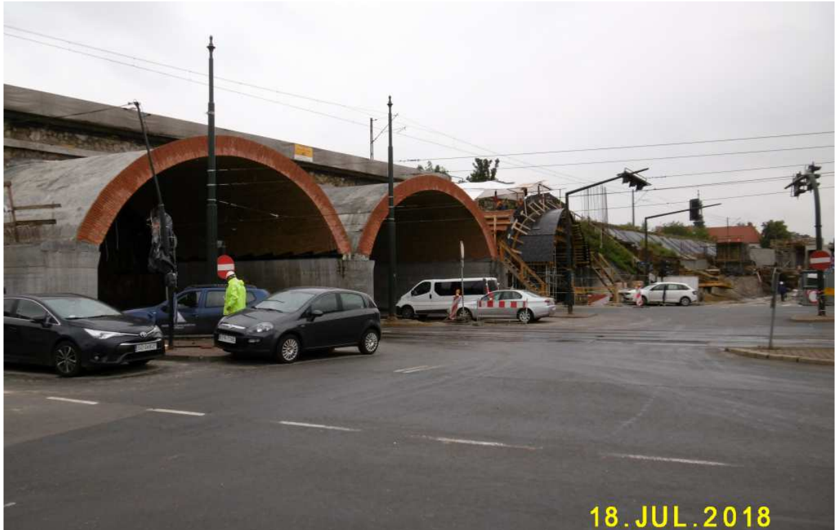
Fot. nr 119 (119-120). Rozbudowa ponad 150-letniego wiaduktu kolejowego nad ulicą Grzegórzecką.
