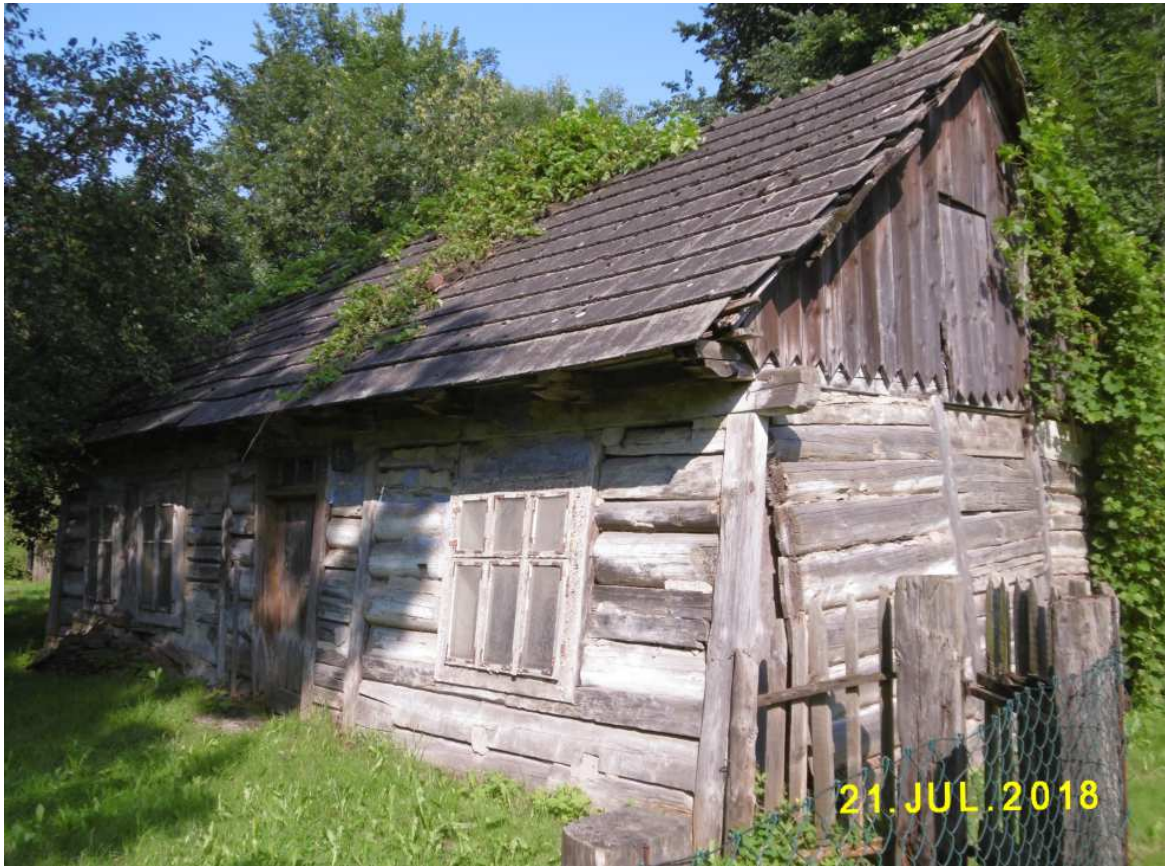
Fot. nr 283. Wyburzona już chałupa z ulicy Jezierskiego 14.
