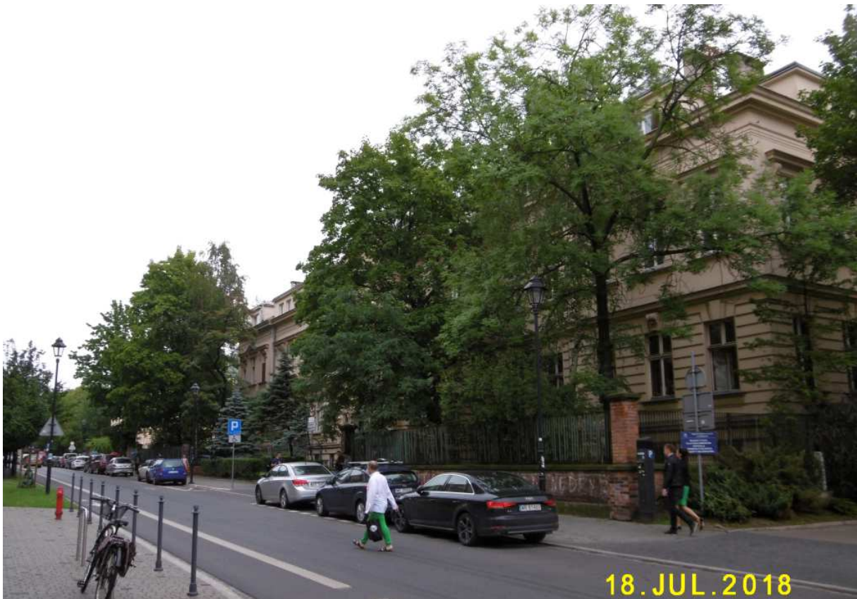
Fot. nr 114. Kolejny budynek szpitalny pod nr 15.
