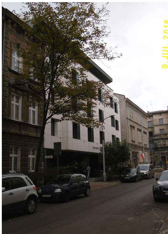
Fot. nr 63 (63-64). Obcy architektonicznie dodatek do zabudowy ulicy Szujskiego (nr 4) w postaci hotelu Grand Ascot. Znikł tu cenny zabytek zabudowy willowo-ogrodowej.
