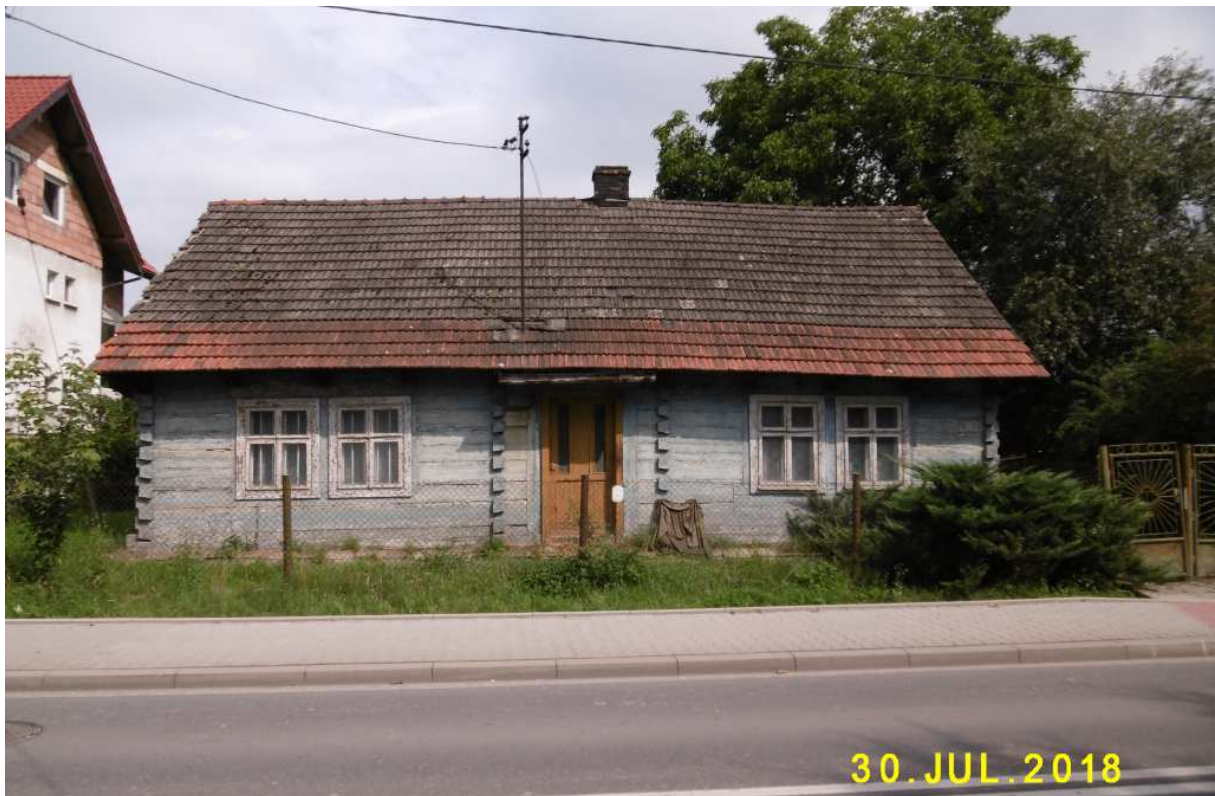
Fot. nr 260 (260-261). 100-letni dom z ulicy Lubockiej 17 i jego zaplecze.
