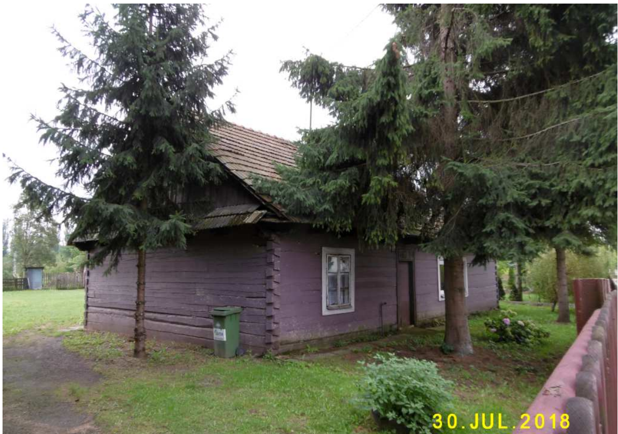
Fot. nr 262. Chałupa z ulicy Lubockiej 16
