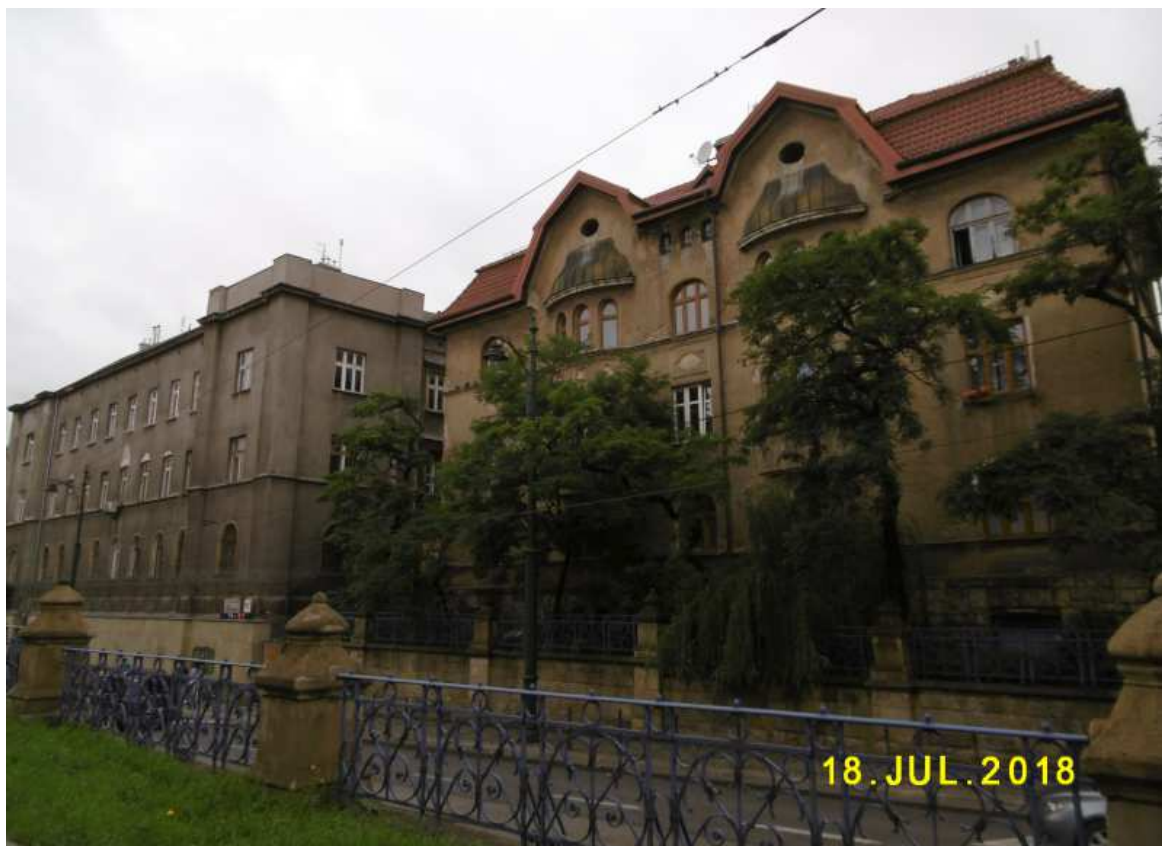
Fot. nr 102. Budynki kolejowe przy ulicy Lubicz 10-12.
