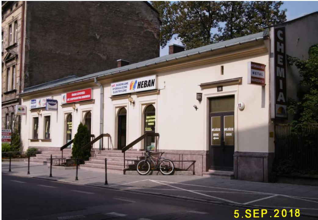
Fot. nr 48. Mocno zniekształcona fasada dawnego domu podmiejskiego z ulicy Garbarskiej 11.
