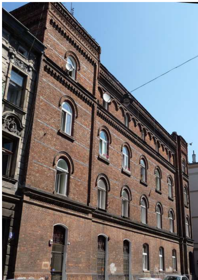
Fot. nr 20. Widok z ulicy Kolettek. (09.07.2012)
