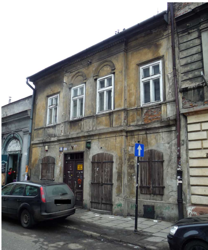
Fot. nr 57. Dom pod nr 14, przebudowany na początku XIX wieku. (13.03.2013)
