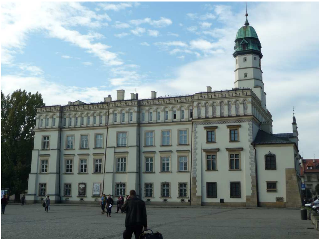
Fot. nr 93. Widok z placu Wolnica. Ratusz powstał wraz z lokacją miasta Kazimierz w roku 1335, a jego rozbudowa pochodzi z lat 1875-76. (10.10.2013)
