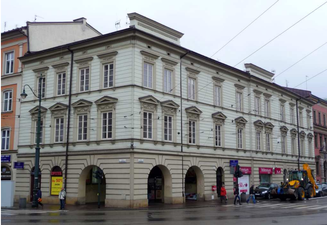
Fot. nr 8. Klasycystyczna elewacja kamienicy pod nr 2. (10.01.2012)
