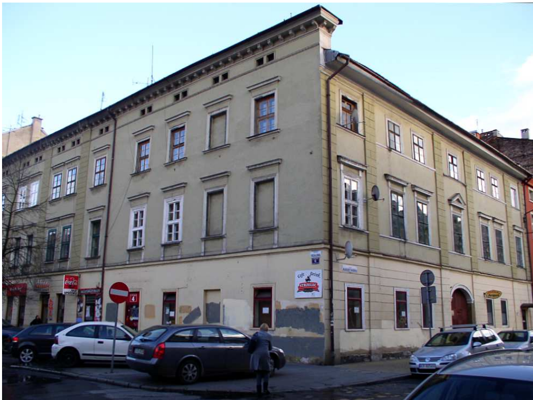
Fot. nr 117 (117-118). Klasycystyczna kamienica z naroża ulic: Augustiańskiej 26 i Węglowej, która powstała w roku 1826. (12.11.2011)
