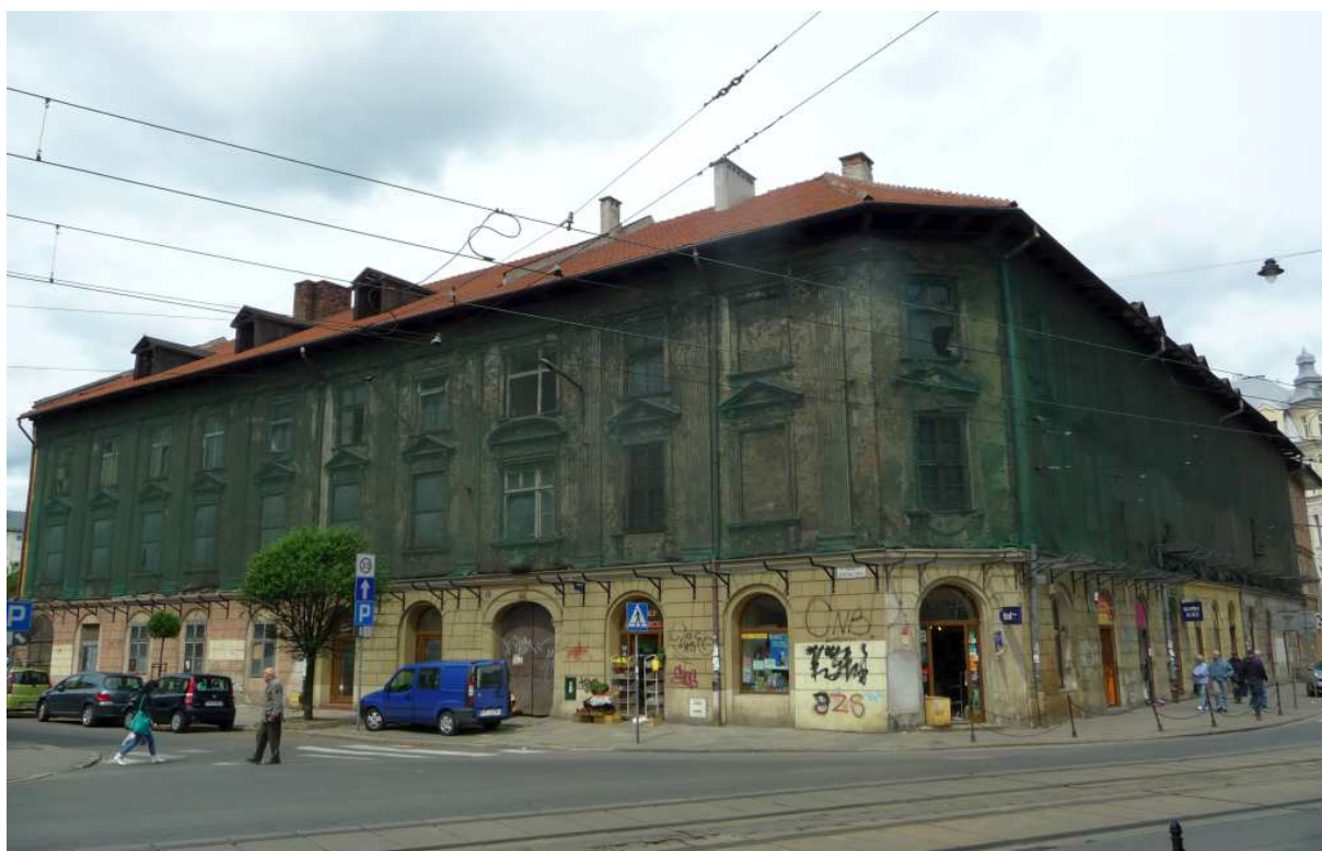
Fot. nr 77. Czekażąca od lat na remont zabytkowa kamienica z ulicy Krakowskiej 29/Węglowej 1. (27.05.2013)
