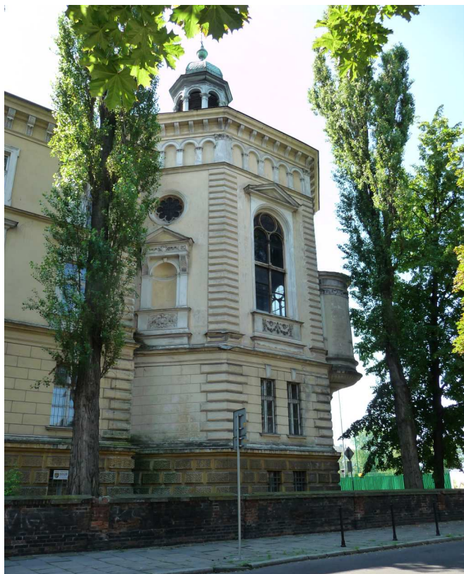
Fot. nr 26. Wieża dawnej kaplicy. Widok z ulicy Kolettek. (09.07.2012)
