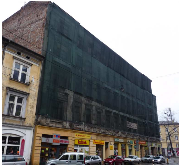
Fot. nr 18. Kamienica pod nr 18 przygotowana do remontu. (10.01.2012)
