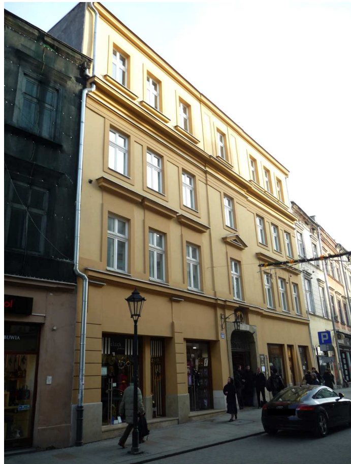
Fot. nr 5. Kamienica „Podelwie” pod nr 32 tuż po remoncie i uporządkowaniu fasady. (04.12.2013)
