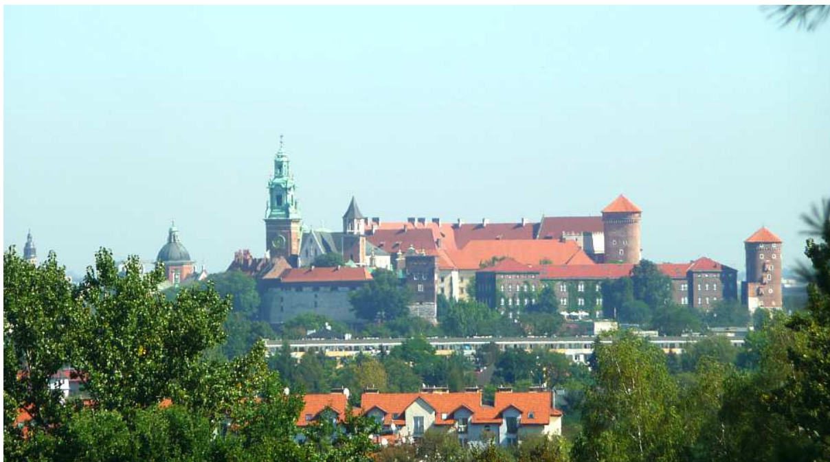
Fot. nr 114 (114-115). Widok spod szafca FS-29 na dębnickiej skale nad ulicą Tyniecką. (10.09.2012)
