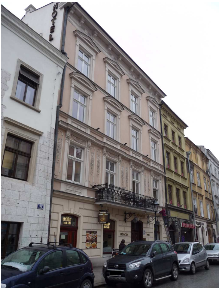
Fot. nr 12. Zabudowa fragmentu ulicy od nr 47 do 51. (10.01.2012)
