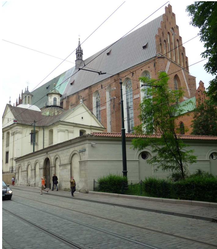
Fot. nr 207. Kościół Dominikanów w ujęciu z Plant. (12.06.2013)
