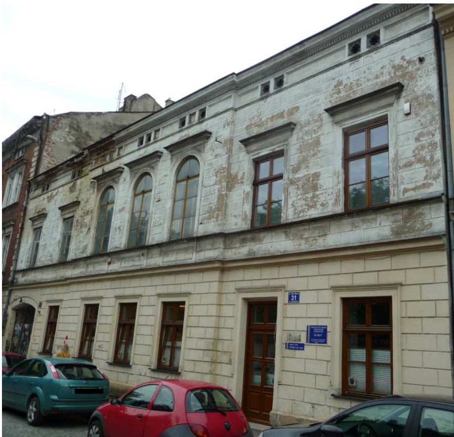
Fot. nr 147 (147-149). Kamienica Zieleniewskich pod nr 31. (12.06.2013)
