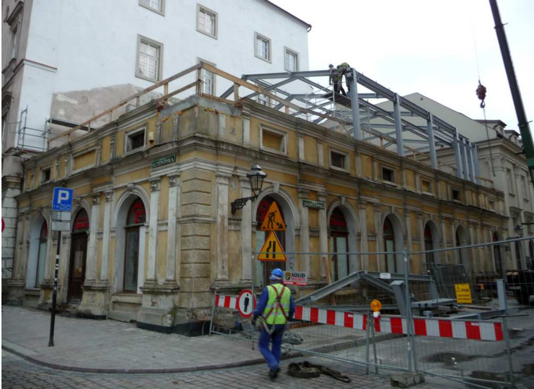
Fot. nr 112. Narożny budynek z ulicą Szczepańską na etapie przebudowy. (26.09.2013)
