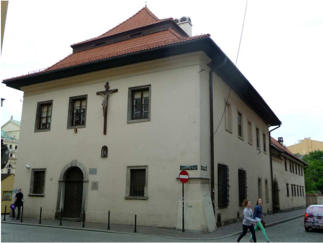
Fot. nr 146. Dom Pod Krzyżem w narożu z ulicą Szpitalną 21. (12.06.2013)
