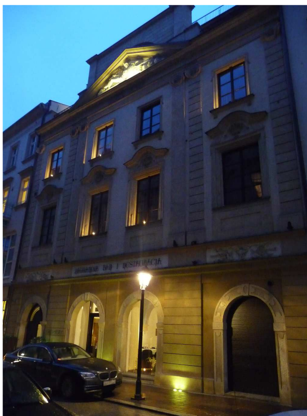
Fot. nr 123. Klasycystyczna kamienica pod nr 5. (12.03.2013)
