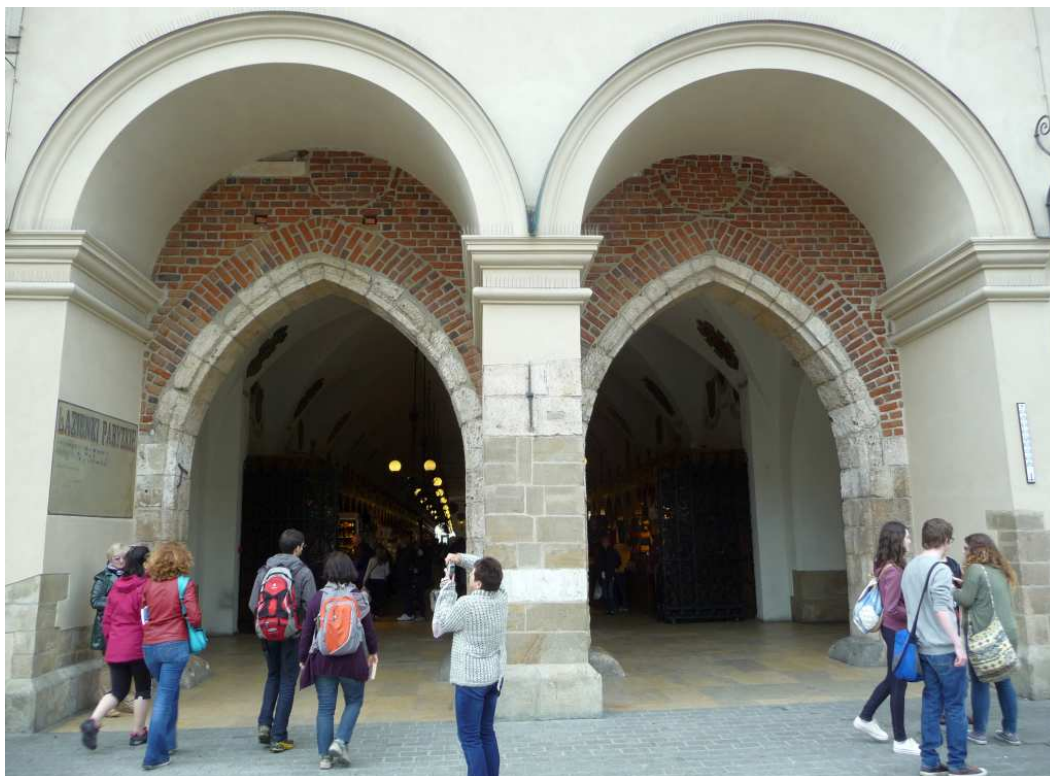
Fot. nr 60. Ostrołukowe portale przy wejściu do hali Sukiennic. 28.06.2013)
