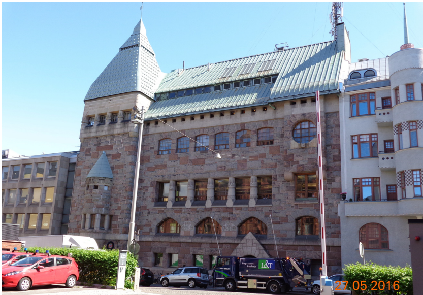
Budynek Helsińskiego Towarzystwa Komunikacji, arch. L. Sonck, 1905
