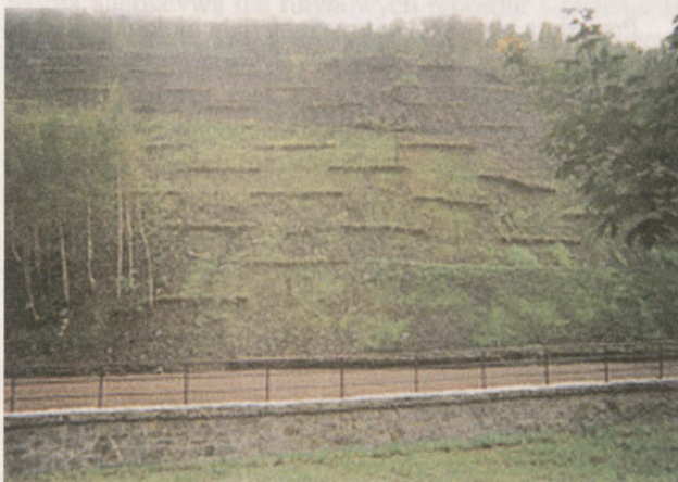
Ryc. 4. Rekultywacja zwałowiska w dzielnicy Gaj w Wałbrzychu. Zabezpieczanie skarp przed osuwaniem się materiału skalnego. Fot. R. Tritt
