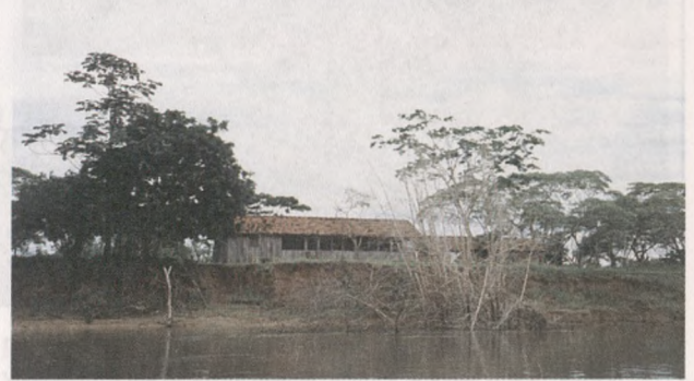
Fot. 5. Opuszczona chata nad brzegiem Parany
