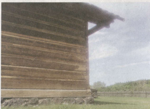
Ryc. 7. Rudy darniowe w podmurówce wiejskiej kuźni (XVIII w.), Skansen Kurpiowski w Nowogrodzie (województwo podlaskie)
