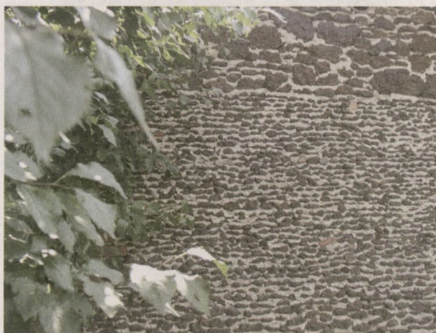
Ryc. 13. Fragment ściany budynku gospodarczego w Wierzchach (województwo wielkopolskie)
