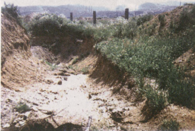
Ryc. 11. Wykop w sąsiedztwie pól uprawnych. Fot. R. Tritt
