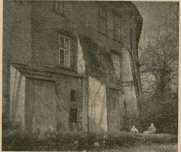
Ryc. 1. Mury północno-wschodnie Zamku w Wieliczce oraz dobudowane po trzęsieniu ziemi w r. 1785 wzmocnienia. Fot. A. Długosz
