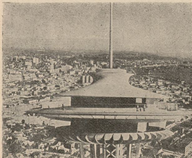
Ryc. 4. Na szczycie wieży zbudowano restaurację na trzysta osób, wykonuje ona w ciągu godziny pełny obrót
