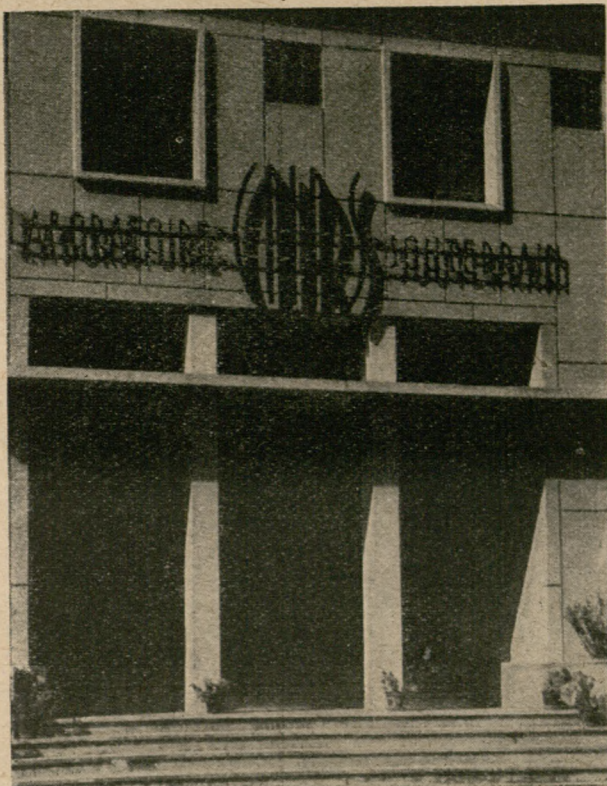
Ryc. 1. Budynek laboratorium podziemnego w Moulis Fot. W. Szymczakowski
