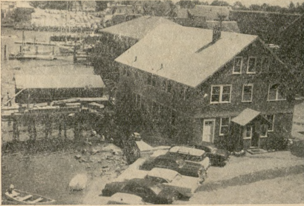
Ryc. 2. Jeden z budynków stacyjnych (zaopatrzenia i pracownia)
