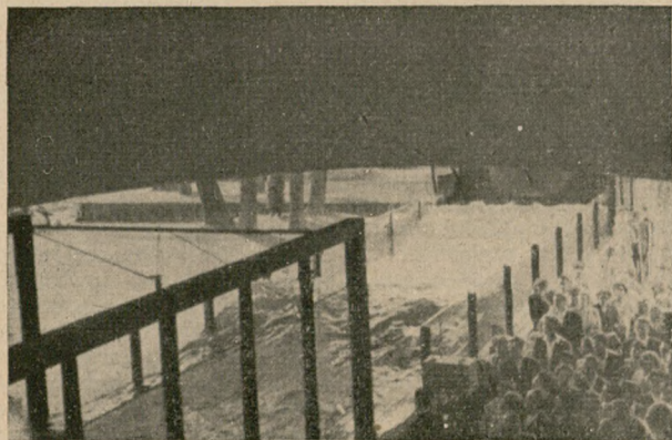
Ryc. 3. Ruchoma ścianka żelazna (w głębi, poza kopułą) wywołuje sztuczną falę w basenie o szklanych ścianach. Fot. L. Świdzińska
