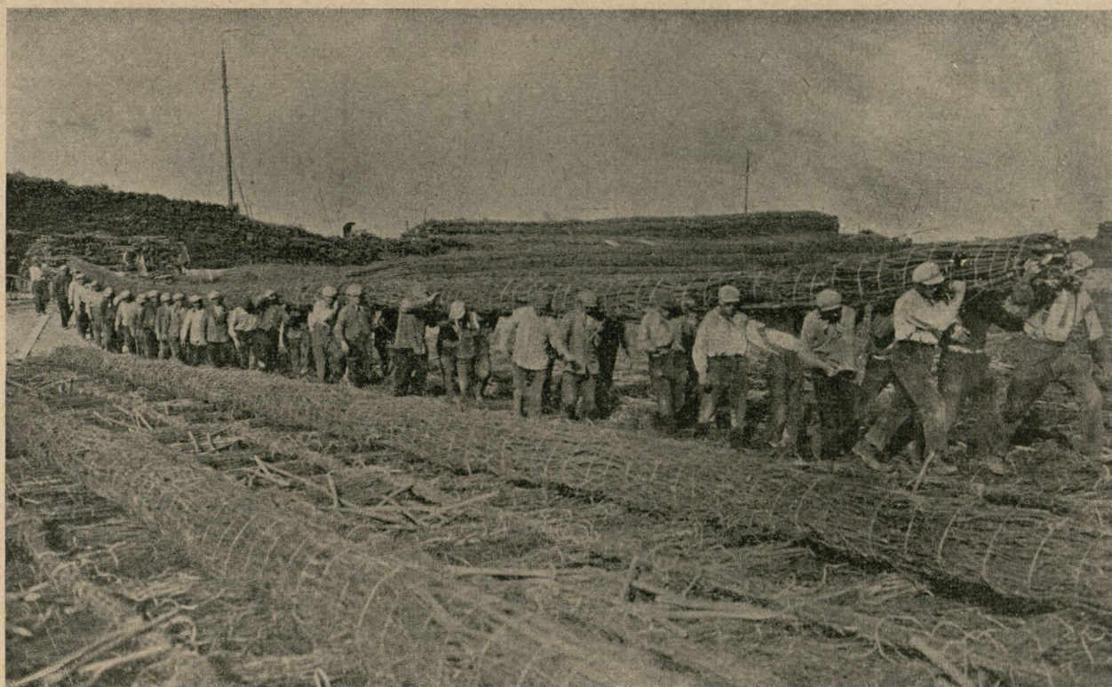
Ryc. 4. Potężne faszyny z chrustu wypełnione kamieniami służą jako pierwszy opór przeciw falom przy zakładaniu tamy
