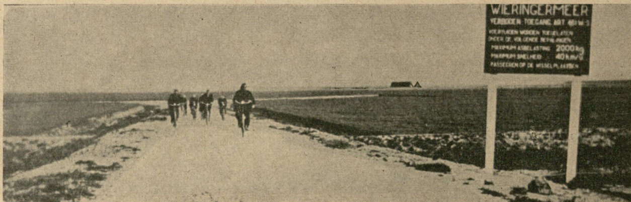
Ryc. 7. Droga utrwalona klinkierem na byłym dnie morskim. Droga przez polder Wieringer była zbudowana zaraz po osuszeniu, nim się teren dostatecznie osiadł
