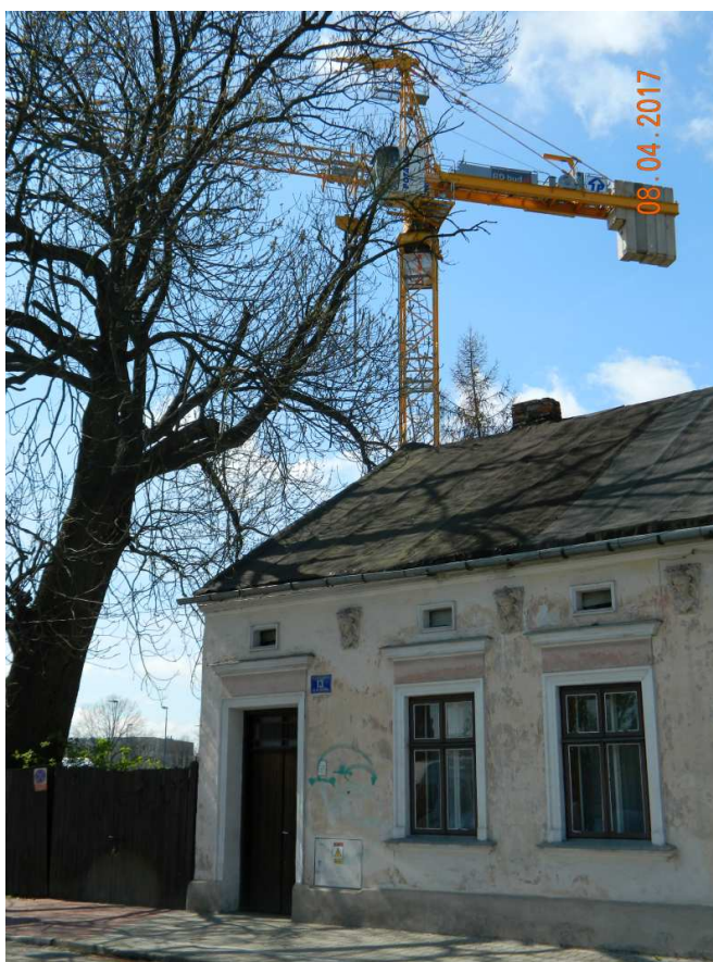
Fot. nr 17. Domek przy ulicy Kilińskiego 13 i rozpoczęta w jego sąsiedztwie budowa.
