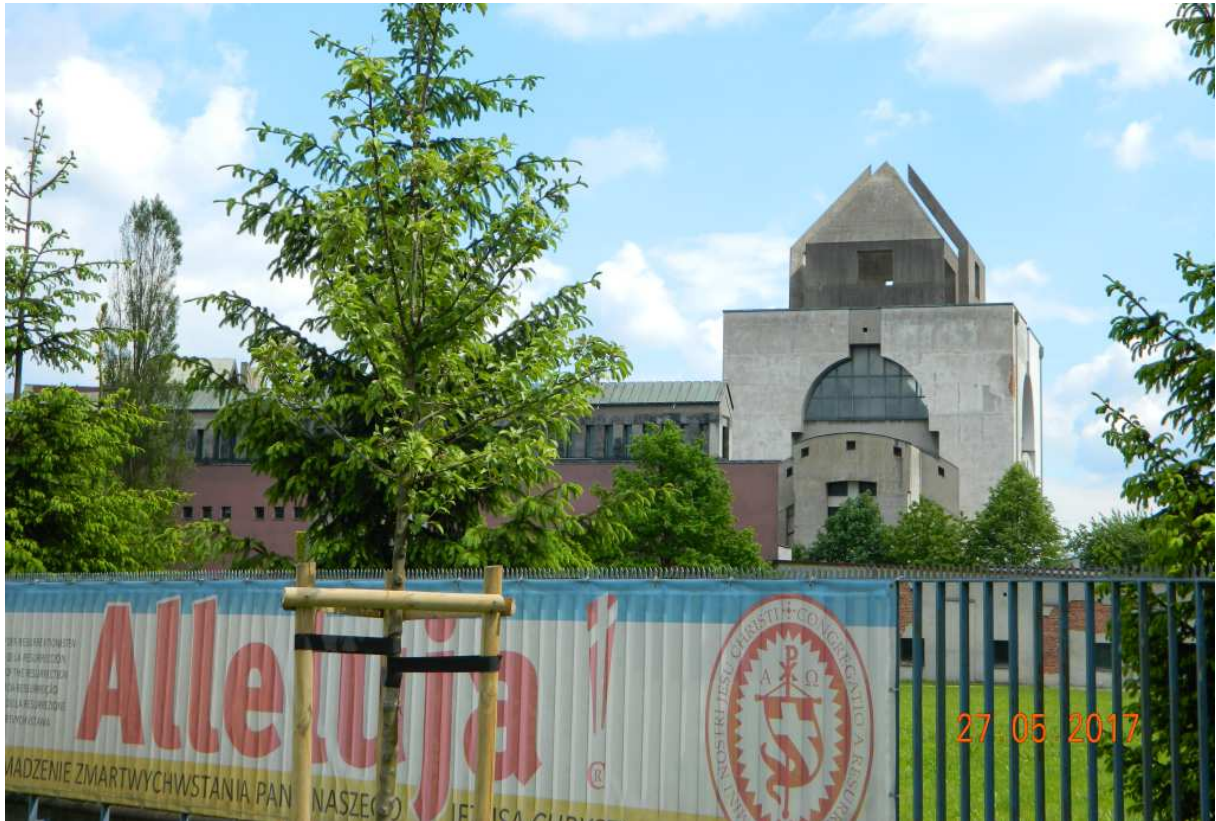
Fot. nr 28. Ujęcie z ulicy gen. Zielińskiego
