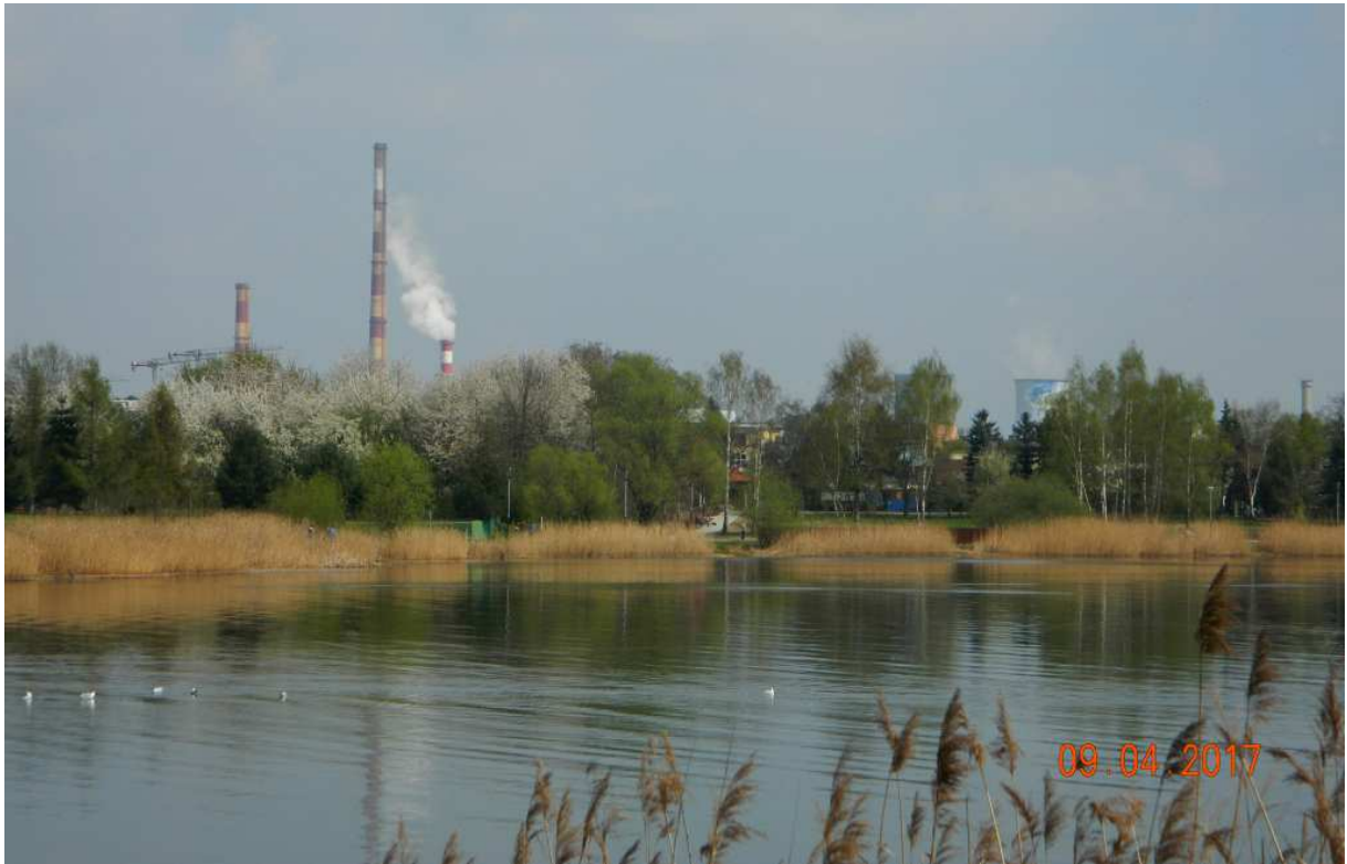
Fot. nr 218 (218-219). W stronę elektrociepłowni w Łęgu.
