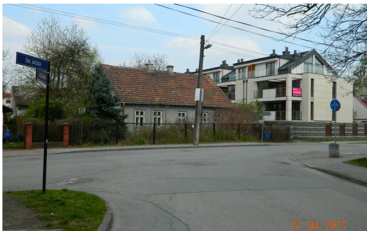
Fot. nr 31. Współczesna zabudowa ulicy Twardowskiego o nr: 91 i 93. Z dawnej zabudowy tego fragmentu ulicy (powyżej ulicy Kapelanka) pozostał już tylko dom pod nr 93 (z lewej). Piękny, stylowy „antyk” spod nr 91 został wyburzony w roku 2014. Ujęcie z wylotu ulicy Ceglarskiej.
