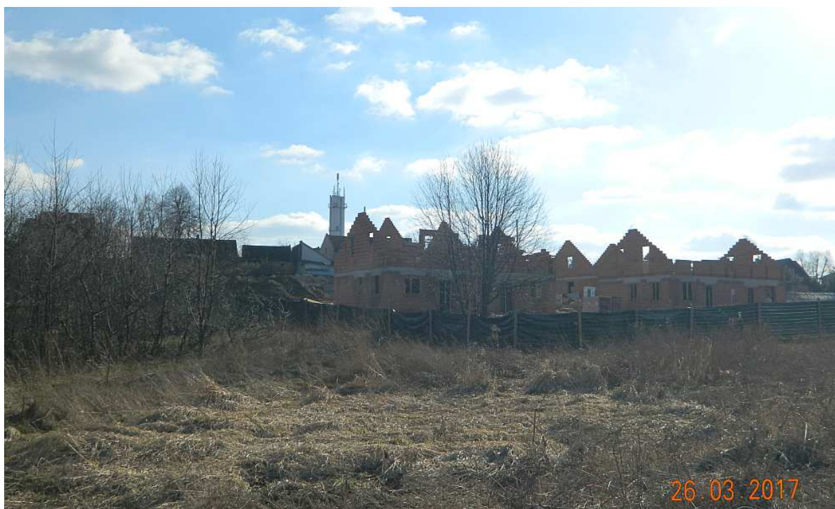
Fot. nr 301 (301-302). Szybko rozrasta się zabudowa na pograniczu Rżaki i Piasków Wielkich na styku ulic: Kosocickiej i Rżackiej.
