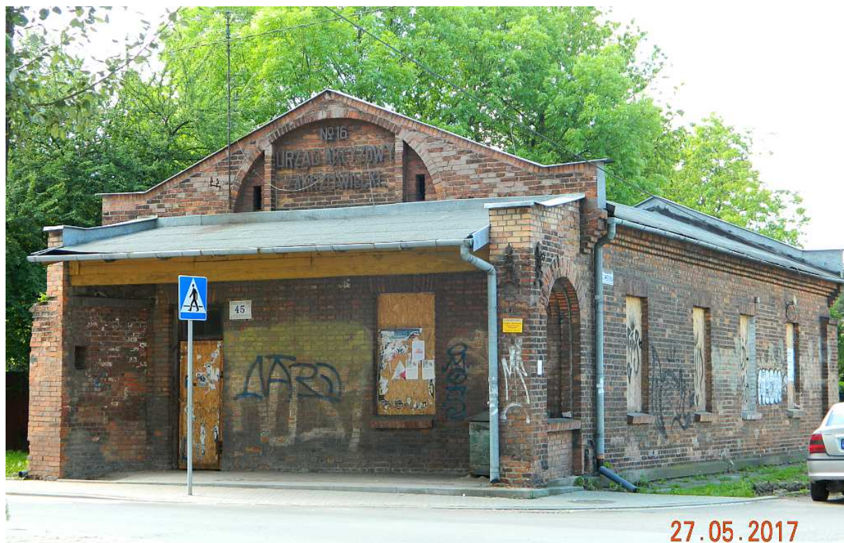
Fot. nr 30. Budynek Urzędu Akcyzowego nr 16 przy ulicy Twardowskiego 45, który powstał z miejsca dawnej bramy zakrzowieckiej z czasów Twierdzy Kraków.
