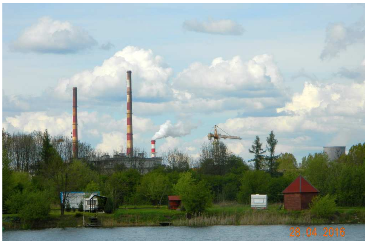
Fot. nr 182. Kominy elektrociepłowni w Łęgu ponad nowo zabudowywanym obszarem pomiędzy ulicami: Kozią i Bagrową.
