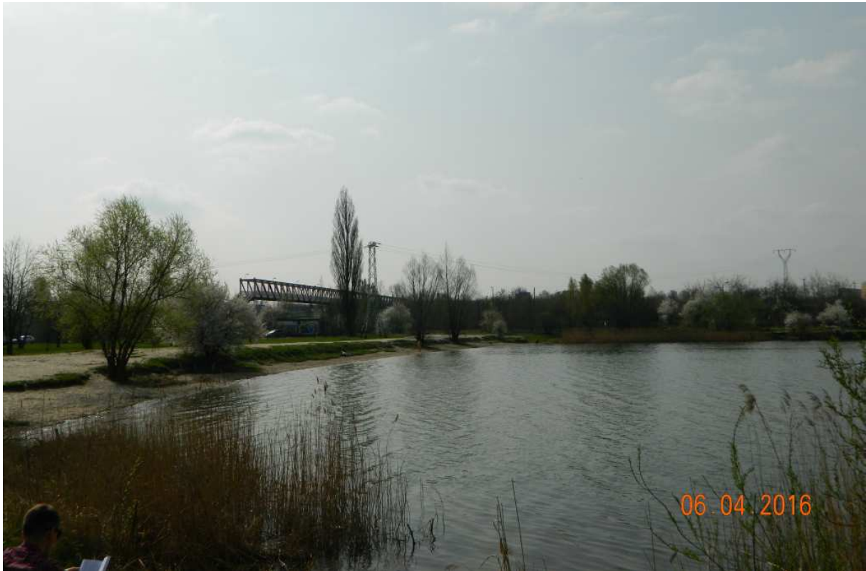
Fot. nr 237 (237-238). Kładka dla pieszych nad stacją rozrządową w Prokocimiu. Może niedługo zniknie, gdy zlikwidowana zostanie zamierzająca dziś stacja rozrządowa w Prokocimiu, a jej miejsce powstanie nowe blokowisko?
