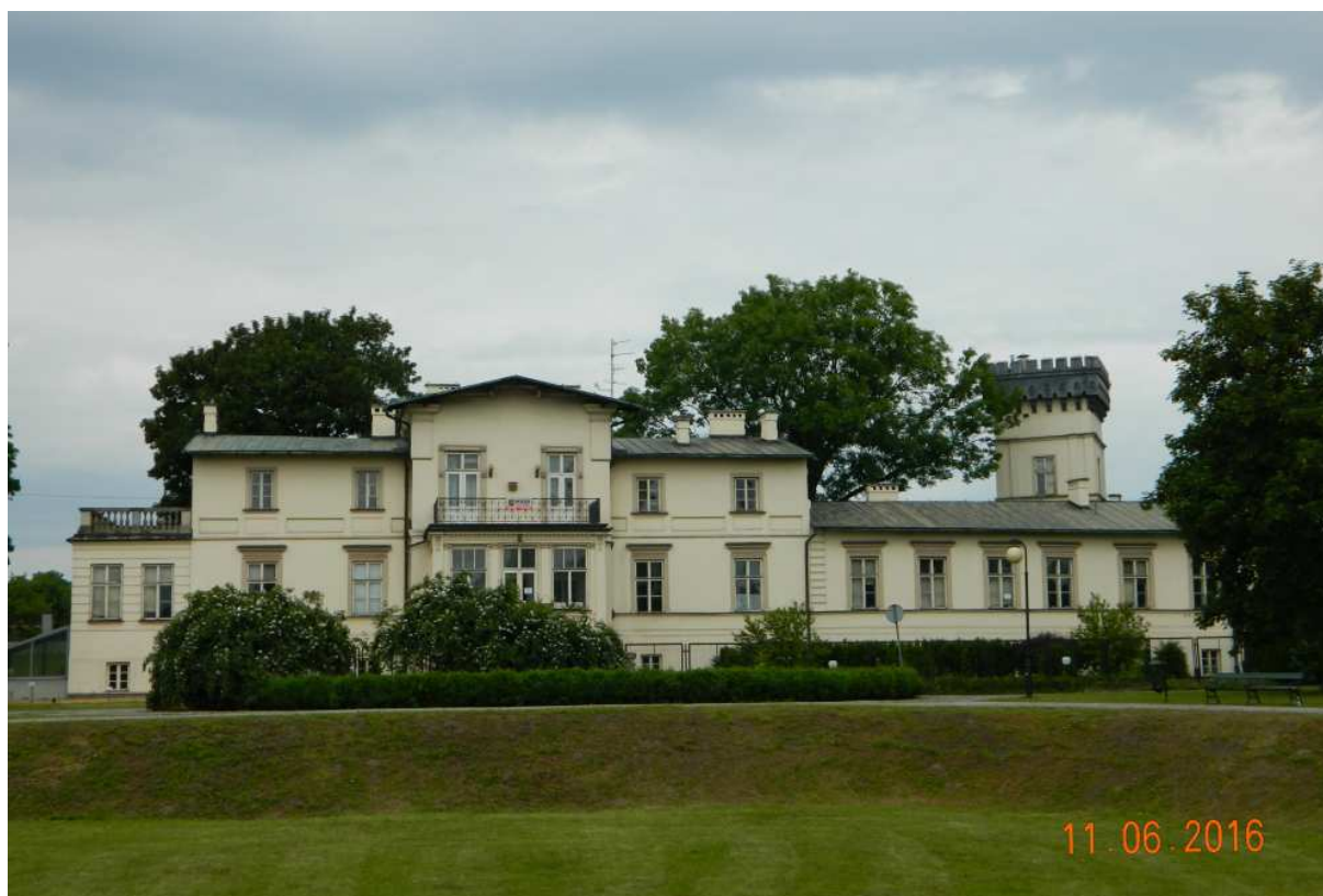
Fot. nr 32 (32-34). Eklektyczny Pałac Lasockich i jego detale – widok od strony parku.
