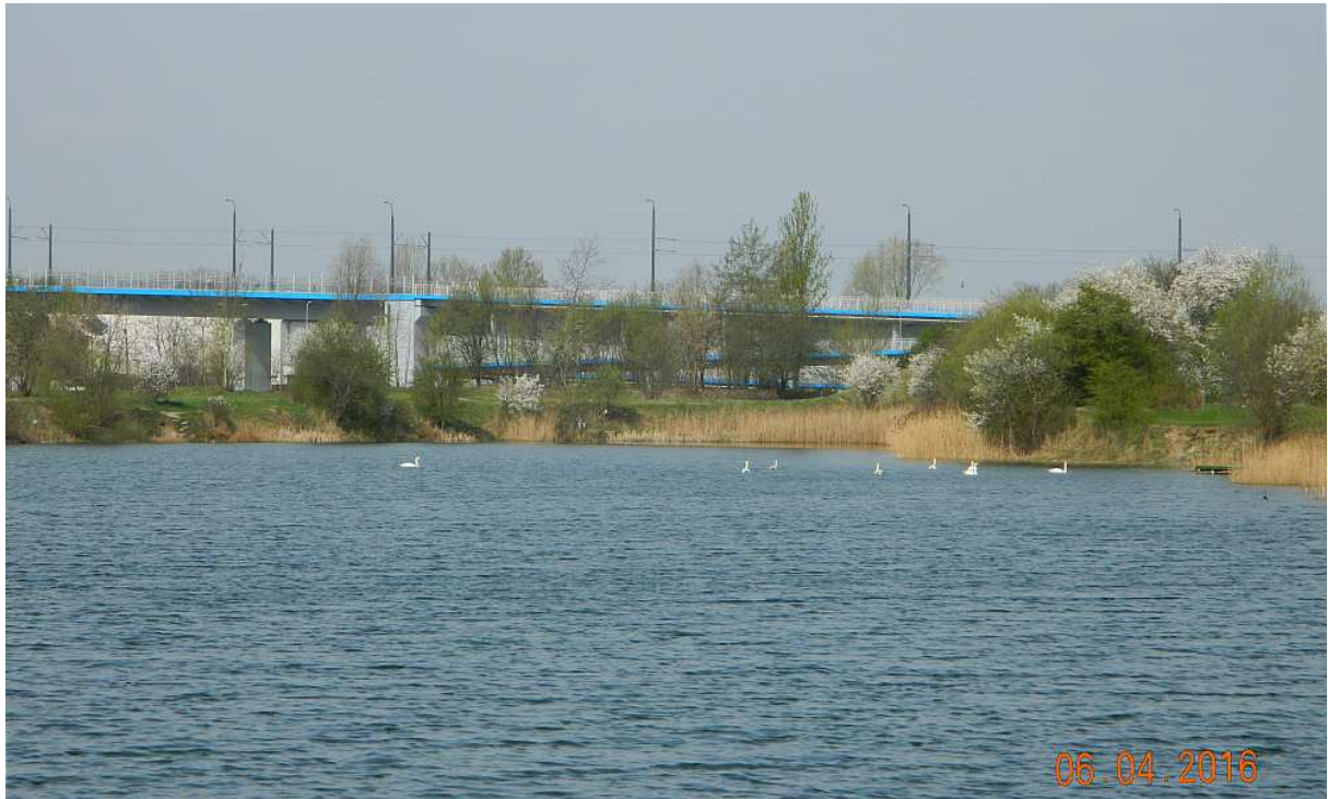
Fot. nr 219. Estakada tramwajowo-rowerowa – widok od strony kąpieliska.
