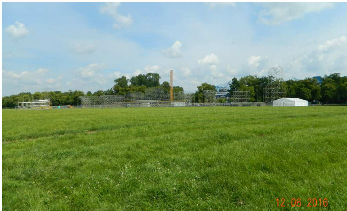
Fot. nr 110 (110-111). Trwa budowa ołtarza na Światowe Dni Młodzieży.
