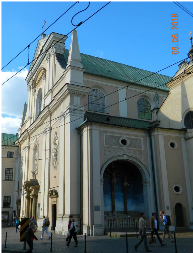
Fot. nr 76. Widok na Ogrojec.
