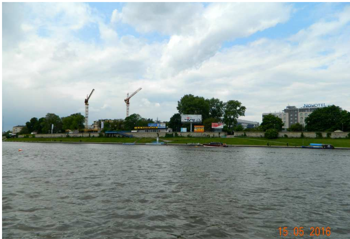
Fot. nr 40 (40-42). Trwa zabudowa bulwaru wiślanego w sąsiedztwie ulicy Kościuszki przez źle kojarzoną w Krakowie firmę deweloperską ECHO. Dla niej nie ma żadnych świętości, że wskaże choćby zabudowę sąsiedztwa Parku Dębnickiego.
