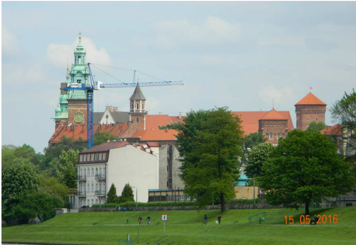
Fot. nr 46(46-47). Sylwety Wawelu w ujęciu z sąsiedztwa Pałacu Lasockich. Żurawie budowlane stają się prawdziwą zmurą dla fotografów i dają apokaliptyczny obraz.
