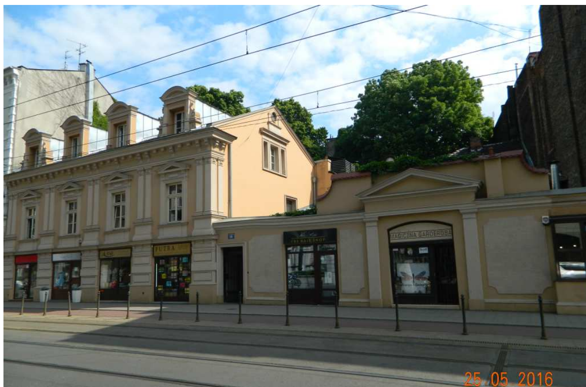
Fot. nr 20. Galicyjski klimat pogranicza Wesolej i Stradomia – zachowana do dzisiaj niska zabudowa ulicy Starowiślniej pod nr 10, na skraju dawnej Wesolej (1893). Tu mieściła się dawna pracownia malarska Piotra Stachewicza, a później Leona Wyczółkowskiego.
