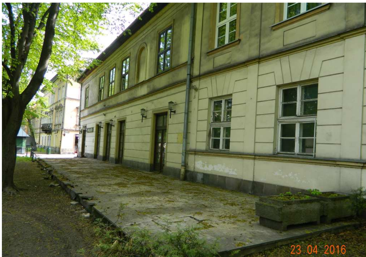
Fot. nr 15 (15-16). Kamieniczka z naroża Plant i ulicy Szewskiej (nr 26), gdzie przez cztery dekady funkcjonowała popularna kawiarnia „U Zalipianek”.
