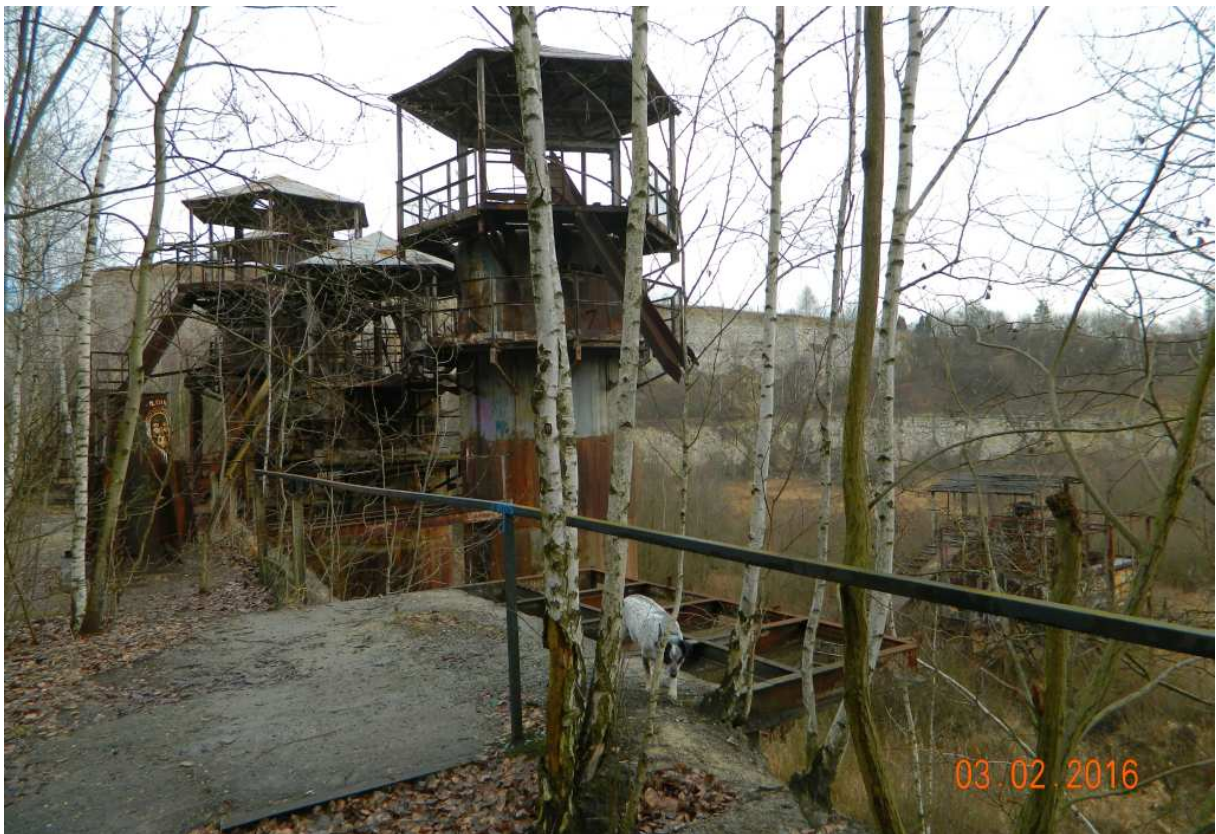
Fot. nr 34 (34-40). Detale dawnej, powojennej instalacji przeróbczej.
