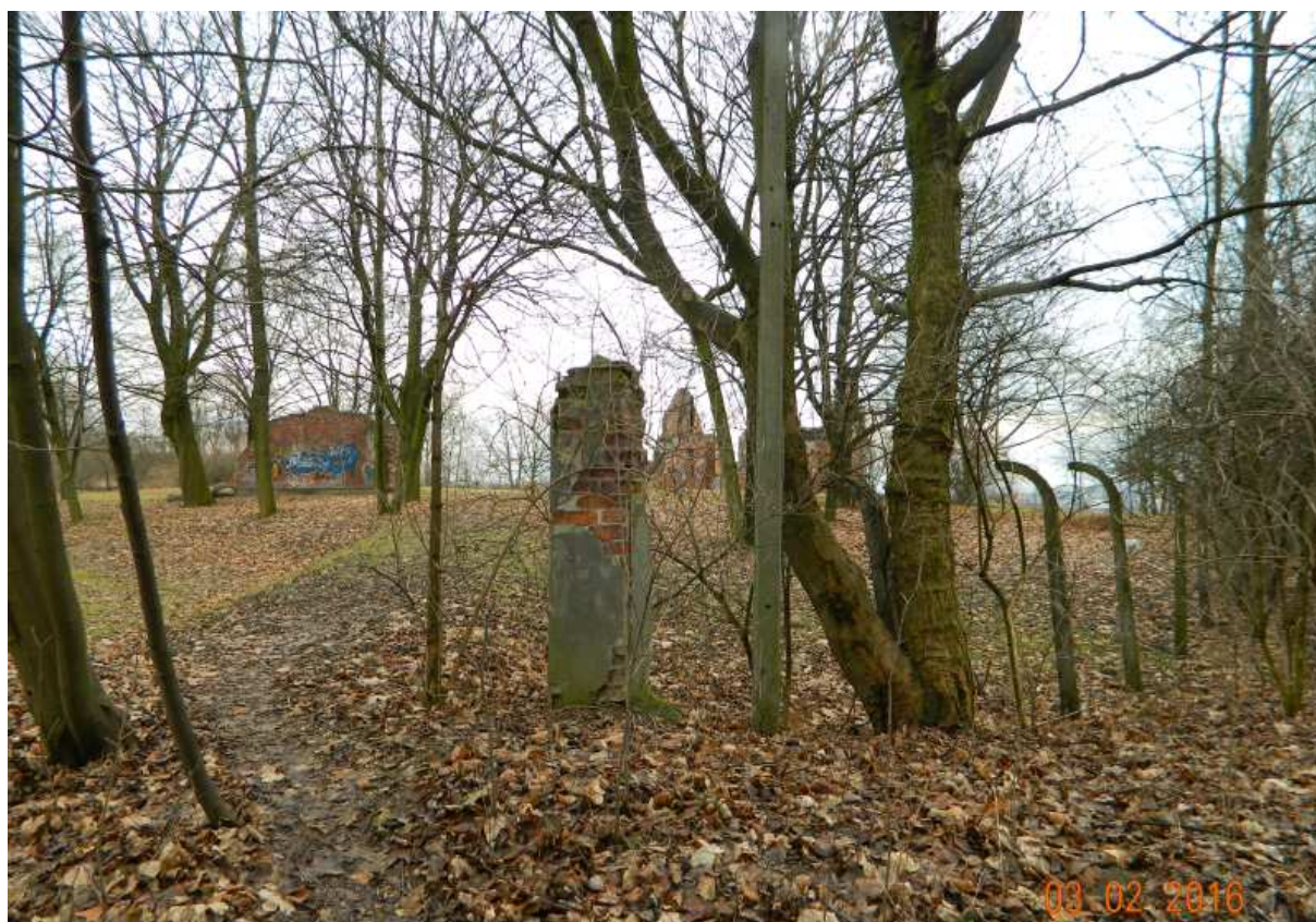
Fot. nr 96 (96-99). Ruina dawnej prochowni w sąsiedztwie kamieniołomu Libana i ulicy Swoszowickiej.
