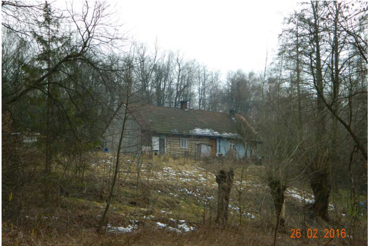
Fot. nr 259. Wiekowa chałupa na zakrzaczonym zboczu w głębi ulicy Szczawnickiej.
