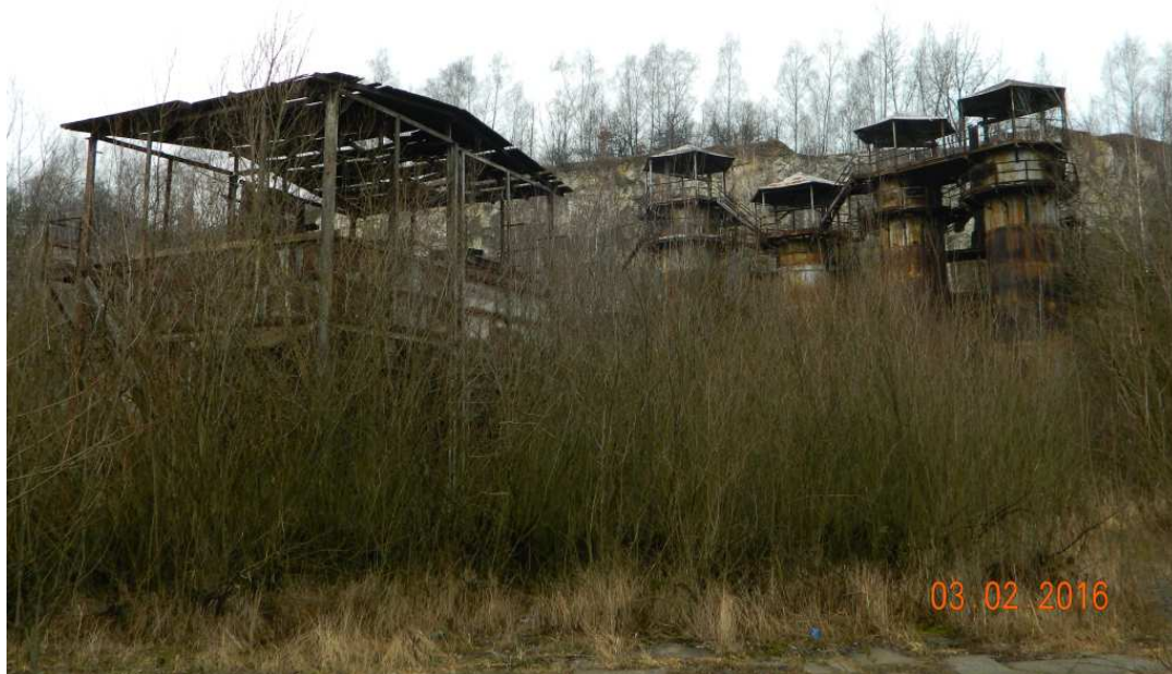
Fot. nr 17 (17-19). Pozostałości powojennej instalacji do przeróbki wapienia.
