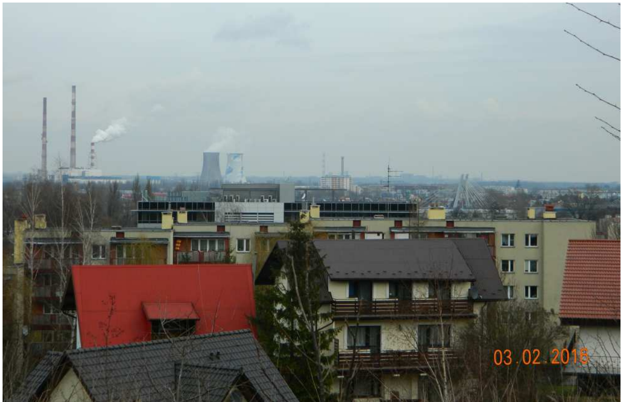
Fot. nr 120. Ponad ulicą Wielicką w stronę elektrociepłowni w Łęgu i dawnej HiL (w tle).
