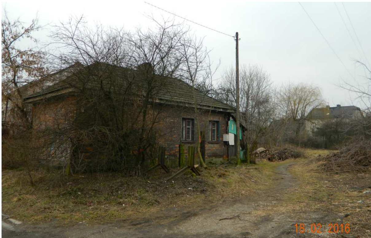
Fot. nr 173. Dawna budka dróżnika przed wiaduktem przy ulicy Morawiańskiego.
