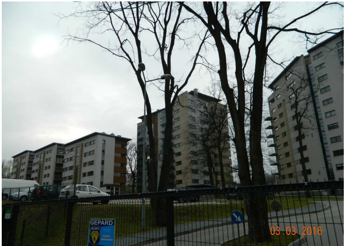
Fot. nr 71 (71-72). Marnie przedstawia się przyszłość tych starych dębów, które zostały wciśnięte w wąski korytarz pomiędzy wysokimi blokami.
