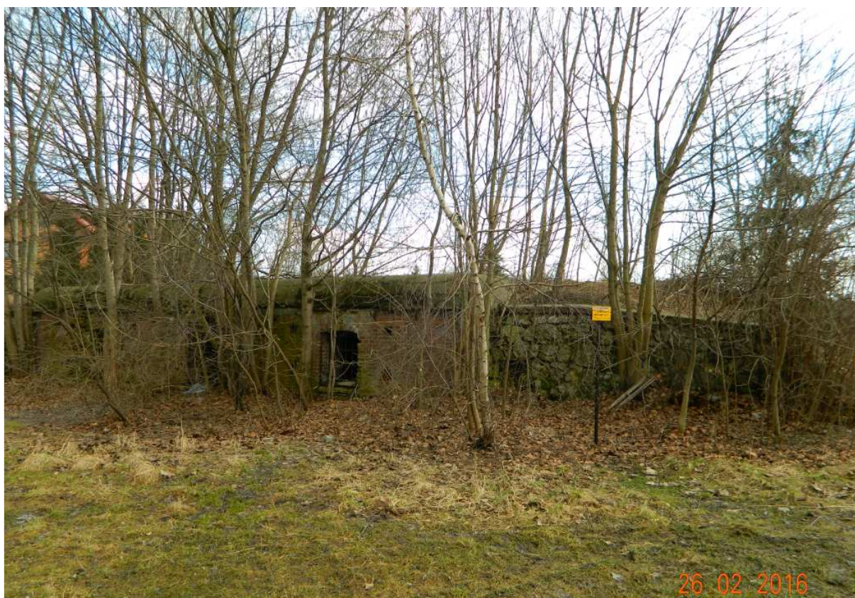
Fot. nr 192. Schron amunicyjny na początku ulicy Niebieskiej.
