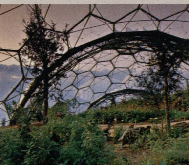
Na szkieletcie ze stali rozpięto sześciokątne okna z superwytrzymałej folii przepuszczającej ultrafiolet
