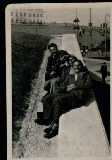
Z przyjaciółmi przy wylocie tunelu Trasy W-Z, lata 50.
