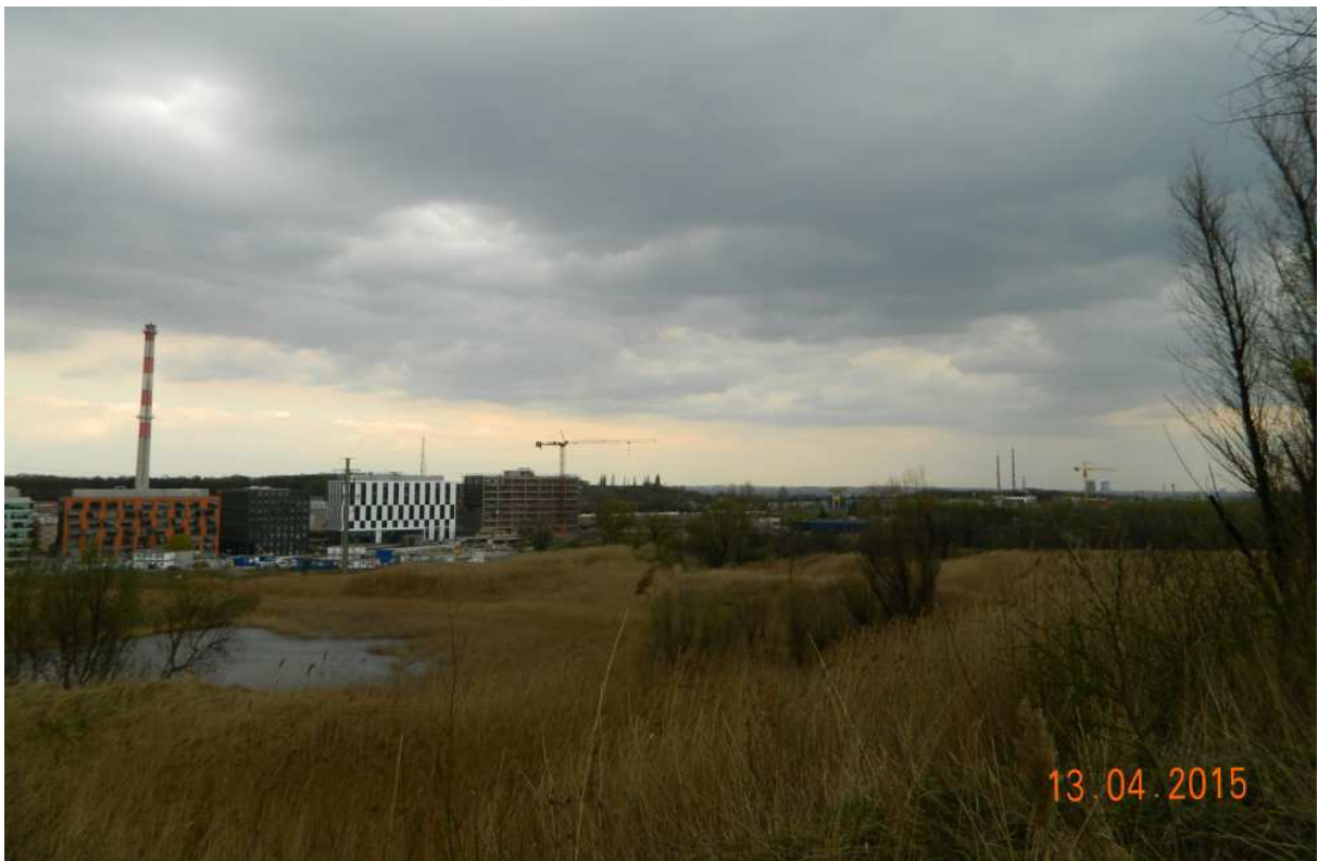
Fot. nr 126. Wspomnienie po przemysłowej Bonarce, fabryce o galicyjskich korzeniach, kiedyś cementowni, potem wytwórni nawozów sztucznych, po której pozostał staw i komin.
