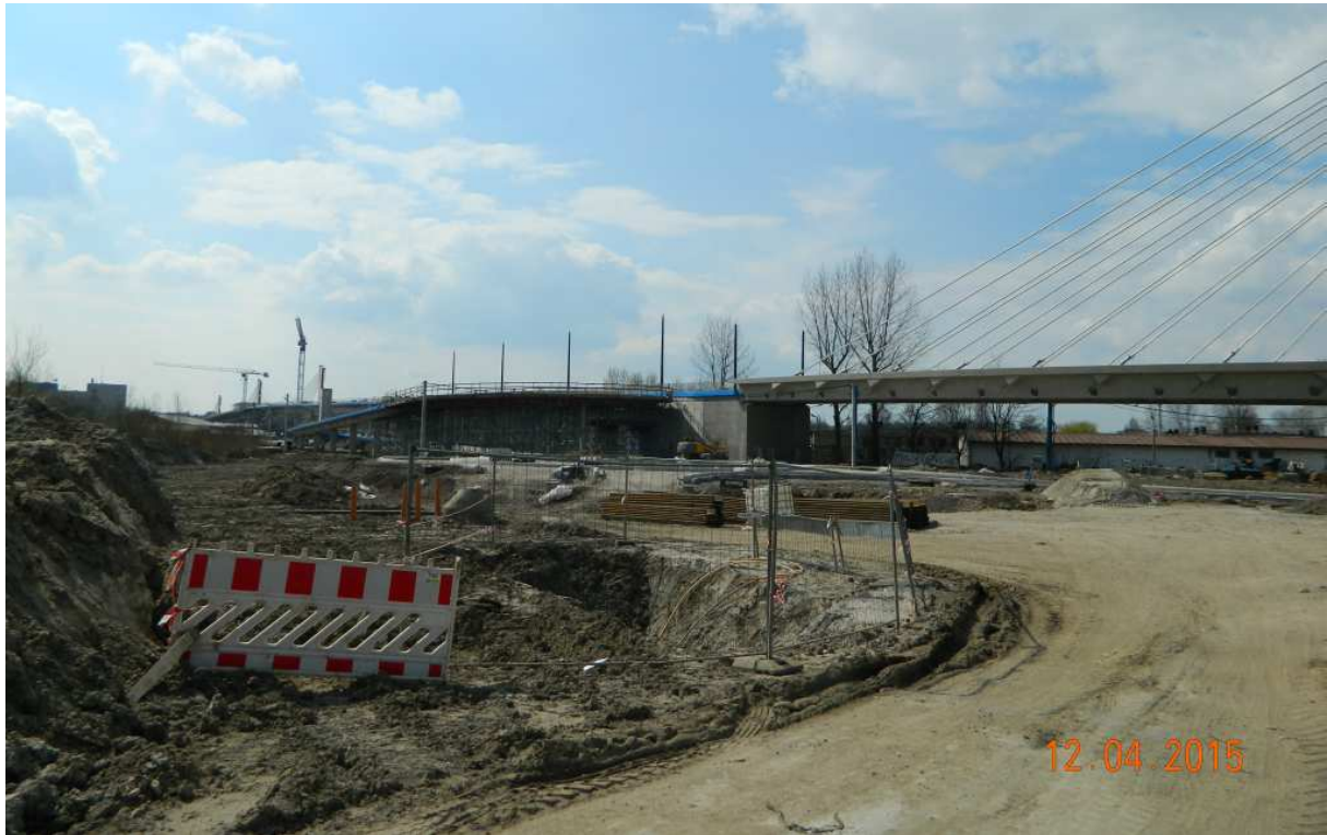
Fot. nr 215 (215-217). Końcowy etap budowy nowej estakady – fragment w sąsiedztwie ulicy Żołnierskiej.
