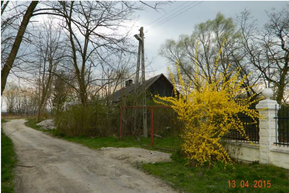
Fot. nr 119 (119-122). Potwornie zaniedbany i zagrożony domek podmiejski z początku ulicy Wspólnej (nr 1).
