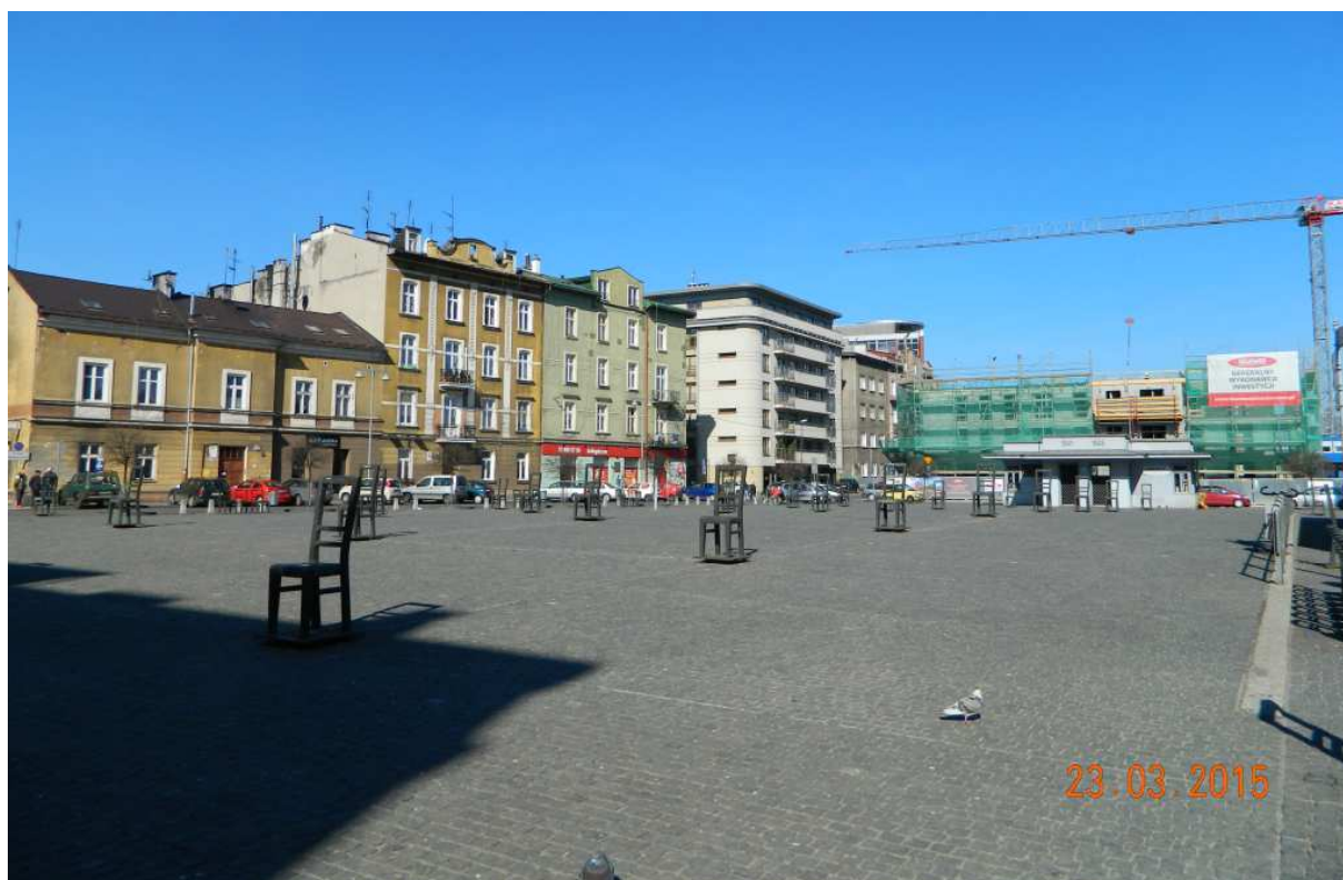
Fot. nr 12. Widok w stronę ulic: Piwnej i Nadwiślańskiej. Przy wylocie ulicy Piwnej trwa kolejna budowa. Plac Bohaterów Getta szybko się kurczy.
