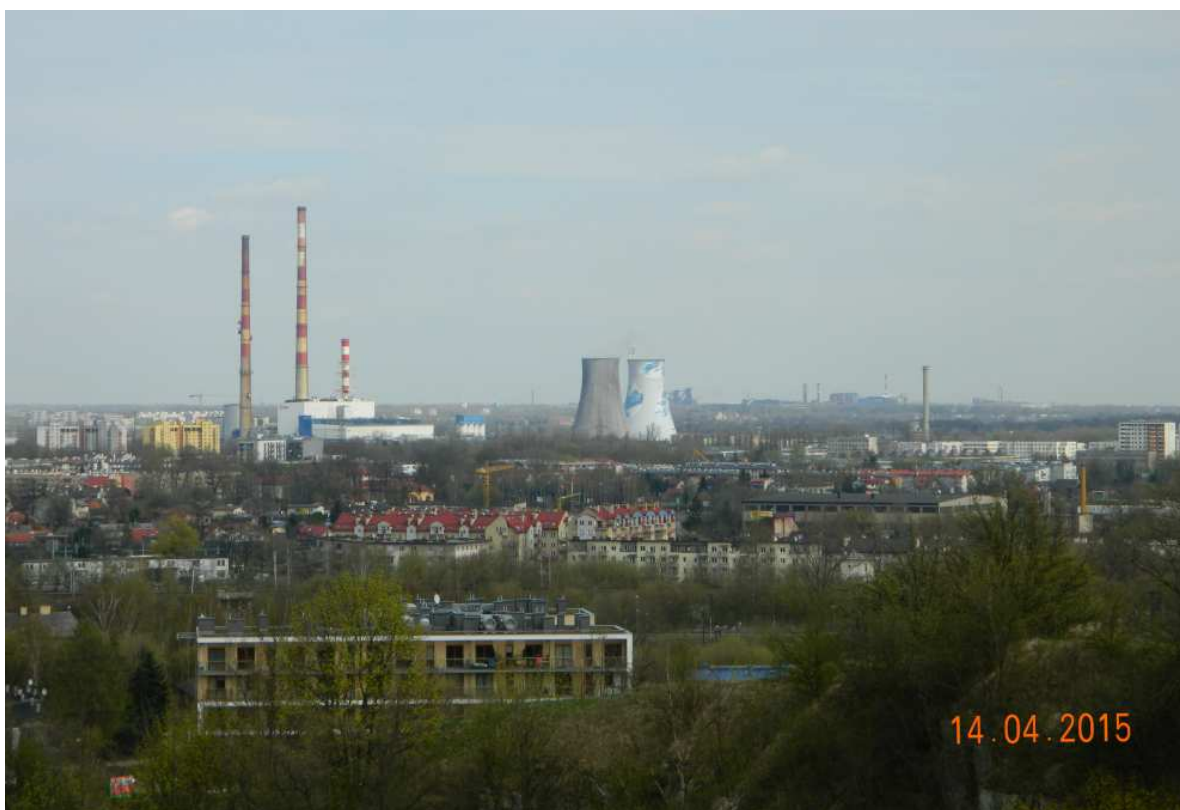
Fot. nr 68 (68-69). Elektrociepłownia w Łęgu i dawny kombinat metalurgiczny (w tle).
