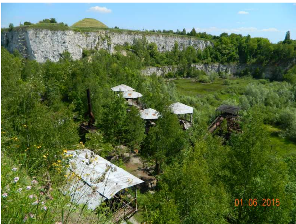
Fot. nr 50. Widok od strony ulicy Swoszowickiej na dawną instalację przeróbczą skały.
