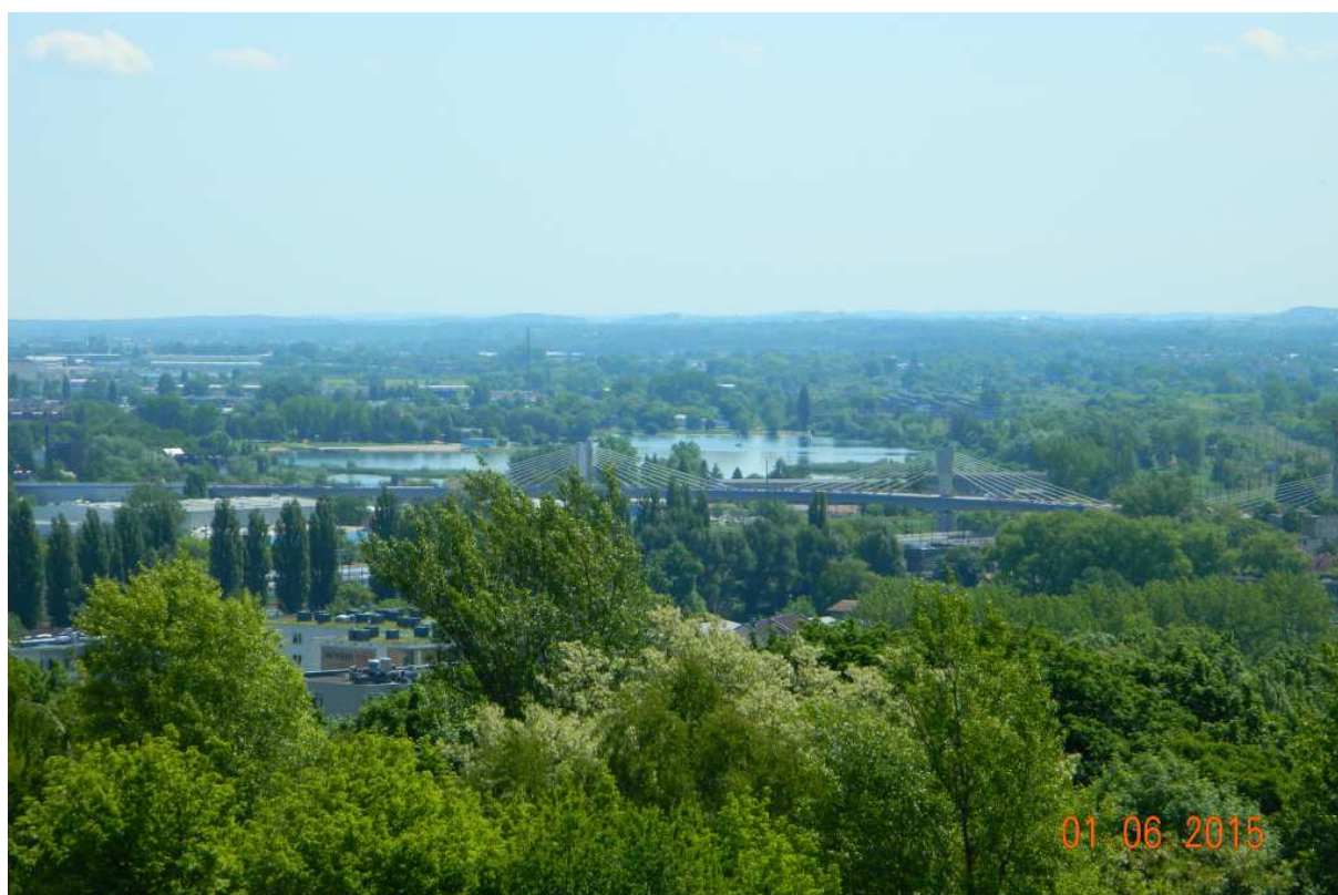
Fot. nr 40. Bagry i nowo powstająca estakada drogowa.
