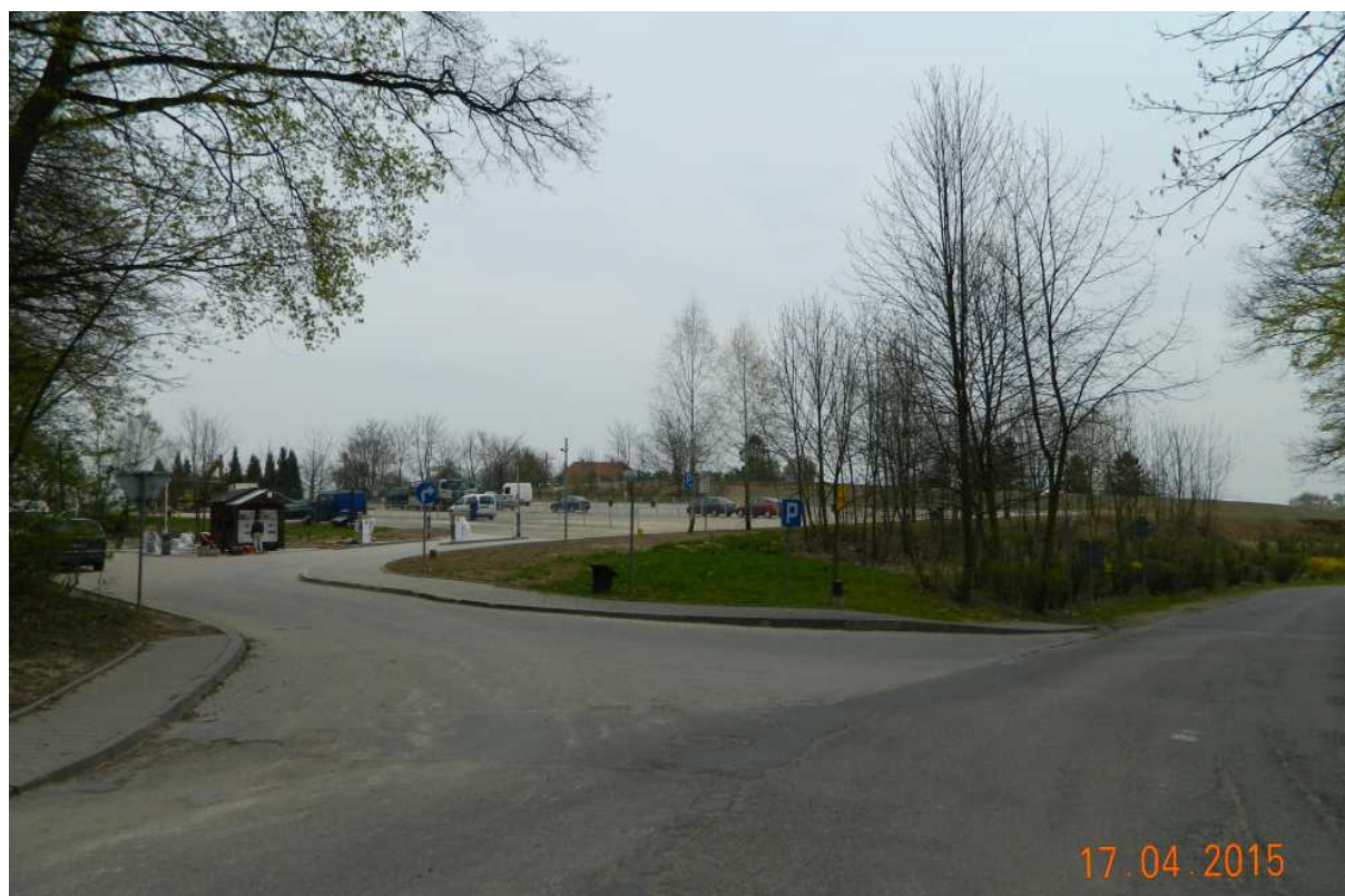
Fot. nr 195 (195-197). Końcowy etap rozbudowy parkingu na styku ulic: Leśnej i Kukułczej.
