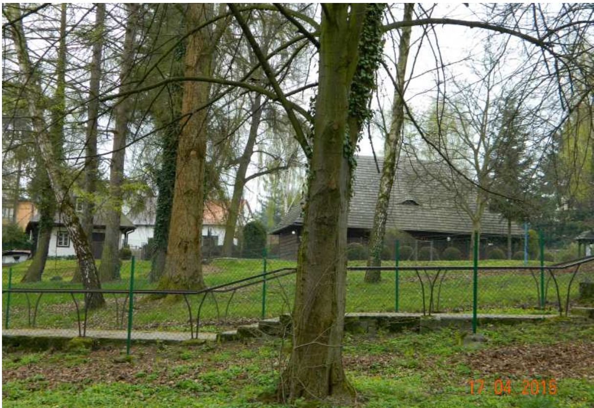
Fot. nr 157. Plebania w budynku zabytkowej karczmy z Pasieki koło Czernichowa.
