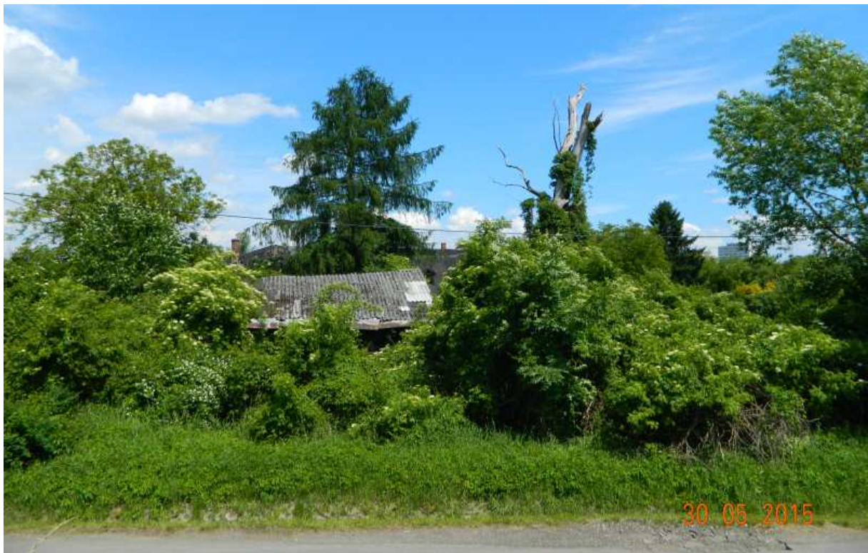
Fot. nr 57 (57-58). Szczelnie okryta zielenią dawna osada rolnicza przy ulicy Mydlnickiej (nr: 73-77), która powstała w sąsiedztwie dawnego jazu – ujęcie z wału Rudawy
