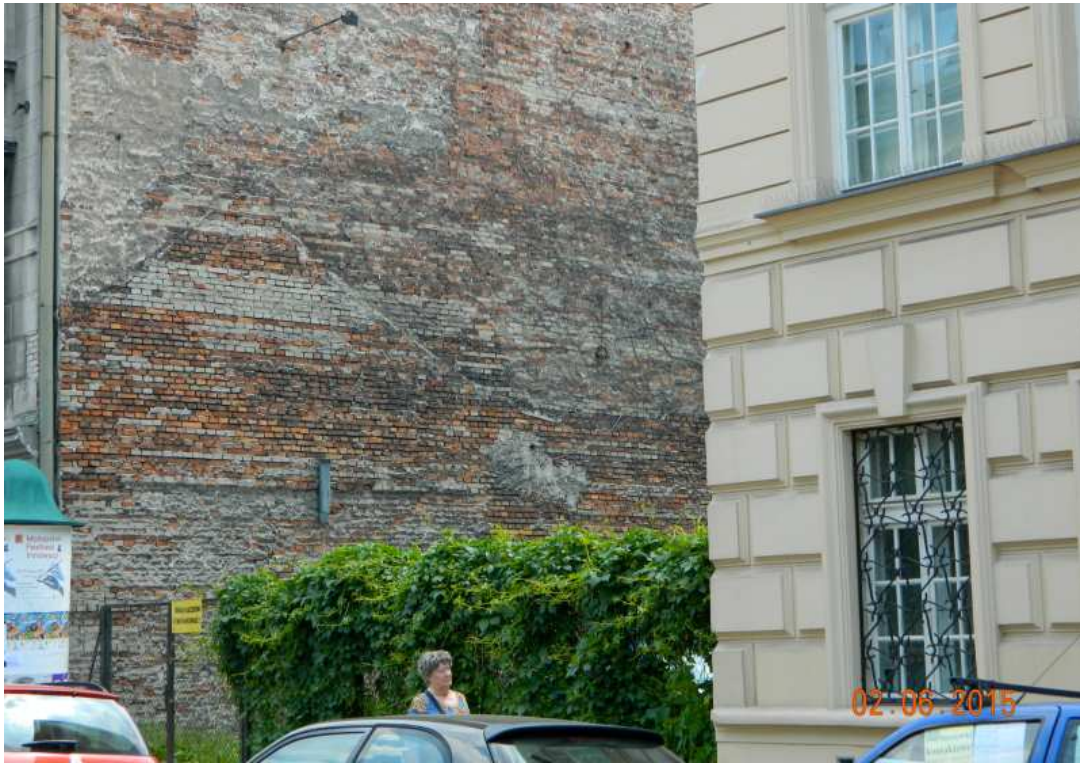
Fot. nr 26. Wspomnienie parterowego domku malarza Witolda Rzegocińskiego z ulicy Krupniczej 24 (na ścianie bocznej Domu Literatów widoczny narys dachu).
