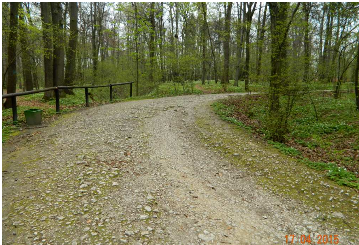
Fot. nr 178 (178-179). Dawna droga dojazdowa (forteczna) do baterii FB-38, która kiedyś funkcjonowała w miejscu Kopca Piłsudskiego.
