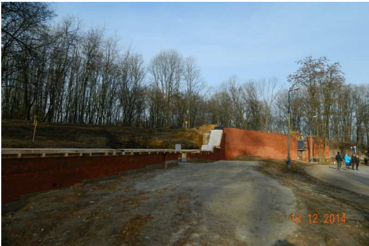
Fot. nr 18 (18-19). Widoki od strony alei Waszyngtona.
