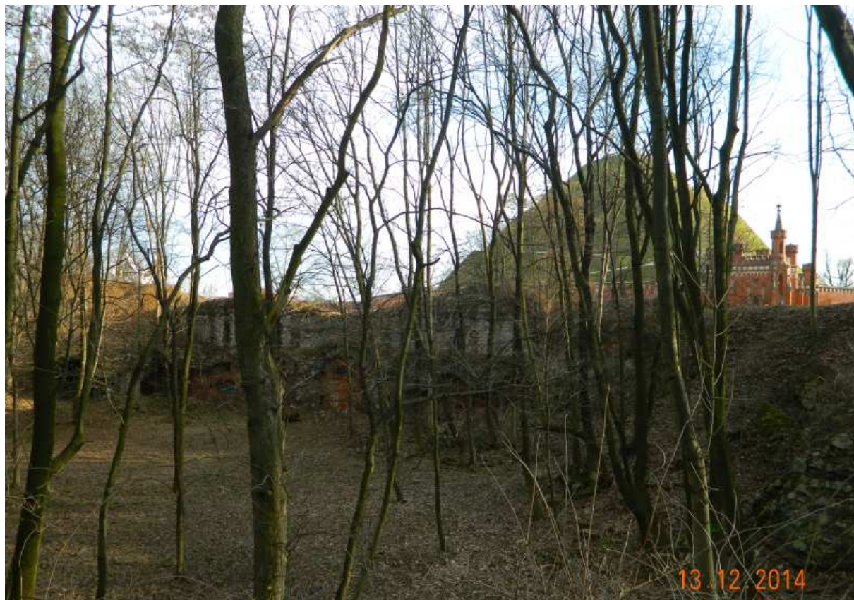
Fot. nr 25 (25-29). Ruina bastionu nr II. Widoki od strony fosy.
