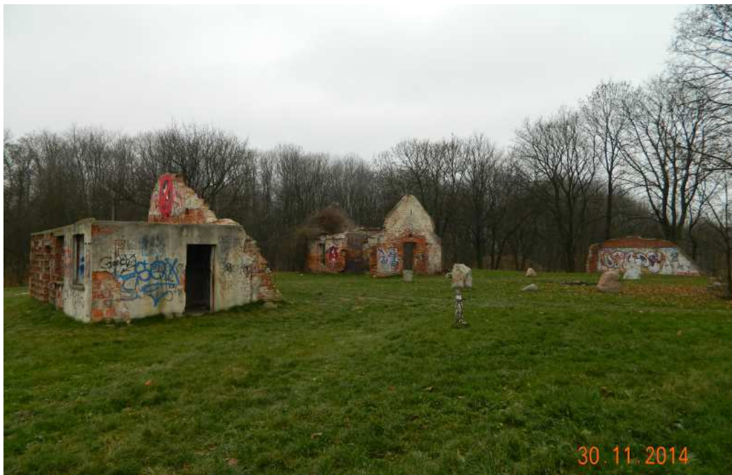
Fot. nr 124 (124-126). Ruina dawnej prochowni z czasów Twierdzy Kraków w sąsiedztwie ulicy Swoszowickiej i Lasu Bonarka.
