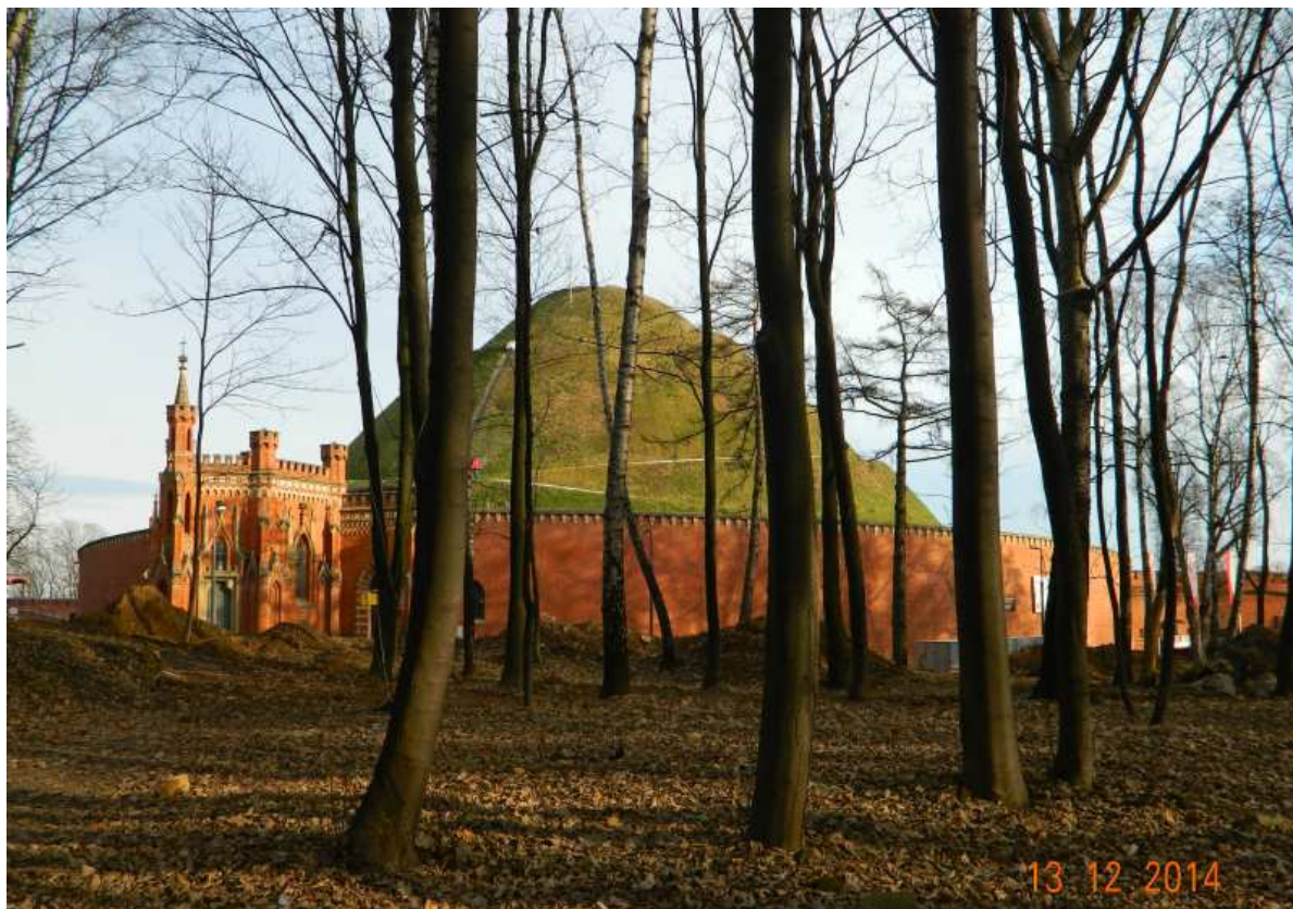
Fot. nr 21. Ujęcie z przedpola splantowanego bastionu nr I.
