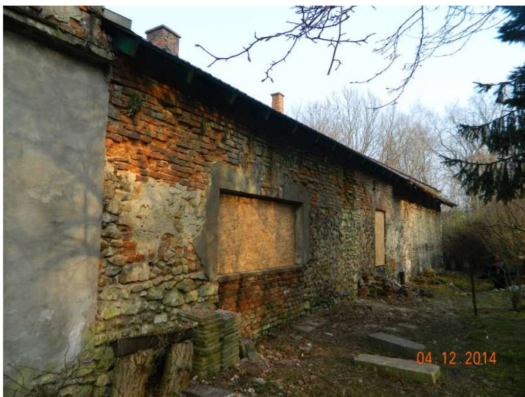
Fot. nr 172. Dawna wozownia od strony podwórka.
