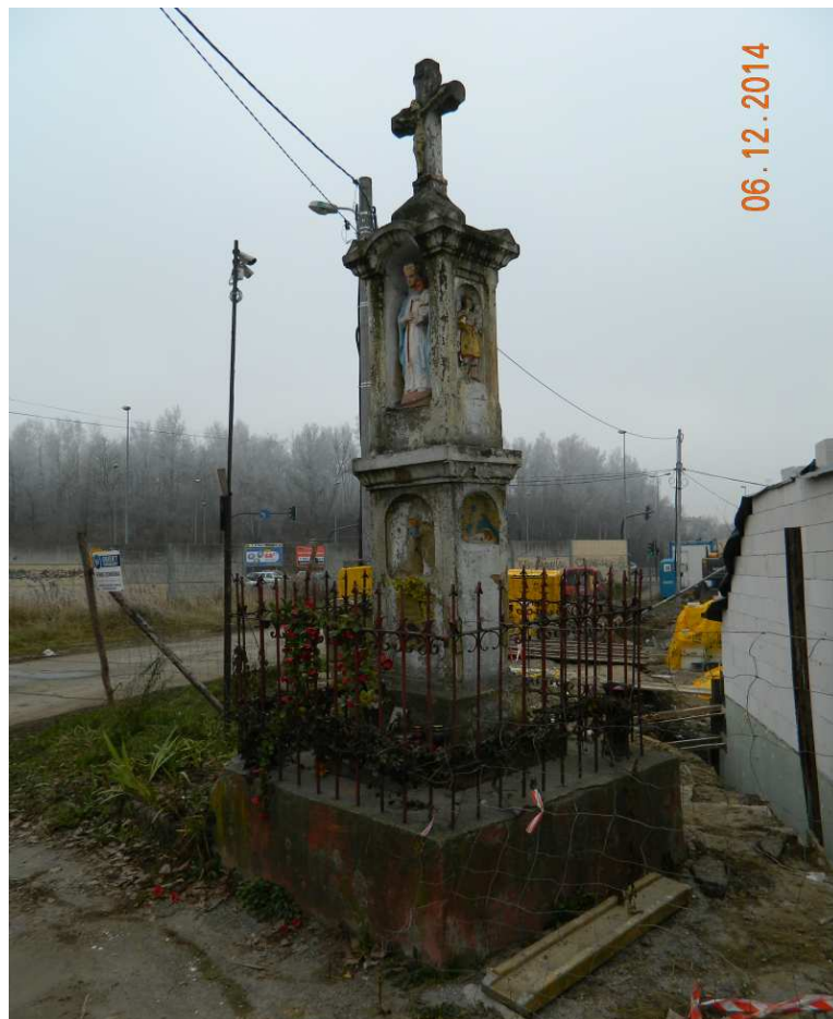
Fot. nr 238. Mocno zaniedbana, czterostronna kapliczka słupowa z naroża ulic: Cechowej i Myślenickiej, posadowiona tu w 1876 roku.
