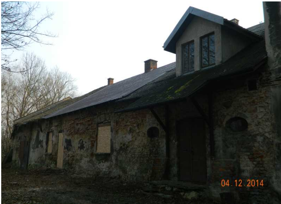
Fot. nr 168. Dawna wozownia od strony stawu.
