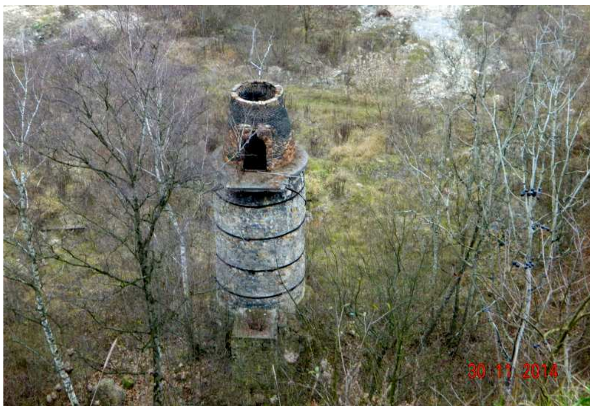
Fot. nr 94. Dawny piec do wypalania skały wapiennej na dnie kamieniołomu.
