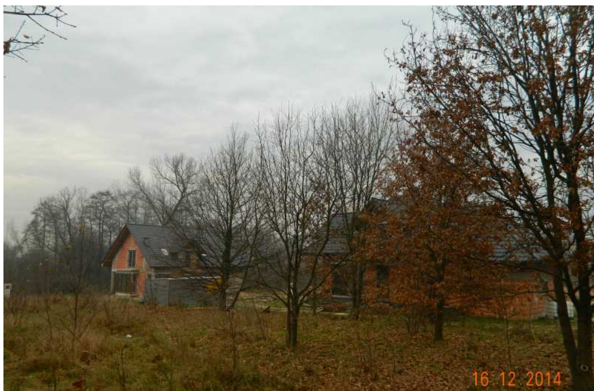
Fot. nr 208. Współczesna zabudowa skraju łąki na styku ulic: Mokrej i Obronnej. Oba te budynki powstały w tym roku (2014) niczym grzyby po deszczu.
