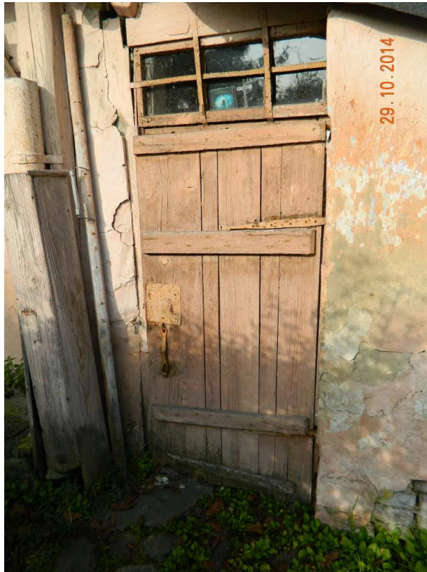
Fot. nr 124. Drzwi do komórki.
