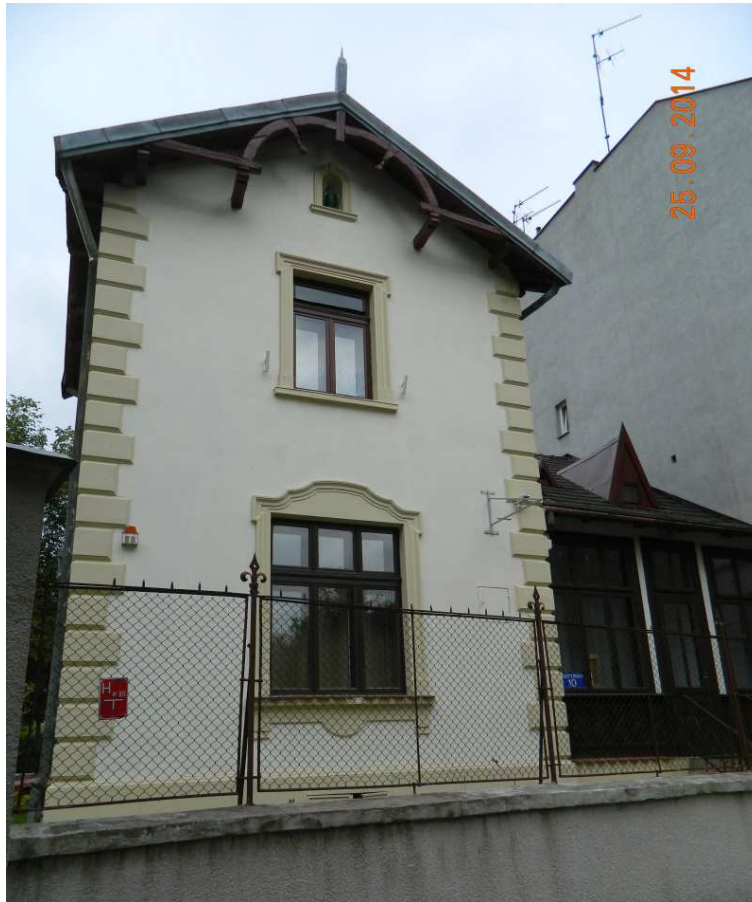
Fot. nr 90. Artystyczna więźba drewniana dachu.
