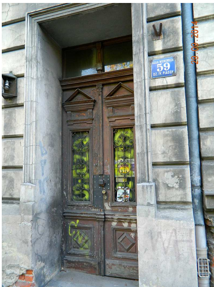
Fot. nr 55(55-56). Detale eklektycznej kamienicy spod nr 59 (1898). Tu drzwi wejściowe.
