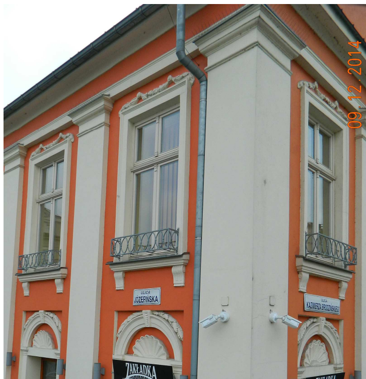
Fot. nr 85. Przywrócone detale okien w kamienicy pod nr 2, choć to już plastiki.
