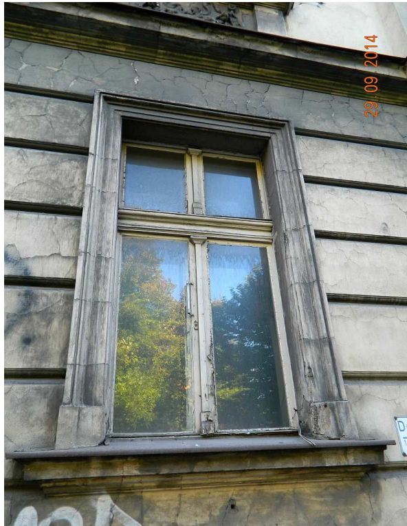
Fot. nr 56. Oryginalne okno parteru, podobne jak w sąsiednich kamienicach.
