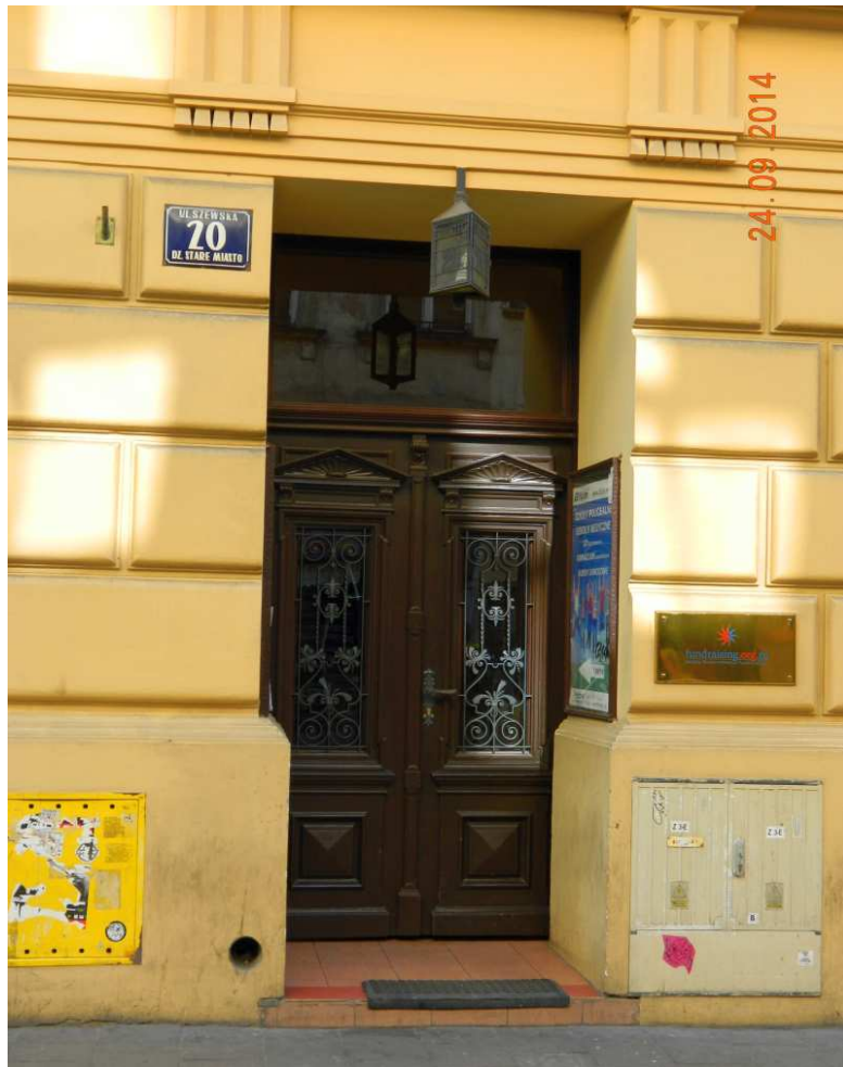
Fot. nr 35 (35-36). Drzwi kamienicy po remoncie.
