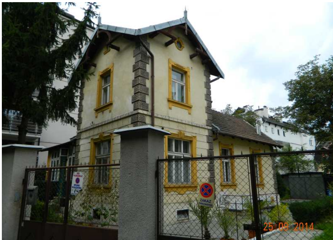
Fot. nr 91 (91-92). Równie interesująca willa z ulicy Cieszyńskiej 8 (1917). I tu zachowały się fragmenty zdobionej więźby dachowej.
