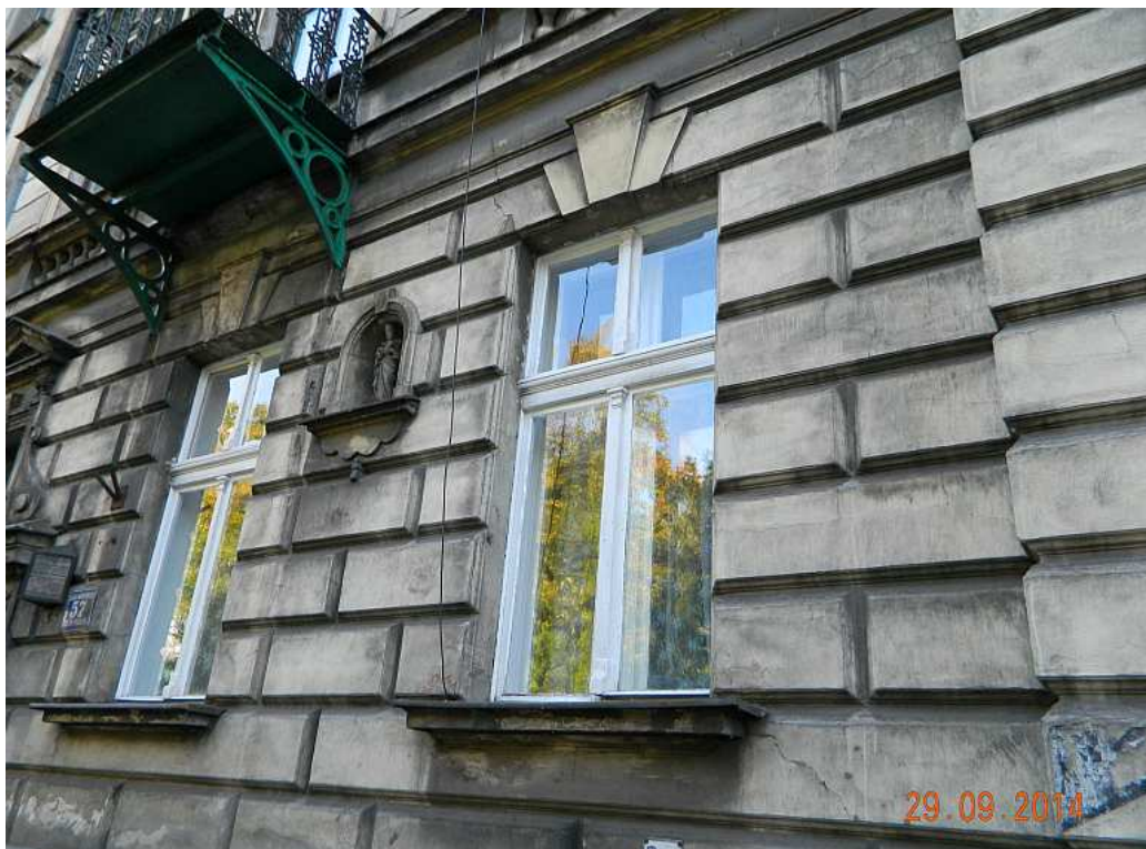
Fot. nr 54. Oryginalne okna z głowiczkami typu doryckiego.
