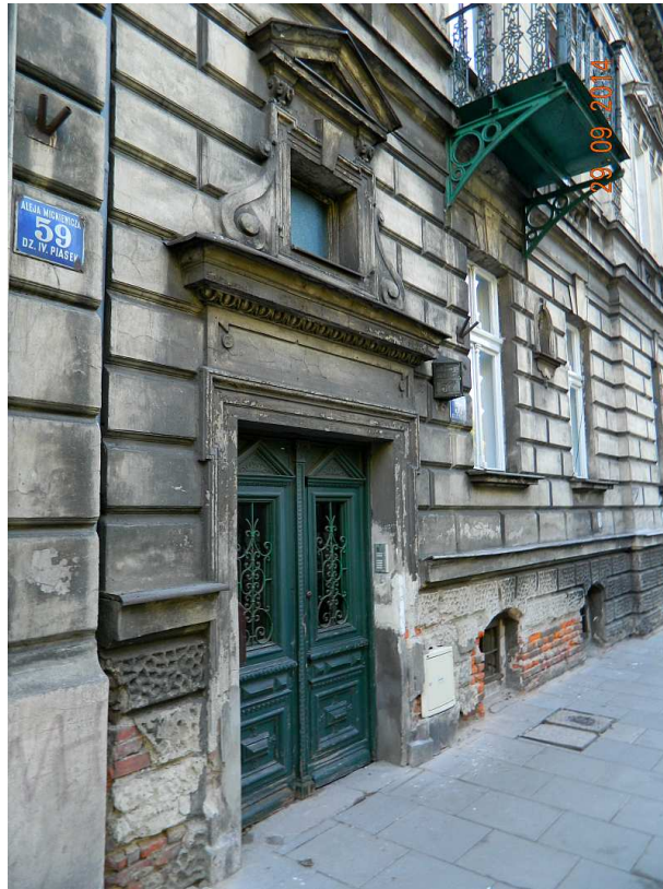
Fot. nr 52 (52-54). Detale parteru eklektycznej kamienicy z 1898-go roku z alei Mickiewicza 57
