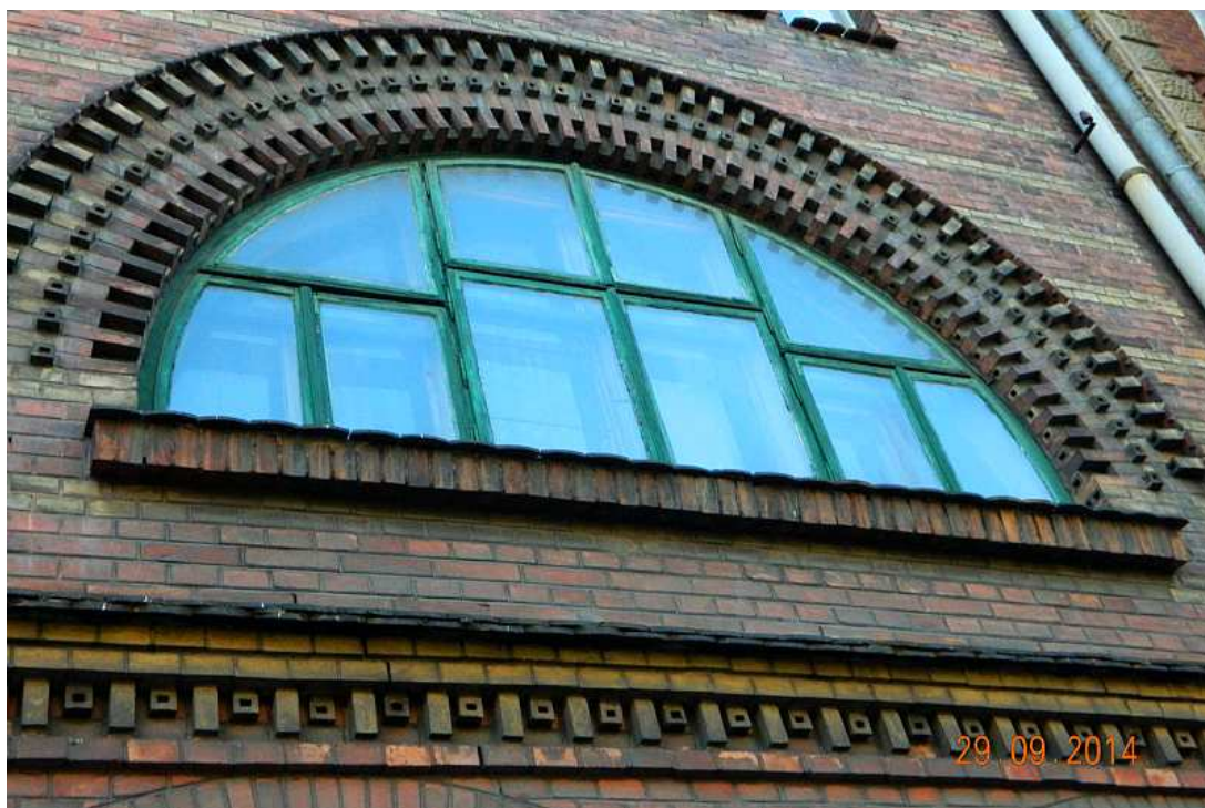
Fot. nr 63. Oryginalne okno I-go piętra.
