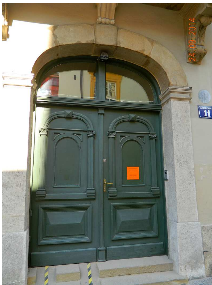
Fot. nr 26 (26-27). Drzwi kamienicy Szołayskich od strony ulicy Szczepańskiej 11.
