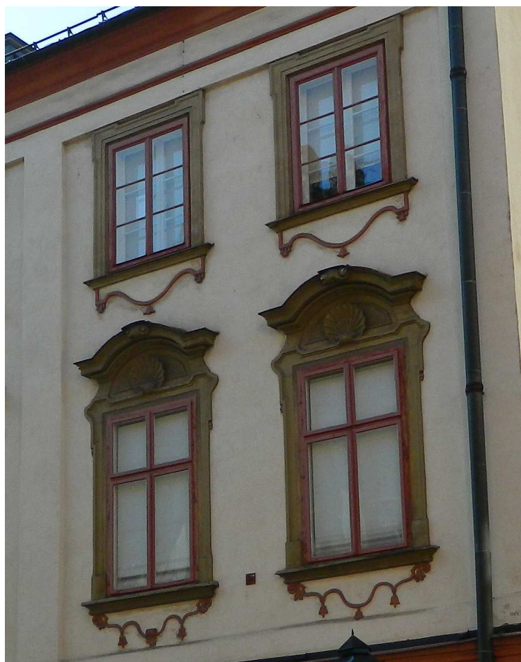
Fot. nr 18. Oryginalne okna fasady.
