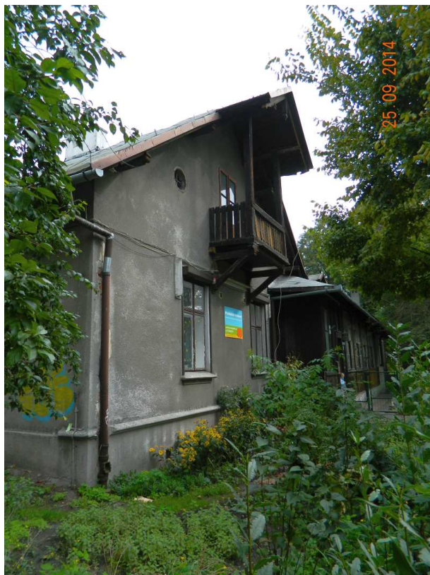
Fot. nr 97. Fasada od strony ulicy Grottgera. Więżba dachowa ciągle z elementami artystycznej ciesiołki.
