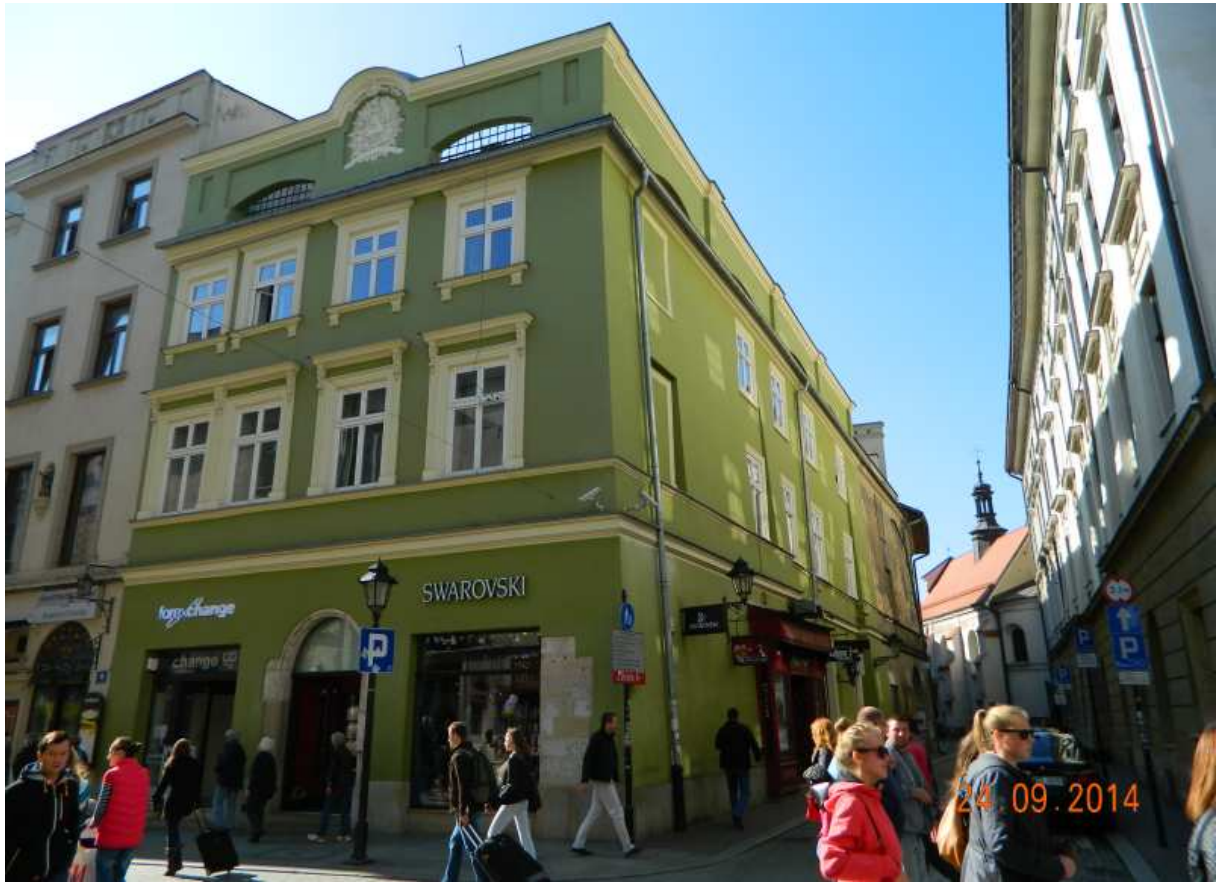
Fot. nr 5 (5-8). Kamienica Cyrusowska z ulicy Floriańskiej 12 i detale jej fasady.
