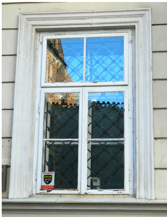
Fot. nr 21. Oryginalne okno parteru.
