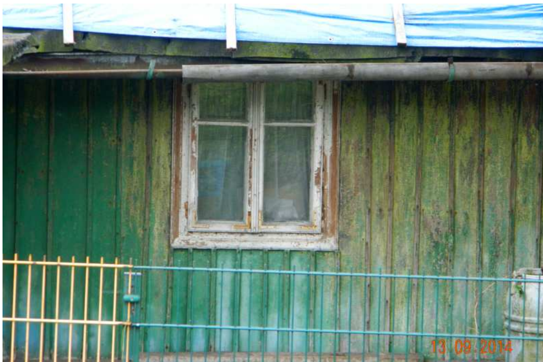
Fot. nr 117. Oryginalne okno.
