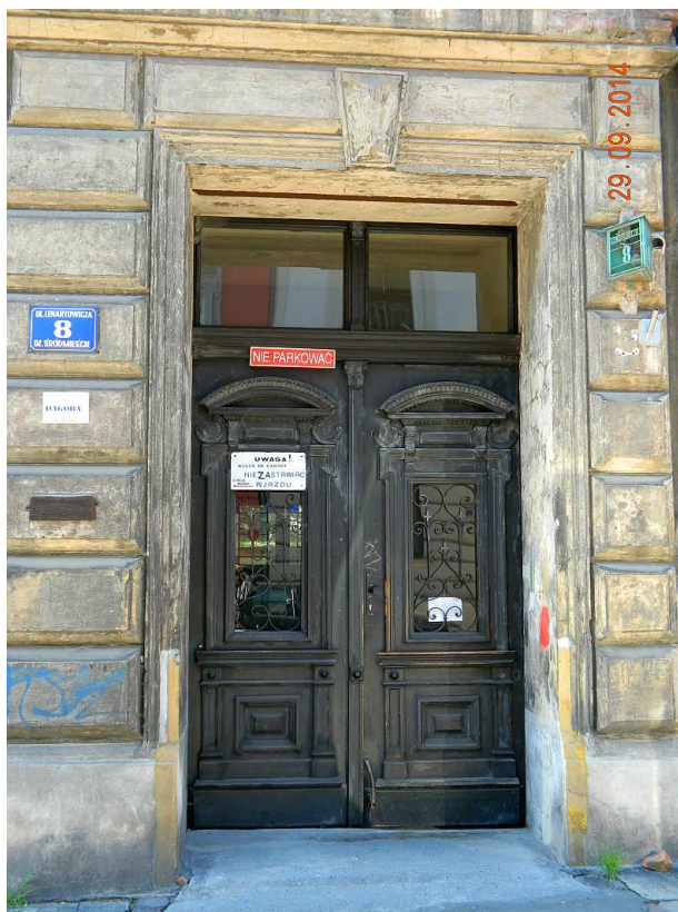
Fot. nr 67. Eklektyczne, bogato zdobione drzwi kamienicy z ulicy Lenartowicza 8, wybudowanej w końcu XIX-go wieku.
