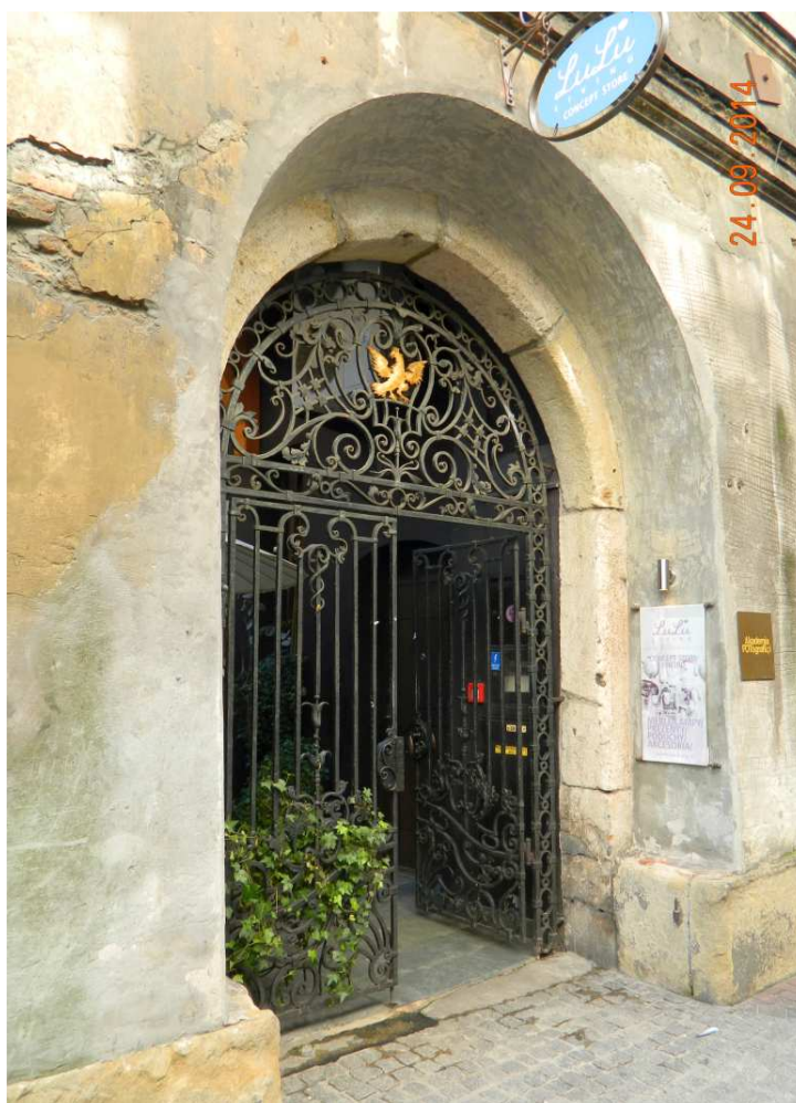
Fot. nr 12 (12-13). Metalowe drzwi wejściowe do kamienicy z ulicy św. Tomasza 17.
