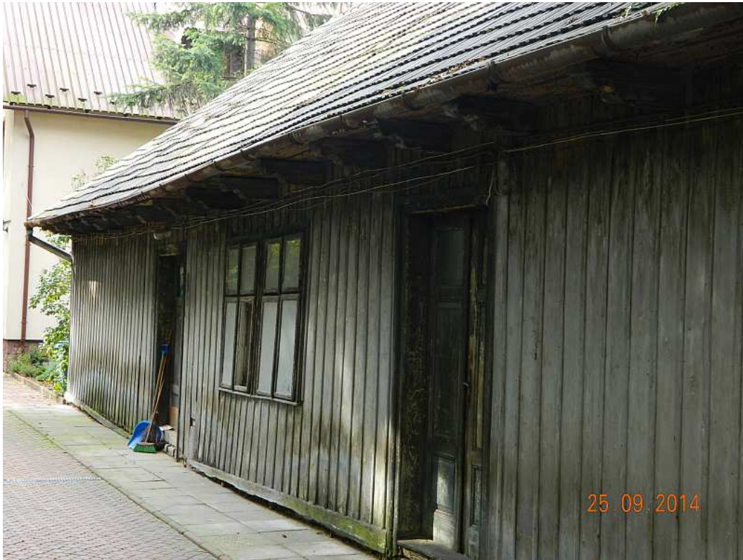
Fot. nr 104. Oryginalne okna od strony Podwórka.
