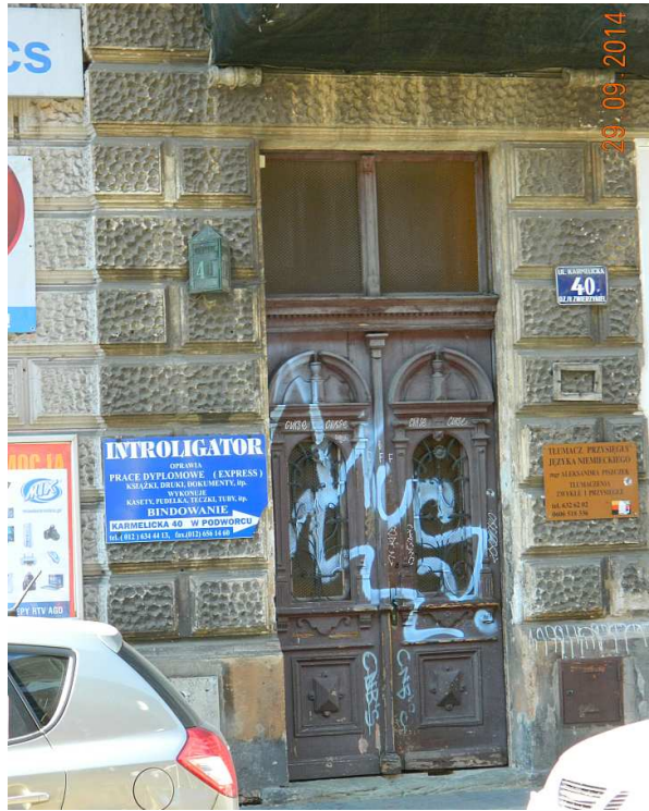
Fot. nr 72. Bogato zdobione drzwi wejściowe.
