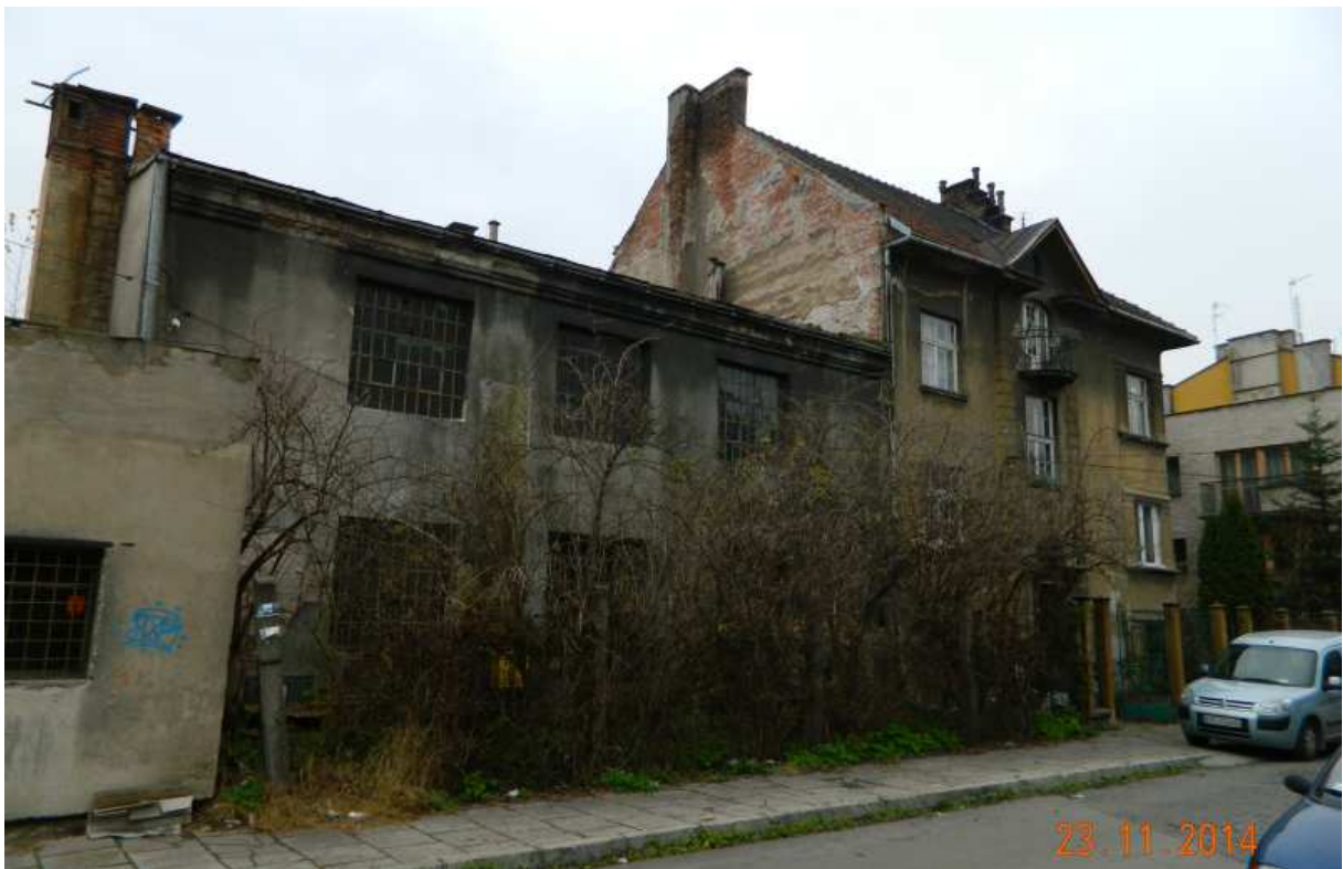
Fot. nr 139 (139-140). Międzywojenna zabudowa fragmentu ulicy Rolnej pod nr 11.
