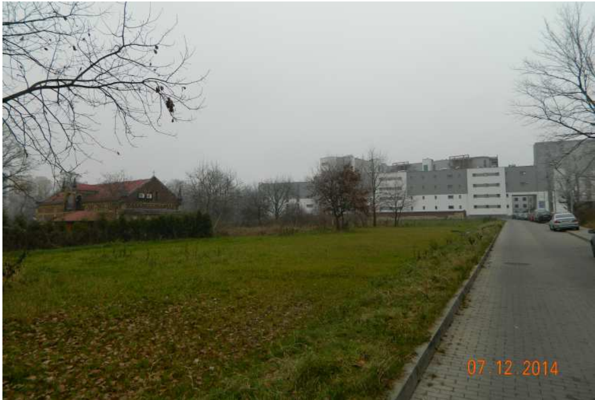
Fot. nr 250. Kompleks mieszkalny z ulicy Górników 50-66 – widok spod „rządówki”.
