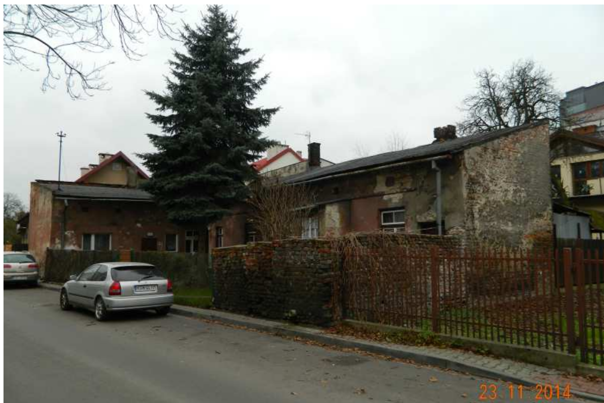
Fot. nr 153(153-155). Jeden z nielicznych już przykładów dawnej zabudowy Zakrzówka – domek z ulicy Dworskiej 11.
