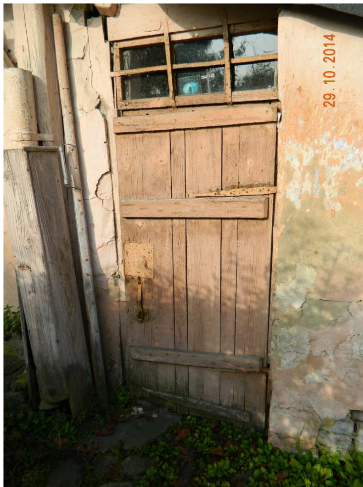
Fot. nr 192. Drzwi do komórki.
