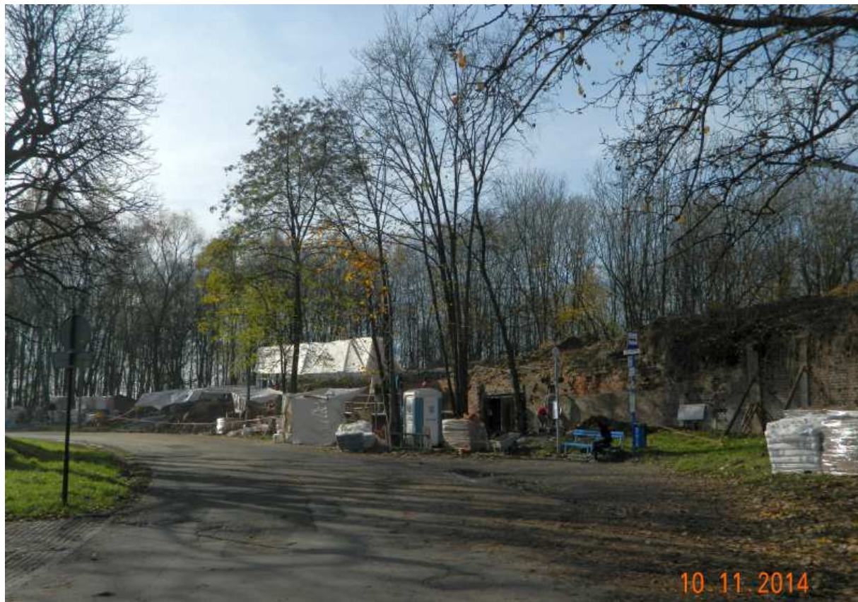
Fot. nr 17 (17-17g). Bastion nr II, obecnie w stanie ruiny. Trwają prace rewaloryzacyjne przy jego ścianie zewnętrznej i kurtynie I-II.
