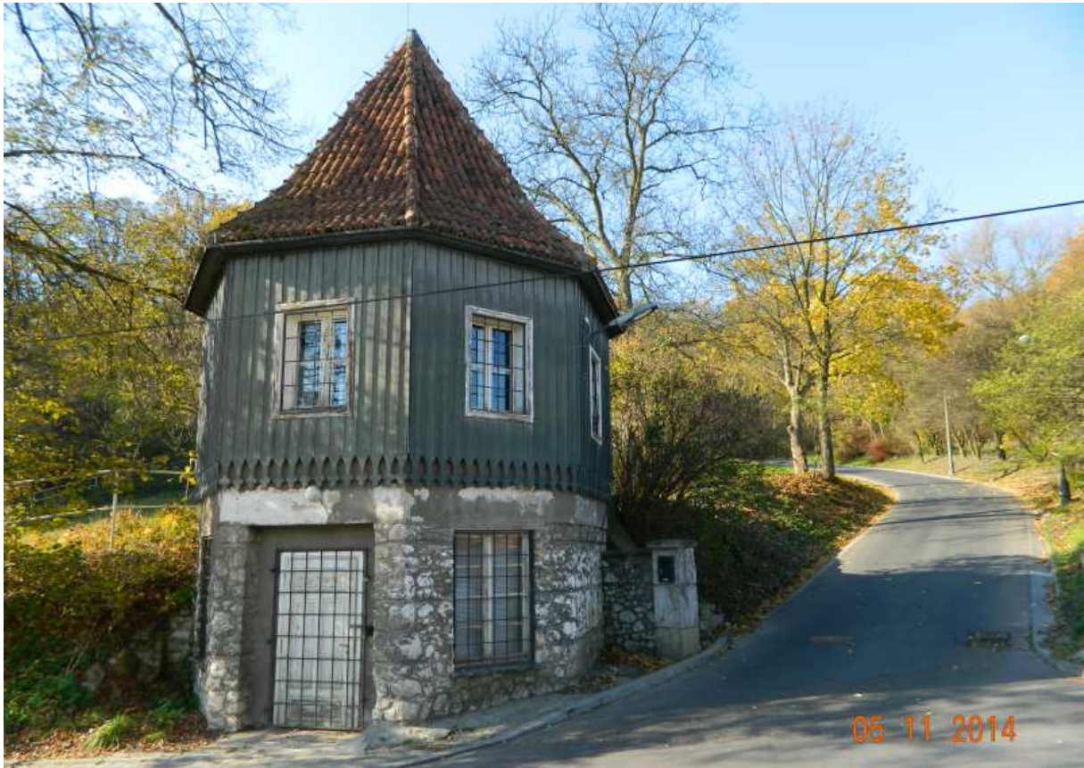
Fot. nr 112. Z bocznym fragmentem ulicy Jodłowej w tle.
