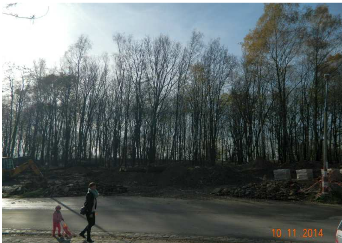
Fot. nr 18. Splantowany teren po bastionie nr I, który został poważnie uszkodzony pod koniec II wojny światowej. Aktualnie trwają prace rewaloryzacyjne przy kurtynie I-II, łączącej kiedyś oba te bastiony.
