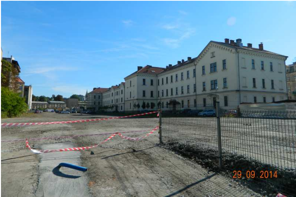
Fot. nr 8 (8-9). Widoki dziedzińca od strony ulicy Dolnych Młynów.
