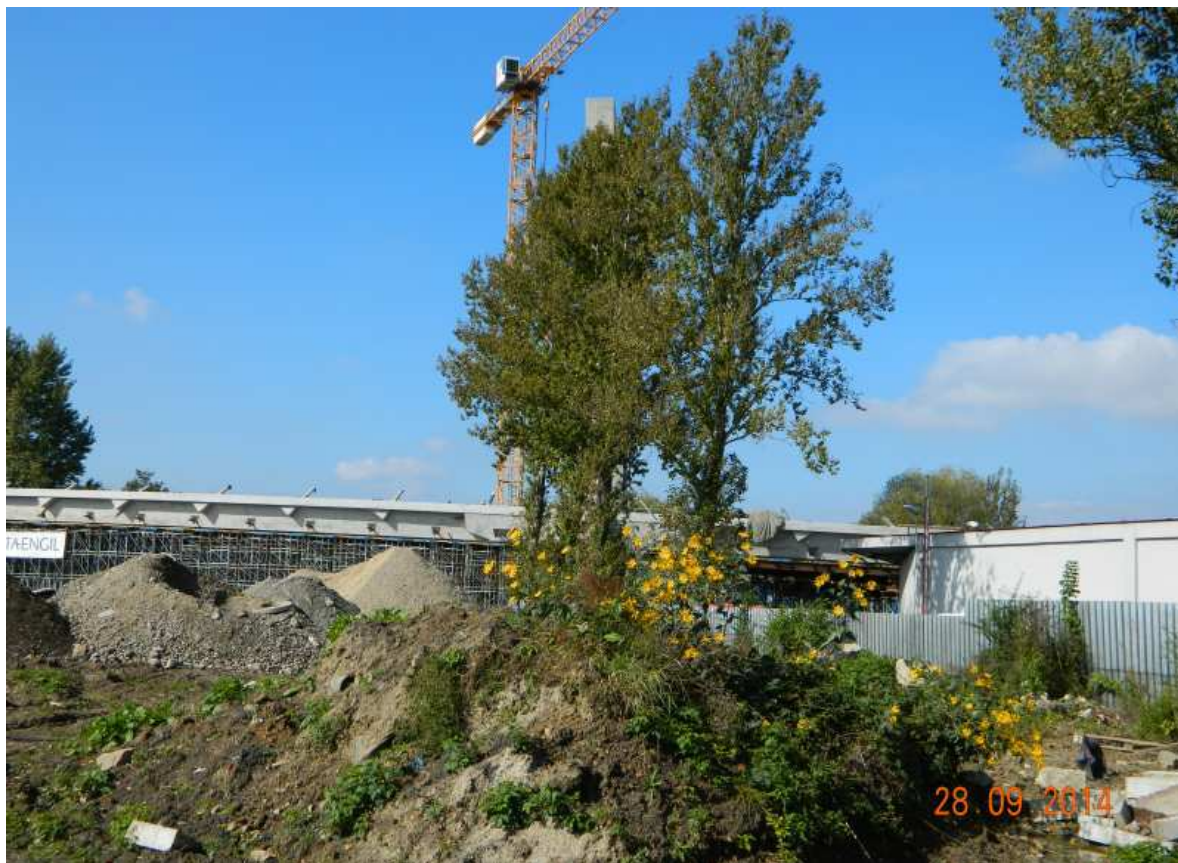
Fot. nr 230(230-233). Budowa nowej estakady drogowej w sąsiedztwie ulicy Żołnierskiej.
