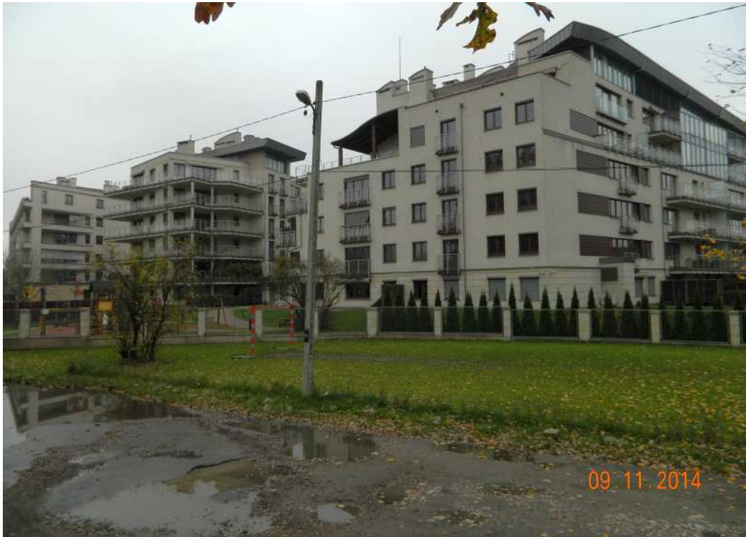
Fot. nr 226. Apartamentowce Ludwinów – ujęcie z ulicy Zatorskiej.
