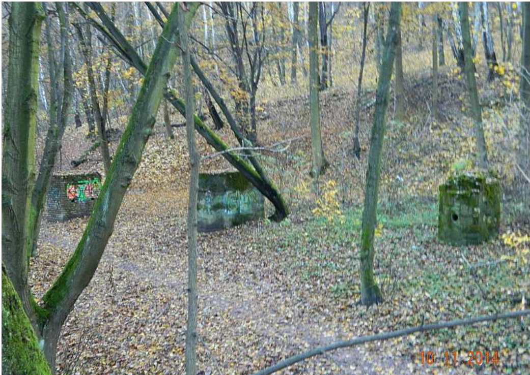
Fot. nr 34. Pozostałości po filarach mostu obok dawnego toru saneczkowego „Berlin”.
