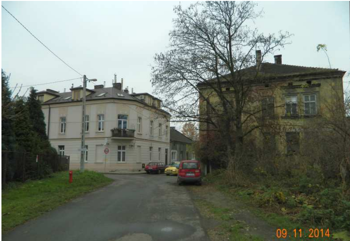
Fot. nr 218. Odnowiona kamieniczka z 1906-go roku z naroża ulic: Tureckiej 9 i Swoboda
