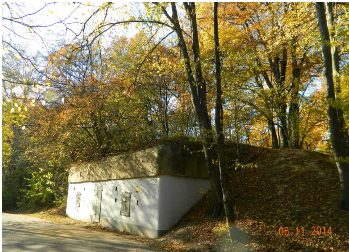
Fot. nr 135. Bunkier (schron amunicyjny), który stanowił element pobliskiej baterii Ostra Góra (FB 36), dziś zarośniętej.
