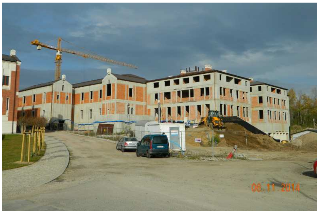
Fot. nr 307. Dobudowywany fragment zabudowań od strony wschodniej.
