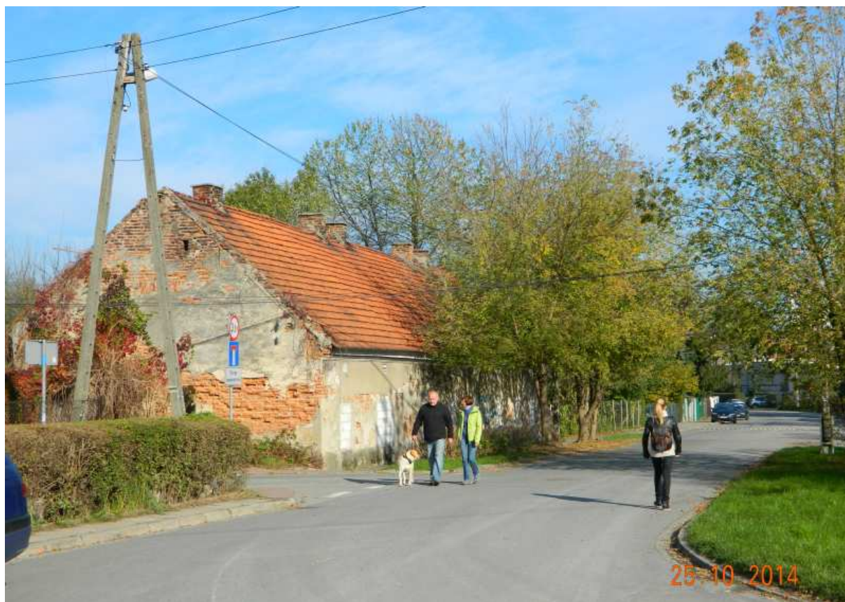
Fot. nr 162. Końcówka ulicy Twardowskiego i zrujnowany dom mieszkalny pod nr 117.
