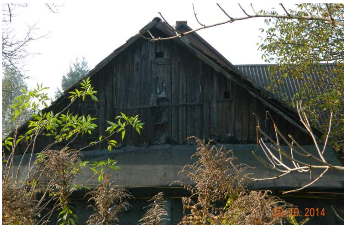
Fot. nr 181. Strych.
