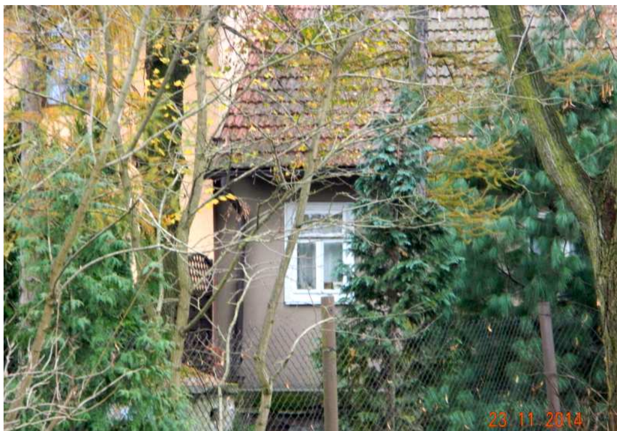
Fot. nr 143 (143-144). Oryginalne okno.
