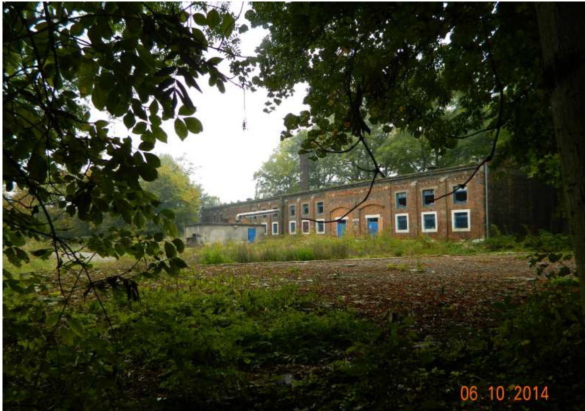
Fot. nr 240 (240-244). Dawny folwark Na Wrzosach, wybudowany pod koniec XIX-go wieku przez Erazma Jerzmanowskiego, ostatnio wykorzystywane przez firmę ANIMEX. Fot. nr: 240-242 to zabudowania wokół jego dziedzińca wewnętrznego.
