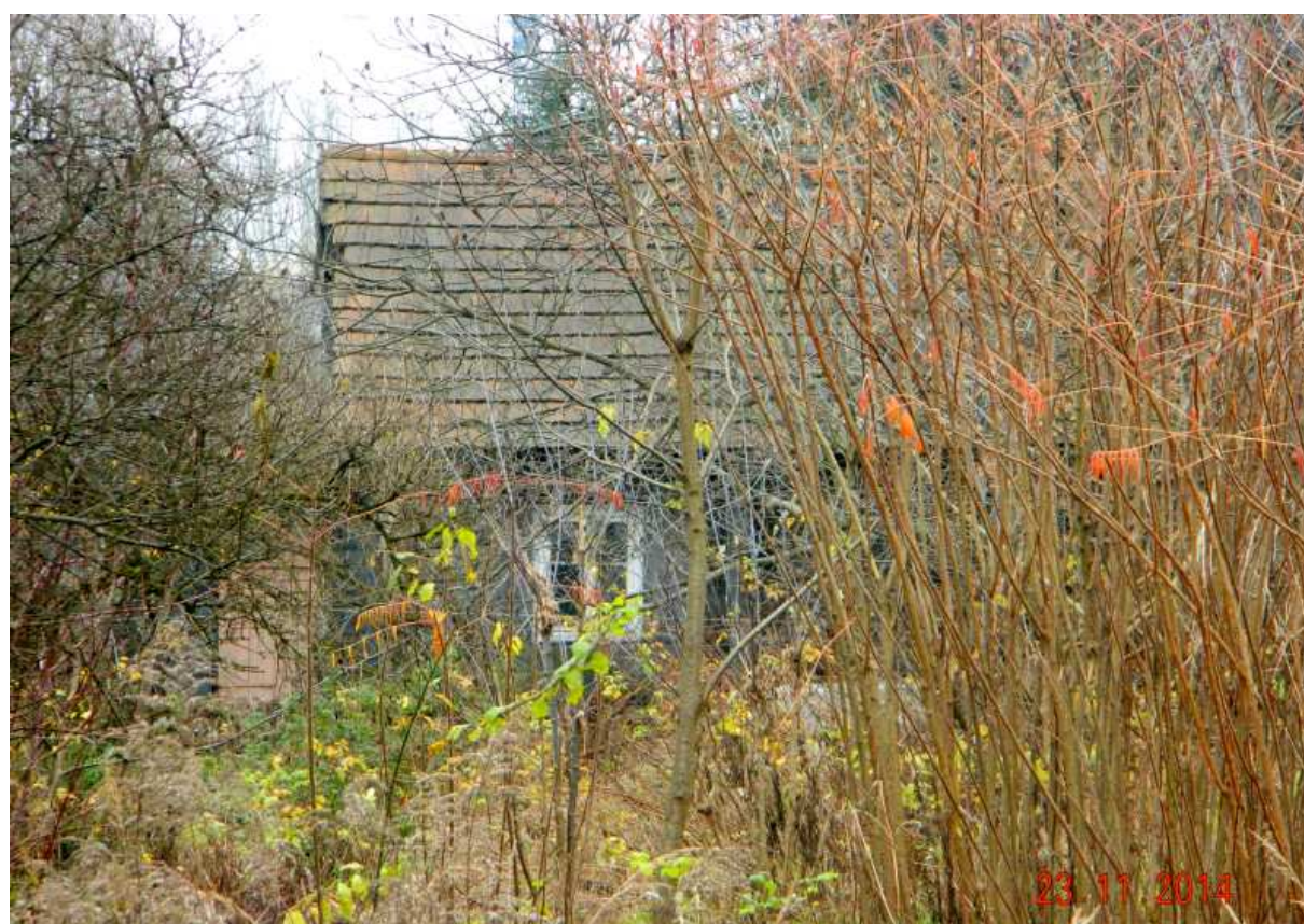
Fot. nr 183 (183-184). Widok w stronę podwórka z ulicy Rozdroże.
