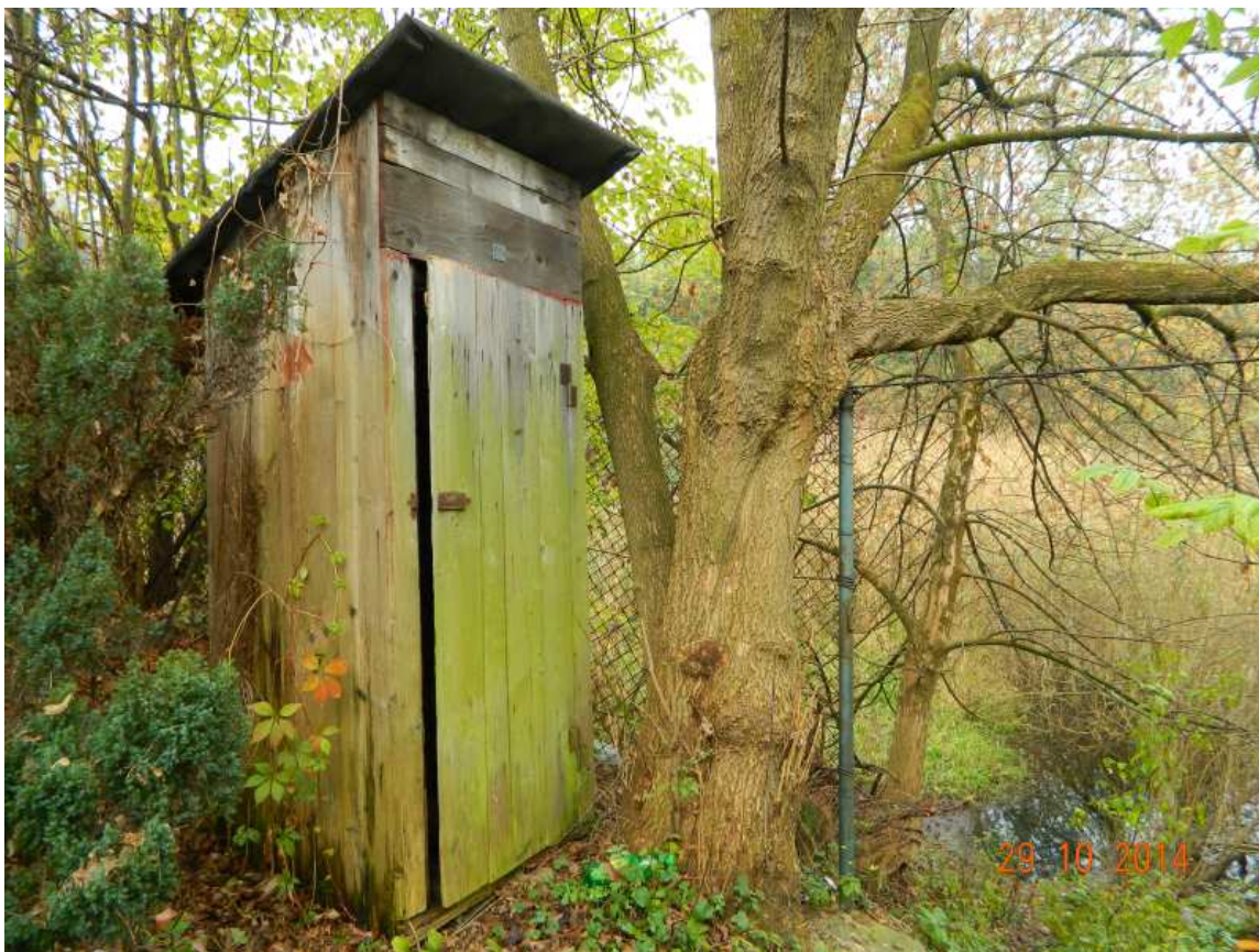
Fot. nr 196 (196-197). Wygódka na skraju rozlewiska od strony Wilgi.
