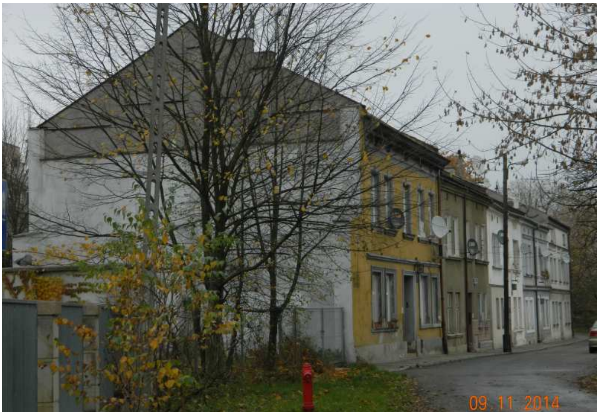
Fot. nr 223 (223-225). Ulica Zatorska (nr: 13-21). Budynek powoli zmieniają swoje szaty, ale dawny klimat ciągle jest tu wyczuwalny.
