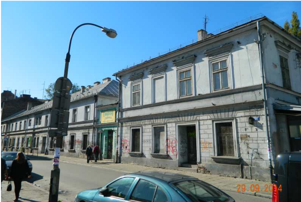
Fot. nr 10(10-11). Zabudowania dawnej Rządowej Fabryki Tytoniu i Cygar z ulicy Dolnych Młynów 8-10, uruchomionej w 1872 roku. Po II wojnie światowej działały Krakowskie Zakłady Tytoniowe. Na zdjęciu budynek socjalny od ulicy Dolnych Młynów.
