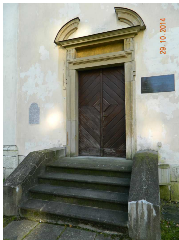
Fot. nr 177. Boczne wejście do nawy głównej.
