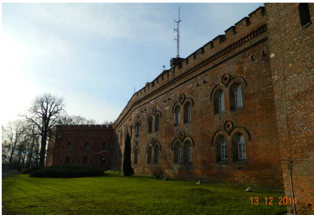
Fot. nr 12 (12-21d). Fort nr 2 Kościuszko. Tu koszary i bastion nr V.
