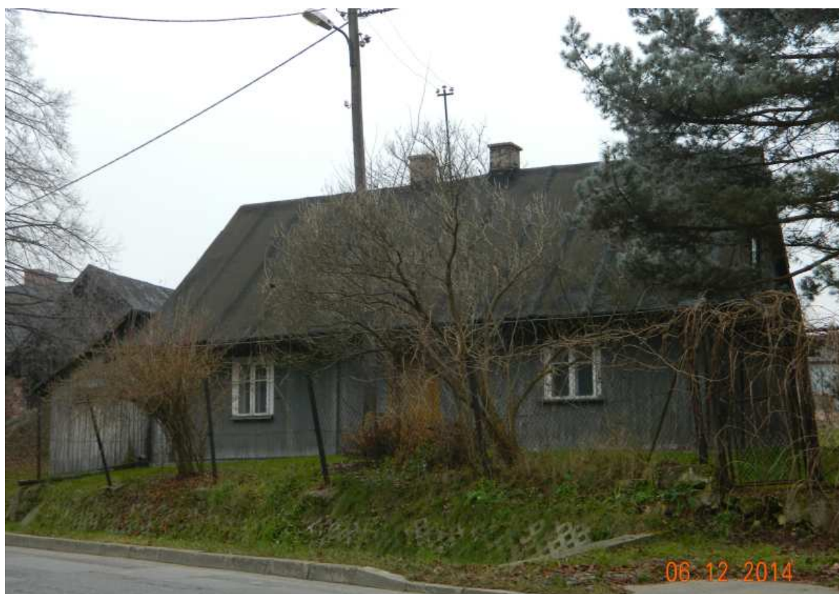
Fot. nr 292 (292-296). Piękna chałupa z ulicy Cechowej 12.
