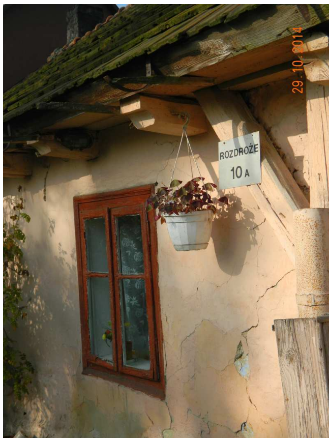
Fot. nr 191. Oryginalne okno.
