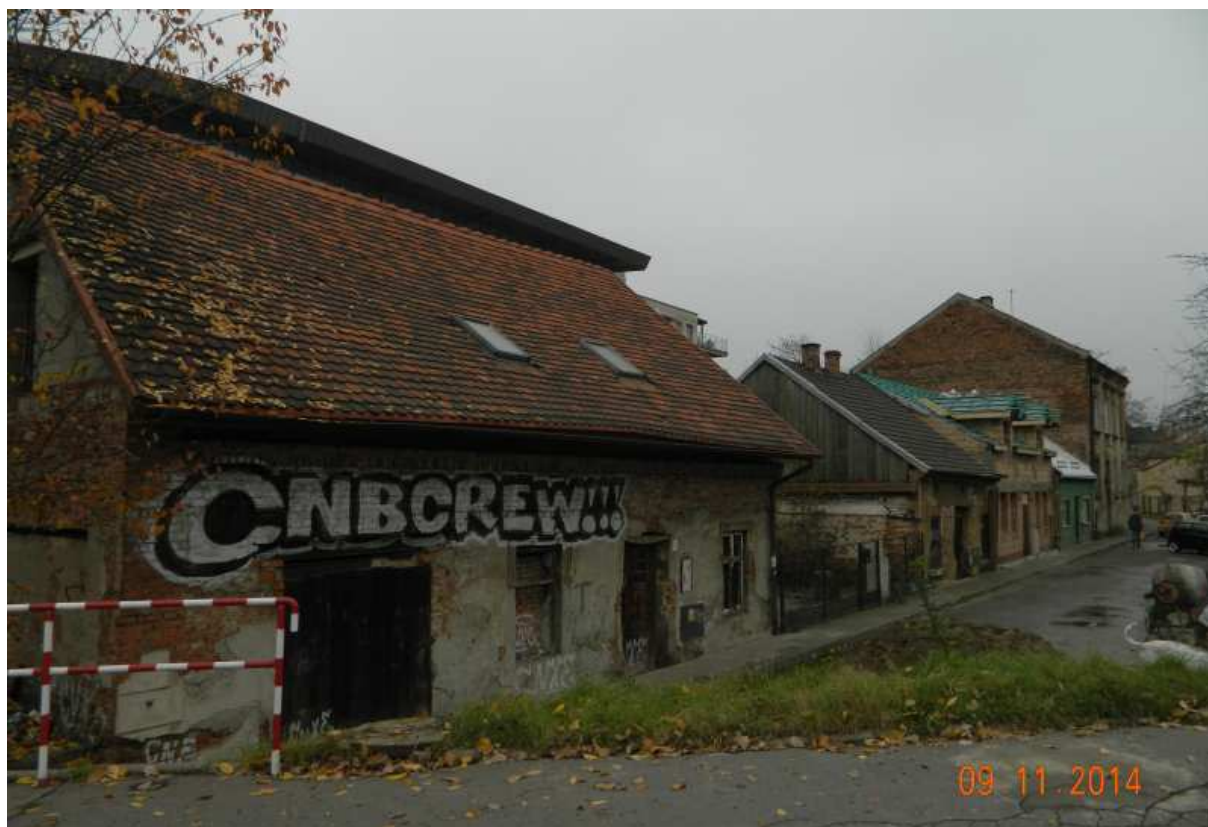
Fot. nr 214 (214-222). Dawny świat starego Ludwinowa przyłoczony współczesną zabudową. Ulica Turecka (nr: 6-16), serce dawnego Ludwinowa. Fot. nr: 214-216 to początkowy fragment ulicy.
