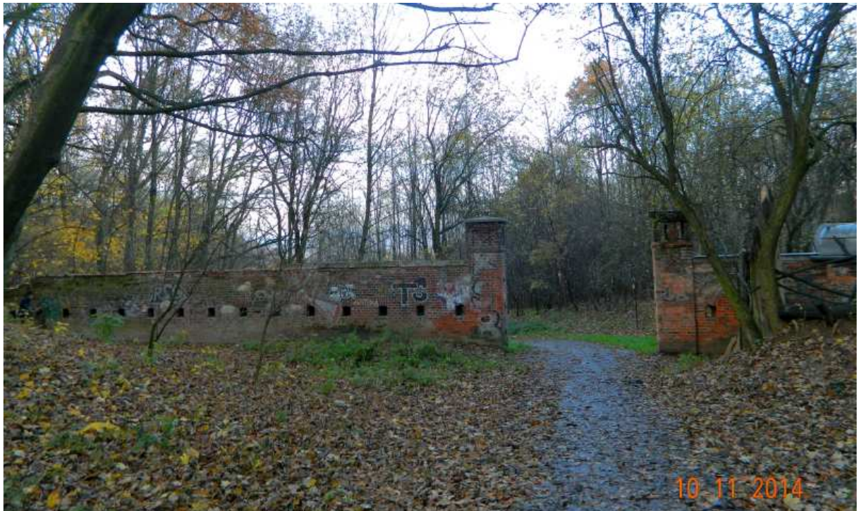
Fot. nr 39 (39-39b). Pozostałości po zespole bramy 3a fortu Kościuszko na końcu ulicy Hofmana (Spadzistej), zlokalizowanej przy szańcu ziemnym FS 3 (z lat 1854-55).
