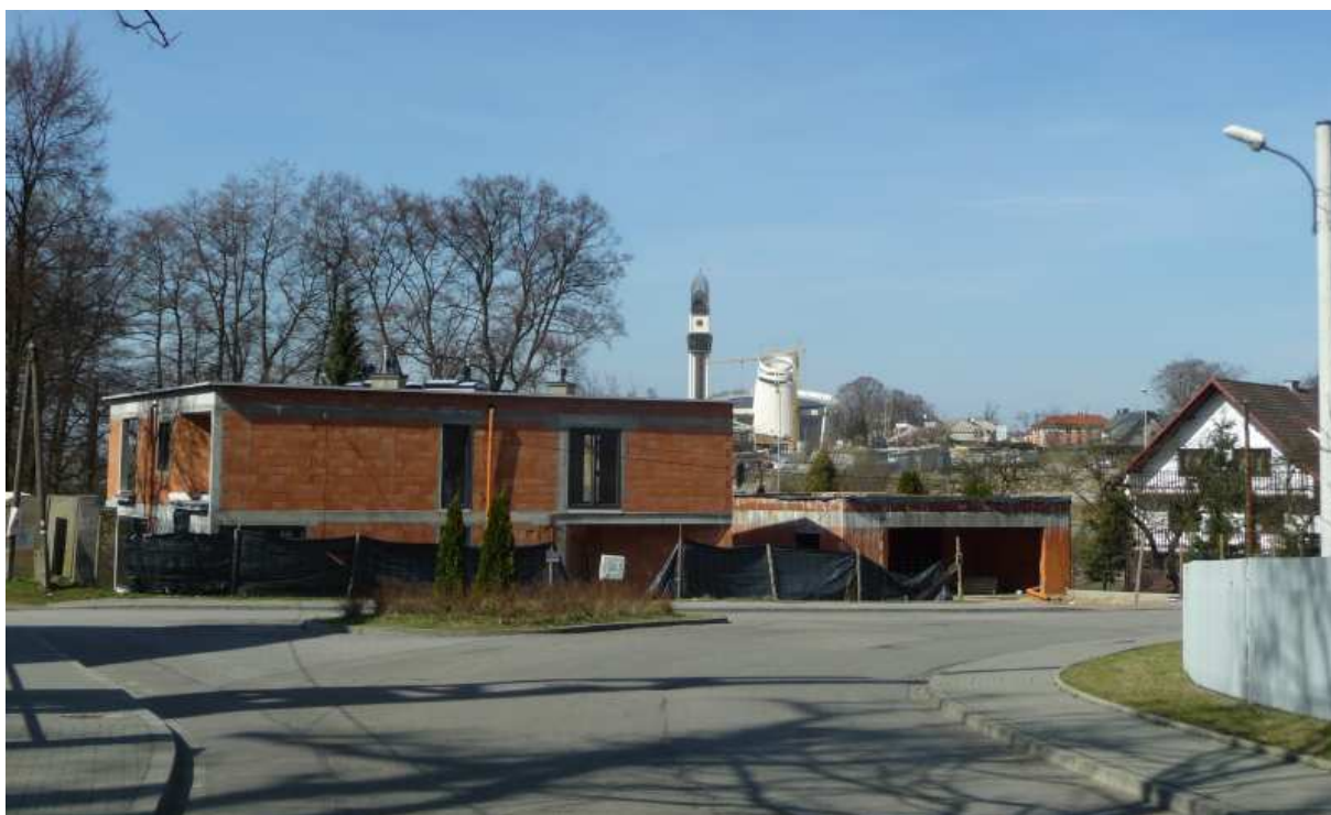
Fot. nr 165 (165-166). Nowozabudowana posesja przy ulicy Millana 11. W tle Sanktuarium BM. (20.03.14)
