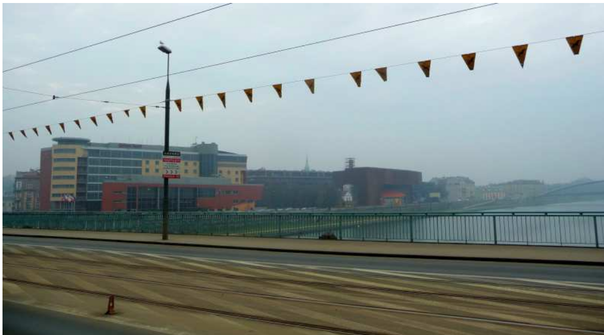
Fot. nr 26. Przymglona panoram Podgórza we fragmencie pomiędzy III i IV mostem. Pośrodku przebudowywany obiekt dawnej elektrowni podgórskiej. (27.02.14)
