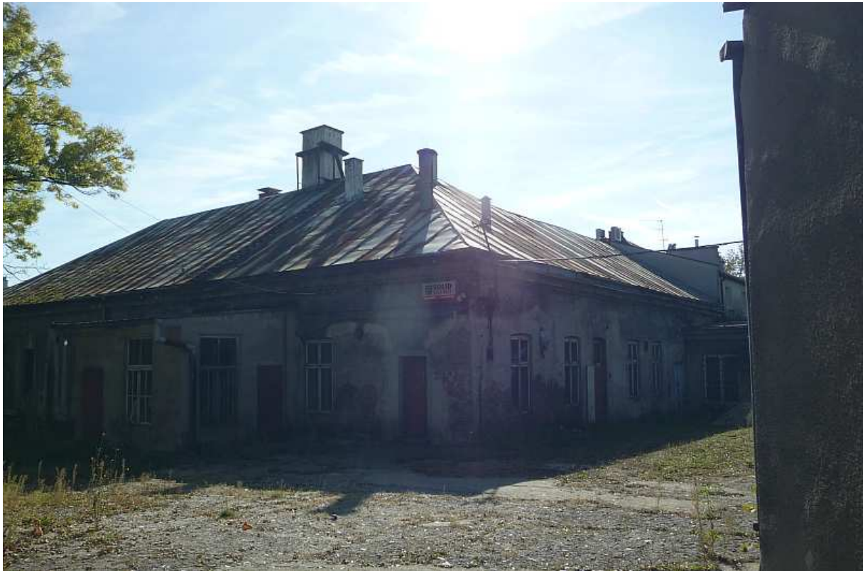
Fot. nr 98. Opuszczony budynek fabryczny z ulicy Dembowskiego 1, który niebawem zniknie. (05.10.13)
