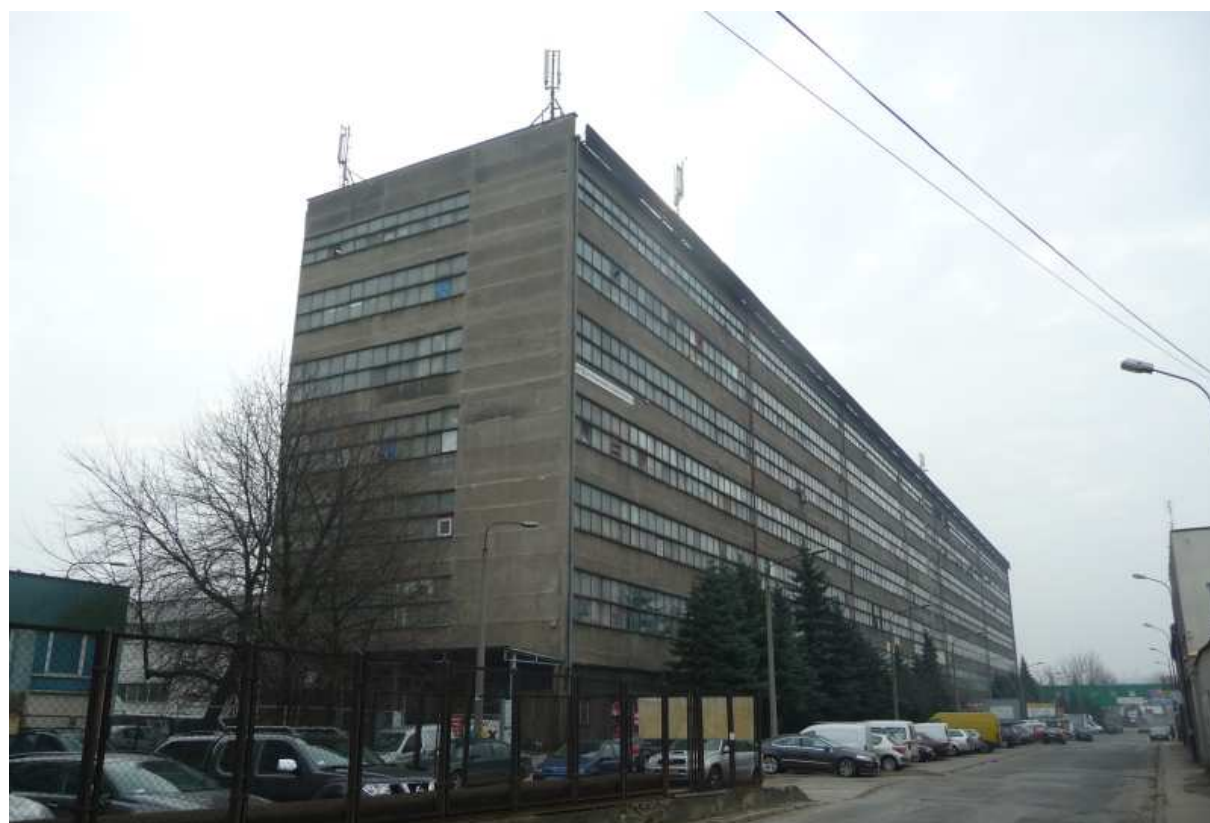
Fot. nr 54. Dawny budynek TELPOD-u. (27.02.14)
