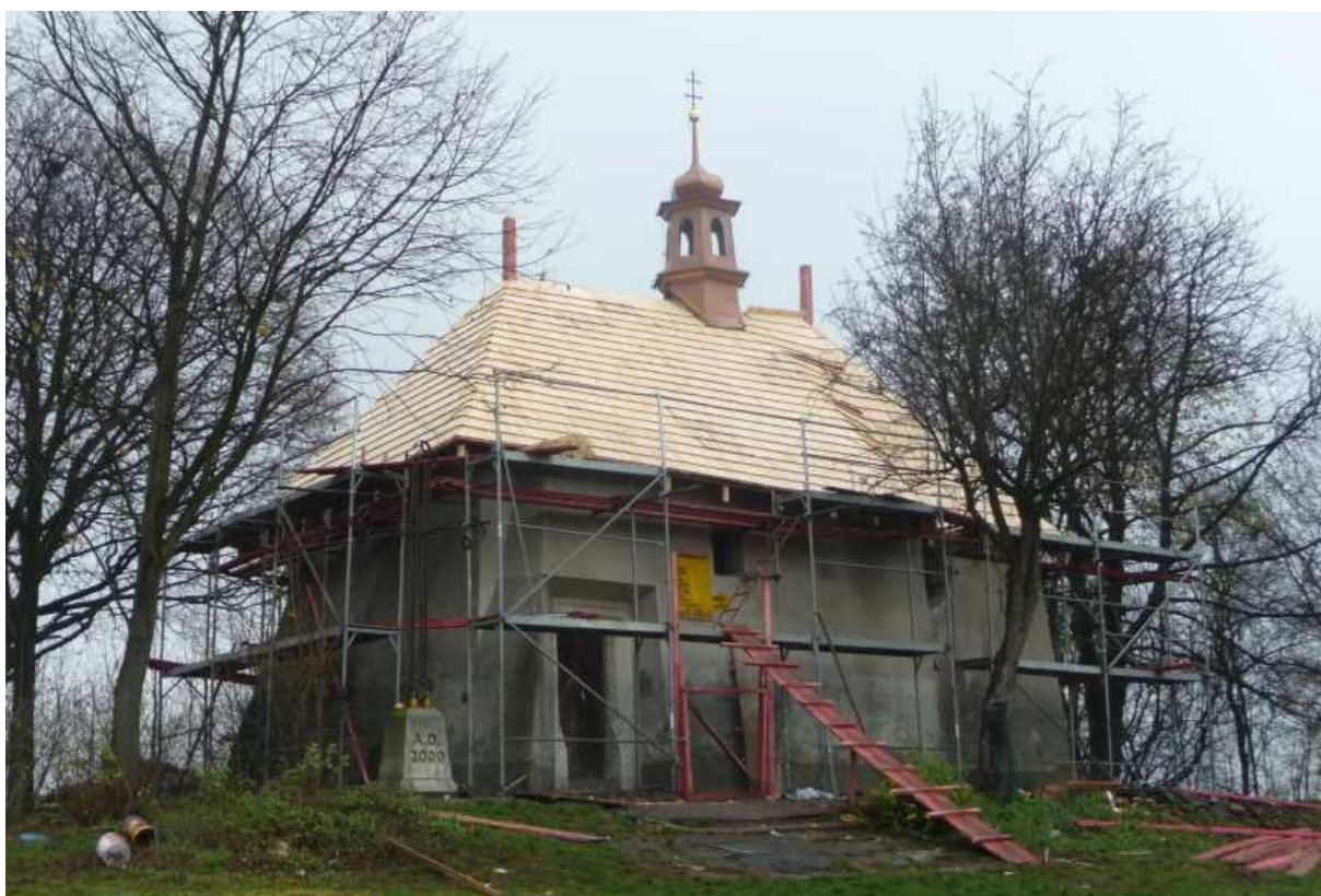
Fot. nr 97. Odnowa kościółka św. Benedykta, połączona z wymianą dachu. (23.11.13)
