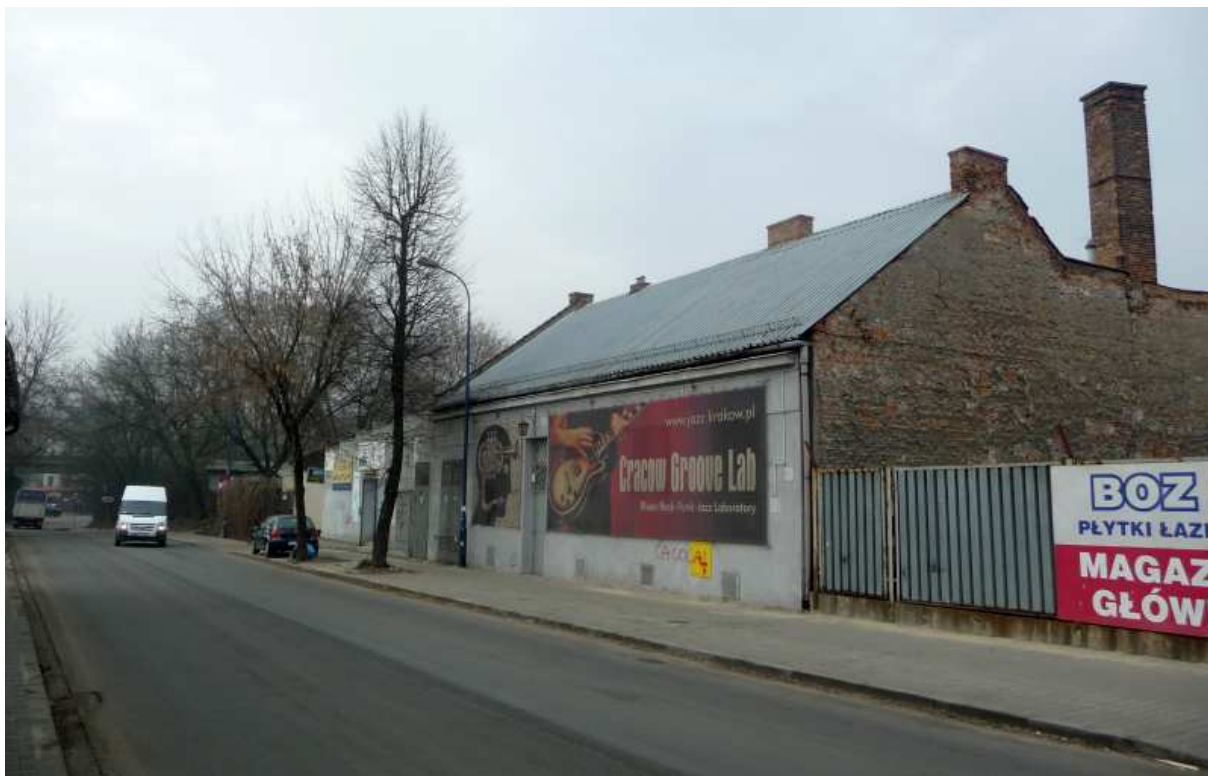
Fot. nr 67. Dawna zabudowa Zabłocia - budynki pod nr: 19-23. (27.02.14)
