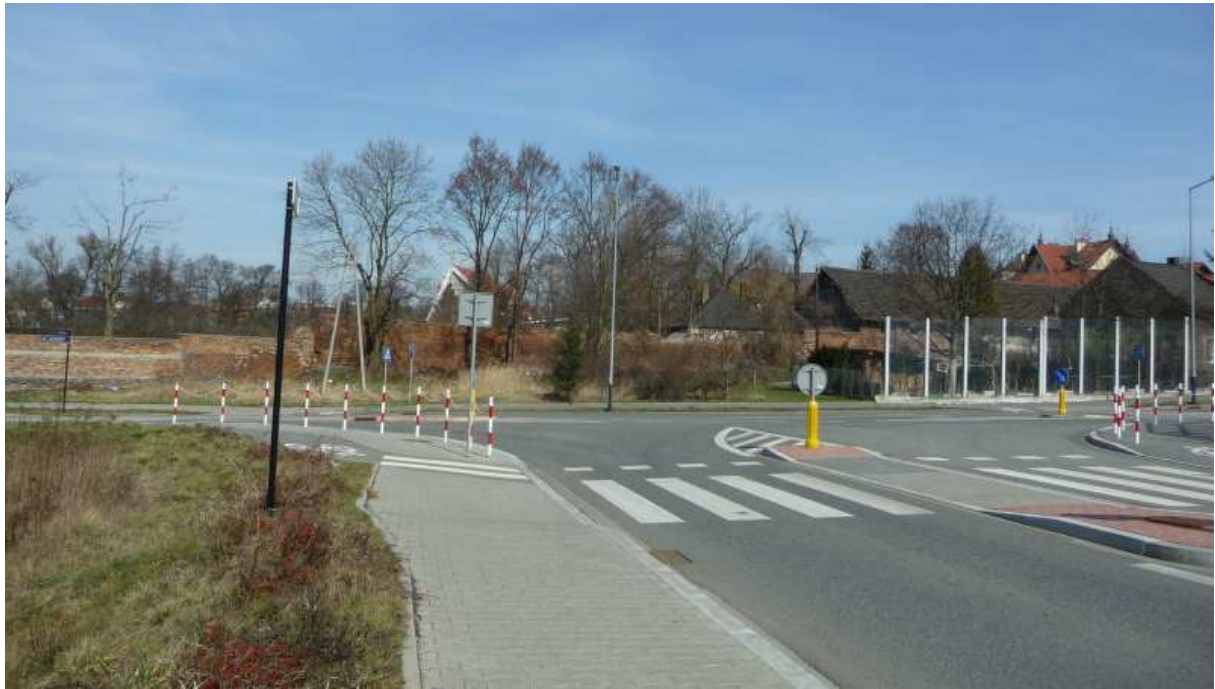
Fot. nr 158 (158-159). Tereny należące do Zakonu Sióstr Felicjanek, położone za murem biegnącym wzdłuż ulicy Do Sanktuarium BM – widok z ulicy Totus Tuus. (20.03.14)
