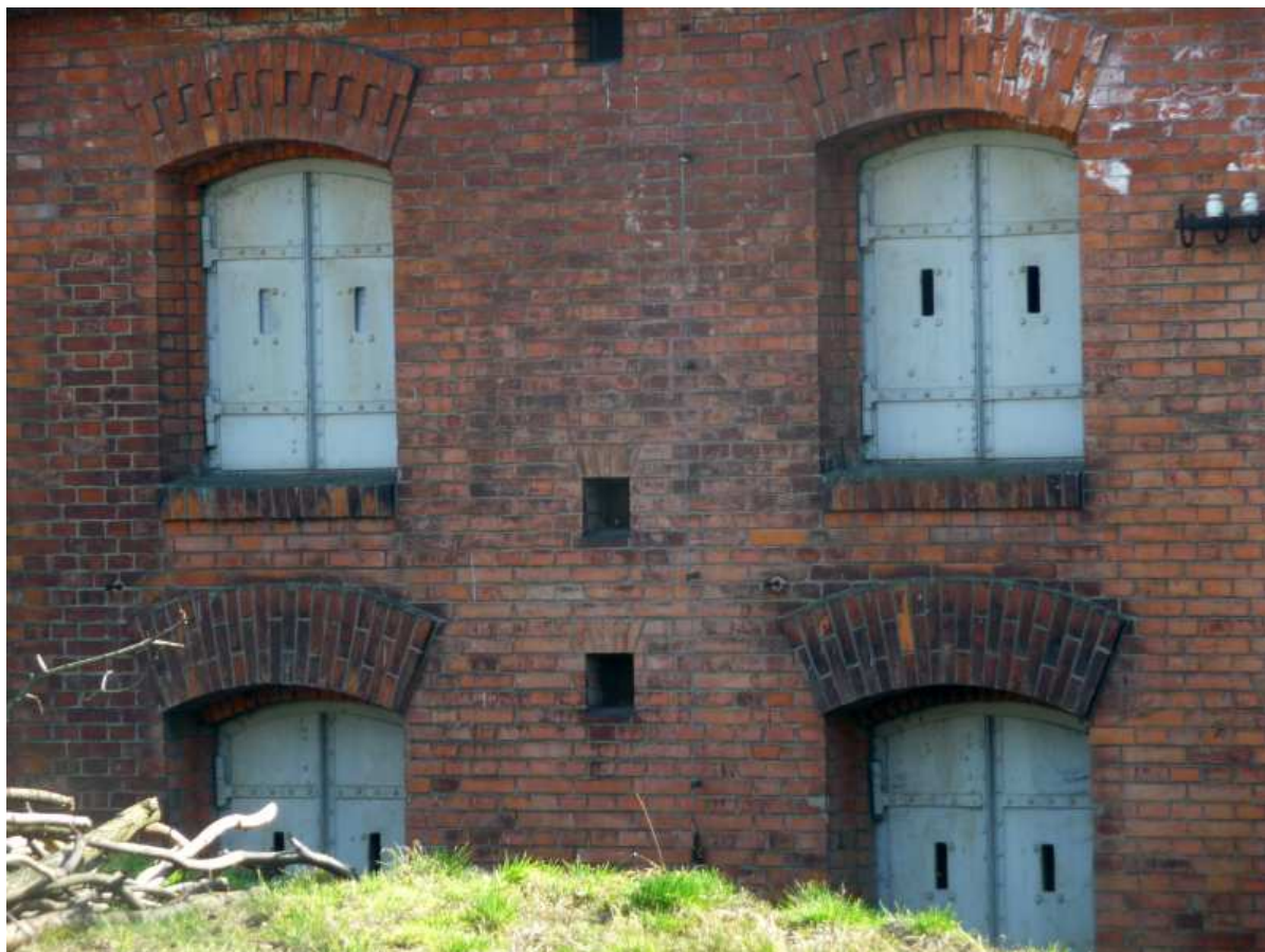
Fot. nr 132. Żelazne osłony okien. (11.03.14)
