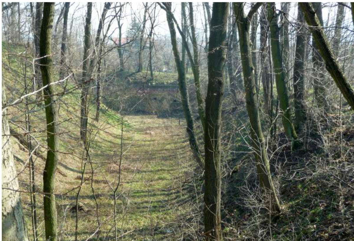
Fot. nr 133. Fosa od strony ulic: Niebieskiej i Żelazowskiego. (11.03.14)
