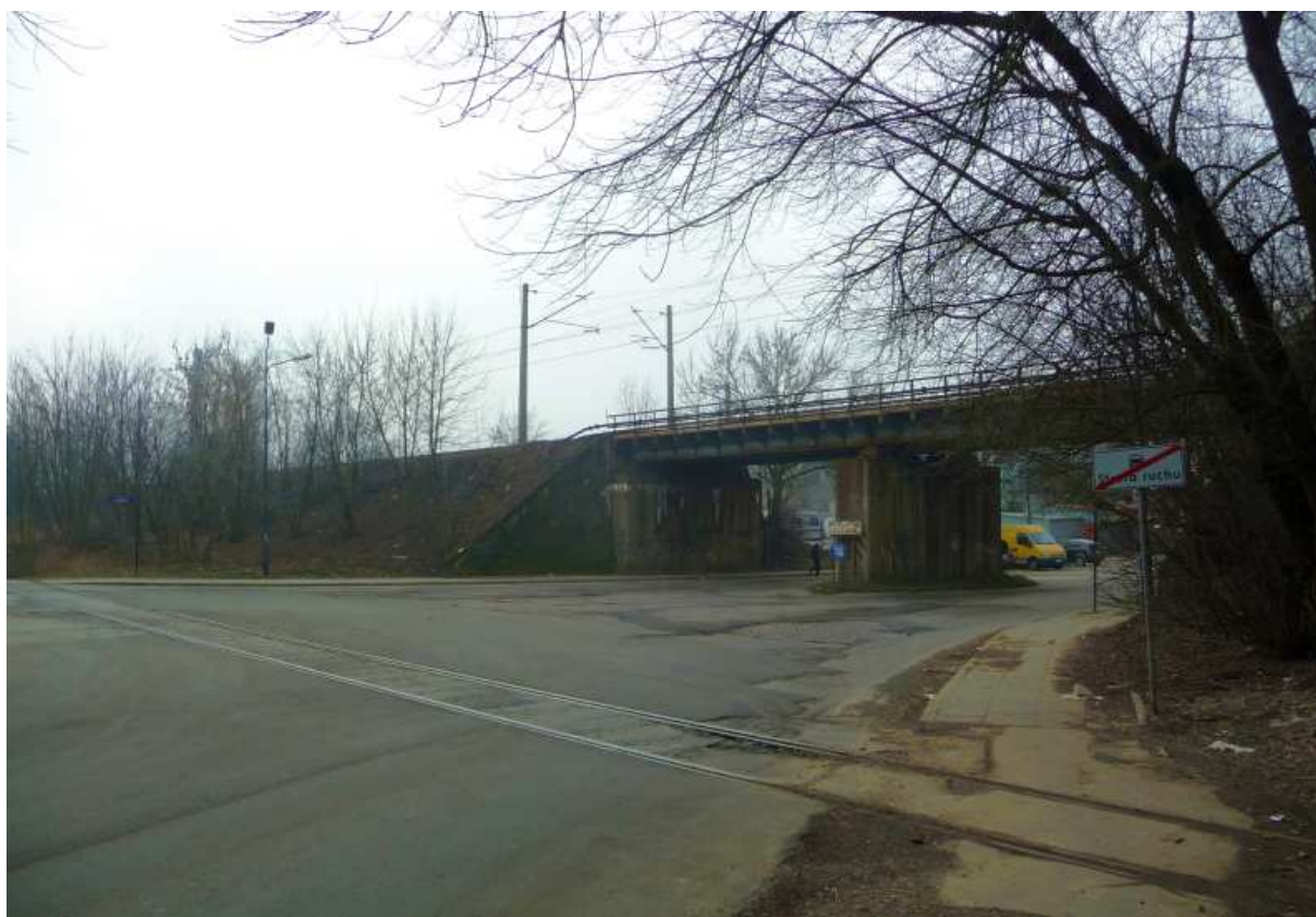
Fot. nr 68. Wiadukt na styku ulic: Romanowicza, Dekerta i Dąbrowskiego. (27.02.14)
