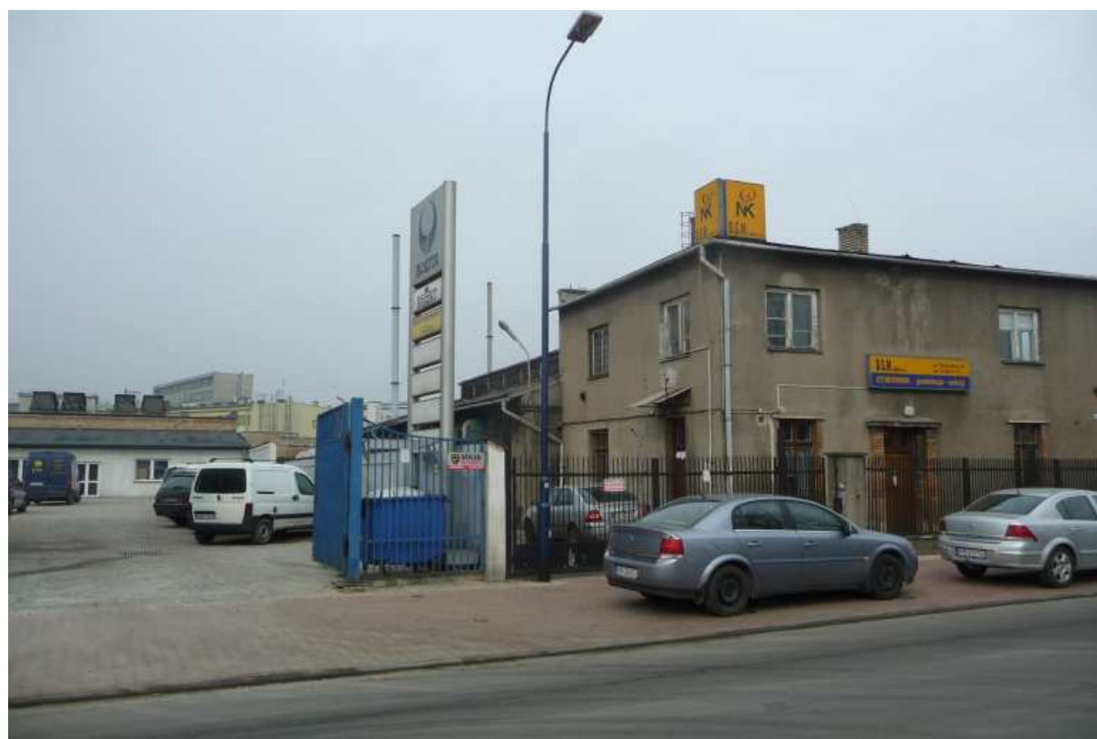
Fot. nr 66. Budynki pod nr 15. (27.02.14)
