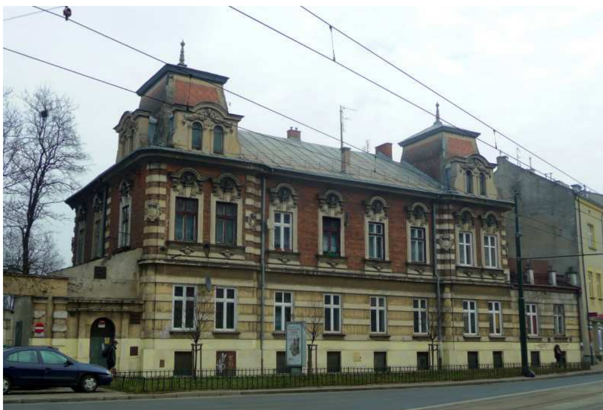
Fot. nr 78. Fasada od strony ulicy Limanowskiego. (27.02.14)
