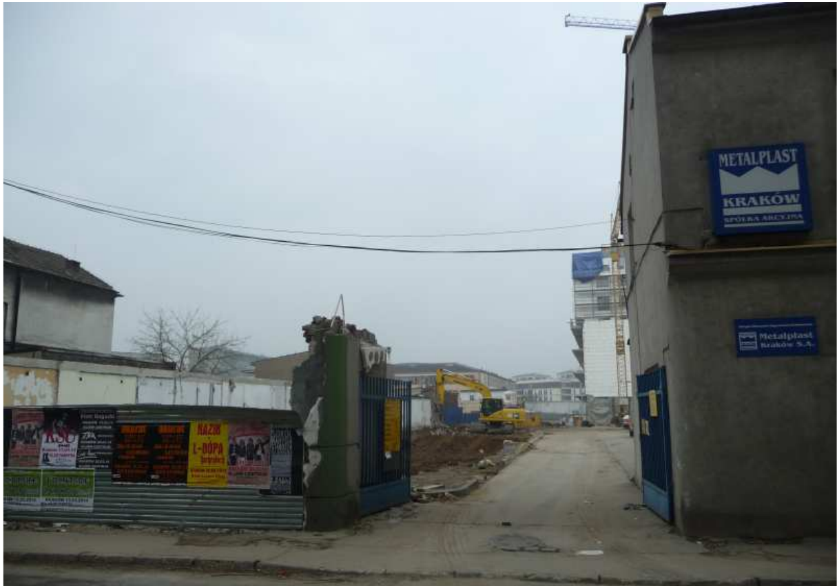
Fot. nr 56 (56-57). Budynek pod nr 7. (27.02.14)
