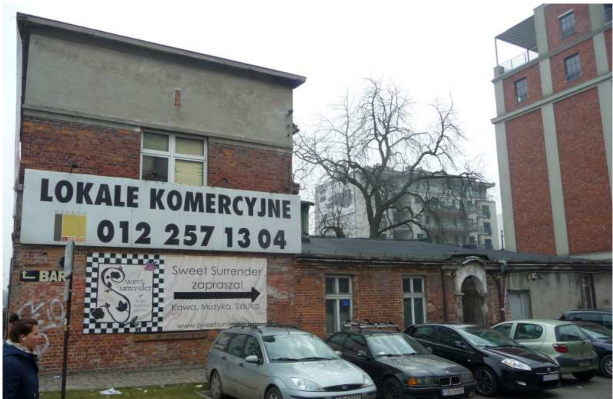
Fot. nr 43 (43-44). Resztki dawnej zabudowy Zabłocia. (27.02.14)
