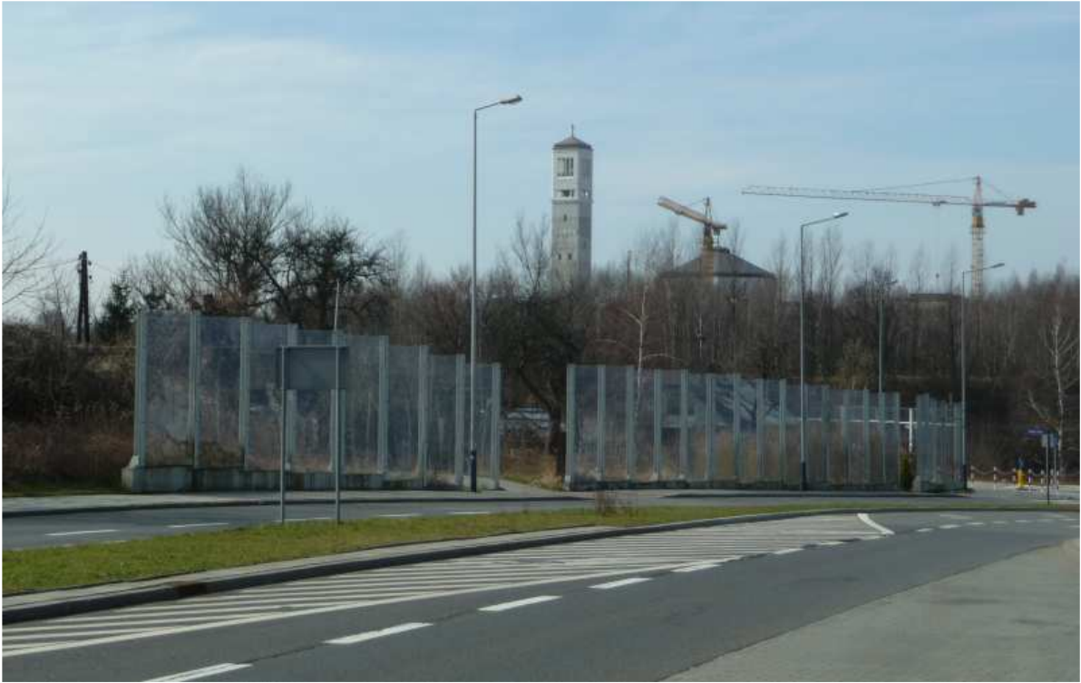
Fot. nr 156. Centrum Jana Pawła II w końcowym etapie budowy. Widok z ulicy Do Sanktuarium BM. (20.03.14)
