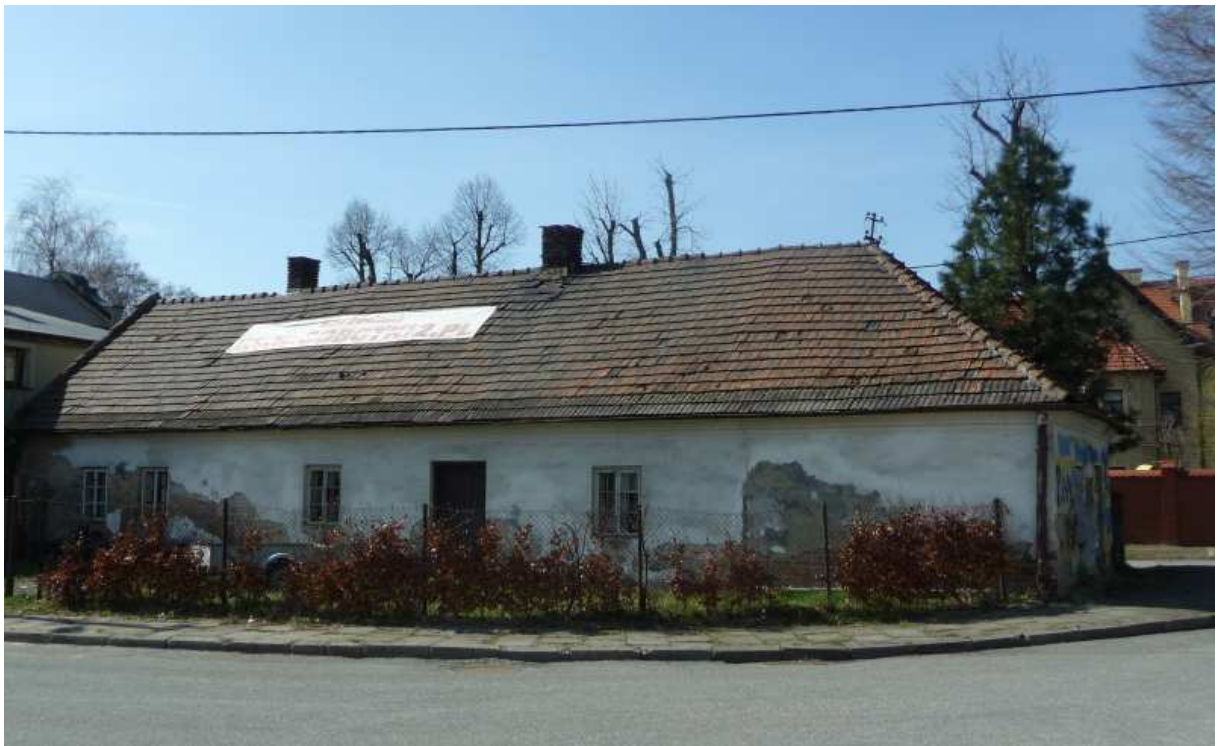
Fot. nr 171. Widok od strony ulicy Turowicza. (20.03.14)
