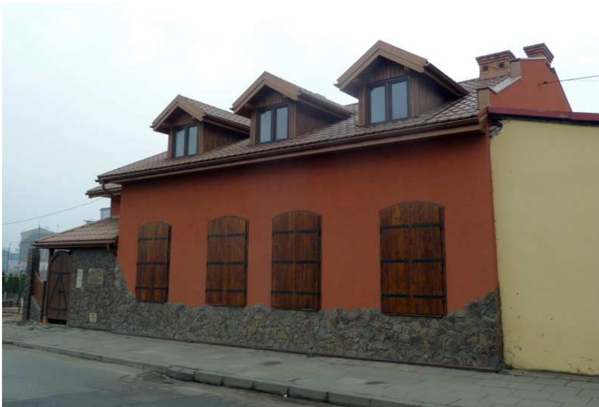
Fot. nr 32 (32-33). Świeżo odrestaurowany budynek dawnej rzeźalni miejskiej z ulicy Zabłocie 11. (27.02.14)
