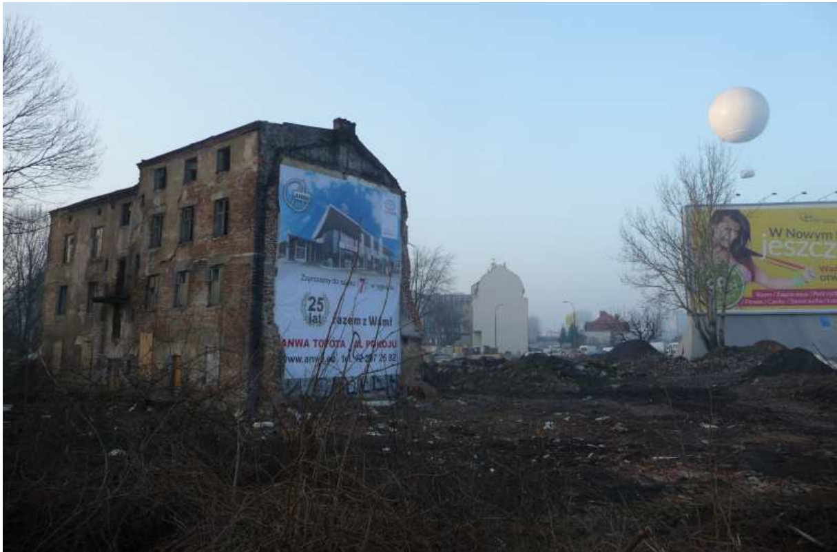
Fot. nr 195 (195-197). Ostatnie prace rozbiórkowe. (13.02.14)
