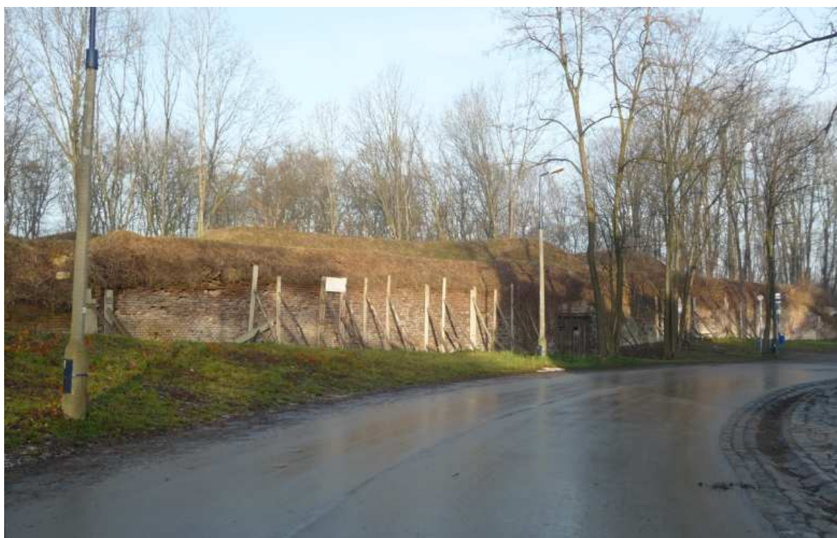
Fot. nr 113 (113-114). Ruina bastionu nr II – widok od strony Kopca. (04.01.14)
