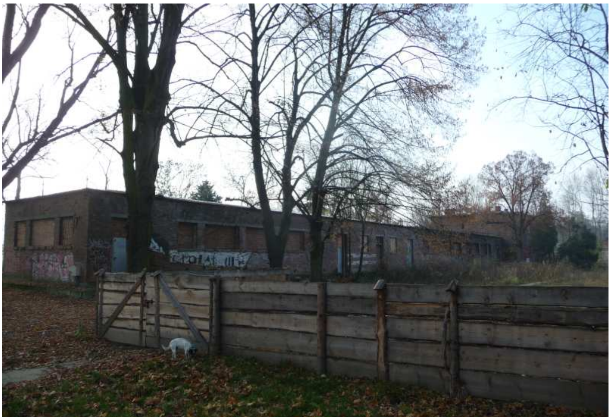
Fot. nr 159 (159-160). Budynek szatni i przebieralni – widok od strony basenu. (17.11.13)
