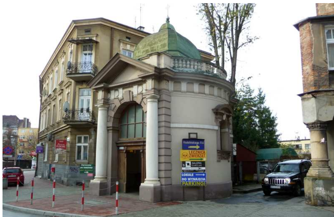
Fot. nr 188 (188-189). Kaplica p.w. św. Piotra i Pawła przy ulicy Madalińskiego. (10.11.13)
