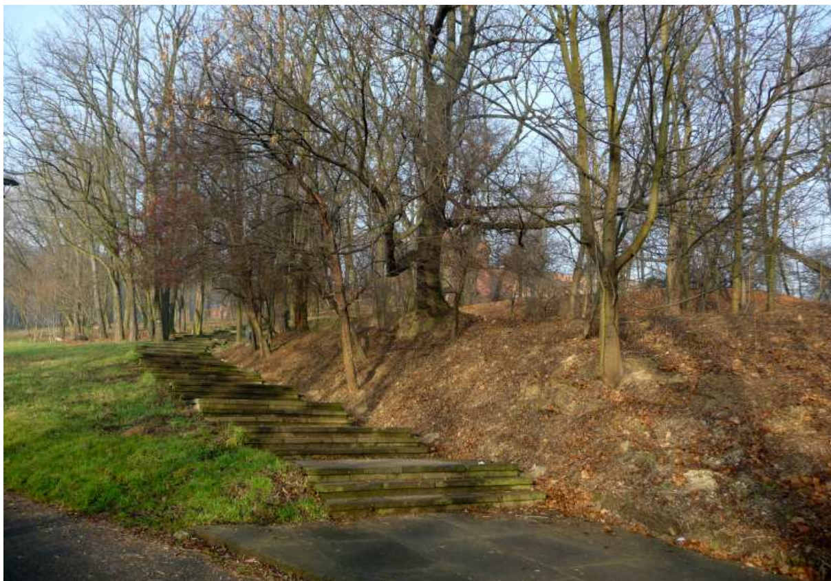
Fot. nr 99 (99-101). Prawie półwieczne już schody, które wiodą z Alei Waszyngtona pod bastion nr V fortu nr 2 Kościuszko. (04.01.14)
