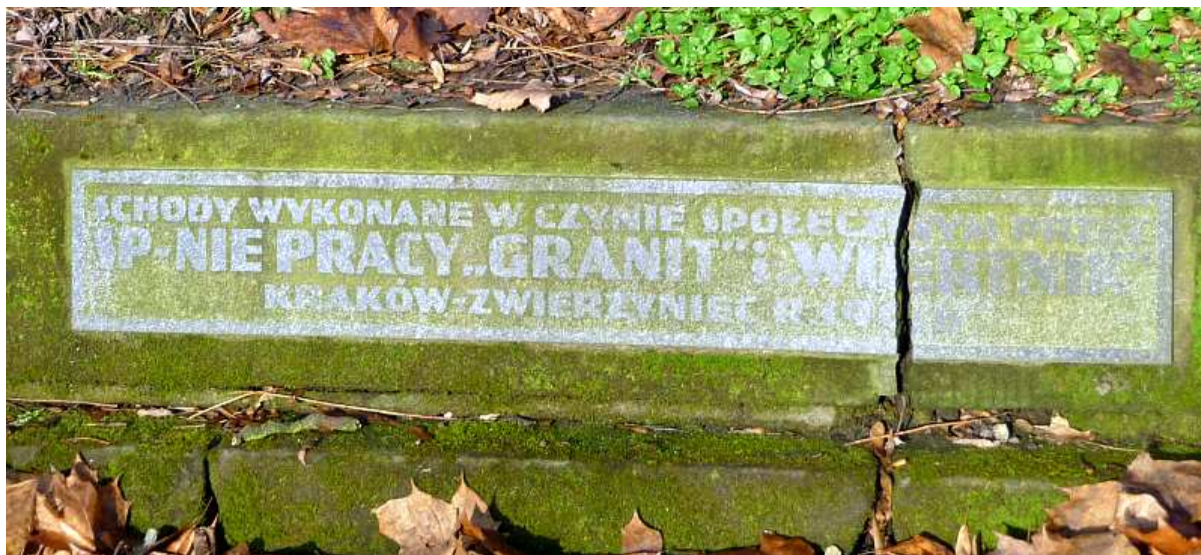
Fot. nr 100 (100-101). Napis w końcowym fragmencie schodów: „Schody wykonane w czynie społecznym przez Sp-nię Pracy „Granit” i „Wiertnik”. Kraków – Zwierzyniec R 1966”. (04.01.14)
