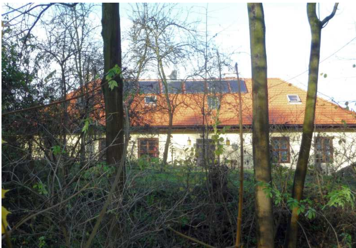
Fot. nr 135. Urokliwy dworek na końcu ulicy Drożyna, obok którego dawniej prowadziła ścieżka, dziś skutecznie przysłonięty przez panoszące się na zboczu Sikornika chaszczce. (10.11.13)
