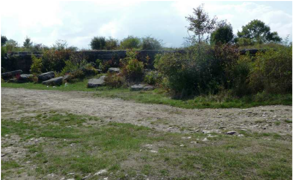
Fot. nr 236 (236-239). Pozostałości koszar szyjowych i bastionów. (22.09.13)
