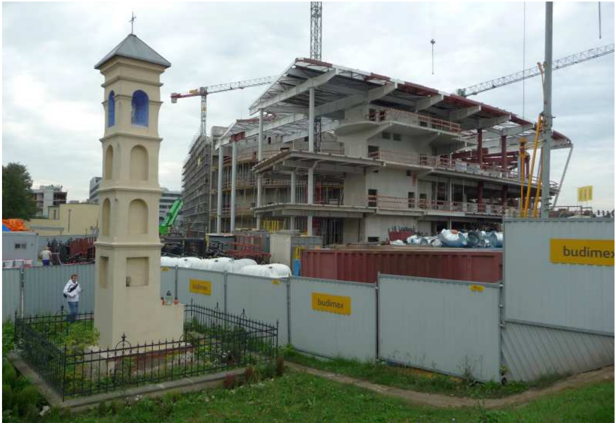
Fot. nr 211 (211-212). Dwa świąty: przeniesiona w nowe miejsce, zabytkowa kapliczka słupowa i przytłaczający ją kolos Centrum Kongresowego. (25.09.13)
