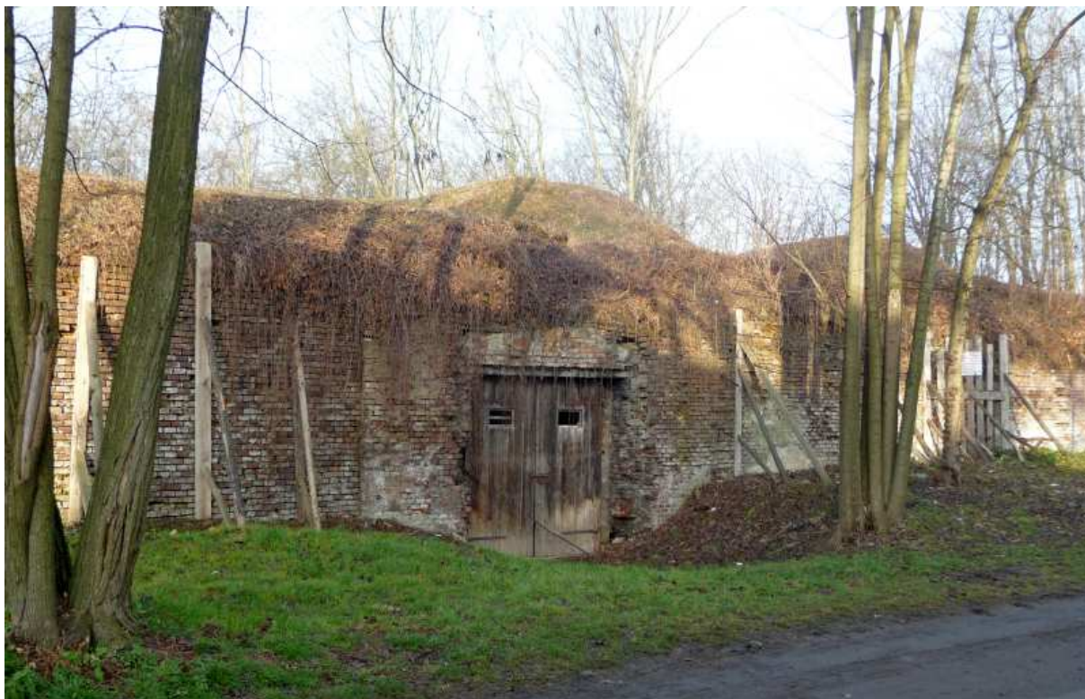
Fot. nr 114. Dawna brama wjazdowa do wnętrza bastionu. (04.01.14)
