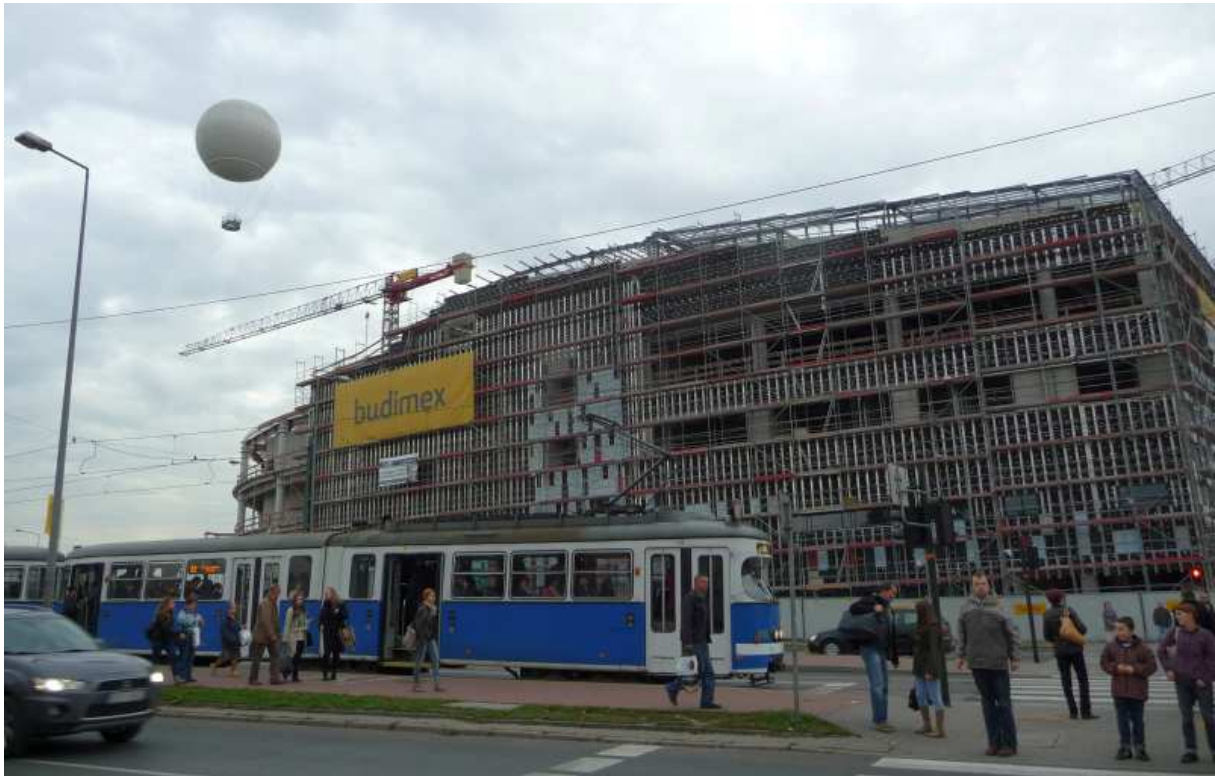
Fot. nr 213 (213-214). Nowopowstający moloch Centrum Kongresowego w sąsiedztwie Ronda Grunwaldzkiego – widok z ulicy Monte Cassino. (25.09.13)
