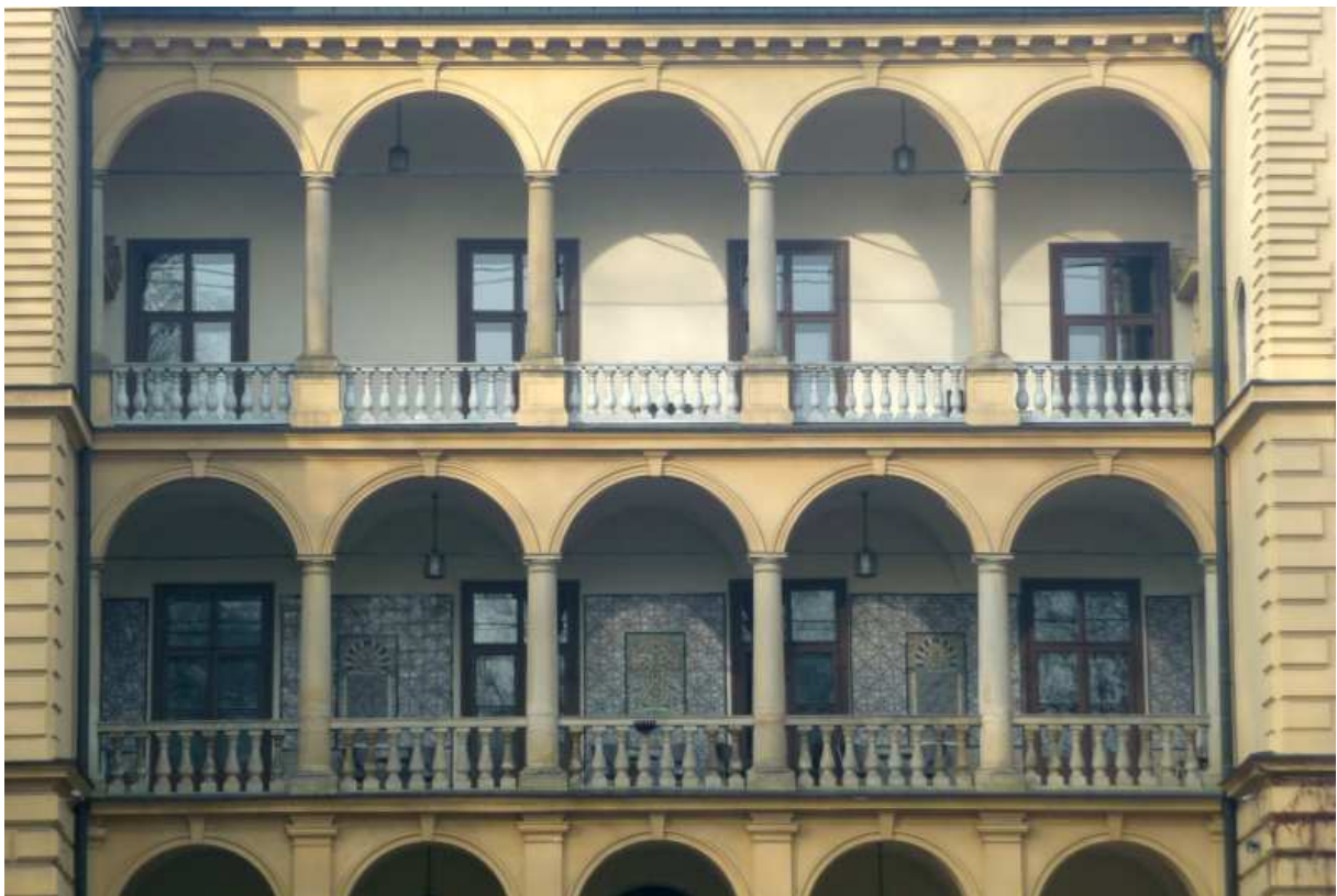
Fot. nr 31. Renesansowa, arkadowa loggia. (04.01.14)
