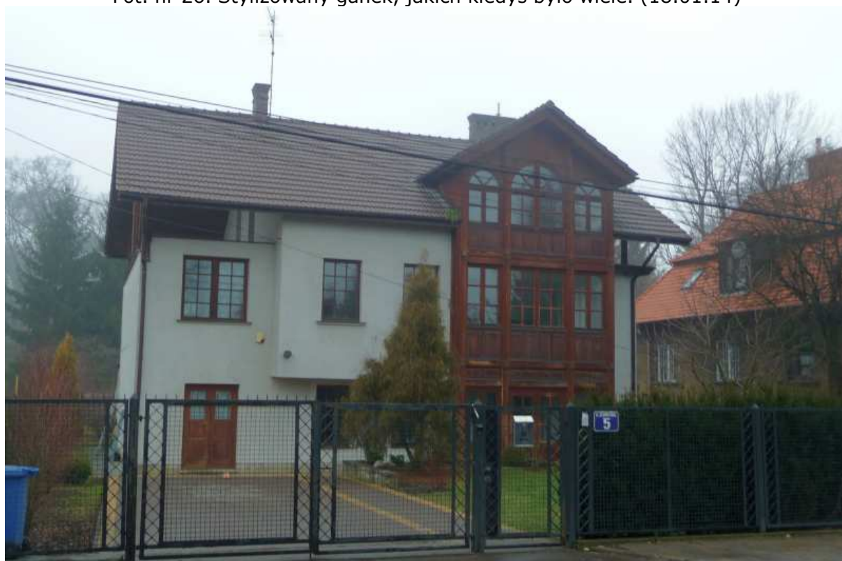
Fot. nr 27 (27-28). Przebudowany dom z ulicy 28-Lipca 1943 nr 5, z oryginalnym drewnianym ryzalitem. (18.01.14)
