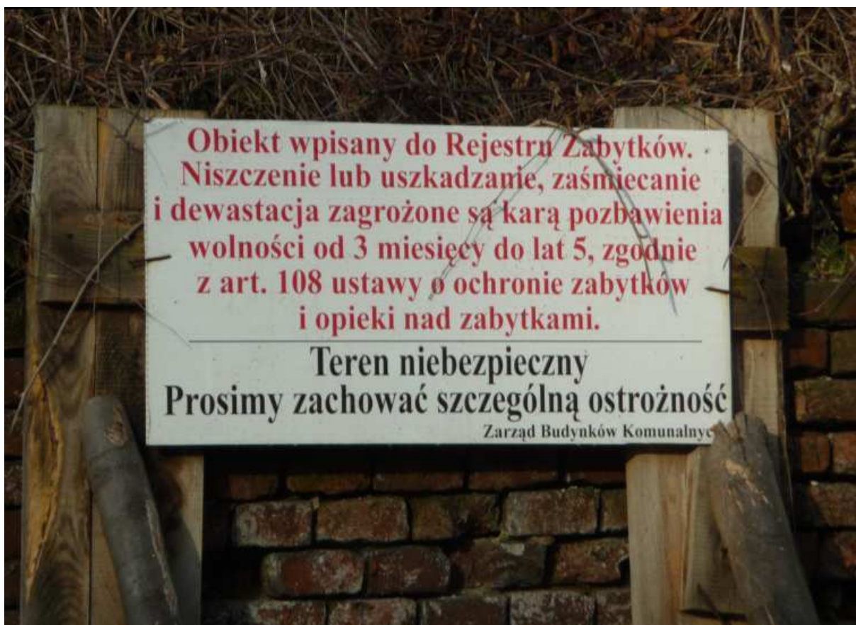
Fot. nr 115. Krzepiący serce komunikat. Byle za treścią poszły prace zabezpieczające, a jeszcze lepiej rekonstrukcyjne. (04.01.14)
