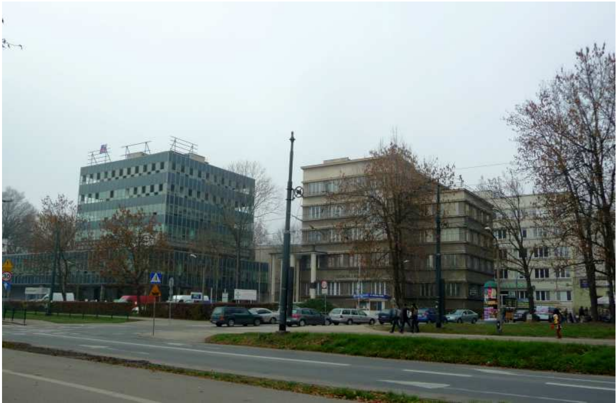
Fot. nr 148 (148-149). Dom Piłsudskiego z ulicy Oleandry (z prawej) i przylegający do niego budynek Petroinformu, który po pół wieku istnienia został wyburzony. (17.11.13)
