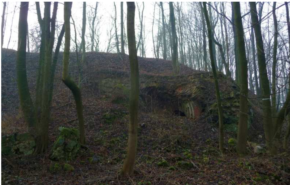
Fot. nr 120 (120-125). Przymglona ruina bastionu nr II – widoki od strony fosy. (04.01.14)
