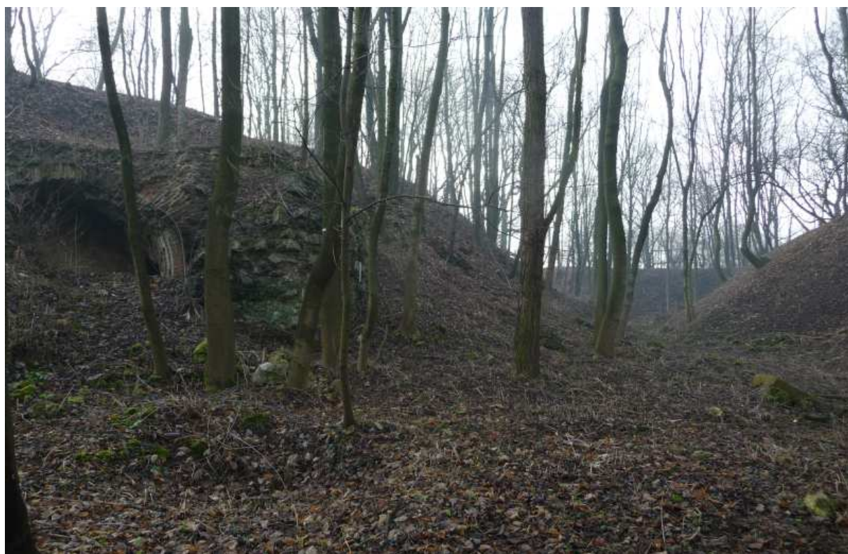
Fot. nr 119. Widok od strony dawnej „berlinki”. (04.01.14)
