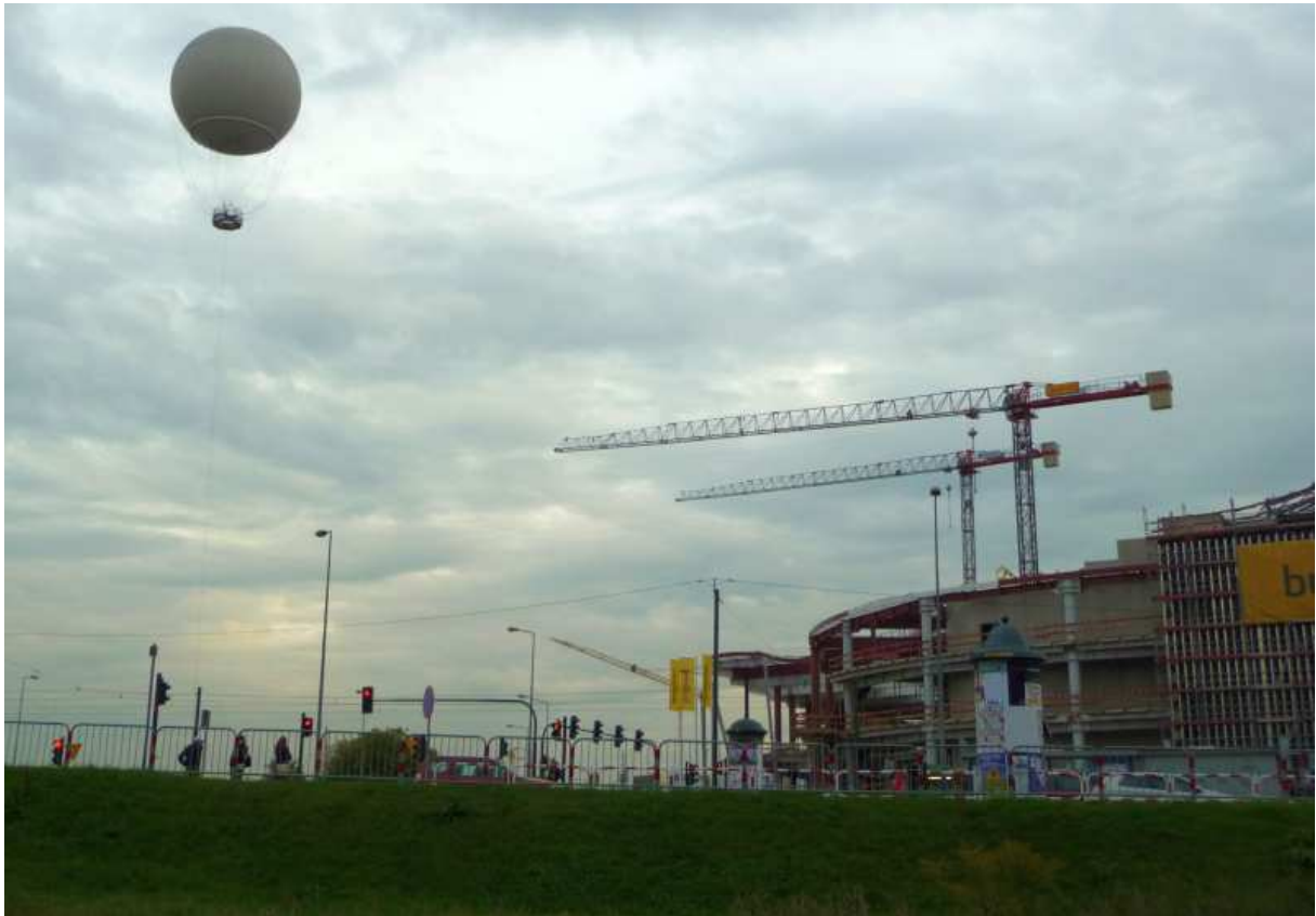
Fot. nr 215. Widok na Rondo Grunwaldzkie z niecki ulicy Kilińskiego. (25.09.13)
