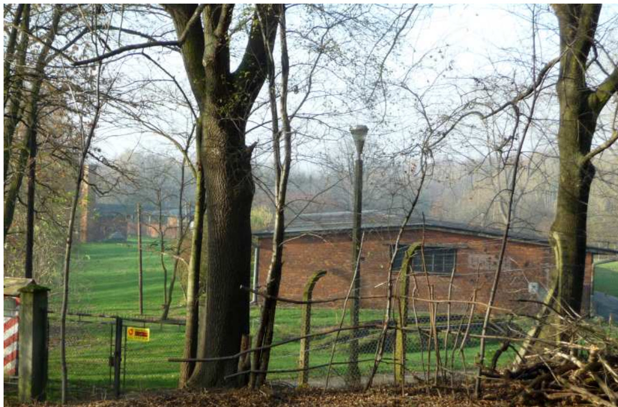
Fot. nr 126 (126-127). Dawne poniemieckie garaże w sąsiedztwie fortu Kościuszko, przylegające do Słonecznej Promenady. (17.11.13)
