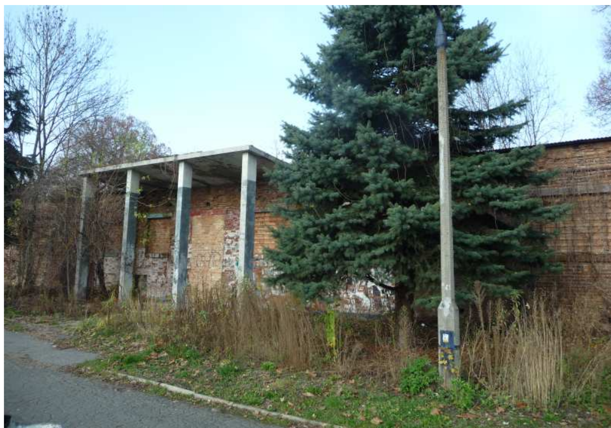
Fot. nr 161 (161-162). Budynek szatni od strony alei 3-Maja. Pośrodku zamurowane wejście, a obok okienko dawnej kasy, jedno z dwóch kiedyś istniejących. (17.11.13)
