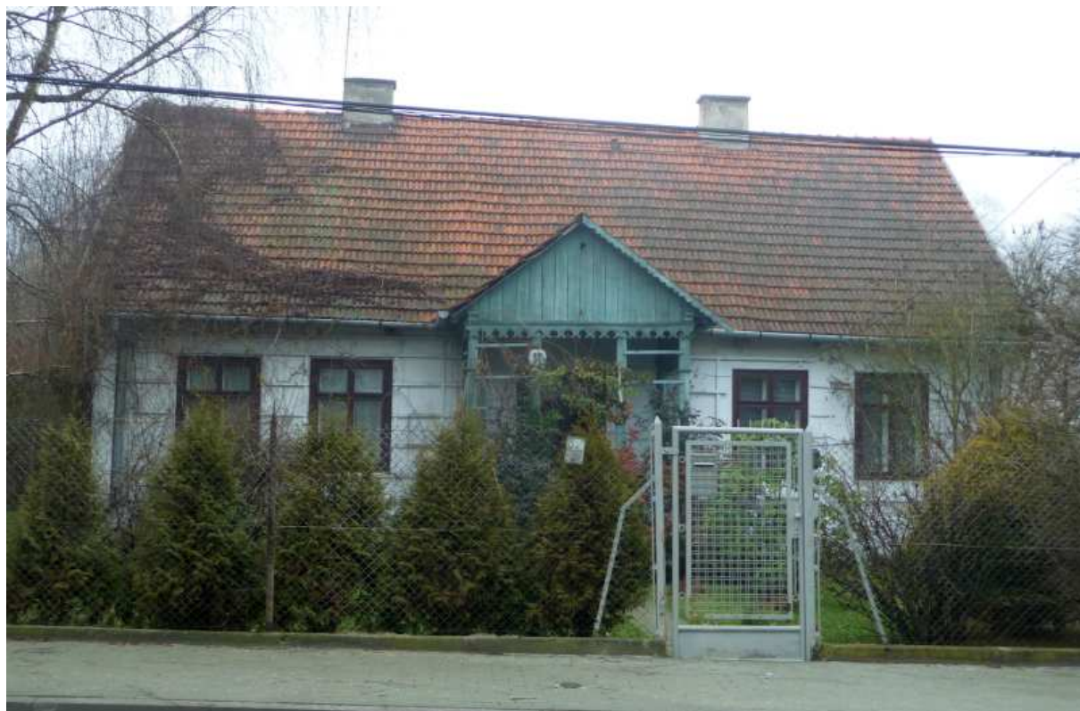
Fot. nr 24 (24-25). Oryginalna fasada w pełnej krasie. (18.01.14)
