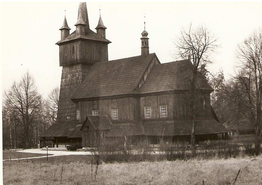
Fot. II. Widok od strony ulicy Cisowej.
