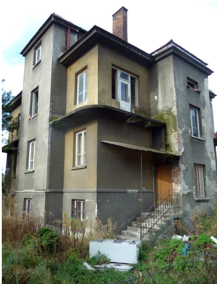
Fot. nr 90 (90-91). Kolejna przedwojenna ruina u wylotu ul. Korzeniowskiego. (10.11.13)
