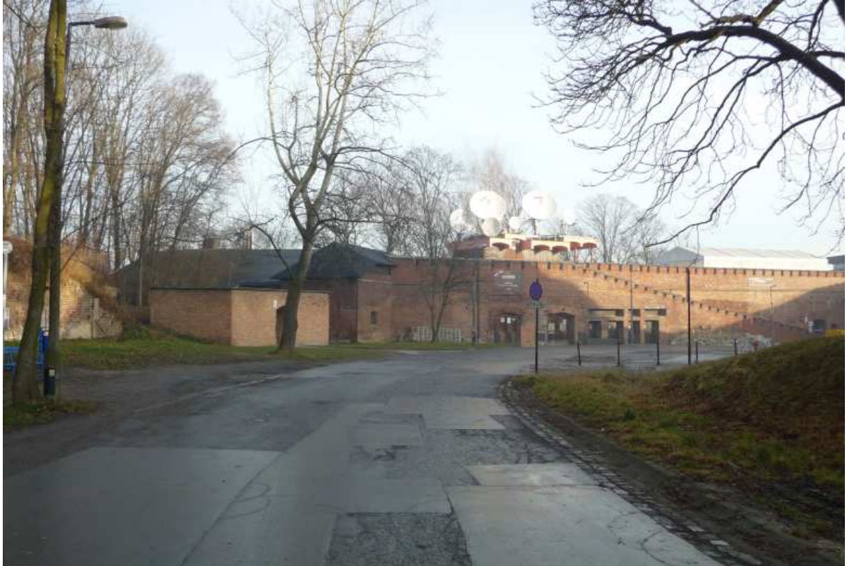
Fot. nr 116. Okolice dość luźno zrekonstruowanego bastionu nr III. (04.01.14)
