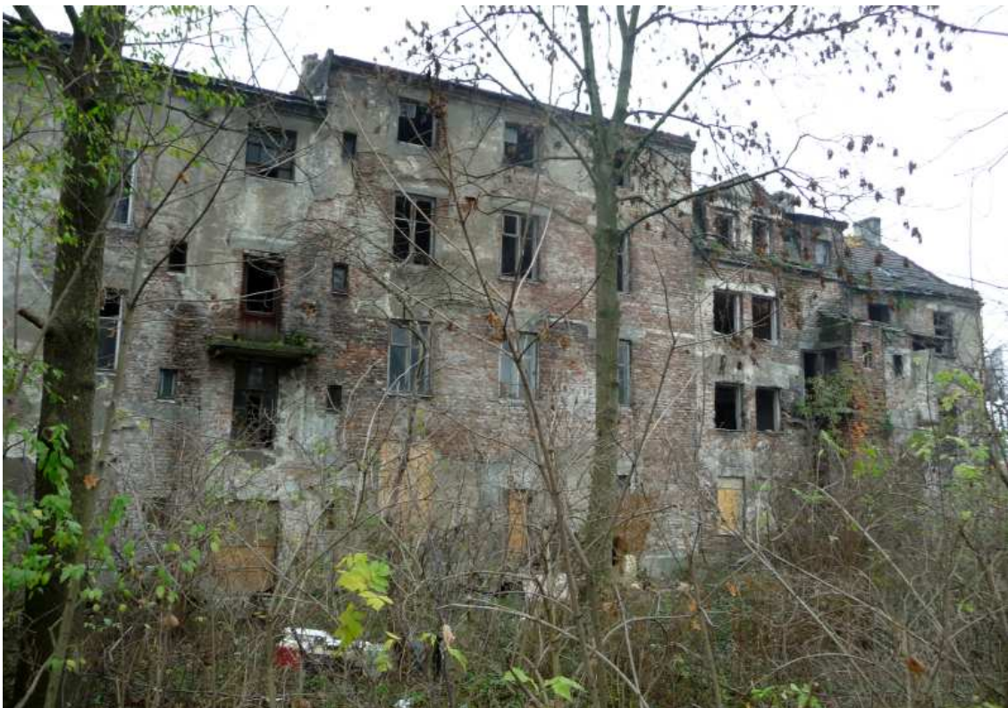
Fot. nr 192. Jeszcze jedno ujęcie od strony hotelu Hilton Garden Inn. (17.11.13)
