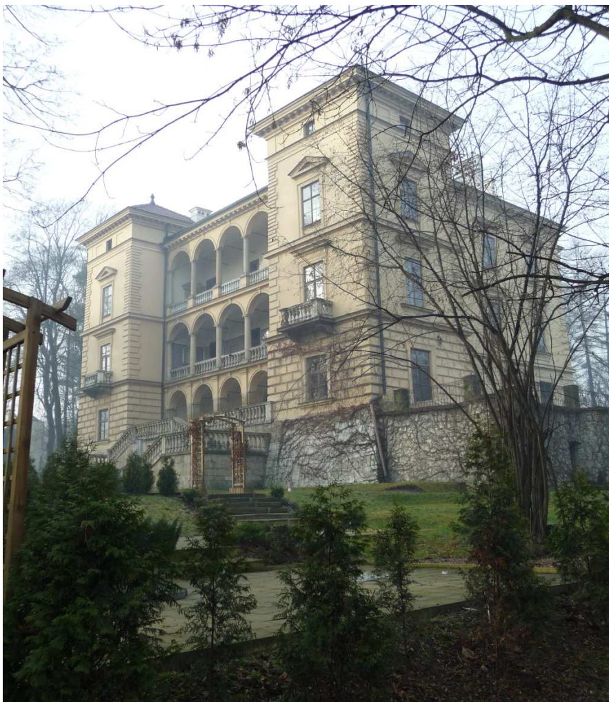
Fot. nr 34. Boniowane ryzality i arkadowa loggia fasady. (04.01.14)
