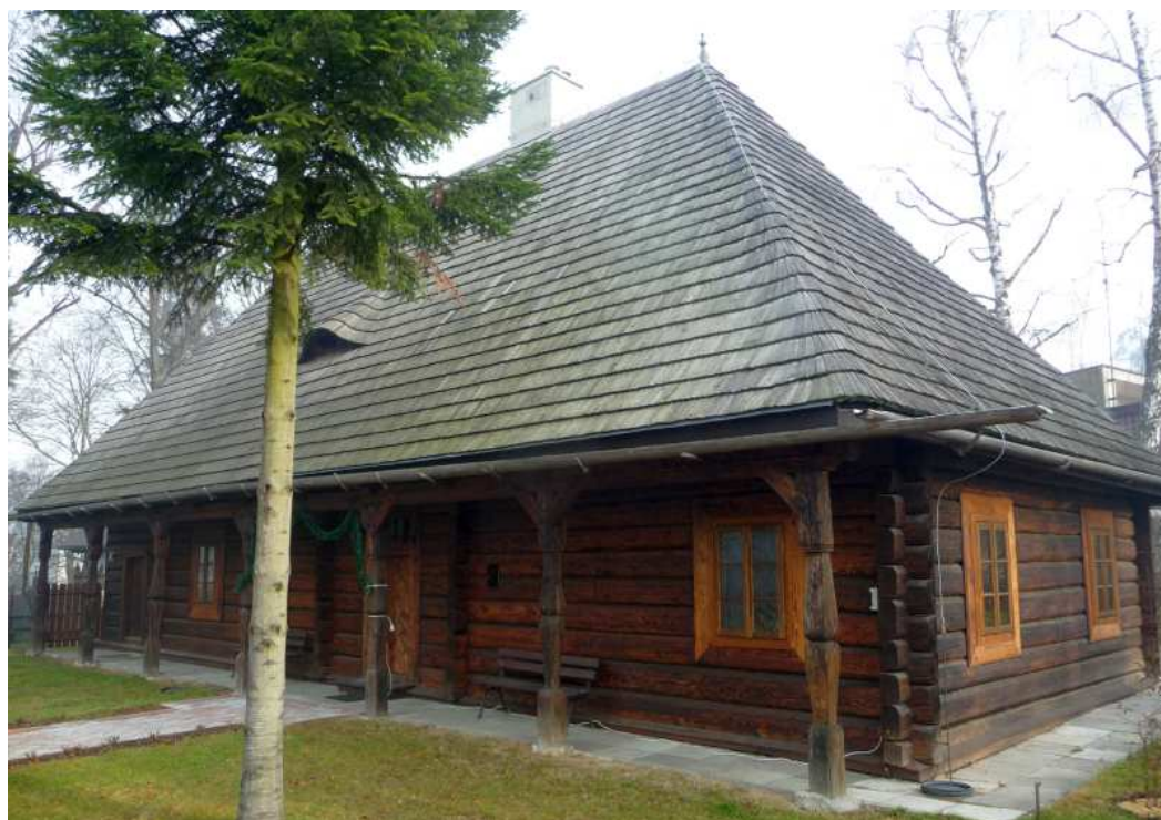
Fot. nr 71(71-72).Fasada zabytkowej karczmy szczęśliwie prawem chronionej.(04.01.14)
