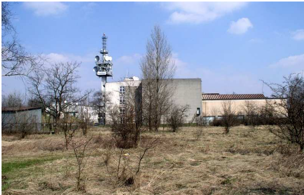
Fot. nr 173. Ośrodek TVP Kraków zbudowany w miejscu zburzonego w latach 50-tych fortu nr 32 w kształcie wieży Maksymiliańskiej. (29.03.2011)
