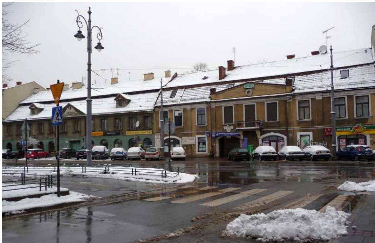
Fot. nr 9. Oryginalny fragment zabudowy z początku XIX-go wieku. (14.01.2012)
