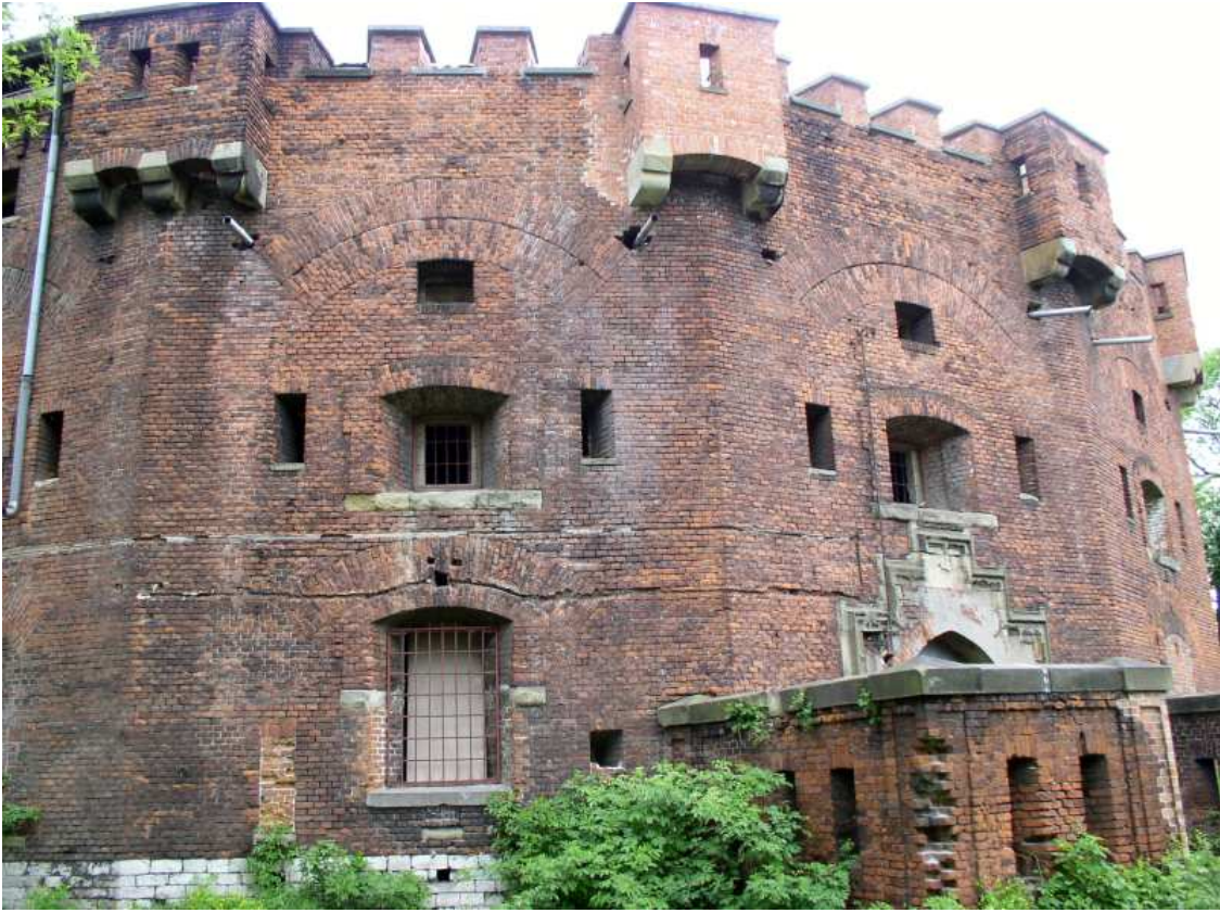
Fot. nr 118. Bastion przy bramie wjazdowej. (15.05.2009)
