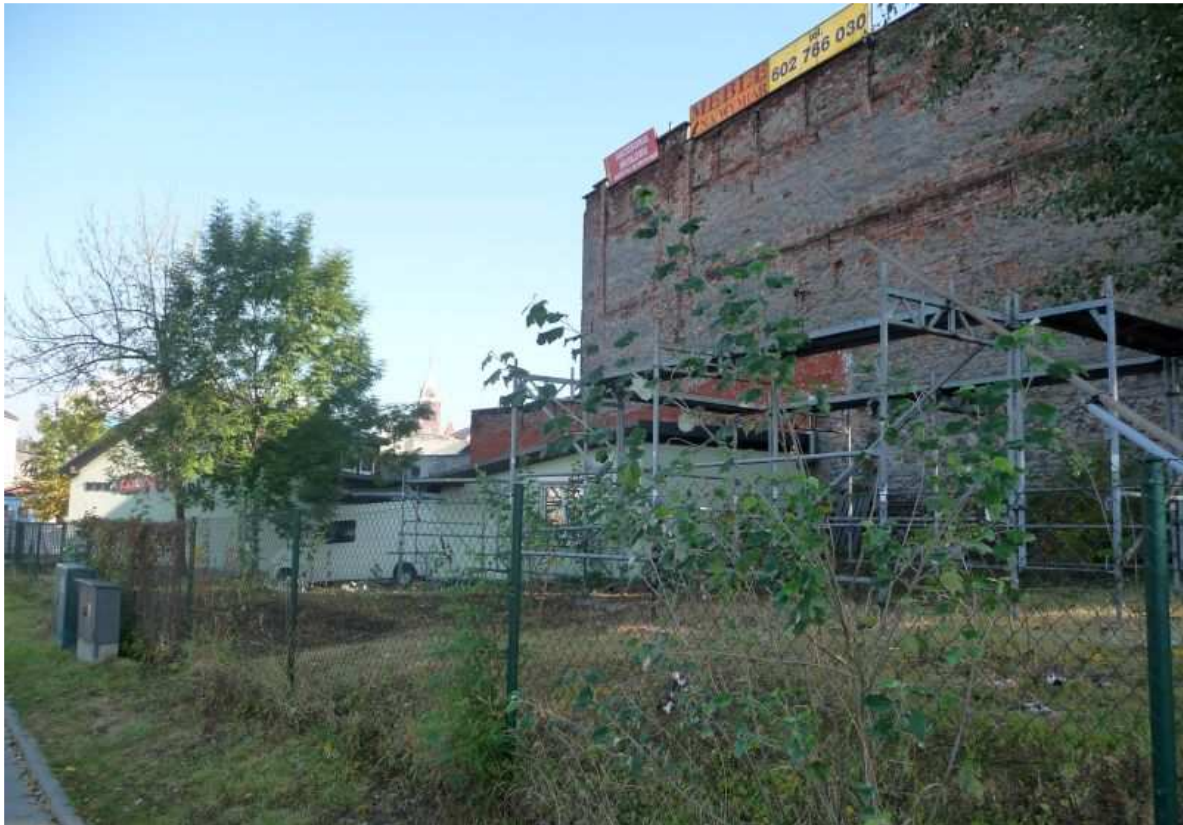
Fot. nr 20. Fragment zabudowy końcowego odcinka ulicy Kalwaryjskiej na styku z ulicą Podskale i Rondem Matecznego. (17.10.2011)
