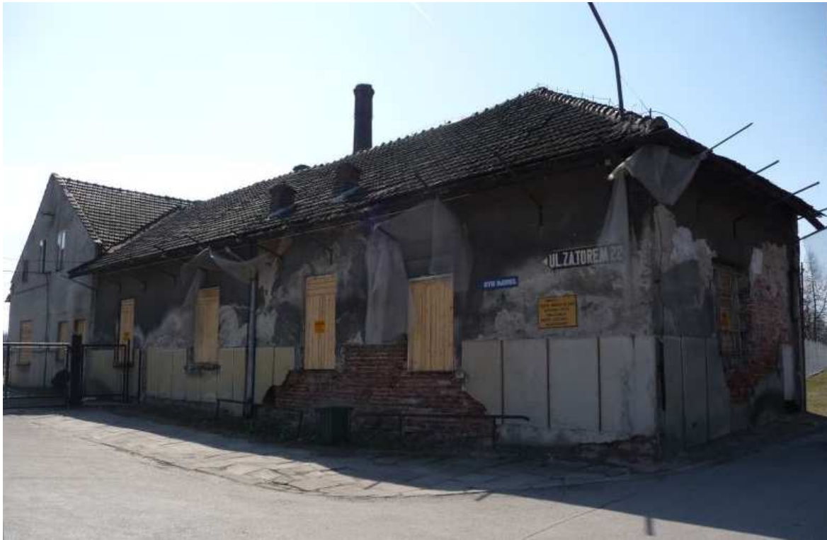
Fot. nr 214 (214-219). Budynek biurowy dawnego kamieniołomu Libana przy ulicy Za Torem 22. (25.03.2011)
