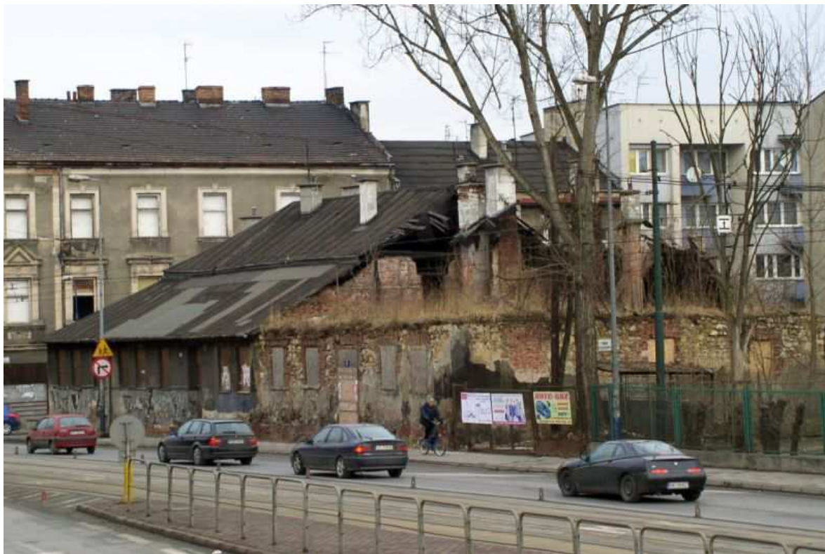
Fot. nr 99. Ruina spalonego dworku z końca XVIII-go wieku (pod nr 47). (05.02.2011)
