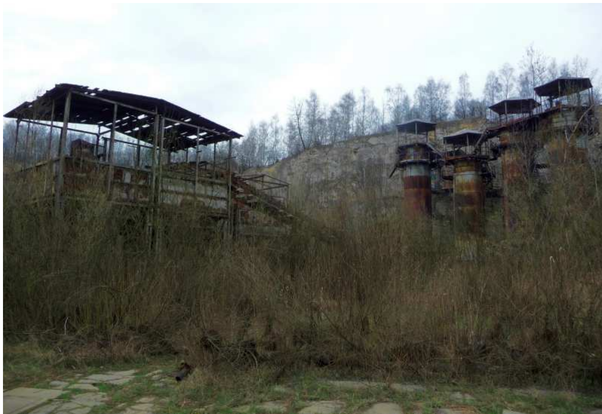
Fot. nr 226 (226-227). Dawna instalacja przeróbki kamienia wapiennego. (20.04.2013)
