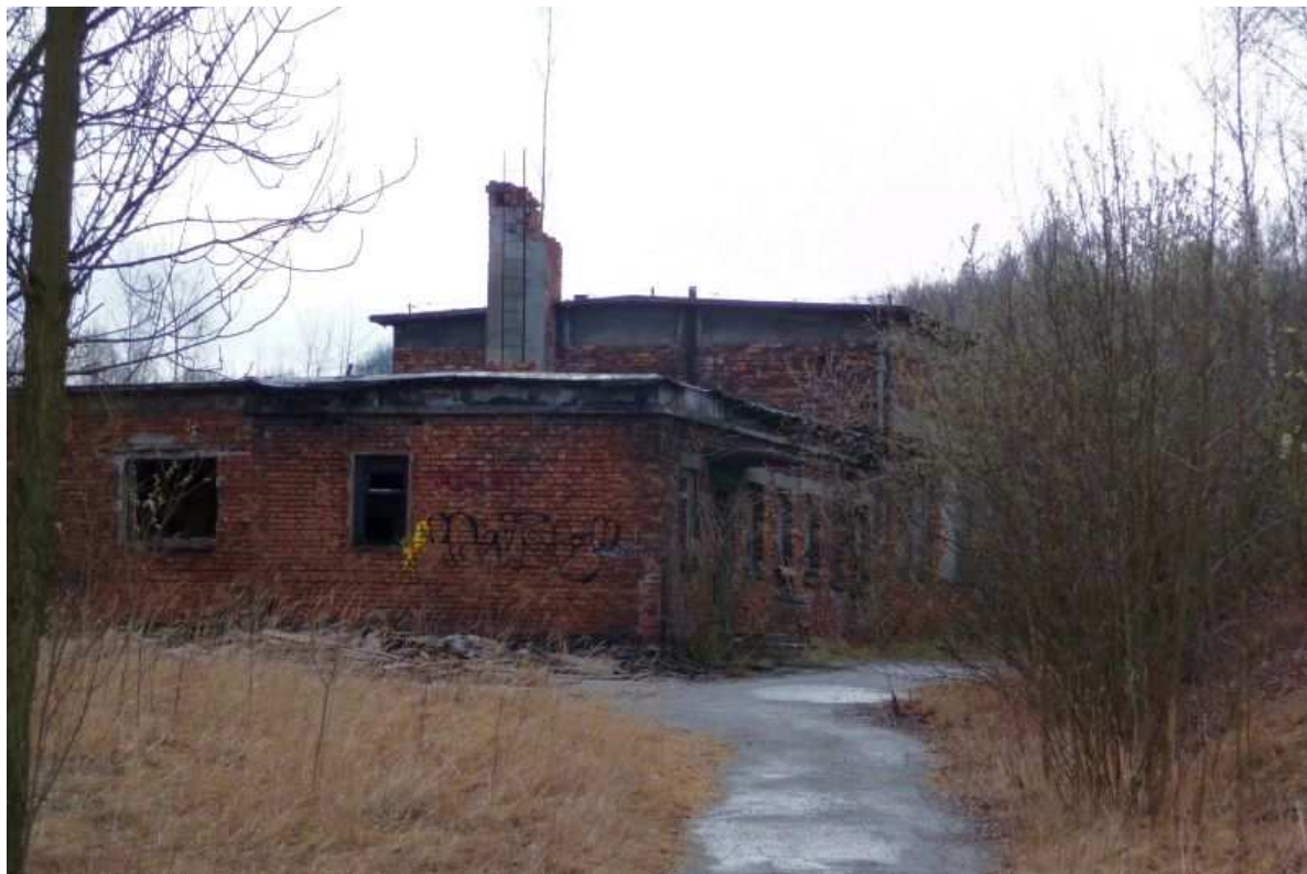
Fot. nr 222. Drugi budynek od strony ulicy Swoszowickiej. (30.03.2012)
