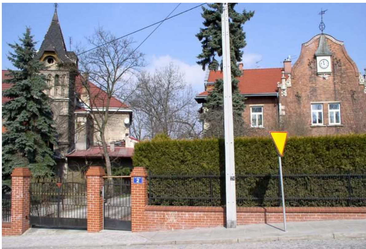
Fot. nr 132 (132-133). Zabudowa na styku Placu Lasoty i ulicy Parkowej. (29.03.2011)
