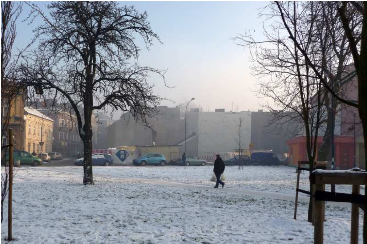
Fot. nr 79. Burzony właśnie parterowy domek pod nr 10. (12.12.2012)
