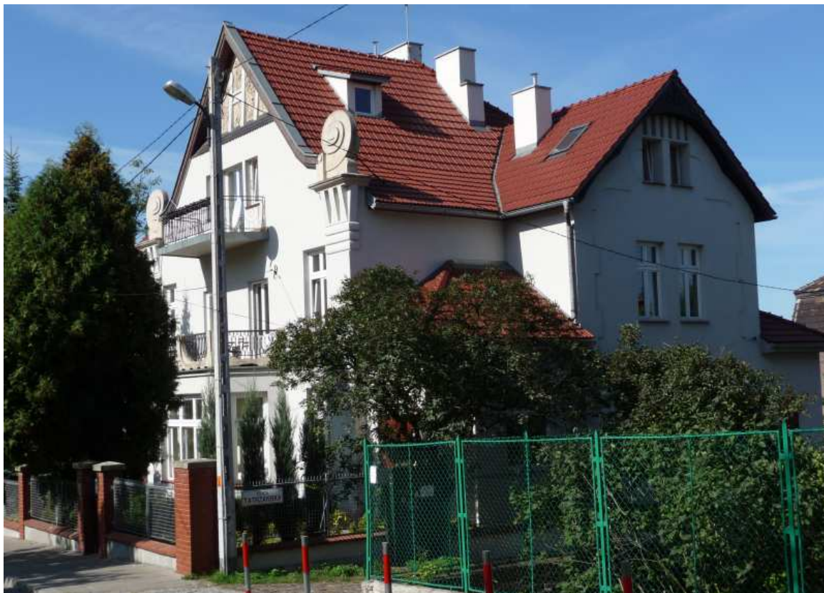
Fot. nr 136. Widok willi od strony z ulicy Tatrzańskiej. (11.09.2011)
