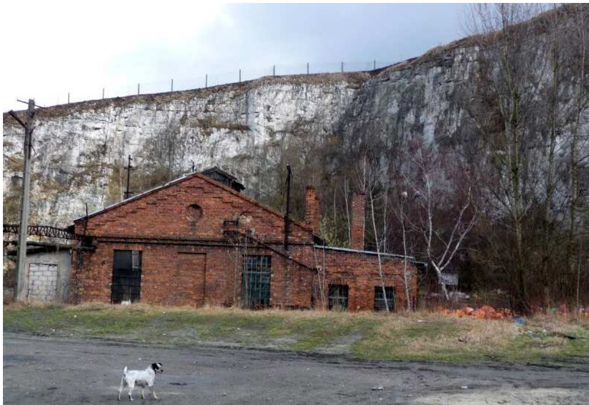
Fot. nr 220 (220-221). Pierwszy z budynków kopalni na wysokości Kopca. (30.03.2012)
