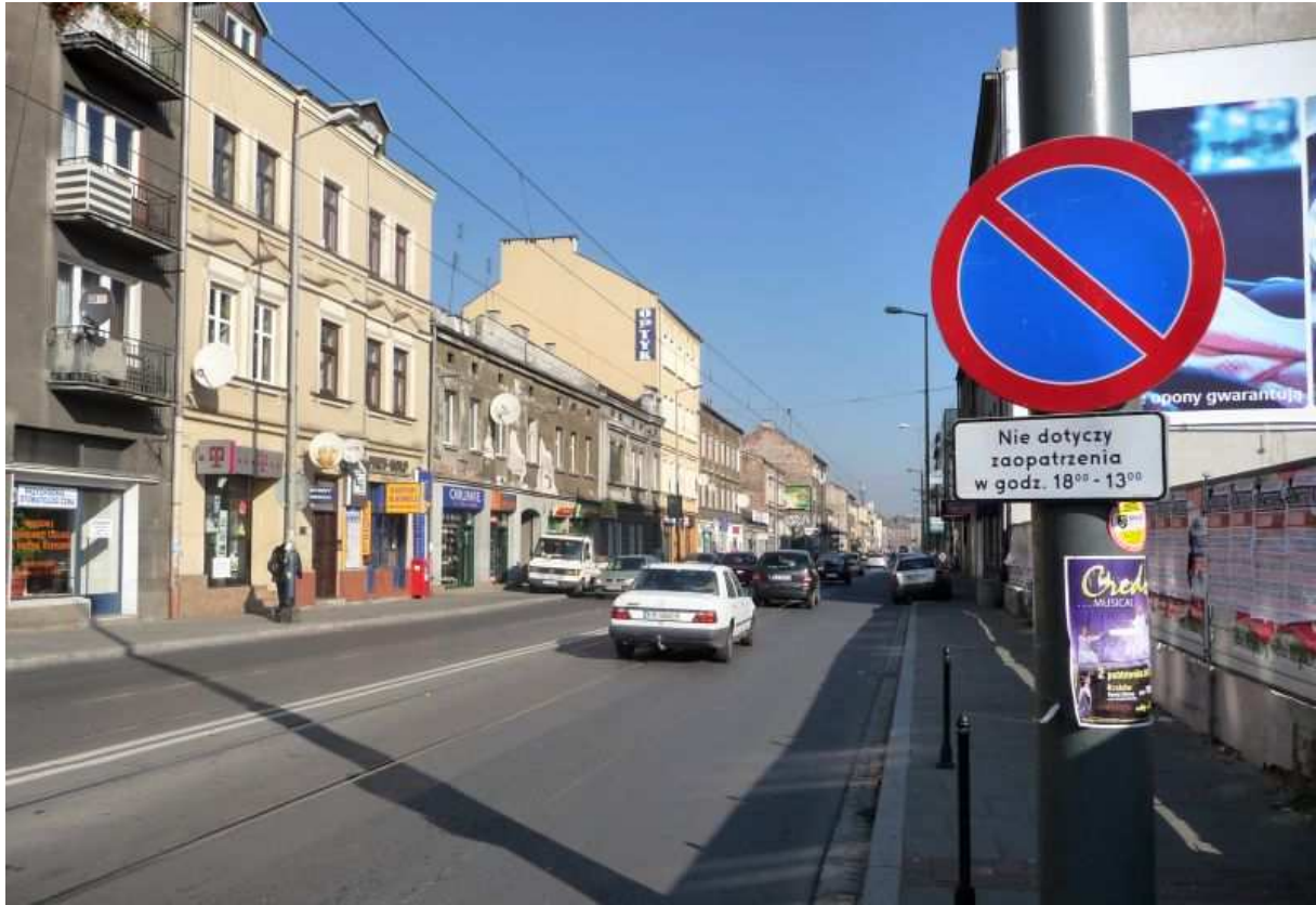
Fot. nr 18. Fragment zabudowy powyżej ulicy Śliskiej. (17.10.2011)
