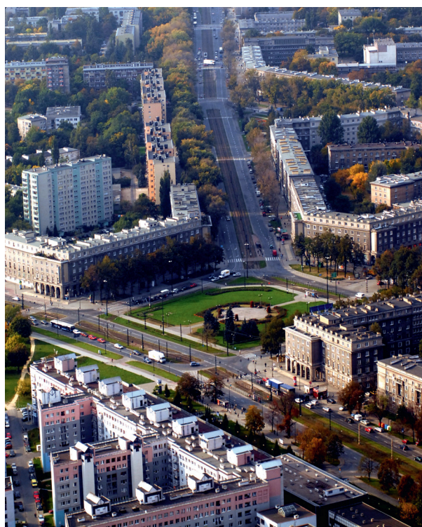
1. Nowohucki Plac Centralny stanowi ściśle symetryczną koncepcję architektoniczną, 2010 r. Fot. Wojciech Matusik
