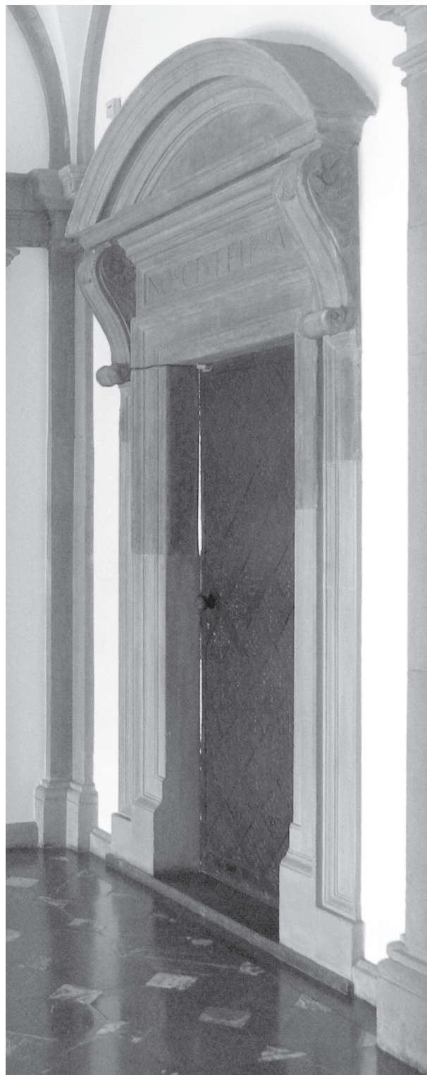
18. Wewnętrzny portal na I piętrze schodów w skrzydle północnym na Wawelu, warsztat Bartłomieja Berrecciego (?), 1516–1536 (?). Fot. M. Fabiański
