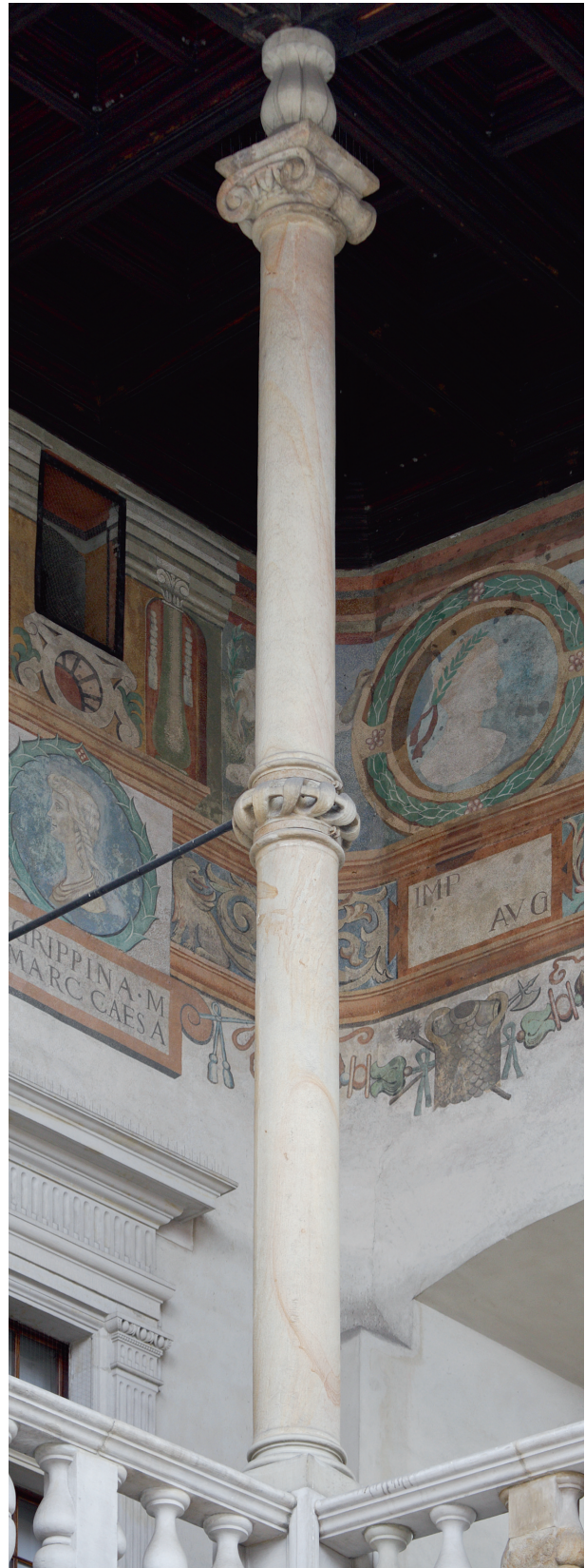
7. Kolumna II piętra krążganków wawelskich u zbiegu skrzydeł wschodniego i południowego, Bartłomiej Berrecci na wzór Franciszka Florentczyka, 1533–1536 (może wymieniona 1537–1538), baza i impost wymienione, 1907–1909. © Zamek Królewski na Wawelu. Fot. D. Błazewski
