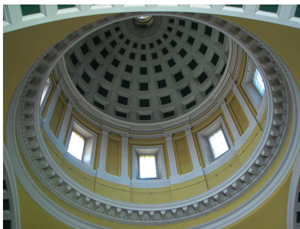
17. Wnętrze kopuły kaplicy zakładowej Domu Ubogich. Fot. A. Laskowski, 2006
