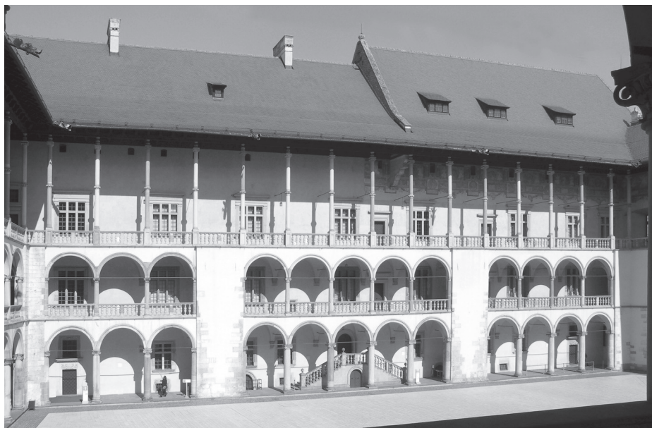
19. Elewacja zachodnia skrzydła wschodniego zamku na Wawelu, zbudowanego pierwotnie w latach 1520–1536. Pośrodku widoczne wejście na schody Poselskie, zrekonstruowane przez Adolfa Szyszko-Bohusza, 1926. Fot. M. Fabiański
