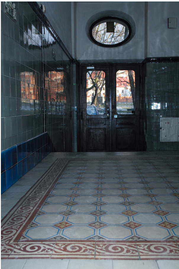
19. Kraków ul. Straszewskiego 8, posadzka i okładzina ścienna ułożone przez firmę Jana Godzickiego ok. 1914
