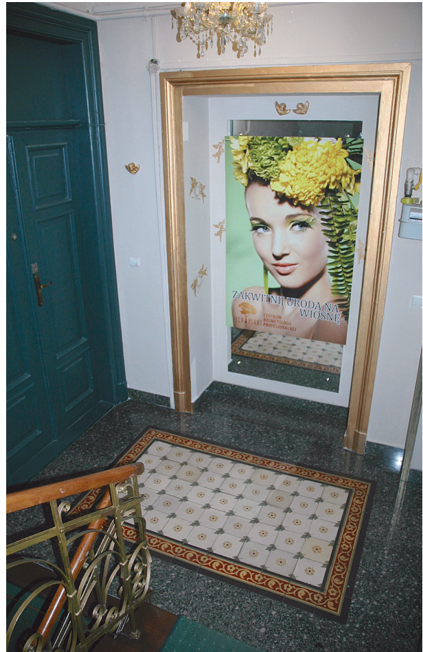
28. Kraków, ul. Zacisze 6, wnętrze klatki schodowej po generalnym remoncie z odzyskanymi fragmentami XIX-wiecznej posadzki
