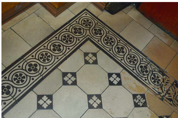
9. Kraków, ul. Smoleńsk 6. Fragment posadzki kościoła pod wezwaniem Najświętszego Serca NMP
