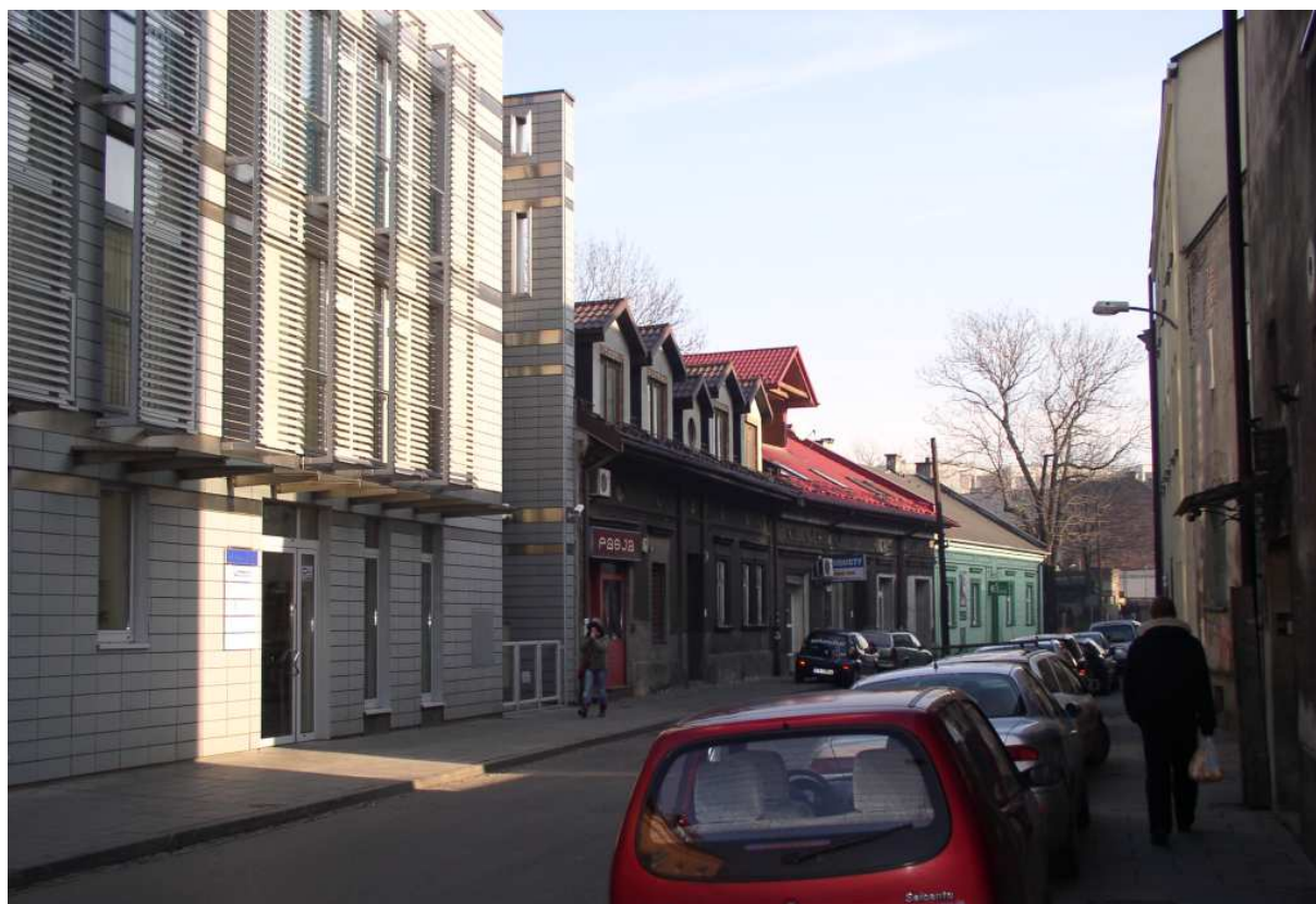
Fot. nr 201. Widok od strony Placu Bohaterów Getta. (27.11.09)
