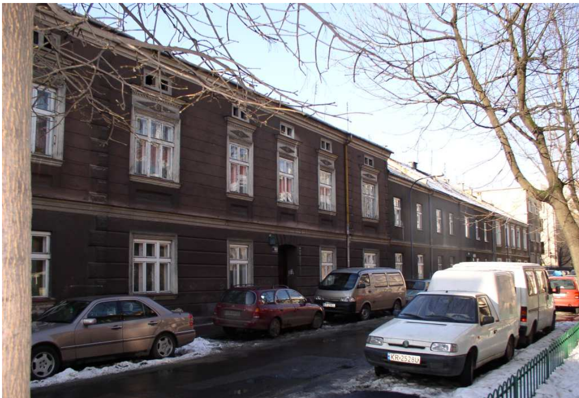
Fot. nr 109. Charakterystyczna zabudowa Podgórze z początku II połowy XIX-go wieku – fragment ulicy Krakusa (kamieniczka pod nr 19). (19.01.09)
