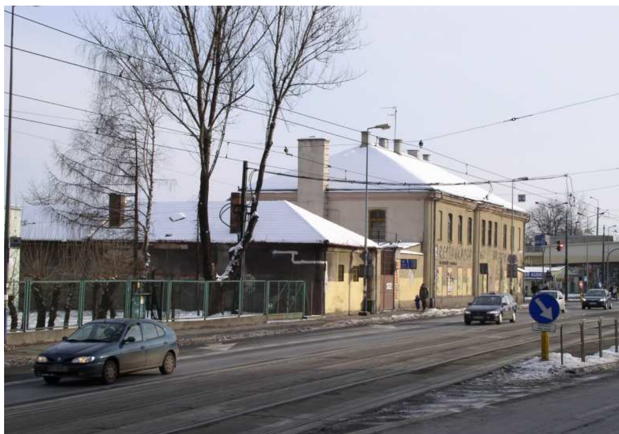
Fot. nr 156. Pochodzący z końca XVIII-go wieku budynek zajazdu „Pod św. Benedyktom” (ulica Wielicka 2, w narożu z ulicą Powstańców Wielkopolskich), przebudowany w czasach Twierdzy Kraków na koszary wojskowe. (17.01.09)
