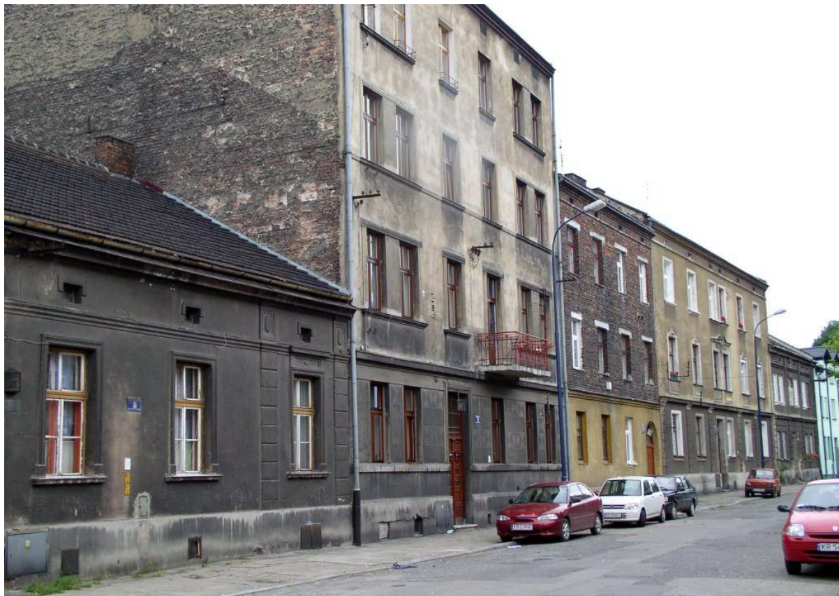
Fot. nr 221. Fragment ulicy Wałowej od jej wlotu do ulicy Dekerta (nr:1-11). (13.06.09)
