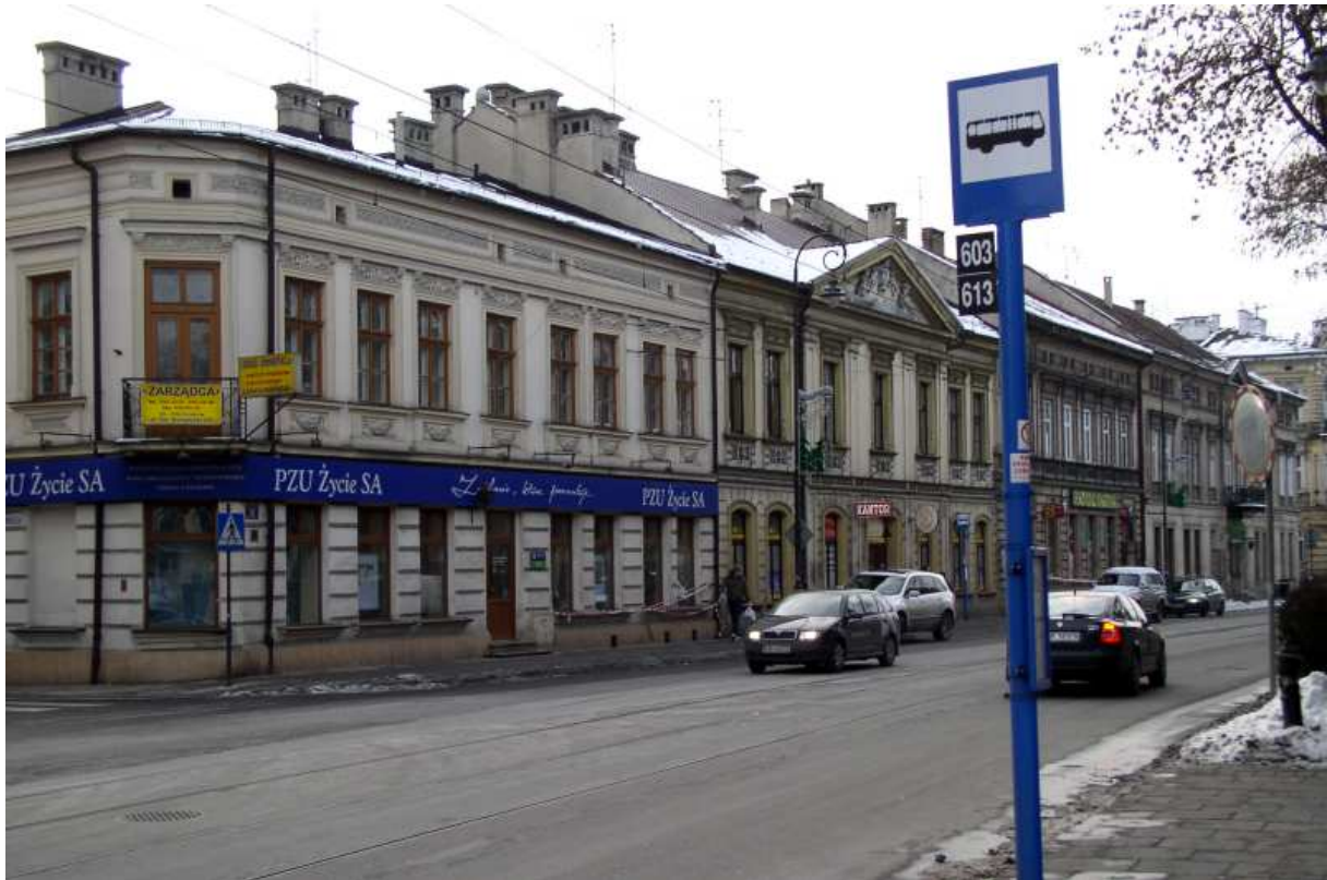
Fot. nr 140. Odcinek ulicy o numerach: 16-22. (17.01.09)
