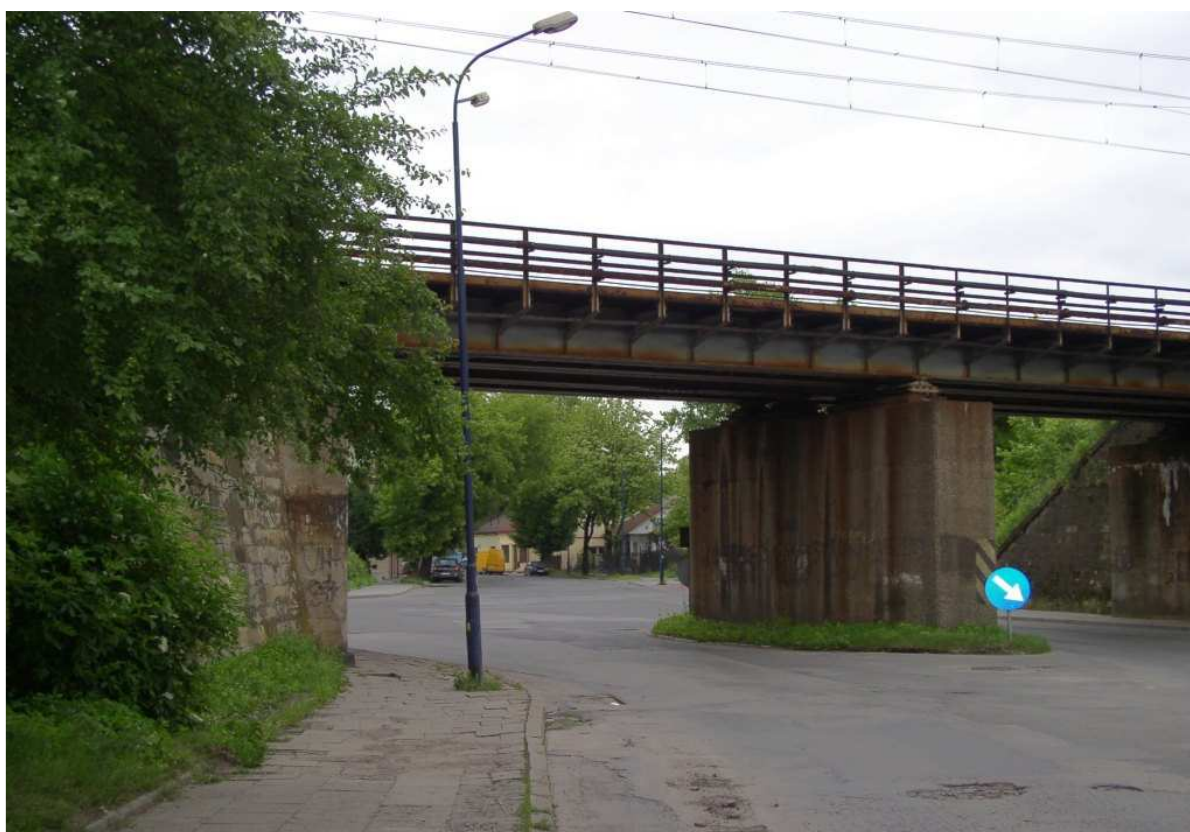
Fot. nr 216. Wiadukt kolejowy na styku ulic: Dąbrowskiego i Dekerta (13.06.09)
