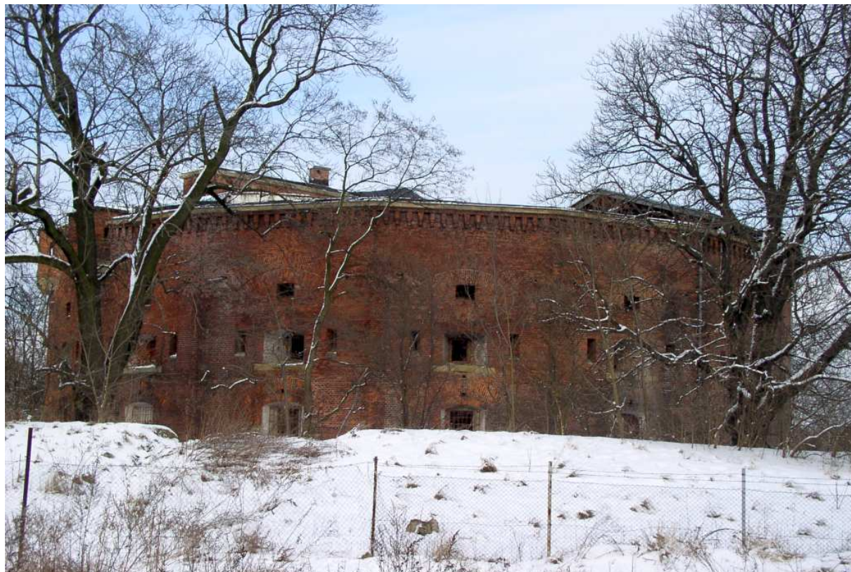
Fot. nr 162(162-165). Fort nr 31 („św. Benedykt”), tzw. baszta maksymiliańska – widok od strony cmentarza. (17.01.09)
