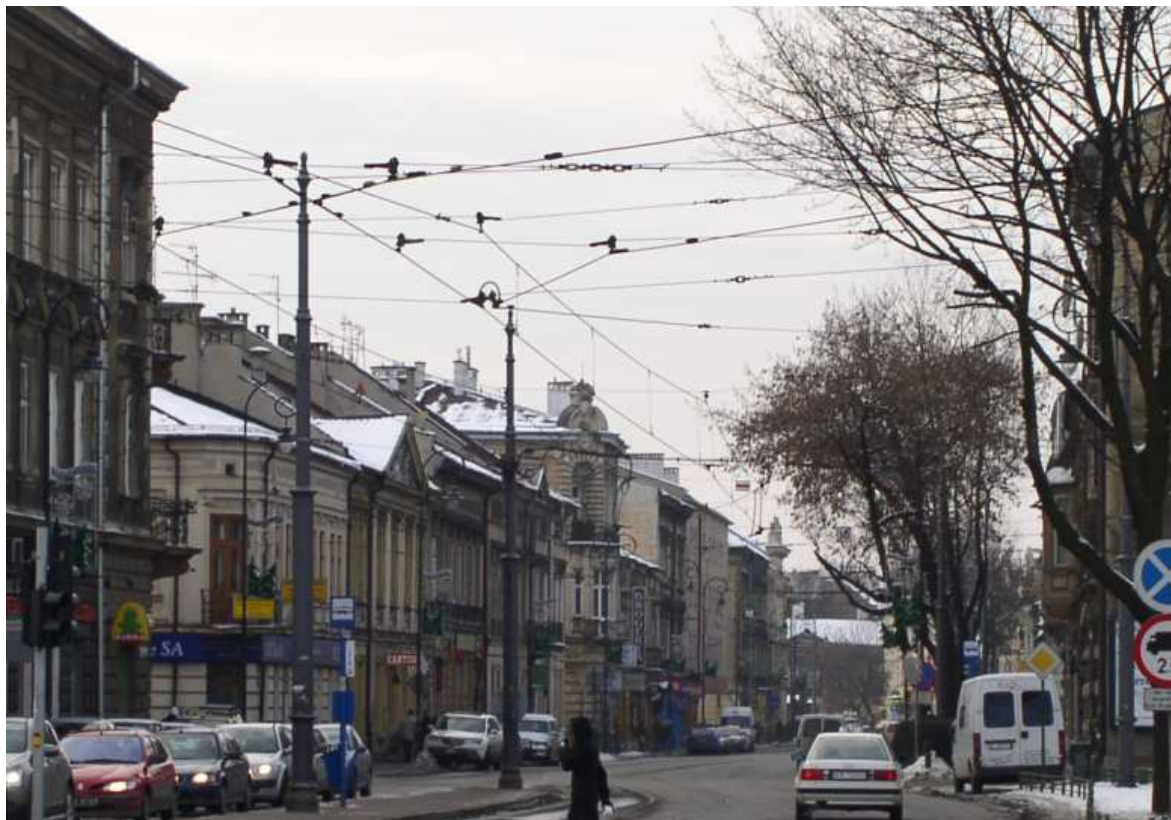
Fot. nr 142. Panorama ul. Limanowskiego ze skrzyżowania z ulicą Na Zjeździe.(17.01.09)
