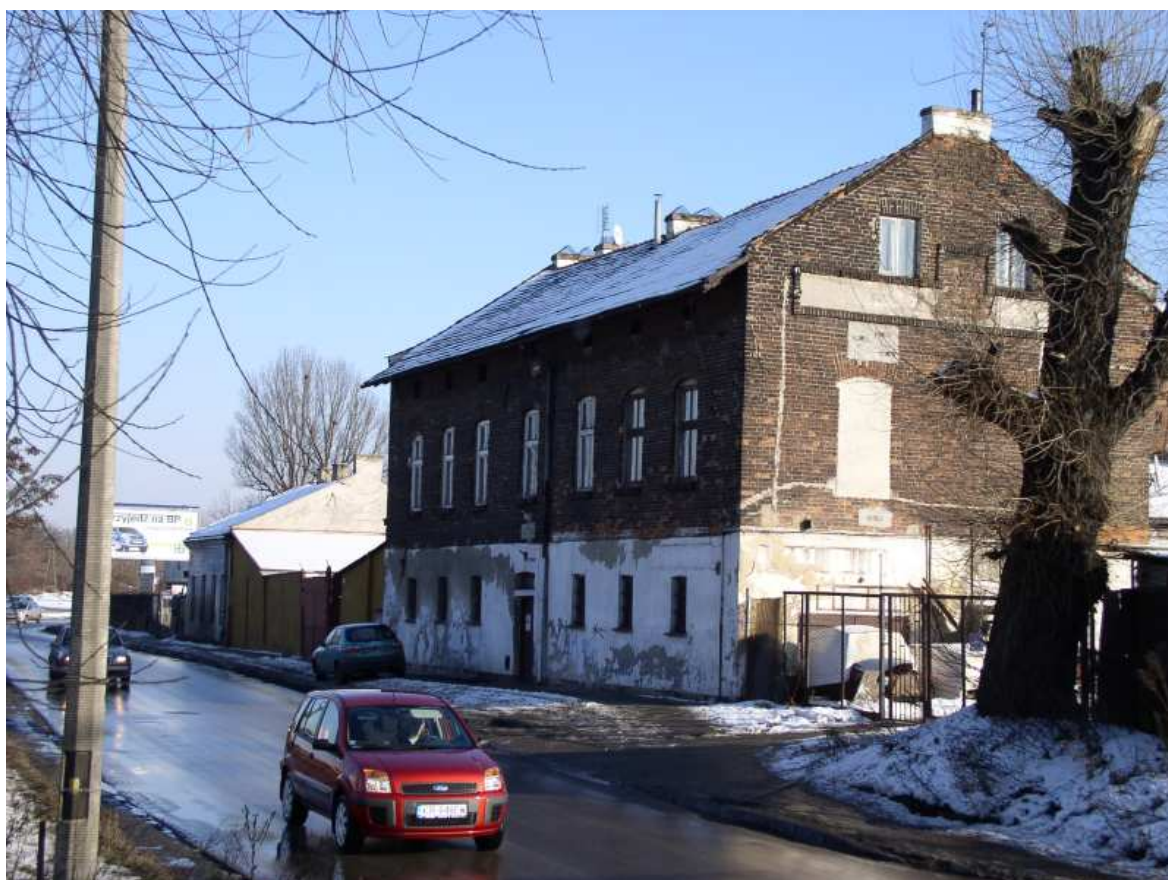
Fot. nr 131. Dawna zabudowa początkowego odcinka ulicy Zabłocie (nr: 9-13).(19.01.09)
