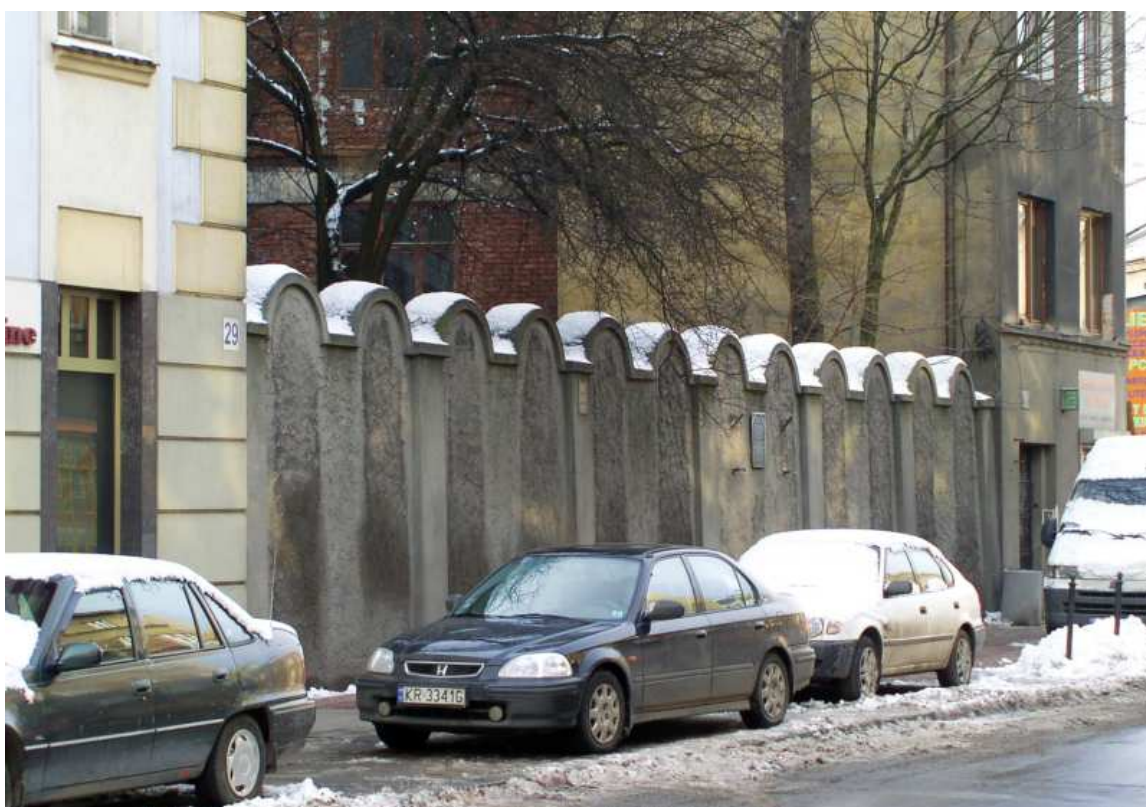
Fot. nr 185. Odcinek muru dawnego getta w sąsiedztwie kamienicy pod nr 29. (17.01.09)
