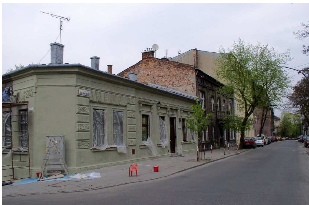
Fot. nr 75. Narożnik ulic: Zamojskiego (nr 39) i Smolki. (23.04.09)
