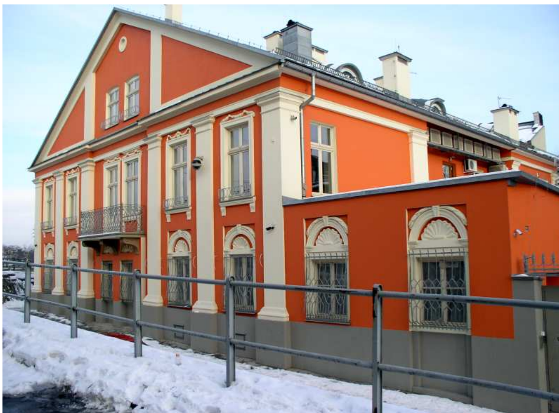
Fot. nr 102. Kamienica spod nr 2 - widok z ulicy Mostowej. (17.01.09)
