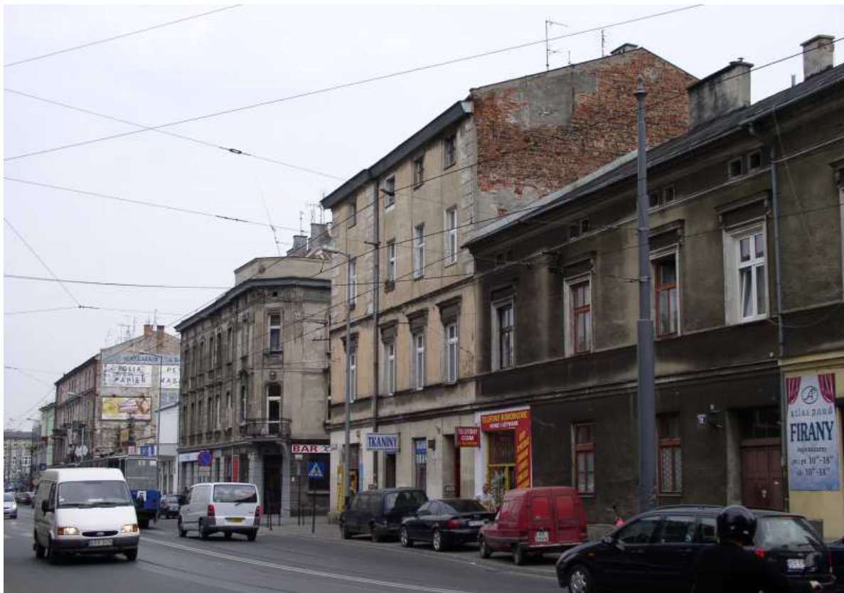
Fot. nr 19. Fragment zabudowy przy poniżej nr 31, przy wylocie ulicy Stromej.(23.04.09)
