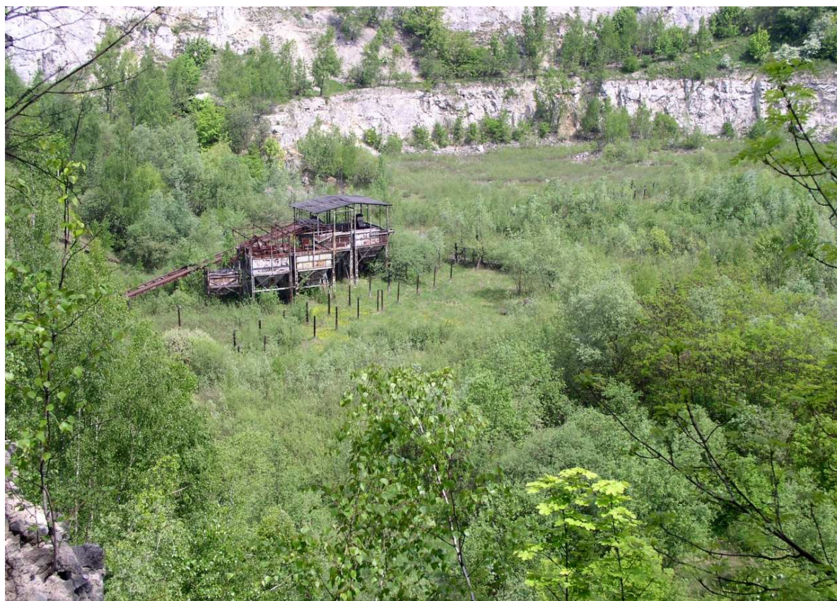
Fot. nr 242. Resztki dawnej instalacji krusząco-sortującej. (09.05.09)
