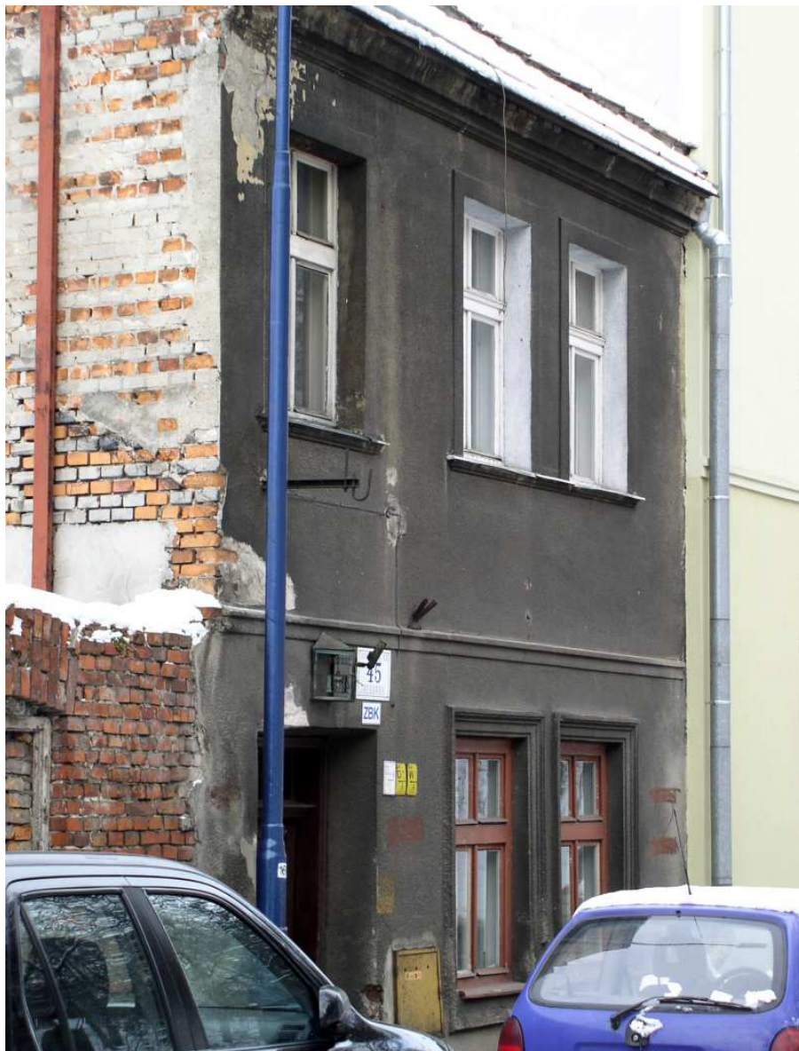
Fot. nr 178. Kamieniczka spod nr 45. (17.01.09)
