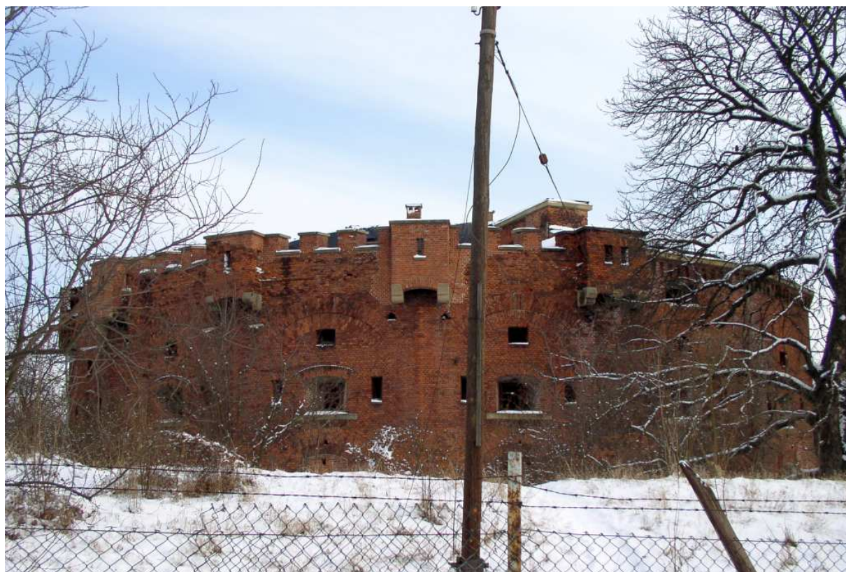
Fot. nr 163. Widok od strony wykutego w skale, trójkątnego bastionu nr VIII. (17.01.09)
