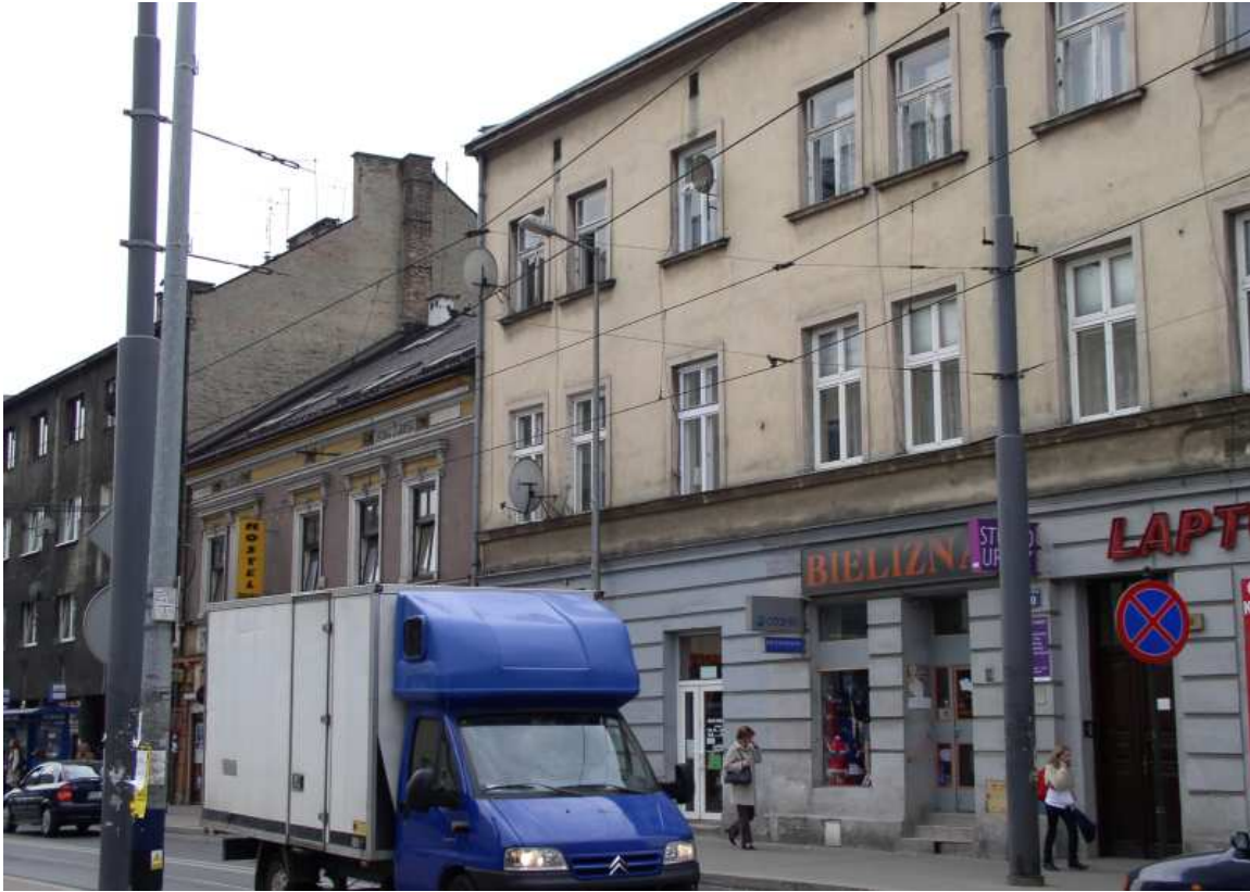
Fot. nr 13. Fragment ulicy w sąsiedztwie ulicy Kutrzeby, gdzie obok siebie sąsiadują budynki z czasów galicyjskich i z okresu PRL-u. (23.04.09)
