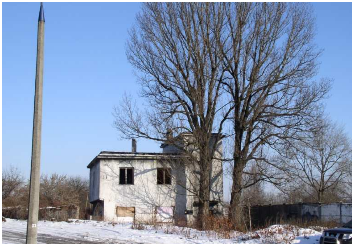
Fot. nr 135. Kolejna ruina, tym razem u wylotu ulicy Przemysłowej. (19.01.09)
