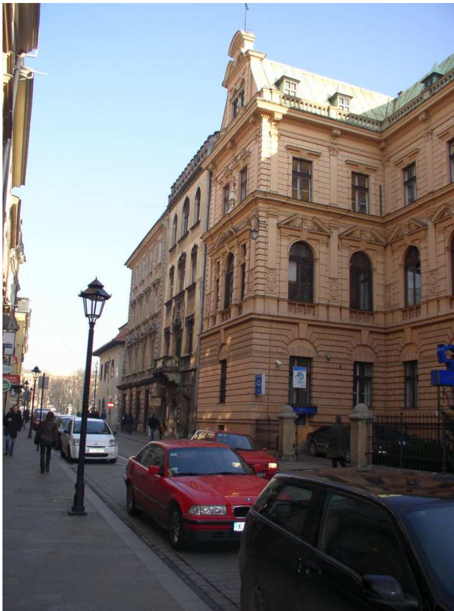
Fot. nr 172. Fragment ulicy Szpitalnej w sąsiedztwie ulicy św. Marka, jeszcze z antykwariatem na parterze narożnej kamienicy pod nr 19. 27.11.09
