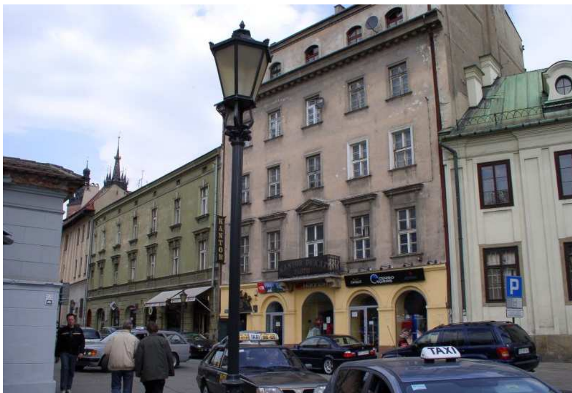
Fot. nr 199. Galicyjska zabudowa pod nr: 12 i 14. 17.04.09
