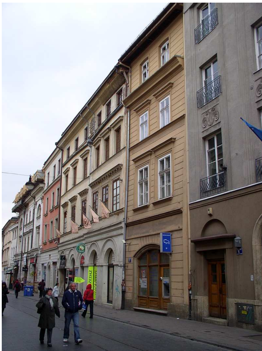
Fot. nr 143. Zabudowa ulicy Szewskiej pnie się go góry. Właśnie nadbudowano III piętra kamienic pod nr: 3 i 7. 26.11.10
