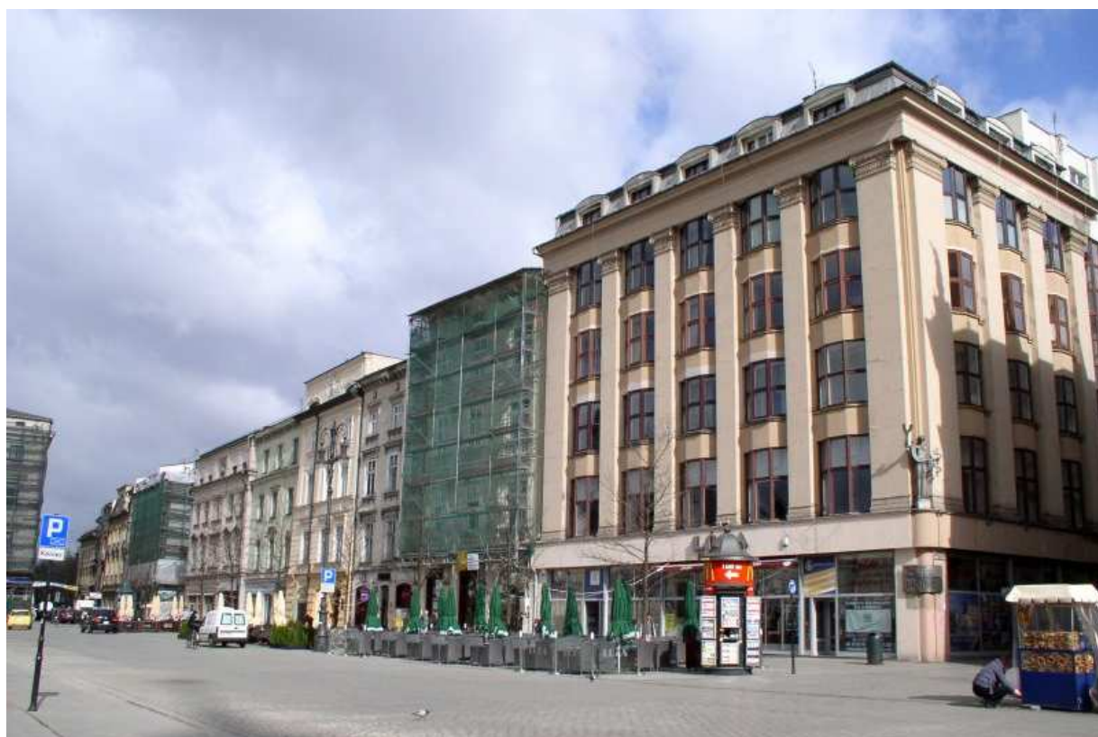
Fot. nr 71 (71-72). Fragment linii A-B, czyli południowej pierzei Rynku, pomiędzy ulicami: św. Jana i Sławkowską – widok od strony Sukiennic. 09.04.11
