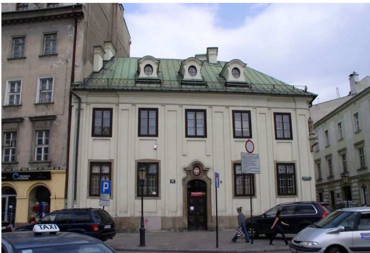
Fot. nr 198. Budynek dawnej mennicy pod nr 16. 17.04.09
