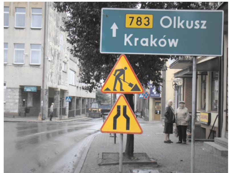
Remont głównych ulic miasta idzie pełną parą; oby zdążyć przed zapowiadaną wczesną zimą!
