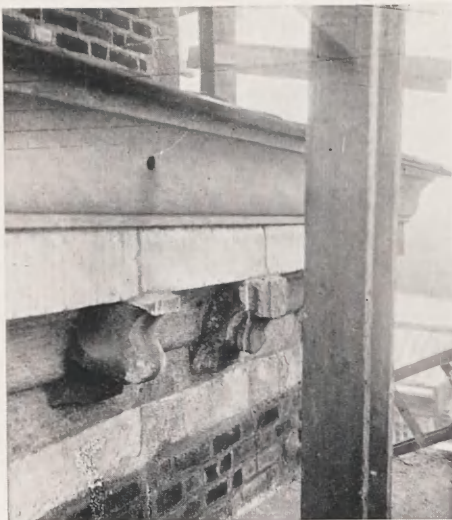
Fig. 7. Wieża ratuszowa. Konsola średniowieczna i gzyms wieńczący nowszy.
