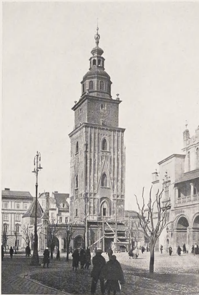
Fig. 1. Wieża ratuszowa. Fot. Witold Loziński.
