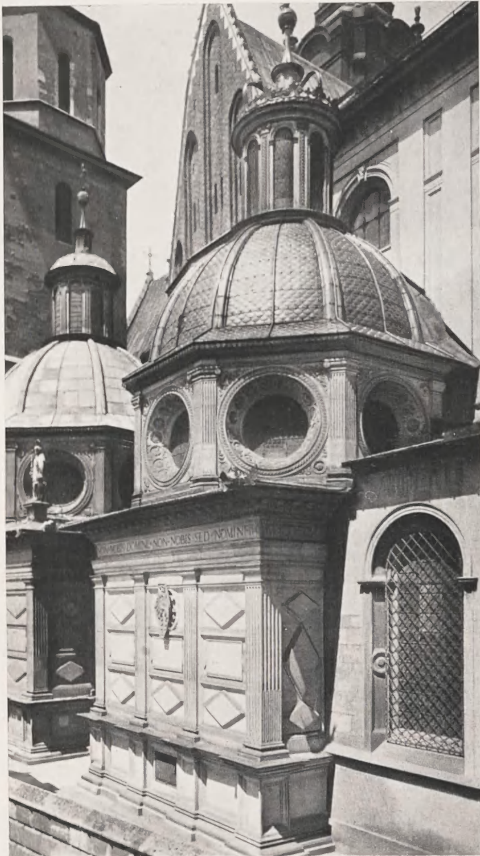
Fig. 10. Kaplica Zygmuntowska od południowego wschodu.
