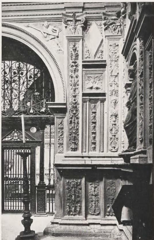
Fig. 18. Połowa ściany wchodowej,
