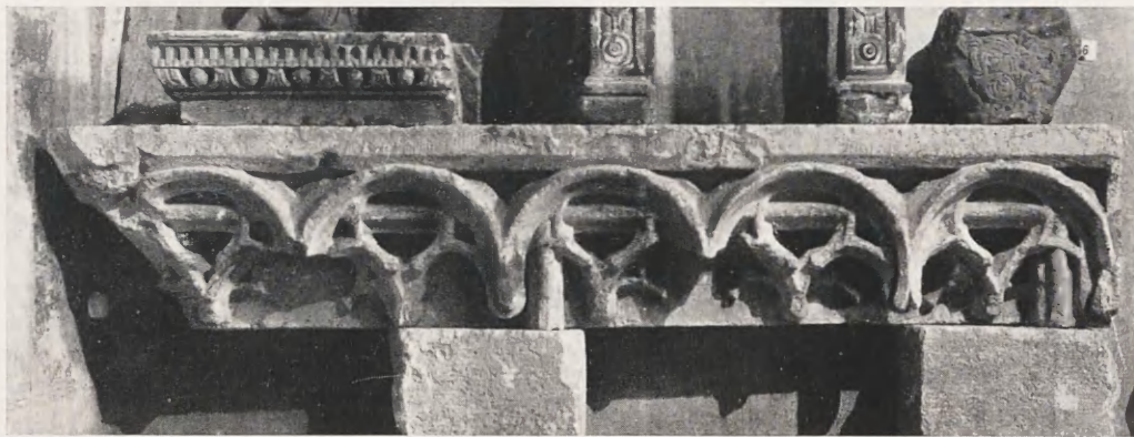
Fig. 8. Wieża ratuszowa. Gzyms rzeźbiony wyjęty z zewnątrz.
