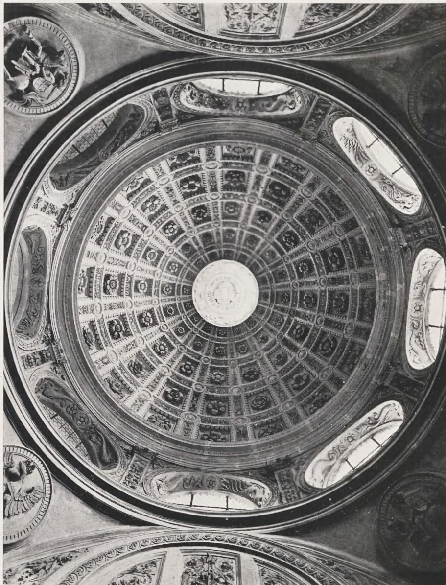
Fig. 20. Wnętrze bębna i kopuły.
