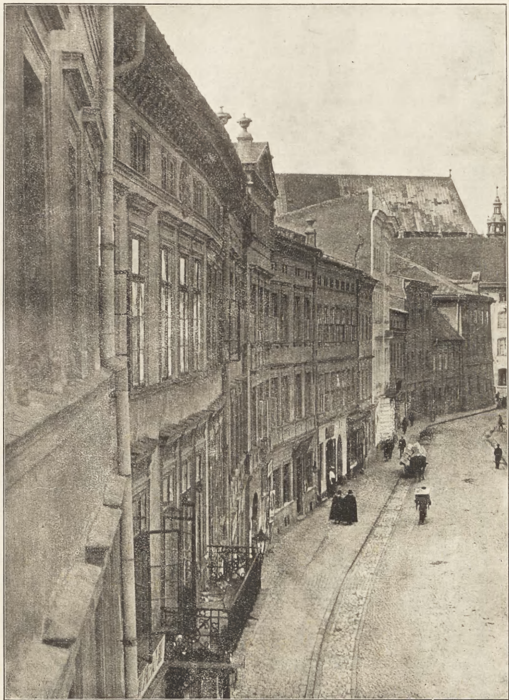
ULICA STOLARSKA OD PLACU DOMINIKAŃSKIEGO.
