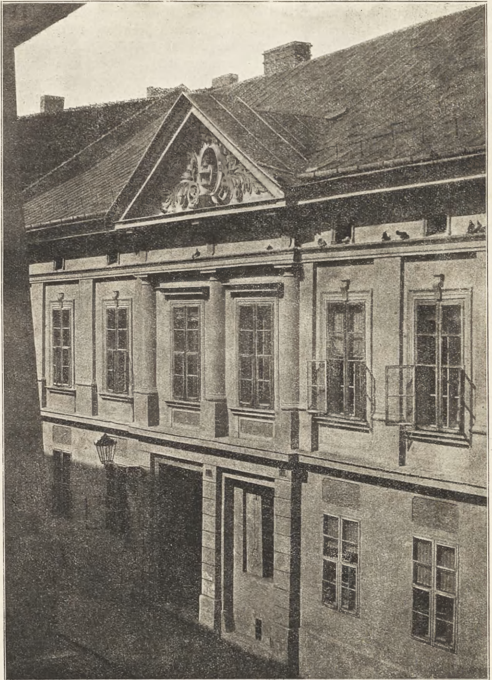
DOM BARTYNOWSKICH PRZY UL. ŚW. TOMASZA NR. 28.
