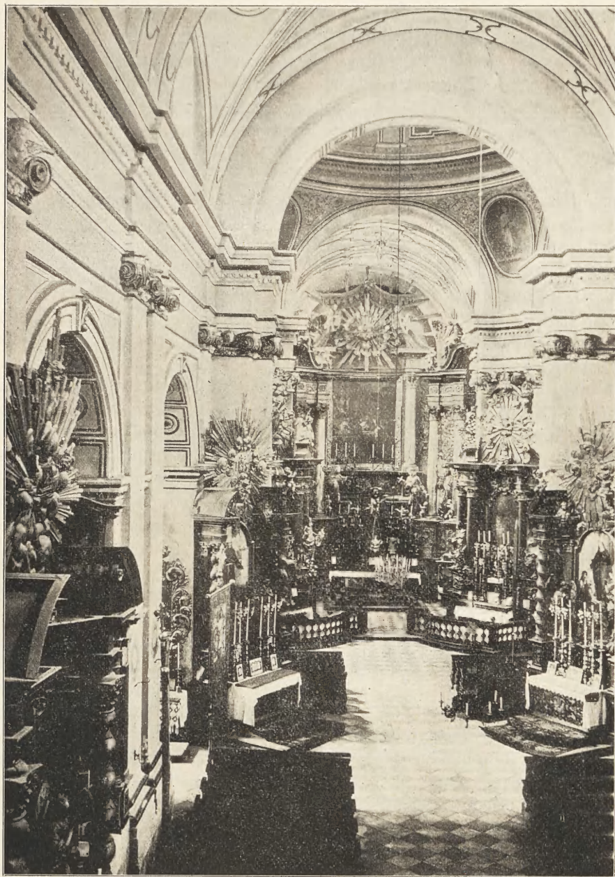
Fig 15. Wnętrze kościoła OO. Bernardynów w Krakowie.
