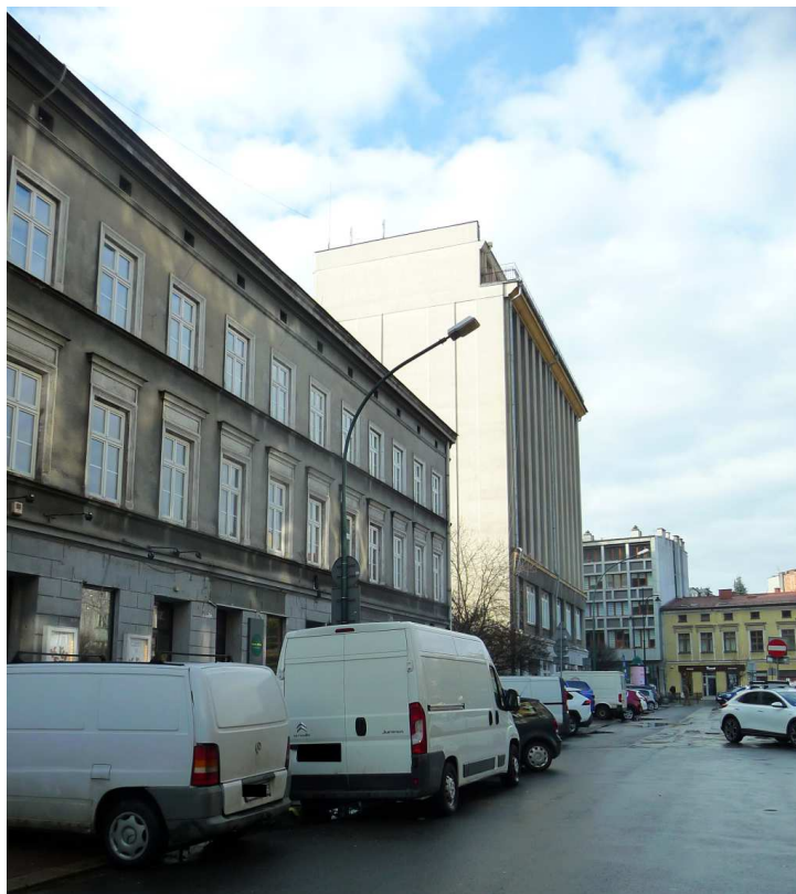
Fot. nr 255. Podmiejska zabudowa na styku ulicy Paderewskiego i Rynku Kleparskiego.
