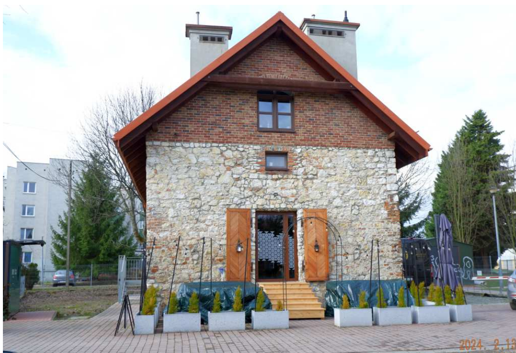
Fot. nr 494. Boczna ściana.
