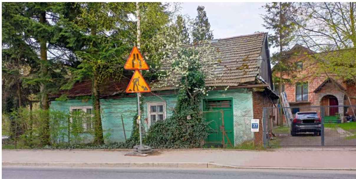
Fot. nr 453 (453-455). Dawna chałupa, zapewne z okolic przełomu wieków XIX i XX, z ulicy Malborskiej 37 i jej detale. (20.04.2023)
