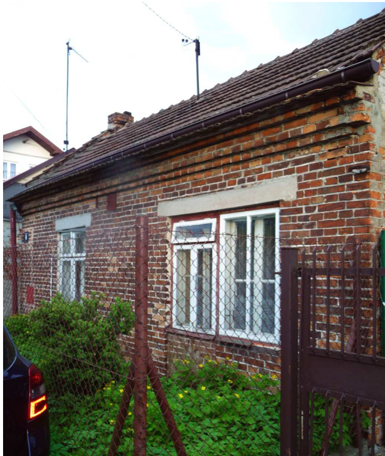
Fot. nr 409 (409-410). Murowany oryginał spod nr 8. (08.05.2023)
