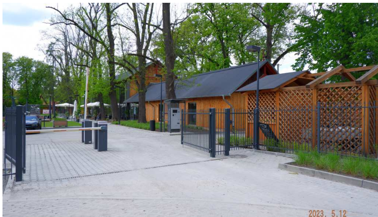
Fot. nr 228. Tylny fragment budynku.
