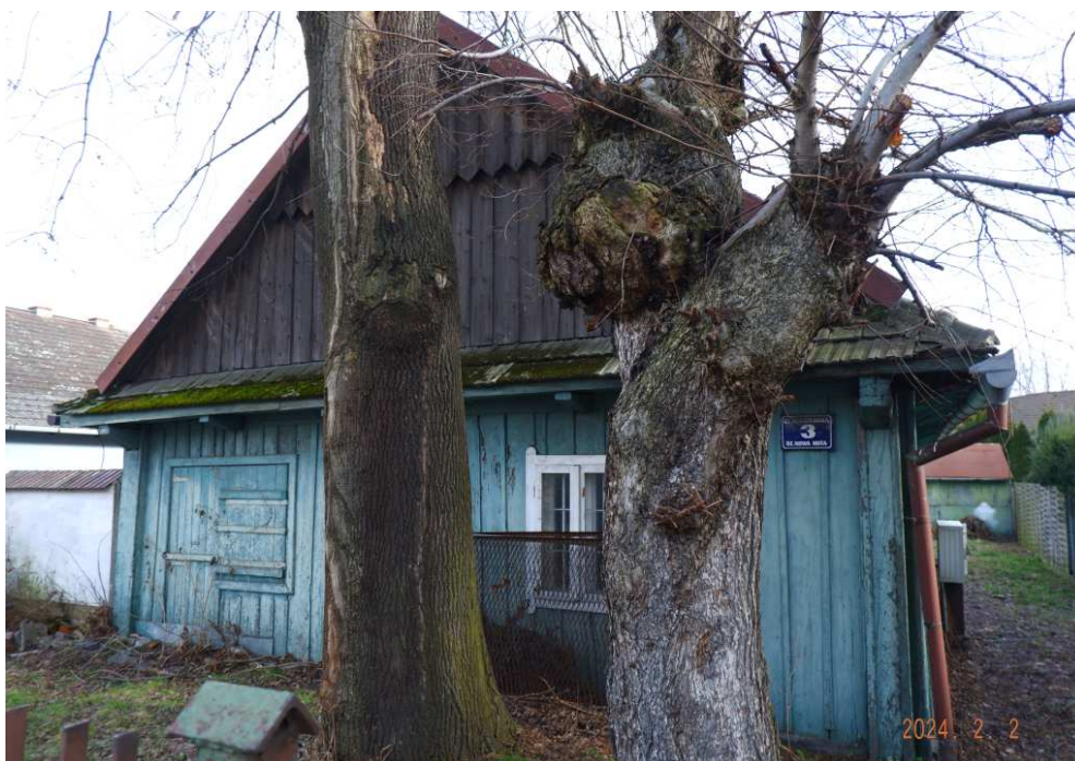
Fot. nr 304. Ściana szczytowa od strony ulicy.
