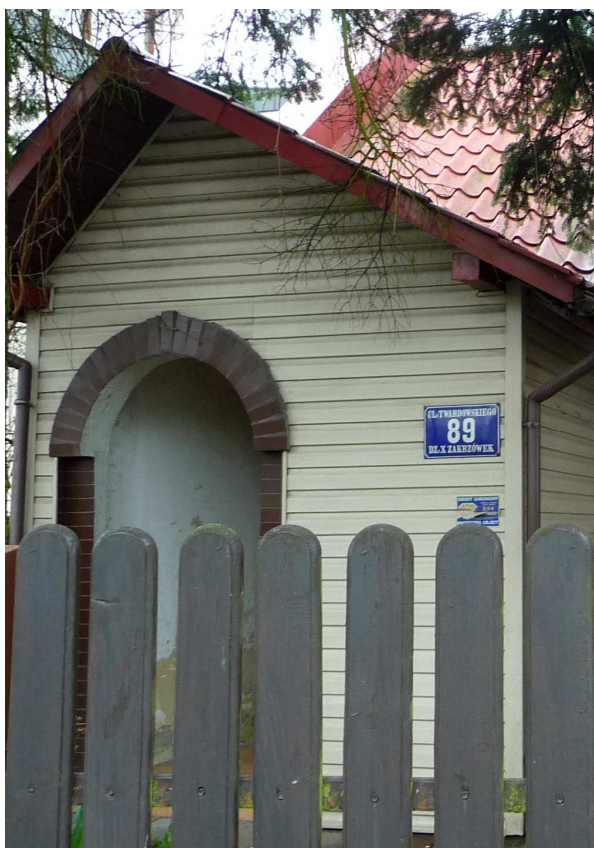
Fot. nr 388. Przebudowany ganek i tabliczka z czasów Wielkiego Krakowa.
