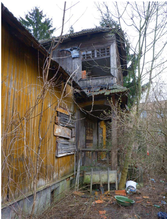
Fot. nr 579 (579-580). Próby uchwycenia fasady z efektownym gankiem i galeryjką widokową przez zakrzaczone przedpole obiektu. (20.03.2023)
