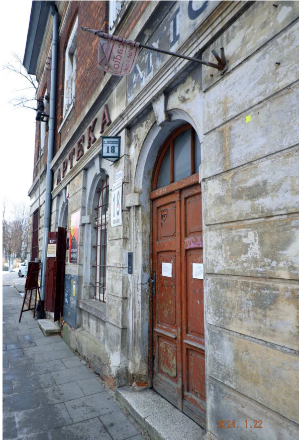
Fot. nr 161. Parter budynku.
