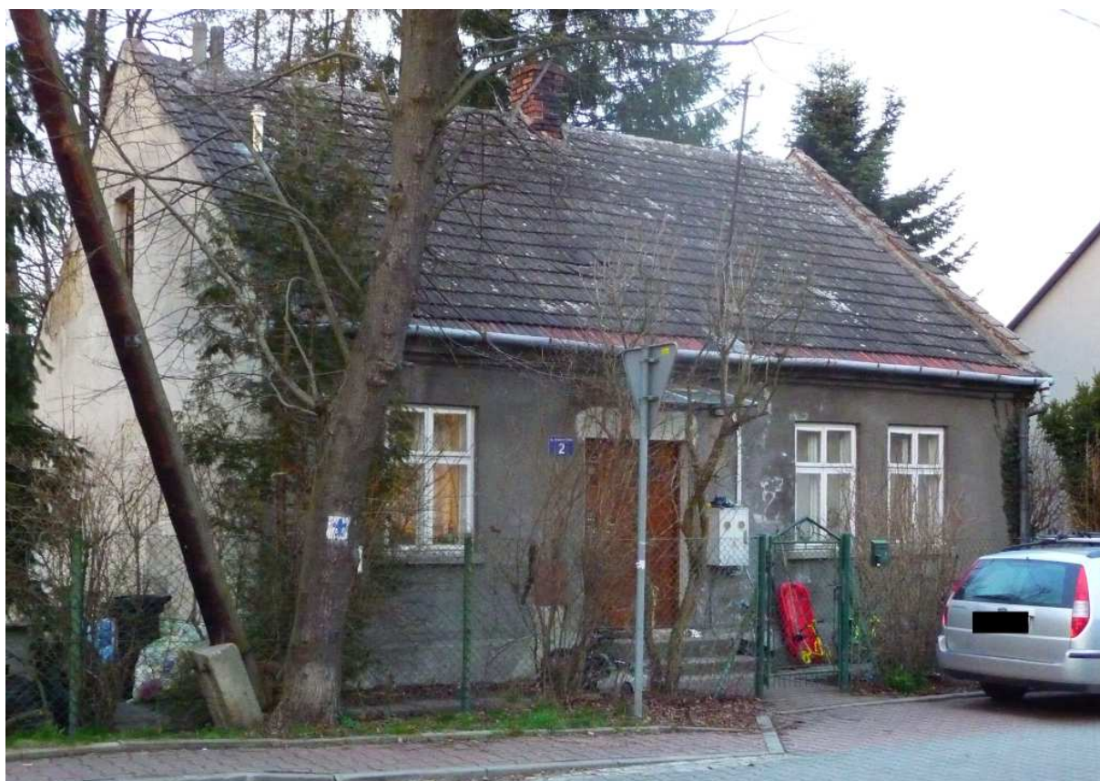
Fot. nr 652. Murowany dom z oryginalnymi oknami typu skrzynkowego z ulicy Światowida 2. (25.02.2024)
