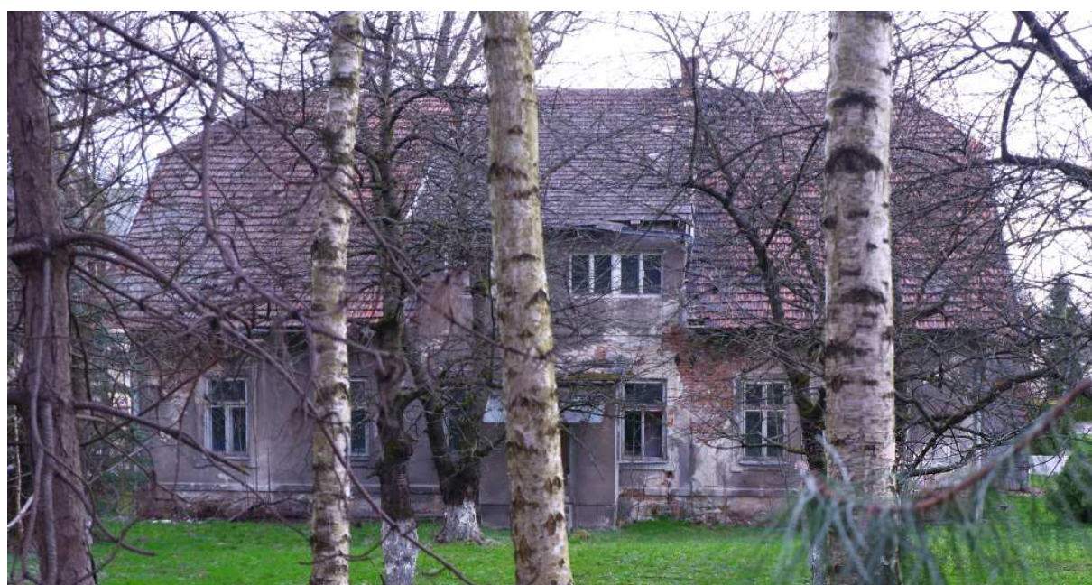
Fot. nr 638. Elewacja od strony ogrodu. (25.03.2023)
