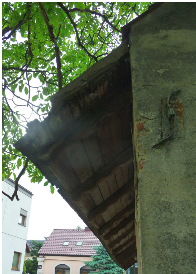
Fot. nr 504. Więźba dachowa. (08.06.2023)
