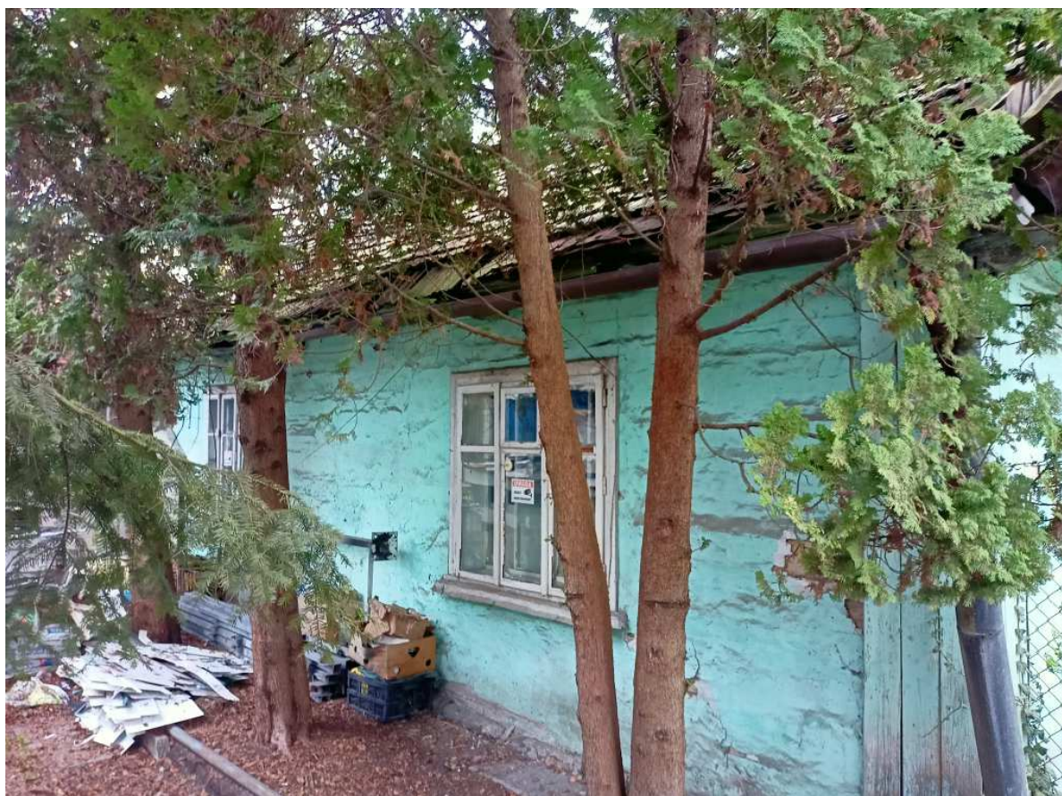
Fot. nr 454. Oryginalne okna chałupy we fragmencie od strony podwórka. (20.04.2023)
