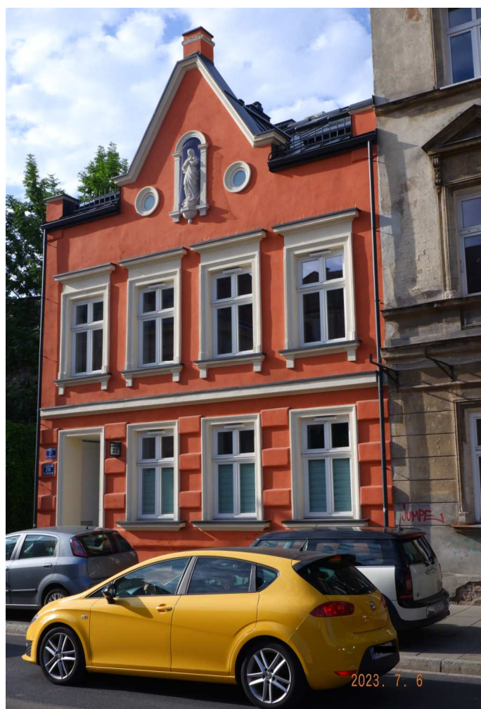
Fot. nr 32. Przykładnie odnowiona fasada kamieniczki pod nr 21.
