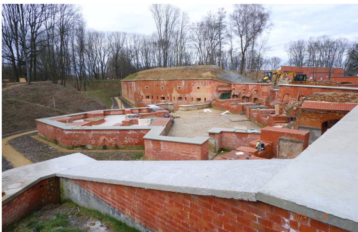
Fot. nr 212 (212-214). Bliskie ukończenia prace wg stanu z końca lutego roku 2024. (26.02.2024)
