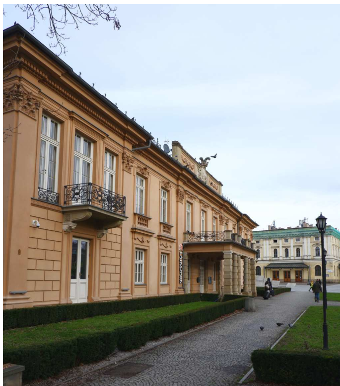
Fot. nr 250. Pałac Wołodkowiczów z roku 1884 przy ulicy Lubicz 4. (02.01.2024)
