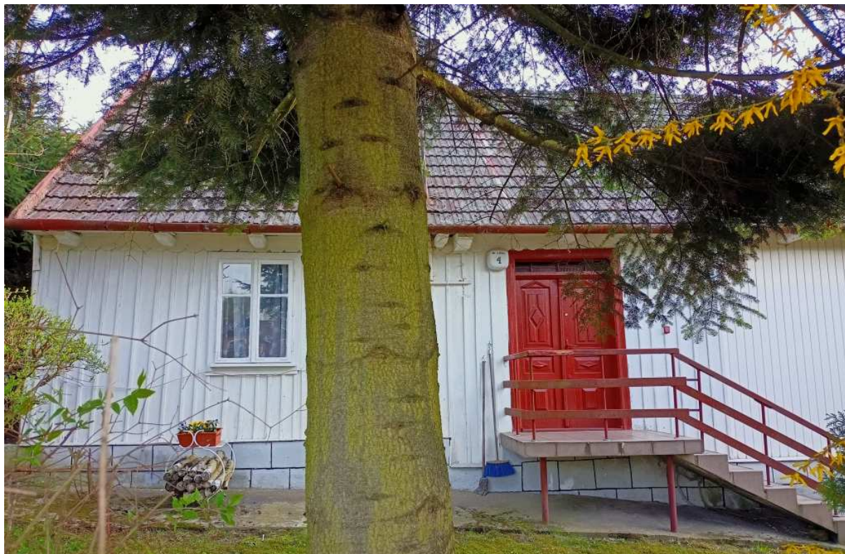
Fot. nr 648. Oryginalne detale: okienko i drzwi. (16.03.2024)
