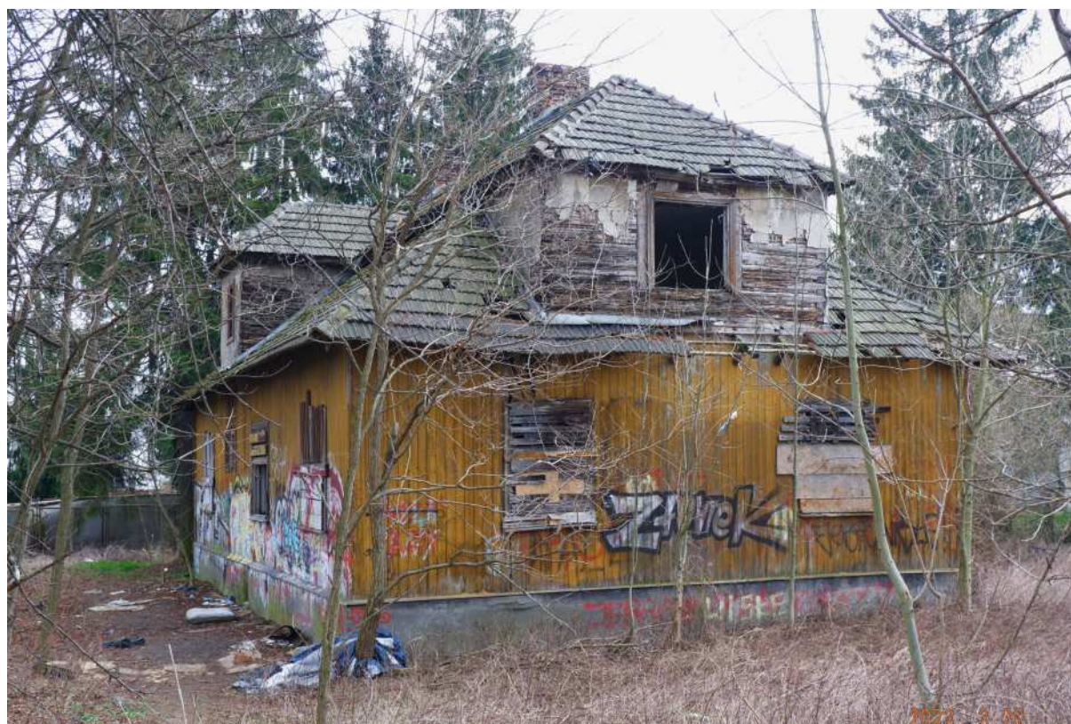
Fot. nr 578 (578-580). Będąca już w stanie nieodwracalnej ruiny willa z I. ćwierci XX wieku z ulicy Czechowicza 10. Tylna część od strony torów kolejowych.
