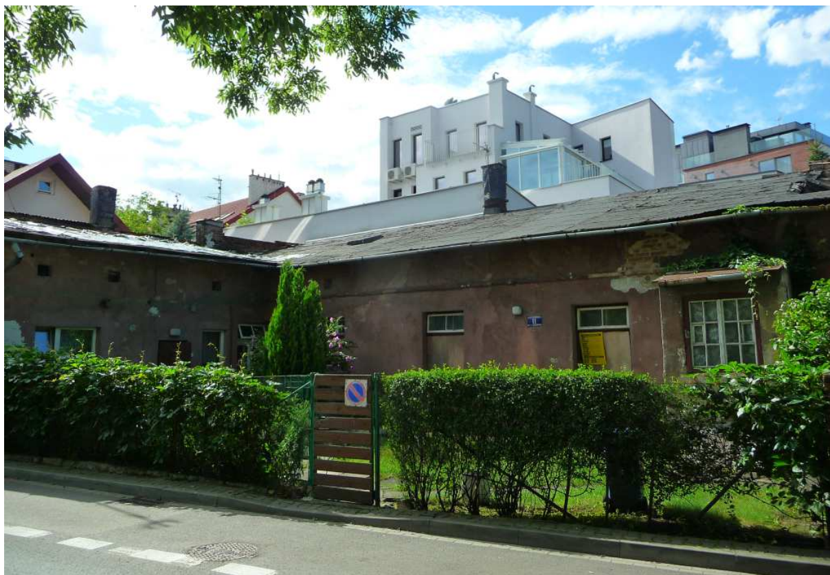
Fot. nr 353 (353-354). Relikt parterowej zabudowy Zakrzówka pod nr 11, który zapewne niebawem zniknie. ((02.08.2023)
