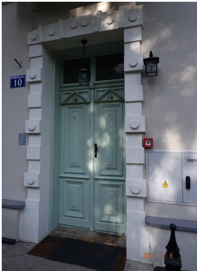
Fot. nr 75. Oryginalny portal i drzwi wejściowe.
