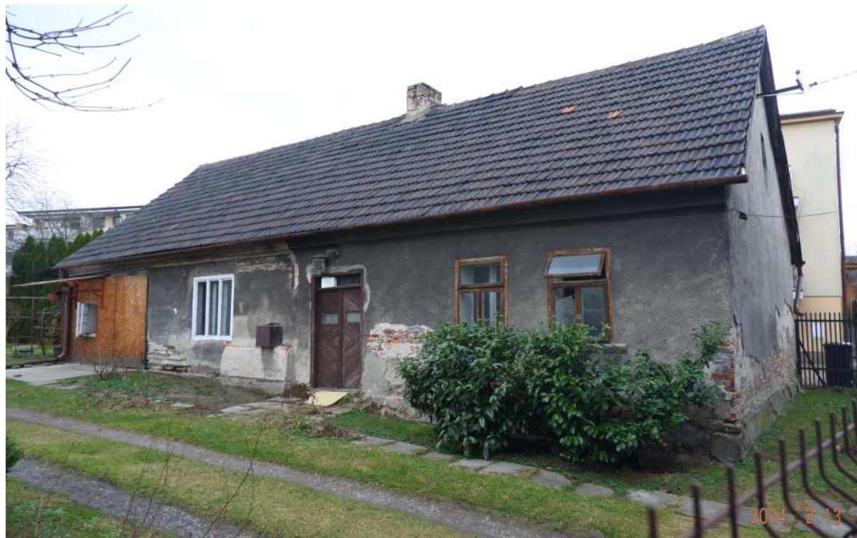
Fot. nr 529. Fasada.
