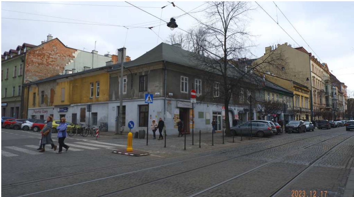
Fot. nr 51. Narożnik z ulicą Garbarską.
