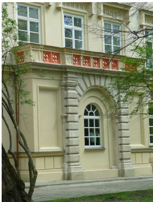
Fot. nr 144. Prawy wykusz również z wykorzystaniem portalu pałacu. (27.04.2023)
