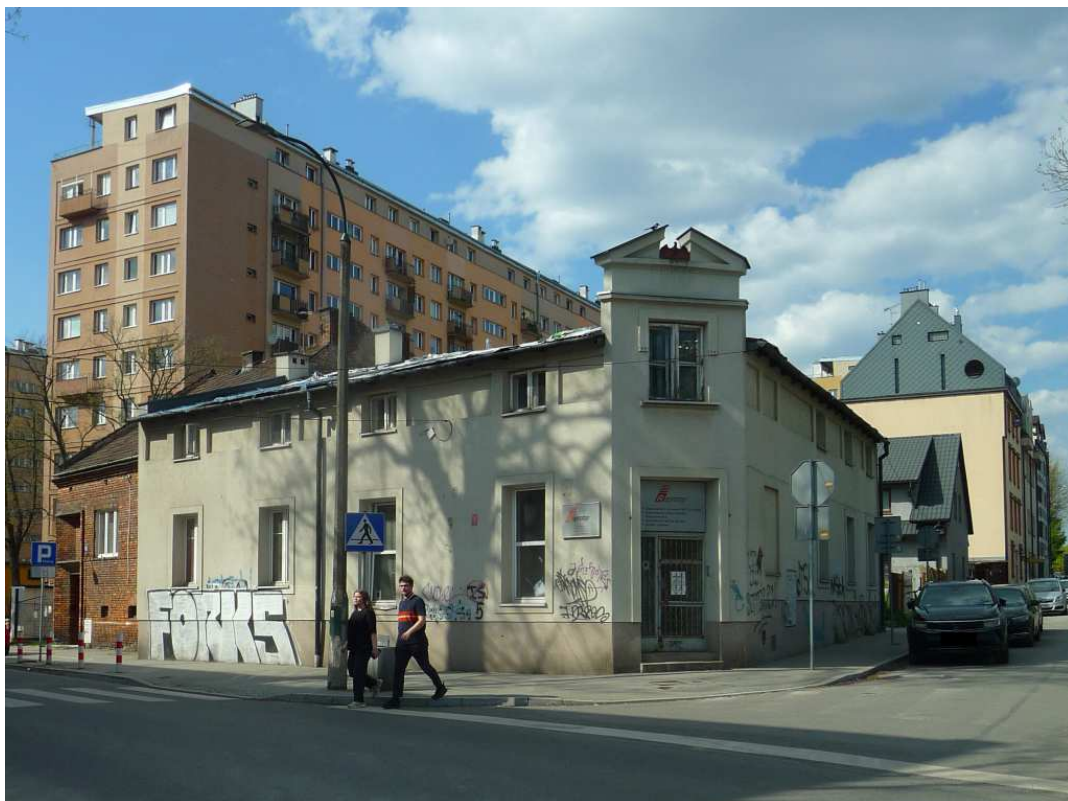
Fot. nr 130 (130-131). Kamieniczka „pod orłem” z roku 1911 przy ulicy Mazowieckiej 113, która niebawem może zostać szpetnie przebudowana. (23.04.2023)
