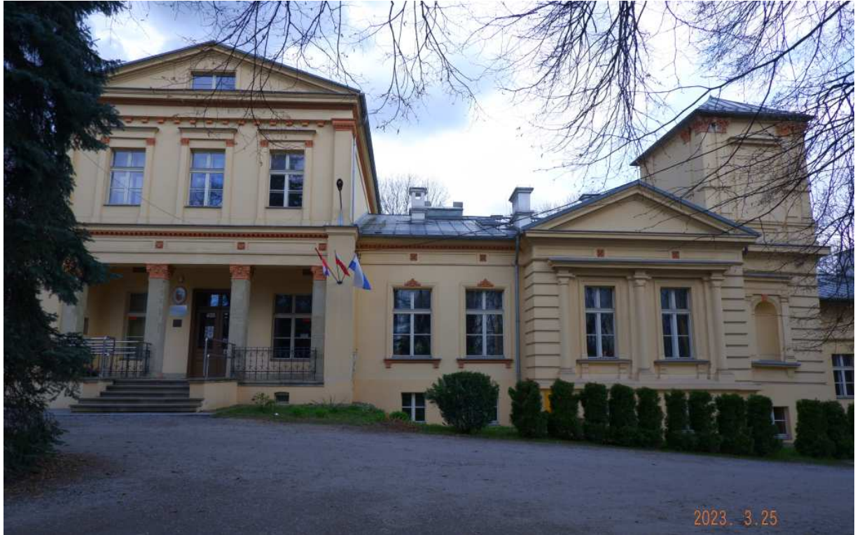
Fot. nr 641. Kolumnowy ryzalit środkowy i prawe skrzydło z wieżą.
