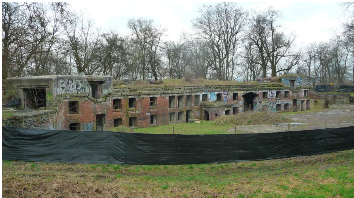
Fot. nr 657 (657-658). Fort wodny nr 50A (Lasówka) w oczekiwaniu na rewitalizację. (02.03.2024)
