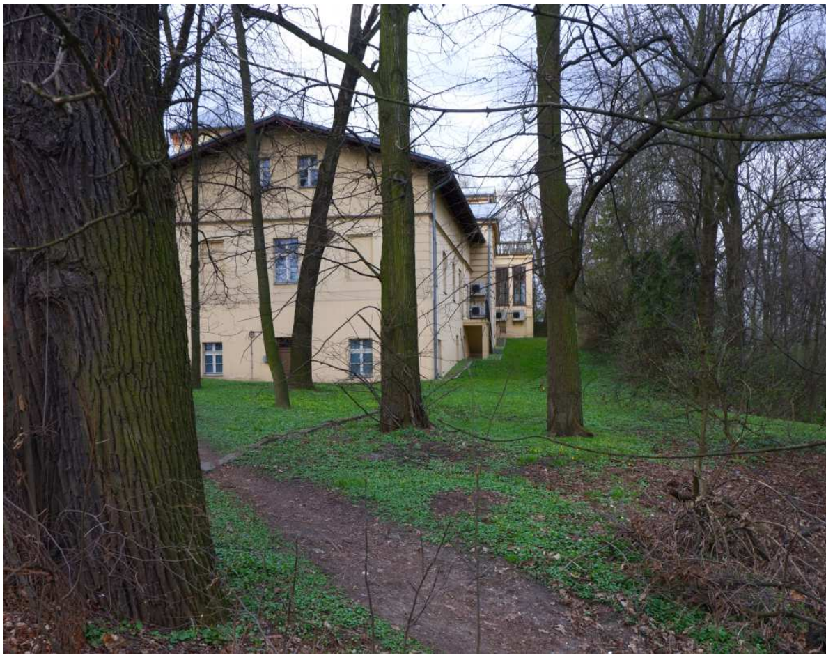
Fot. nr 639 (639-643). Zespół dworsko-parkowy Czeczów przy ulicy Popiełuszki 36. Dwór to rozległy pałacyk wzniesiony po roku 1873 w stylu eklektycznym z inicjatywy Karola Czecha de Lindewald, w miejscu dawnego dworu z XV wieku. (25.03.2023)
