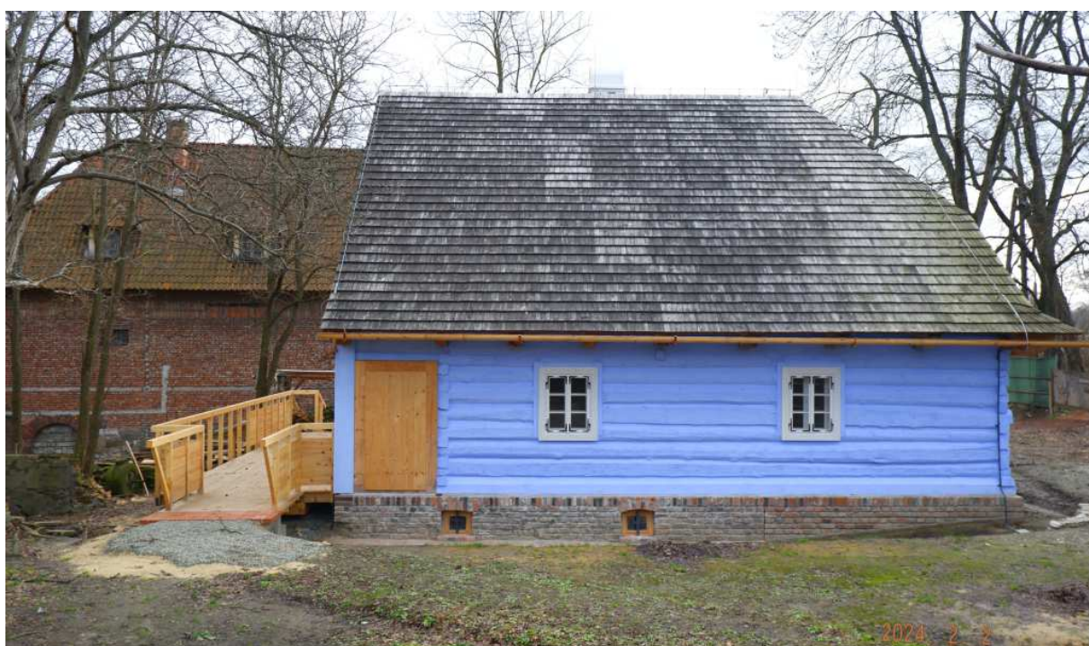
Fot. nr 322. Fragment od strony ulicy.
