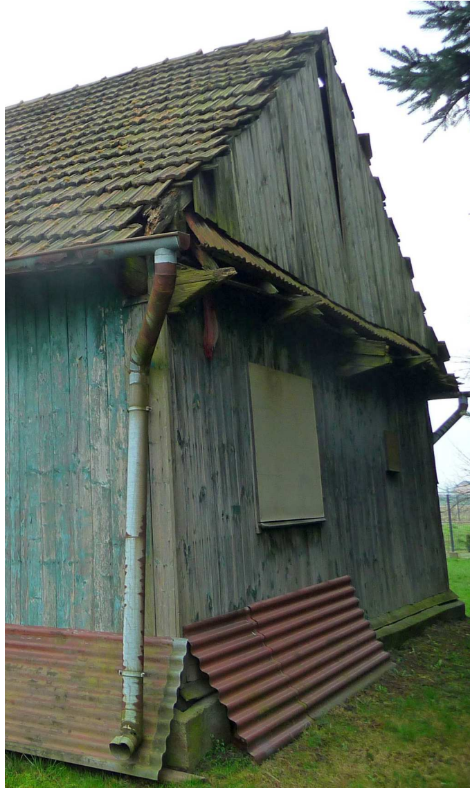
Fot. nr 661. Ściana szczytowa chałupy. (02.03.2024)
