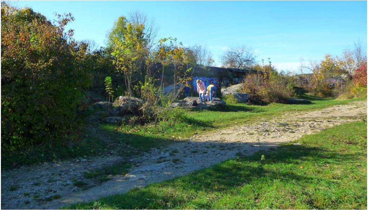
Fot. nr 399 (399-402). Wokół ruin międzypolowego fortu artyleryjskiego nr 53 Bodzów. (02.11.2023)
