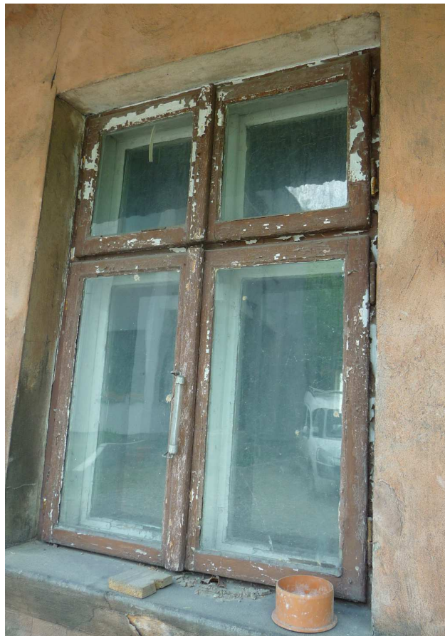
Fot. nr 506. Oryginalne okno typu skrzynkowego. (08.06.2023)
