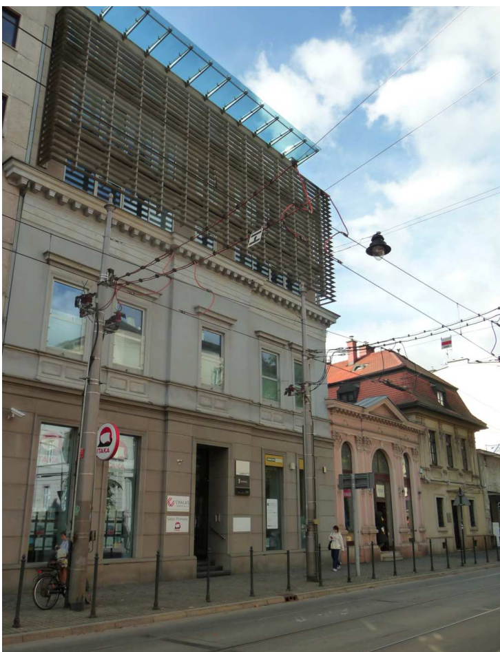
Fot. nr 34 (34-52). Wzdłuż ul. Karmelickiej. Fragment zabudowy o nr: 66-68. (04.10.2023)
