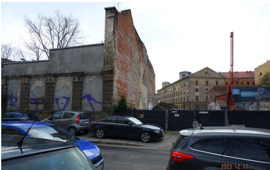
Fot. nr 31. Pusta przestrzeń po wyburzonym budynku spod nr 4.
