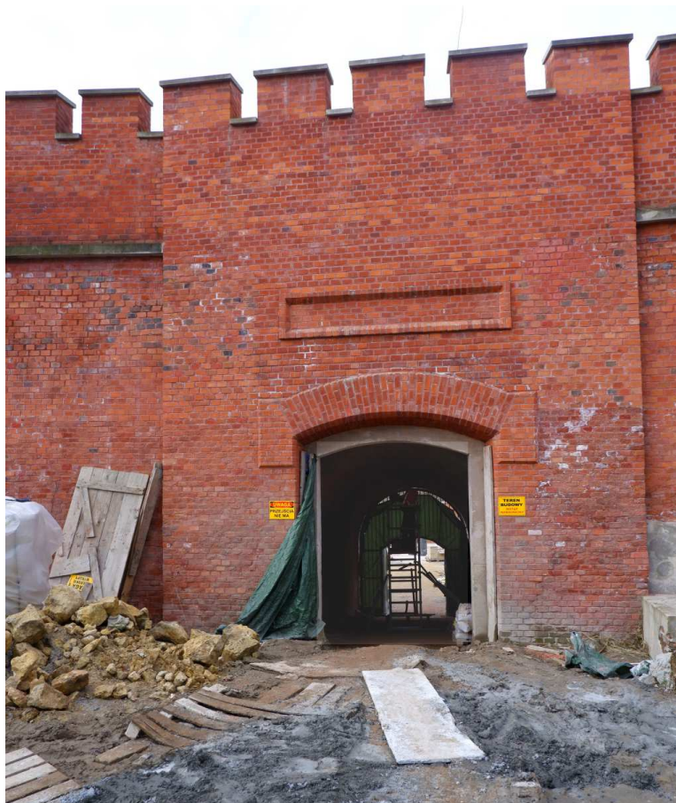
Fot. nr 205. Brama wjazdowa do bastionu nr 2. (26.02.2024)
