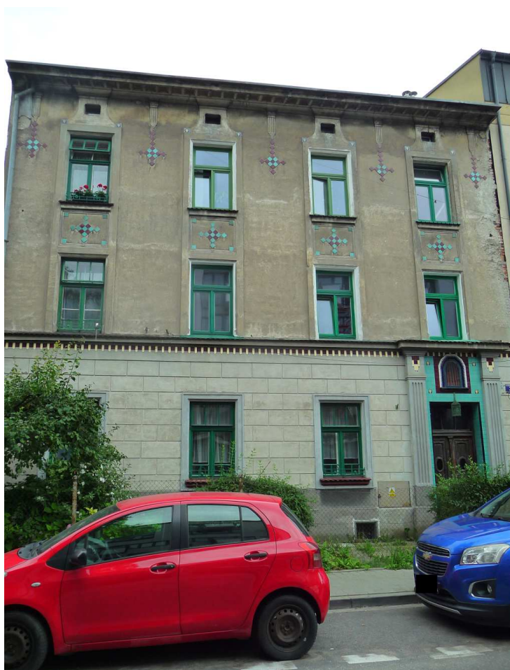
Fot. nr 364 (364-365). Kamienica pod nr 34 z I. dekady XX w. i jej detale. (01.08.2023)
