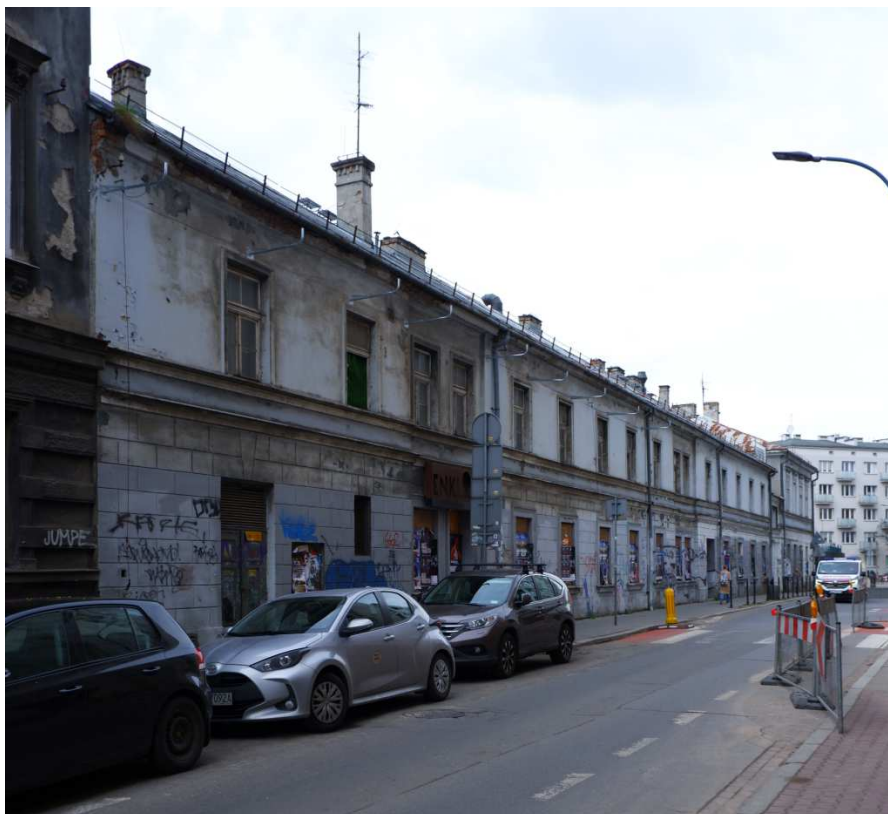
Fot. nr 24 (24-27). Zabudowania dawnej Krakowskiej Fabryki Tytoniowej pod nr: 10-12 przed zbliżającymi się zmianami. Fot. nr: 23-24 - budynek socjalny. (14.04.2023)
