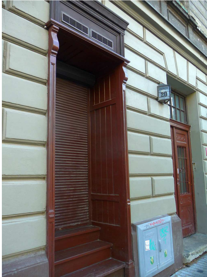
Fot. nr 9. Wejście do dawnego zakładu ślusarskiego Brzezickiego pod nr 20. (04.10.2023)
