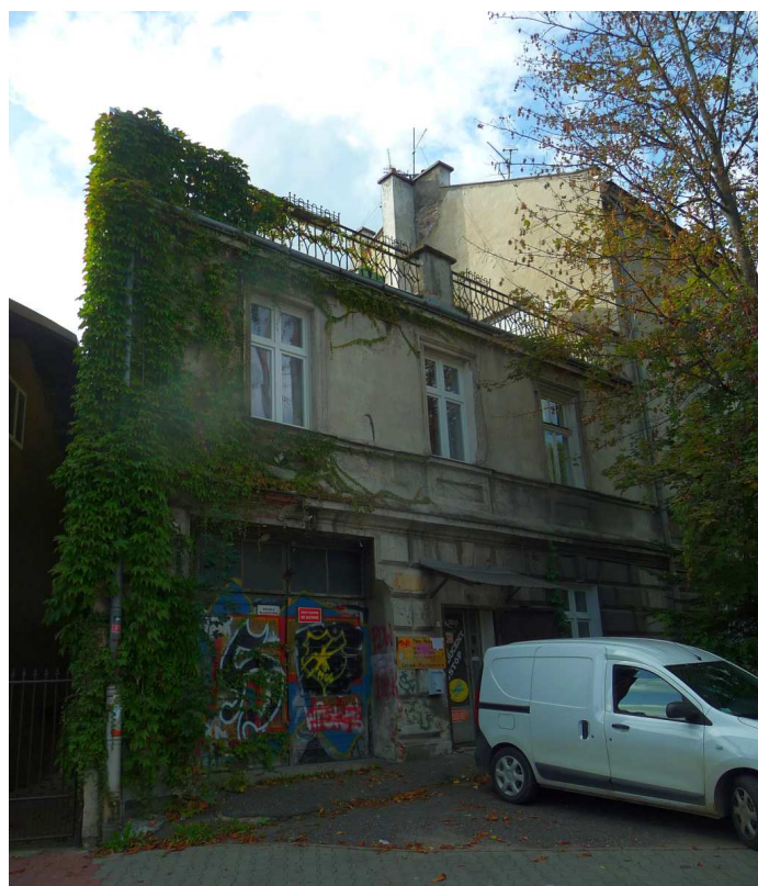
Fot. nr 344. Dom spod nr 2. (12.10.2023)
