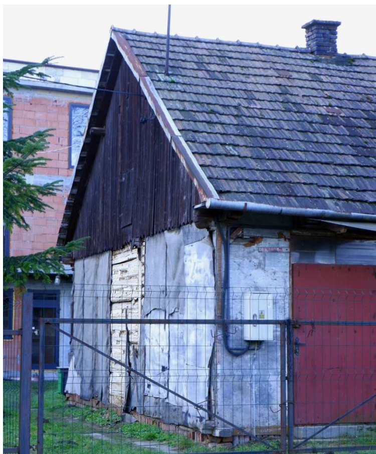
Fot. nr 302. Ściana boczna z widocznym pośrodku belkowaniem pierwotnej chałupy. (02.02.2024)
