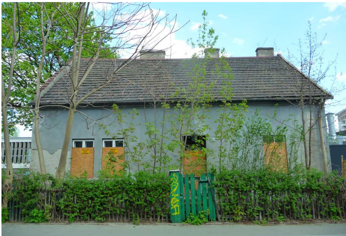
Fot. nr 108. Fasada już z zabitymi deskami oknami typu skrzynekowego. (23.04.2023)
