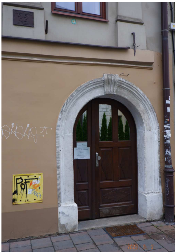
Fot. nr 54. Portal wejściowy.
