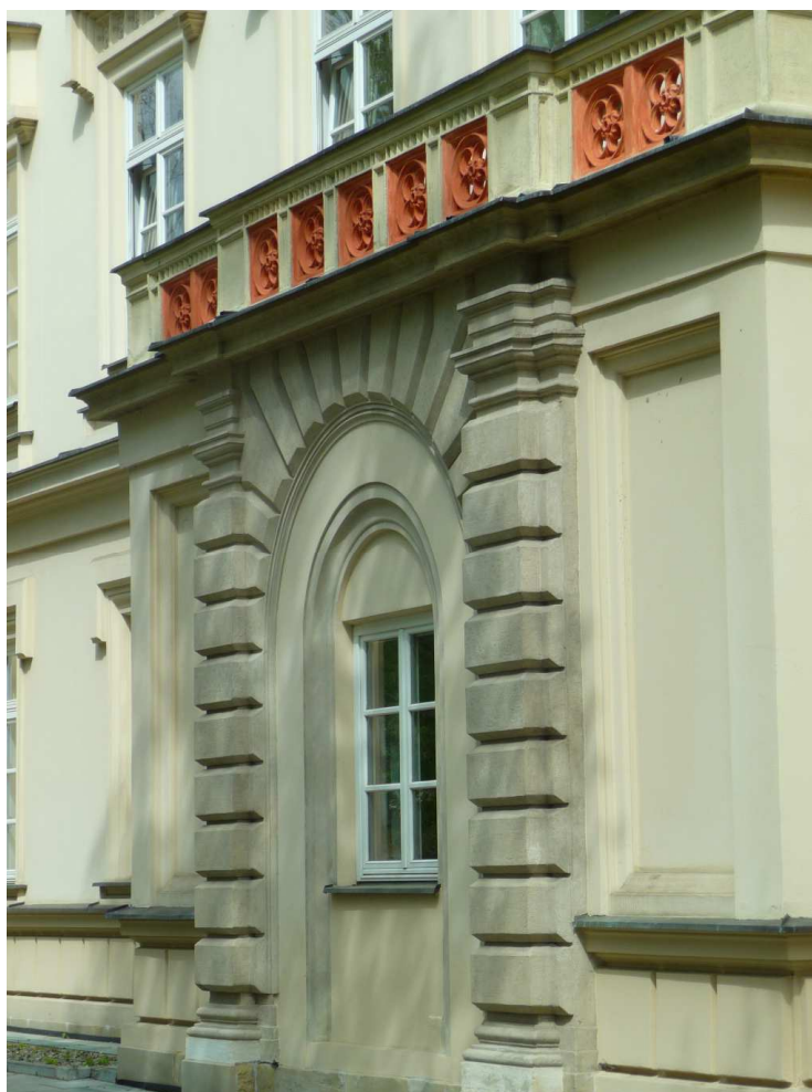
Fot. nr 142. Lewy wykusz z wykorzystaniem boniowanego portalu pałacu. (27.04.2023)
