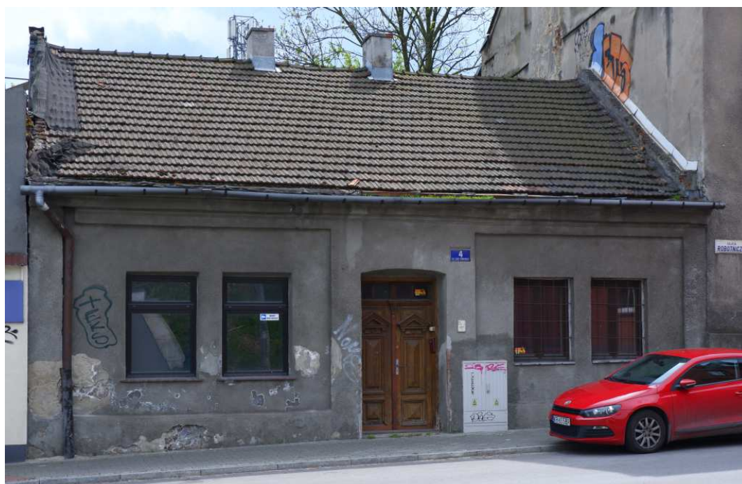
Fot. nr 440 (440-441). Zapewne ponad stuletni dom pod nr 4 i jego detale. (02.05.2023)
