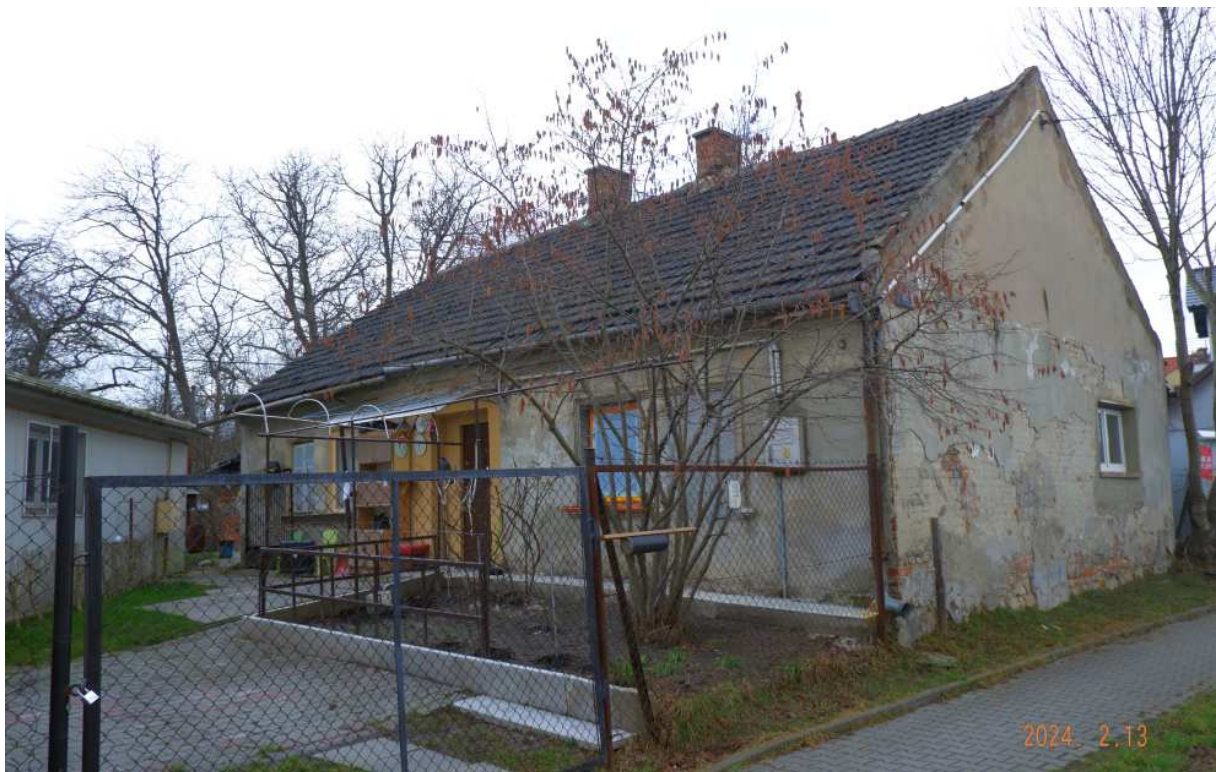
Fot. nr 537. Przebudowany dom pod nr 29.
