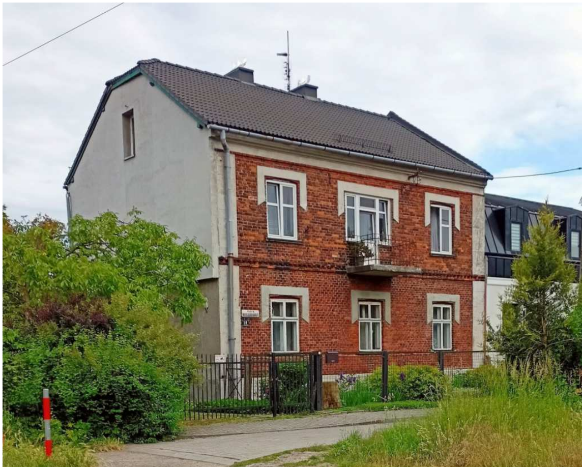
Fot. nr 574. Zapewne około 100-letni podmiejski dom z ulicy Darasza 14, gdzie w parterze zachowały się oryginalne okna typu skrzynkowego.
