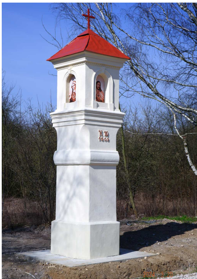
Fot. nr 393 (393-393a). Odnowiona i wzbogacona w obrazy we wnękach kapliczka słupowa, datowana na rok 1909, zapewne dawna latarnia stojąca rozstaju lokalnych dróg, dziś na styku ulic: Pychowickiej i Wyłom. W związku z rewitalizacją Parku Skały Twardowskiego została ona nieco przesunięta w głąb ulicy Wyłom.
