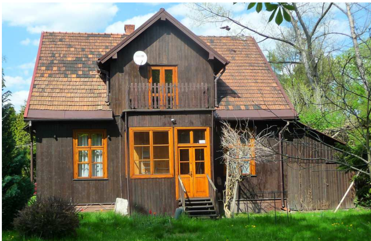
Fot. nr 100. Oryginalna fasada. (23.04.2023)
