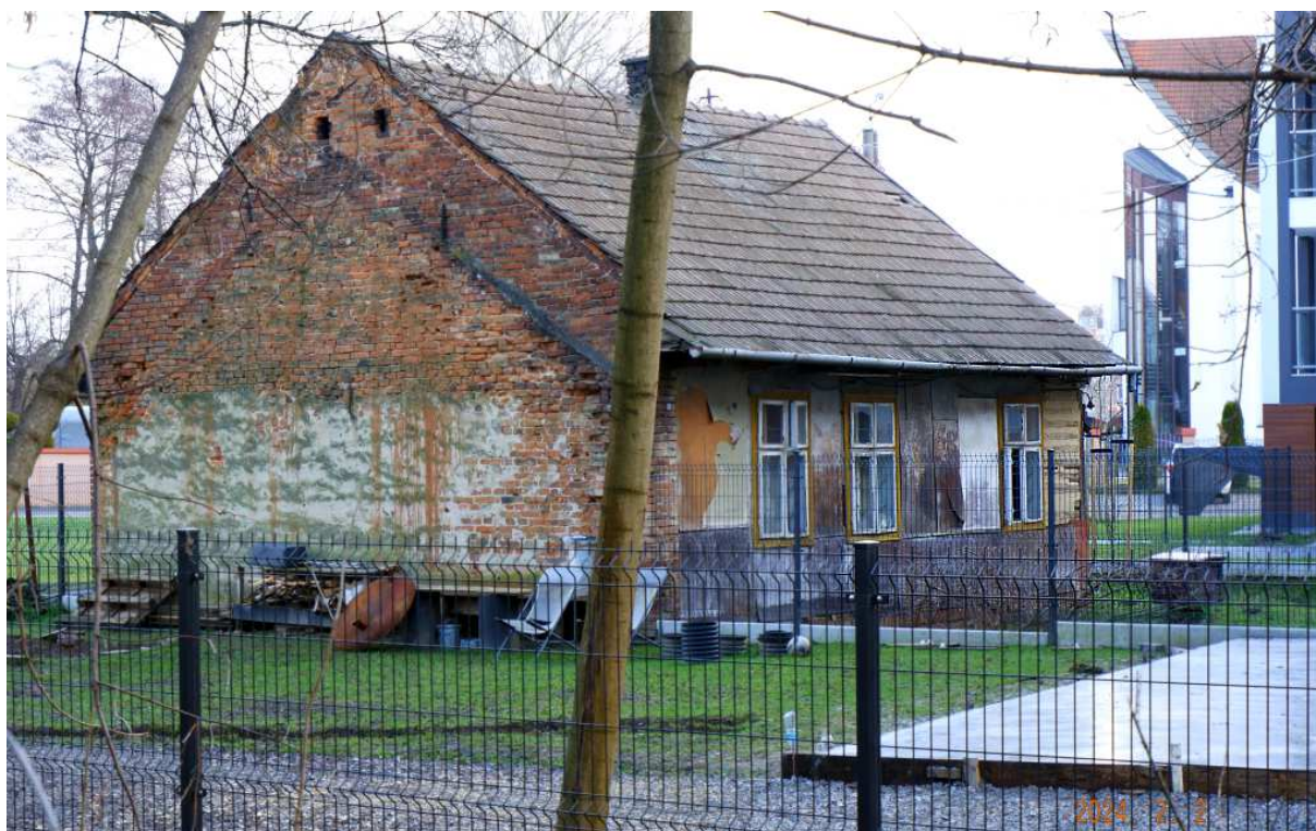
Fot. nr 297 (297-302). Zrujnowana dawna chałupa z ulicy Bulwarowej 11, o czym świadczą zachowane fragmenty wykonanych z drewnianych bali ścian i dwie warstwy dachu, zapewne przebudowana w okresie międzywojennym na murowany dom, obecnie wciśnięta między współczesną zabudowę. Widok od strony podwórka.
