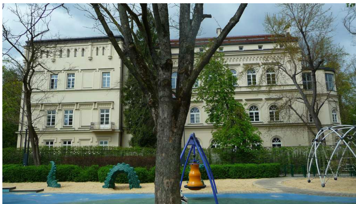
Fot. nr 146. Prawy bok od strony ulicy Kazimierza Wielkiego. (27.04.2023)
