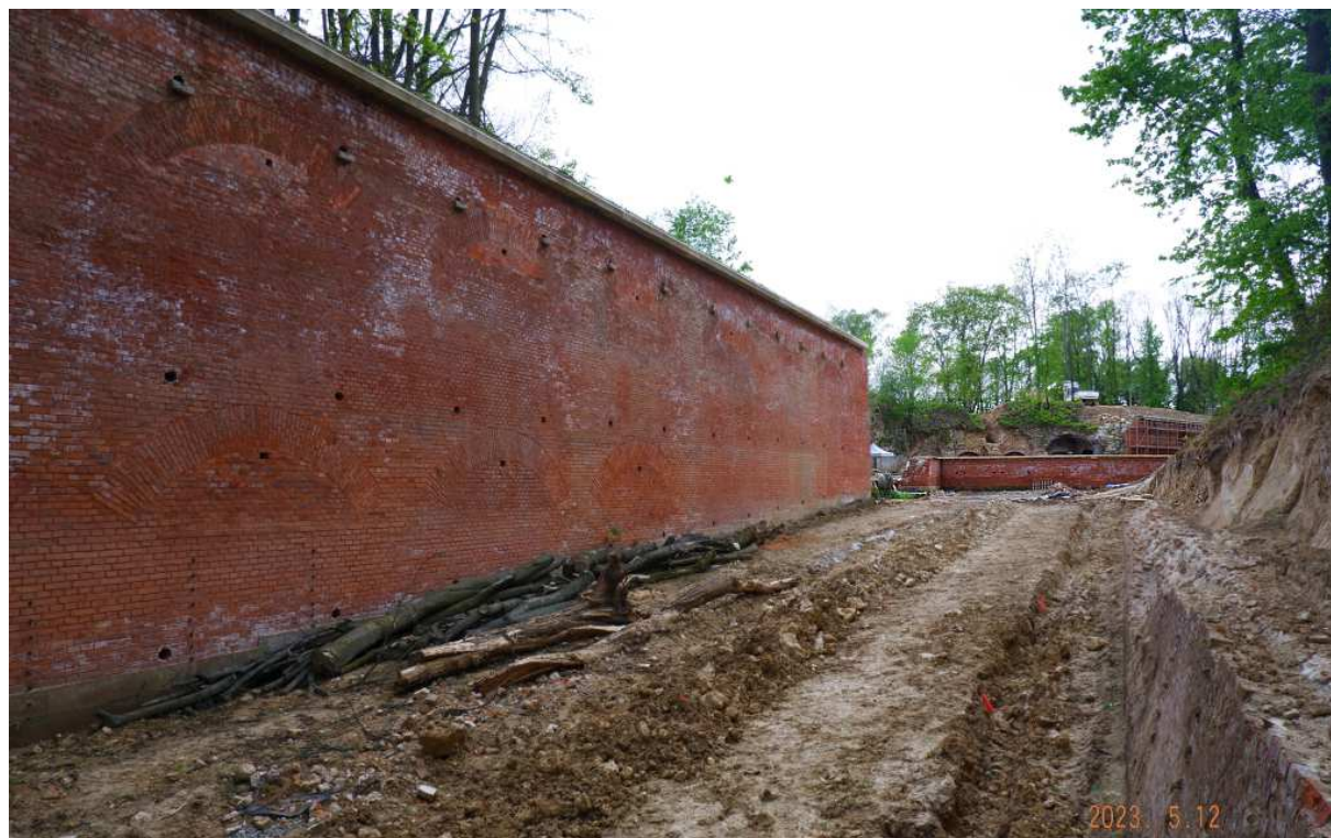
Fot. nr 219. Omurowany wał ziemny bastionu nr 3.
