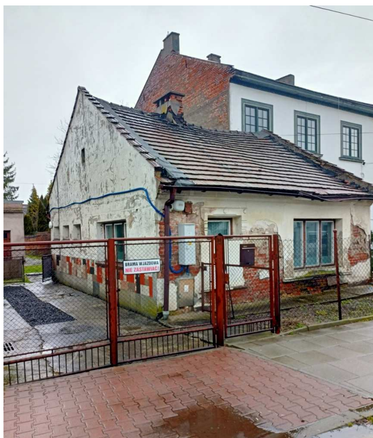
Fot. nr 391. Domek podmiejski spod nr 109 z mocno już zniekształconą fasadą.
