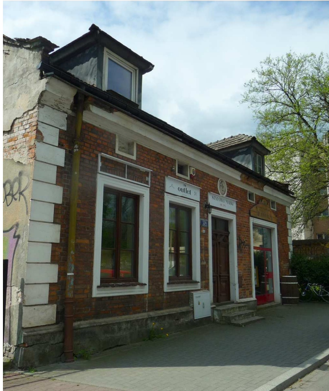
Fot. nr 151 (151-152). Wybudowany pod koniec XIX wieku dom pod nr 124. Fasada domu z nowymi oknami. (27.04.2023)
