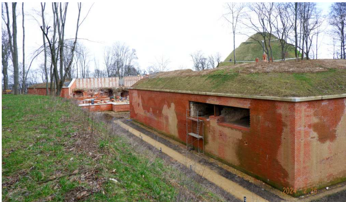
Fot. nr 215. Omurowany wał ziemny bastionu nr 2.
