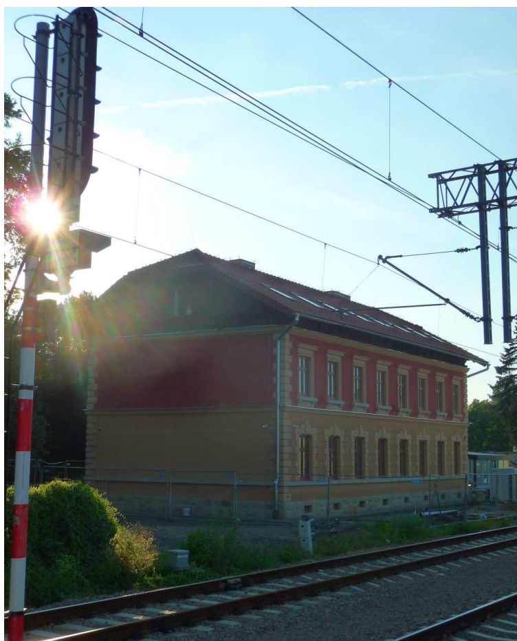
Fot. nr 473 (473-474). Odnowiony budynek stacyjny przy ul. Dworcowej 2b. (20.08.2023)
