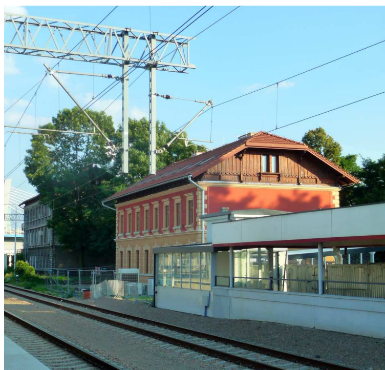
Fot. nr 474. W tle czekający na odnowę budynek pod nr 2c. (20.08.2023)
