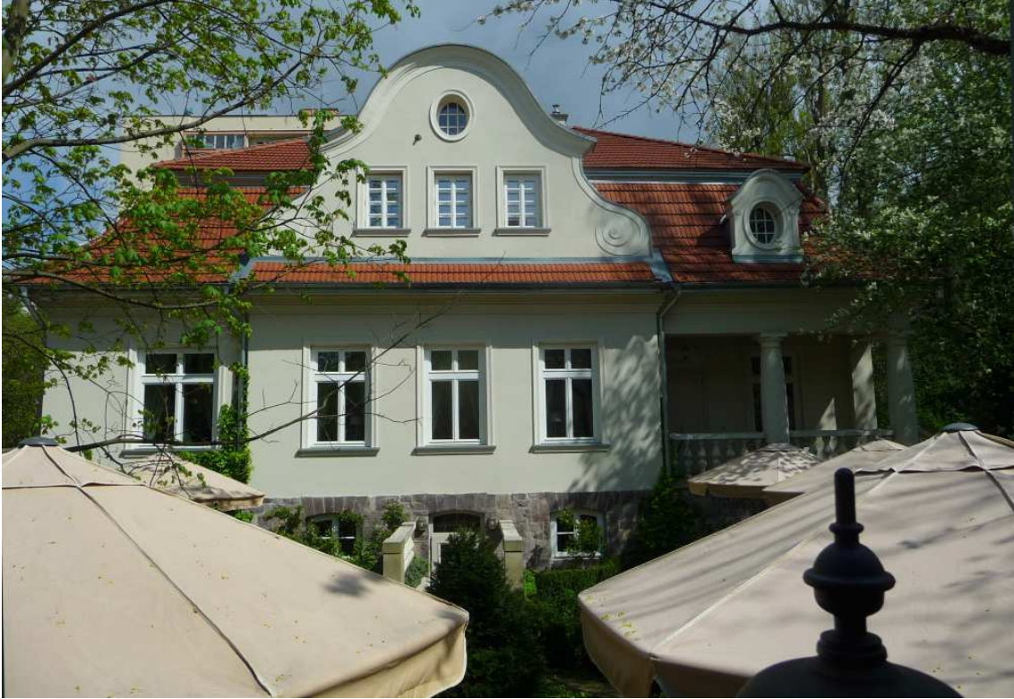
Fot. nr 153. Willa (pod nr 105) Fryderyka Pautscha (1877-1950), znanego malarza z okresu Młodej Polski, reprezentującego nurt folklorystyczno-ekspresjonistyczny, wybudowana ok. roku 1920 wg projektu Józefa Gałęzowskiego. (27.04.2023)
