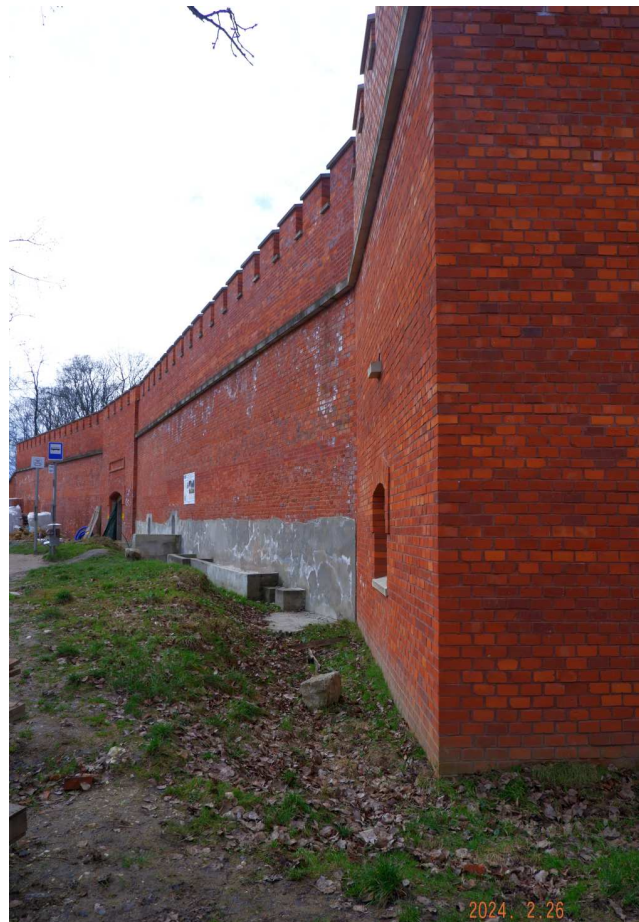
Fot. nr 204. Częściowo zrekonstruowana ściana wewnętrzna bastionu nr 2.
