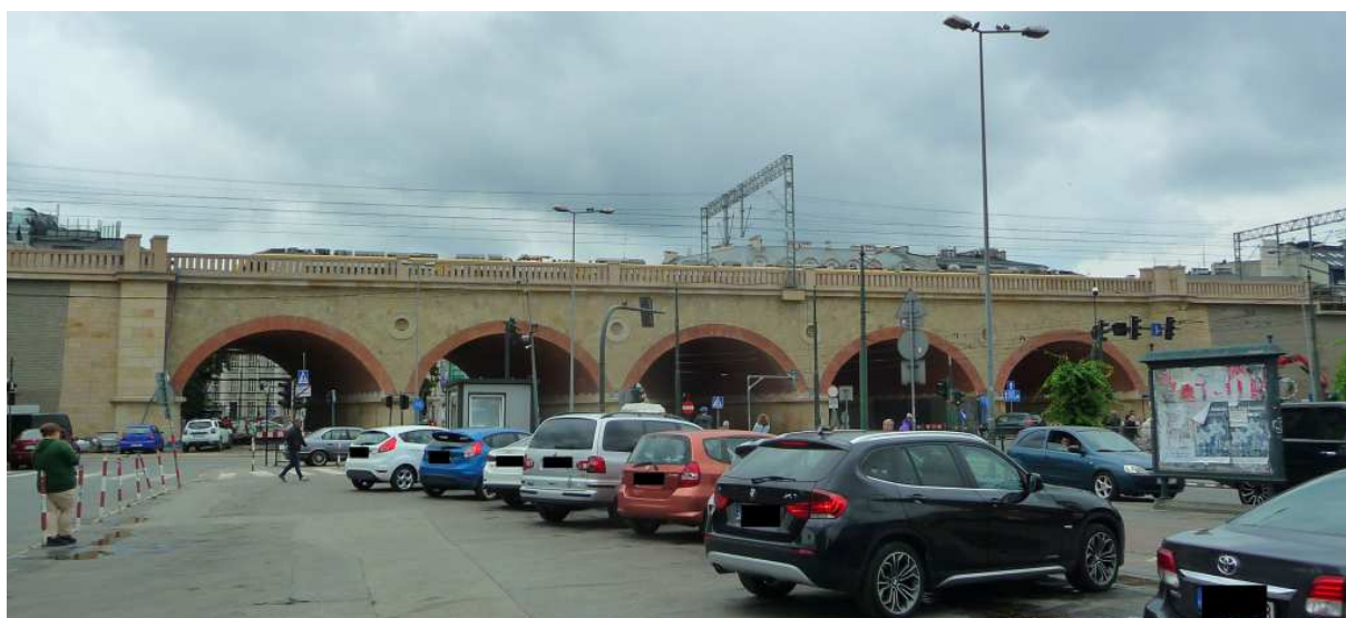
Fot. nr 234 (234-235). Wybudowany od nowa wiadukt nad ulicą Grzegórzecką, „nowy zabytek” przypominający oryginał z roku 1863. Widok z ulicy Grzegórzeckiej. (27.06.2023)
