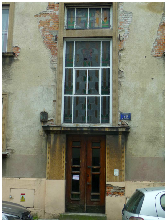
Fot. nr 427. Detale fasady. (25.05.2023)
