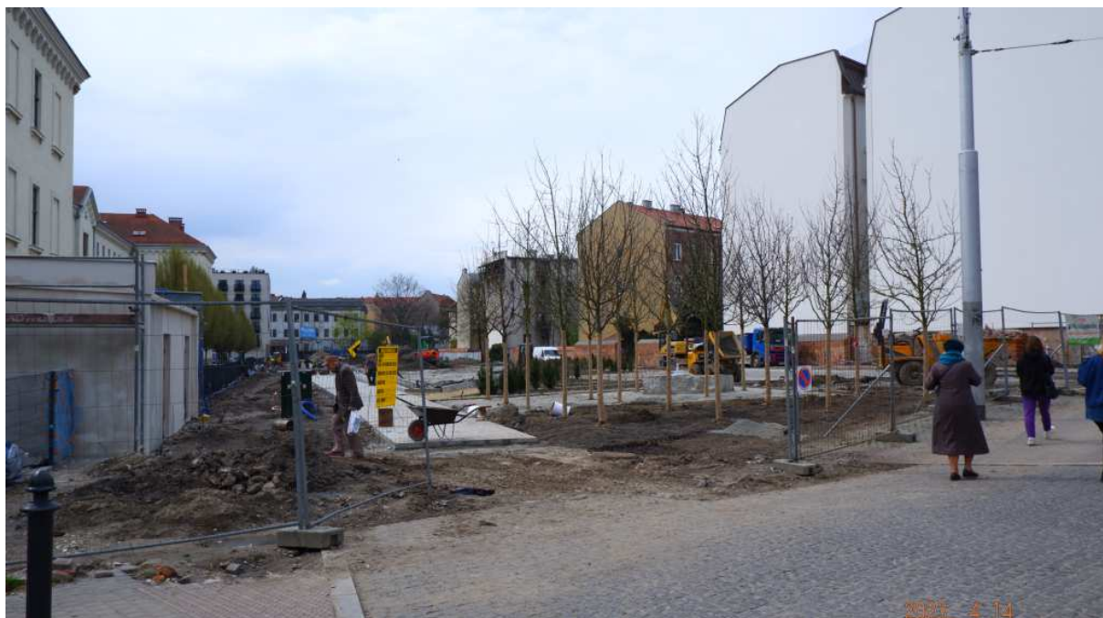
Fot. nr 45 (45-48). W Parku Wisławy Szymborskiej; tu ostatni etap budowy.
