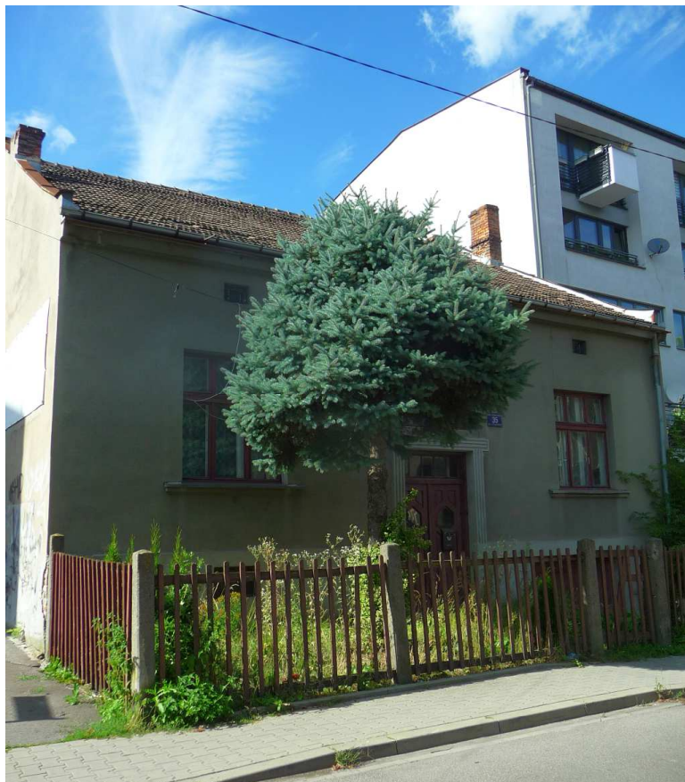
Fot. nr 367. Parterowy dom przedwojenny spod nr 35. (02.08.2023)
