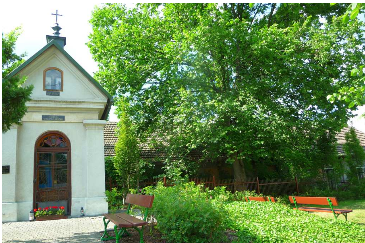
Fot. nr 462 (462-464). Kapliczka typu domkowego p.w. MB Częstochowskiej, wybudowana w roku 1882, przy dawnym domostwie Persów przy ulicy Malborskiej 112, Obiekt powstał z inicjatywy Piotra Persa, wójta Gminy Wola Duchacka. (26.06.2023)
