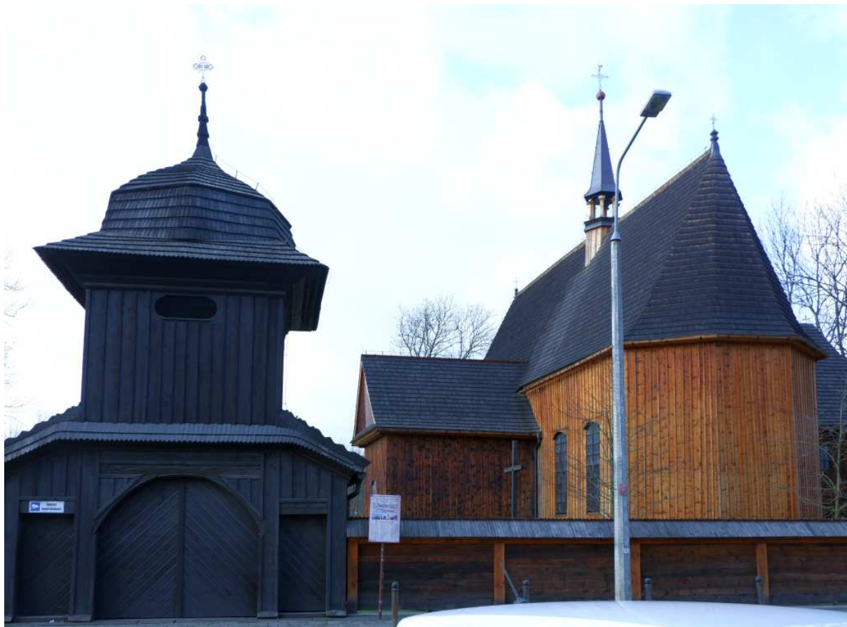
Fot. nr 313. Dzwonnica i prezbiterium. (02.02.2024)
