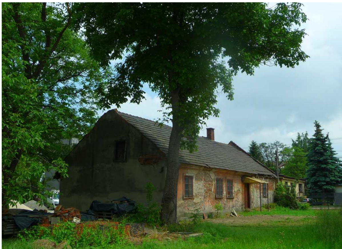
Fot. nr 499 (497-500). Widoki na fasadę. (08.06.2023)
