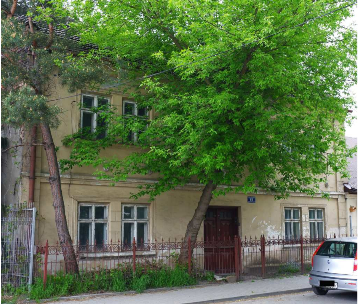
Fot. nr 541. Oryginalne okna typu skrzynkowego w fasadzie domu.
