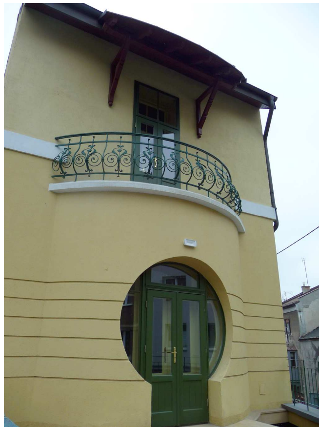
Fot. nr 422. Narożnik z ulicą Zamojskiego. (25.05.2023)
