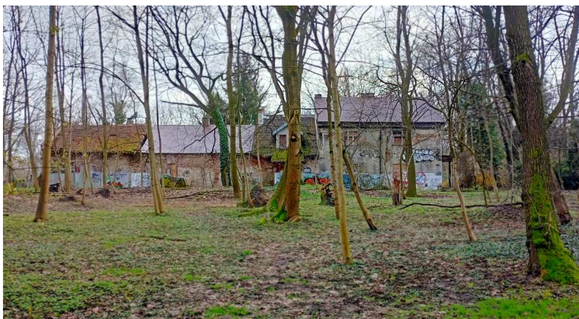
Fot. nr 460a. Widok od strony parku po założeniu nowego dachu. (14.02.2024)
