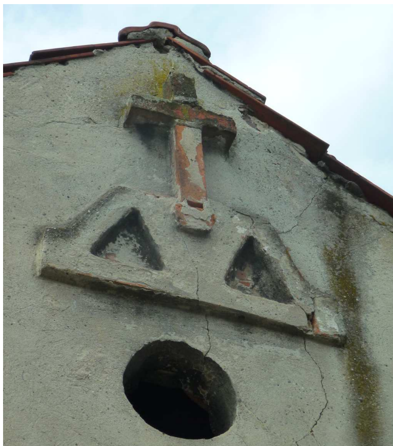
Fot. nr 509. Znak murarski przypominający symbole wolnomularskie na ścianie szczytowej od strony ulicy Koszykarskiej. (08.06.2023)
