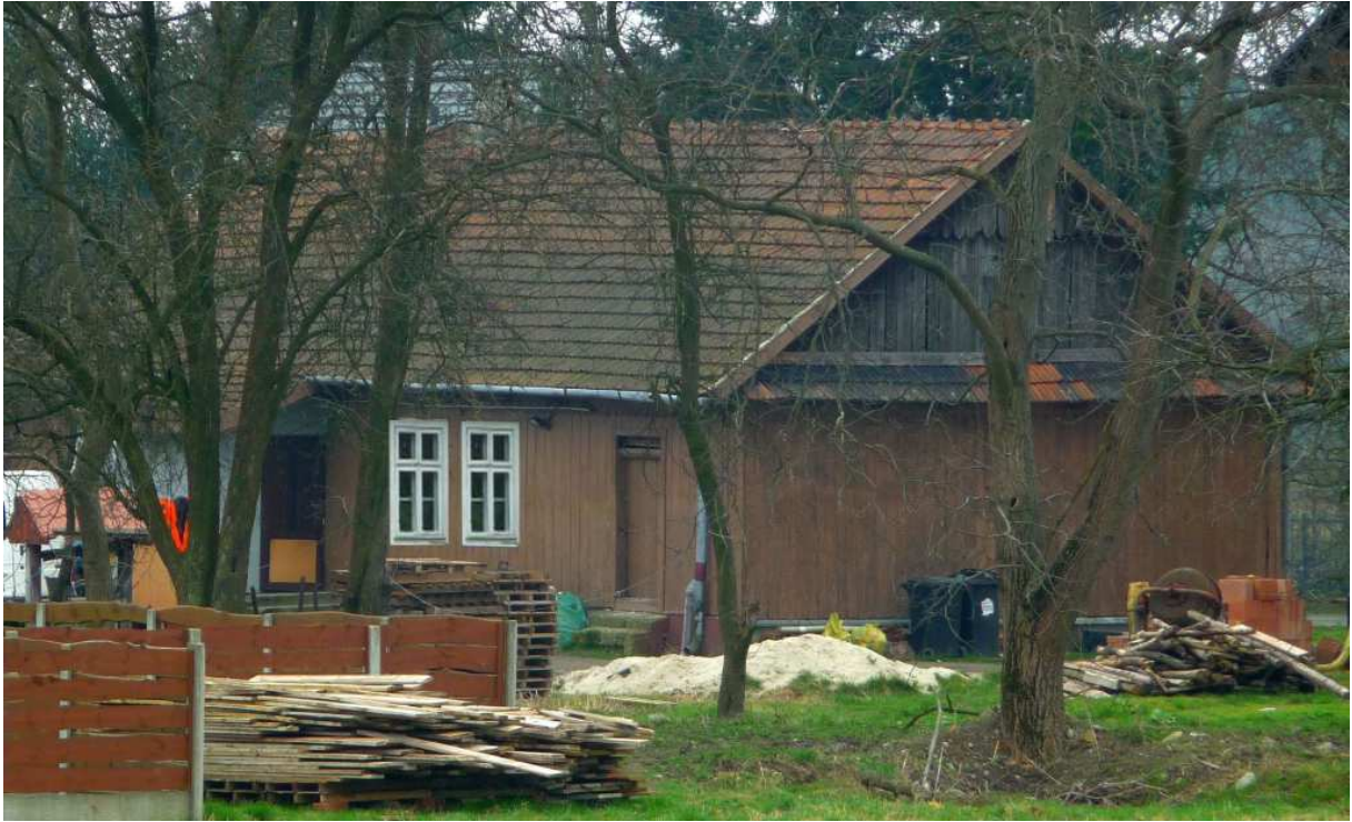
Fot. nr 665. Dawny dom z ulicy Golikówka 22 (?) ze zrekonstruowanymi przeze mnie oknami typu skrzynkowego – widok z wału wiślanego. (02.03.2024)
