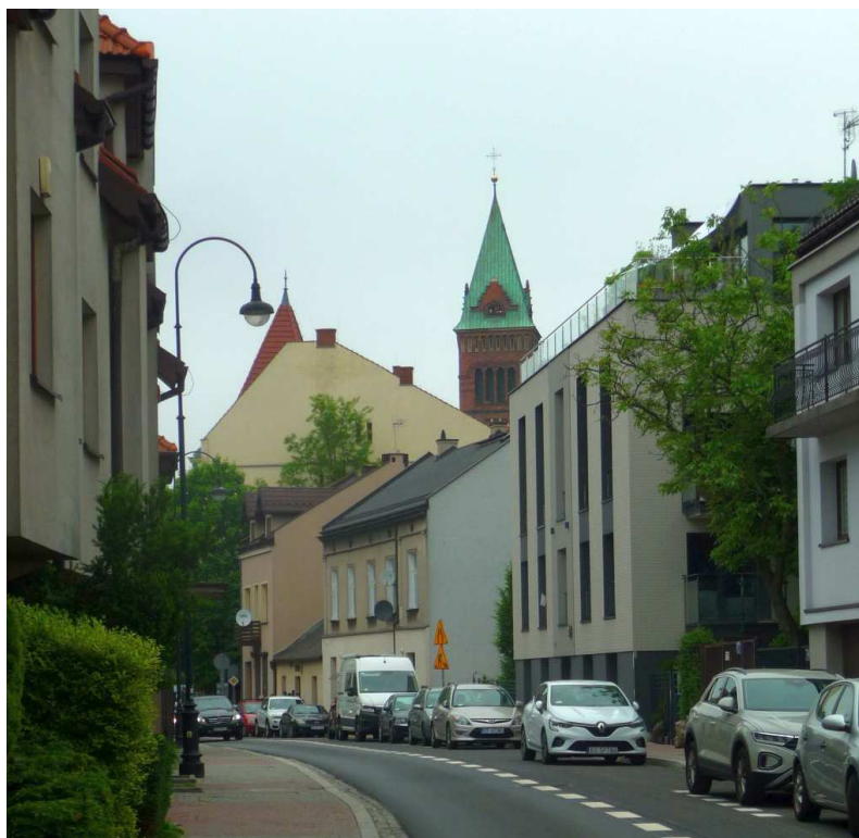
Fot. nr 424 (424-427). Wzdłuż ulicy Zamojskiego. Fragment zabudowy poniżej nowego budynku pod nr 73. (25.05.2023)
