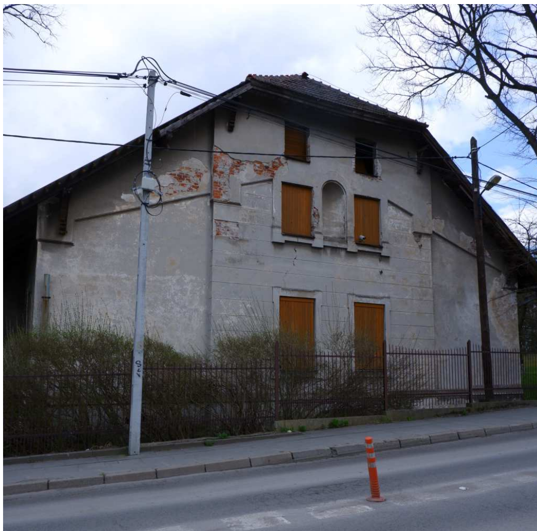
Fot. nr 637. Ściana szczytowa od strony ulicy. (25.03.2023)
