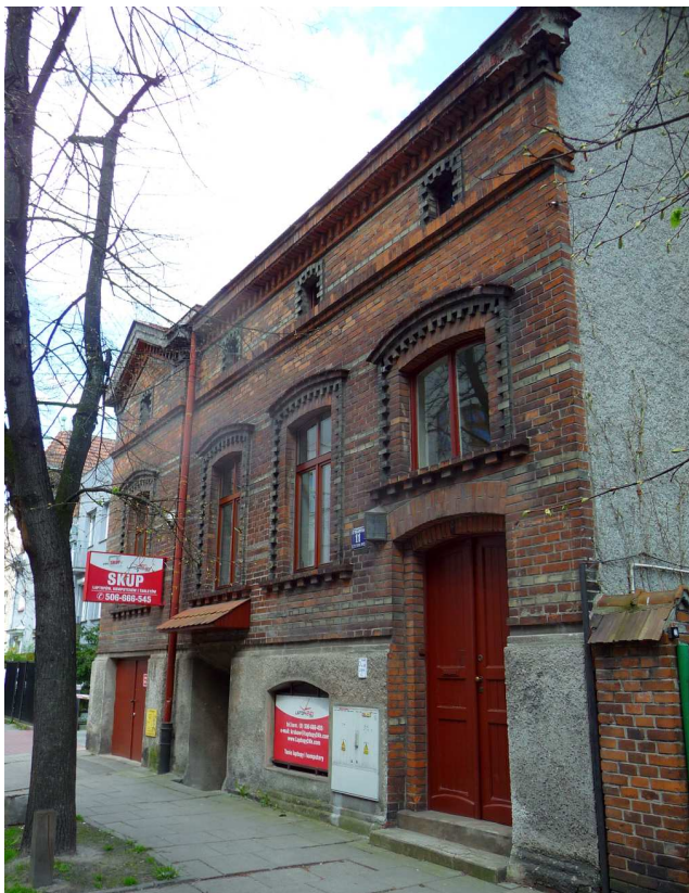
Fot. nr 86. Dom z roku 1914 przy ulicy Kujawskiej 11. (23.04.2023)
