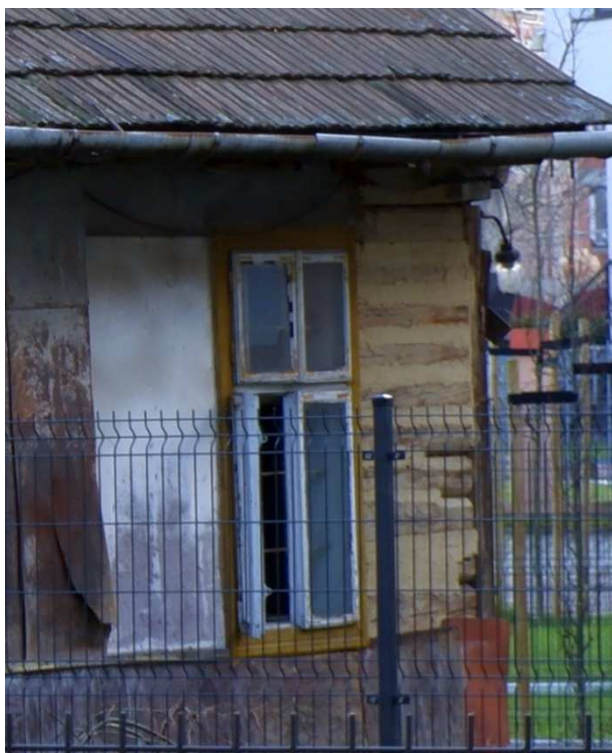
Fot. nr 299. Okno od strony podwórka i dawna struktura drewniana ściany. (02.02.2024)
