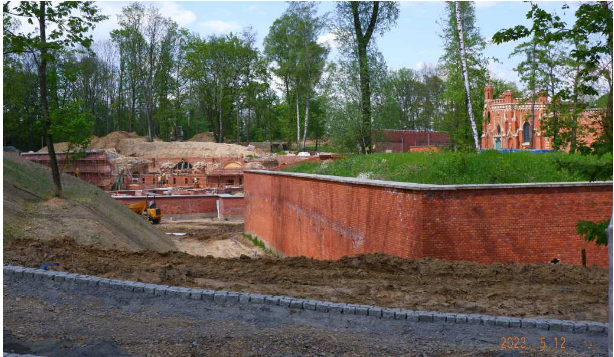
Fot. nr 209 (209-210). Omurowany wał ziemny bastionu nr 1.
