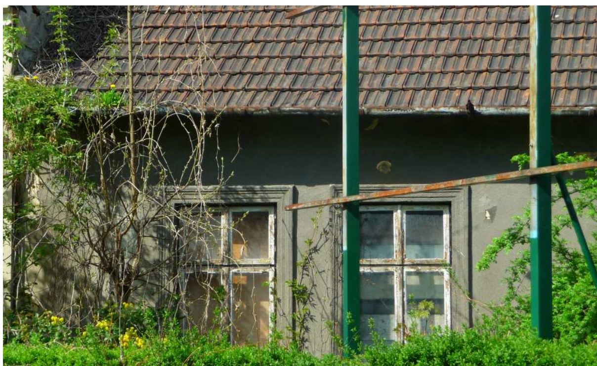
Fot. nr 116. Okna typu skrzynkowego w domu pod nr 45. (23.04.2023)
