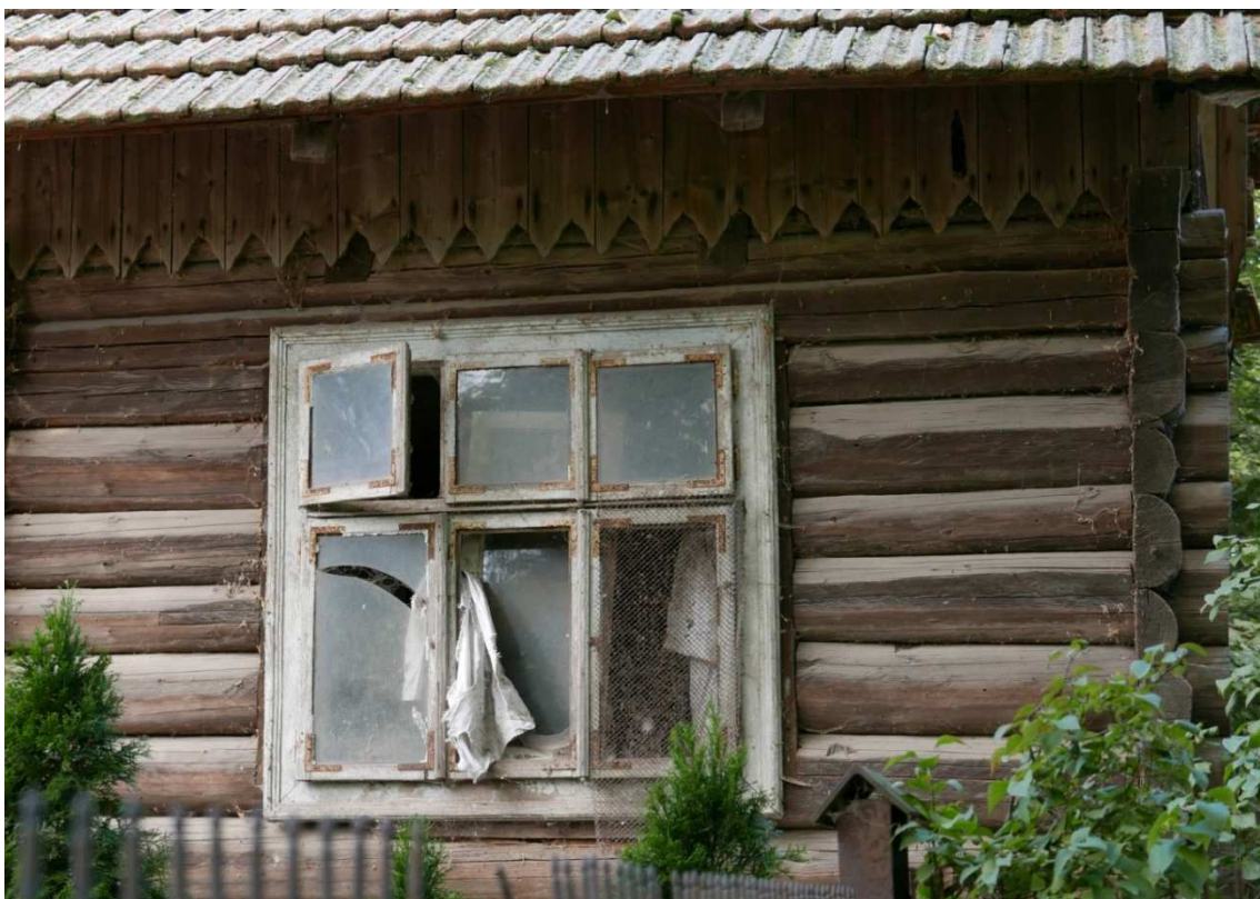
Fot. nr 293. Oryginalne okno typu weneckiego w prawym fragmencie fasady domu.
