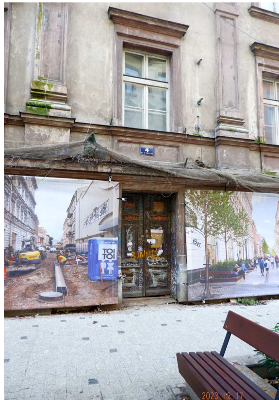
Fot. nr 4. Kamieniczka spod nr 4 z końca XVIII wieku w oczekiwaniu na remont.
