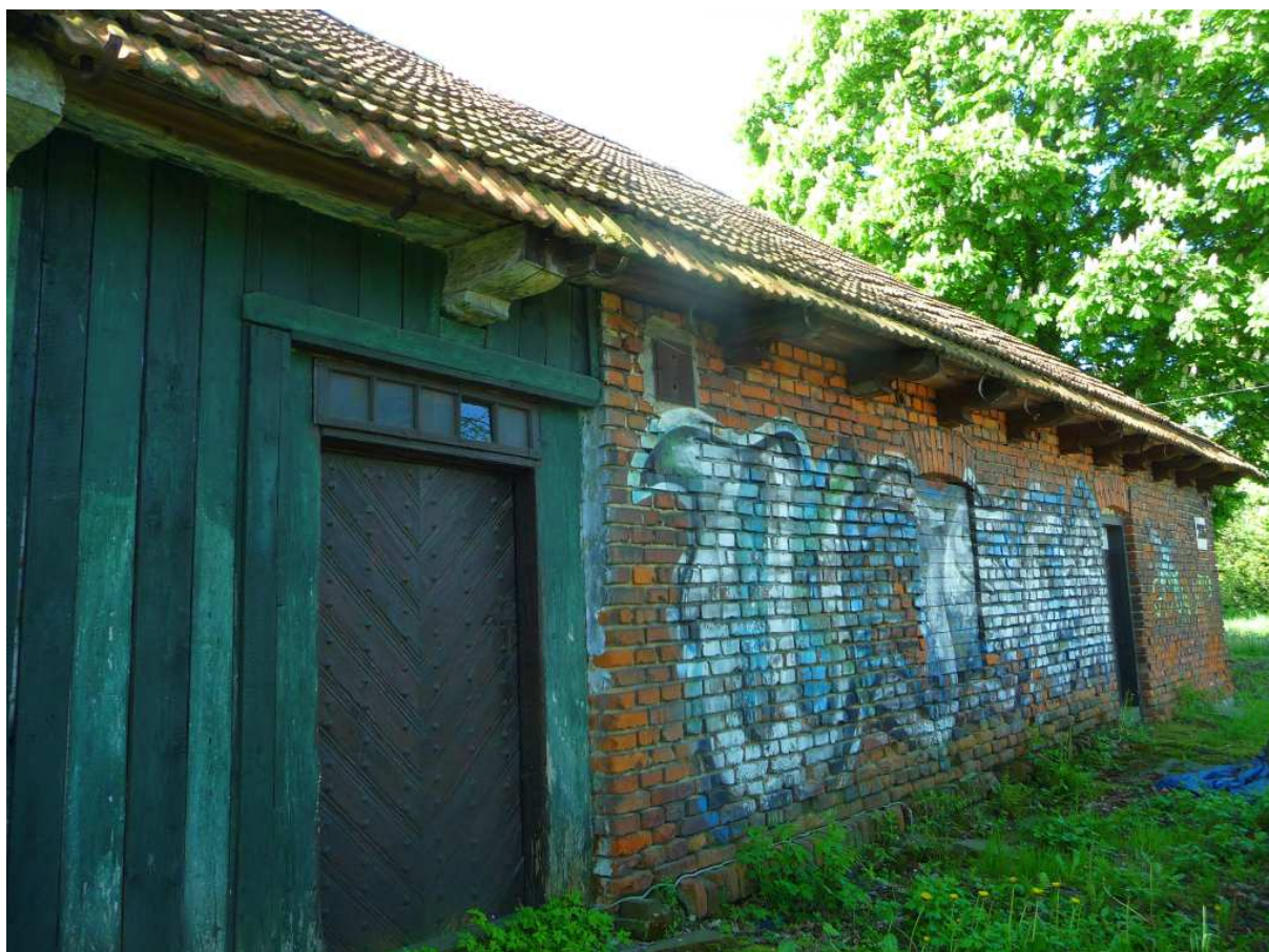
Fot. nr 598. Oryginalne drzwi z obelichem i murowana część gospodarcza, która mogła zostać dostawiona później. (11.05.2023)
