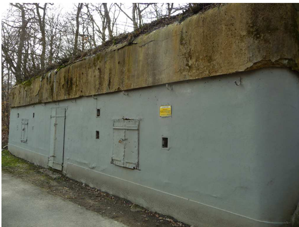
Fot. nr 232. Schron amunicyjny (kazamata) na Ostrej Górze w zespole baterii FB-36. (19.03.2023)
