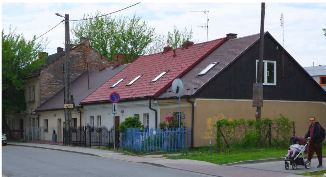
Fot. nr 539 (539-545). Fragment niskiej zabudowy ulicy o numerach: 65-69. Dom pod nr 63 został już rozebrany. (13.05.2023)
