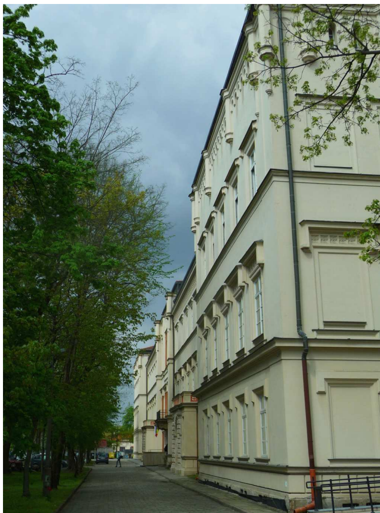
Fot. nr 145. Widoki na fasadę. (27.04.2023)
