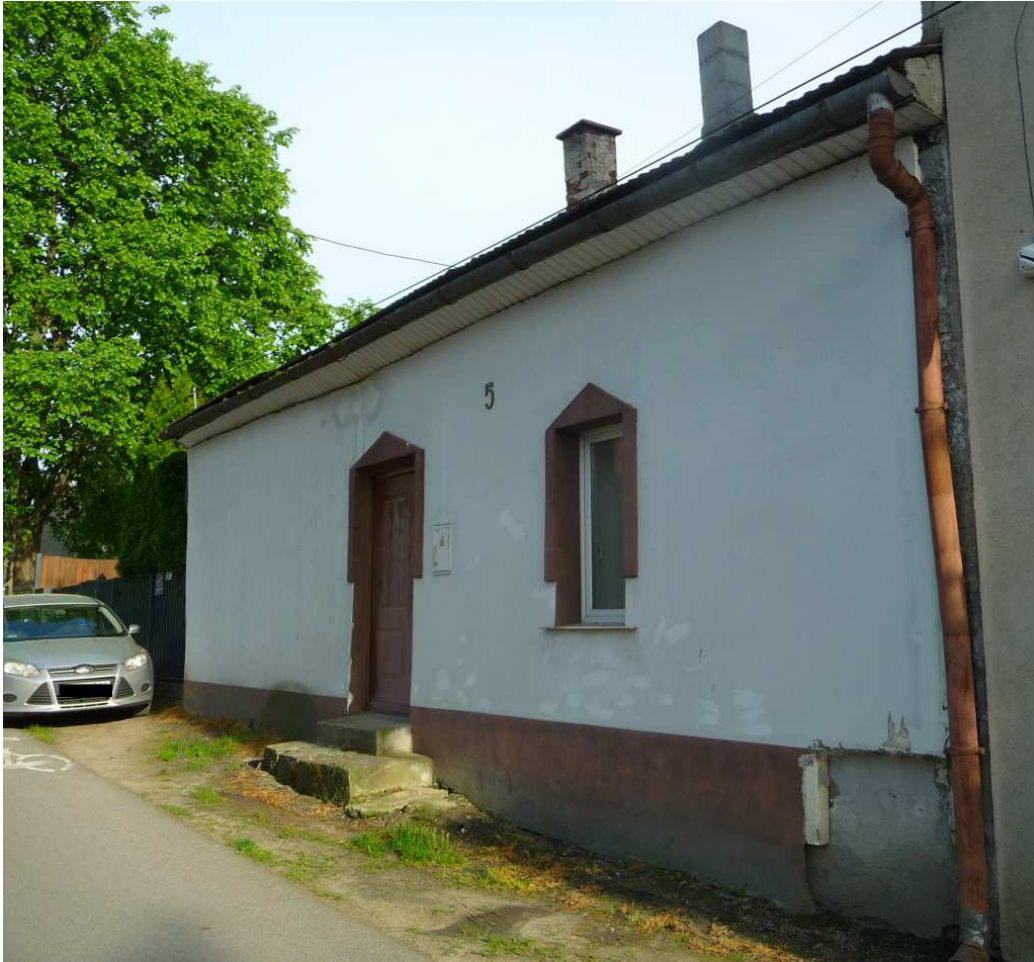
Fot. nr 531 Przebudowany dom podmiejski pod nr 5. (22.05.2023)
