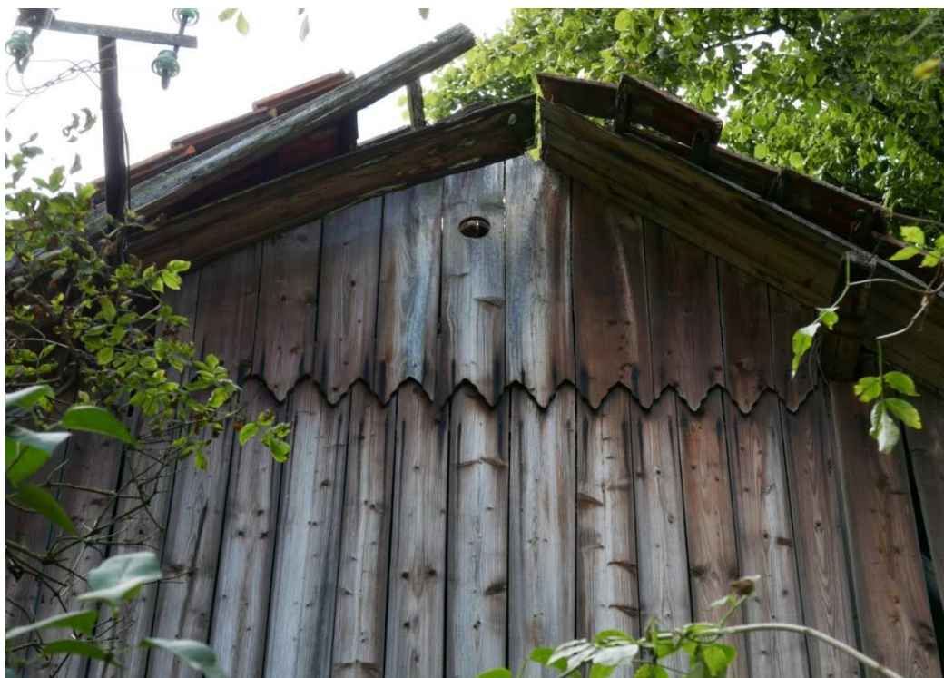
Fot. nr 296. Prawa, boczna ściana szczytowa.
