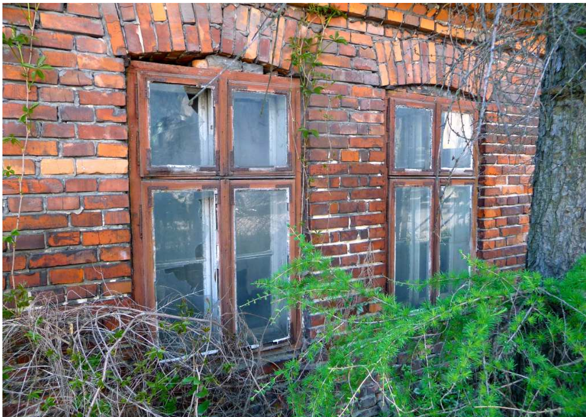
Fot. nr 611. Oryginalne okna typu skrzynekowego w prawym fragmencie. (11.05.2023)
