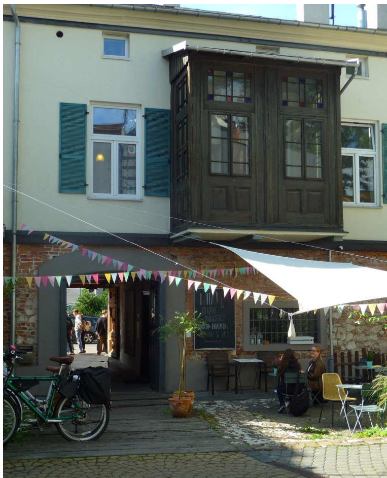
Fot. nr 21. Oszklony ganek domu pod nr 3 od strony podwórka. (04.10.2023)
