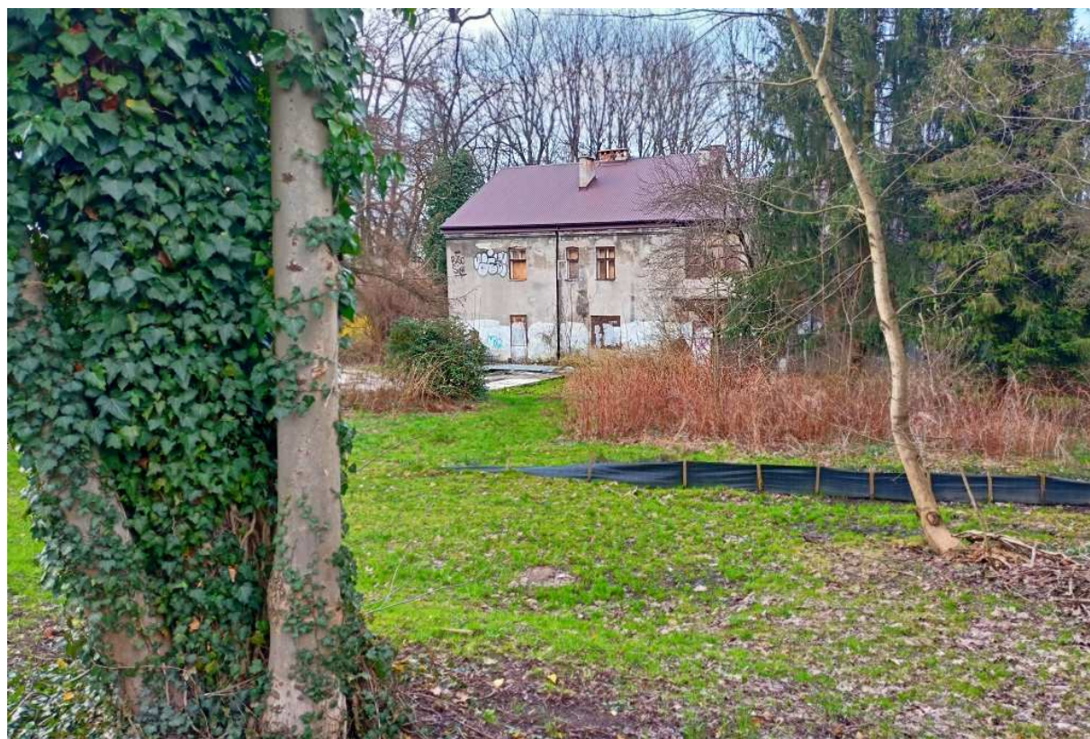
Fot. nr 459a. Stan po założeniu prowizorycznego dachu. (14.03.2024)
