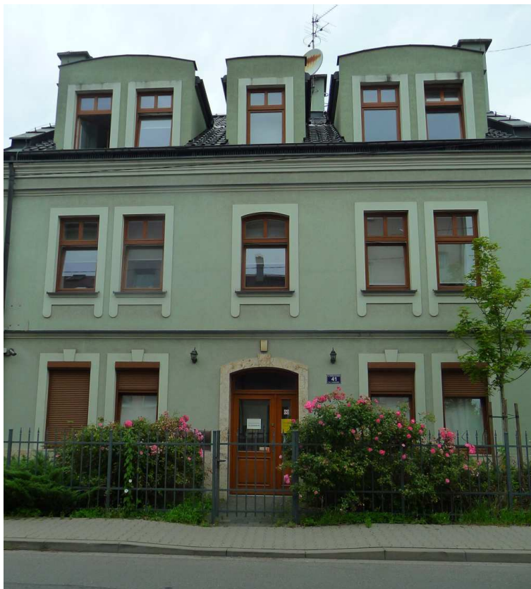
Fot. nr 369. Niedawno wyremontowana kamieniczka pod nr 41. (01.08.2023)
