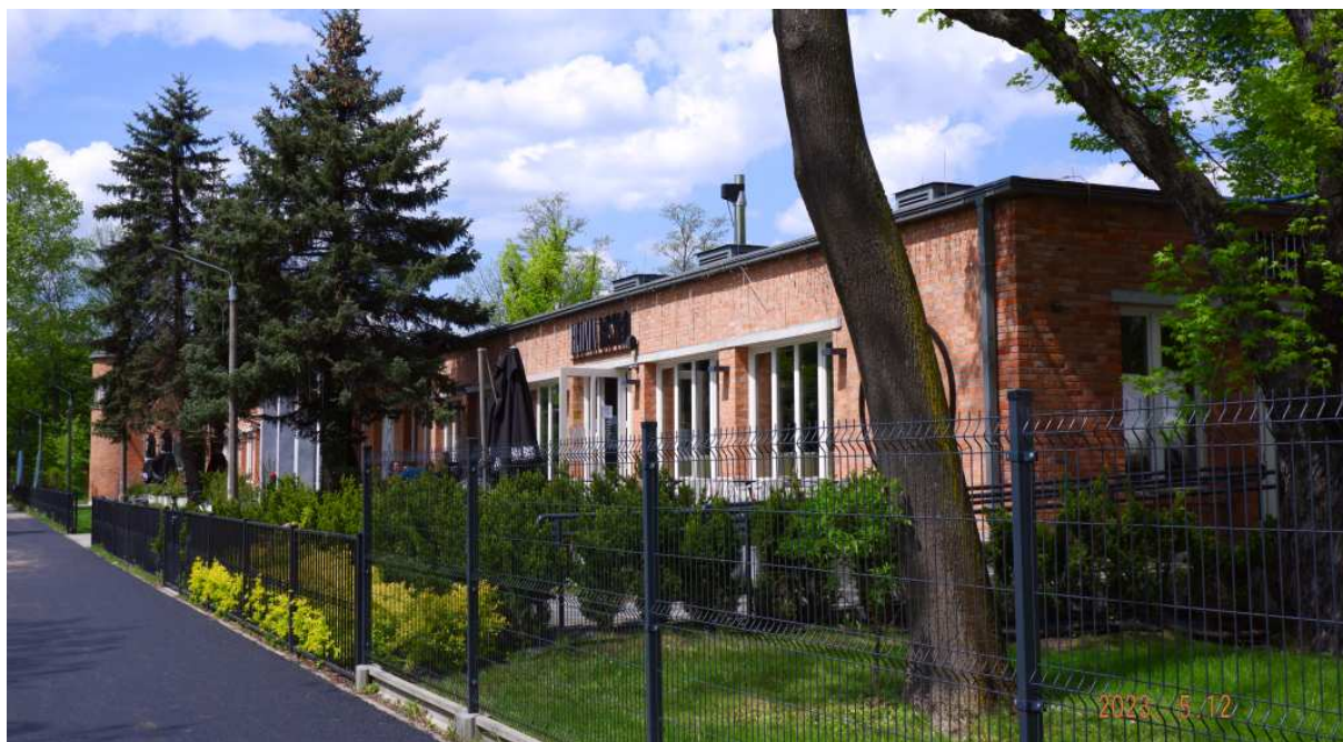
Fot. nr 77. Uratowany od zagłady budynek dawnych szatni przy kompleksie dawnych basenów w Cichym Kącziku.
