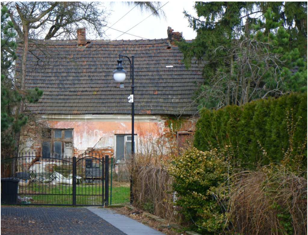
Fot. nr 478. Relikt dawnej zabudowy Płaszowa w głębi posesji pod nr 6. (14.02.2024)
