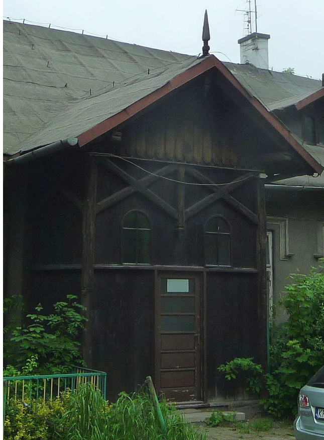
Fot. nr 125. Kryty ganek przy wejściu. (25.05.2023)
