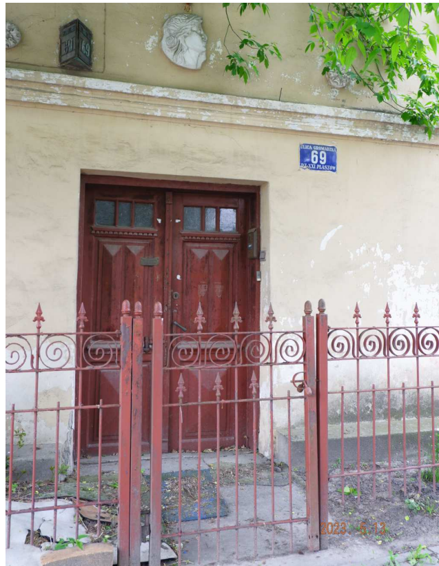
Fot. nr 543. Oryginalne drzwi. (13.05.2023)
