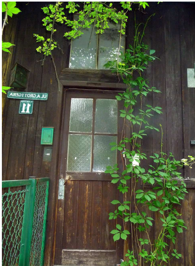
Fot. nr 120 (120-122). Detale fasady. (25.05.2023)
