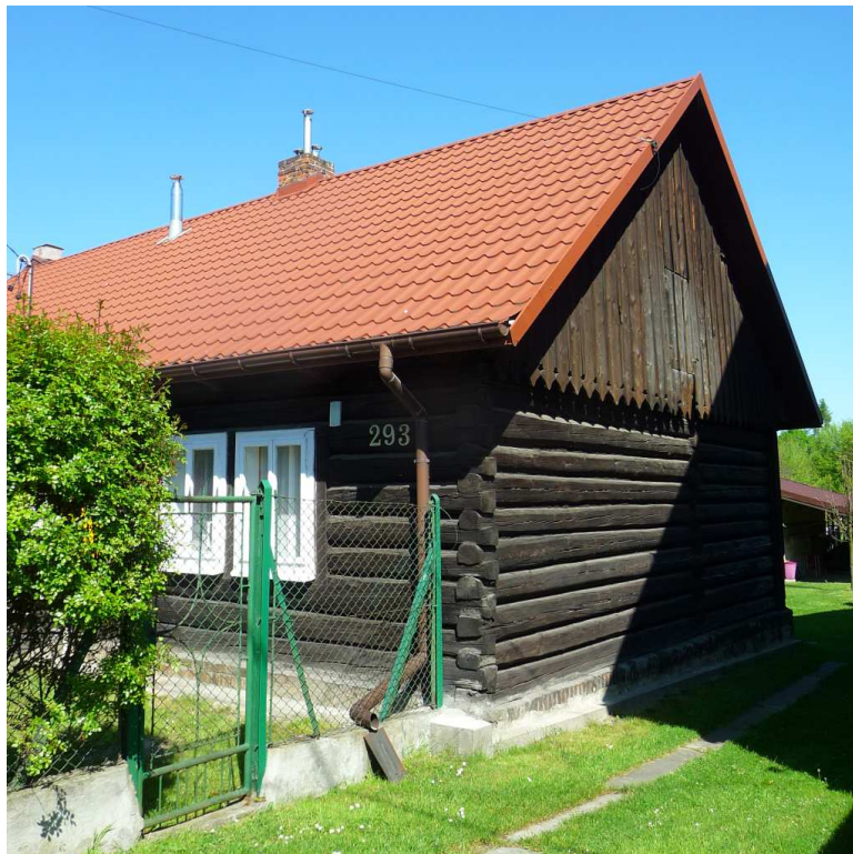
Fot. nr 606. Naroże chałupy o konstrukcji zrębowej. (11.05.2023)
