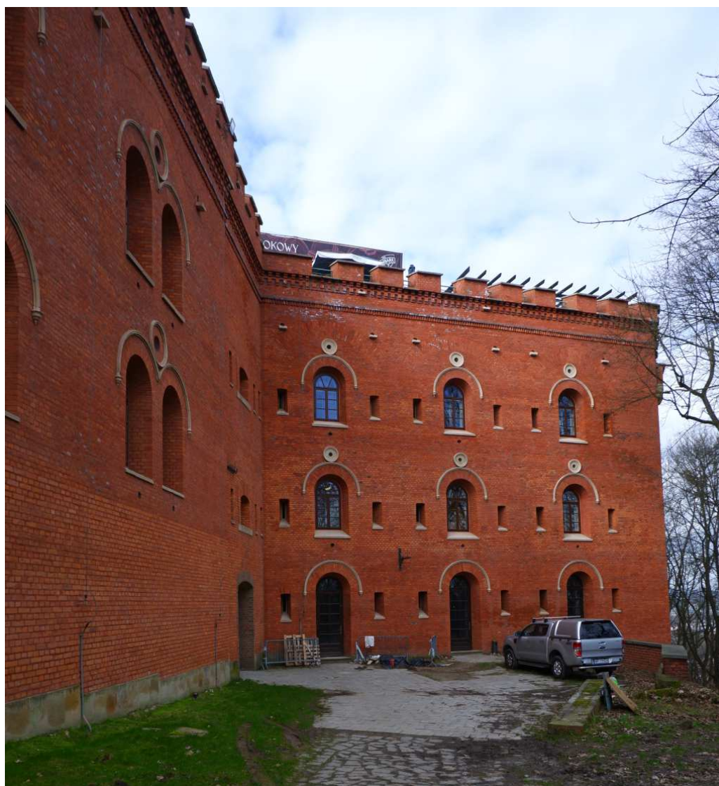
Fot. nr 202. Świeżo odnowiony po latach budowlanego marazmu bastion nr 4 fortu Kościuszko. (26.02.2024)
