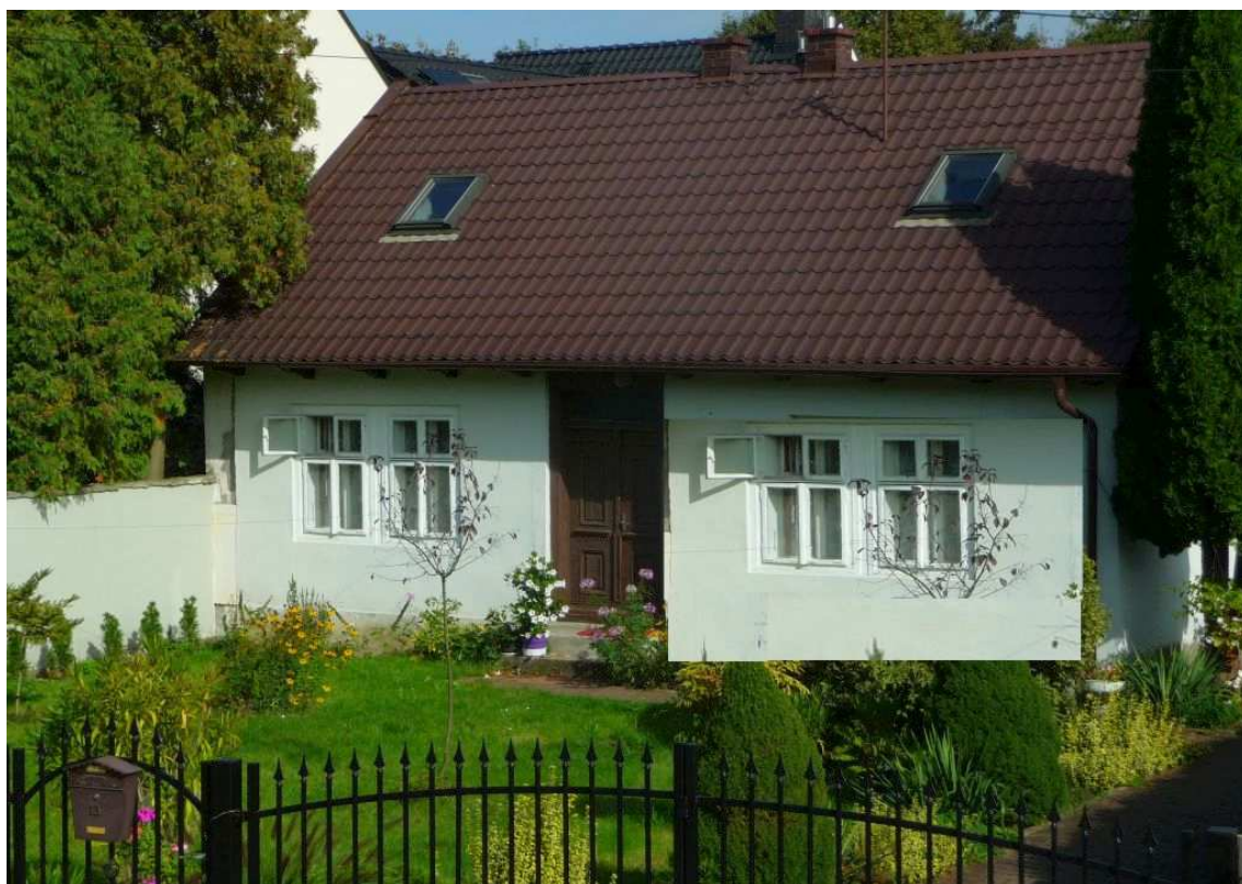
Fot. nr 84. Próba rekonstrukcji fasady. (02.10.2023)
