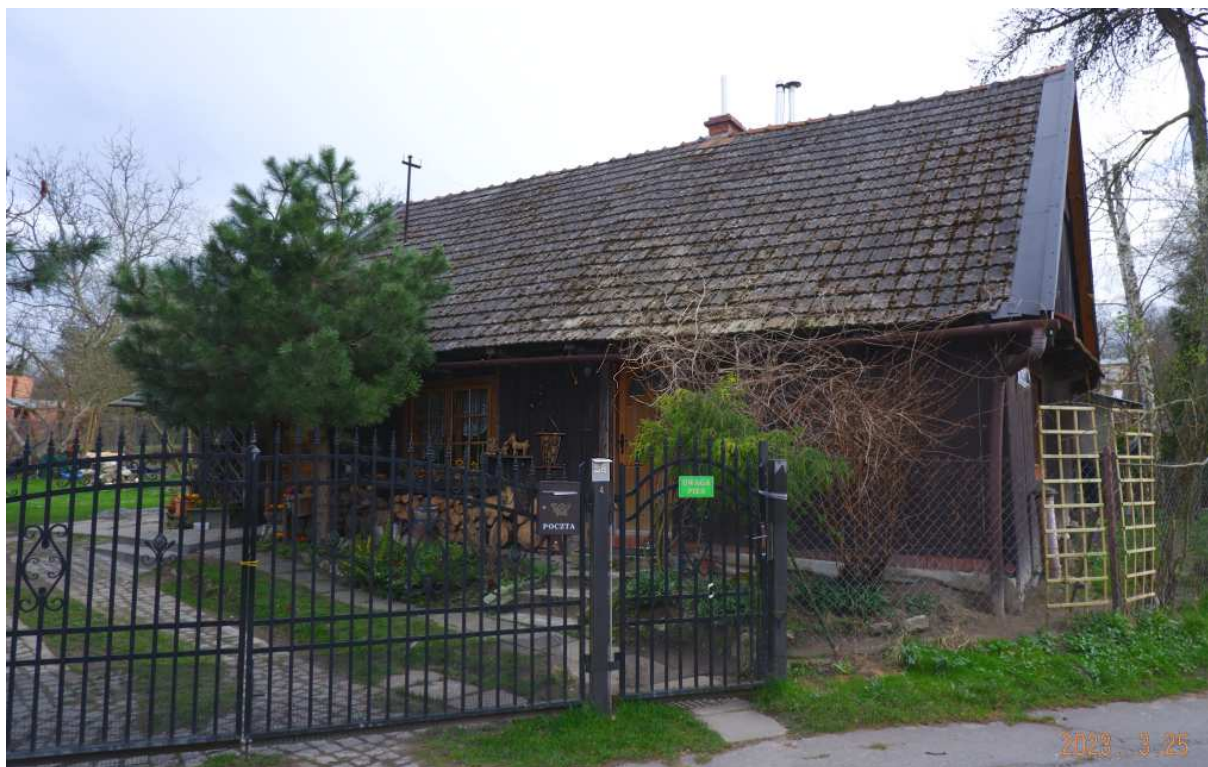
Fot. nr 625. Zapewne ponad stuletnia chałupa z ulicy Braci Jamków 4.
