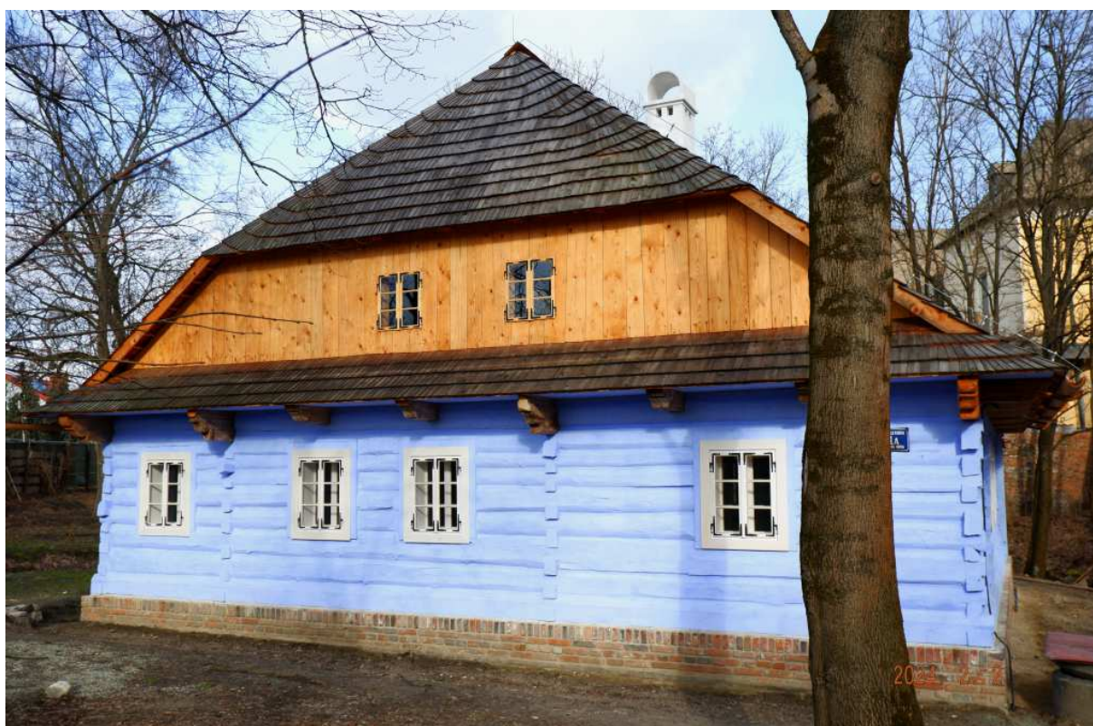
Fot. nr 324 (324-325). Ściana szczytowa.
