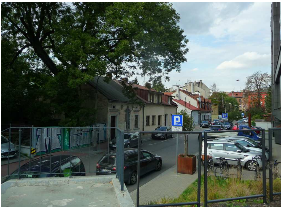
Fot. nr 342 (342-344). Wzdłuż ulicy Kilińskiego. Zabudowa poniżej nr 13. (12.10.2023)
