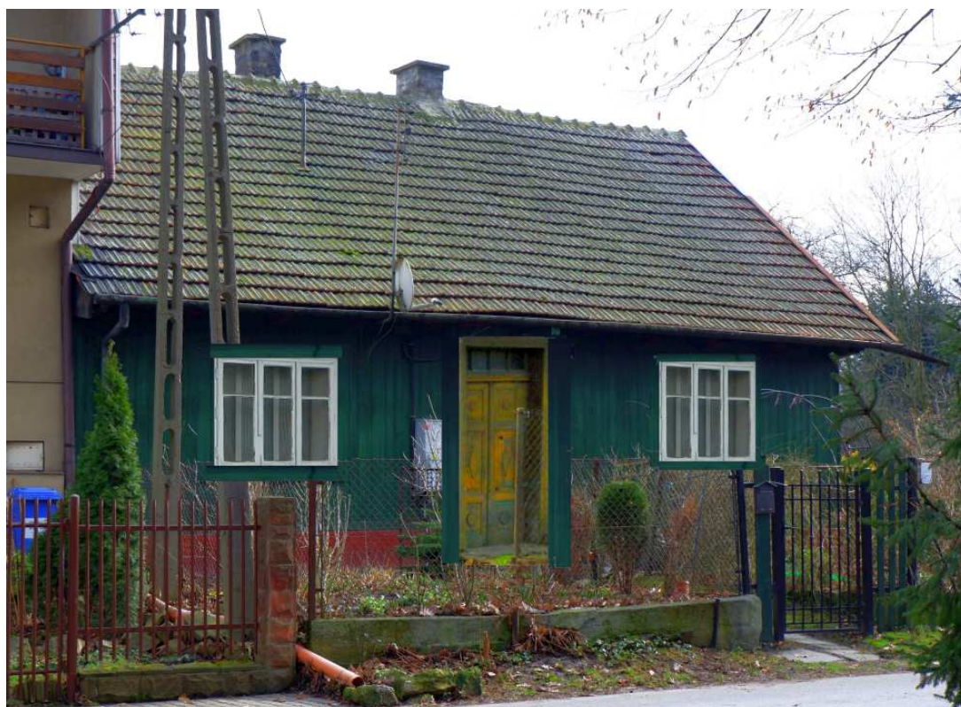
Fot. nr 488. Próba rekonstrukcji fasady.
