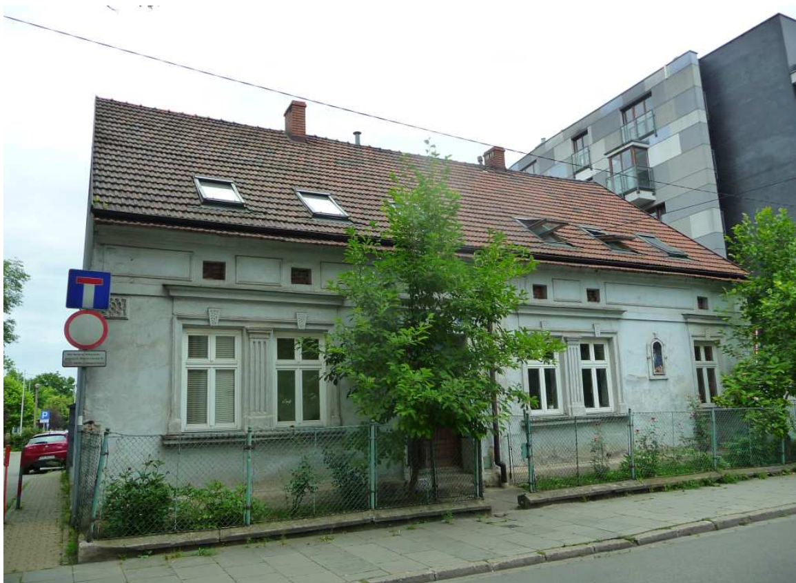
Fot. nr 361. Wybudowany w połowie XIX wieku dom ostatniego wójta Gminy Zakrzówek przy ulicy Mieszczańskiej 17, nieliczny już relikw podmiejskiej zabudowy. (01.08.2023)
