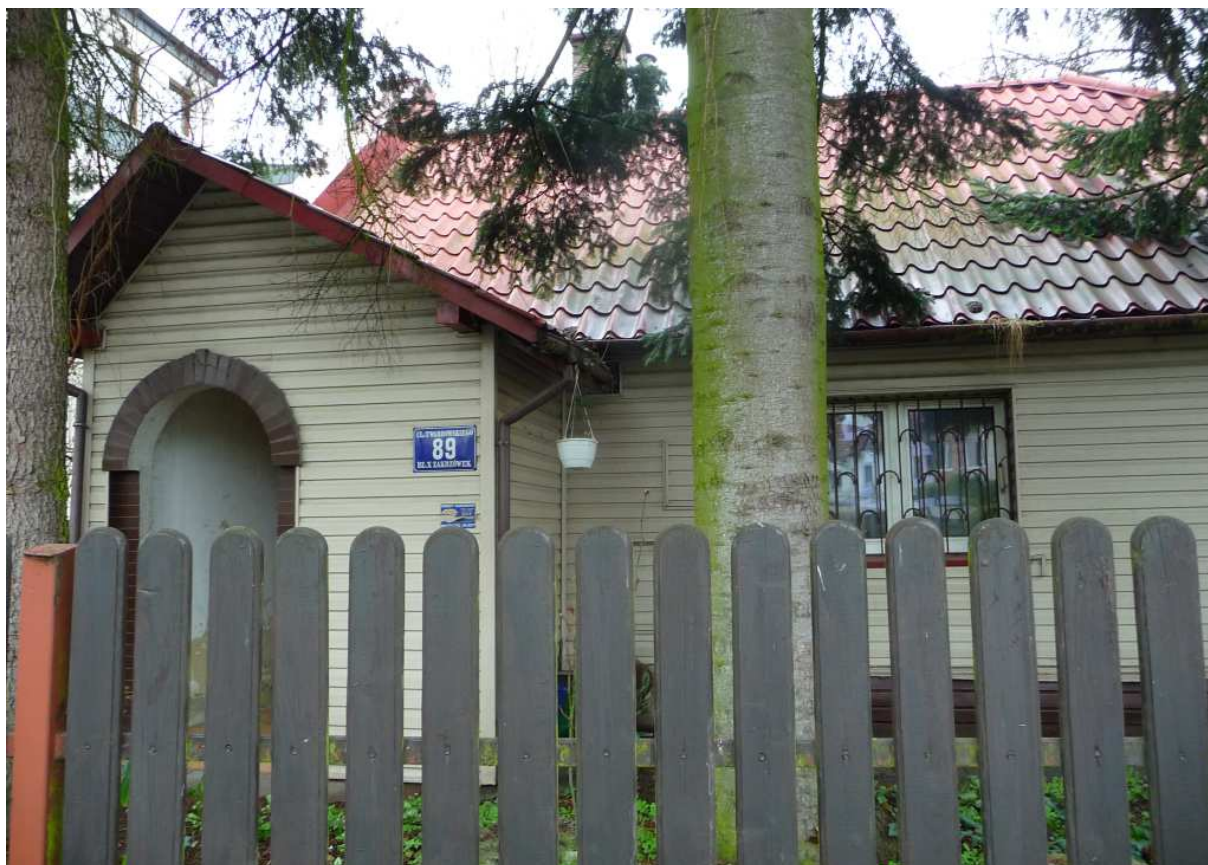
Fot. nr 388 (388-388a). Ukryta pod szalunkiem elewacja domu pod nr 89.
