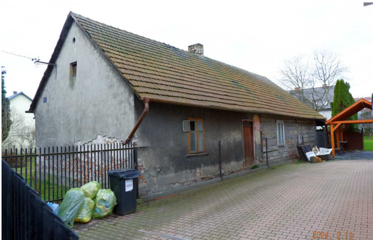
Fot. nr 528 (528-529). Znacznie przebudowana dawna chałupa pod nr 15. Widok od strony podwórka.
