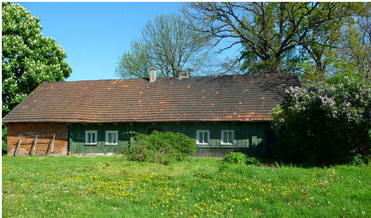
Fot. nr 599 (599-601). Fasada od strony ogrodu ukryta pod warstwą szalunku, co utrudnia rozeznanie czy obiekt w tym fragmencie jest drewniany. (11.05.2023)
