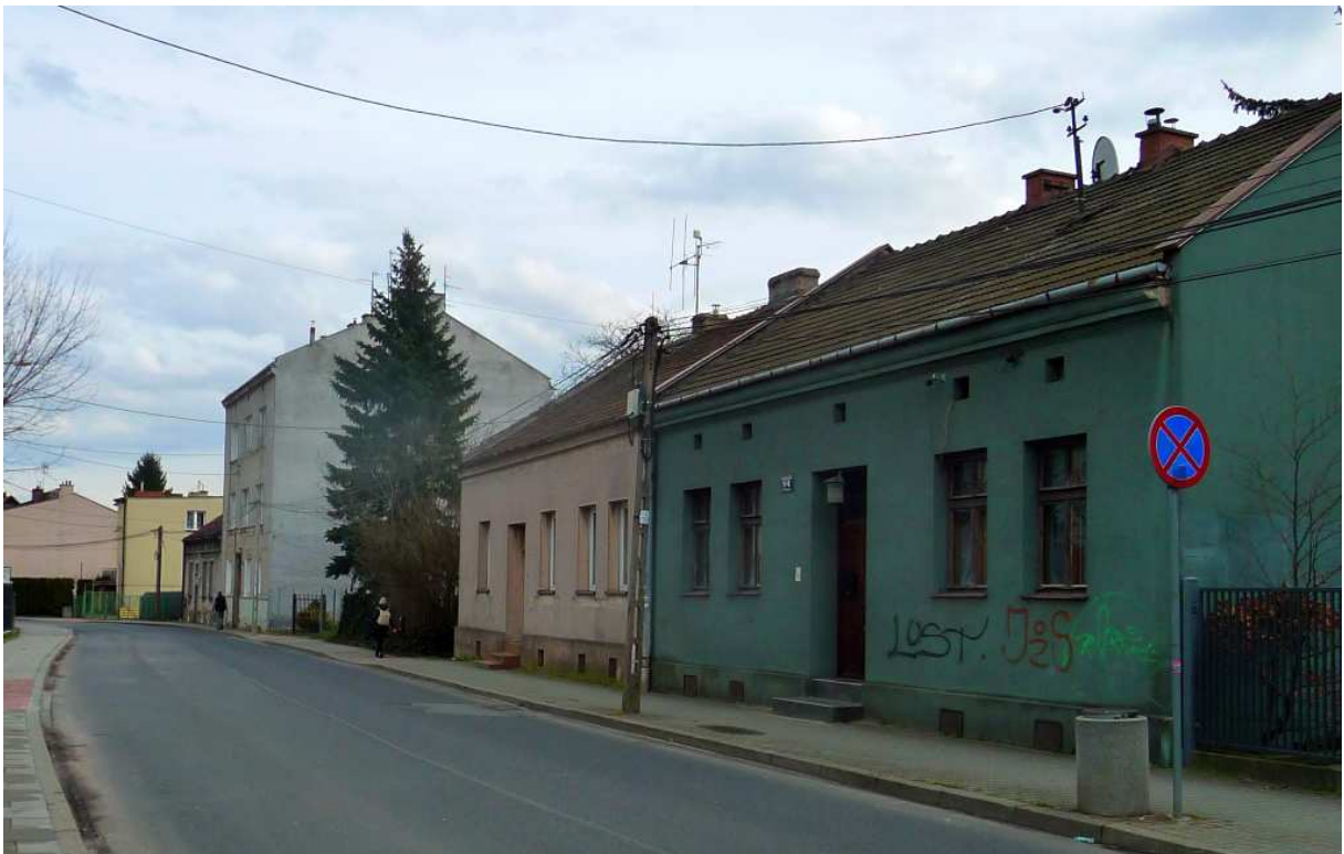
Fot. nr 520. Zabudowa powyżej domu pod nr 14. (24.02.2024)
