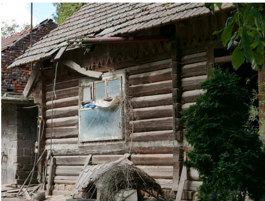
Fot. nr 294. Widok na lewy fragment fasady.
