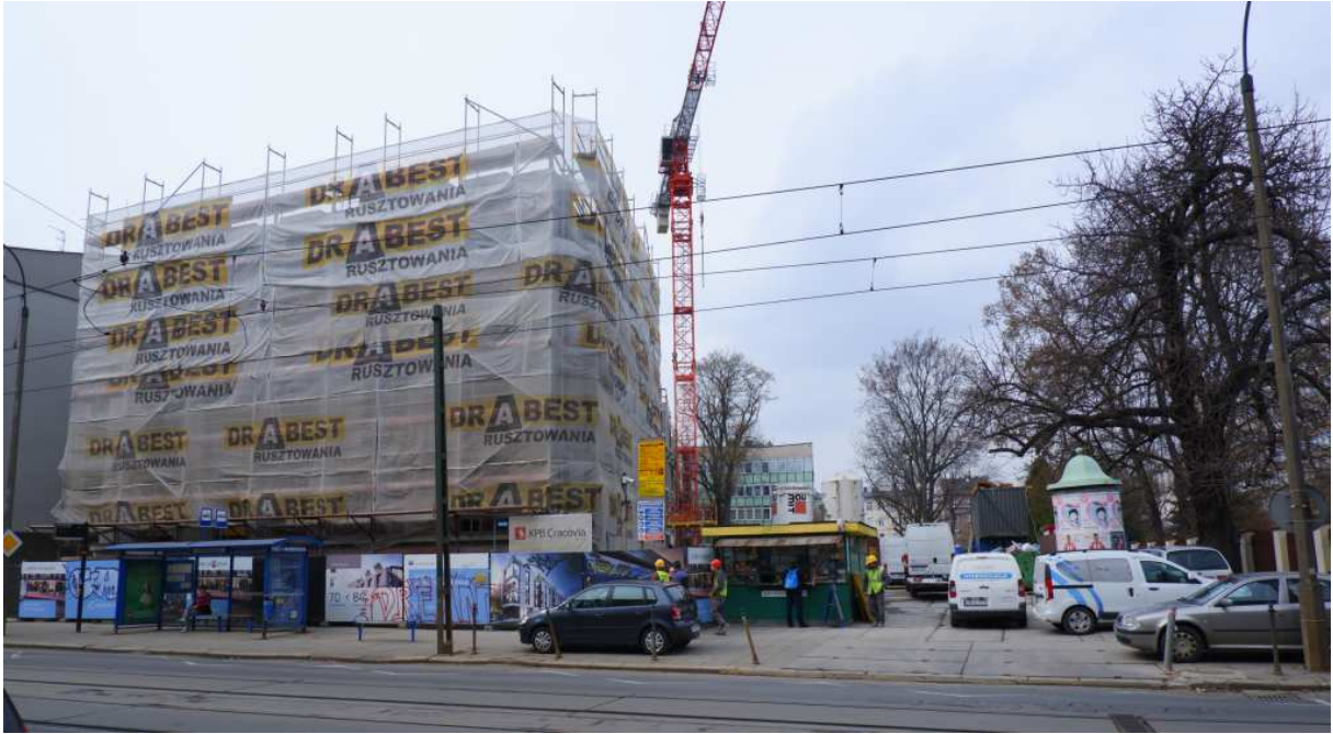
Fot. nr 52 (52-53). Trwa zabudowa posesji pod nr 39. (29.03.2022)
