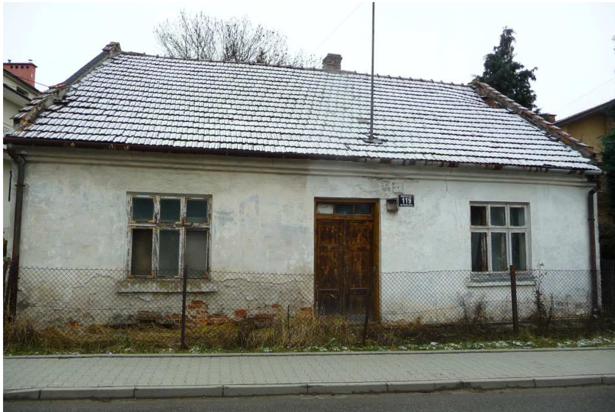
Fot. nr 197 (197-198). Może powojenny już dom z ulicy Cienistej 46, gdzie w fasadzie zachowały się oryginalne okna typu weneckiego. (03.02.2023)
