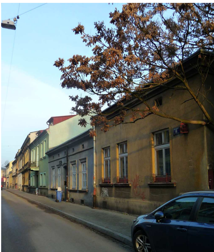
Fot. nr 235. Zabudowa ulicy poniżej domu o nr 18. (02.01.2023)
