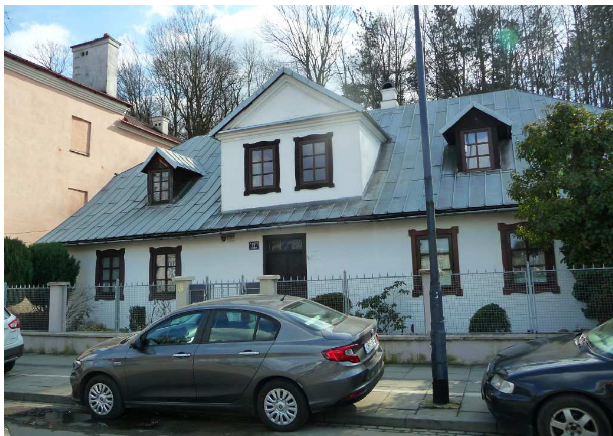
Fot. nr 301. Fasada dworku. (08.03.2023)
