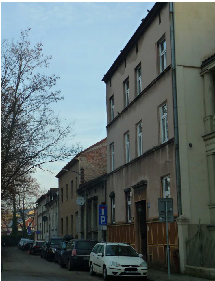
Fot. nr 227. Zabudowa ulicy Zduńskiej poniżej domu o nr 16. (02.01.2023)
