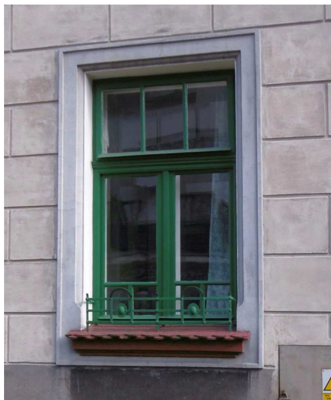
Fot. nr 255. Oryginalne okno. (06.04.2022)
