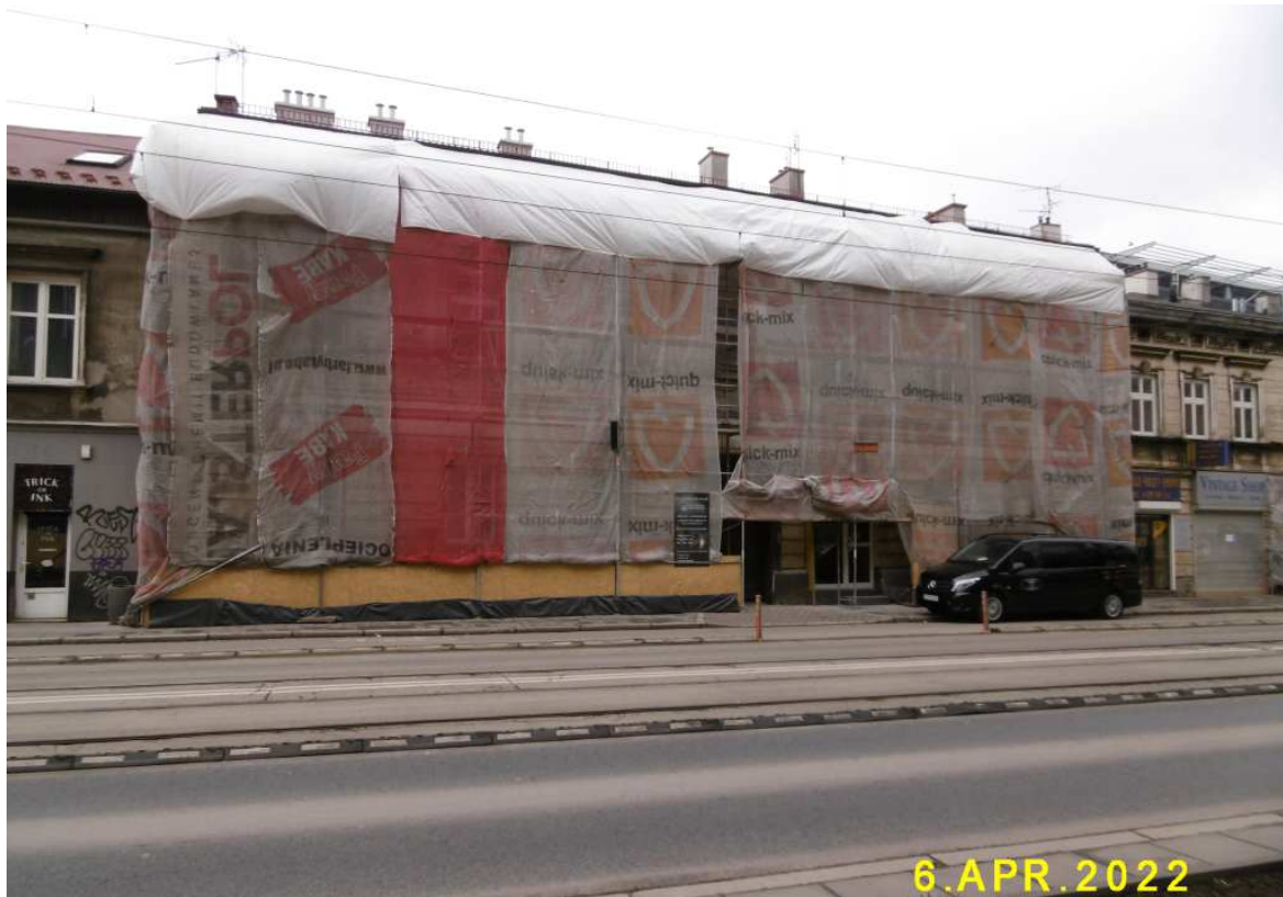
Fot. nr 152. Remontowany dom pod nr 27, powstały ok. roku 1900.
