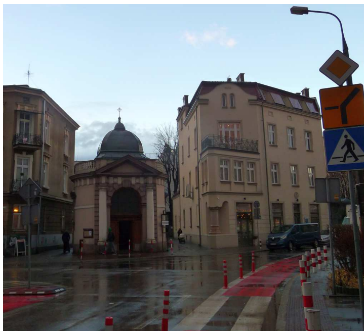
Fot. nr 228 (228-229). Kaplica św. Piotra i Pawła przy Madalińskiego 13, wybudowana w roku 1902 wg projektu Józefa Pokutyńskiego. (05.01.2023)
