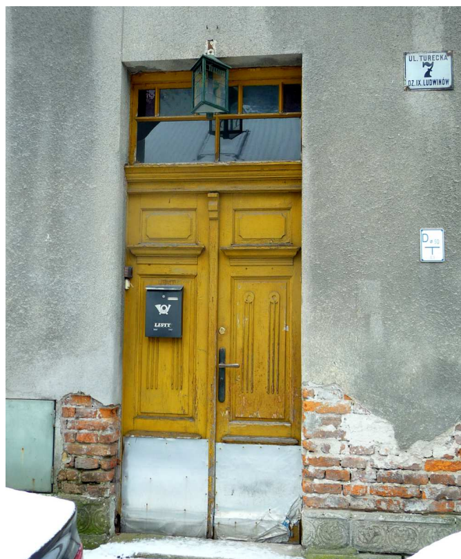
Fot. nr 289. Oryginalne drzwi i tabliczka z czasów Wielkiego Krakowa. (05.02.2023)
