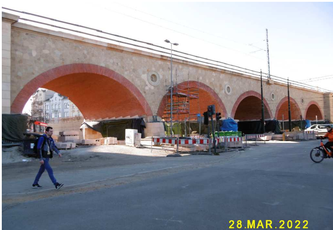
Fot. nr 167 (167-171). Przebudowywany czy raczej budowany od nowa wiadukt przy ulicy Grzegórzeckiej, który w oryginale powstał nad korytem starej Wisły w roku 1863. Fot. nr: 167-168 - ujęcia z ulicy Grzegórzeckiej.
