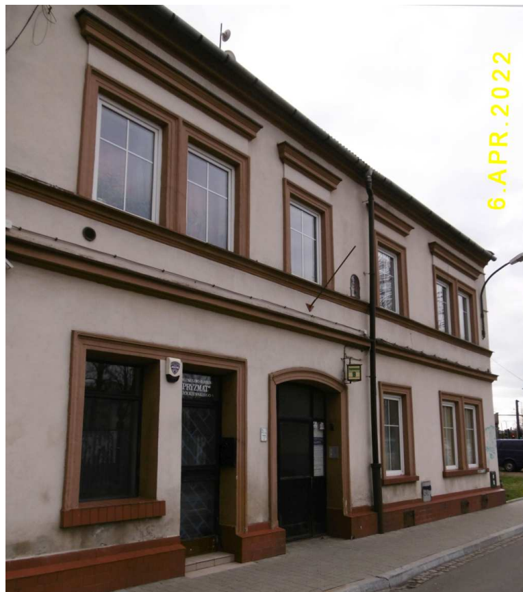
Fot. nr 135. Dom pod nr 9.
