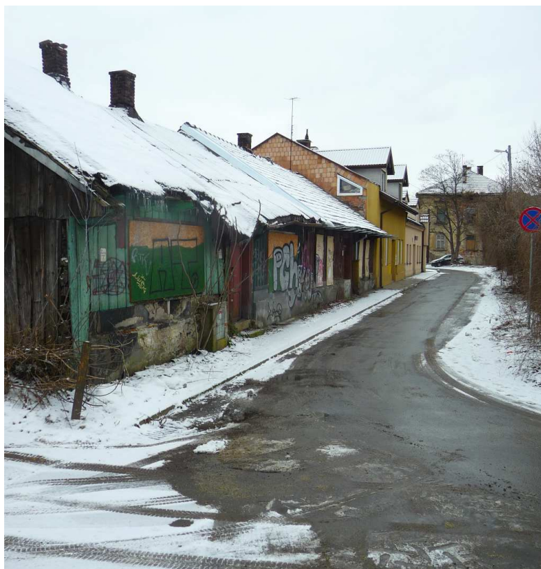
Fot. nr 280 (280-290). Wzdłuż ulicy Tureckiej. Zabudowa poniżej nr 21. (05.02.2023)
