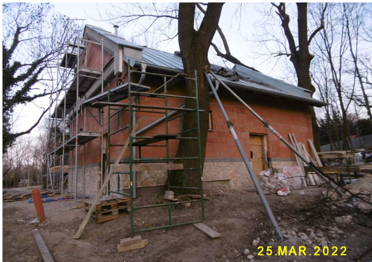
Fot. nr 326 (326-328). Odbudowa spichlerza przy starym dworze Bemów.
