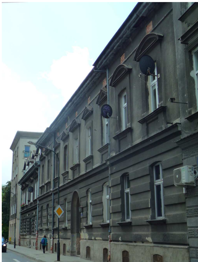
Fot. nr 160. Fragment zabudowy powyżej nr 19. (02.06.2022)
