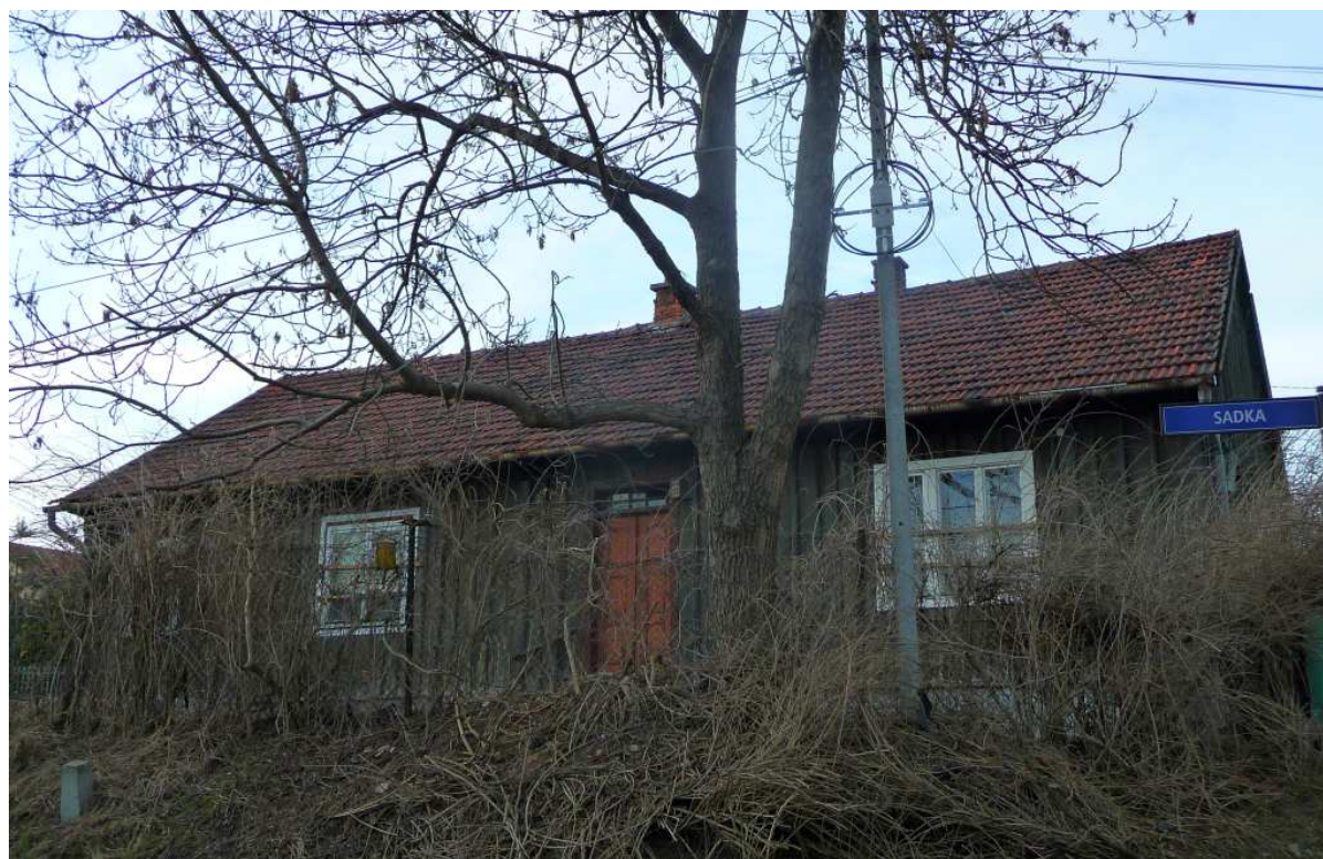
Fot. nr 381 (381-382). Opuszczony dom przy ulicy Błotnej 14 i jego detale. (07.03.2023)
