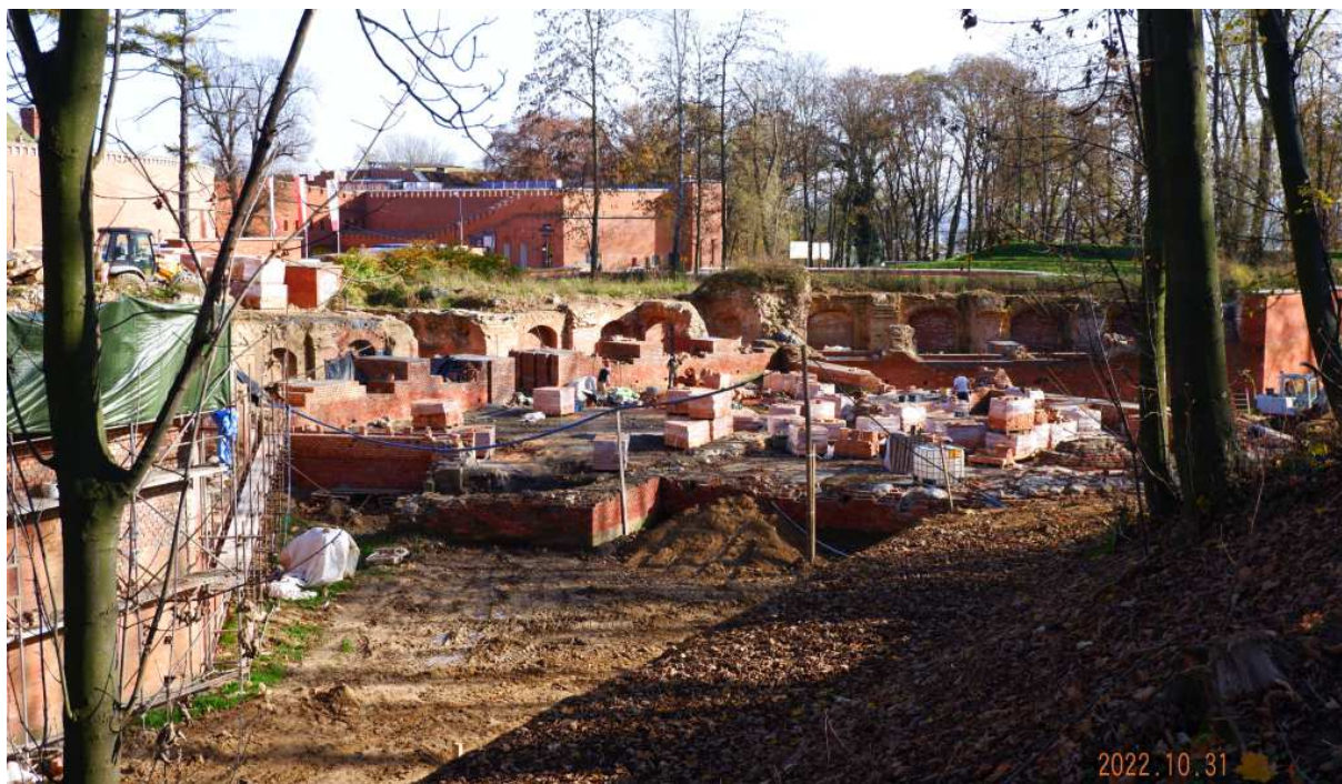
Fot. nr 76. Odkopywanie przyziemia i rekonstrukcja bastei pomiędzy bastionami nr: 1 i 2.
