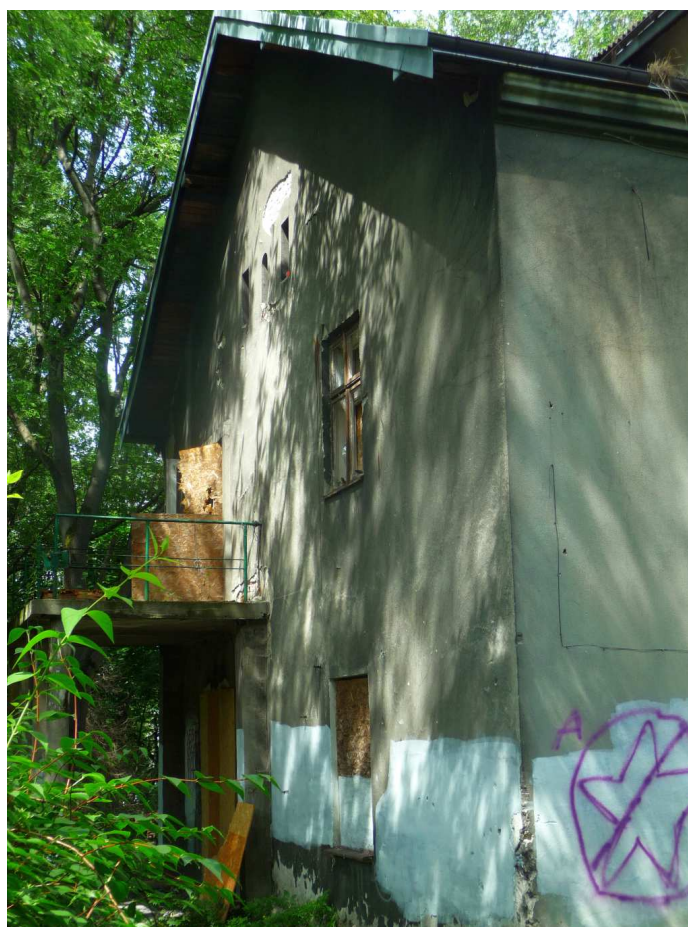
Fot. nr 335. Szczytowa ściana od strony ulicy Estońskiej. (12.07.2022)
