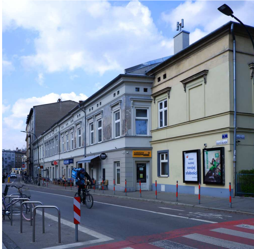
Fot. nr 26. Ulica Dolnych Młynów – widok z ulicy Krupniczej. (19.04.2022)
