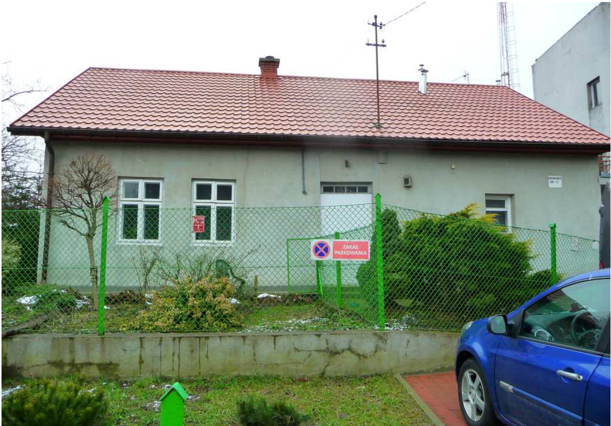
Fot. nr 188. Zapewne jeszcze międzywojenny dom murowany z ulicy Fatimskiej 13, gdzie w fasadzie zachowały się jeszcze okna typu skrzynkowego. (03.02.2023)
