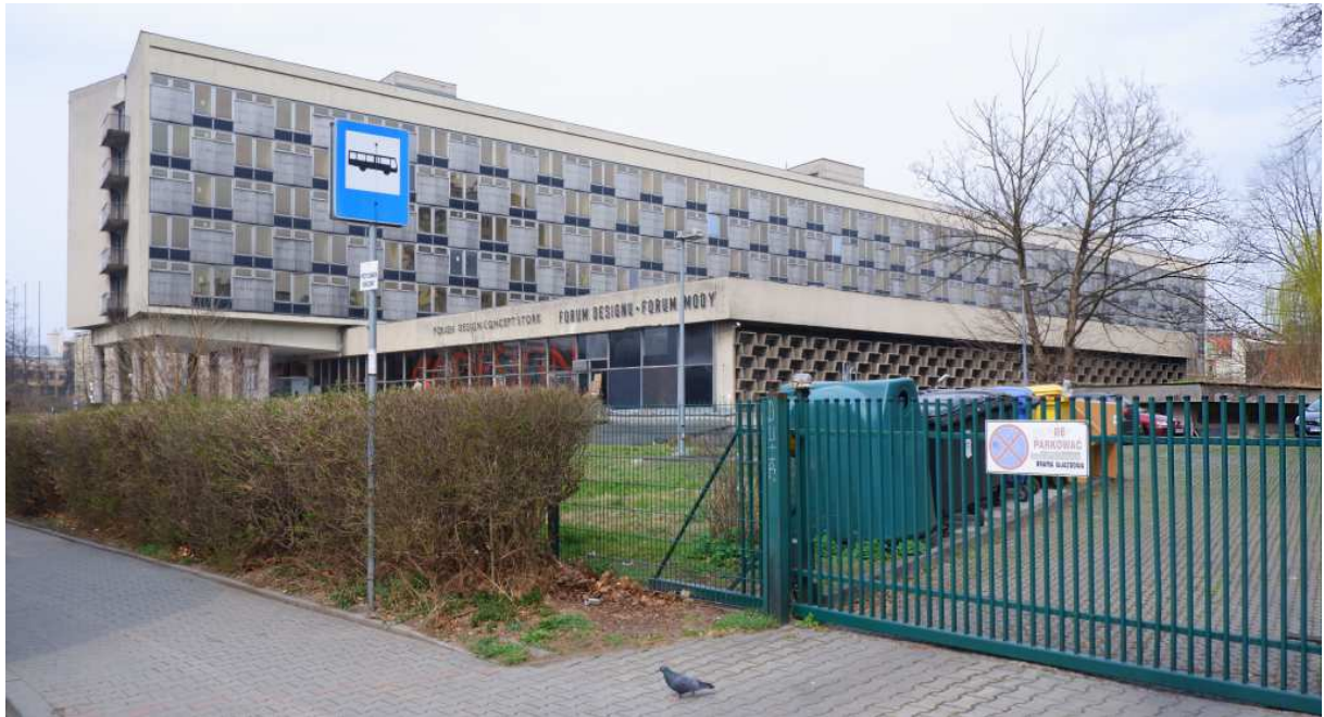
Fot. nr 72 (72-73). Dawny Hotel Cracovia. Tylny fragment w ujęciu z ulicy Kałuzy. Stan przed spodziewaną budowlaną burzą. (29.03.2022)
