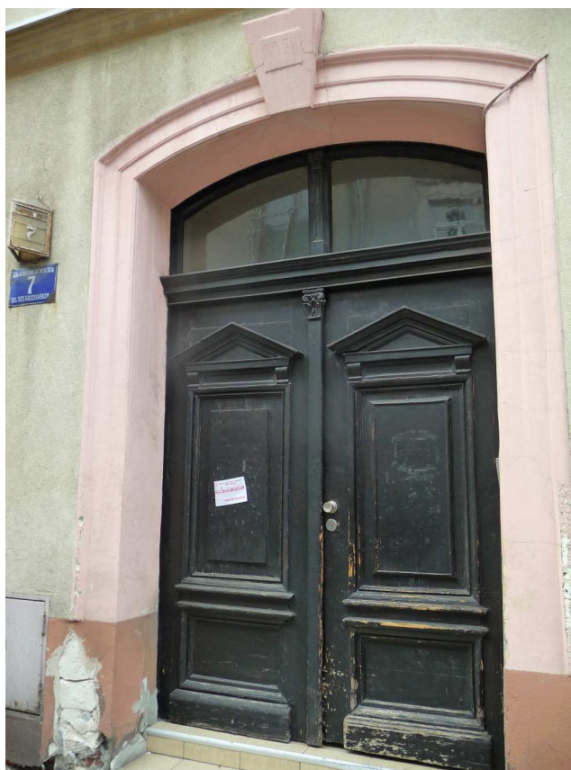
Fot. nr 159. Oryginalne drzwi domu spod nr 7.
