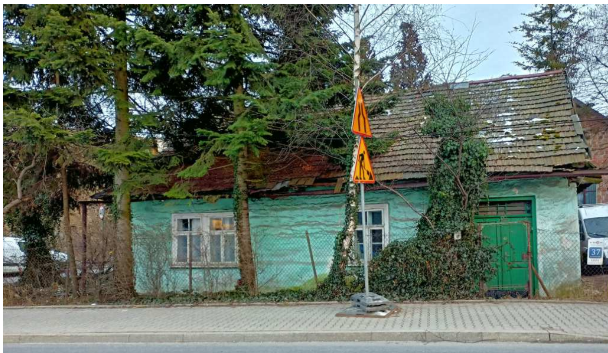
Fot. nr 311. Dawna, zapewne ponad 100-letnia chałupa pod nr 37, która ciągle trwa. (29.01.2023)
