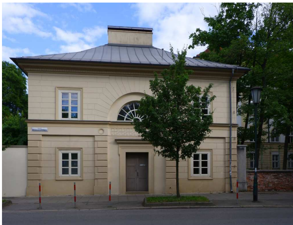
Fot. nr 127 (127-130). Zespół Collegium Śniadeckich, dawnego obserwatorium astronomicznego pod nr 27. Prawa oficyna. (17.06.2022)
