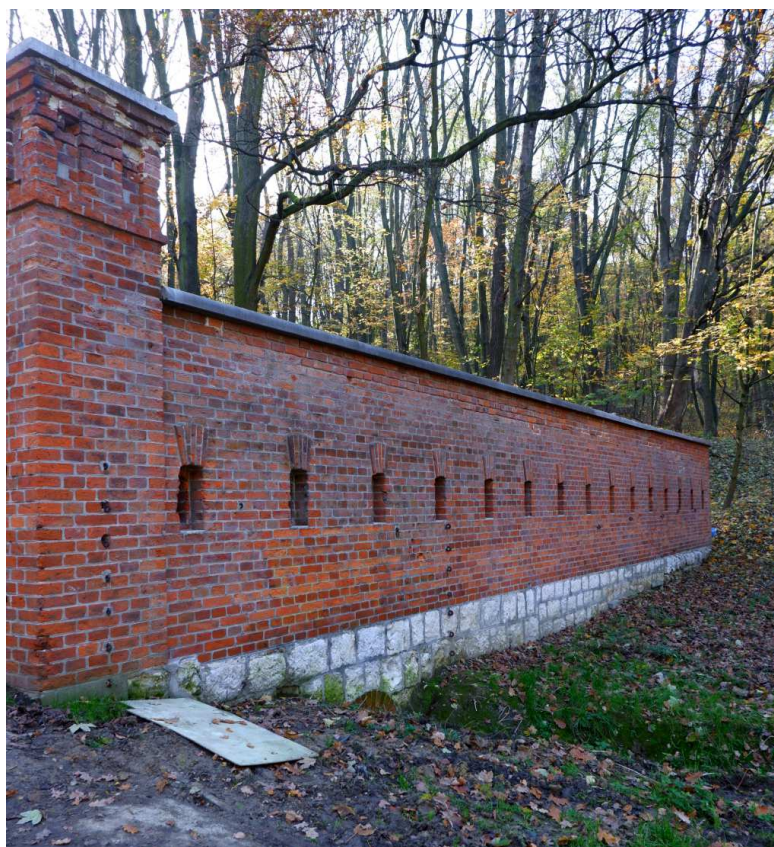
Fot. nr 83. Mur strzelniczy przy bramie. (31.10.2022)
