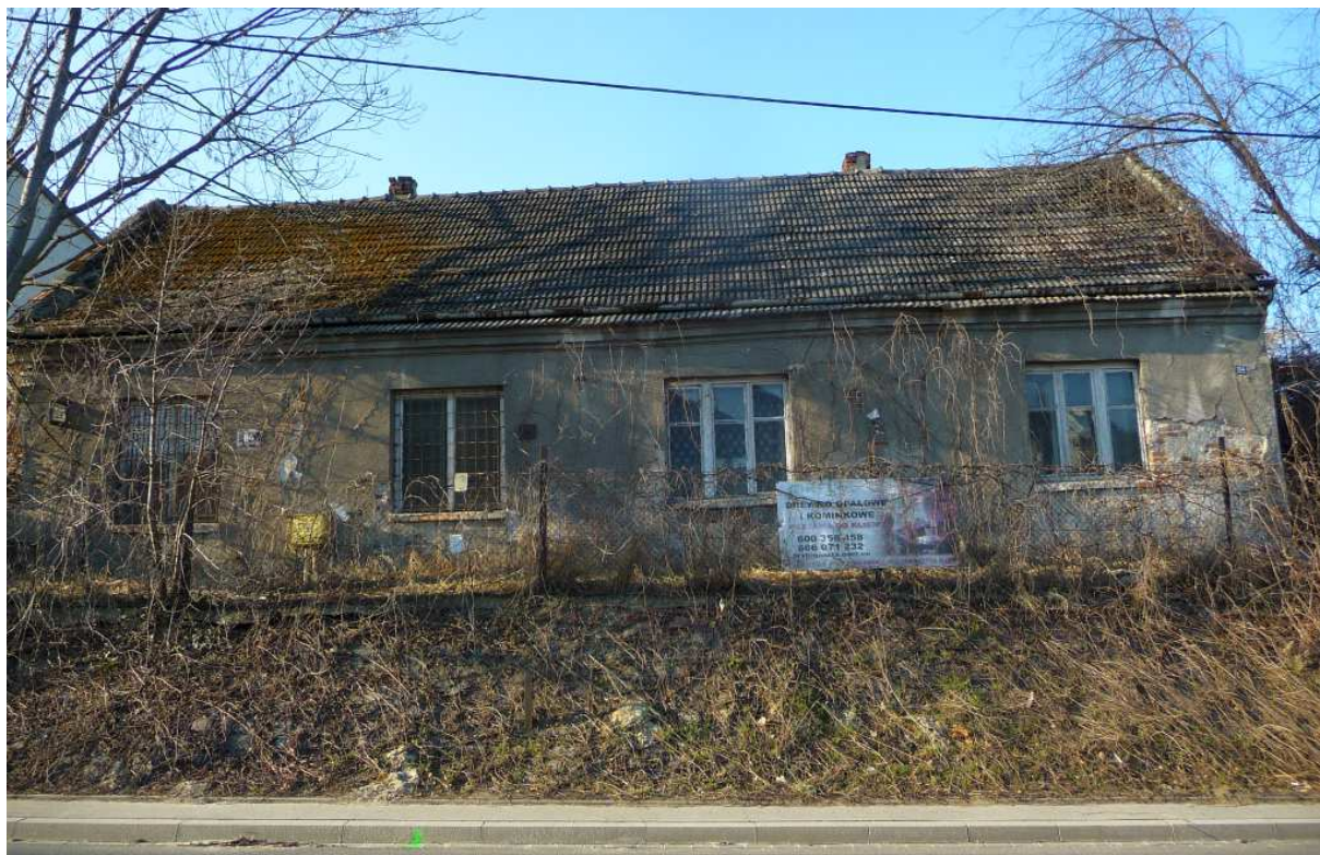
Fot. nr 313. Wspomnienie przedwojennej zabudowy Woli pod nr 84. (28.02.2023)
