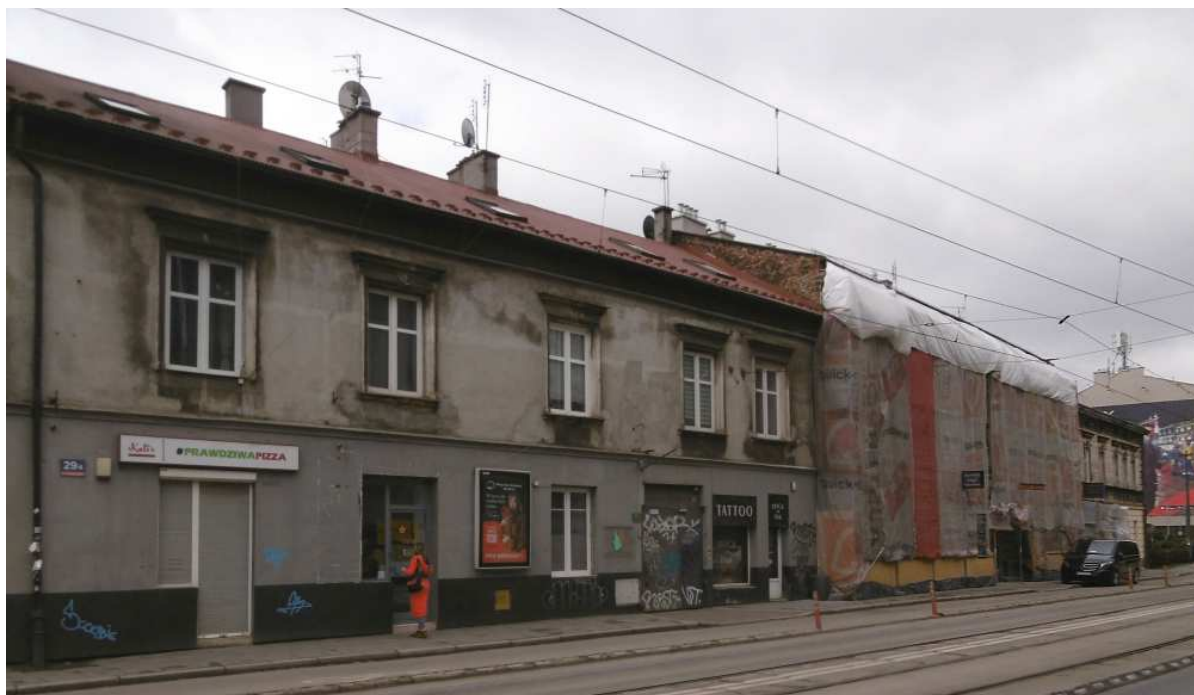
Fot. nr 150 (150-153). Wzdłuż ulicy Grzegórzeckiej. Fragment niskiej zabudowy poniżej numeru 31, powstałej głównie w ostatniej dekadzie XIX (06.04.2022)
