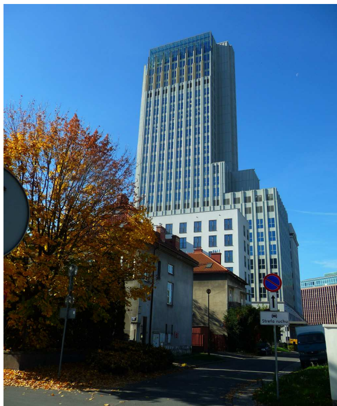
Fot. nr 174 (174-175). Dawny „szkieletor” z ronda Mogilskiego, dziś obudowany i dodatkowo rozbudowany. Ujęcie z alei Beliny-Prażmowskiego. (18.10.2022)
