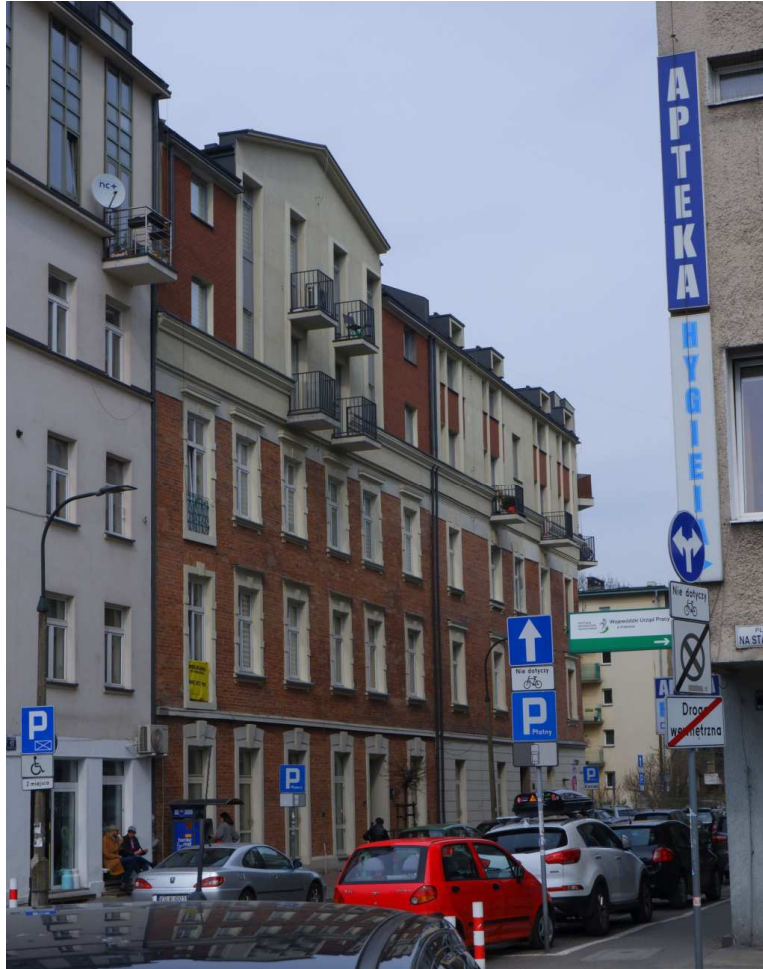
Fot. nr 70. Karkołomna nadbudowa kamienicy z ulicy Stachowicza 13. (29.03.2022)
