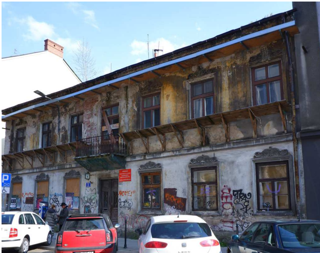
Fot. nr 11. Ruina 150-letniej kamieniczki przy ulicy Batorego 8. (19.04.2022)
