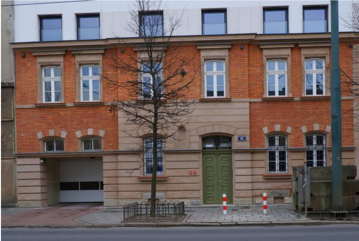
Fot. nr 58 (58-59). Fasada domu pod nr 60 „wklejona” w apartamentowiec. (29.03.2022)
