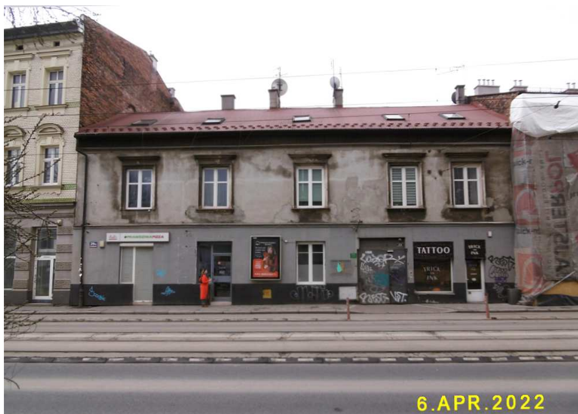
Fot. nr 151. Jednopiętrowy dom spod nr 29, wybudowany ok. roku 1890.
