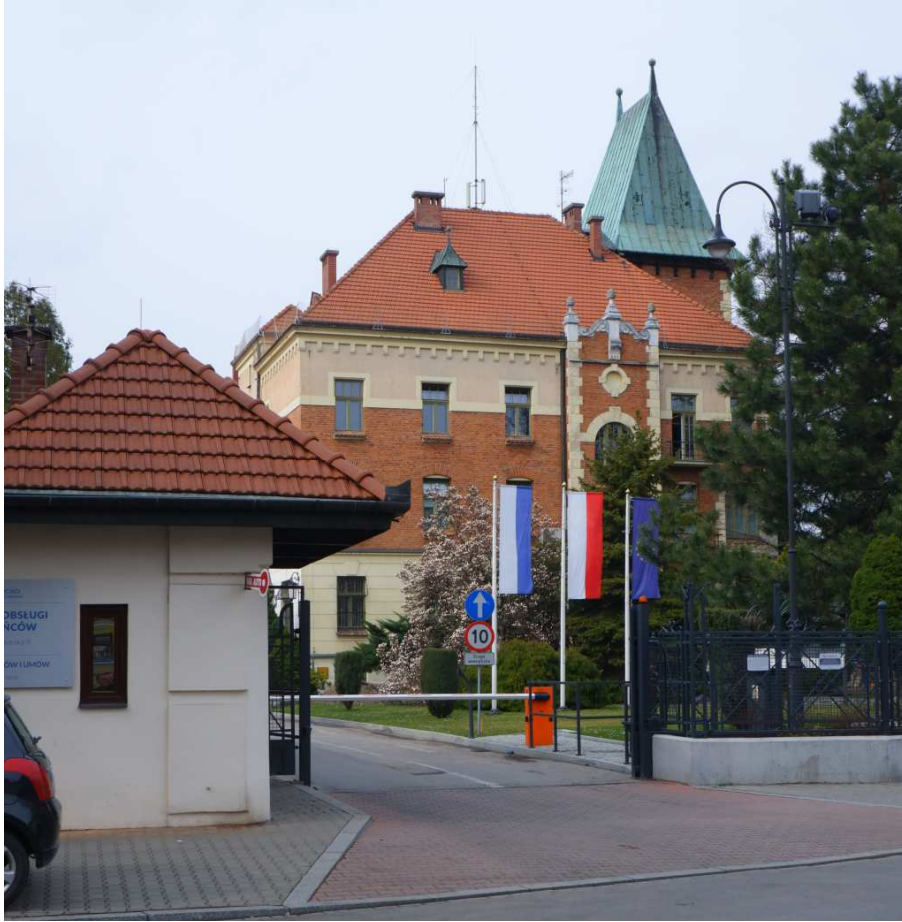
Fot. nr 68. Dworzec Wodociągowy z ulicy Łowieckiej 2, perła eklektyzmu. (29.03.2022)
