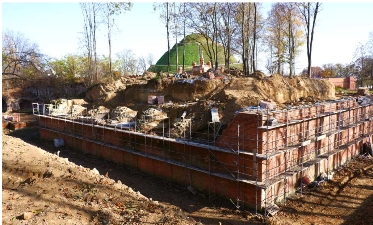
Fot. nr 77. Odtworzone mury ceglanych ścian we fragmencie fortu w sąsiedztwie bastionu nr 2, gdzie trwają prace rekonstrukcyjne, dla mnie wreszcie, bo czekałem na to od dziecka.
