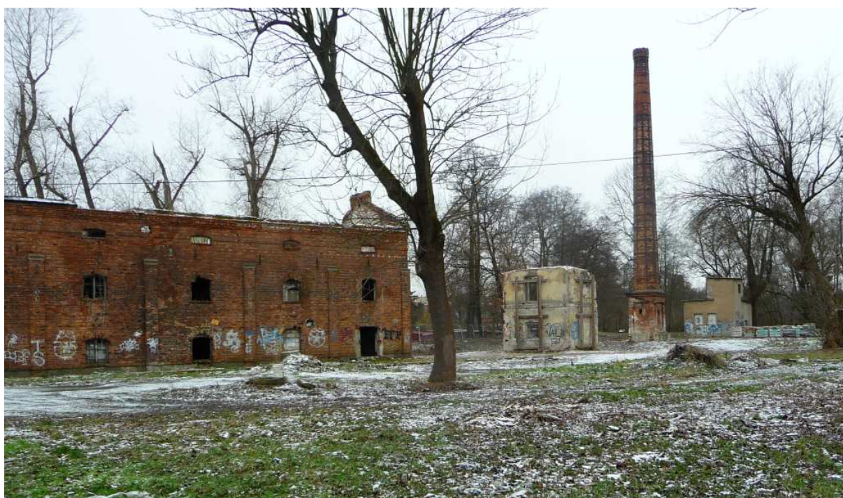
Fot. nr 203 (203-204). Widoki od strony ulicy Podrzecze po częściowych wyburzeniach. (03.02.2023)
