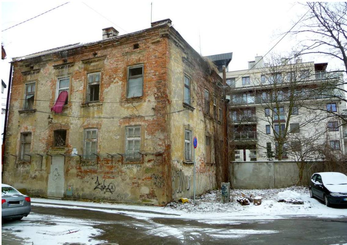
Fot. nr 286. Ruina dawnego domu pracowników pobliskich zakładów garbarskich spod nr 16, wybudowanego w latach 30. XX wieku. (05.02.2023)
