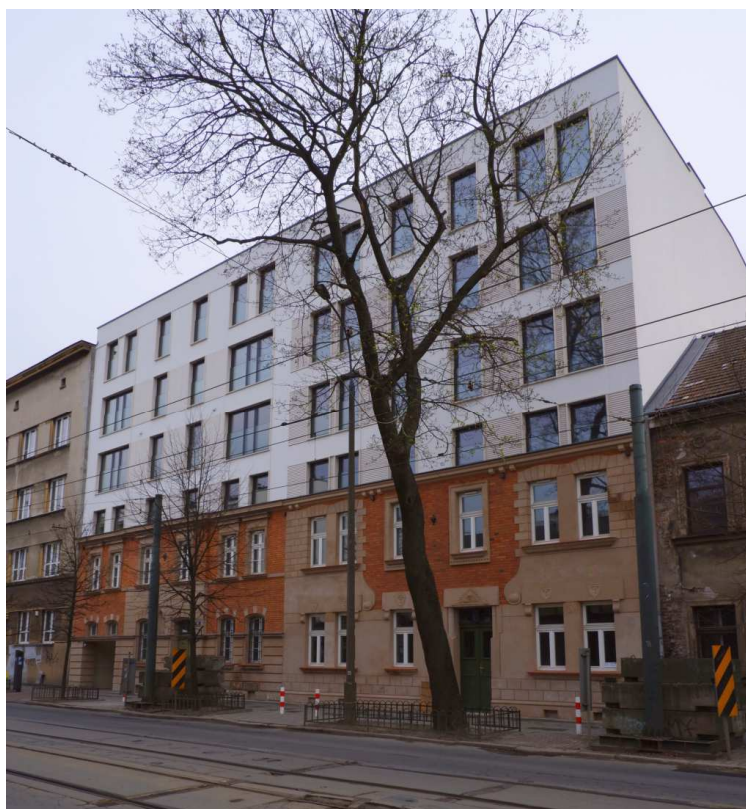
Fot. nr 57. Apartamentowiec powstały kosztem zabytkowej tkanki o nr: 60-62. Pozostały tylko ściany domów fasadowe, wklejone w jego kilkupiętrową bryłę. (29.03.2022)
