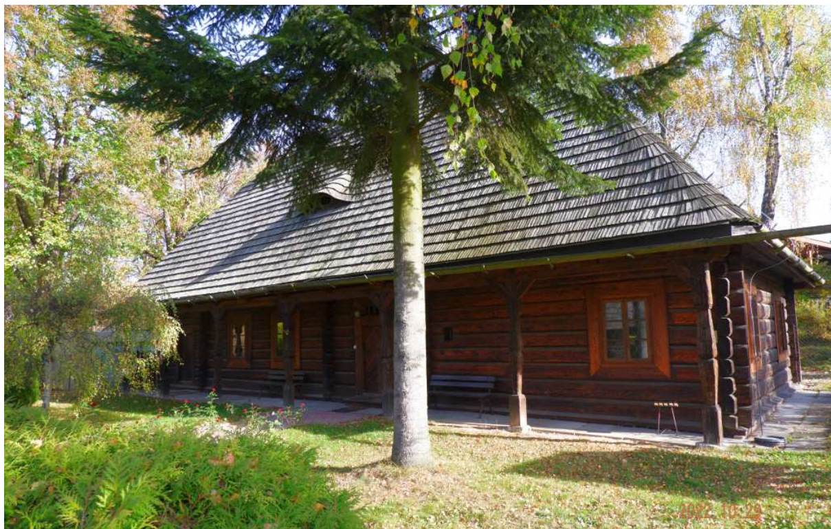
Fot. nr 97 (97-98). Fasada z podcieniowymi arkadami. (29.10.2022)
