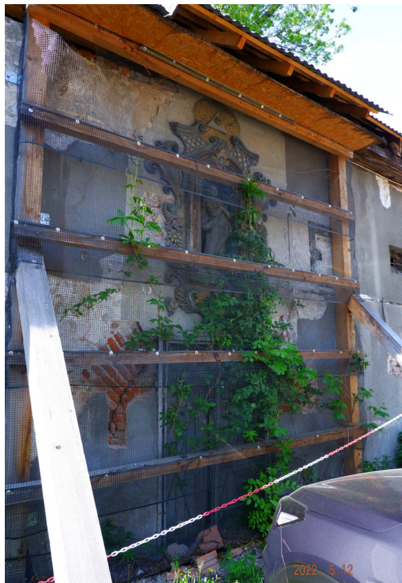
Fot. nr 9 (9-10). Rokokowa figura z roku 1753 w trakcie przygotowania do zabiegów konserwacyjnych. Na szczęście sama ściana oficyny została ostatnio wzmocniona, bo zagrażało jej zawalenie.
