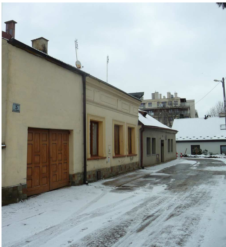
Fot. nr 295. Fragment zabudowy ulicy Swoboda poniżej domu pod nr 5. (05.02.2023)
