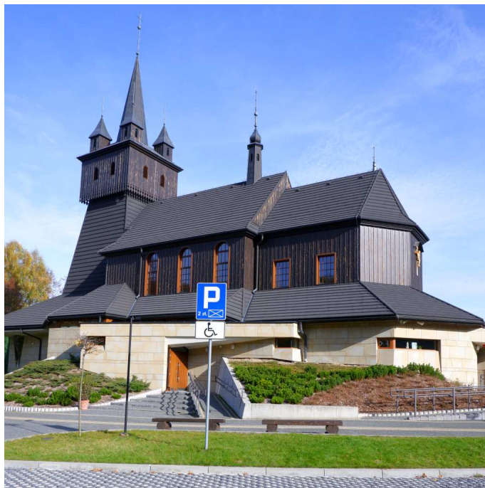
Fot. nr 92 (92-94). Nowo wybudowany, w miejscu dwóch spalonych drewnianych poprzedników, kościół p.w. Najświętszej Marii Panny Królowej Polski. (29.10.2022)
