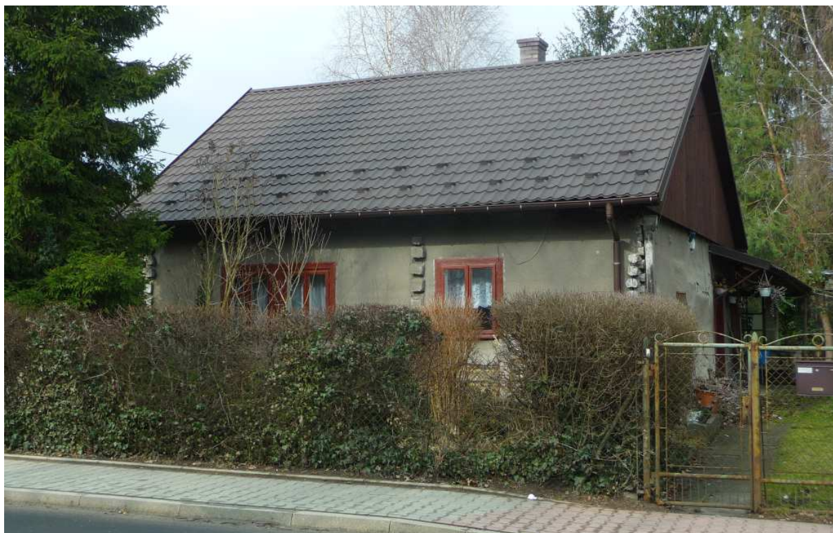
Fot. nr 314. Ukryta pod tynkiem drewniana faktura domu, a może nawet ponad 100-letniej chałupy, spod nr 114. (24.02.2023)
