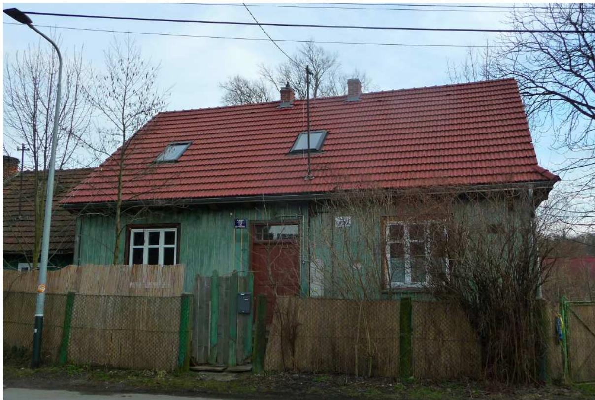
Fot. nr 384. Fasada od strony ulicy po wymianie okien na współczesne plastiki. (07.03.2023)
