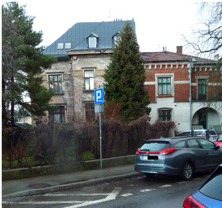
Fot. nr 216 (216-218). Fragment zabudowy willowej pod nr: 24 i 26. (05.01.2023)
