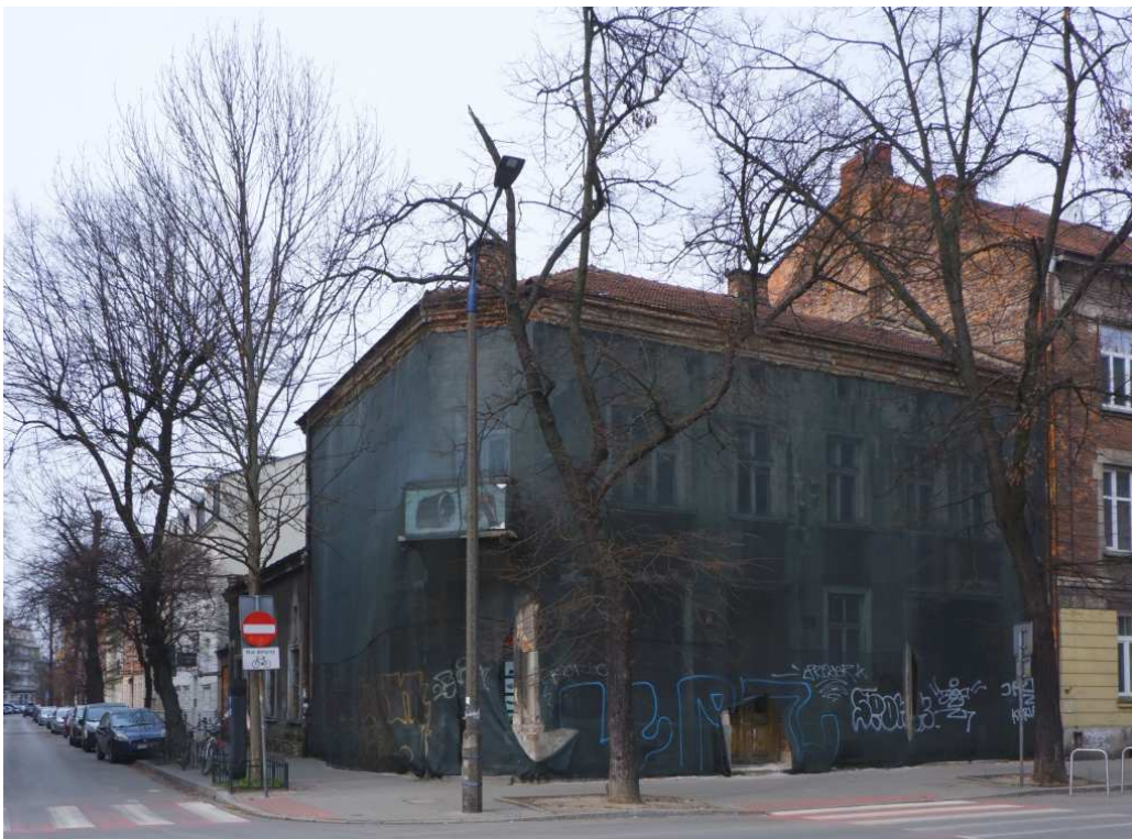
Fot. nr 67. Dom z naroża ulicy Senatorskiej 5 i Filareckiej 1 w oczekiwaniu na rozbiórkę. Po dawnej wytwórni wód gazowanych Jaworskiego wkrótce nie będzie śladu. (29.03.2022)
