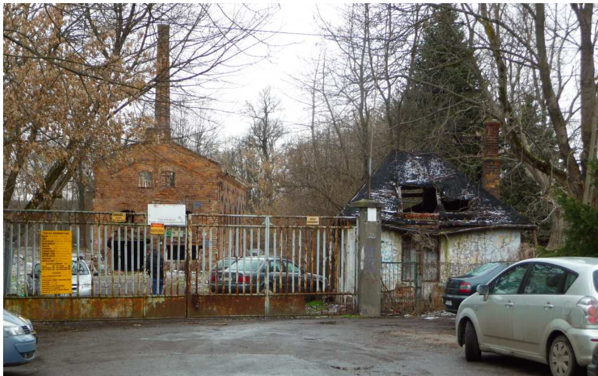
Fot. nr 202 (202-204). Powstały ok. roku 1915, przy młynówce Dłubni, zespół dawnego młyna Lelity przy ulicy Kocmyrzowskiej 3a-5 w przeddzień przebudowy na blokowisko mieszkalne. (03.02.2023)
