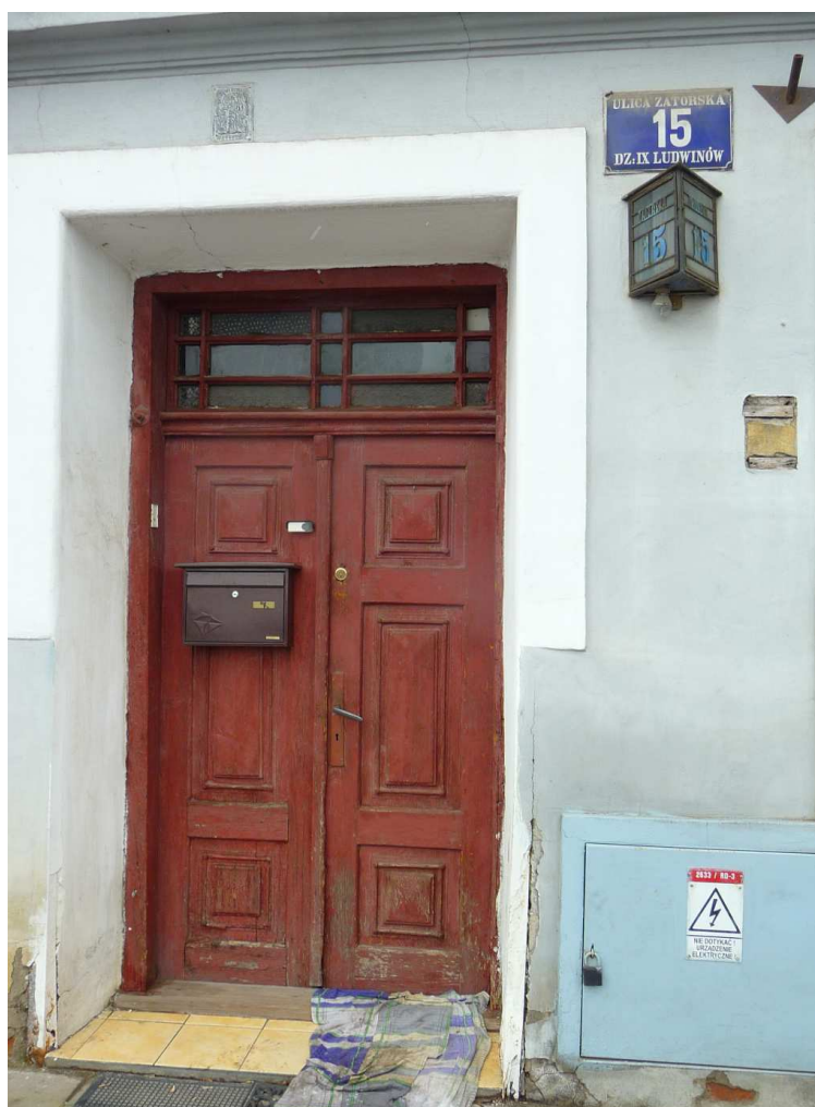
Fot. nr 275. Drzwi ze świetlikiem i tabliczką z czasów Wielkiego Krakowa. (05.02.2023)
