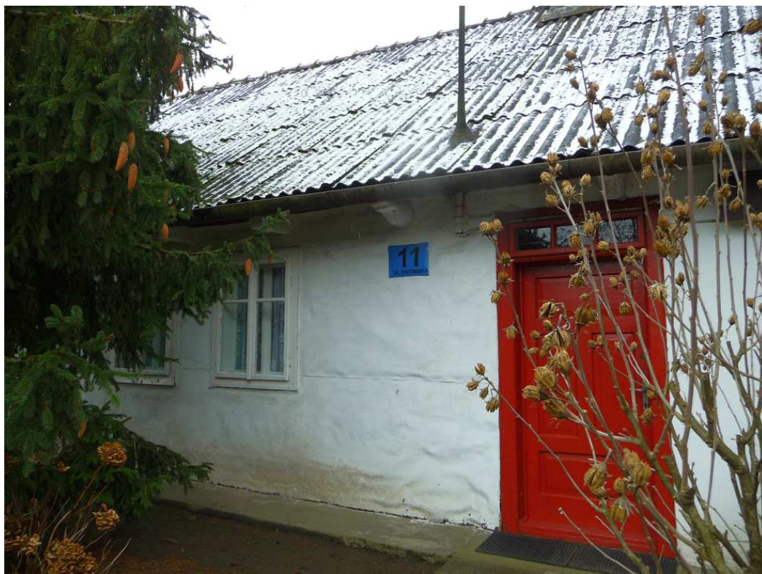
Fot. nr 186 (186-187). Chałupa z początku XX. wieku pod nr 11. Oryginalne detale bielonej fasady. (03.02.2023)
