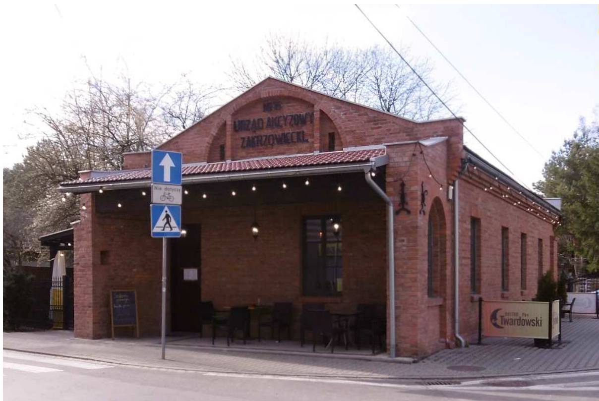
Fot. nr 244 (244-245). Odnowiony i przeznaczony na cele gastronomiczne budynek dawnej rogatki zakrzowieckiej (nr 16) pod nr 45, gdzie pierwotnie mieściła się brama w zespole obwarowań Twierdzy Kraków, powstała ok. roku 1890. (06.04.2022)
