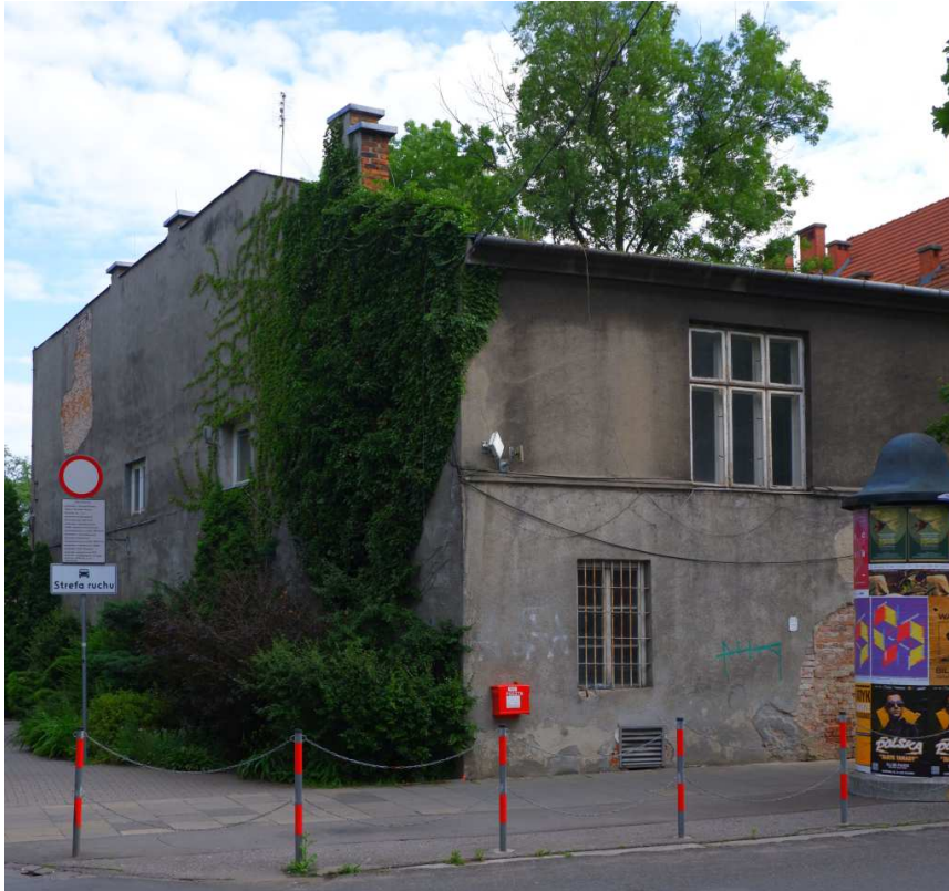
Fot. nr 124. Portiernia przy wjeździe z ulicy Kopernika w ulicę Śniadeckich. (17.06.2022)
