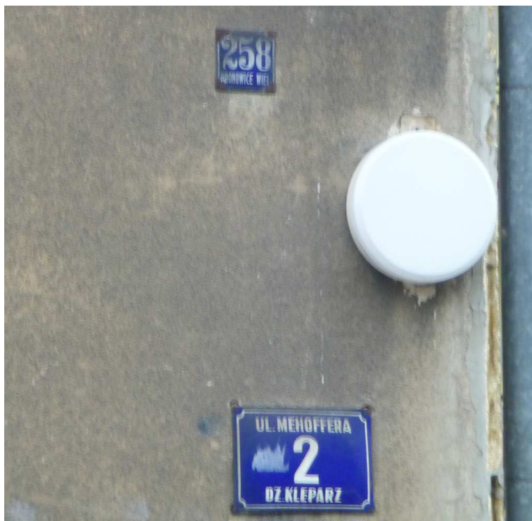
Fot. nr 114. Detale na ścianie bocznej. (14.11.2022)
