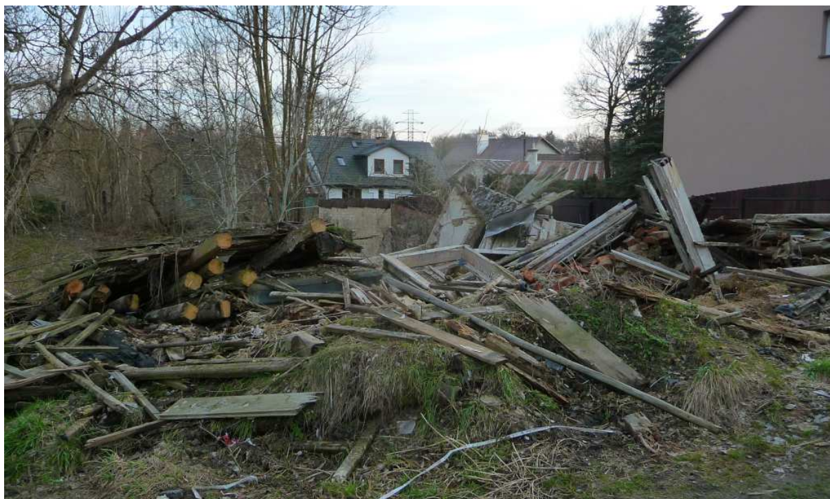
Fot. nr 391. Smutne pozostałości po drewnianym domu z gankiem z ulicy Mokrej 26. (07.03.2023)
