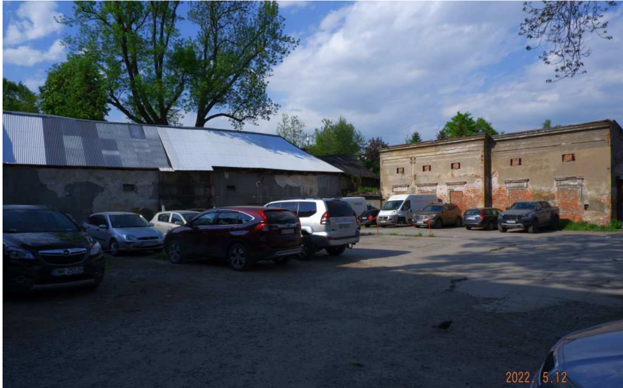
Fot. nr 18. Narożnik północno-wschodni.
