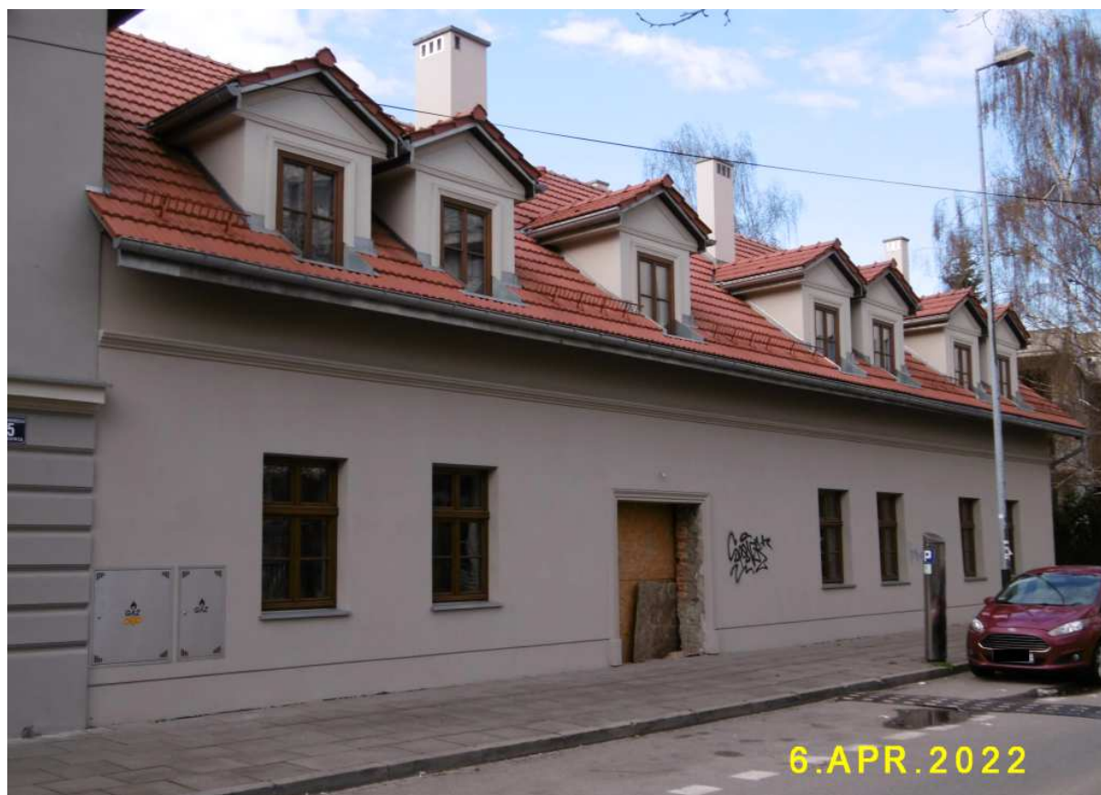
Fot. nr 262. Budynek dawnej karczmy, przylegający do dworu.
