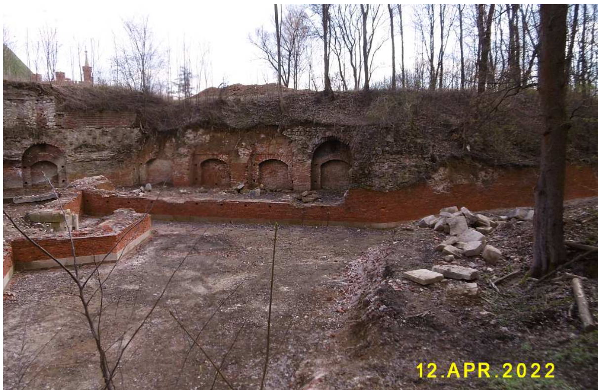
Fot. nr 79. Na przedpolu zrujnowanego bastionu nr 2, gdzie odkopane zostały partie przyziemia.
