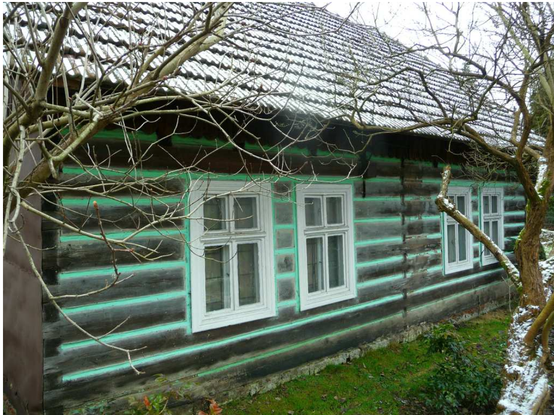
Fot. nr 207. Przykładnie malowana fasada i tylko okna nie są już oryginalne. (03.02.2023)
