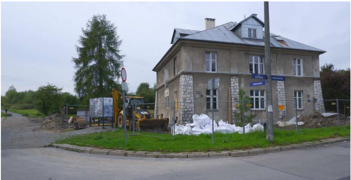
Fot. nr 307 (307-308). Remontowany, dawny budynek pracowników nowego podgórskiego kirkutu przy ulicy Jerozolimskiej 3, powstały na początku lat 30. XX wieku, który w czasie istnienia KL Płaszów był siedzibą ss-manów i lokalną katownią. Przy budynku rozpoczęły się prace remontowe związane z utworzeniem na terenie byłego obozu koncentracyjnego Muzeum KL Płaszów. (24.09.2022)
