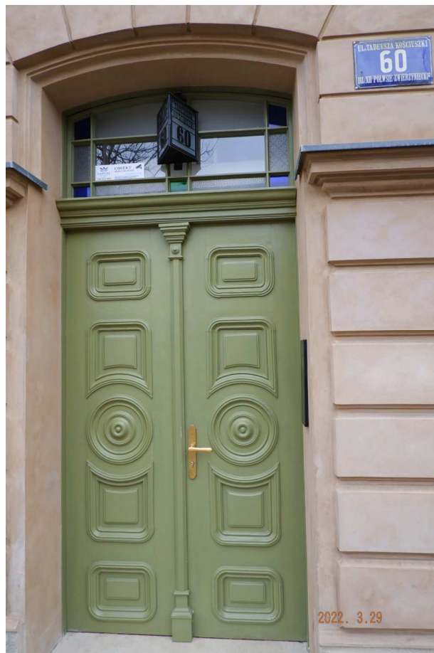
Fot. nr 59. Przynajmniej drzwi kamienicki zostały wzorowo odnowione.
