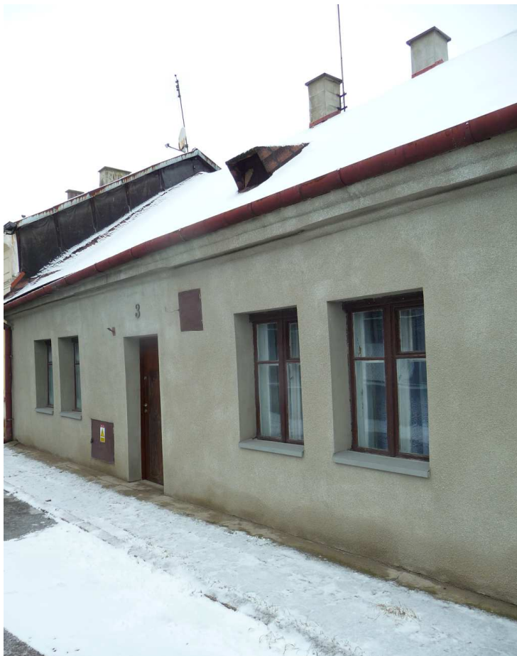
Fot. nr 294. Parterowy, typowo podmiejski dom spod nr 3. (05.02.2023)
