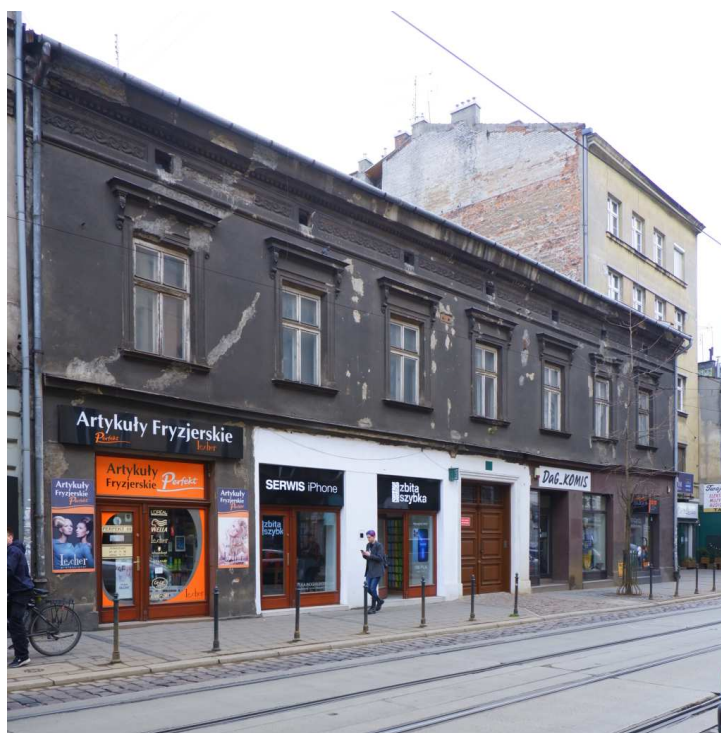
Fot. nr 33. Dom pod nr 12. (29.03.2022)
