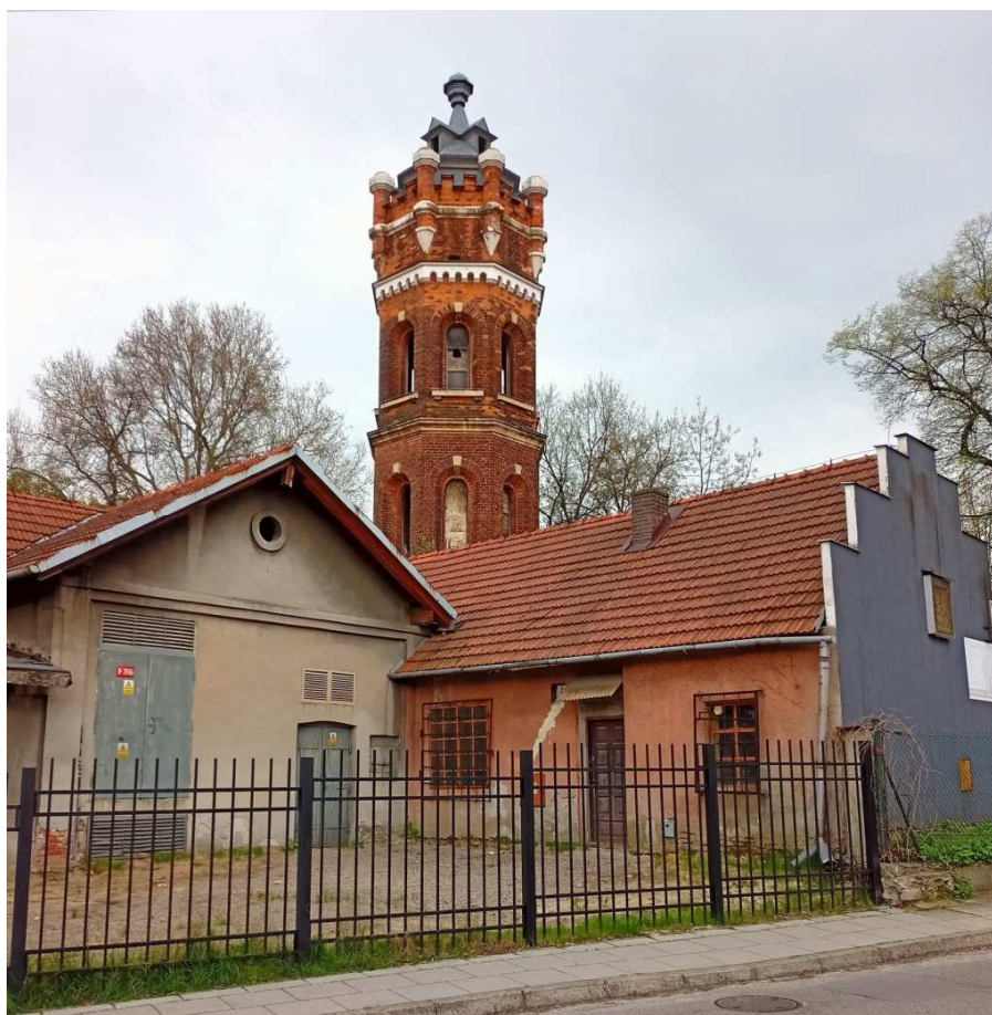
Fot. nr 365. Dawna wieża ciśnieniowa w majątku Jerzmanowskich, przerobiona na początku XX wieku z dawnej wieży widokowej. (01.05.2022)
