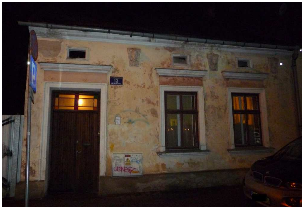
Fot. nr 211. Ciągłe oryginalna fasada. (05.01.2023)
