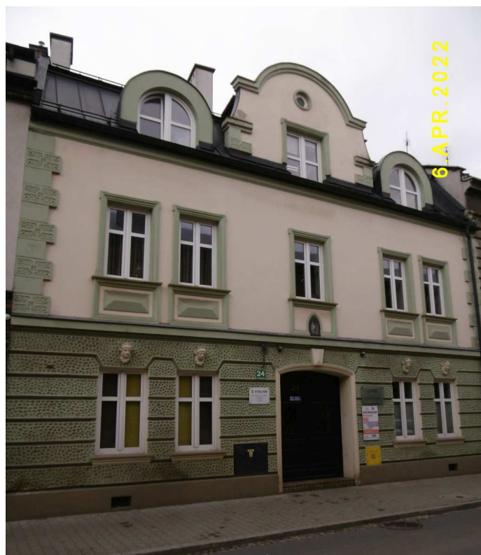
Fot. nr 145. Nadbudowany dom spod nr 24.
