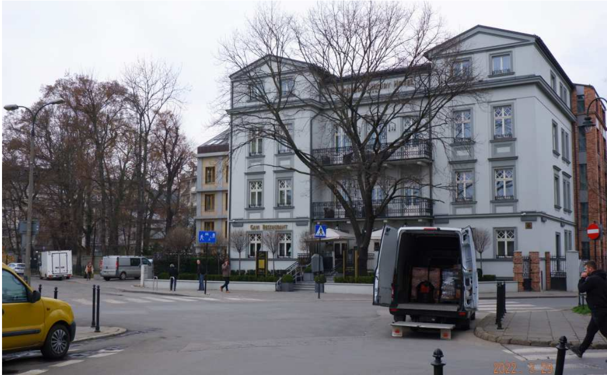
Fot. nr 36. Przebudowana na hotel dawna willa Medyńskich z placu Kossaka 6. To przykład „zabytku – wydmuszki” z całkowicie wyprutym wnętrzem. (29.03.2022)
