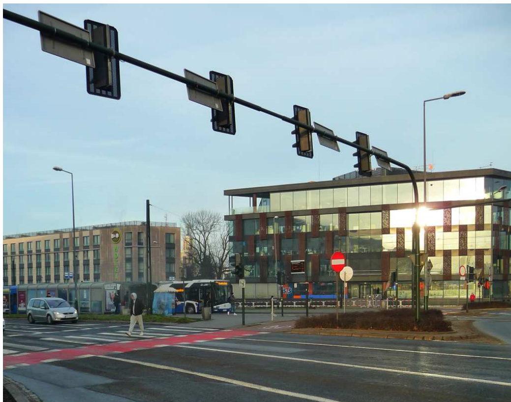
Fot. nr 208. Nowa zabudowa w narożu ulic: Monte Cassino i Kilińskiego. (02.01.2023)
