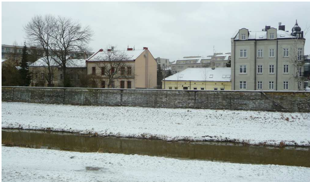
Fot. nr 278 (278-279). Widoki na zabudowę ulicy Przedwiośnie w prawobrzeżnym fragmencie Ludwinowa, oddzielonym w latach 30. XX wieku od reszty dawnej wsi przez nowo powstały kanał Wilgi. (05.02.2023)
