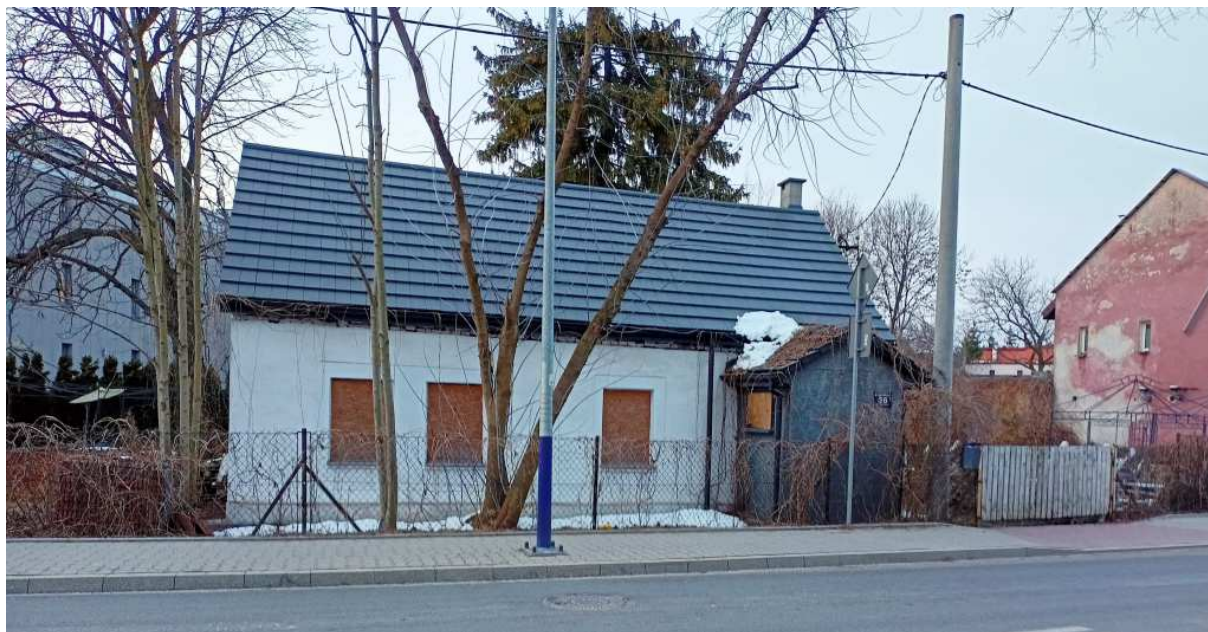
Fot. nr 310 (310-321). Wzdłuż ulicy Malborskiej. Dom pod nr 36. (29.01.2023)
