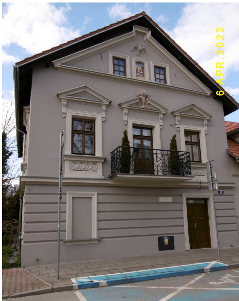
Fot. nr 260. Przykładnie odnowiona fasada.
