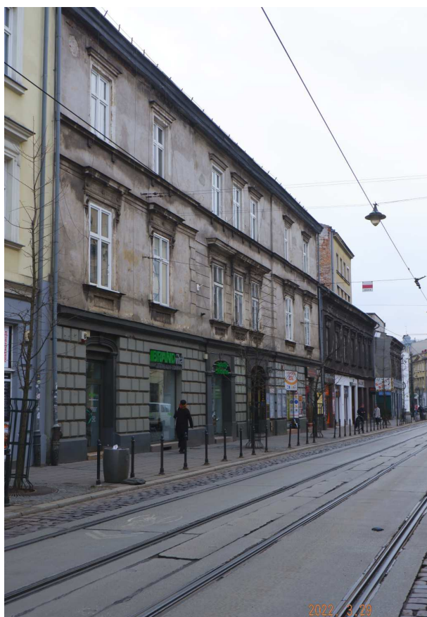
Fot. nr 32 (32-35). Zabudowa ulicy Zwierzynieckiej; tu fragment powyżej nr 10. Niska zabudowa powstawała od przełomu III. i IV. ćwierci XIX wieku. (29.03.2022)
