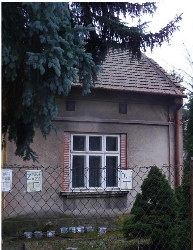
Fot. nr 410. Oryginalny detal przedwojennego domu z ulicy Szpakowej 15. (05.03.2023)
