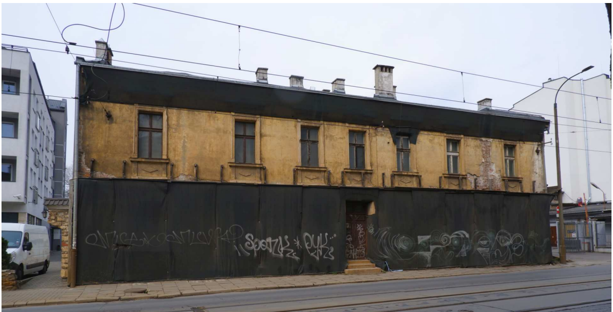
Fot. nr 65. Dom pod nr 51 z zespołu dawnych Garaży Meta, wybudowanych na początku II. ćwierci XX wieku. (29.03.2022)
