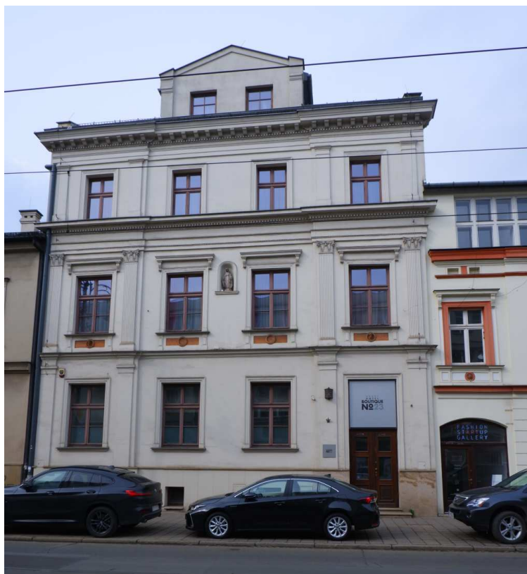
Fot. nr 41. Nadbudowana kamienica pod nr 23. (29.03.2022)
