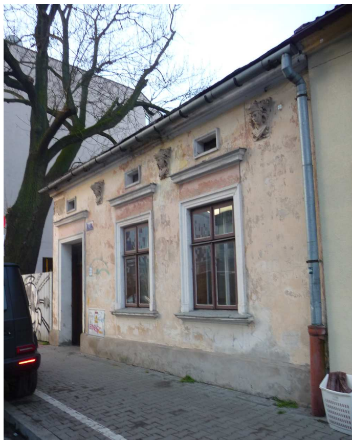
Fot. nr 210 (210-211). Wybudowany w roku 1912 dom pod nr 13. (02.01.2023)
