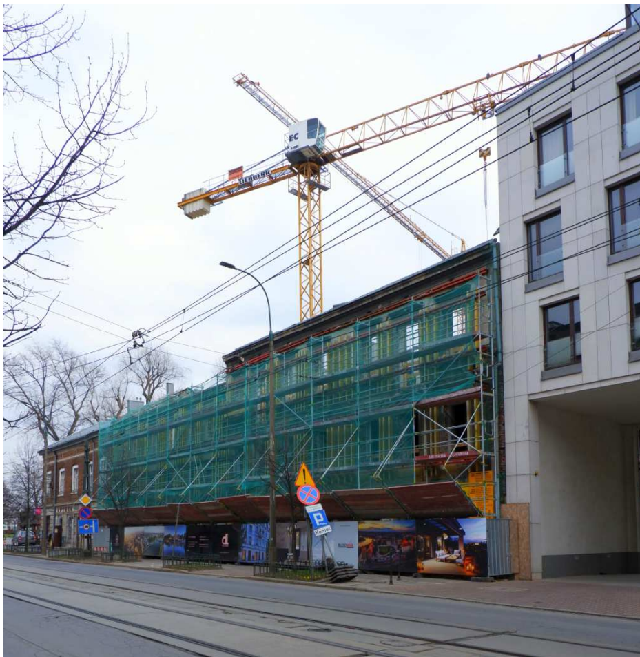
Fot. nr 46. Przebudowywane na apartamentowce domy pod nr: 20 i 22. (29.03.2022)
