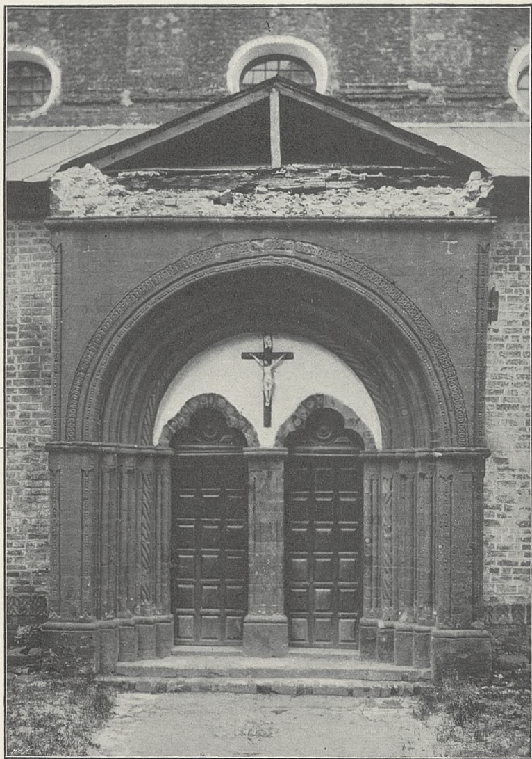
Fig. 1. Sandomierz. Kościół św. Jakóba. Portal główny od strony północnej.
