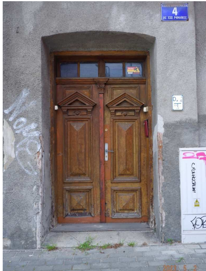
Fot. nr 469. Oryginalne, profilowane w drewnie drzwi i tablica z czasów Wielkiego Krakowa.
