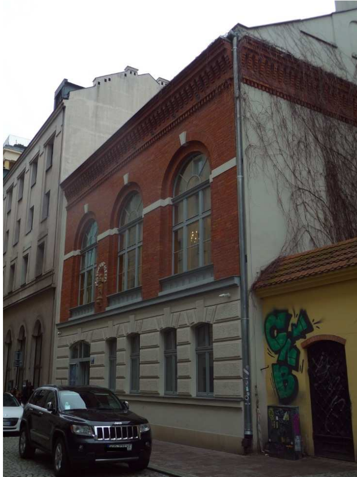
Fot. nr: 46-52. Wzdłuż ulicy św. Tomasza. Fot. nr 46 (46-48). Kamienica spod nr 37 i jej detale. (21.03.2023)
