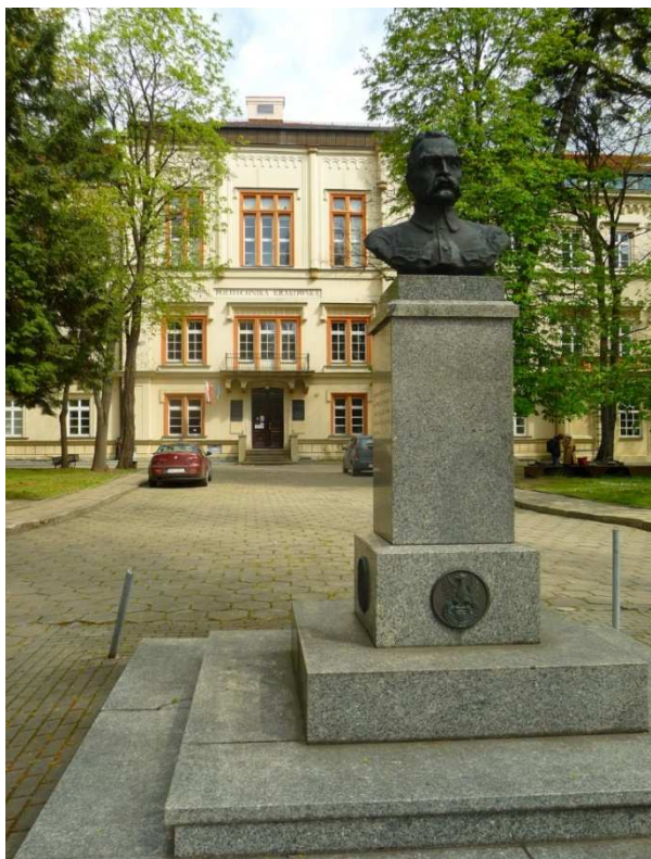
Fot. nr 303 (303-306). Fasada gmachu dawnej Szkoły Kadetów przy ulicy Podchorążych i jej detale. Pomnik Józefa Piłsudskiego na przedpolu budynku. (27.04.2023)
