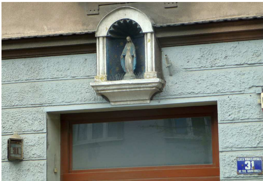
Fot. nr 291. Dom, zapewne z początku XX wieku, pod nr 31, gdzie niestety nie ma już ciekawych drzwi wejściowych. (23.04.2023)
