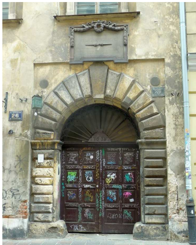
Fot. nr 66 (66-67). Renesansowy portal kamienicy pod nr 26. (25.05.2023)
