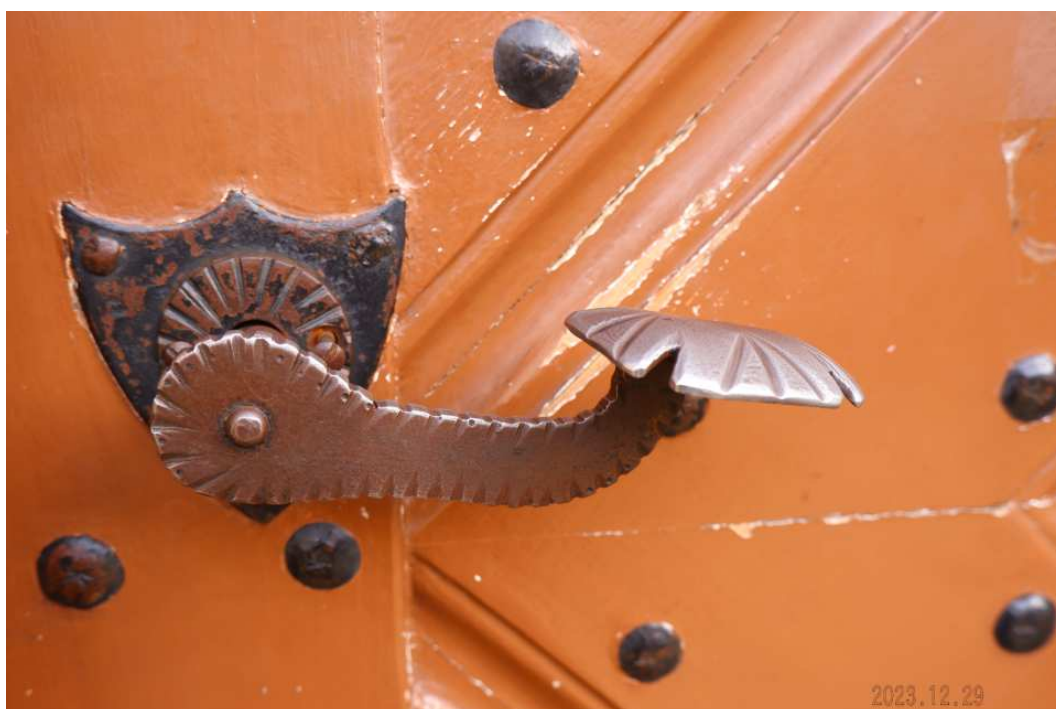
Fot. nr 127. Archaiczna klamka w drzwiach.
