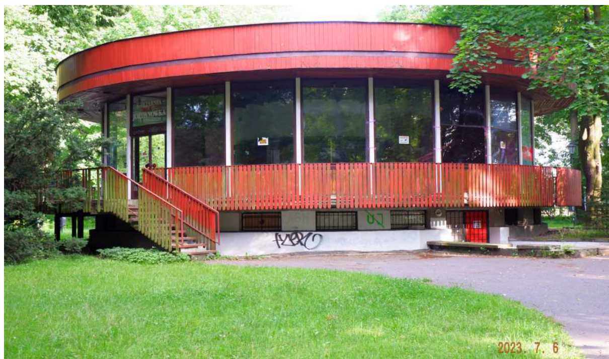
Fot. nr 284. Powstały na początku lat 70. nowy okrągłak, ciągle opuszczony. Nie ma pewności czy pozostanie on w obecnym kształcie, czy powstanie tu nowy obiekt będący rekonstrukcją drewnianego oryginału, co moim zdaniem byłoby najlepszym rozwiązaniem.
