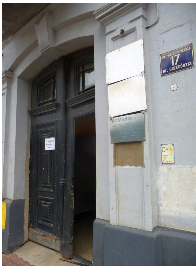
Fot. nr 378. Drzwi kamienicy pod nr 17. (27.06.2023)
