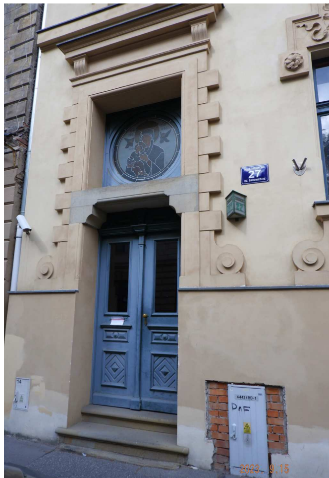
Fot. nr 182 (182-183). Detale parteru kamienicy spod nr 27.
