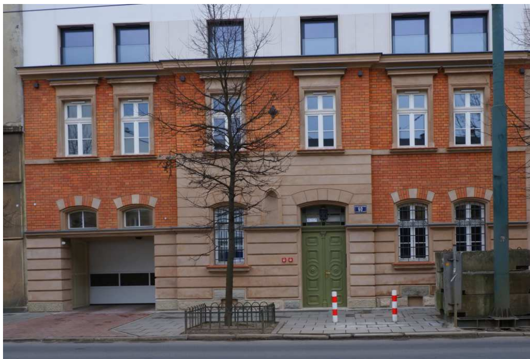
Fot. nr 272 (272-273). Ściana fasadowa domu pod nr 60 „wklejona” w apartamentowiec. (29.03.2022)
