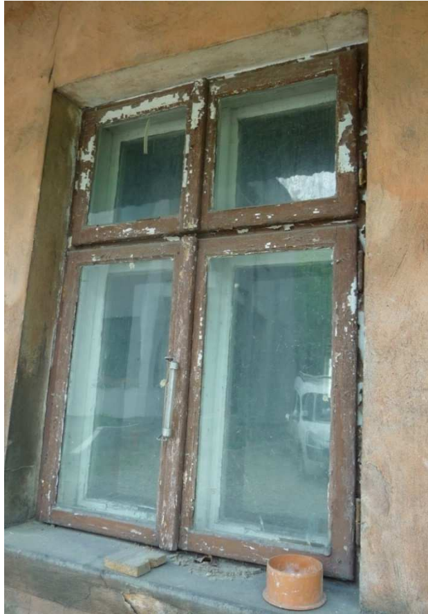
Fot. nr 490. Oryginalne okno typu skrzynkowego. (08.06.2023)
