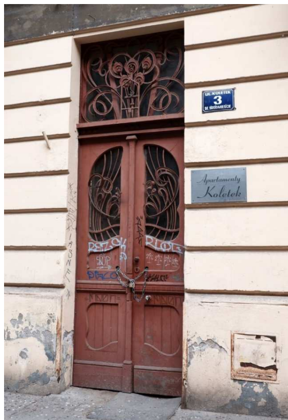
Fot. nr 418. Kamienica pod nr 3. (25.04.2021)
