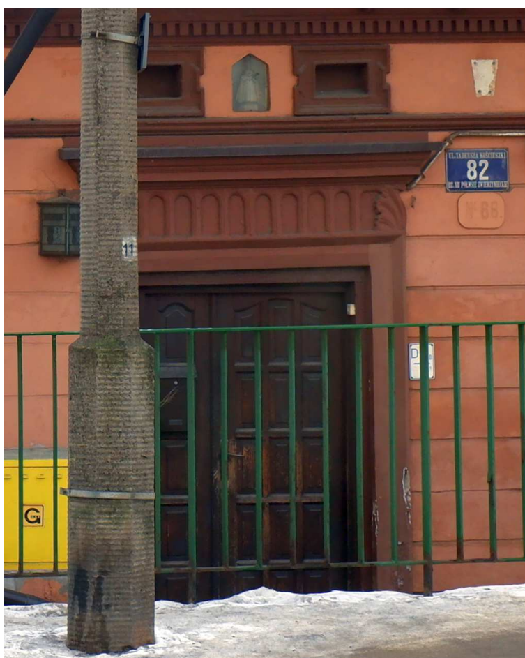
Fot. nr 278. Detale parterowego domku pod nr 82.
