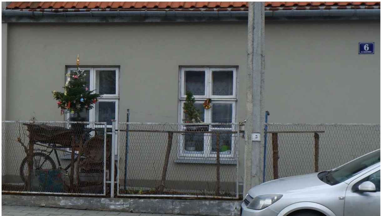
Fot. nr 528. Okna typu skrzynkowego w budynku plebanii przy ulicy Klasztornej 6.
