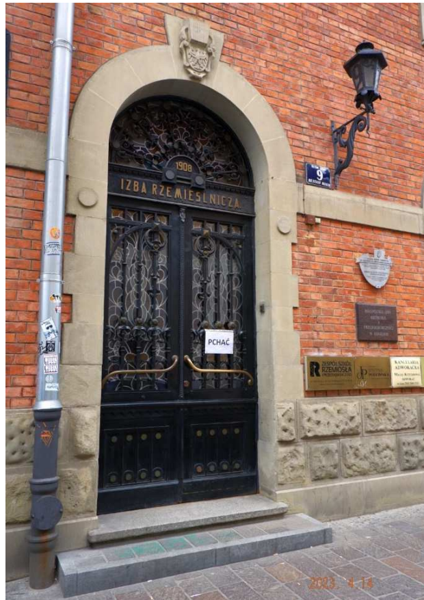
Fot. nr 108. Secesyjne drzwi w budynku Izby Rzemieśniczej przy ul. św. Anny 9.
