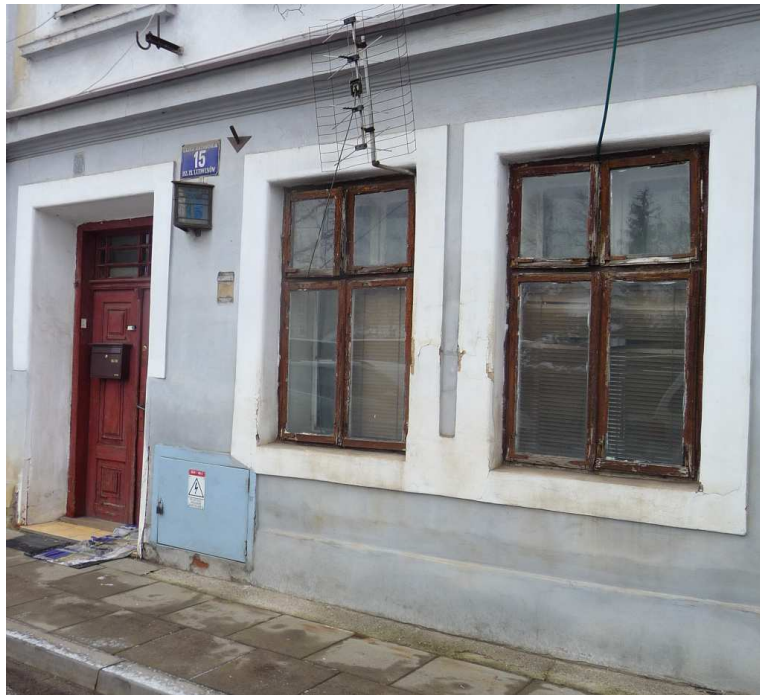
Fot. nr 413 (413-415). Ostałe jeszcze oryginalne detale domu przy ulicy Zatorskiej 15. Okna typu skrzynkowego. (05.02.2023)
