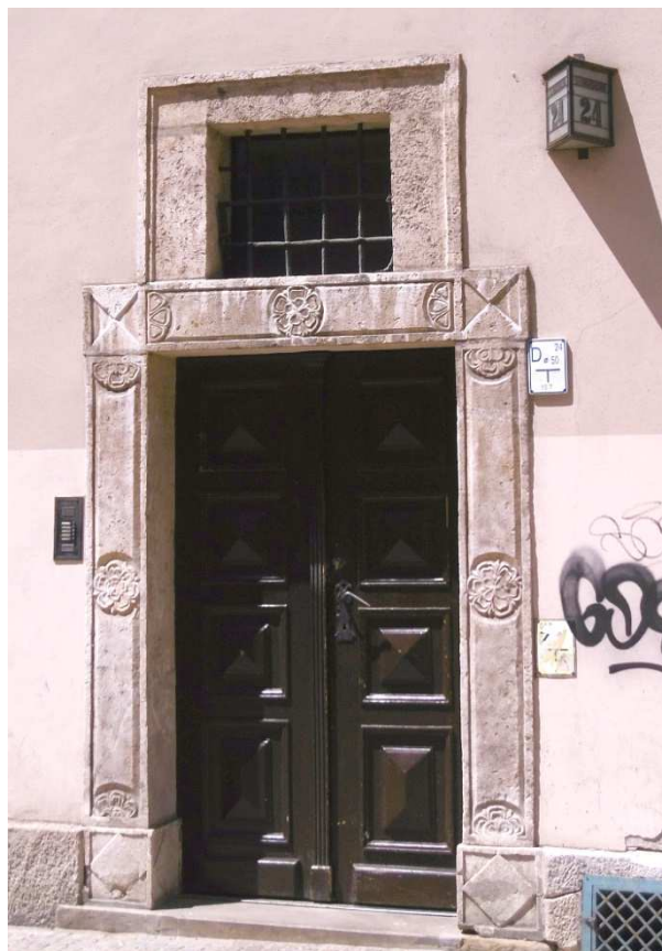
Fot. nr 94. Portal i drzwi w domu zakonu Marków pod nr 24.
