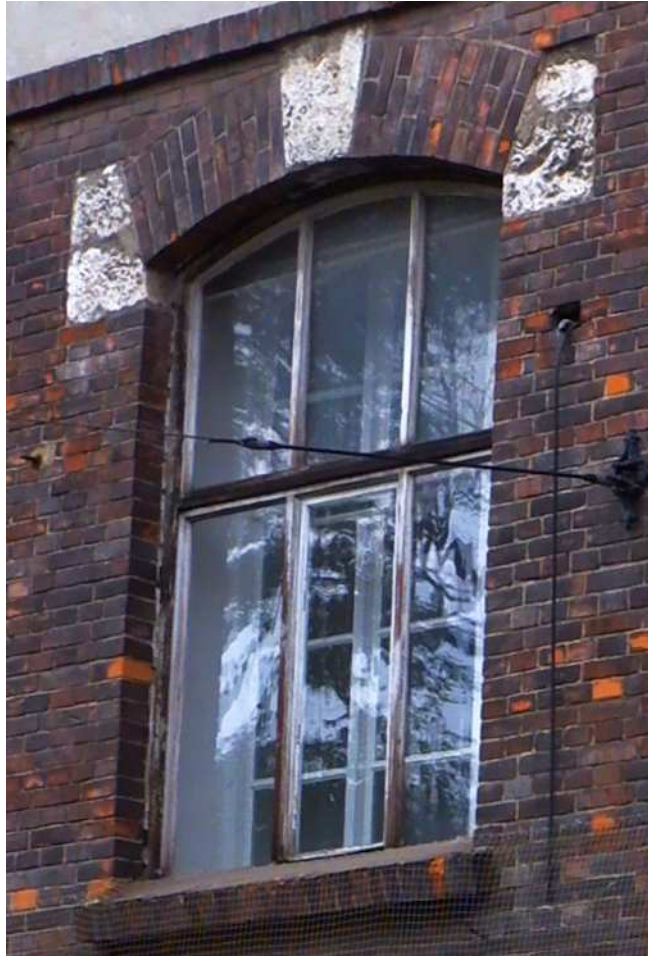
Fot. nr 433. Niemal oryginalne okno dziesięciopolowe, jakie trudno dziś spotkać w Krakowie. (02.07.2022)
