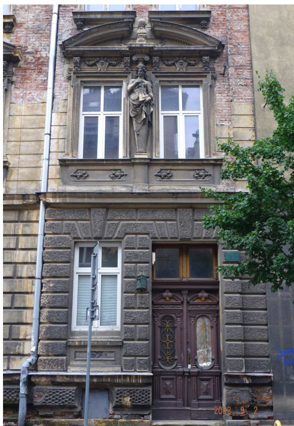
Fot. nr 220. Eklektyczna kamienica, z bogatą z zdobioną fasadą, pod nr 14.
