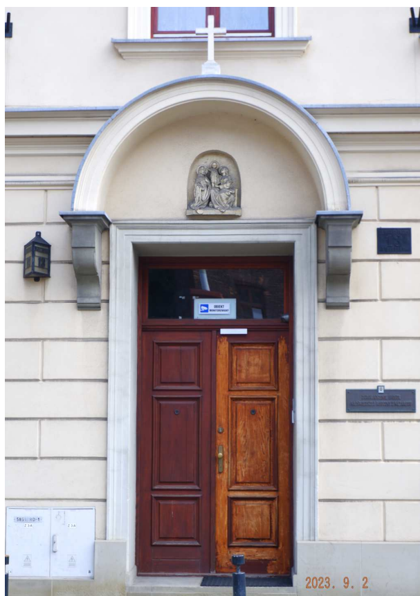
Fot. nr 330. Detale budynku Zgromadzenia Sióstr Najśw. Rodziny z Nazaretu z ulicy Warszawskiej 13.
