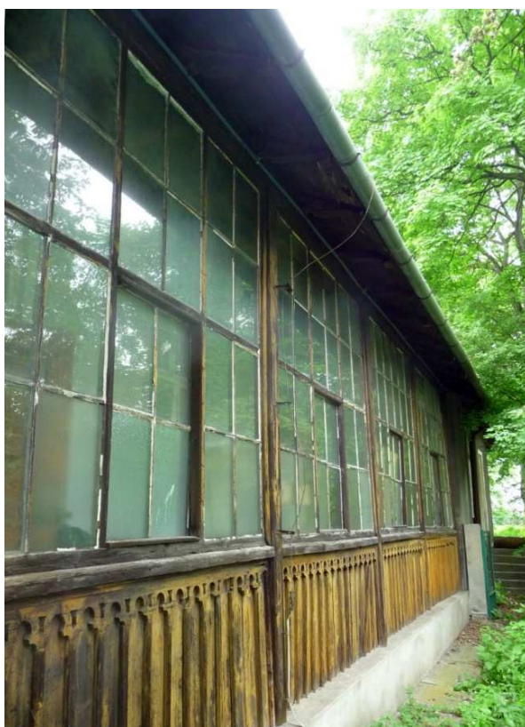
Fot. nr 296. Rozległa weranda od strony ulicy. (25.05.2023)
