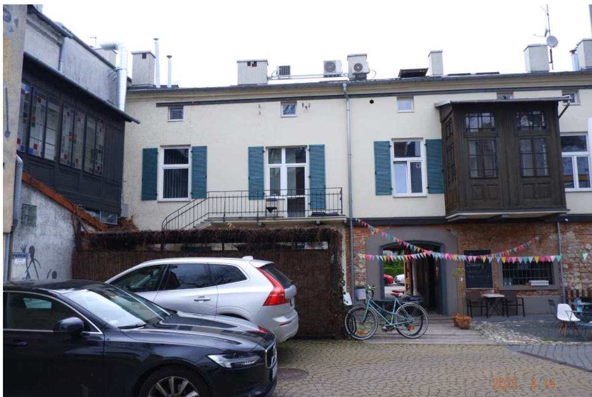
Fot. nr 187 (187-189). Wspólny dziedziniec domów pod nr: 1 i 3 i jego detale.
