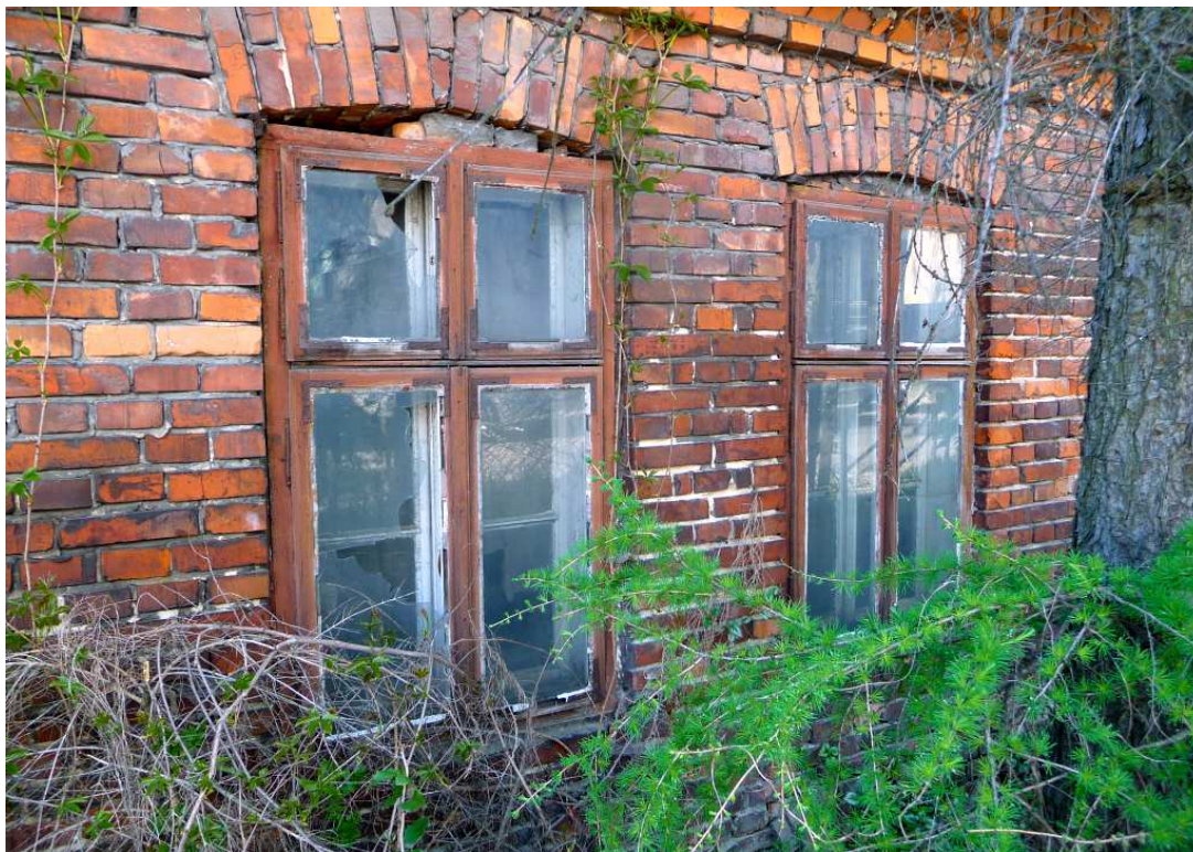
Fot. nr 508. Originalne okna typu skrzynkowego w prawym fragmencie. (11.05.2023)
