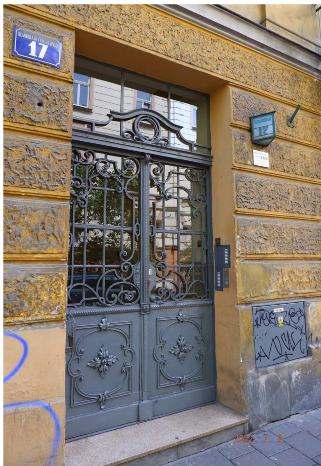
Fot. nr 364. Profilowane w metalu secesyjne drzwi kamienicy z ulicy Zybkiewicza 17.
