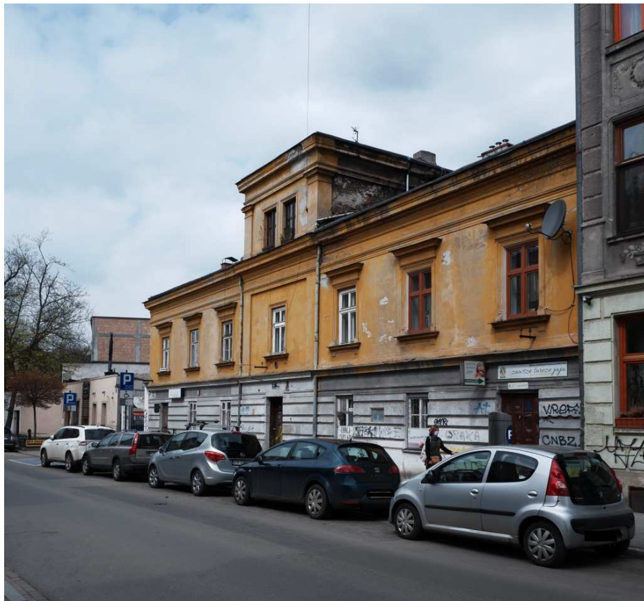
Fot. nr 420 (420-422). Dom pod nr 1 i jego detale. (25.04.2021)
