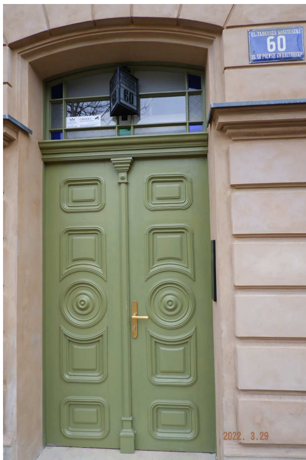
Fot. nr 273. Przynajmniej drzwi kamienicy zostały wzorowo odnowione.
