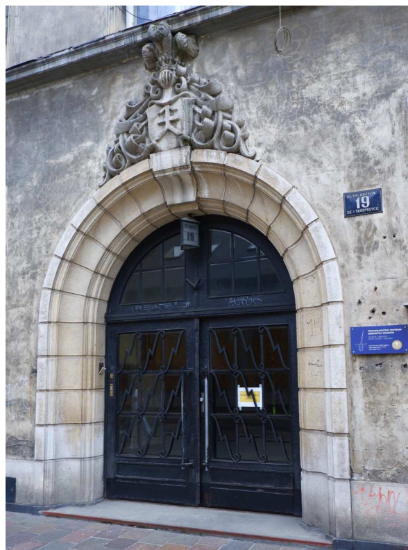
Fot. nr 53. Portal z kartuszem międzywojennej kamienicy z ulicy św. Krzyża 19. (09.07.2022)
