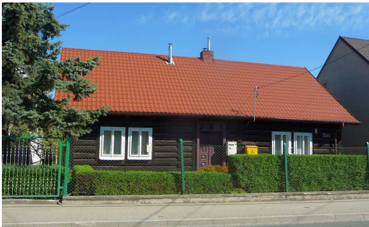
Fot. nr 504 (504-505). Świetnie zachowana drewniana chałupa z ok. roku 1910 z ulicy Bieżanowskiej 293. (11.05.2023)
