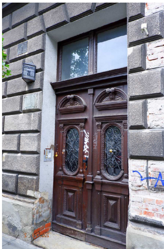
Fot. nr 218. Pełne eklektycznego uroku drzwi kamienicy pod nr 5.
