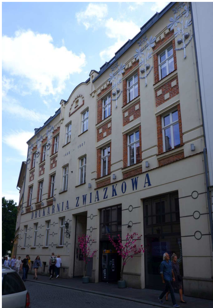
Fot. nr 44 (44-45). Budynek dawnej Drukarni Związkowej pod nr: 13-15. (09.07.2022)
