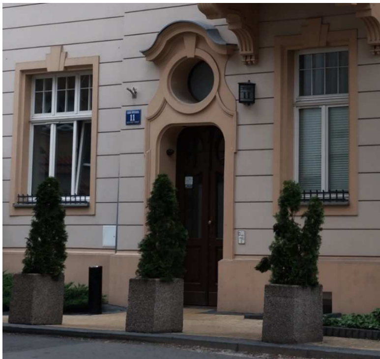
Fot. nr 259. Detale parteru secesyjnej kamienicy z ulicy Wygoda 11.
