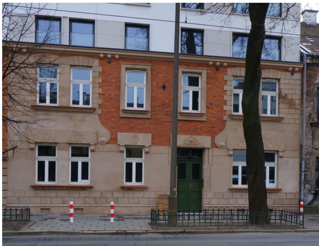
Fot. nr 274 (274-275). Zniszczony dom Pod Opatrznością spod nr 62. (29.03.2022)
