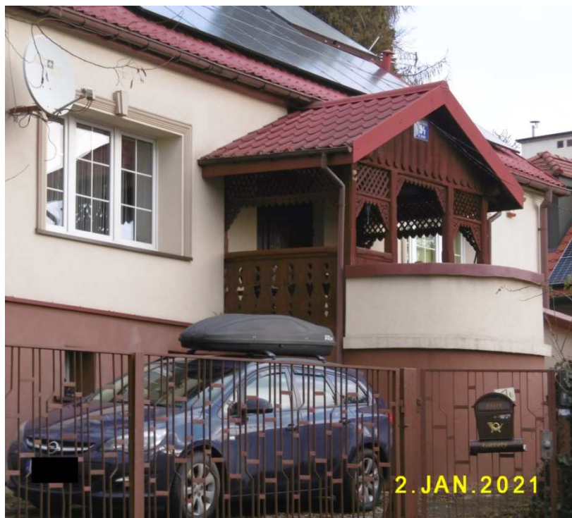
Fot. nr 313. Oryginalny, ażurowy ganek domu przy ulicy Tetmajera 34.
