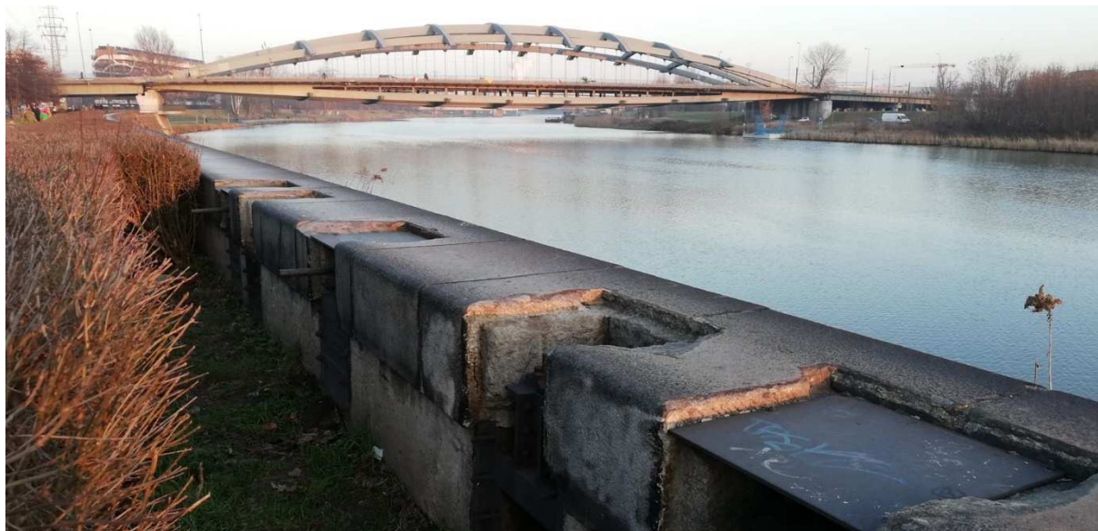
Fot. nr 387 (387-389). Wykonane w fabryce Zieleniewskiego, umykające uwadze urządzenie zamykające odpływ ścieków z dawnej krakowskiej rzeźni, dziś usytuowane w sąsiedztwie galerii Kazimierz. (fot. Łukasz Opalek) (25.01.2020)
