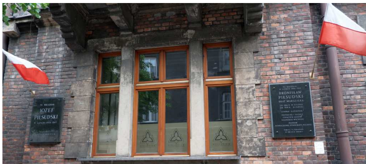
Fot. nr 344. Okno parteru. (19.05.2021)
