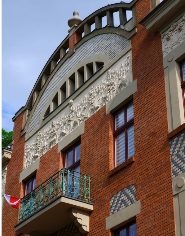
Fot. nr 99. Secesyjne zdobnictwo w zwieńczeniu kamienicy przy ulicy Reformackiej 3. (12.05.2022)
