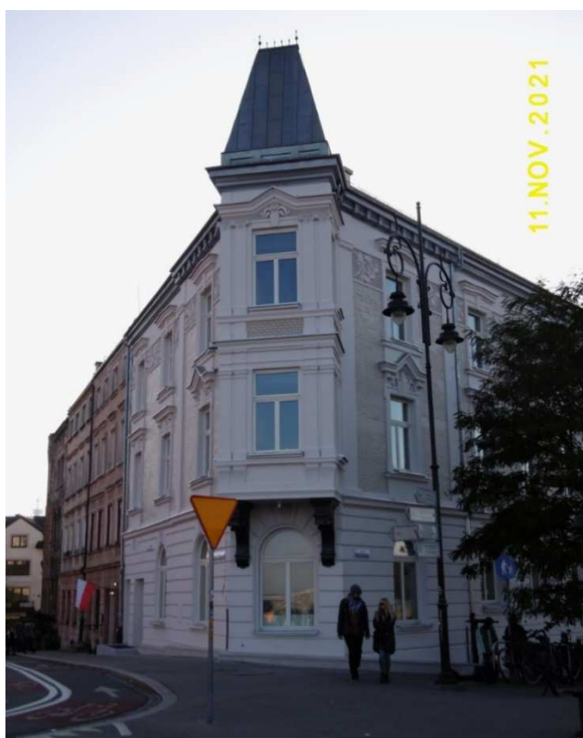
Fot. nr 448. Wykusz w narożu z ulicą Brodzińskiego.
