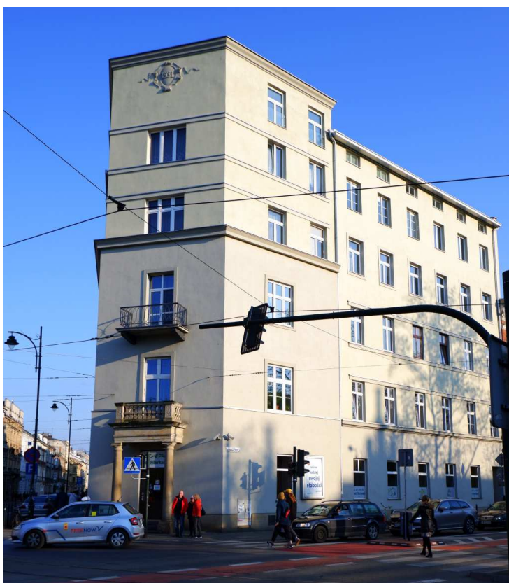
Fot. nr 442 (442-444). Nadbudowana w roku 1931 o dwa piętra narożna kamienica „pod filarkami” przy ulicy Dietla 87, która powstała w latach 1874-78. (23.04.2022)
