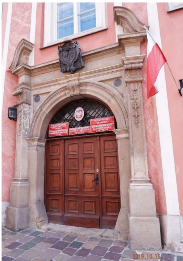
Fot. nr 134. Portal wejściowy.
