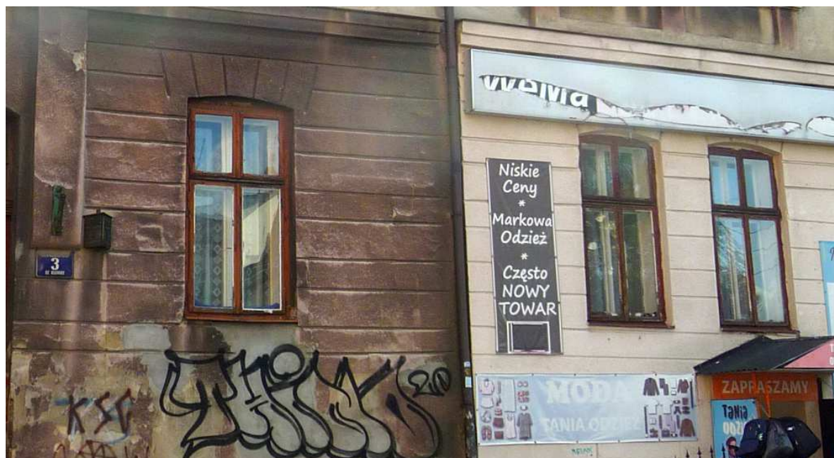
Fot. nr 324. Oryginalne, otwierane na zewnątrz, drewniane okna parteru kamieniczki z ulicy Pędzichów 3, (04.10.2023)
