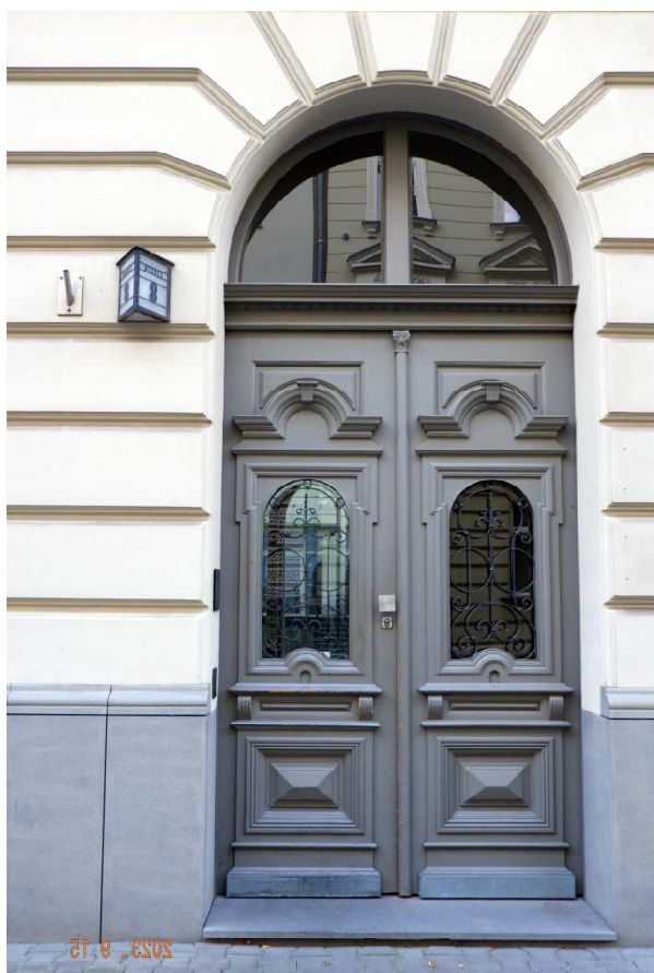
Fot. nr 184. Z dawnych detali kamienicy przy ulicy Czystej 8 przetrwały tylko drzwi wejściowe.
