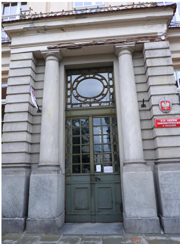
Fot. nr 229 (229-232). Detale budynku szkolnego przy ulicy Szlak 5. Główny portal wejściowy.
