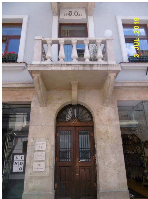
Fot. nr 96. Detale międzywojennej, wybudowanej w roku 1930, kamienicy spod nr 23.
