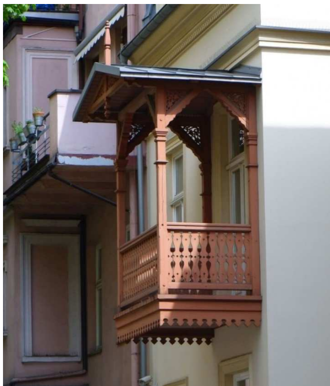
Fot. nr 372. Profilowany w drewnie ganek. (26.04.2023)
