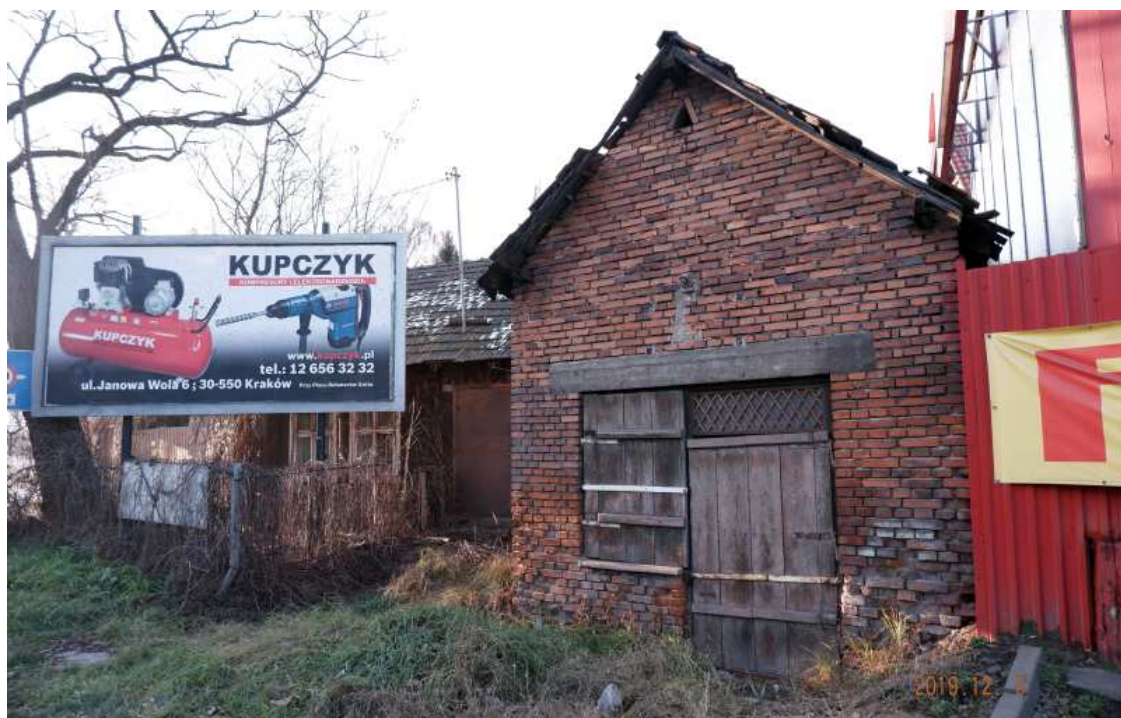
Fot. nr 395 (395-396). Zabudowania mieszkalno-gospodarczy przy ulicy Kocmyrzowskiej 1. Pomieszczenie po dawnym sklepiu mięsny.
