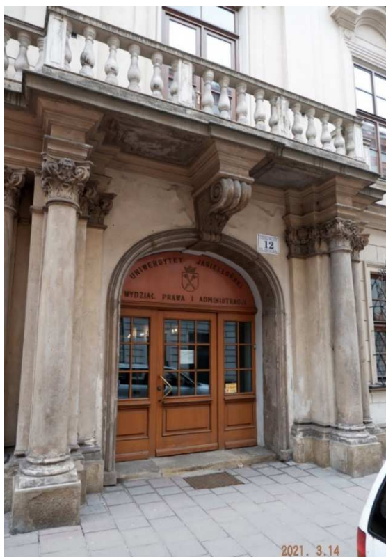
Fot. nr 118. Portal pałacu Larischa od strony ulicy Brackiej 12.
