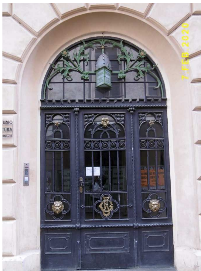
Fot. nr 82 (82-86). Wzdłuż ulicy św. Jana. Fot. nr 82. Secesyjna brama kamienicy Goetza z ulicy św. Jana 3.
