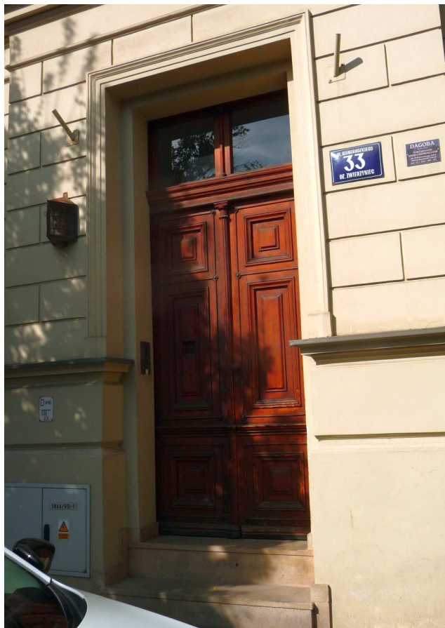
Fot. nr 245 (245-246). Detale kamienicy pod nr 33. Drzwi wejściowe. (04.10.2023)
