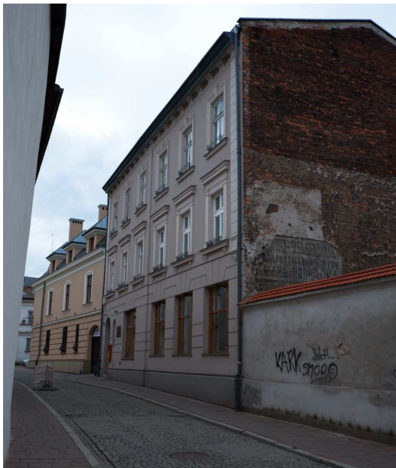
Fot. nr: 121-127. Wzdłuż ulicy Poselskiej. Fot. nr 121 (121-123). Kamienica pod nr 26 i jej naścienny detal. (25.04.2021)
