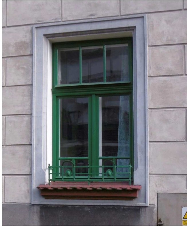
Fot. nr 411. Oryginalne okno na poziomie I. piętra. (06.04.2022)
