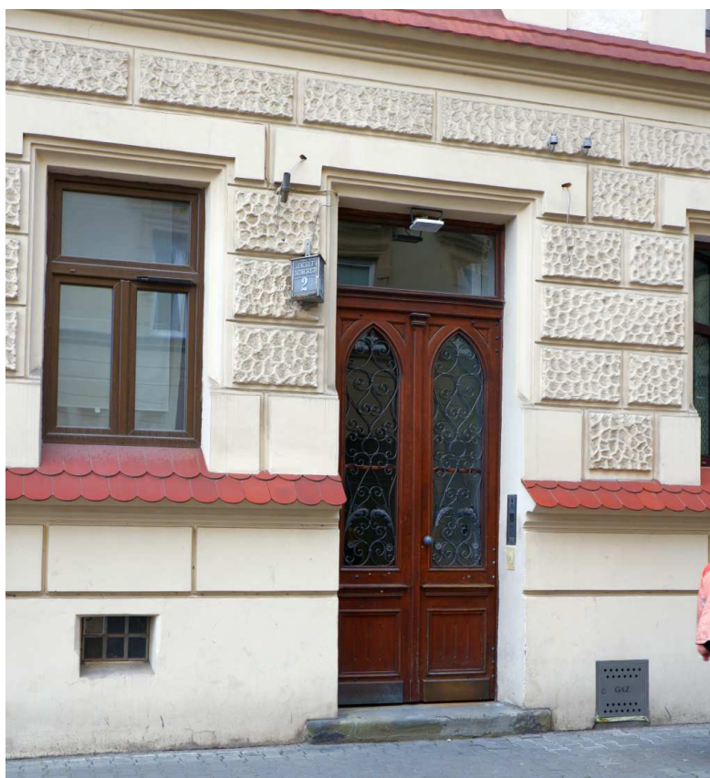
Fot. nr 356. Neogotyckie drzwi kamienicy przy ulicy Dwernickiego 2. (17.06.2022)
