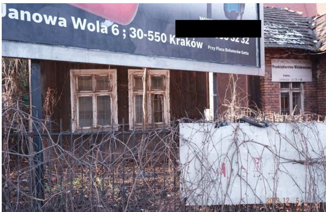
Fot. nr 396. Opustoszały już budynek mieszkalny z oknami typu skrzynkowego.
