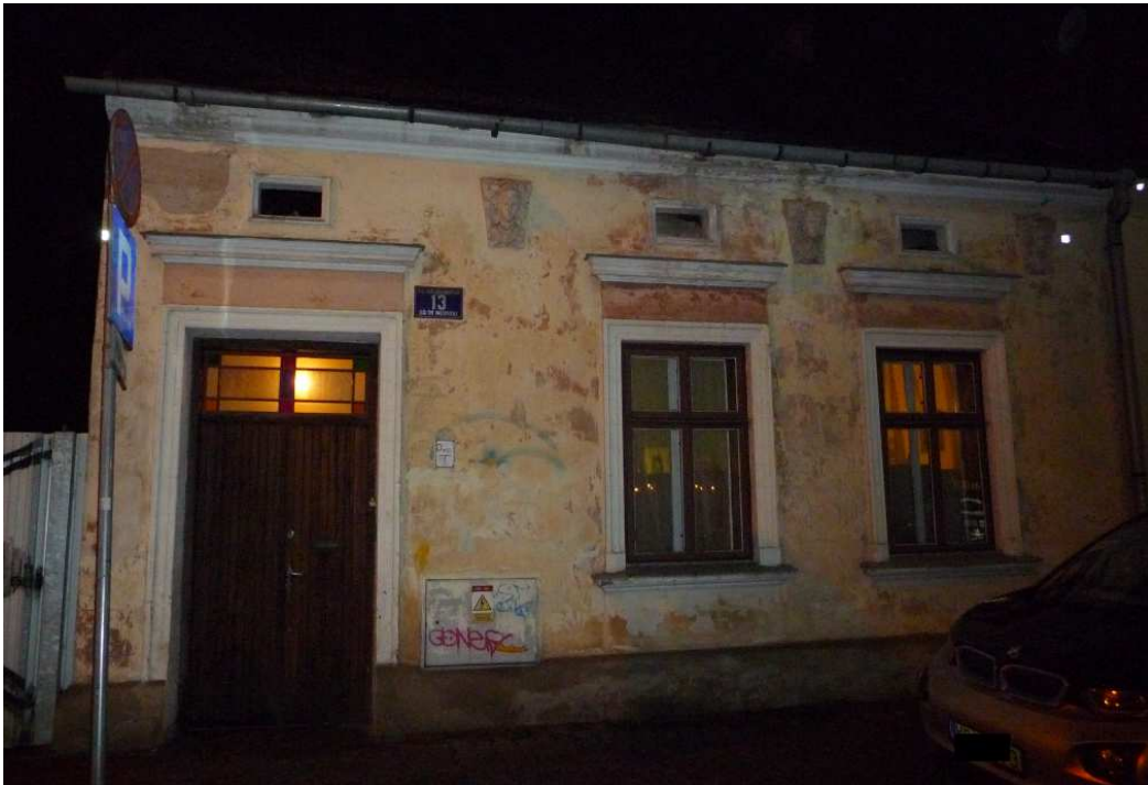
Fot. nr 399 (399-400). Fasada domu z ulicy Kilińskiego 13, wybudowanego w roku 1912 i jego detale. (05.01.2023)
