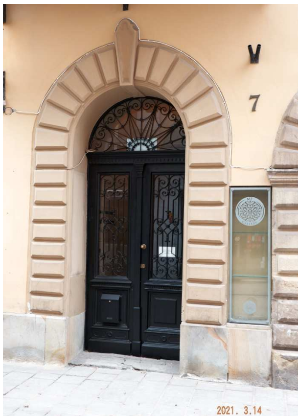
Fot. nr 116 (116-117). Renesansowe portale kamienicy przy ulicy Brackiej 7.
