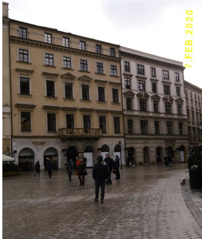
Fot. nr 10. Kamienice pod nr: 12 i 13 po tzw. „rewitalizacji”.
