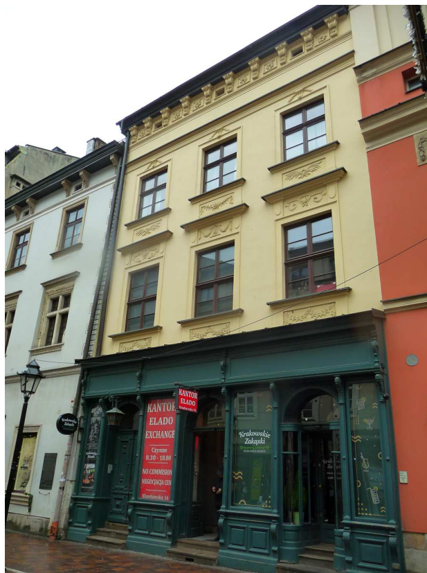
Fot. nr 95. Ciekawy parter kamienicy pod nr 16.
