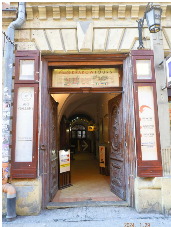
Fot. nr 76. Detale sieni kamienicy spod nr 22.
