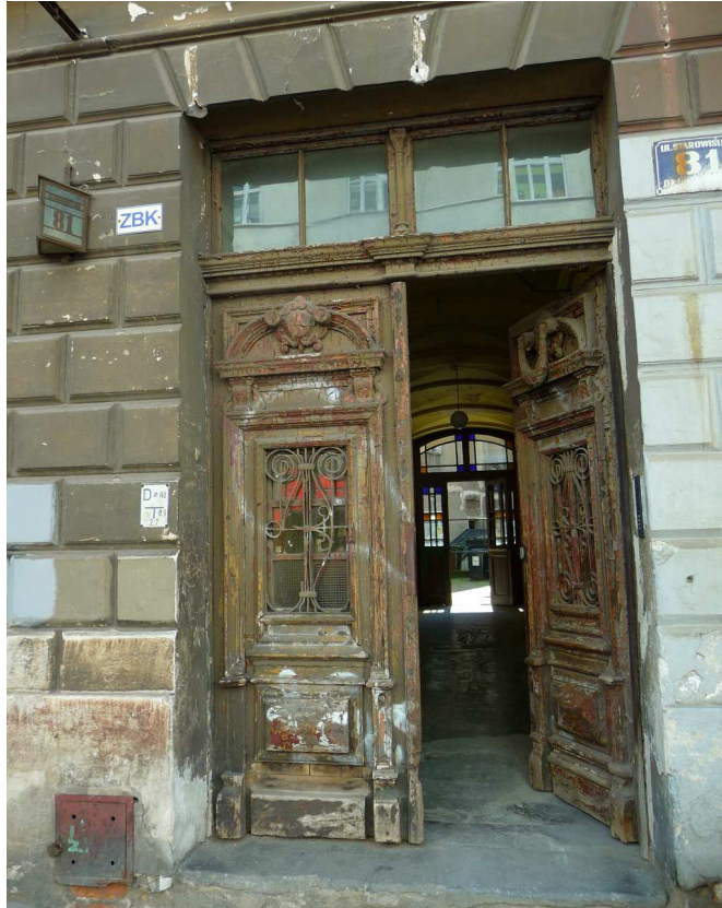
Fot. nr 437 (437-439). Detale kamienicy nr 81. Drzwi wejściowe. (18.07.2023)
