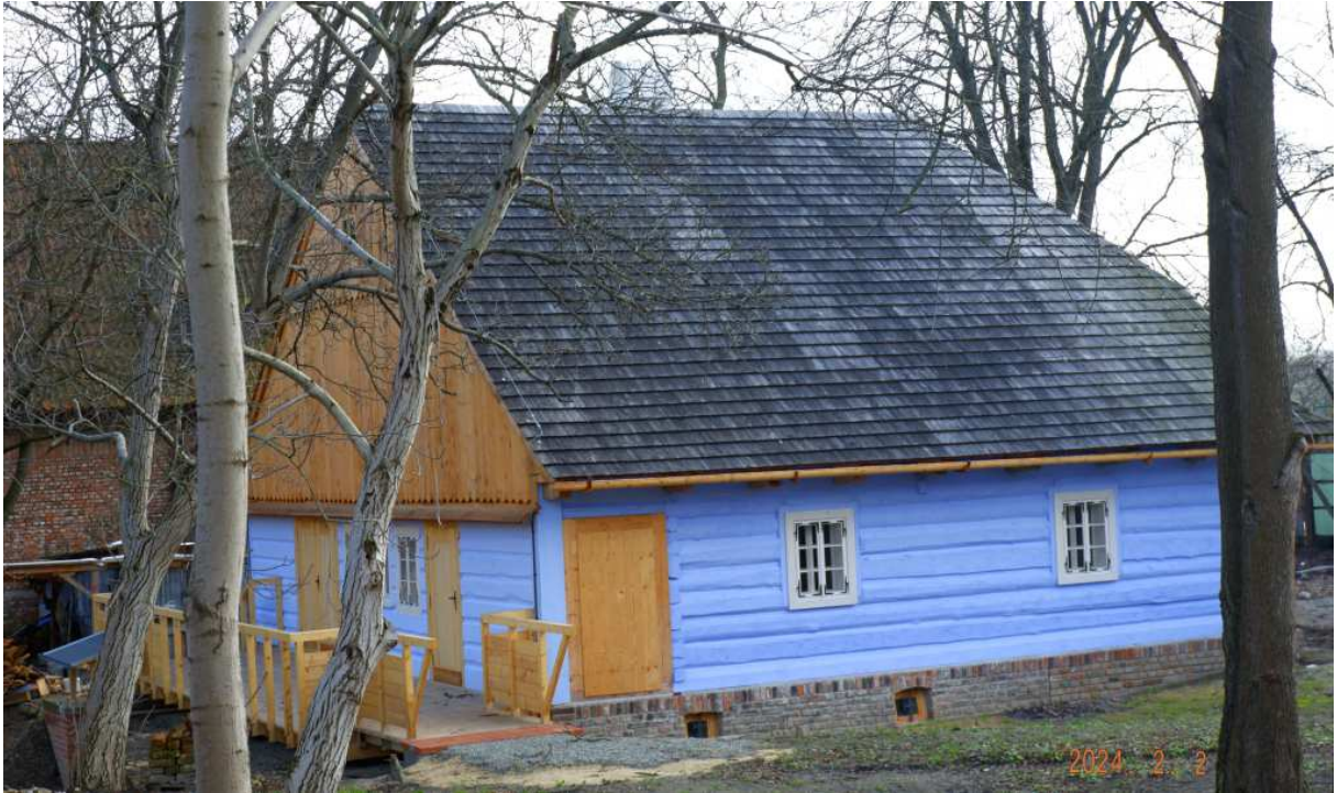
Fot. nr 529 (529-530). Detale chałupy Tomasz Pędrackiego, młynarza, z ulicy Klasztornej 11A, wybudowanej w roku 1870, która została przykładowo zrewitalizowana
