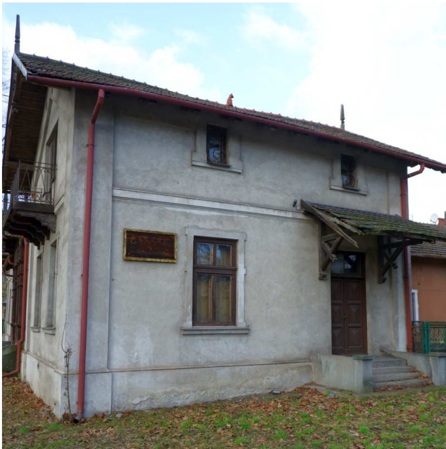
Fot. nr 524. Ściana szczytowa od strony ulicy
