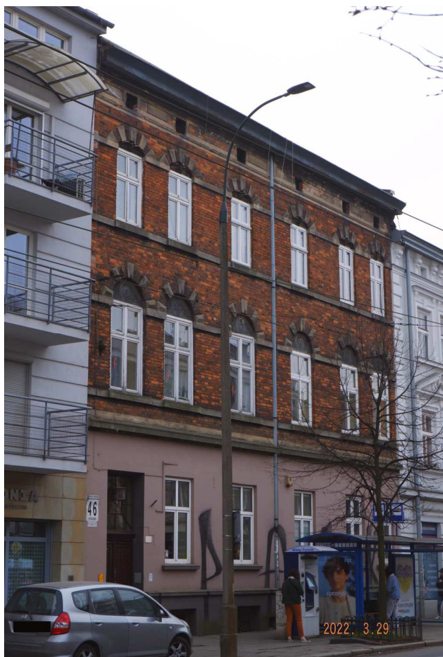
Fot. nr 268 (268-269). Kamienica spod nr 46.
