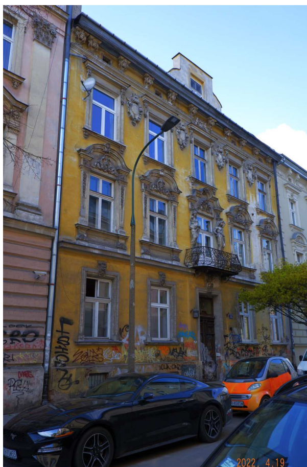
Fot. nr 200 (200-201). Bogato zdobiona, ale mocno zniszczona kamienica spod nr 13.
