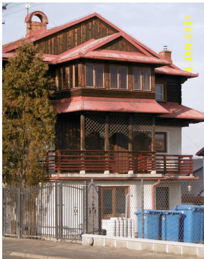
Fot. nr 516. Zapewne przedwojenna willa drewniana z ulicy Rżackiej 47 z loggią widokową w jej bocznej ścianie, nawiązująca do zabudowy kurortowej.
