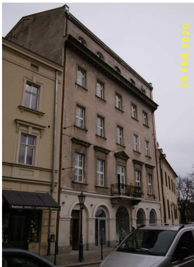
Fot. nr: 31-40. Ciąg dalszy ulicy Sieniej. Fot. nr 31 (31-32). Kamienica spod nr 14 na etapie remontu.
