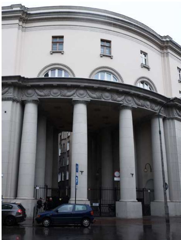
Fot. nr 361. Kolumnowe brama przy wejściu na podwórkę kamienica pracowników Banku PKO na styku ulic: Zybkiewicza 5 oraz Librowszczyzna 10. (16.05.2021)
