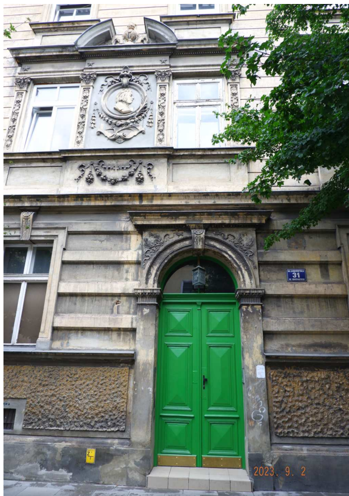
Fot. nr 225 (225-226). Detale fasady neorenesansowej kamienicy pod nr 31.
