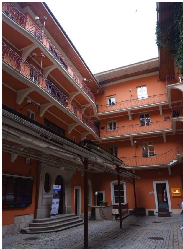
Fot. nr 19. Na dziedzińcu. (14.04.2023)
