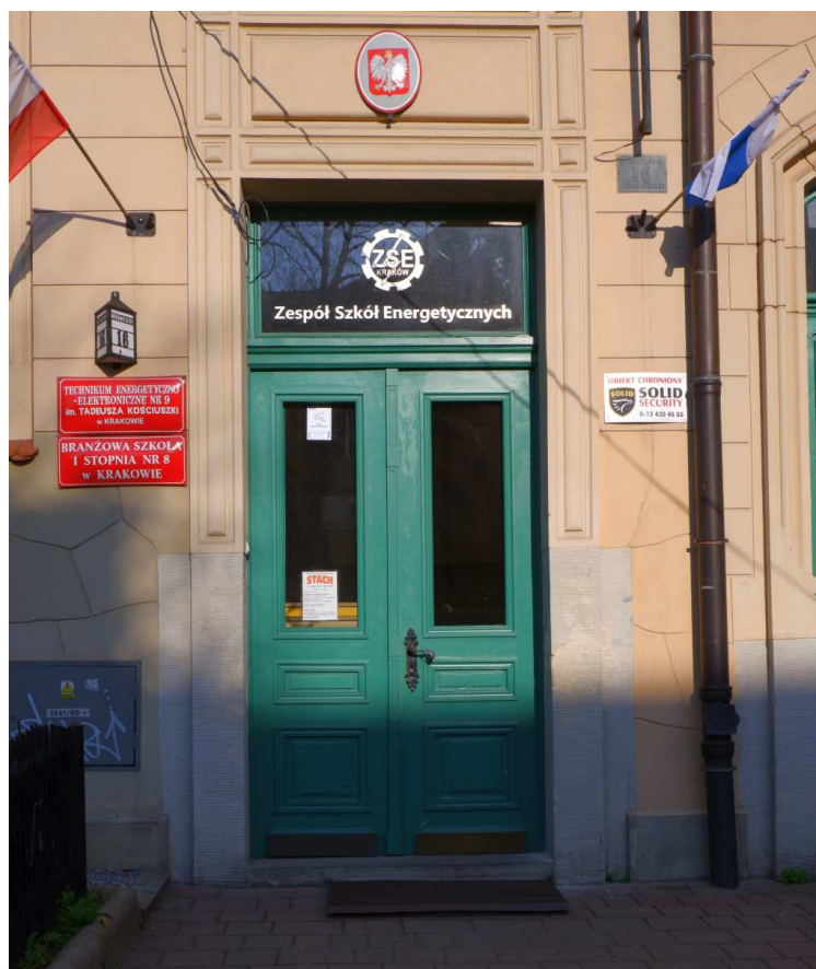
Fot. nr 256. Oryginalne drzwi. (23.04.2022)
