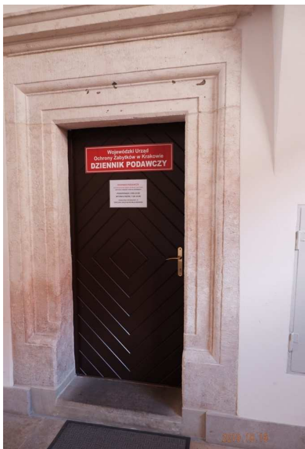
Fot. nr 135 (135-136). Portale w sieni.
