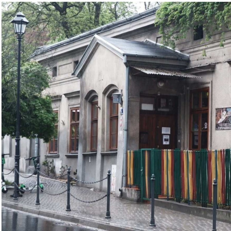
Fot. nr 355. Ganek w budynku dawnego szpitala przy ulicy Kopernika 16, działającego przy kościele św. Mikołaja może już na przełomie XVIII i XIX wieku. (16.05.2021)
