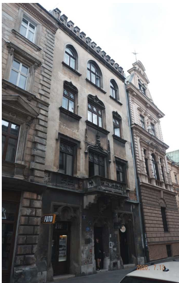
Fot. nr 68 (68-69). Niegotycka kamienica spod nr 17, wydowana na początku ostatniej dekady XIX wieku wg projektu Filipa Pokutyńskiego i jej detale.
