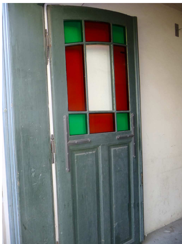
Fot. nr 186. Skrzydło mozaikowych drzwi wewnętrznych. (04.10.2023)
