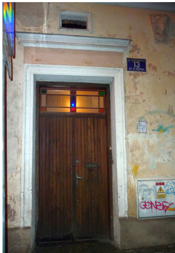
Fot. nr 400. Detale wokół drzwi. (05.01.2023)
