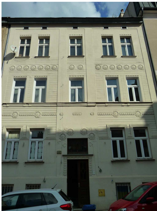
Fot. nr 450 (450-451). Odnowiony dom ze zdobnictwem secesyjnym z ulicy Stromej 4. Budynek powstał w roku 1912 wg projektu Aleksandra Sołtysa. (08.03.2023)
