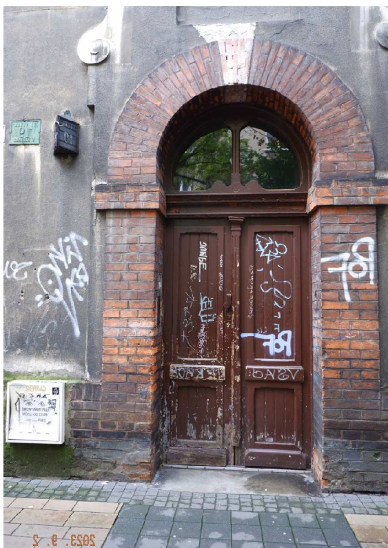
Fot. nr 340 (340-341). Neorenesansowe drzwi kamienicy pod nr 19 i jej detale.
