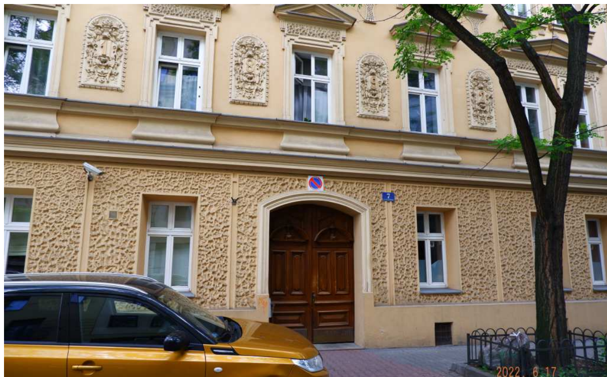
Fot. nr 357 (357-358). Detale czynszówki z ulicy Dwernickiego 7. Data powstania kamienicy (1892) pomiędzy oknami na wysokości I. piętra.
