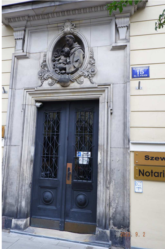
Fot. nr 221. Portal i drzwi kamienicy pod nr 15.
