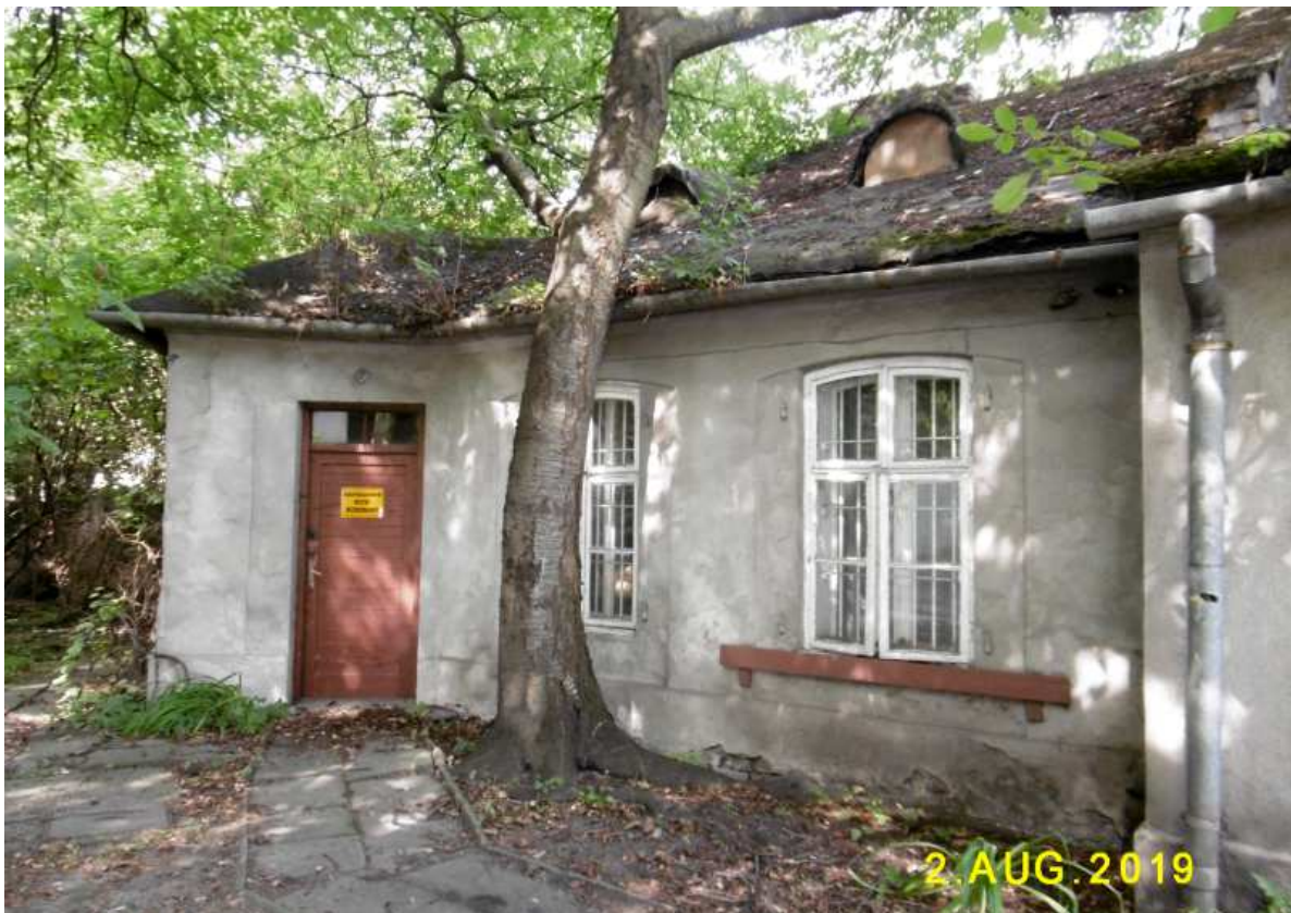
Fot. nr 169. Dawny, kiedyś rolniczy budynek na dziedzińcu pałacu Mioszewsckich, który raczej nie przetrwa. Na uwagę zasługują okna typu skrzynkowe, otwierane na zewnątrz.
