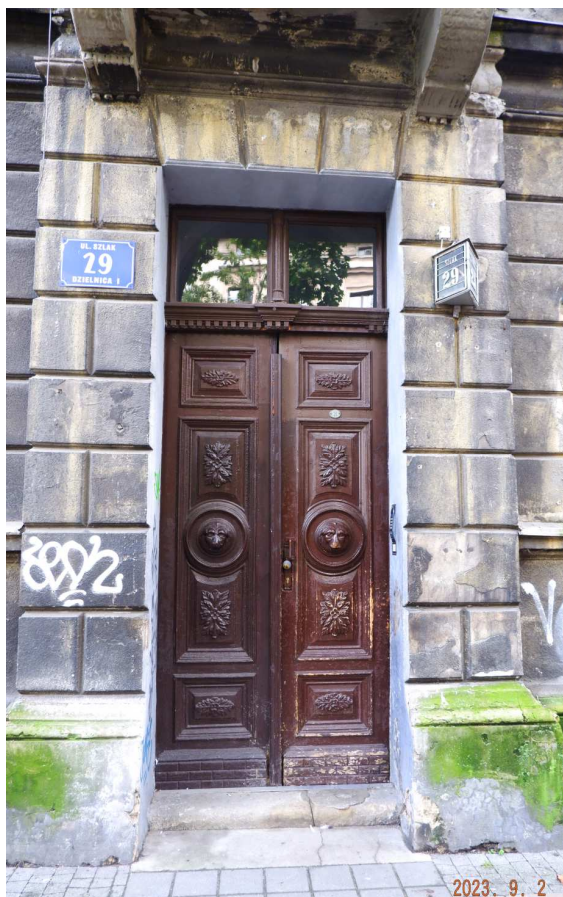
Fot. nr 339. Drzwi kamienicy pod nr 29.
