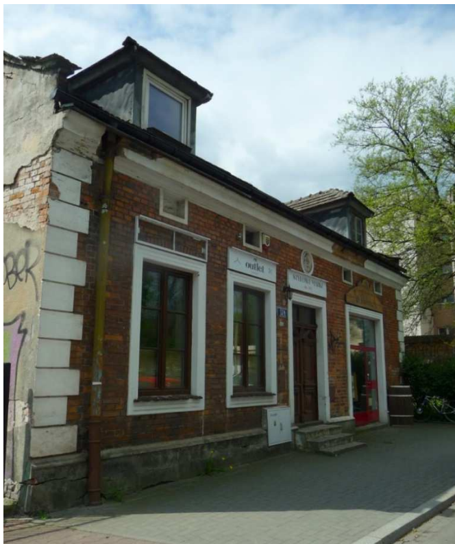
Fot. nr 307 (307-308). Fasada domu z ulicy Kazimierza Wielkiego 124 z nowymi oknami i oryginalnymi drzwiami. (27.04.2023)
