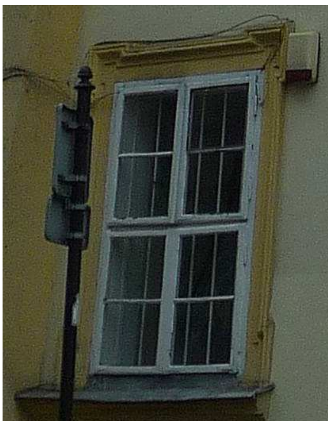
Fot. nr 49. Oryginalne okno, typowe dla klasycystycznej zabudowy Krakowa z połowy XIX. wieku. (21.03.2023)
