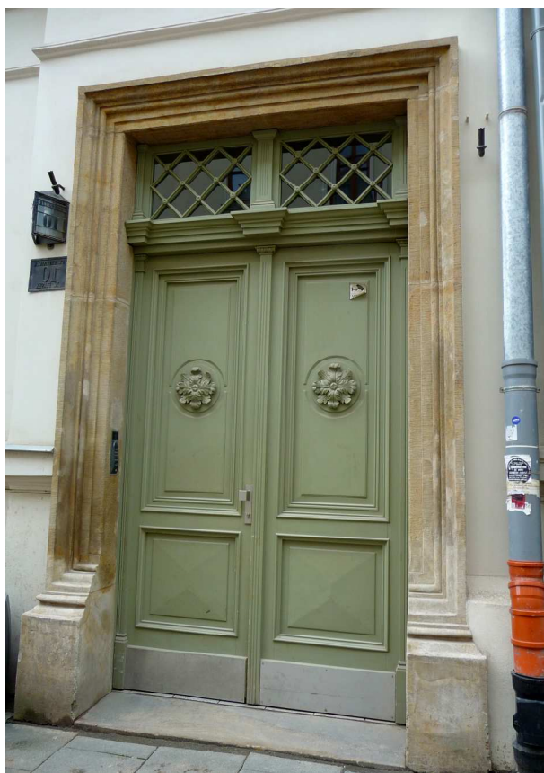
Fot. nr 167. Kompletne drzwi. (08.06.2022)
