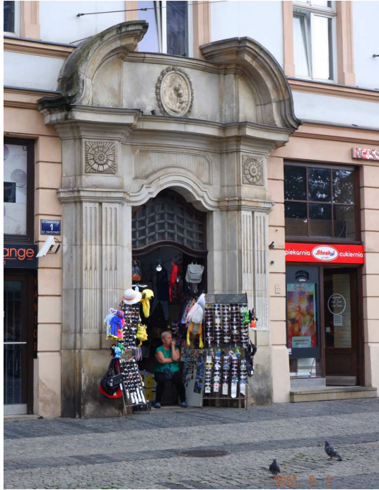
Fot. nr 160. Portal kamienicy Strenka pod nr 1.
