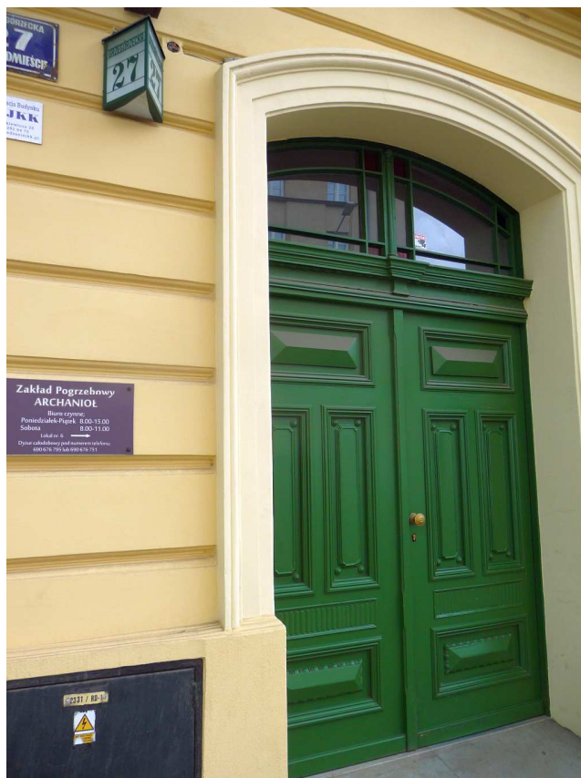
Fot. nr 377. Drzwi kamienicy pod nr 27. (27.06.2023)
