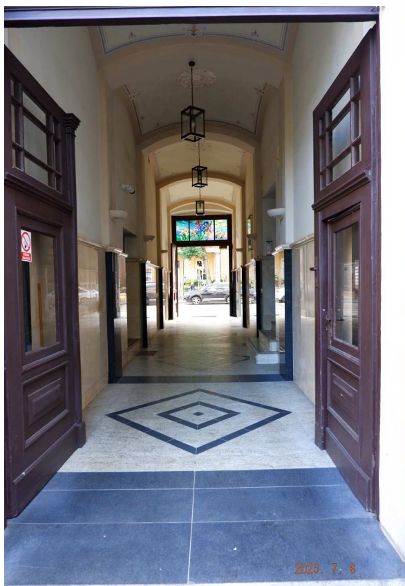
Fot. nr 145. Sień kamienicy pod nr 27.
