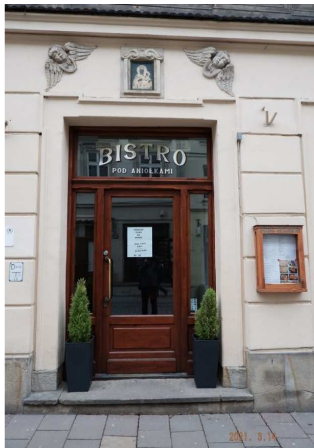
Fot. nr 105. Bar Bistro w kamienicy Pod Aniołkami spod nr 14, w miejscu dawnego Baru Smakosz.
