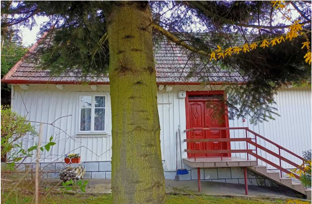
Fot. nr 522. Zapewne ponad 100-letnia chałupa, obita szalunkiem z desek, z ulicy Miarowej 4. Oryginalne detale: okienko typu ościeżnicowego i profilowane w drewnie drzwi. (16.03.2023)
