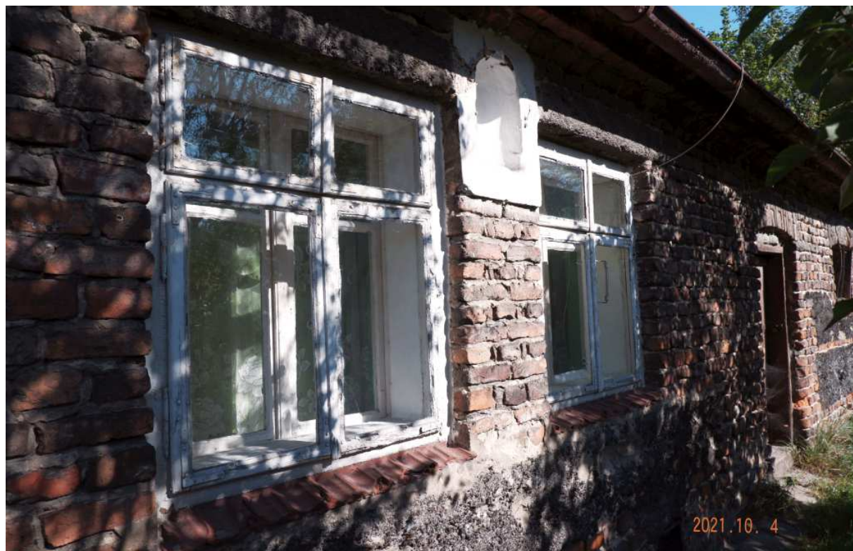
Fot. nr 311. Czteroskrzydłowe okna typu skrzynkowego.
