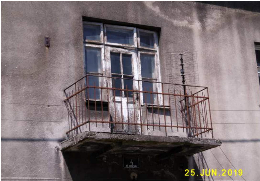
Fot. nr 316. Oryginalna stolarka drzwi i okna ganku I piętra.
