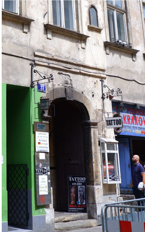
Fot. nr 106 (106-107). Kamienica pod nr 23 i jej detale. Portal. (09.07.2022)
