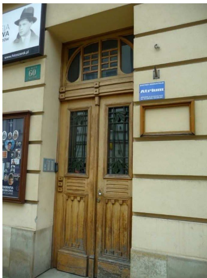
Fot. nr 342. Secesyjne drzwi kamienicy z ulicy Długiej 60. (25.05.2023)
