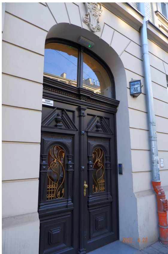
Fot. nr 441. Przykładnie odnowione drzwi kamienicy pod nr 41.
