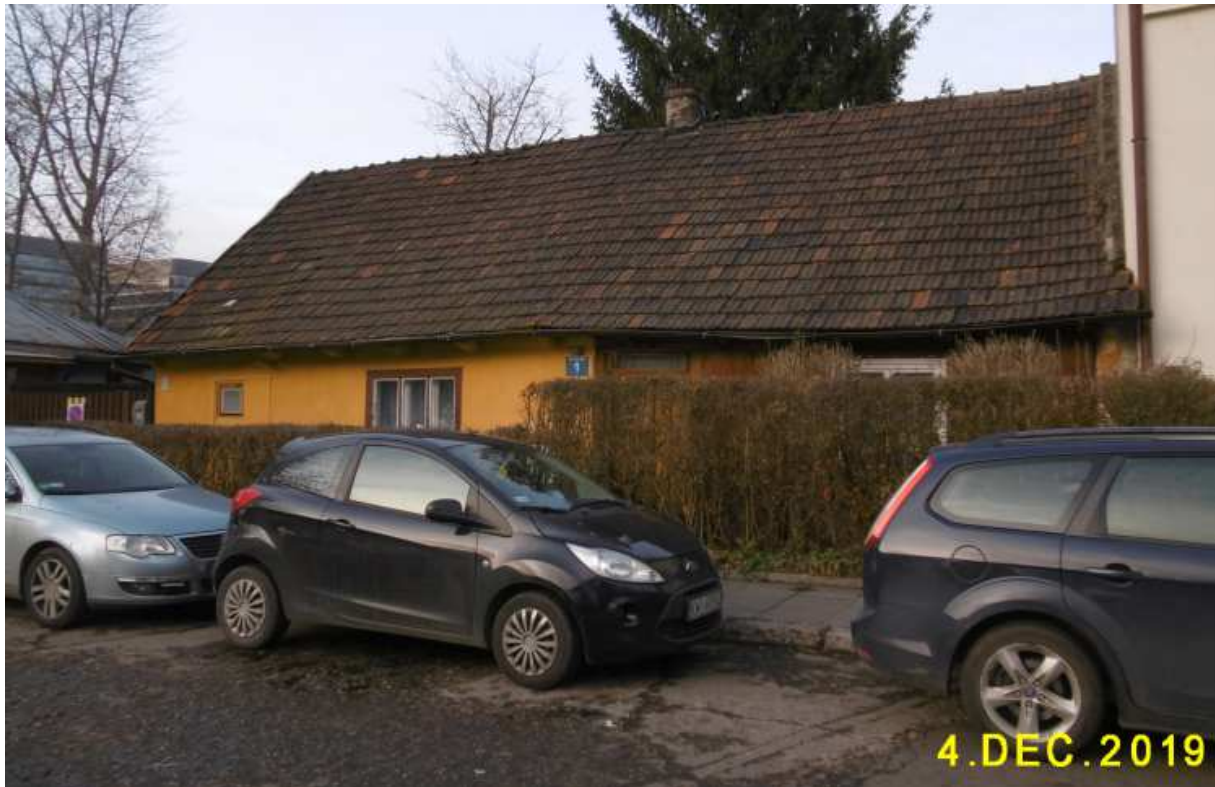
Fot. nr 393 (393-394). Ostatnia chałupa na terenie Dąbia przy ulicy Na Szaniec 1.
