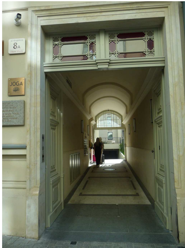
Fot. nr 164 (165-165). Detale sieni kamienicy z końca XIX wieku pod nr 8. (04.10.2023)
