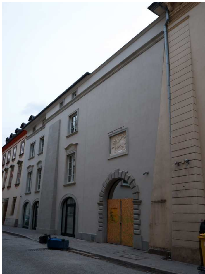
Fot. nr 57 (57-58). Zrekonstruowana kamienica przy ulicy św. Marka 13.
