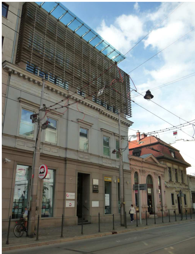
Fot. nr 42 (42-43). Wzdłuż ul. Karmelickiej. Fragment zabudowy o nr: 66-68. (04.10.2023)
