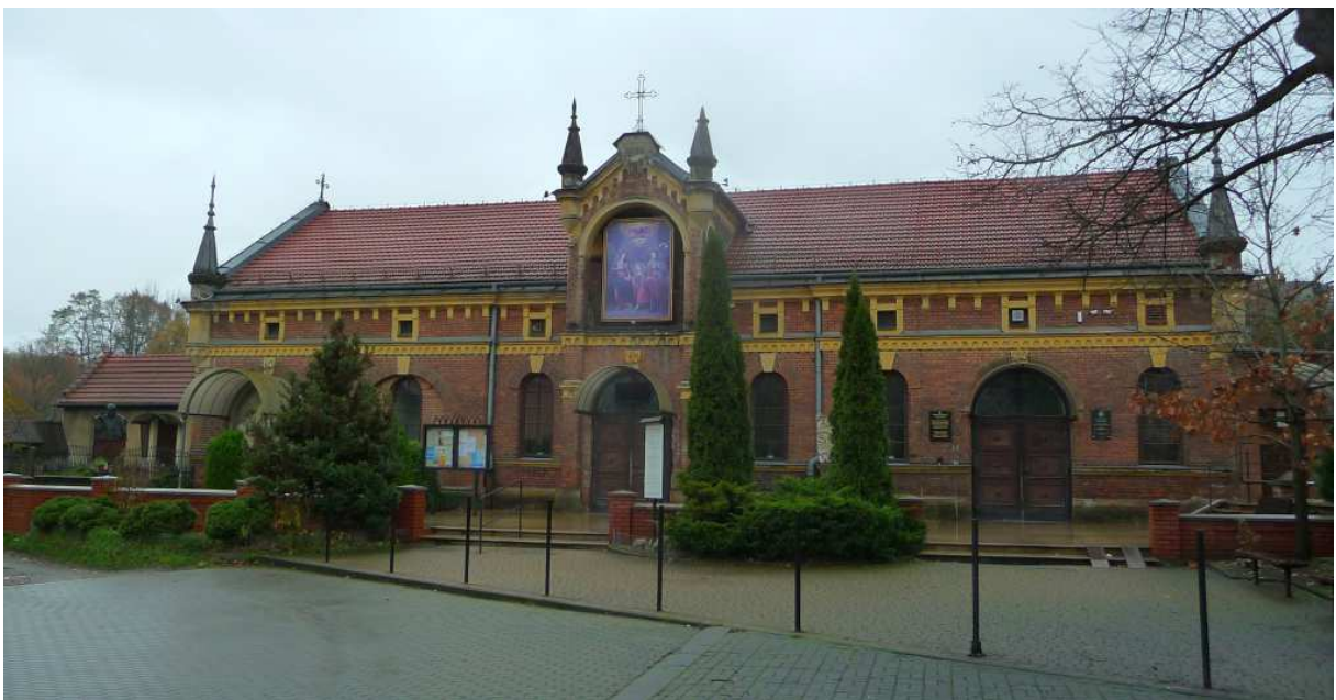
Fot. nr 264. Kaplica Augustianów, przerobiona w roku 1911 z dawnej wozowni Jerzmanowskich. (20.11.2023)
