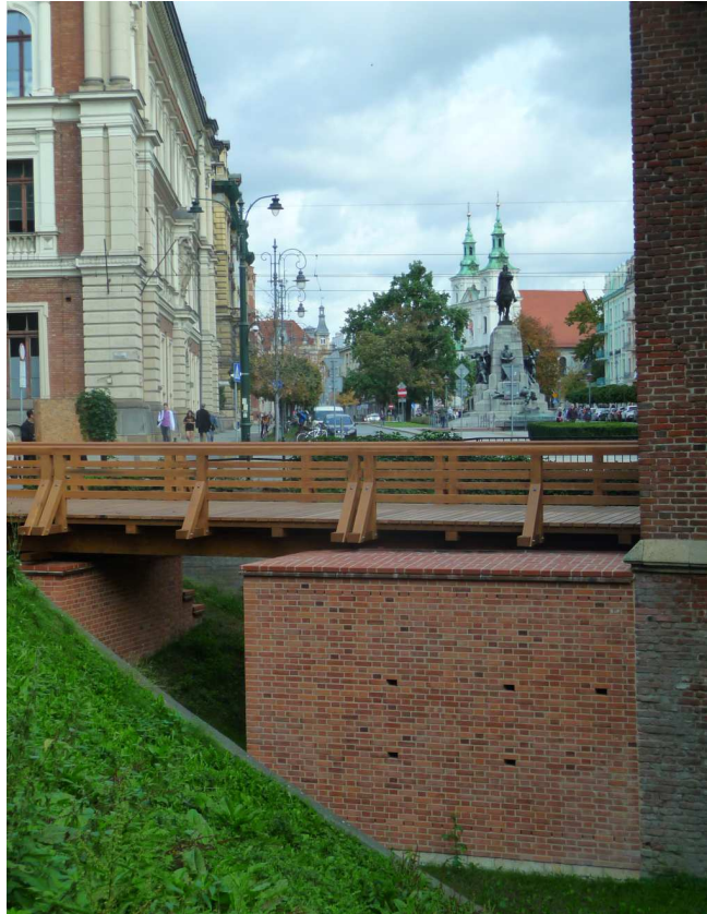
Fot. nr 5 (5-6). Rekonstrukcja kładki wiodącej ku centrum Krakowa od strony Kleparza. (04.10.2023)
