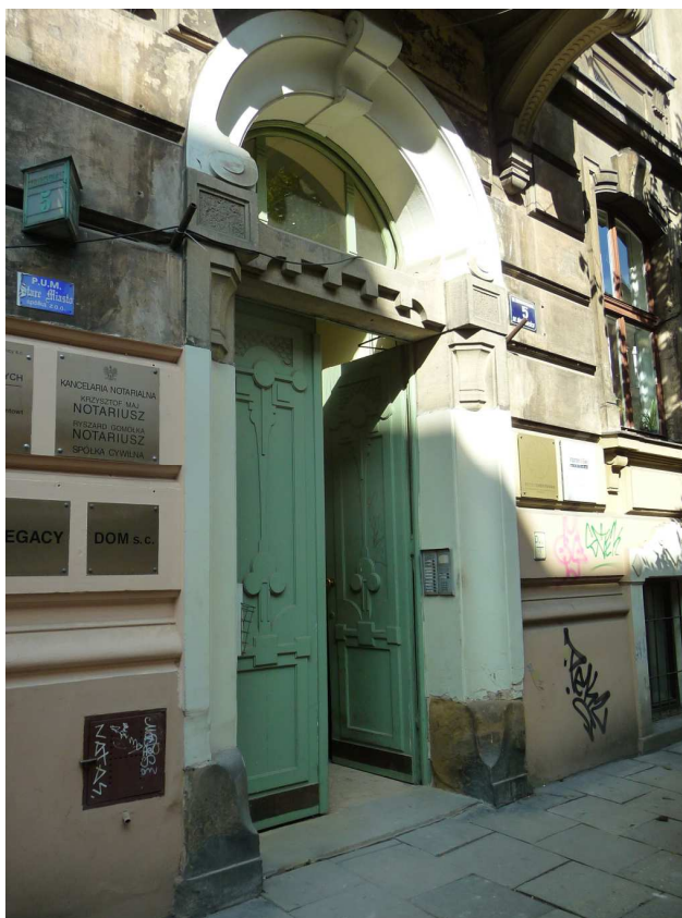
Fot. nr 44 (44-45). Detale kamienicy z ulicy Grabowskiego 5. (04.10.2023)
