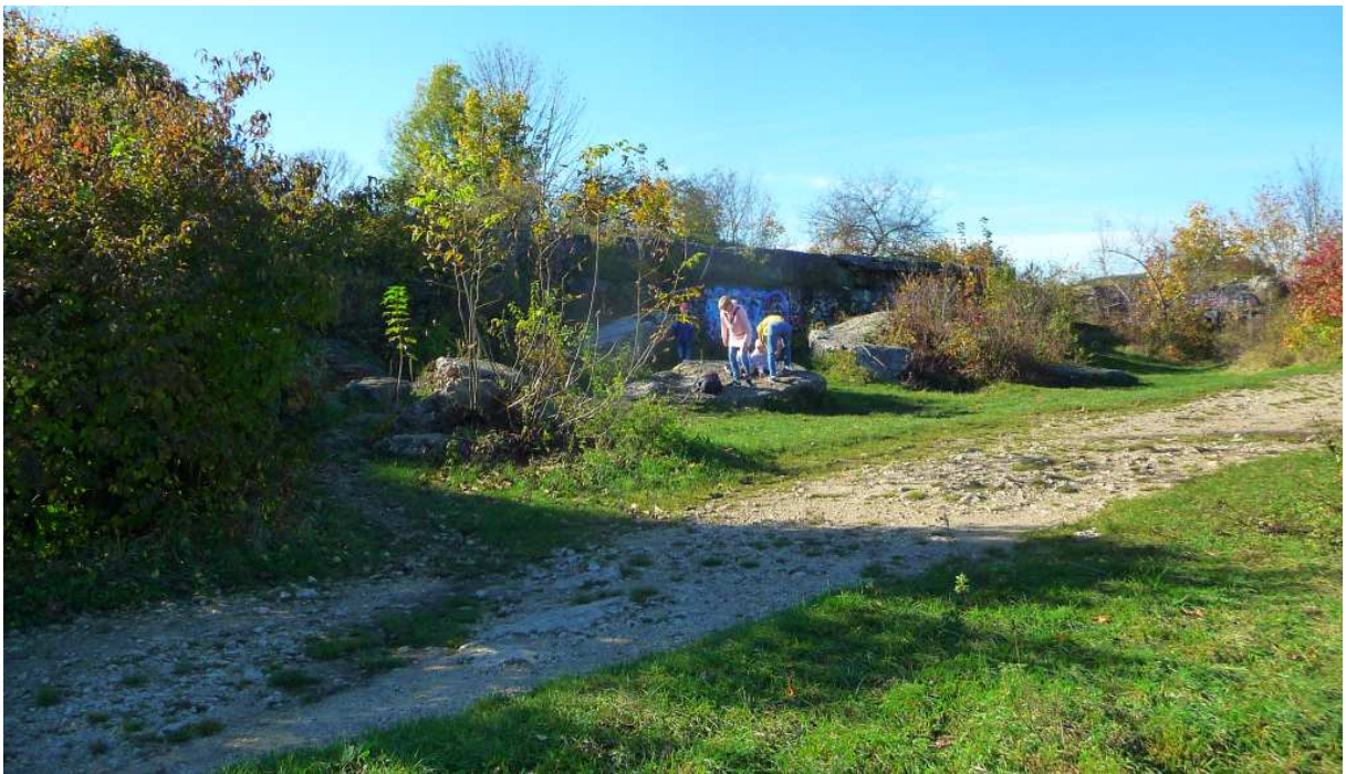
Fot. nr 203 (203-209). Wokół ruin międzypolowego fortu artyleryjskiego nr 53 Bodzów. (02.11.2023)
