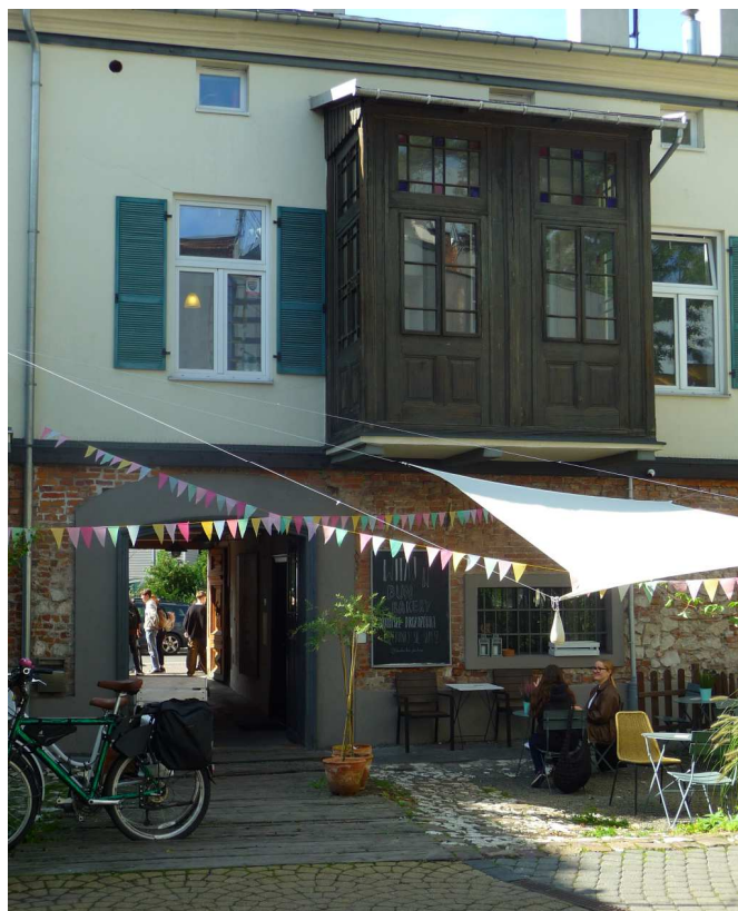
Fot. nr 61. Weranda od strony podwórka. (04.10.2023)
