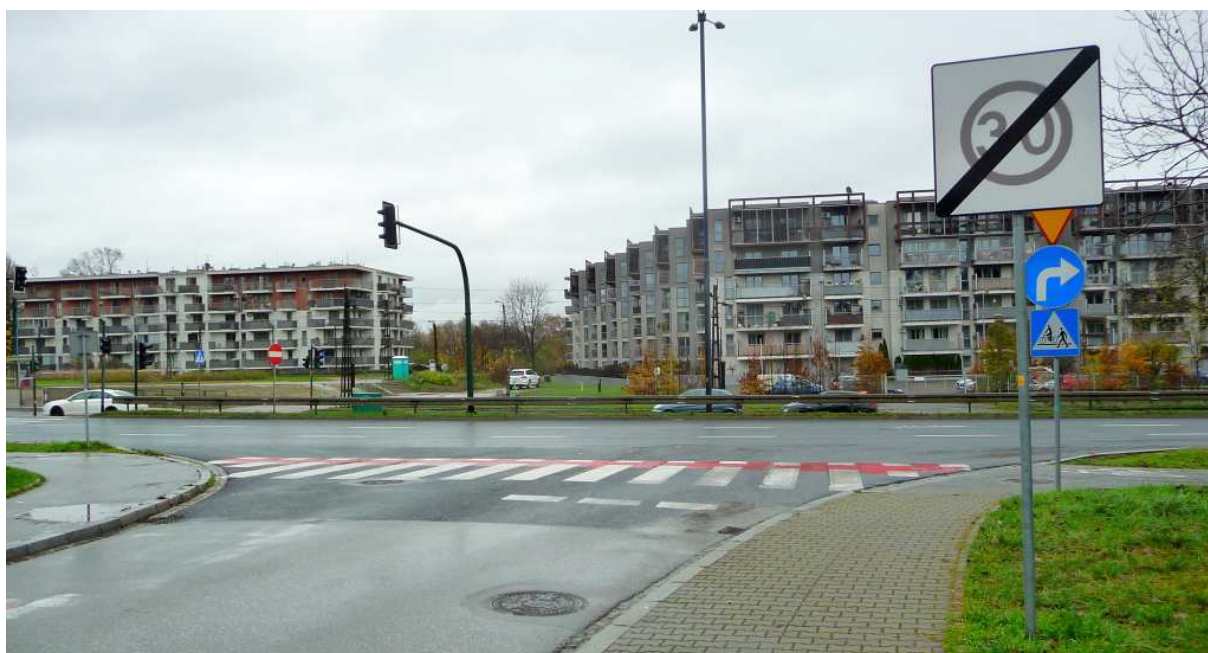
Fot. nr 251 (251-252). Krakowski „alcatraz” przy ulicy Górników 50-66. Widok z ulicy Wielickiej. (20.11.2023)
