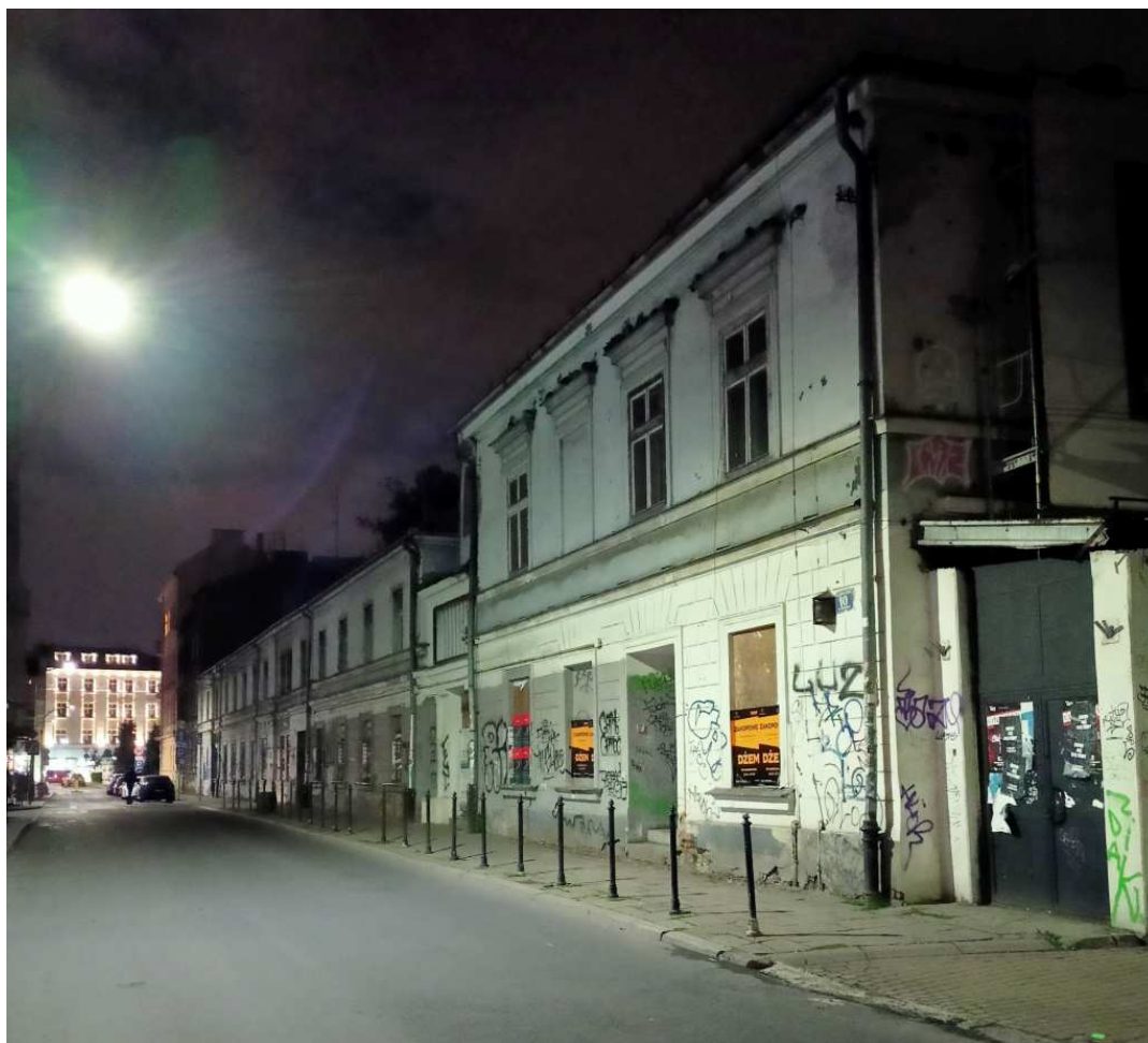
Fot. nr 64 (64-66). Kompleks dawnych budynków KZT pod nr: 10-12. (10.10.2023)
