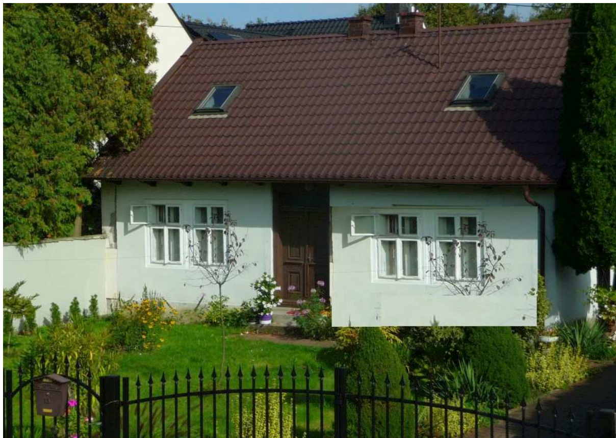
Fot. nr 98. Próba rekonstrukcji fasady. (02.10.2023)
