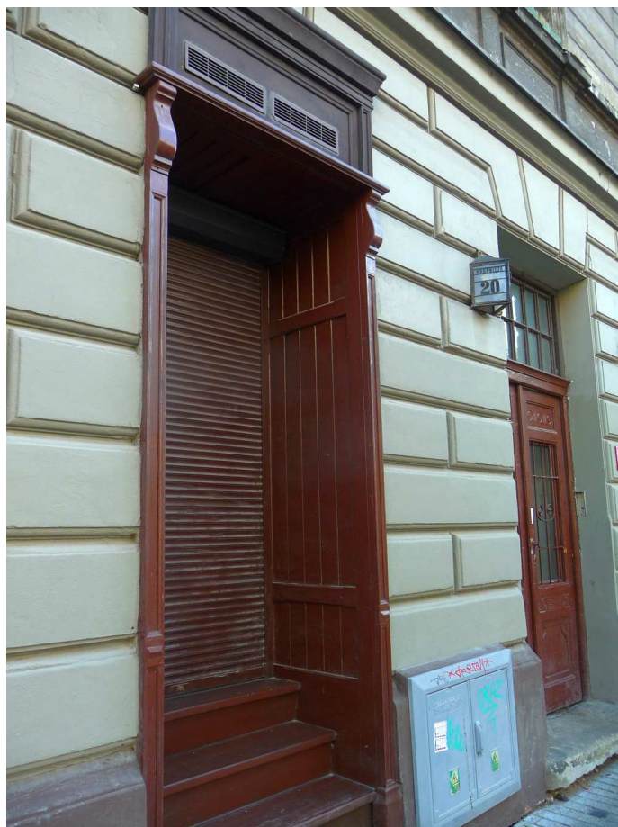
Fot. nr 58. Wejście do dawnego zakładu ślusarskiego Brzezickiego pod nr 20. (04.10.2023)
