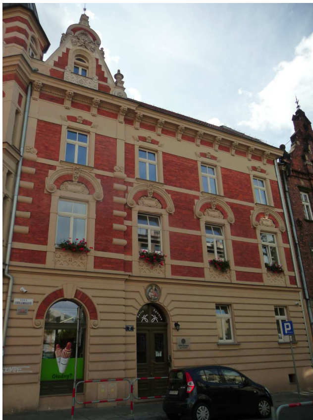
Fot. nr 36 (36-41). Wzdłuż ulicy Siemiradzkiego. Eklektyczna kamienica z końca XIX. wieku pod nr 2, wczesne dzieło Jana Zawiejskiego. (04.10.2023)
