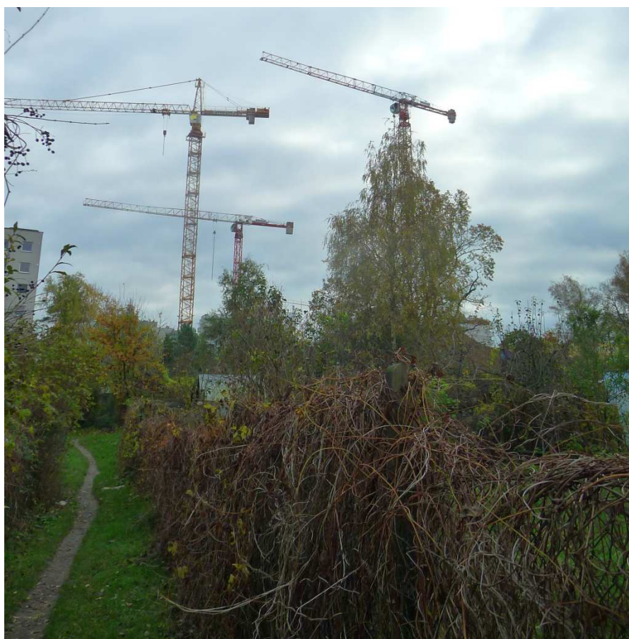
Fot. nr 292. Nowo powstające blokowisko na styku ulic: Podedworze i Bochenka. (12.11.2023)
