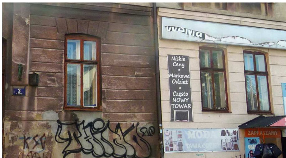
Fot. nr 23. Originalne okna parteru, otwierane na zewnątrz. (04.10.2023)
