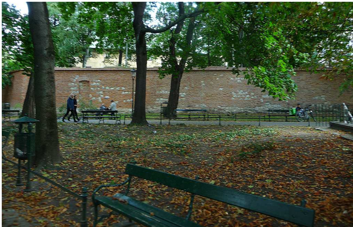
Fot. nr 15. Mur przy zespole klasztornym Reformatów. (04.10.2023)
