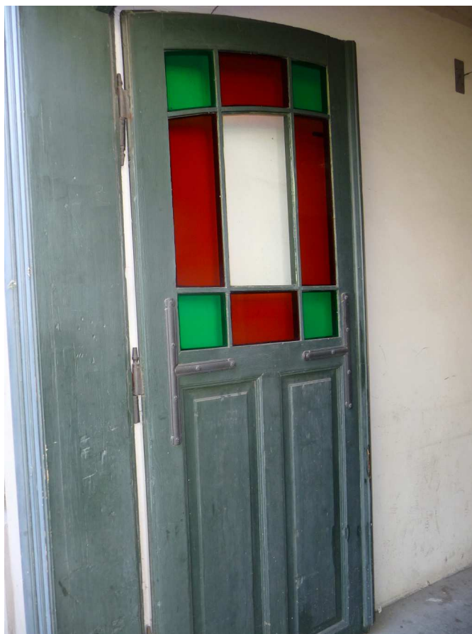
Fot. nr 60 (59-61). Detale domu pod nr 3. Skrzydło drzwi wewnętrznych. (04.10.2023)
