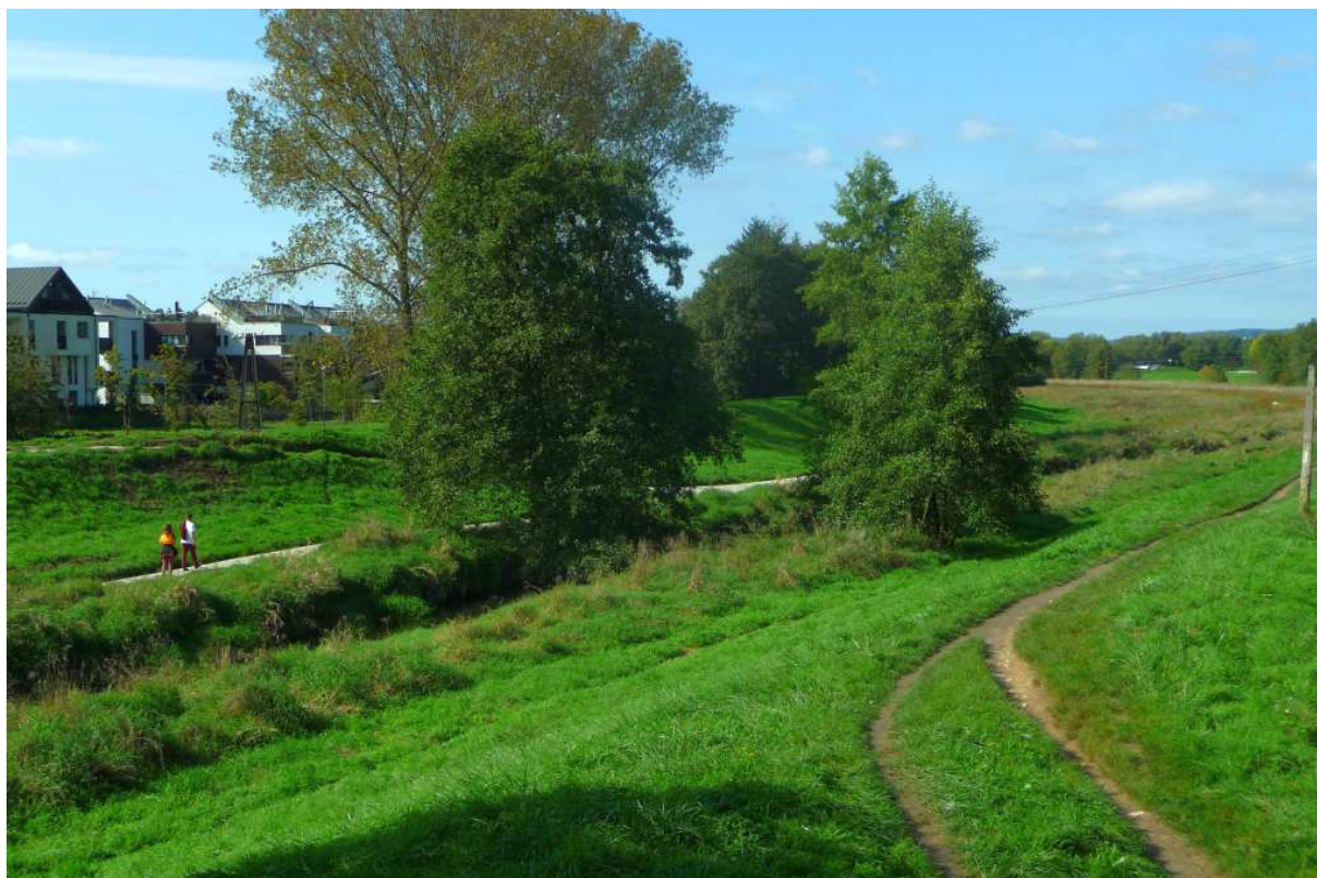
Fot. nr 100. Wały Rudawy poniżej mostu przy ulicy Na Błonie. (02.10.2023)
