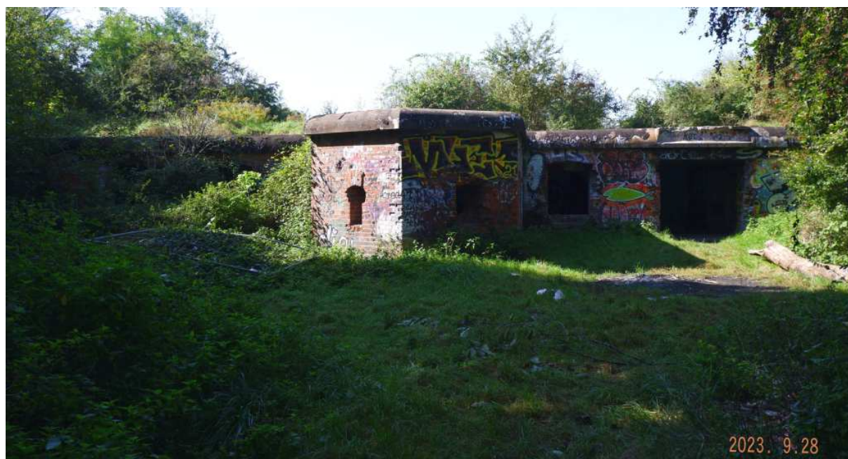
Fot. nr 119 (119-120). Międzypolowy fort piechoty nr 41a, zbudowany w latach 1895-96.
