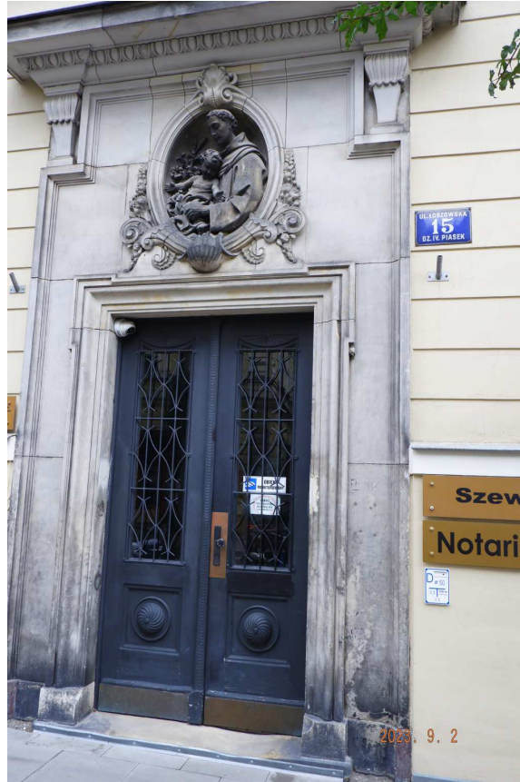
Fot. nr 195. Portal i drzwi kamienicy pod nr 15
