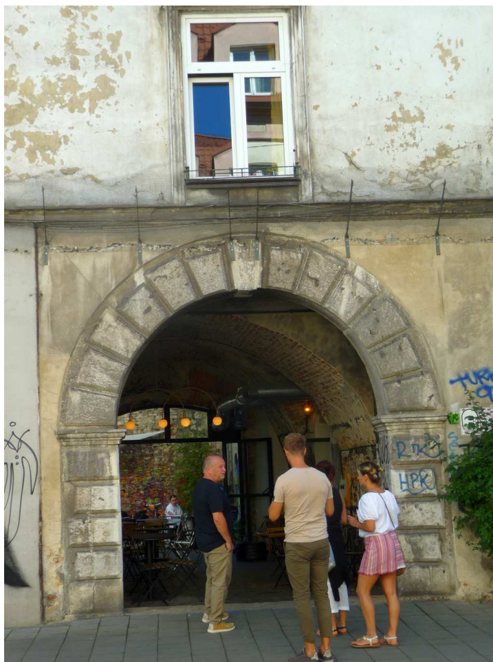
Fot. nr 235. Boniowany portal domu pod nr 11. (20.09.2023)
