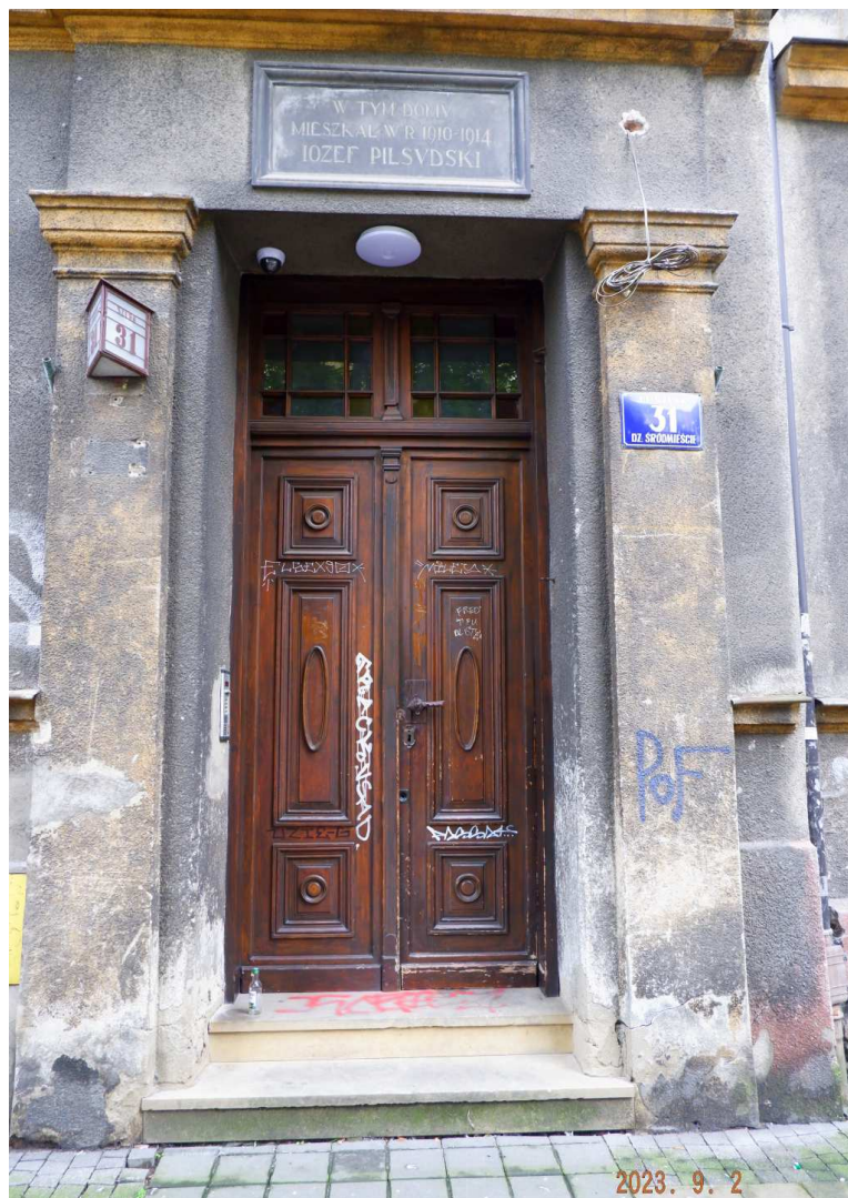
Fot. nr 299 (299-300). Detale kamienicy pod nr 31.
