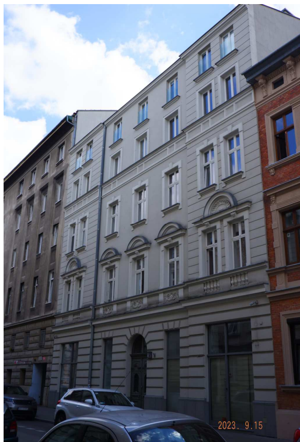
Fot. nr 162 (162-163). Paskudnie nadbudowana o dwa piętra kamienica pod nr 8.
