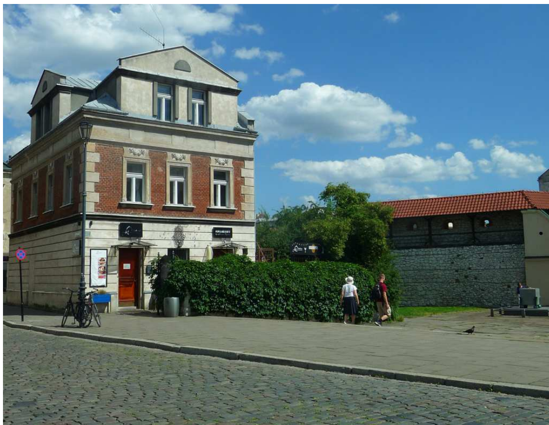
Fot. nr 249 (249-250). Dom pod nr 22 w sąsiedztwie wyburzonej po wojnie bożnicy Na Górcie. (18.07.2023)
