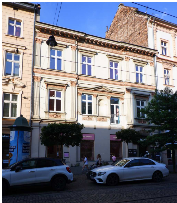
Fot. nr 134. Kamienica pod nr 3, ciągle bez balkonu na wysokości I. piętra.
