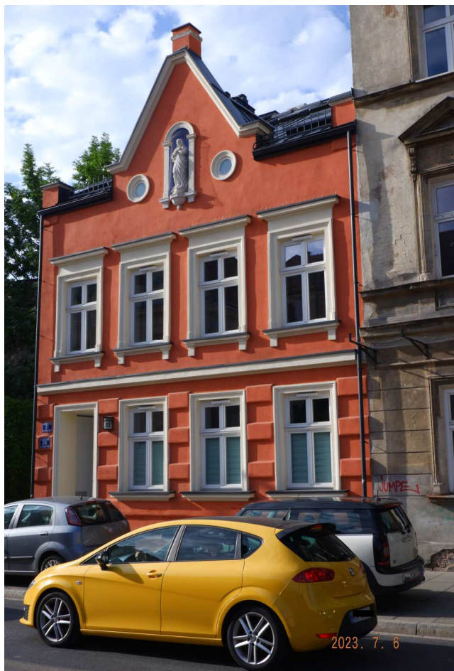
Fot. nr 102. Przykładnie odnowiona fasada kamieniczki pod nr 21.
