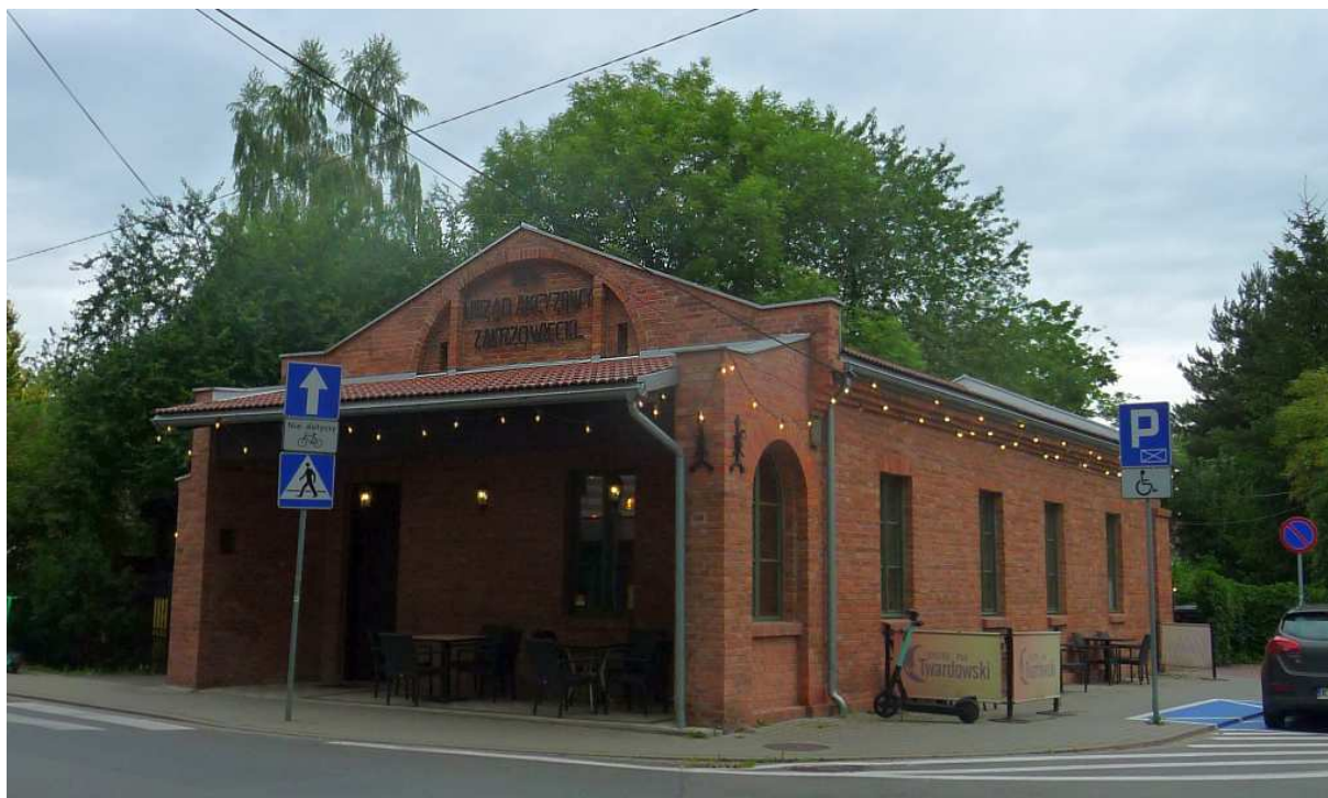
Fot. nr 389 (389-391). Uratowany przed wyburzeniem budynek Zakrzowieckiego Urzędu Akcyzowego pod 43. (01.08.2023)
