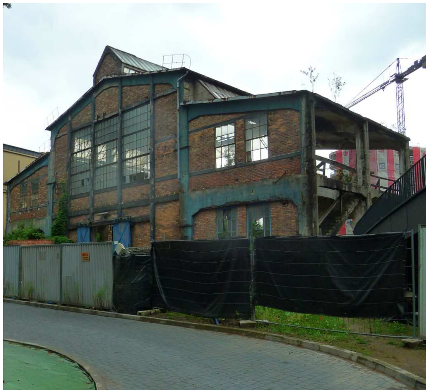
Fot. nr 317 (317-319). Pozostałości po dawnej hali fabrycznej. (27.06.2023)
