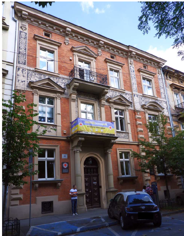
Fot. nr 176 (176-180). Wzdłuż ulicy Studenckiej. Zdobiona dekoracją sgraffitową fasada kamienicy własnej Sławomira Odrzywolskiego pod 19. (15.09.2023)
