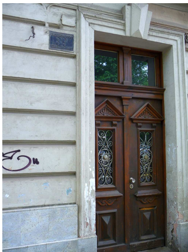
Fot. nr 328. Drzwi kamienicy pod nr 39. (27.06.2023)
