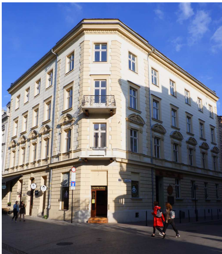
Fot. nr 143. Wyremontowana, narożna kamienica pod nr 12.
