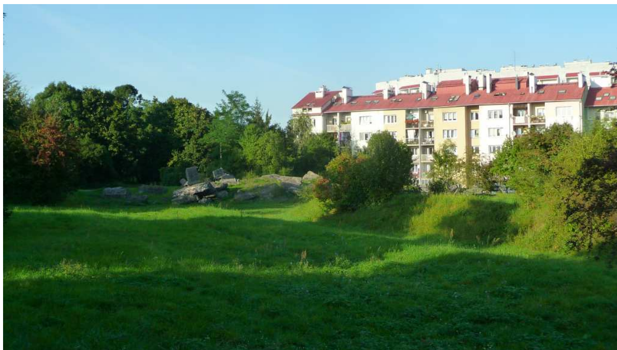
Fot. nr 411. Ruina monumentalnego domu przedpogrzebowego przy ulicy Jerozolimskiej, wybudowanego wg projektu Wandalina Beringera przy nowym kirkucie podgórskim na początku lat 30. XX wieku. W trakcie funkcjonowania w tym miejscu KL Płaszów znajdował się w nim magazyn. Niemcy likwidując Obóz w roku 1944 wysadzili obiekt, uszkadzając znaczną jego część. Pozostałości zostały rozebrane już po II wojnie światowej. W ruinach do dziś czytelne są jej duże fragmenty, m.in. gzymsy ze zdobieniami. Póki co nie ma pomysłu na uporządkowanie gruzowiska. (08.09.2023)
