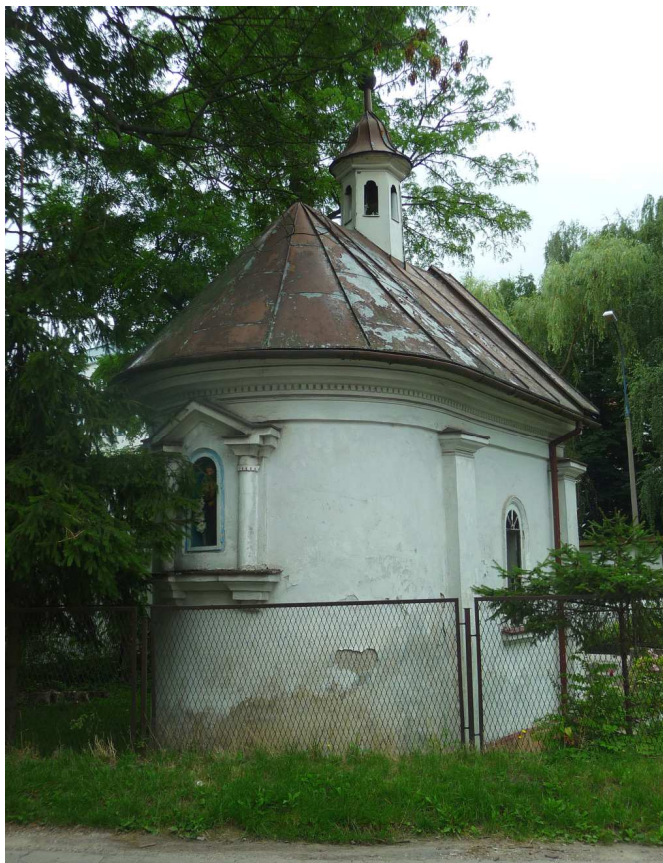
Fot. nr 395. Absyda od strony ulicy Twardowskiego. (01.08.2023)
