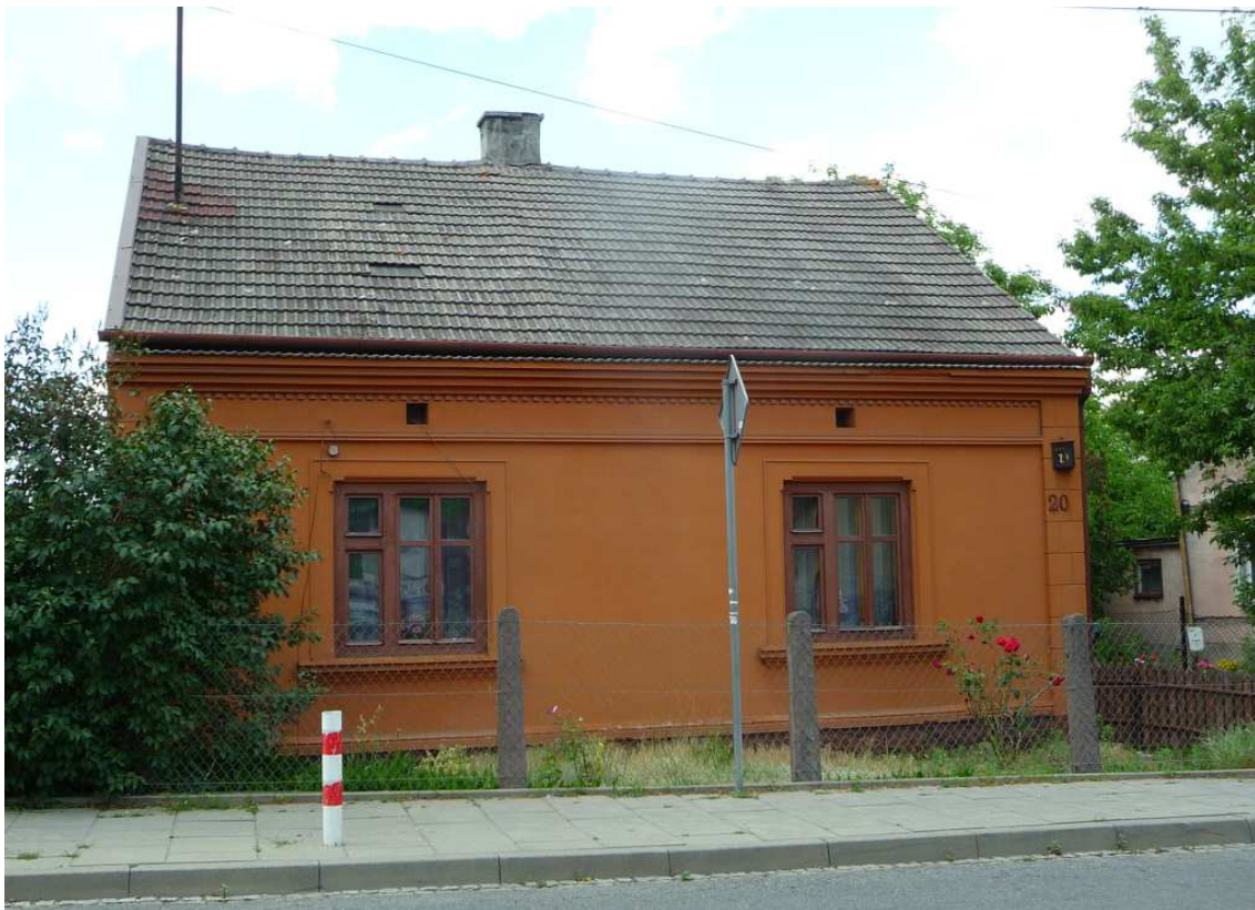
Fot. nr 442. Kolejny relikw niskiej zabudowy z ulicy Klonowica 20. (26.06.2023)
