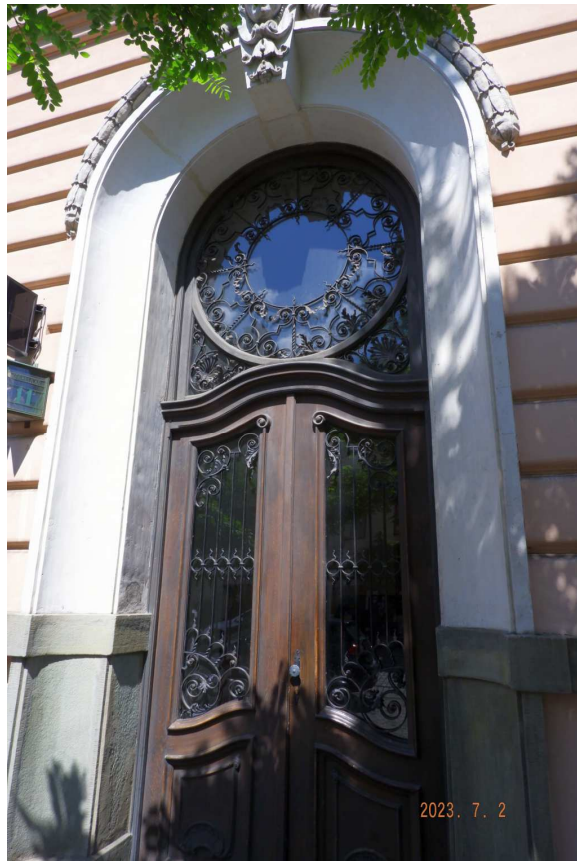
Fot. nr 131. Neorokokowe drzwi kamienicy pod nr 11.
