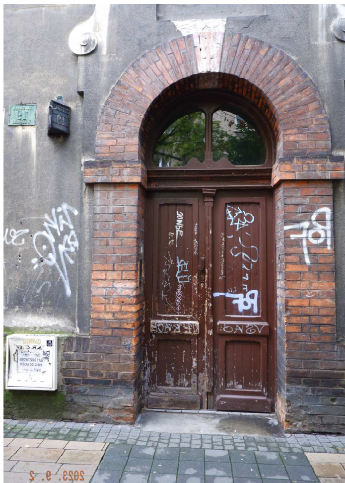
Fot. nr 303 (303-304). Neorenesansowe drzwi kamienicy pod nr 19 i jej detale.
