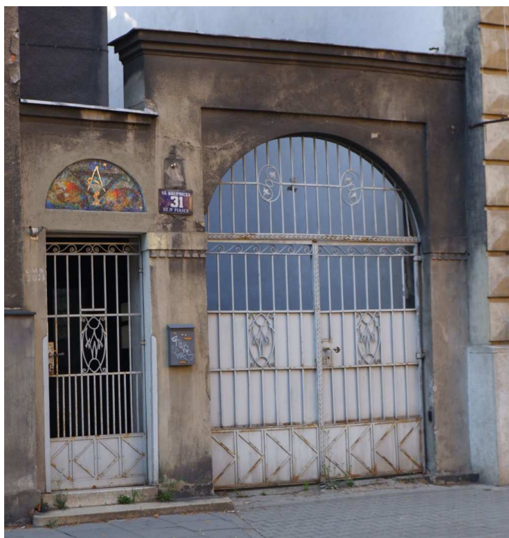
Fot. nr 152. Brama wjazdowa i mozaika. (06.07.2023)
