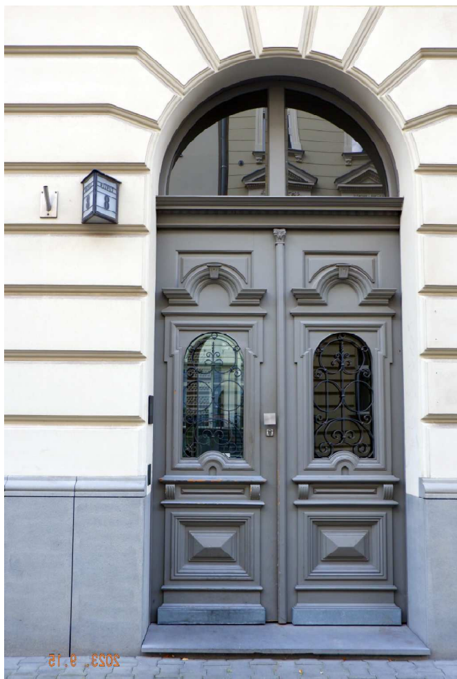
Fot. nr 163. Z dawnych detali kamienicy przetrwały tylko drzwi wejściowe.
