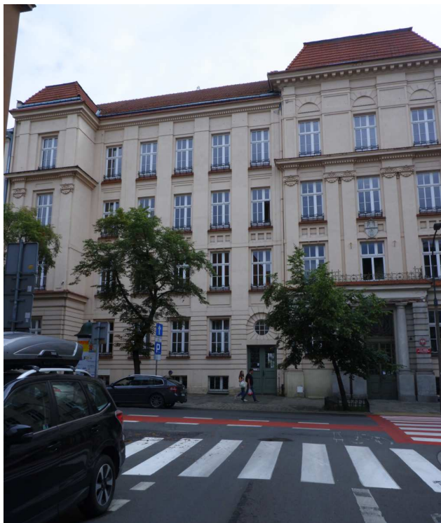
Fot. nr 202 (202-206). Budynek szkolny z ulicy Szlak 5 i jego detale. (02.09.2023)
