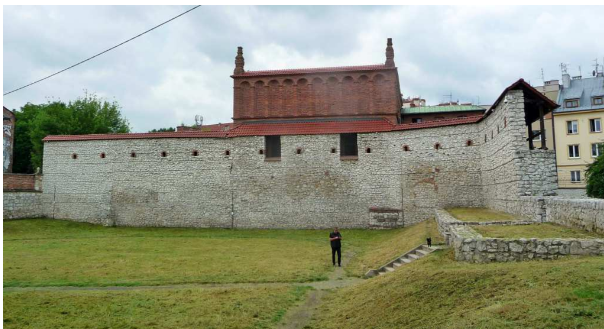
Fot. nr 254 (254-255). Przylegający do bożnicy od strony ulicy Dajwór fragment częściowo zrekonstruowanego muru obronnego Kazimierza. (27.06.2023)
