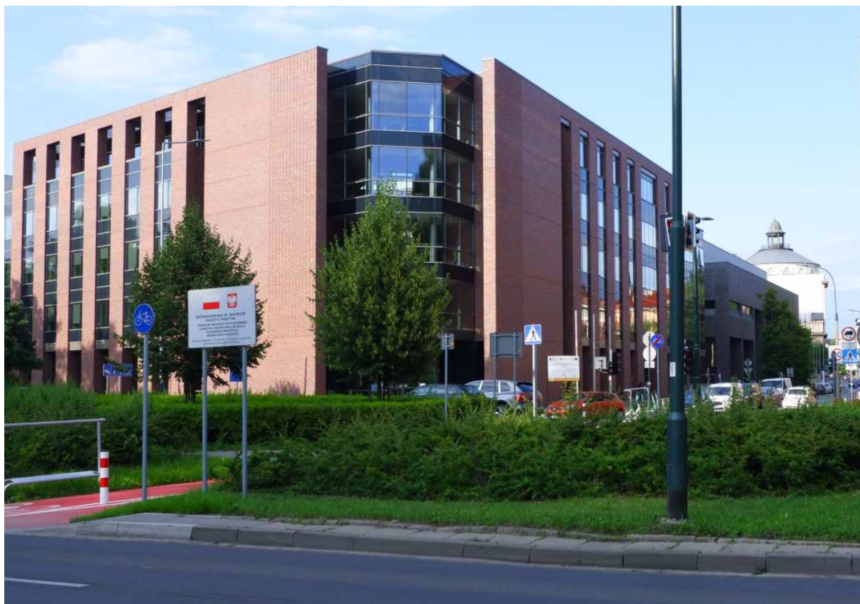
Fot. nr 157. Nowy gmach Collegium Paderevianum przy alei Mickiewicza 9. (06.07.2023)
