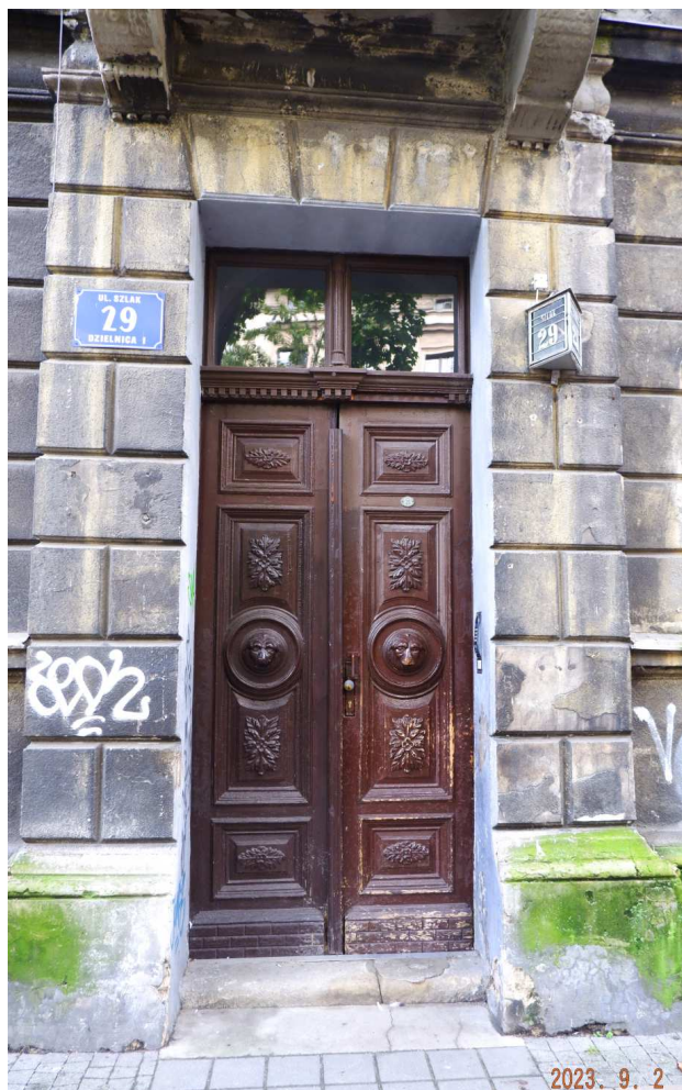
Fot. nr 301. Drzwi kamienicy pod nr 29.
