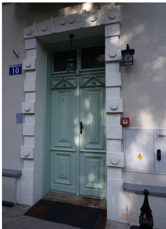
Fot. nr 212. Oryginalny portal i drzwi wejściowe.
