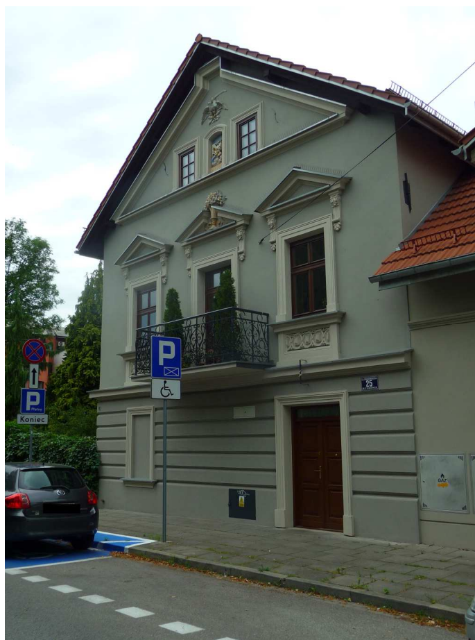
Fot. nr 370 (370-374). Odnowiona fasada budynku dworu i jej detale. (01.08.2023)
