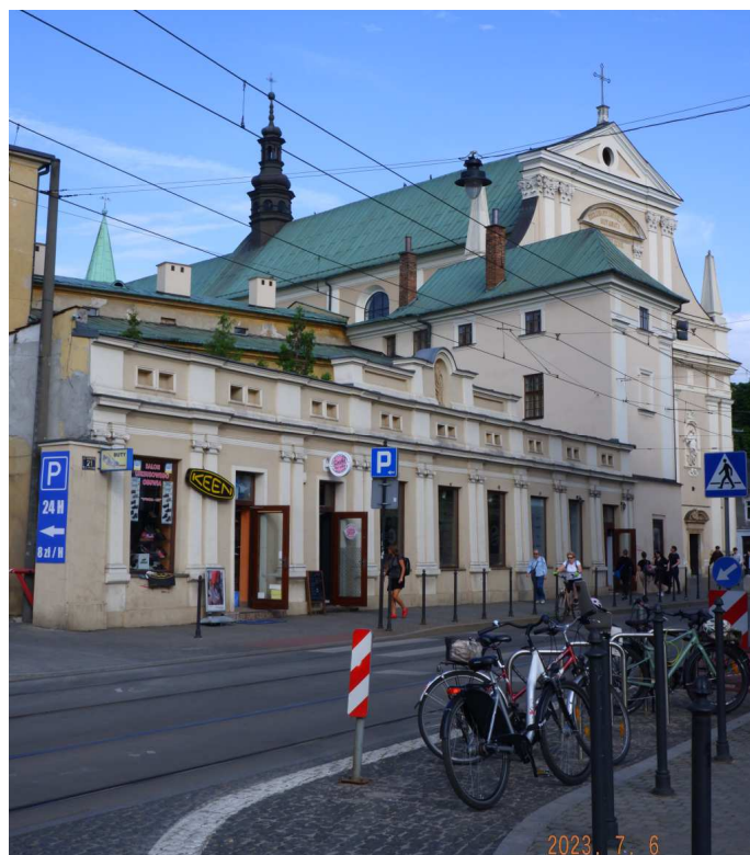
Fot. nr 112 (112-113). XIX-wieczny budynek pod nr 19 i kościół Karmelitów.
