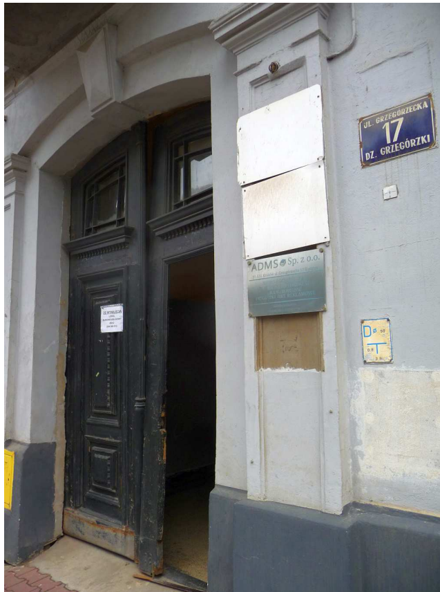
Fot. nr 330. Drzwi kamienicy pod nr 17. (27.06.2023)
