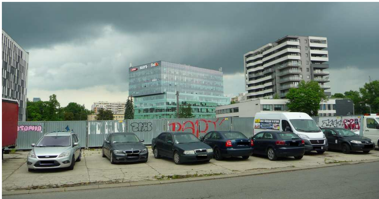
Fot. nr 311 (311-320). Wzdłuż ulicy Grzegórzeckiej. (27.06.2023)
