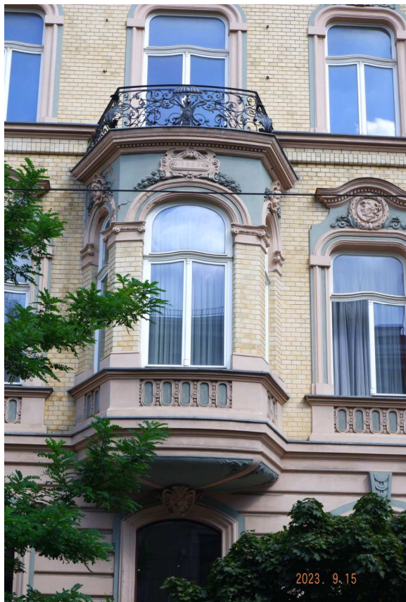
Fot. nr 132. Wykusz kamienicy pod nr 9.
