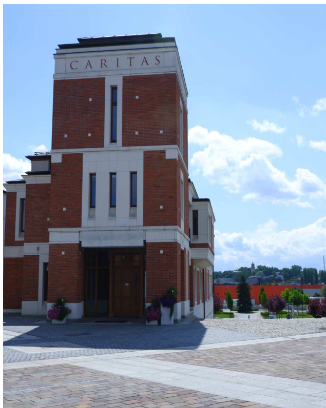
Fot. nr 481. Budynek Caritas. (28.06.2023)
