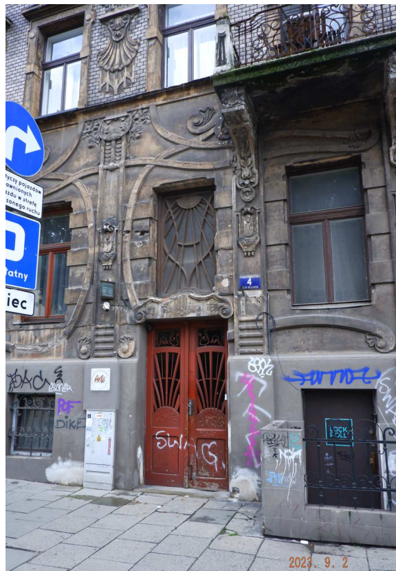
Fot. nr 190 (189-190). Kamienica pod nr 4 i jej secesyjne zdobnictwo.
