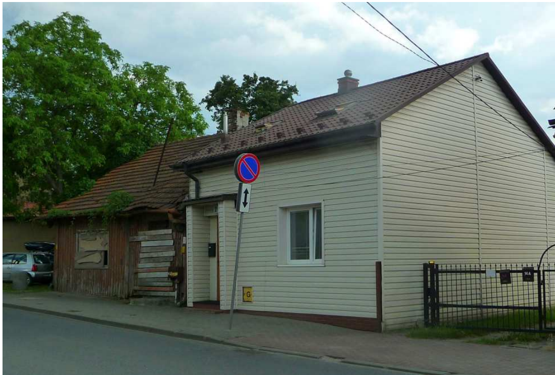
Fot. nr 436. Odchodzący świat dawnej wsi z ul. Trybuny Ludów Nr 14 i 14a. (26.06.2023)
