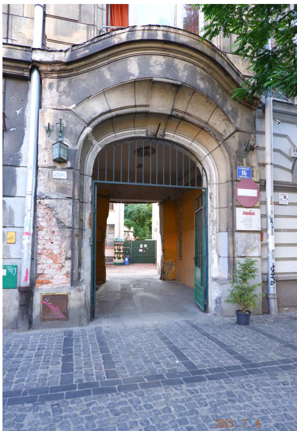
Fot. nr 129 (129-130). Kamienica pod nr 16; w tle pusta przestrzeń po korycie Młynówki.
