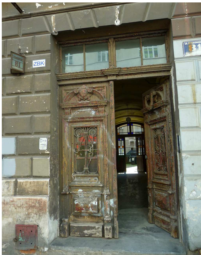
Fot. nr 261 (261-265). Detale kamienicy przy ulicy Starowiśniej. Drzwi wejściowe spod nr 81. (18.07.2023)
