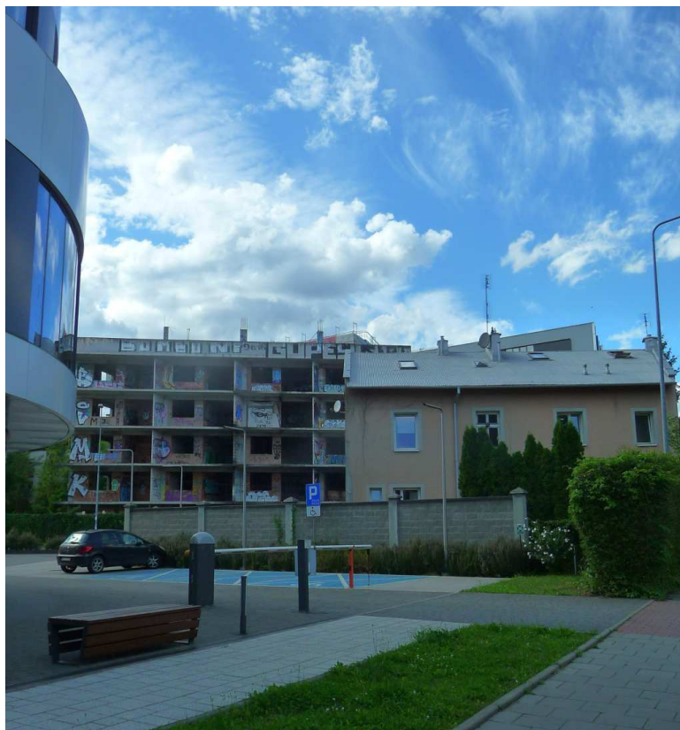
Fot. nr 365 (365-375). Wzdłuż początkowego odcinka ulicy Twardowskiego. W tle niedokończone od lat blokowisko. (02.08.2023)
