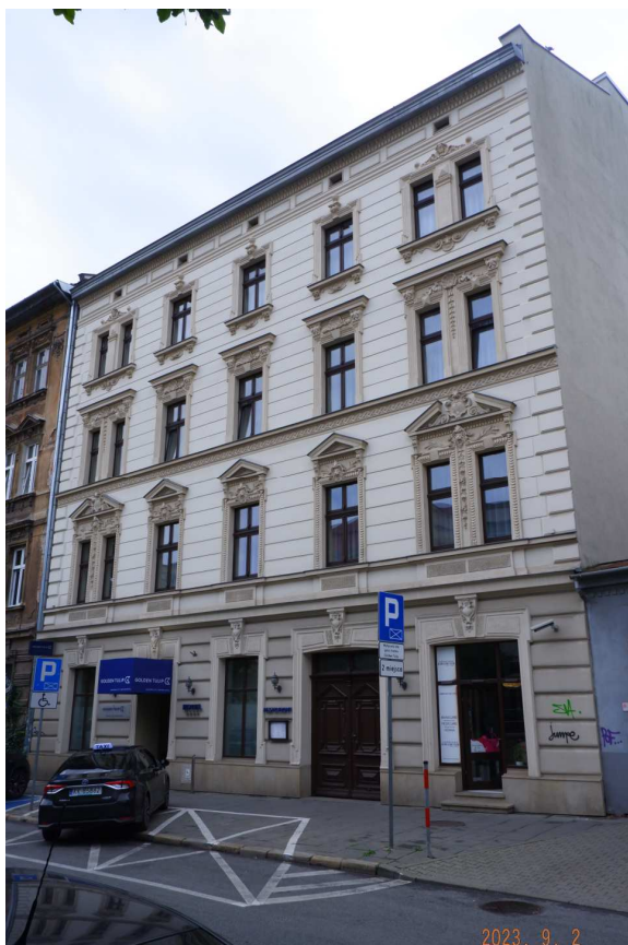
Fot. nr 191. Odnowiona kamienica pod nr 8.
