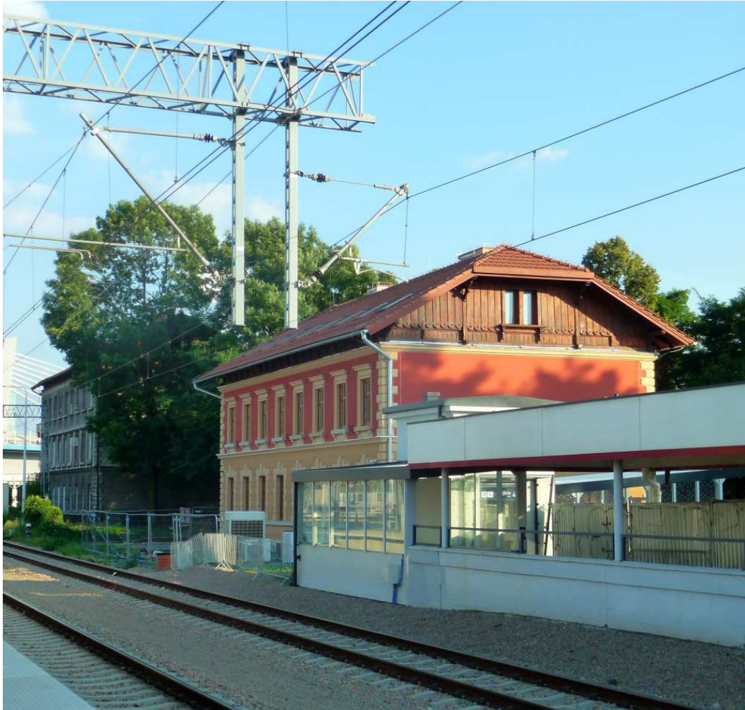
Fot. nr 505. W tle czekający na odnowę budynek pod nr 2c. (20.08.2023)
