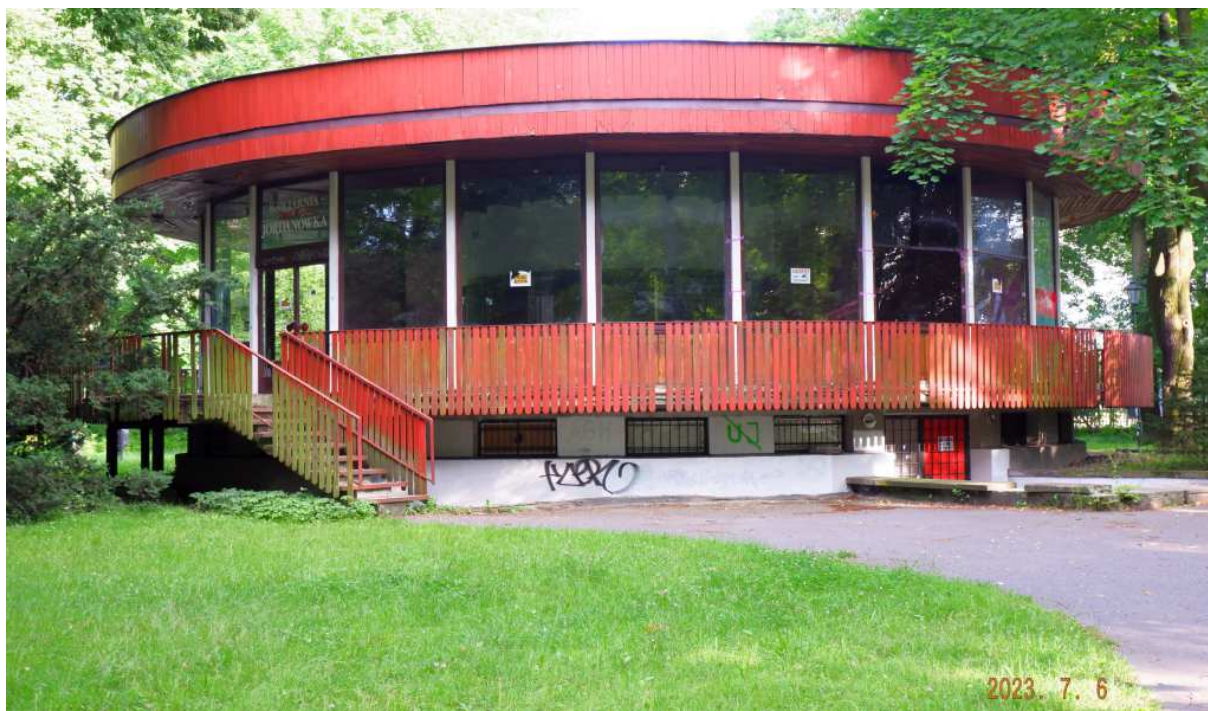
Fot. nr 221. Powstały na początku lat 70. nowy okrągłak, ciągle opuszczony. Nie ma pewności czy pozostanie on w obecnym kształcie czy powstanie tu nowy obiekt, np. rekonstrukcja drewnianego oryginału.
