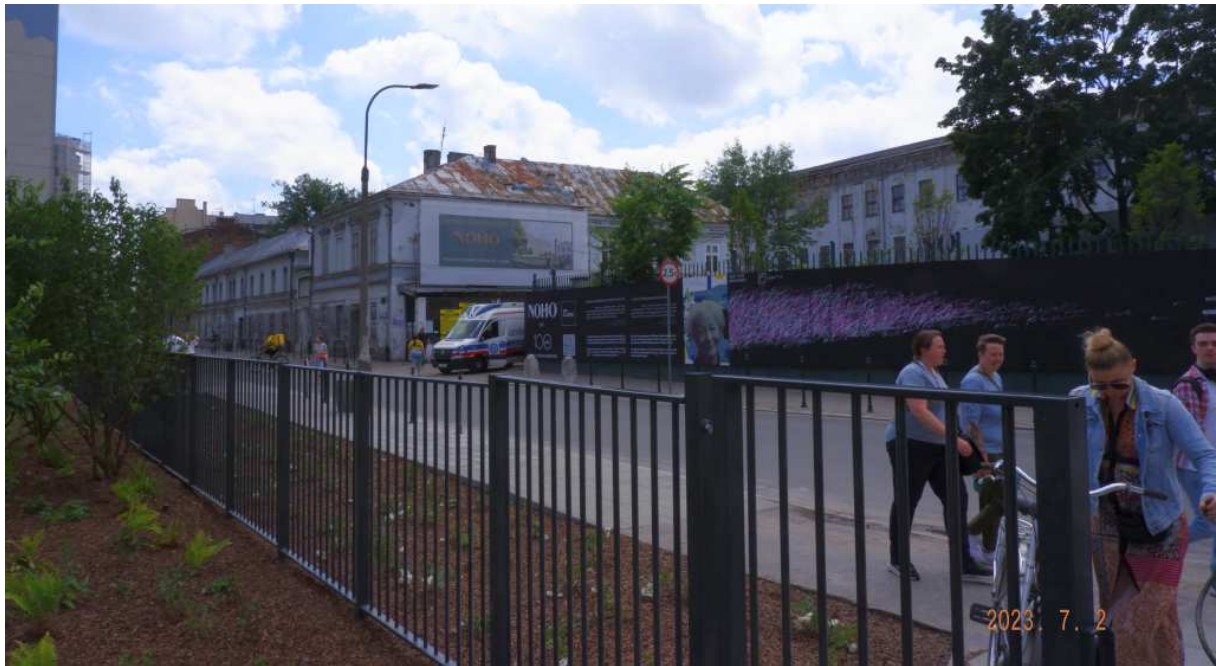
Fot. nr 93 (93-96). Wzdłuż ulicy Dolnych Młynów. Z lewej dawne budynki KZT przed burzą budowlaną.
