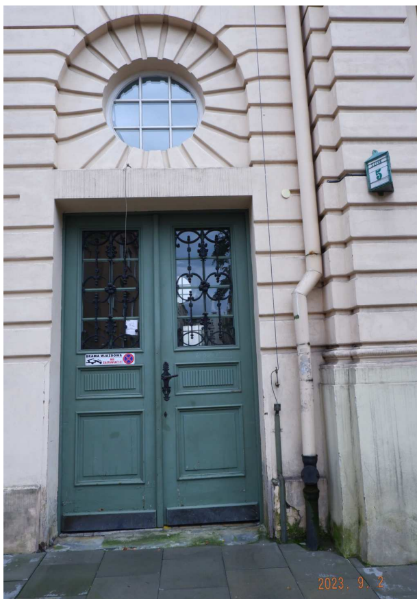
Fot. nr 205 (205-206). Drzwi w lewym fragmencie gmachu.
