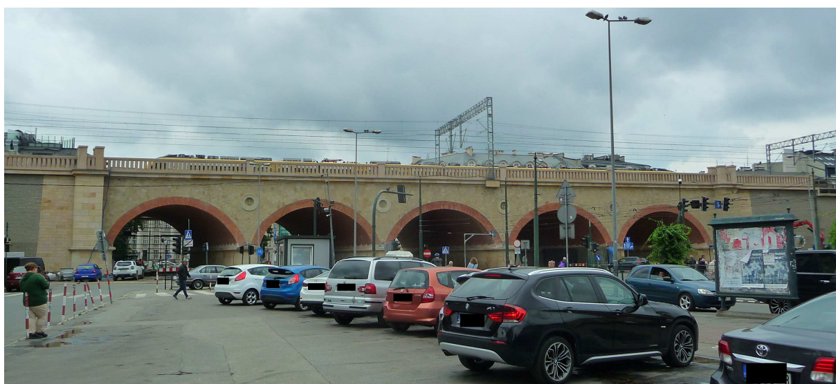
Fot. nr 336. Nowy zabytek – wyburzony oryginał wiaduktu z roku 1863, w którego miejscu powstał przypominający go, rozbudowany nowy obiekt. (27.06.2023)
