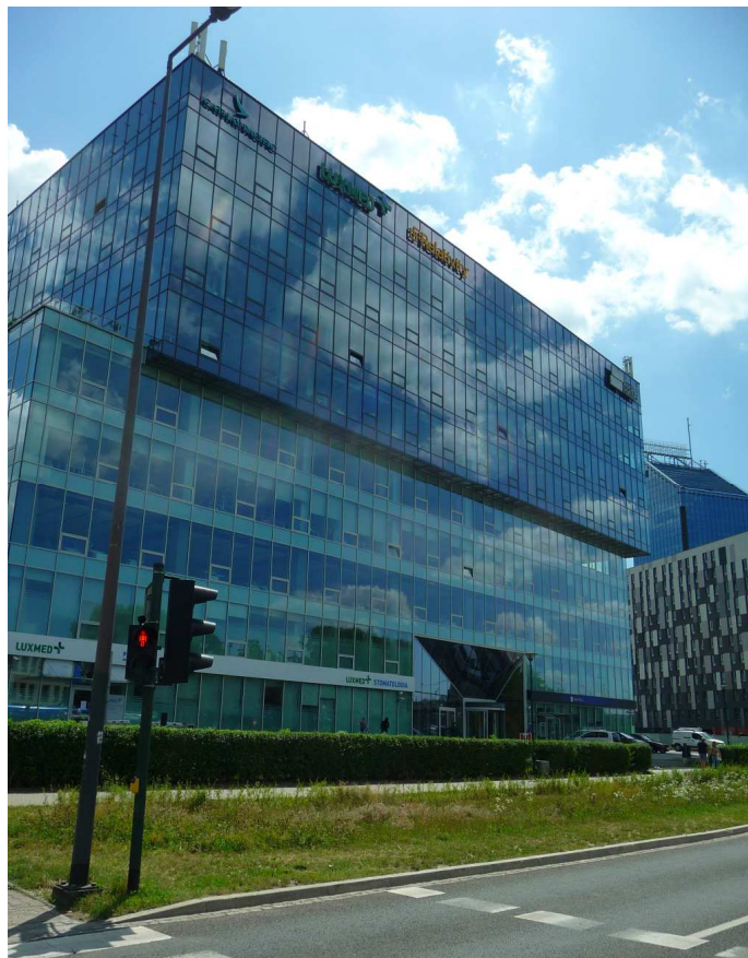
Fot. nr 307. Nowo wybudowany szklany dom pod nr 5, w miejscu budynku RSW Prasa-Książka-Ruch. (18.07.2023)
