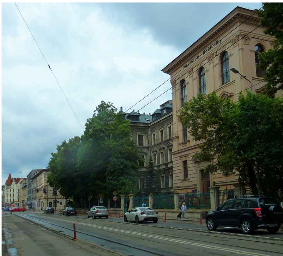
Fot. nr 331 (331-332). Budynek Medycyny Sądowej pod nr 16. (27.06.2023)
