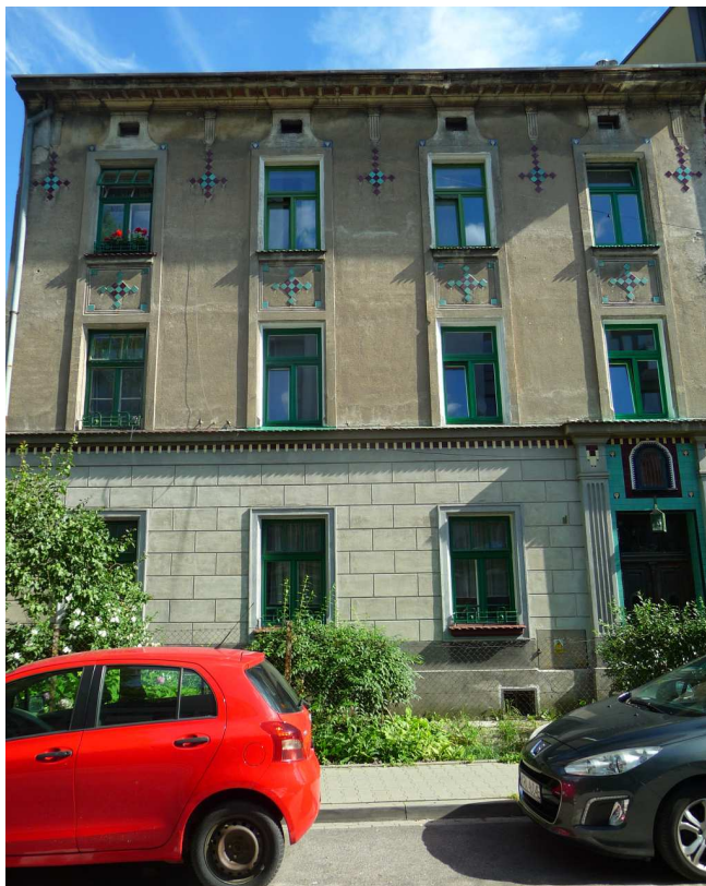
Fot. nr 383 (382-383). Fasada kamienicy(02.08.2023)
