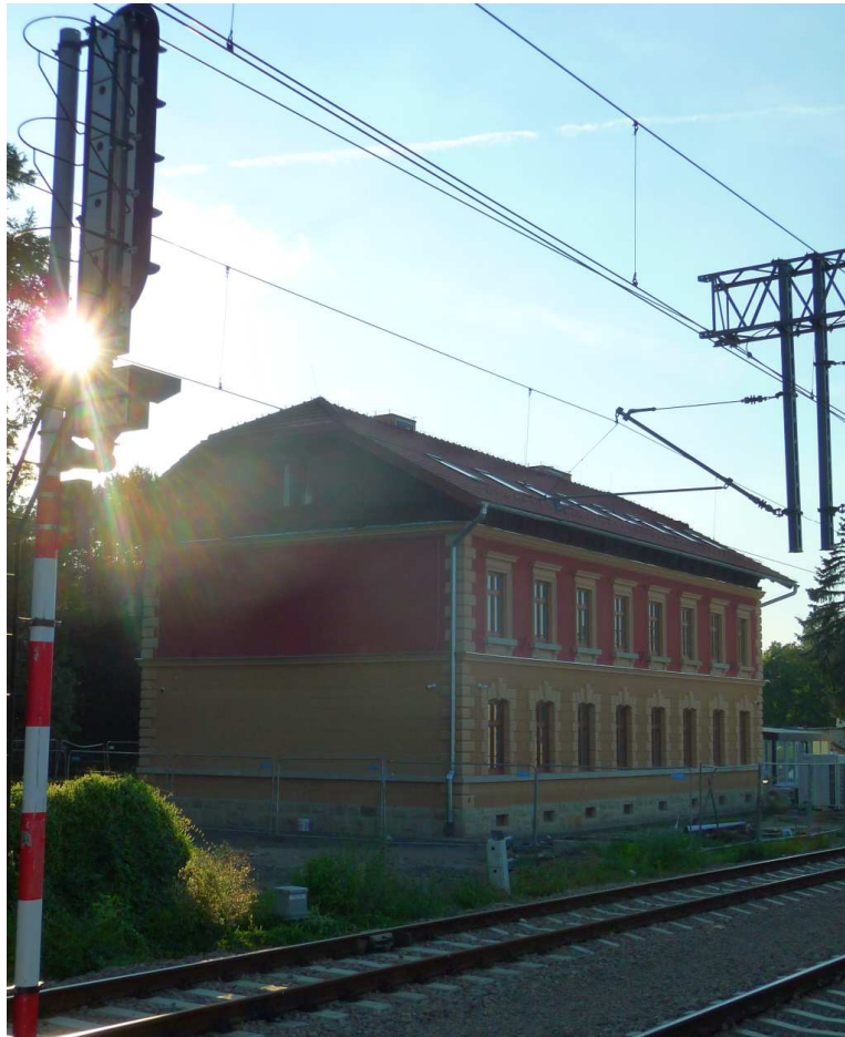
Fot. nr 503 (503-505). Odnowiony budynek stacyjny przy ul. Dworcowej 2b. (20.08.2023)
