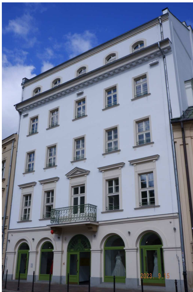
Fot. nr 38. Odnowiona kamienica pod nr 14. (15.09.2023)
