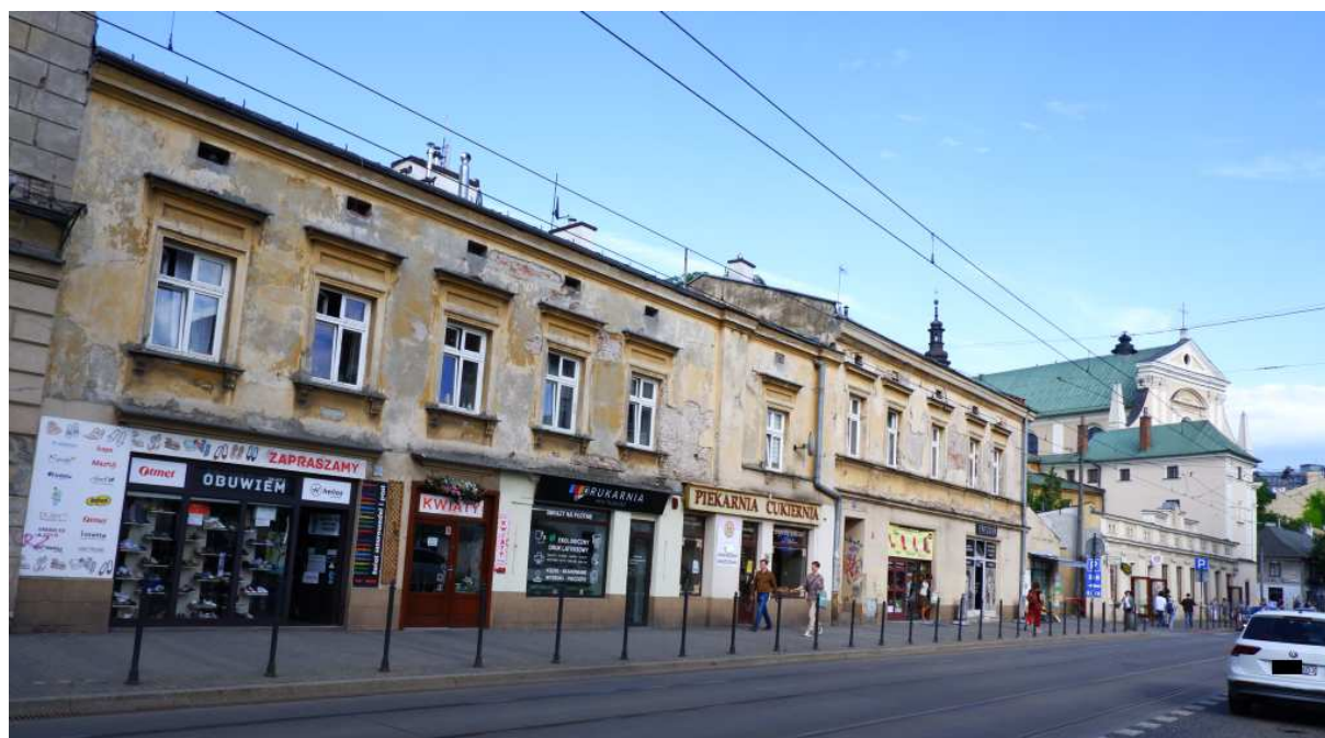
Fot. nr 108. Fragment zabudowy pod nr: 19-23. (06.07.2023)
