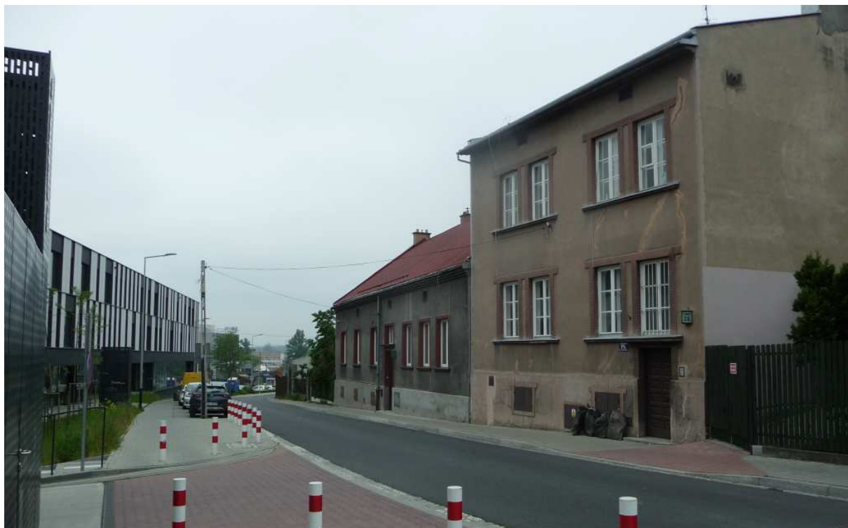
Fot. nr 137. Fragment niskiej zabudowy, zapewne jeszcze przedwojennej, o numerach: 29 a i b. (25.05.2023)
