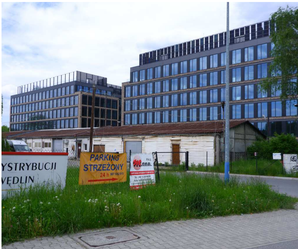
Fot. nr 309. „Szklane domy” przy ulicy Saskiej 27. (13.05.2023)
