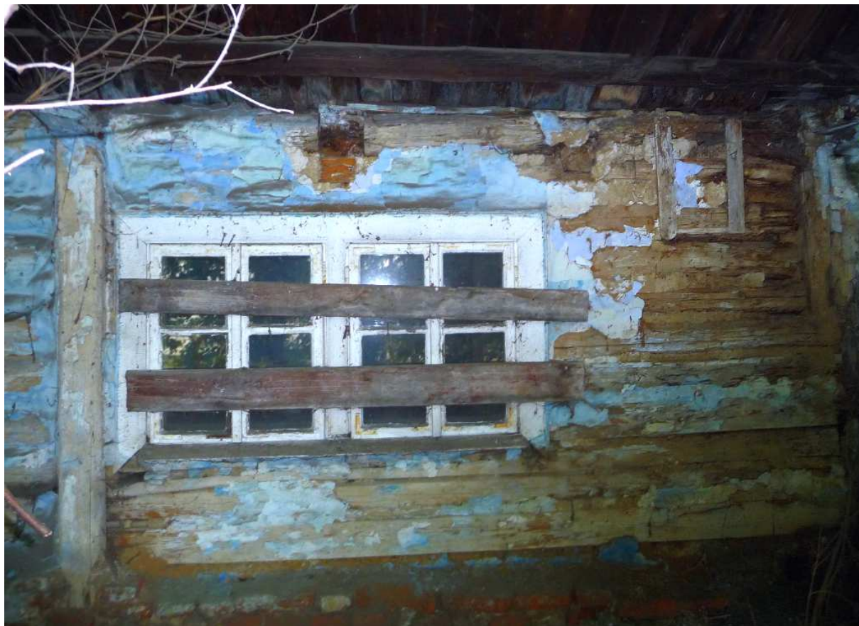
Fot. nr 329. Archaiczna chatka przylegająca do domu pod nr 8. (22.05.2023)
