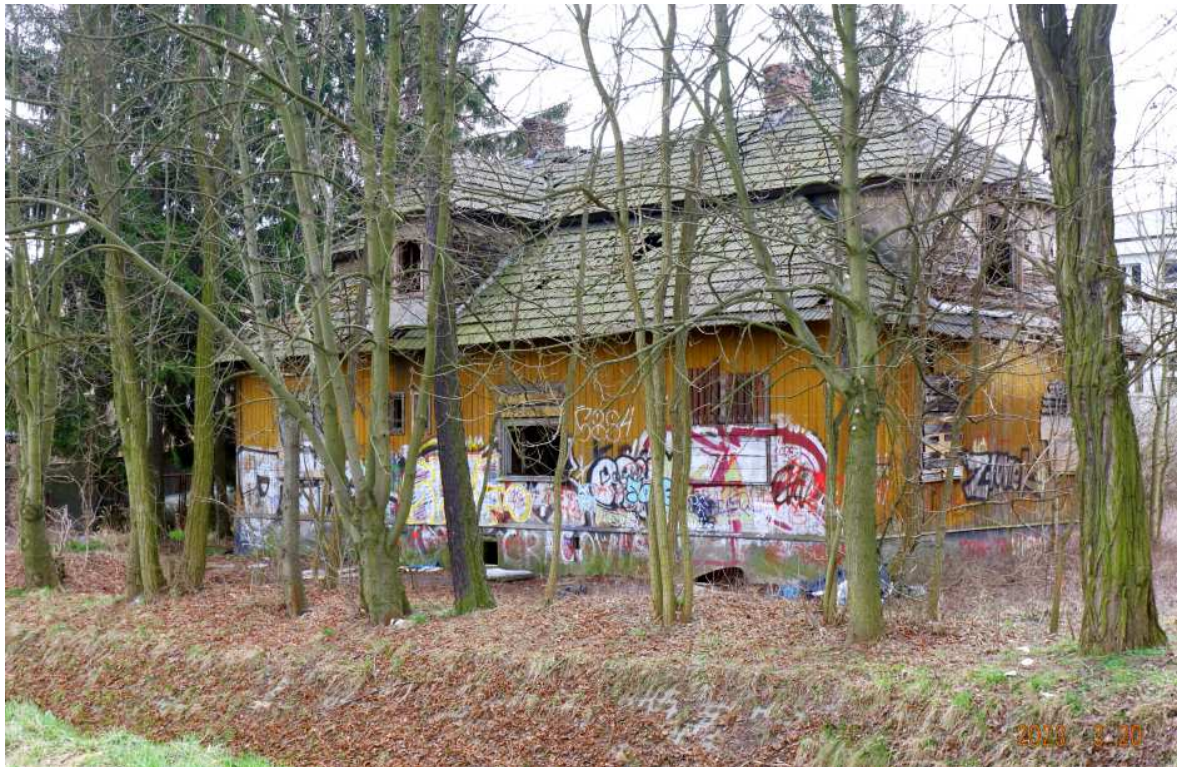
Fot. nr 406. Tylna część od strony torów kolejowych.
