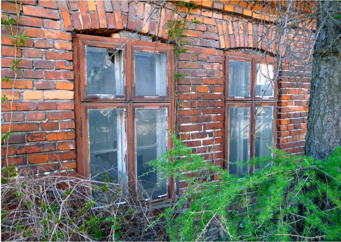
Fot. nr 517. Oryginalne okna typu skrzynkowego w prawym fragmencie. (11.05.2023)
