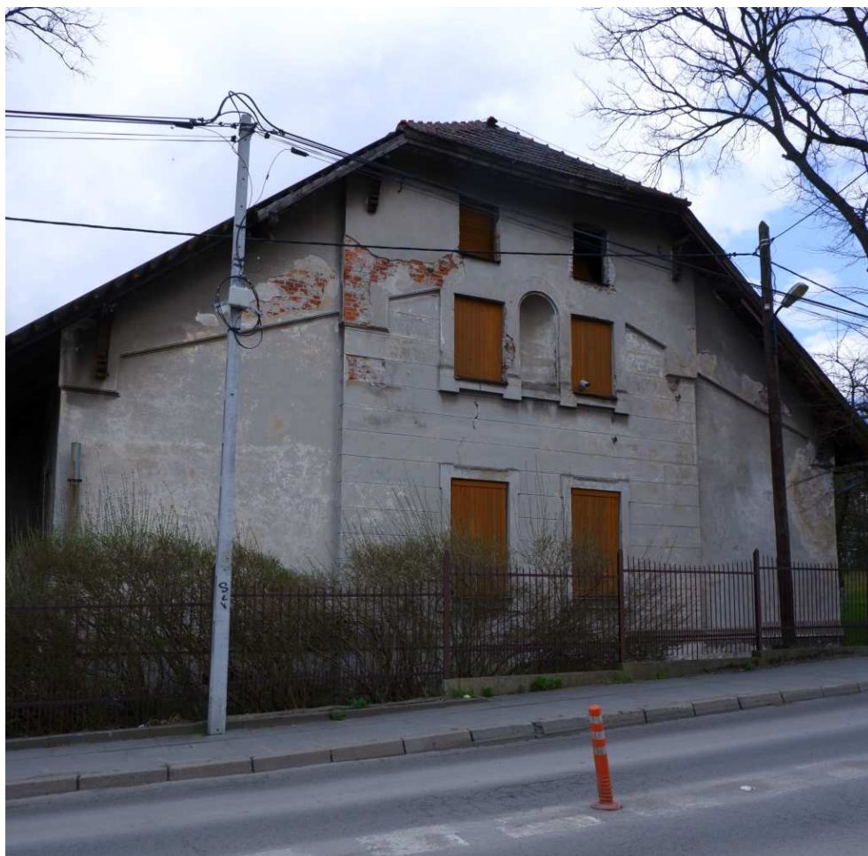
Fot. nr 556 (556-557). Ściana szczytowa od strony ulicy. (25.03.2023)
