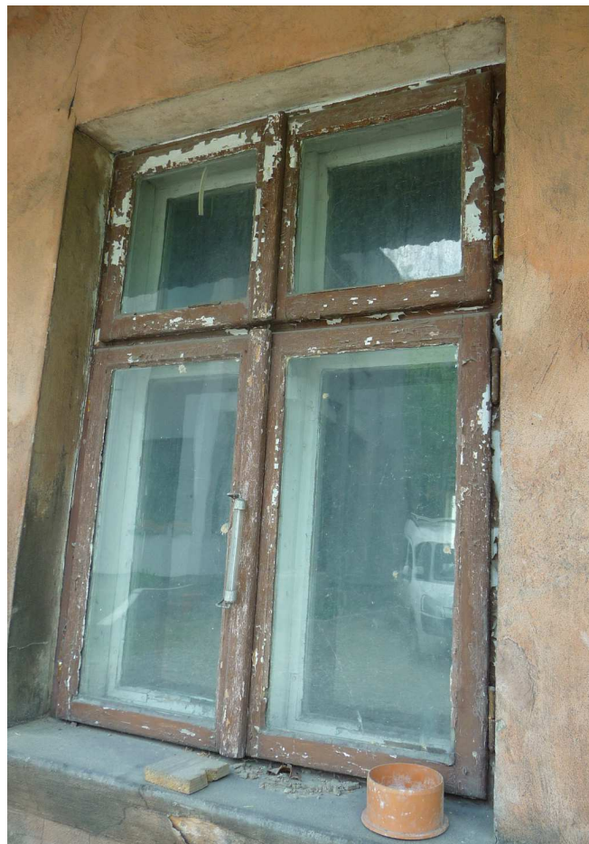
Fot. nr 344. Oryginalne okno typu skrzynkowego. (08.06.2023)
