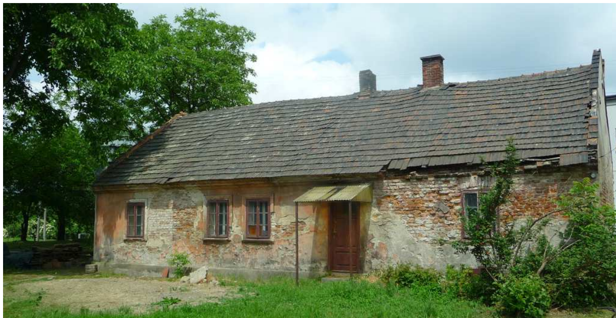
Fot. nr 333 (333-349). Murowana chałupa z roku 1912 z ulicy Koszykarskiej 16, własność znanego architekta. Są szanse, że zostanie przykładowo odrestaurowana. (08.06.2023)
