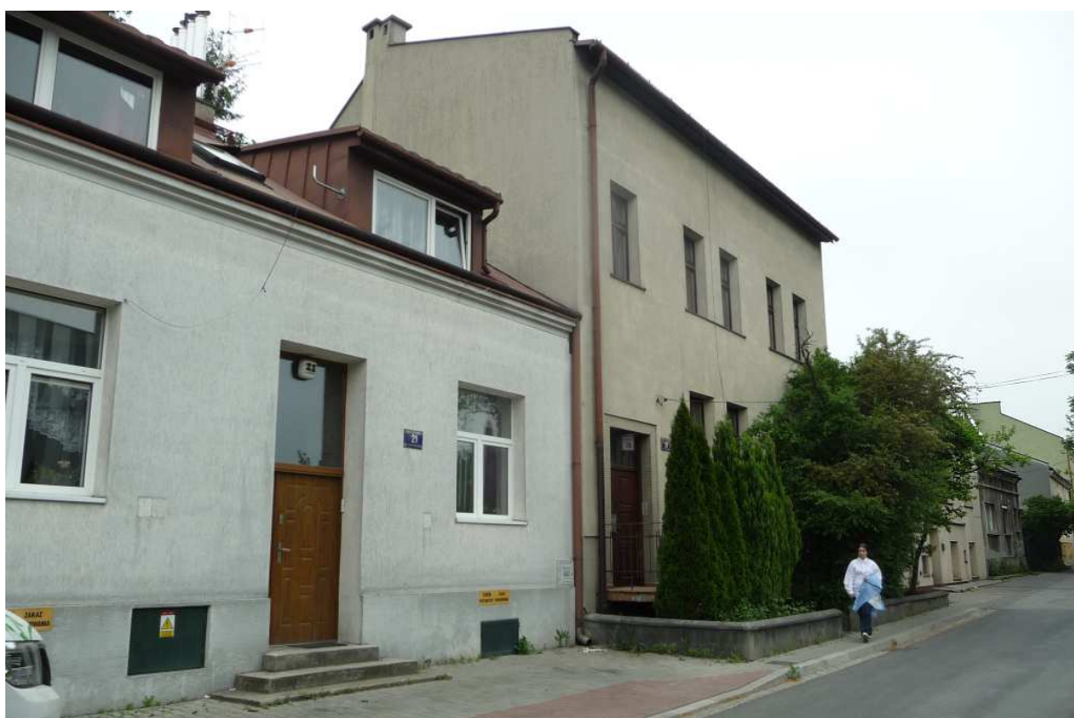
Fot. nr 139. Fragment zabudowy poniżej numeru 21. (25.05.2023)
