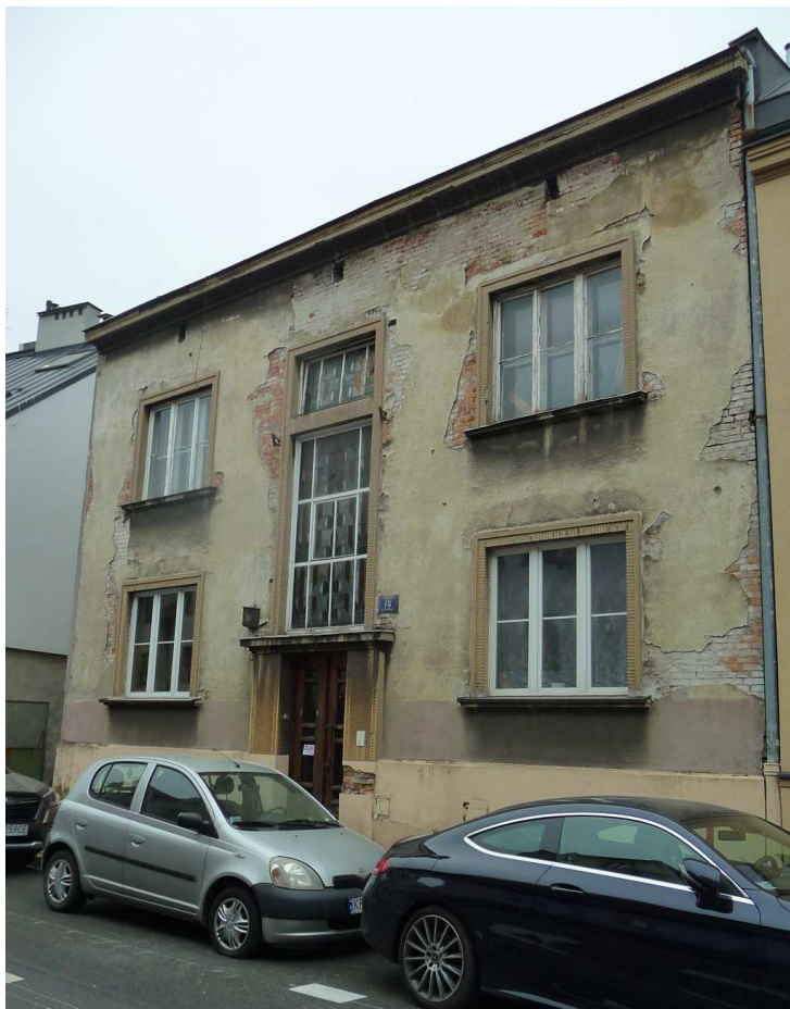
Fot. nr 132 (132-134). Zapewne międzywojenny dom pod nr 78. (25.05.2023)
