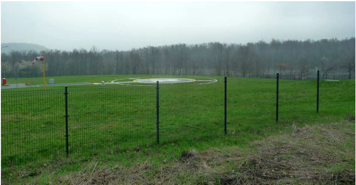
Fot. nr 450. Lądowisko dla helikopterów. (10.04.2023)
