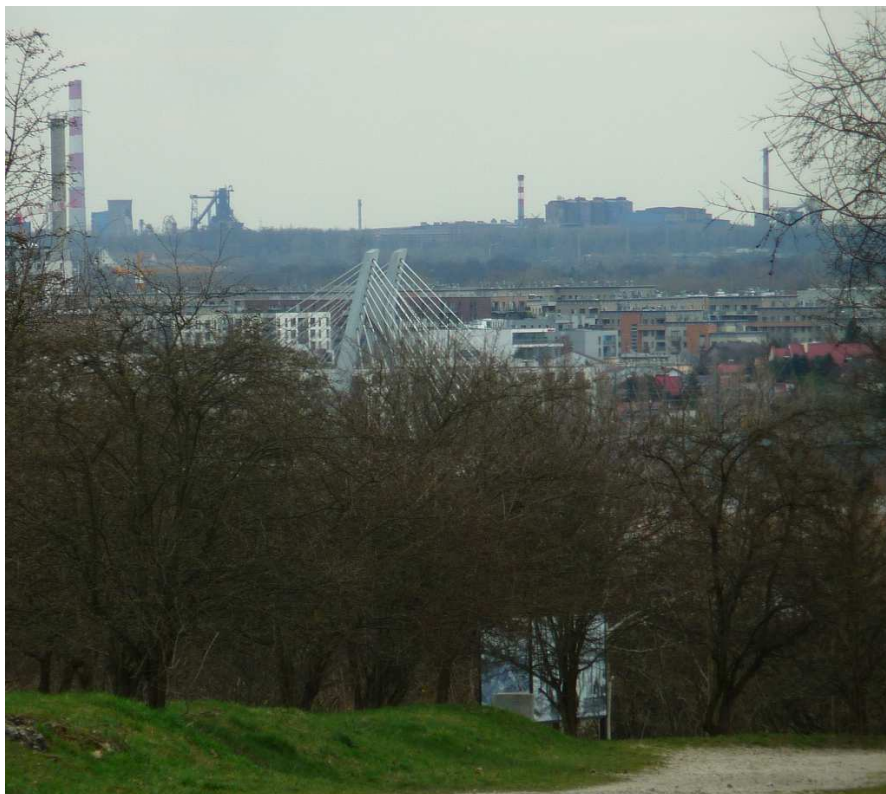
Fot. nr 239. Z infrastrukturą dawnej HiL w tle. (23.03.2023)
