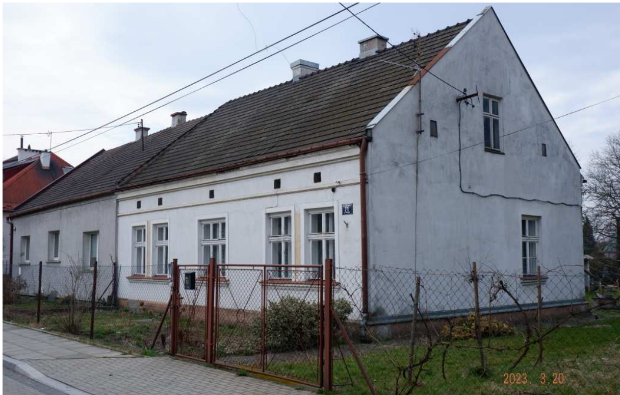
Fot. nr 404. Przedwojenny dom wielorodzinny z ulicy Solarzy 21.
