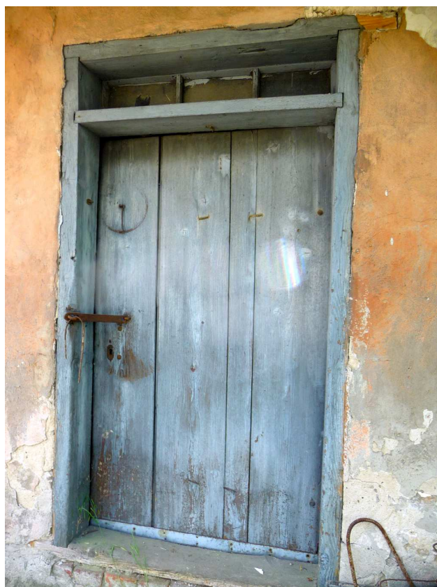
Fot. nr 346. Archaiczne drzwi z oberlichtem. (08.06.2023)
