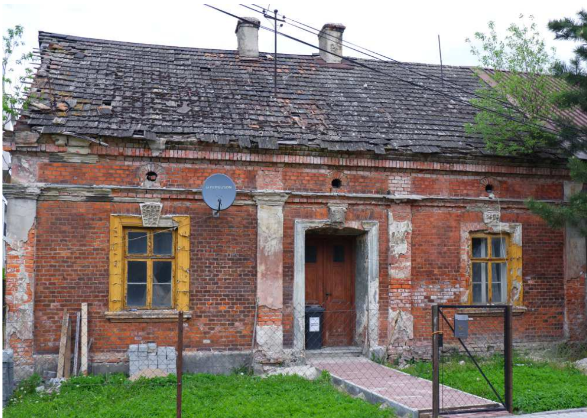
Fot. nr 313. Oryginalna fasada z oknami typu skrzynkowego. Aż wierzyć się nie chce, że taki obiekt może zniknąć. (13.05.2023)
