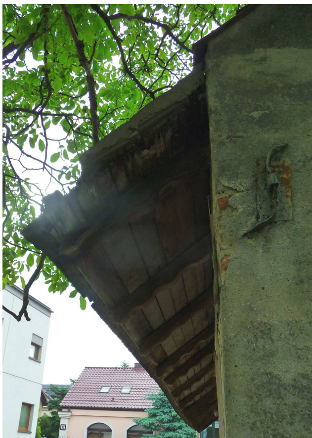
Fot. nr 345. Więźba dachowa. (08.06.2023)
