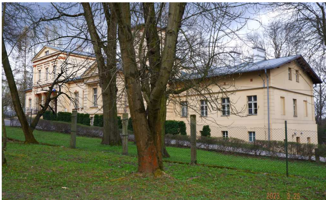
Fot. nr 560 (559-564). Kilka ujęć fasady dworu Czeczów.
