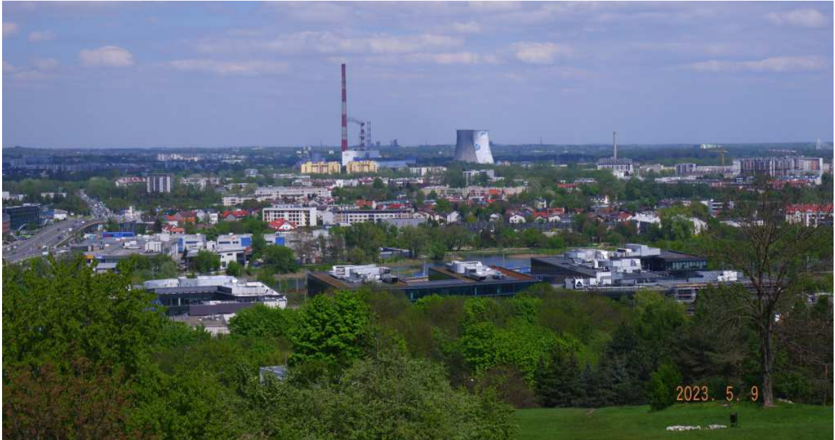
Fot. nr 203. Z kominami elektrociepłowni w Łęgu w tle.
