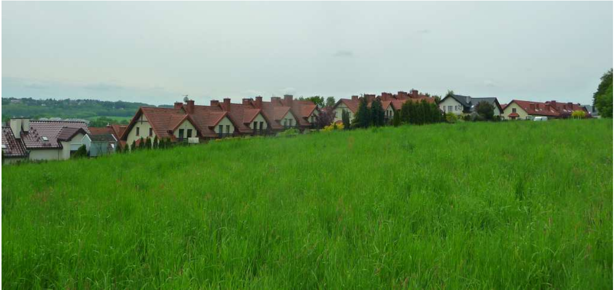
Fot. nr 593 (593-594). Szeregowa zabudowa wzdłuż ulicy Chabrowej. (16.05.2023)
