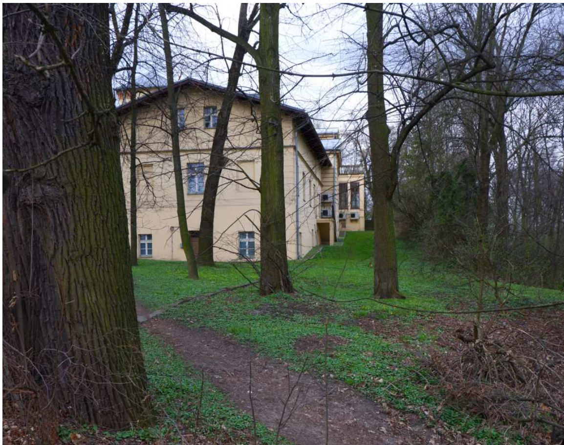
Fot. nr 559 (559-565). Zespół dworsko-parkowy Czeczów przy ulicy Popiełuszki 36. Dwór to rozległy pałacyk wzniesiony po roku 1873 w stylu eklektycznym z inicjatywy Karola Czecza de Lindewald, w miejscu dawnego dworu z XV wieku. (25.03.2023)
