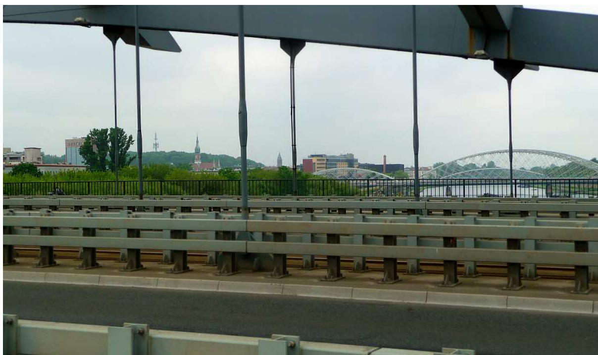
Fot. nr 65. W stronę centrum Podgórze. (08.06.2023)
