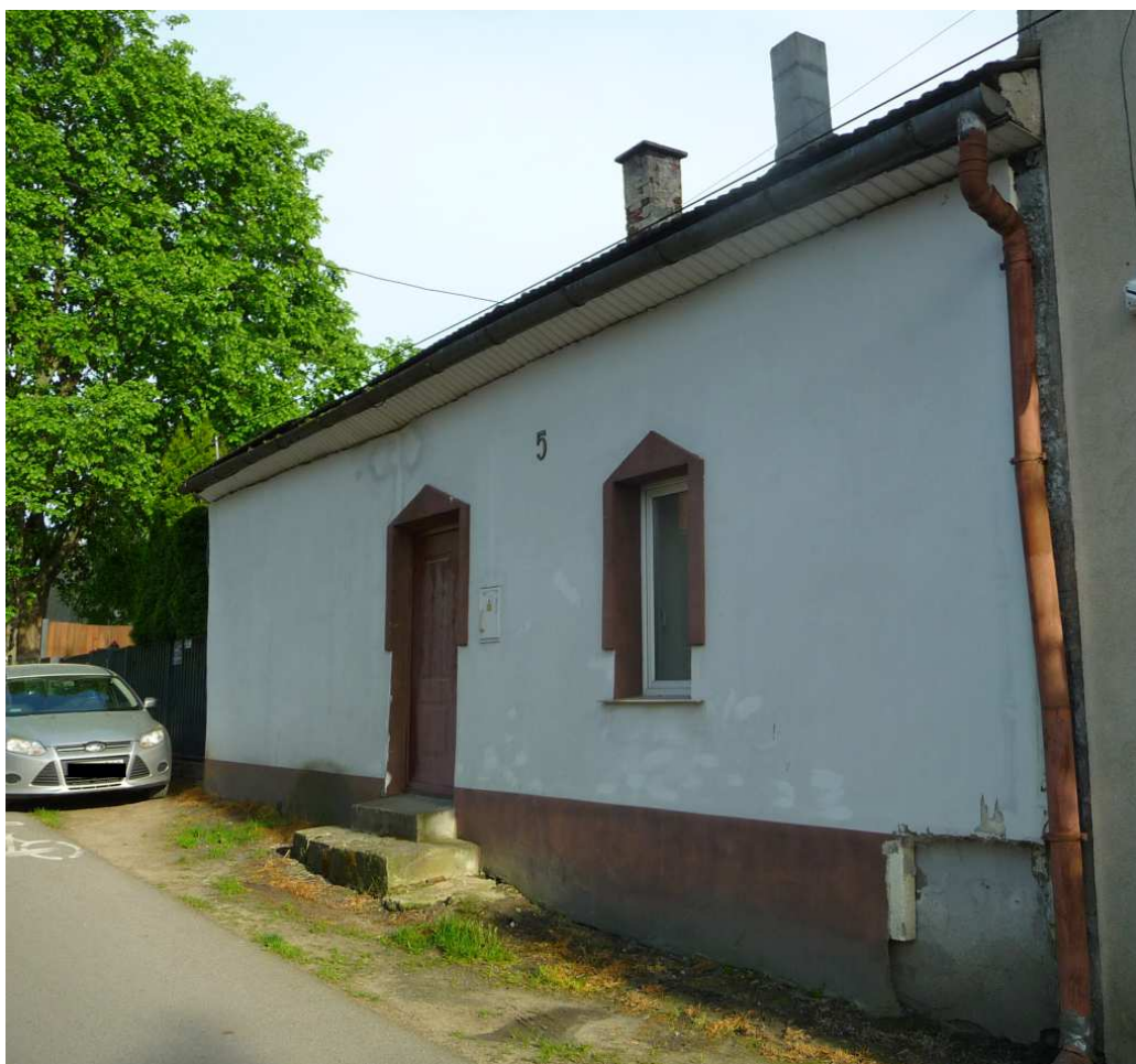
Fot. nr 328 (328-330). Wzdłuż ulicy Stróża Rybna. Przebudowany dom podmiejski pod nr 5. (22.05.2023)
