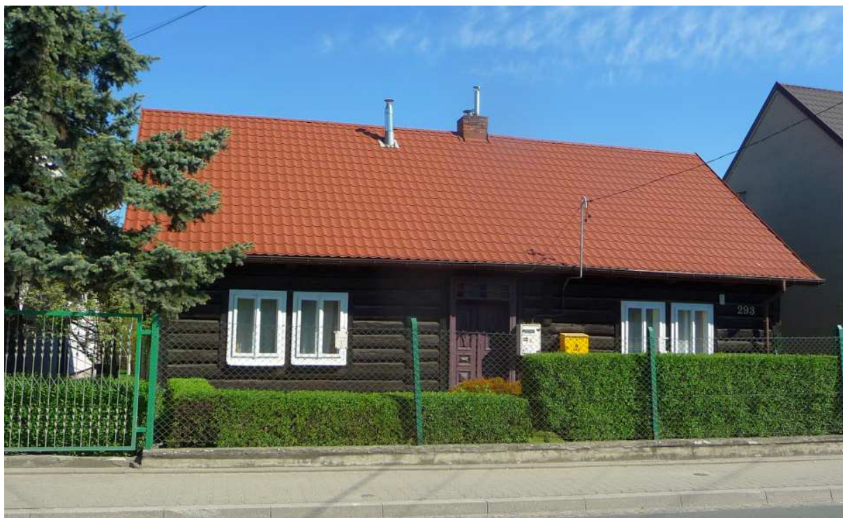
Fot. nr 507 (507-510). Świetnie zachowana drewniana chałupa z ok. roku 1910 z ulicy Bieżanowskiej 293. (11.05.2023)
