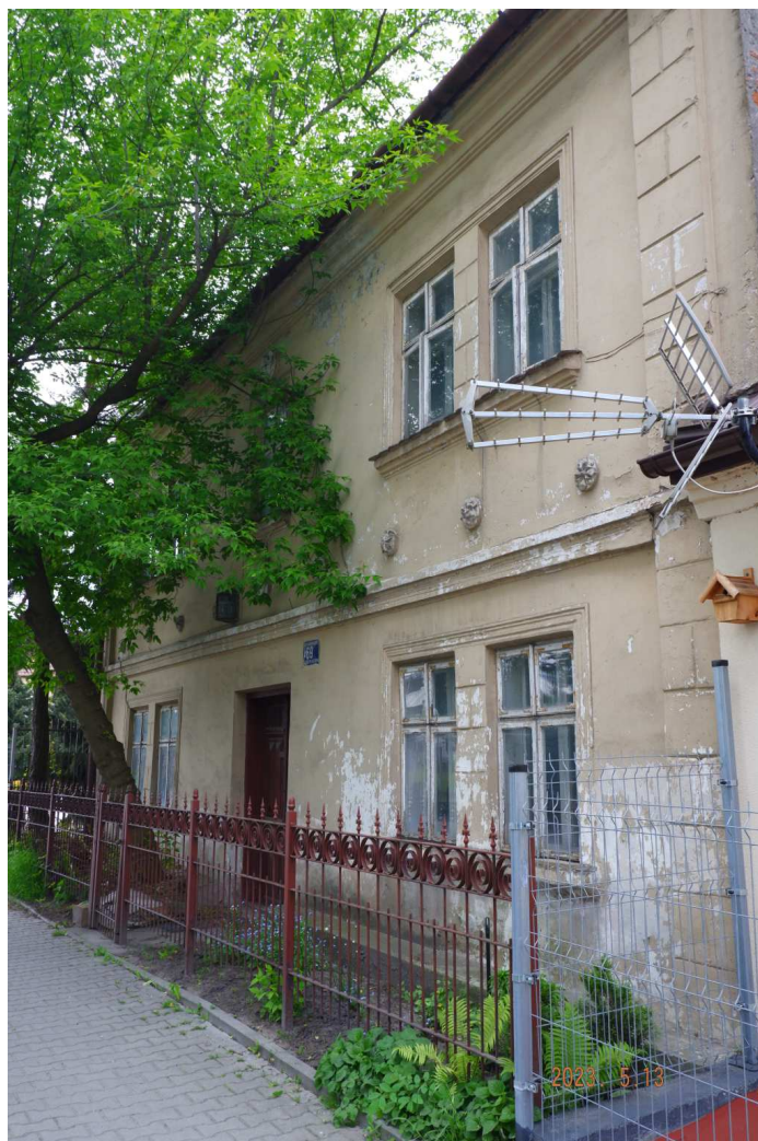
Fot. nr 319. Oryginalne okna typu skrzynkowego.
