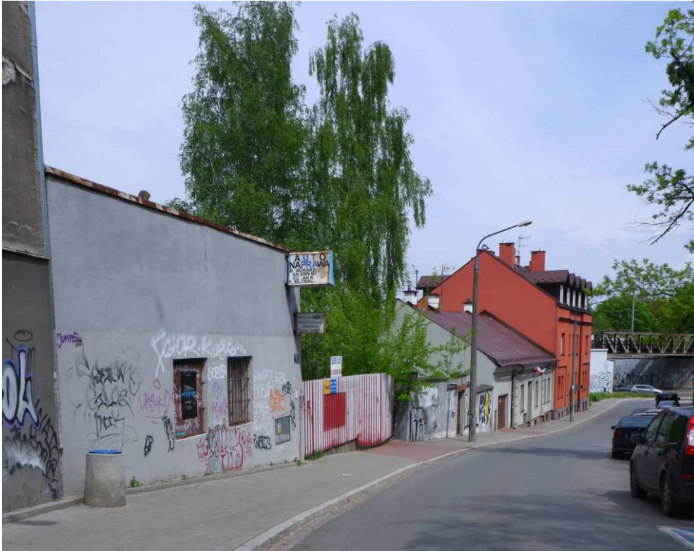
Fot. nr 166 (166-175). Wzdłuż ulicy Robotniczej, która do dziś zachowała niską zabudowę, typową dla dawnego przedmieścia. Widok w stronę ulicy Wielickiej. (02.05.2023)
