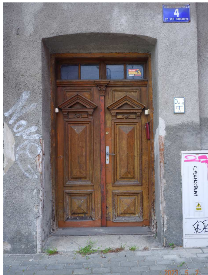
Fot. nr 175. Oryginalne, profilowane w drewnie drzwi i tablica z czasów Wielkiego Krakowa.
