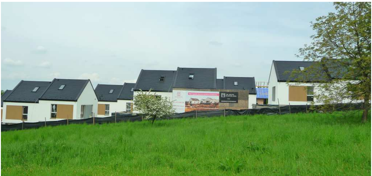
Fot. nr 598 (598-604). Nowopowstająca, gigantyczna zabudowa szeregową na terenie dawnych sadów. (16.05.2023)
