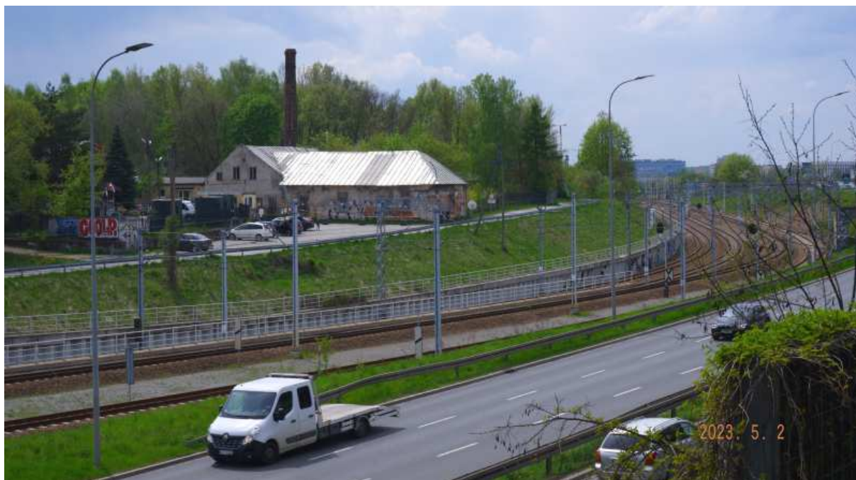
Fot. nr 164. Dawne zabudowania kamieniołomu Libana przy ulicy Za Torem 22, dziś siedziba MPK.
