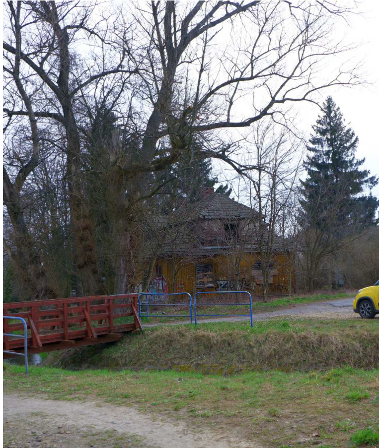
Fot. nr 405 (405-410). Będąca już w stanie nieodwracalnej ruiny willa z I ćwierci XX wieku z ulicy Czechowicza 10.
