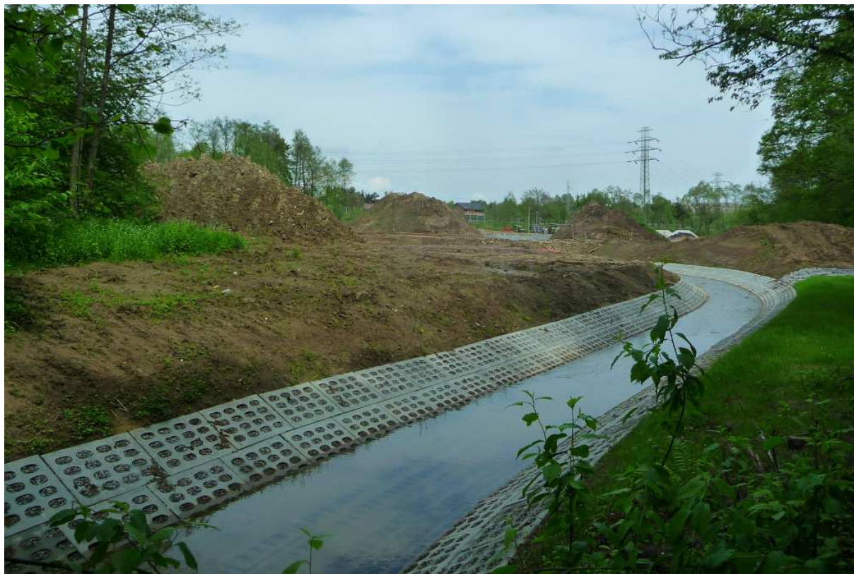
Fot. nr 579 (579-581). Malinówka w swym skanalizowanym korycie. Na styku Rżaki, Kosocic i Krzyżkowic powstaje przeciwpożarowy zbiornik retencyjny, który ma chronić przed nadmiernymi wezbrzeniami Serafę i zapobiegać podtapianiu Bieżanowa. (16.05.2023)
