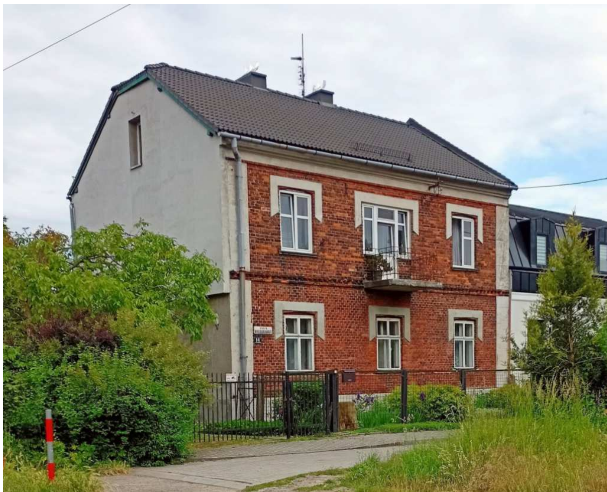
Fot. nr 399. Zapewne około 100-letni podmiejski dom z ulicy Darasza 14, gdzie w parterze zachowały się oryginalne okna typu skrzynkowego.
