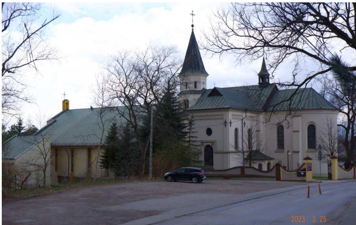
Fot. nr 543. Kompleks dwóch kościołów: parafialny p.w. Narodzenia NMP, w neoromańskim kształcie z końca XIX wieku, nadanym mu przez Karola Knausa, a z lewej przylegająca do niego współcześnie wybudowana nowa świątynia. Przebudowa XVII-wiecznego kościoła parafialnego nastąpiła w latach 1885-86.
