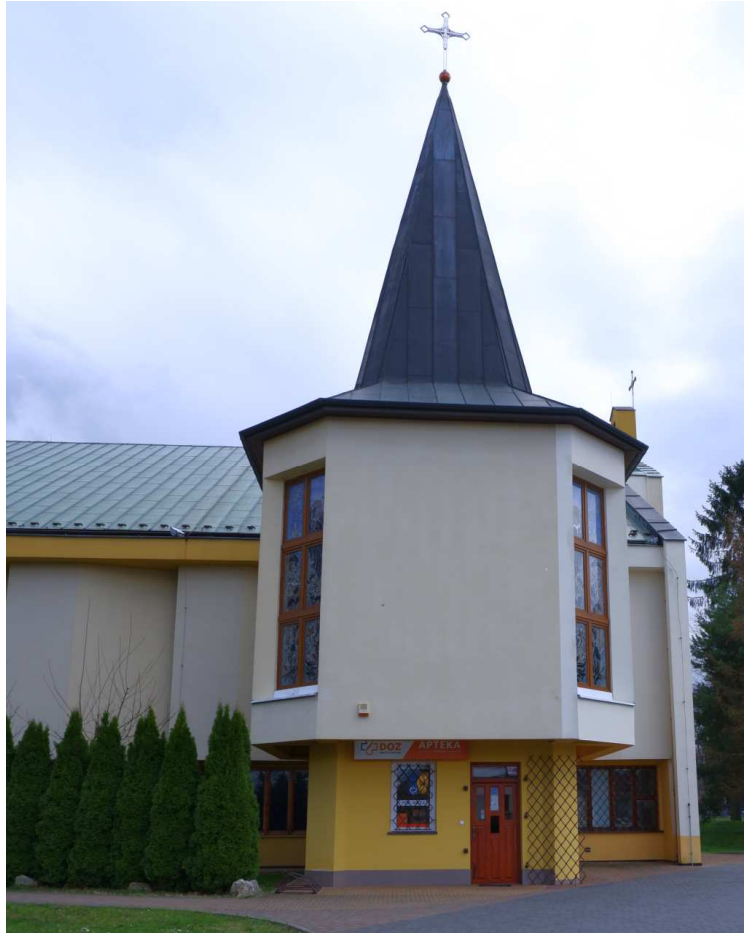
Fot. nr 547. W przyziemiu wieży znalazło się miejsce na.....aptekę. (25.03.2023)
