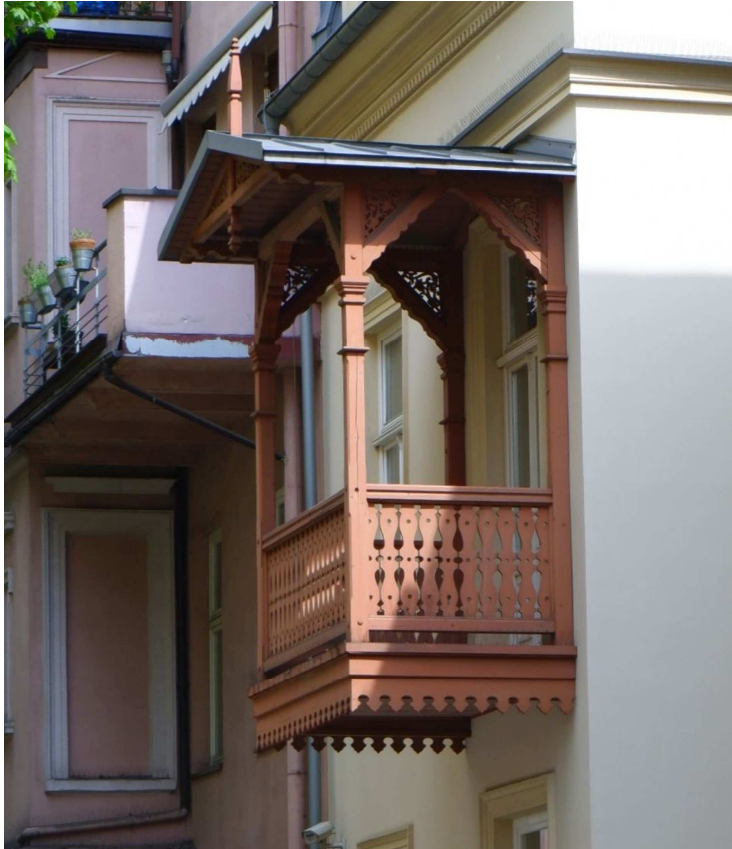
Fot. nr 58. Profilowany w drewnie ganek. (26.04.2023)
