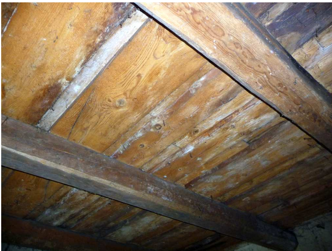
Fot. nr 347 (347-349). Detali w dawnej stajni. Powała. (08.06.2023)
