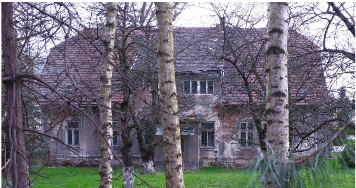
Fot. nr 558. Elewacja od strony ogrodu. (25.03.2023)
