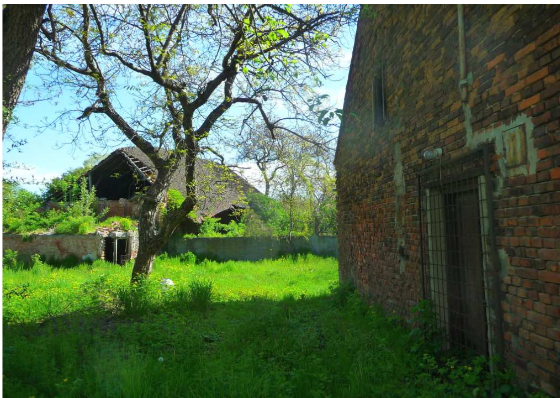
Fot. nr 520 (520-521). Ruina stodoły na tyłach posesji pod nr 6. (11.05.2023)
