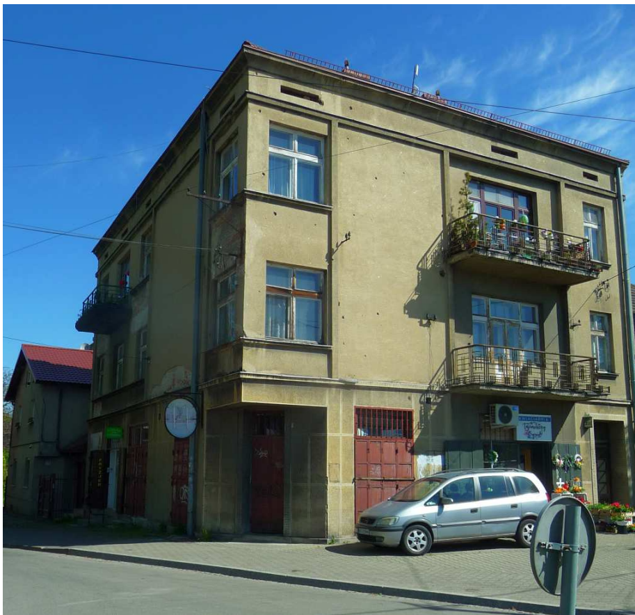
Fot. nr 511. Międzywojenna kamieniczka z ulicy Bieżanowskiej 311. ((11.05.2023
