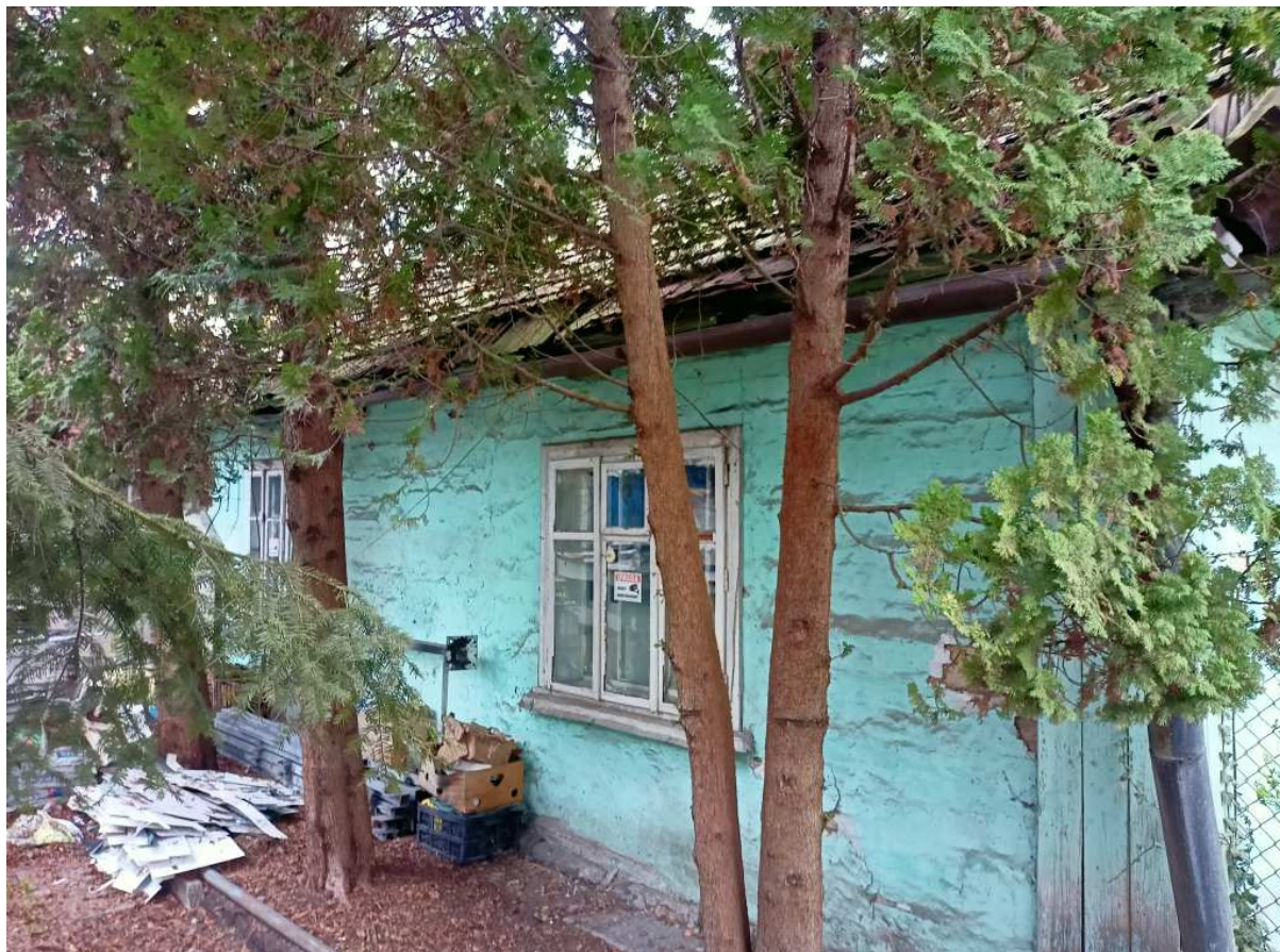
Fot. nr 253 (253-255). Oryginalne okna pierwotnej chałupy od strony podwórka. (20.04.2023)
