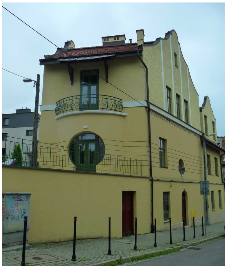
Fot. nr 125 (125-129). Secesyjna willa Podskale z ulicy Podskale 1, wybudowana w roku 1909 wg projektu Antoniego Dostala. Widok z ulicy Podskale. (25.05.2023)
