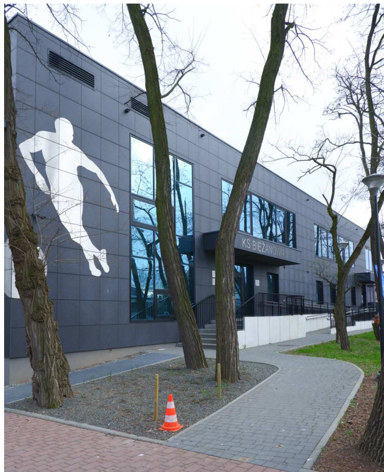
Fot. nr 568. Nowy budynek klubowy. (25.03.2023)
