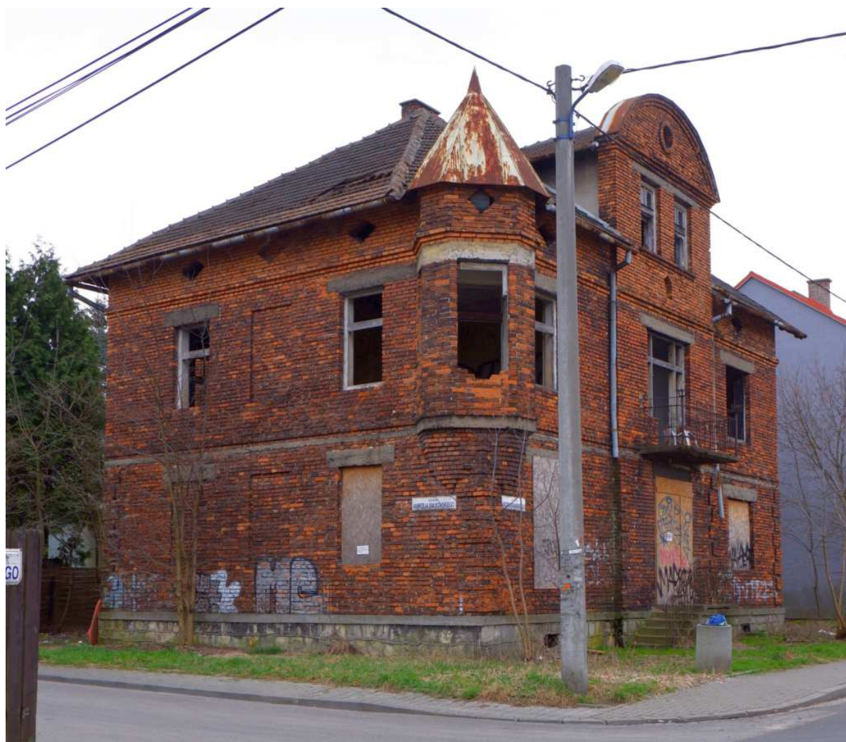
Fot. nr 392 (392-398). Modernistyczna willa z I ćwierci XX wieku z ul. Morawiańskiego 12.
