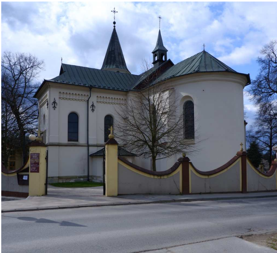
Fot. nr 542. Widok na prezbiterium. (25.03.2023)
