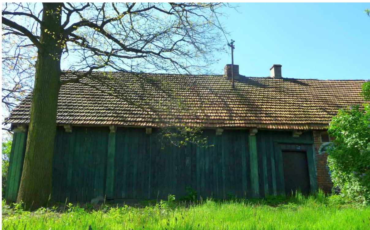
Fot. nr 499 (498-501). Widoki na tylny fragment od strony ulicy. Część mieszkalna. (11.05.2023)
