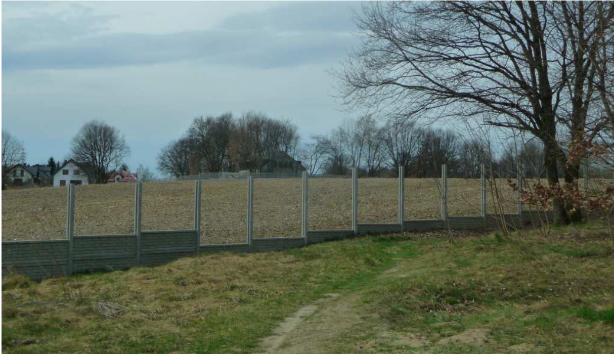
Fot. nr 455 (455-459). Wygradzona Słona Woda i coraz bardziej wyszczerbione ogrodzenie. Widoki od strony ulicy Kostaneckiego. (24.03.2023)
