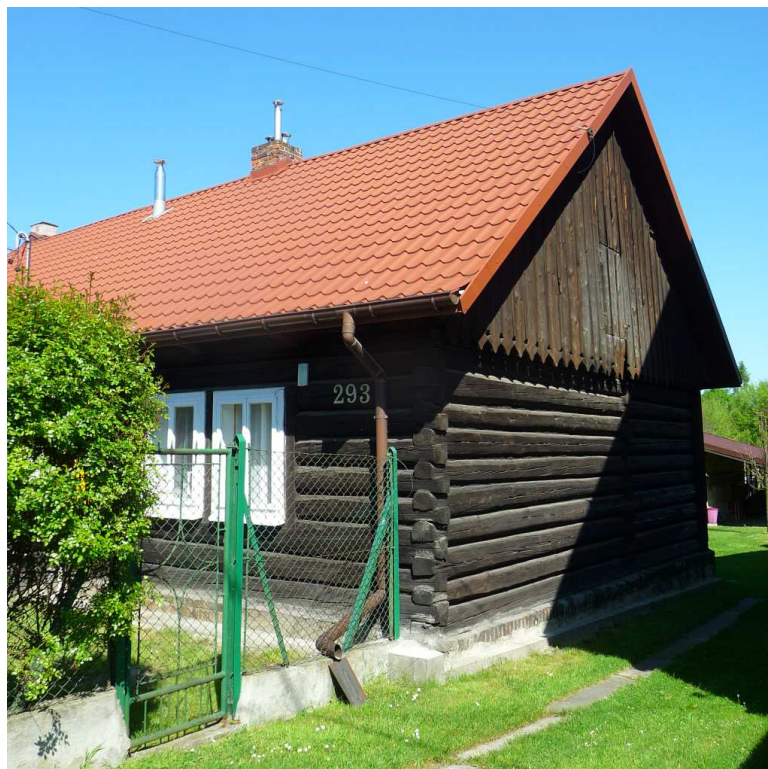
Fot. nr 510. Naroże chałupy o konstrukcji zrębowej. (11.05.2023)
