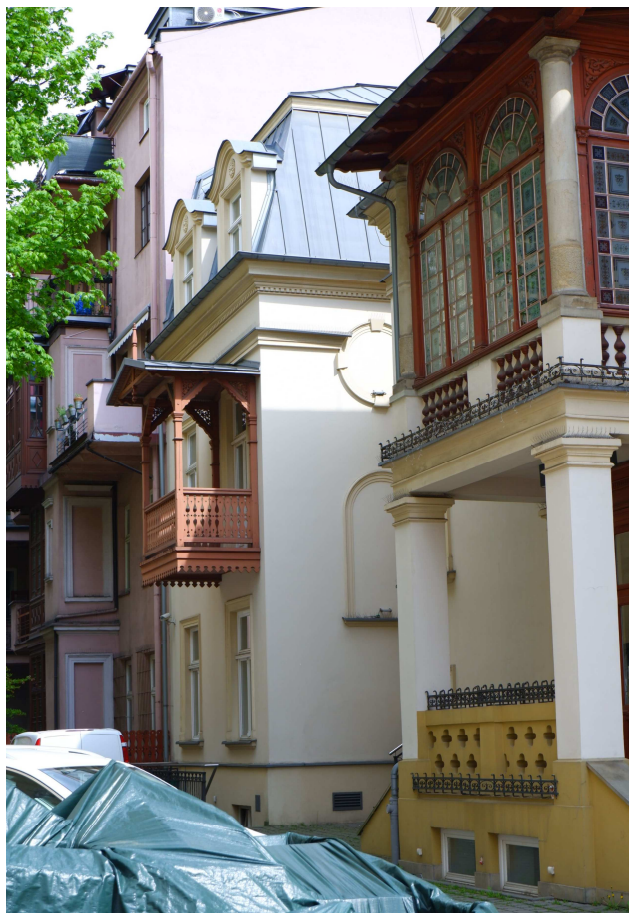
Fot. nr 57 (57-58). Fragment budynku z na tyłach ulicy Bogusławskiego 9. (26.04.2023)
