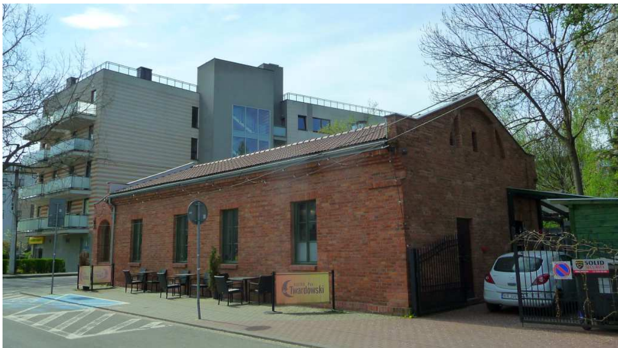
Fot. nr 10. Widok od strony ulicy Szwedzkiej. (24.04.2023)
