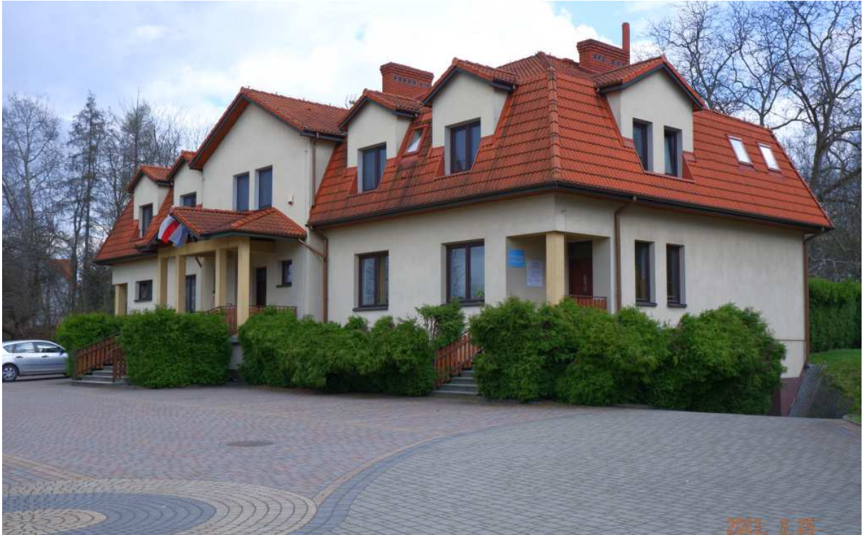
Fot. nr 549. Nowa, murowana plebania, nawiązująca stylistycznie do starego oryginału.
