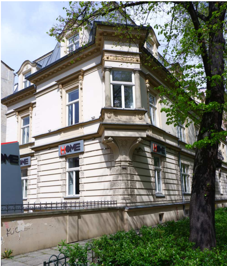
Fot. nr 59. Wykusz w narożu z ulicą św. Sebastiana. (26.04.2023)
