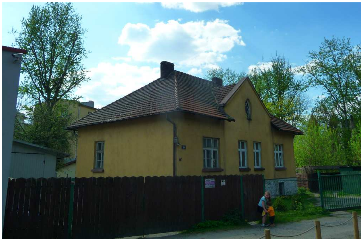
Fot. nr 227 (227-229). Fasada ok. 100-letniego obiektu. (23.04.2023)
