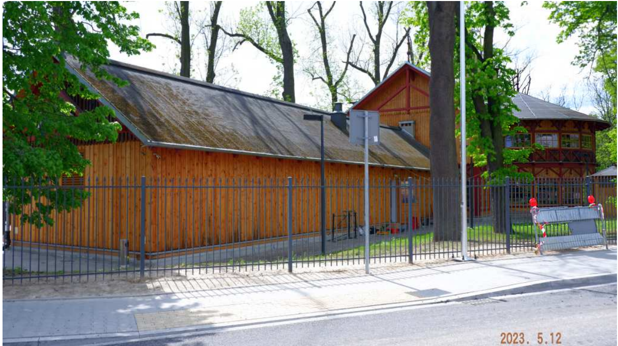
Fot. nr 406 (406-408). Zrekonstruowany, secesyjny fronton dawnej wojskowej strzelnicy przy ulicy Królowej Jadwigi 220, powstałej ok. roku 1900. (406-410).
