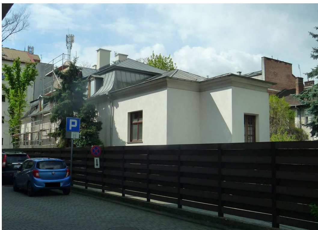
Fot. nr 314 (314-315). Stuletni dom spod nr 120 na etapie remontu. (27.04.2023)
