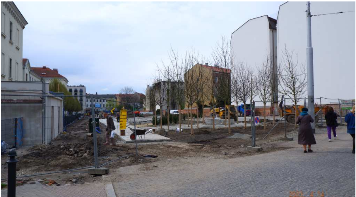
Fot. nr 170 (170-172). Różne fazy budowy Parku Wisławy Szymborskiej.
