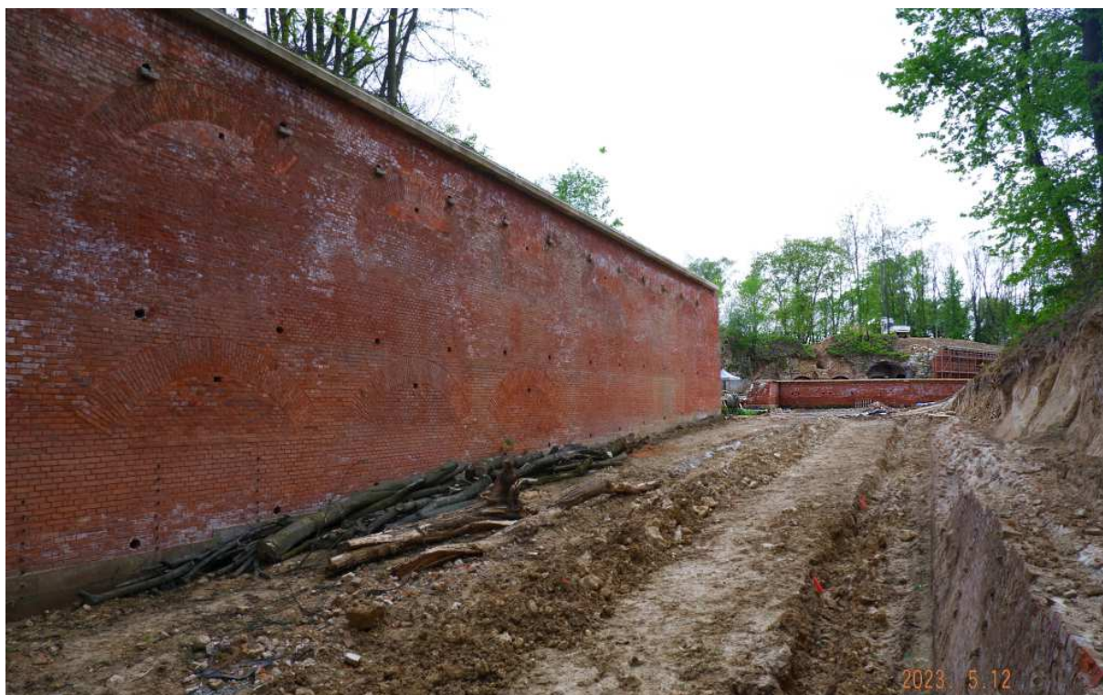
Fot. nr 375 (374-375). Z murami bastionu nr 3 z lewej.
