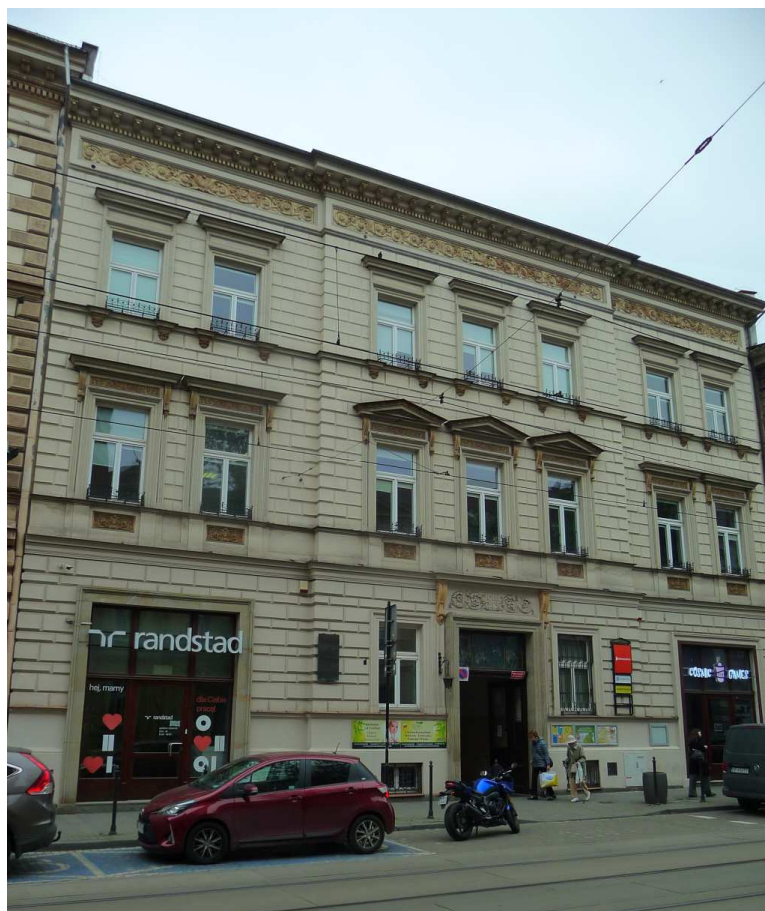
Fot. nr 174. 150-letnia kamienica pod nr 27 autorstwa Filipa Pokutyńskiego. (25.05.2023)
