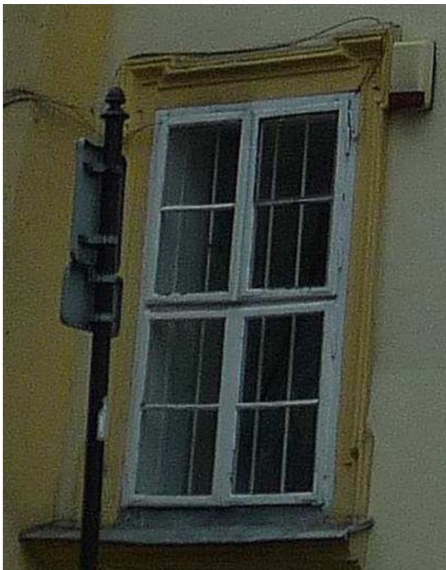
Fot. nr 119 (118-119). Oryginalne okno, typowe dla klasycystycznej zabudowy Krakowa z połowy XIX wieku. (21.03.2023)
