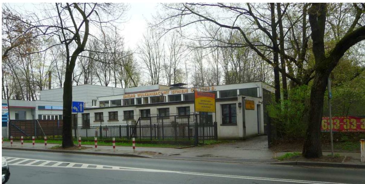
Fot. nr 250. Niski budynek pod nr 93, gdzie od dekad trwa zakład wulkanizacji i wymiany opon. (18.04.2023)
