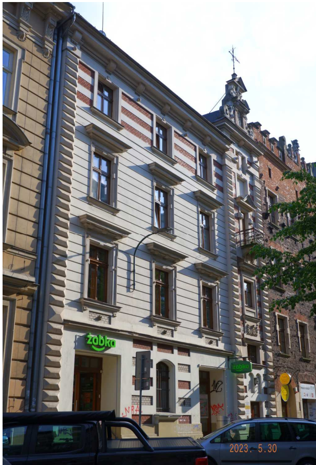
Fot. nr 180 (180-182). Wzdłuż ulicy Batorego. Kamienica nr 26, dzieło T. Talowskiego.
