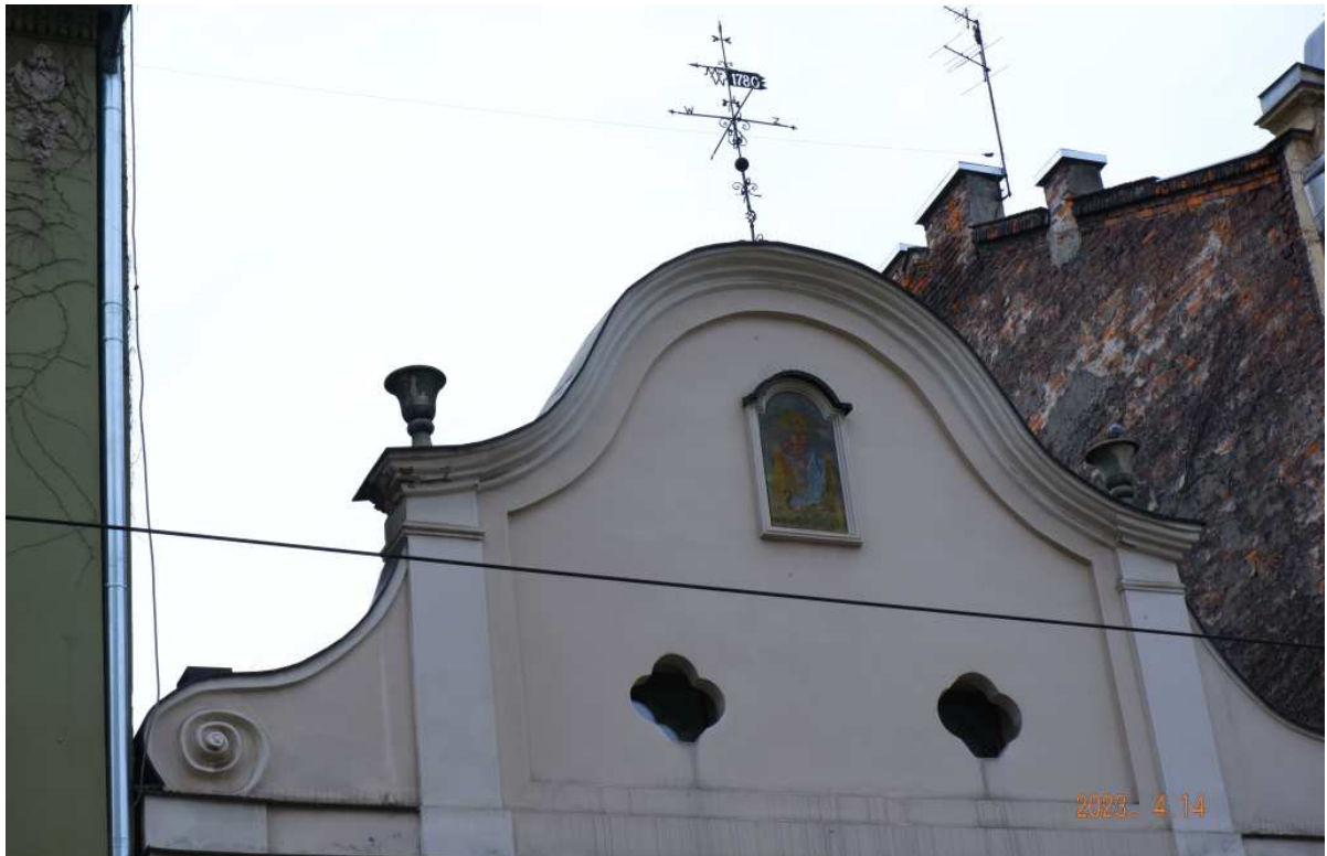
Fot. nr 163 (162-164). Późnobarokowy ratusz Garbar pod nr 12 i jego detale. Zwieńczenie obiektu wybudowanego w roku 1780, o czym informuje zapis na chorągiewce.
