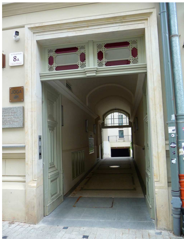
Fot. nr 146. Sień kamienicy pod nr 8. (14.05.2023)
