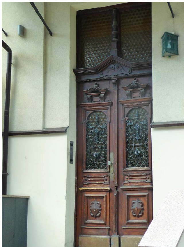
Fot. nr 205. Eklektyczne drzwi kamienicy spod nr 17. (23.04.2023)
