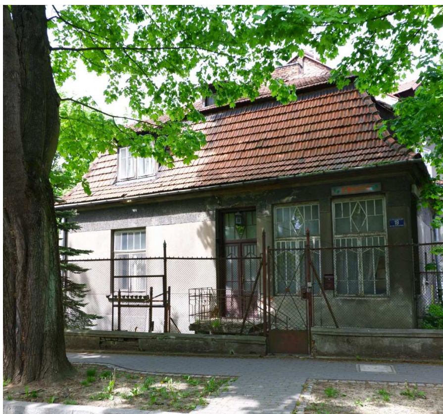
Fot. nr 393. Rzadko spotykane okna w fasadzie willi. (12.05.2023)
