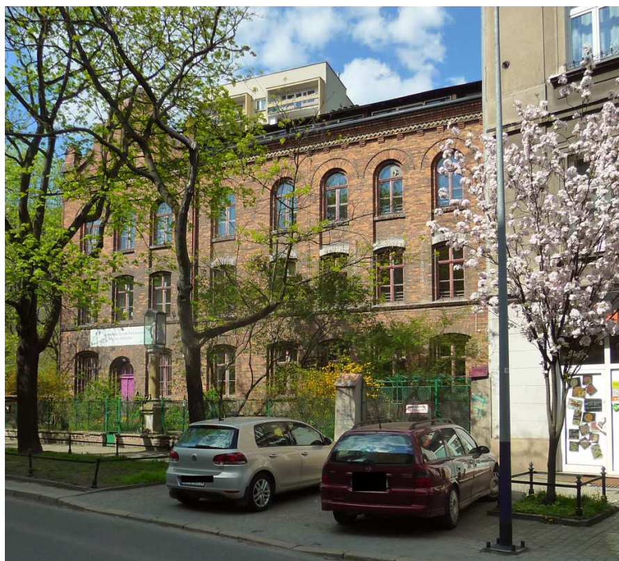
Fot. nr 208 (208-219). Wzdłuż ulicy Kazimierza Wielkiego. Dawna szkoła ludowa pod nr 33z roku 1911; autor projektu (wg GEZ) Kazimierz Hrobni. (23.04.2023)
