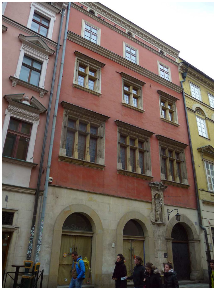
Fot. nr 107 (107-108). Kamienica pod nr 7 i jej detale. (21.03.2023)
