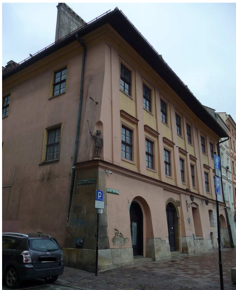
Fot. nr 96 (96-97). Kamienica pod nr 1. (21.03.2023)
