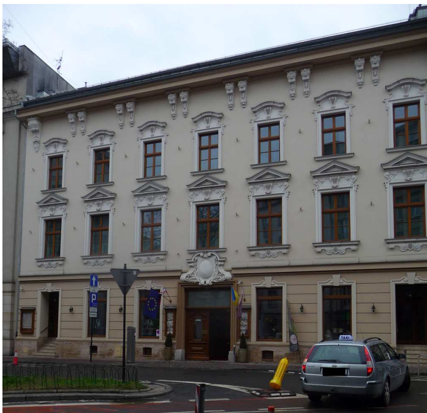
Fot. nr 433. Odnowiona kamienica z ulicy Wielopole 15. (21.03.2023)
