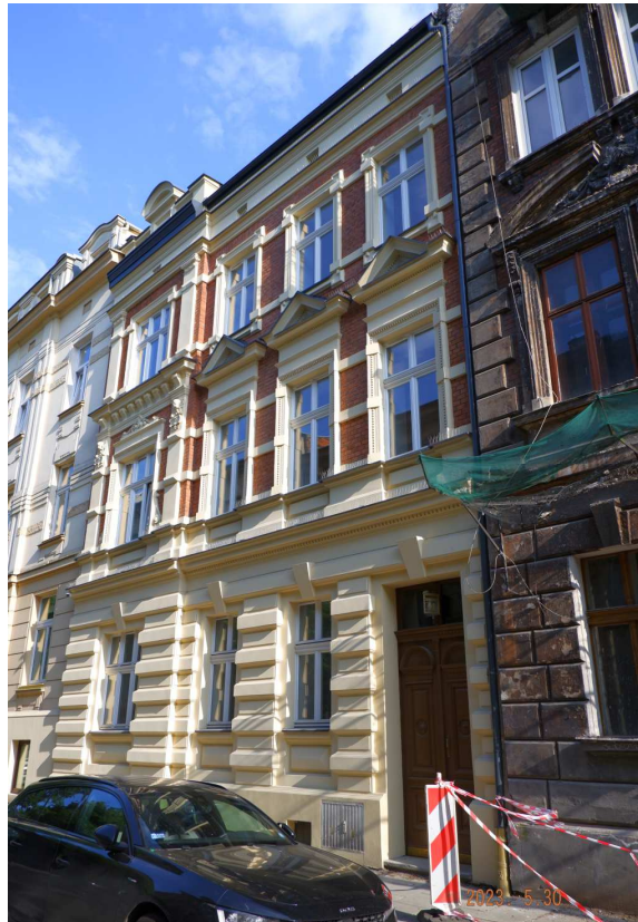
Fot. nr 184 (184-187). Wzdłuż ulicy Siemiradzkiego. Kamienica pod nr 14.
