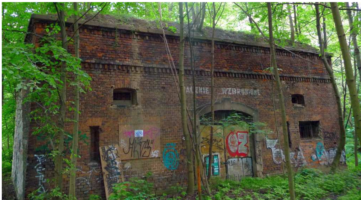
Fot. nr 465. Pozostałości lunety grzegórzeckiej – fortu reditowego nr 17. Jest to oczekujące na rewitalizację jedno z najstarszych dzieł obronnych Twierdzy Kraków, wybudowane w latach 1849-57, które przetrwało w niewielkim fragmencie. (11.06.2023)
