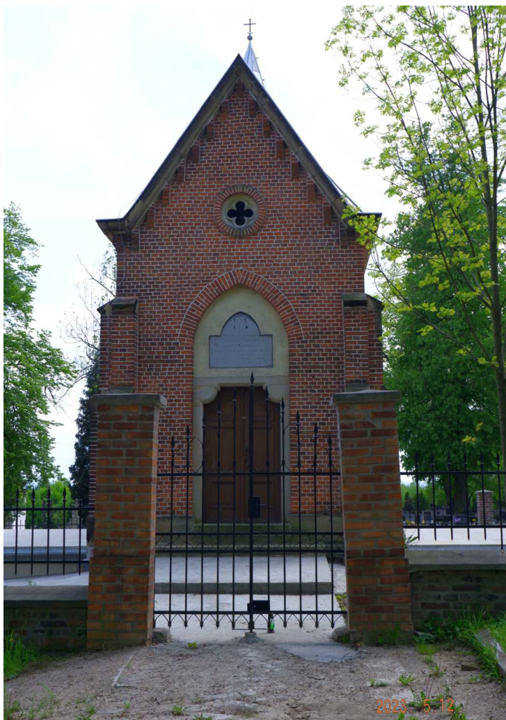
Fot. nr 388. Fasada kaplicy.
