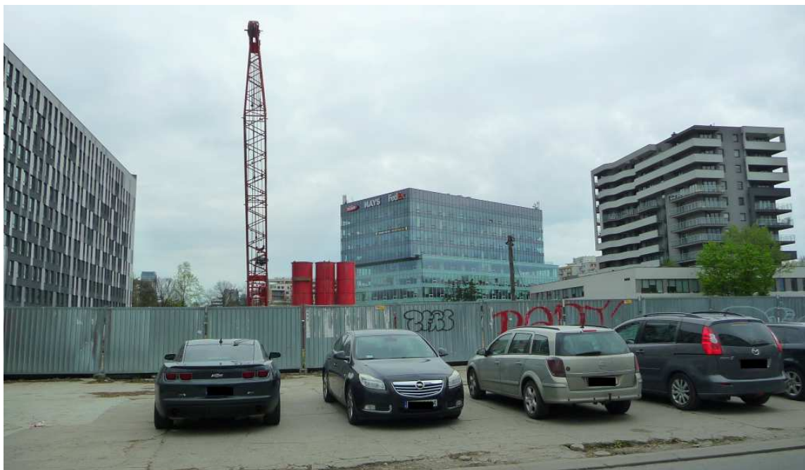
Fot. nr 483. Nowa zabudowa w miejscu dawnego budynku RSW Prasa-Książka Ruch przy alei Pokoju 5 – widok z ulicy Grzegorzeckiej. (29.04.2023)
