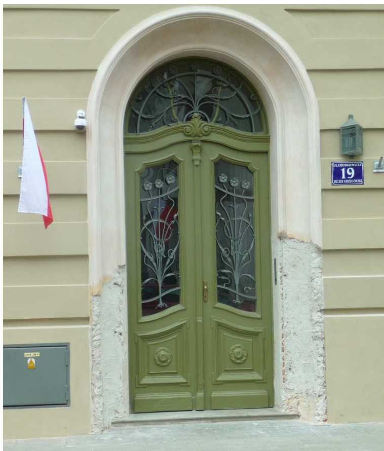
Fot. nr 494 (494-495). Detale kamieniczki spod nr 19, wybudowanej w roku 1907. Secesyjne drzwi. (29.04.2023)
