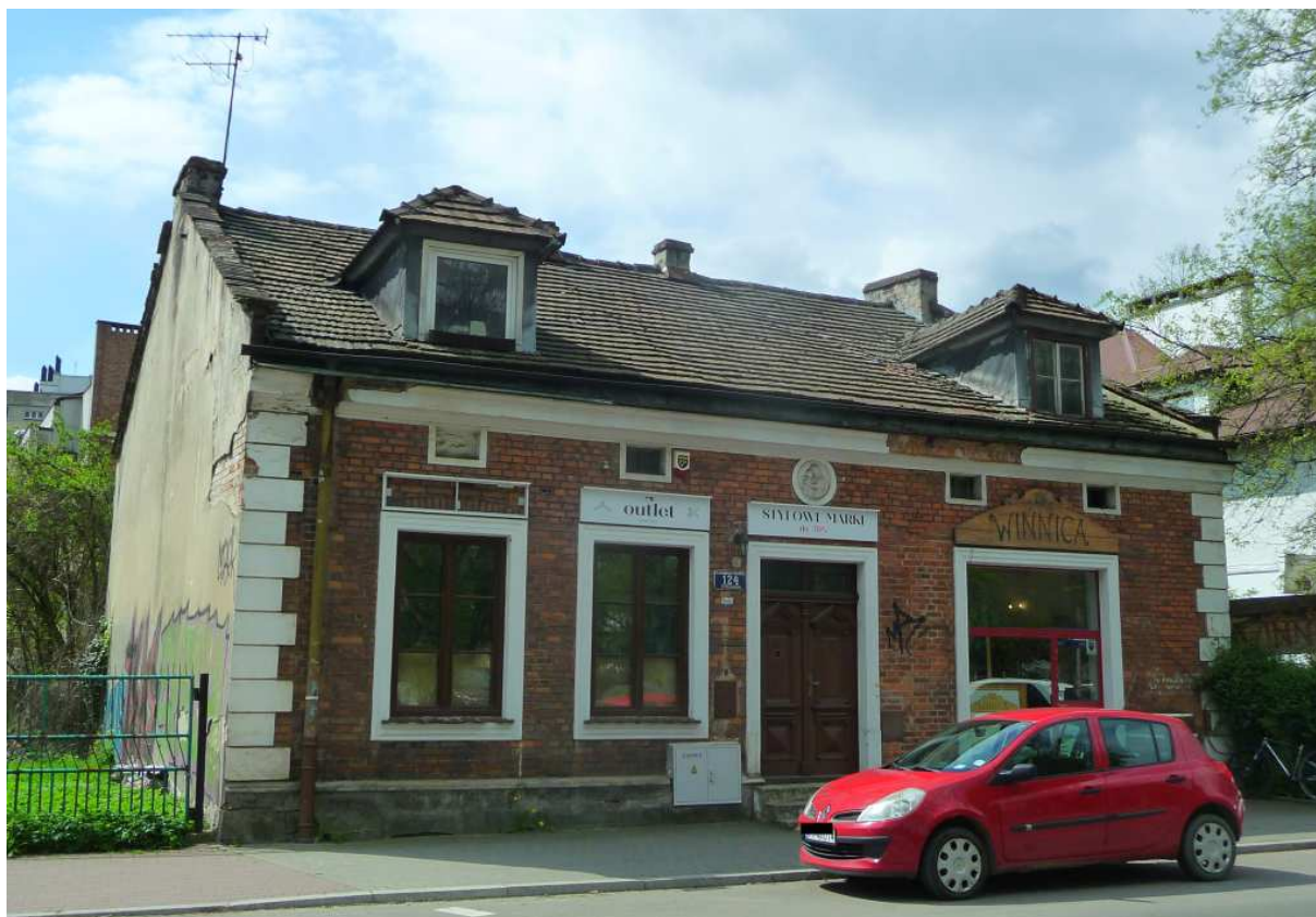
Fot. nr 311 (311-313). Wybudowany pod koniec XIX wieku dom pod nr 124. (27.04.2023)
