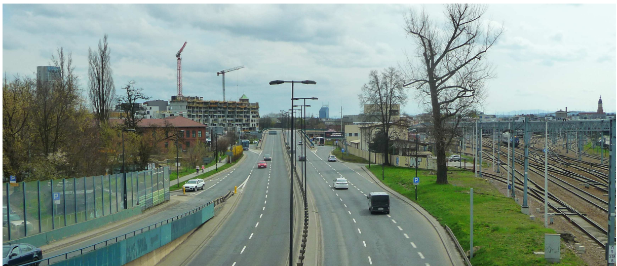
Fot. nr 439. Panorama z wiaduktu nad ulicą Warszawską. Z lewej Olsza, z prawej Wesola. (11.04.2023)
