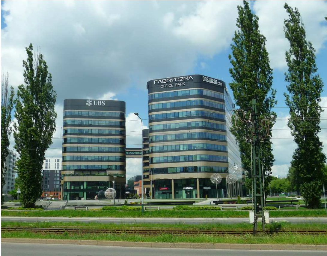
Fot. nr 476 (476-477). Nowo powstałe biurowce przy alei Pokoju 18, w sąsiedztwie wiaduktu kolejowego. (11.06.2023)
