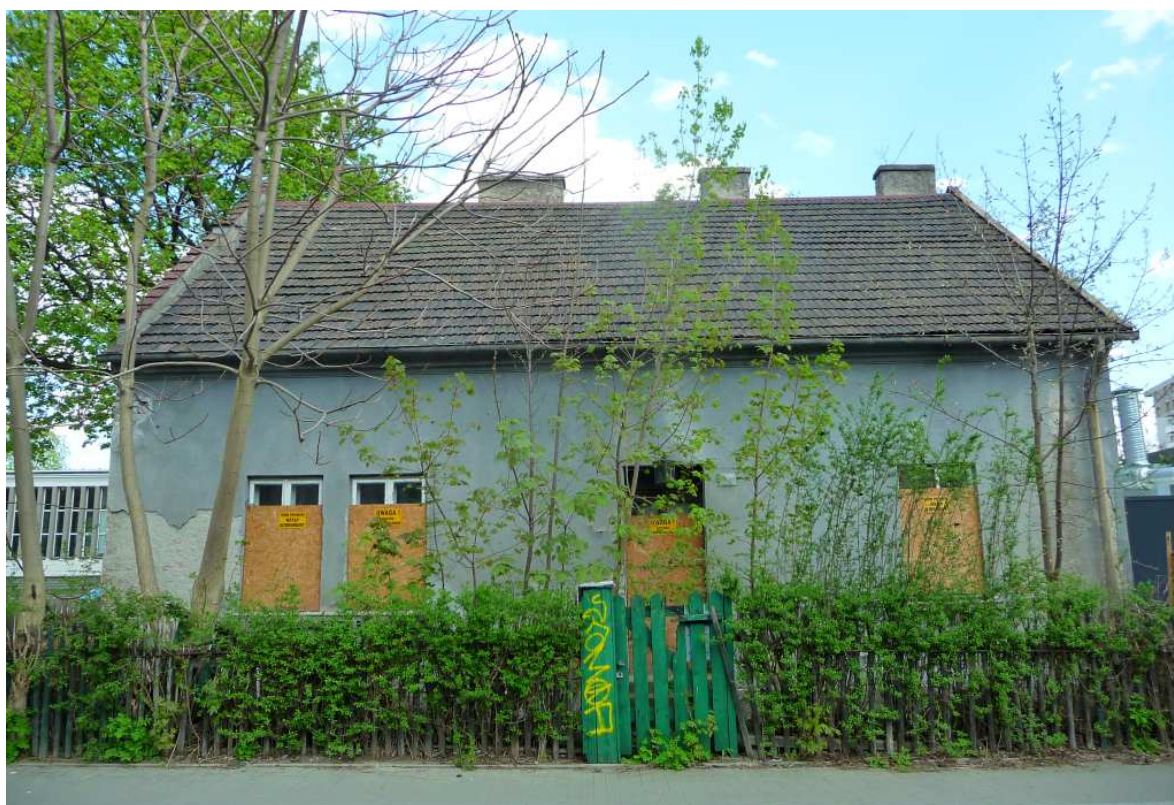
Fot. nr 232. Fasada już z zabitymi deskami oknami typu skrzynekowego. (23.04.2023)
