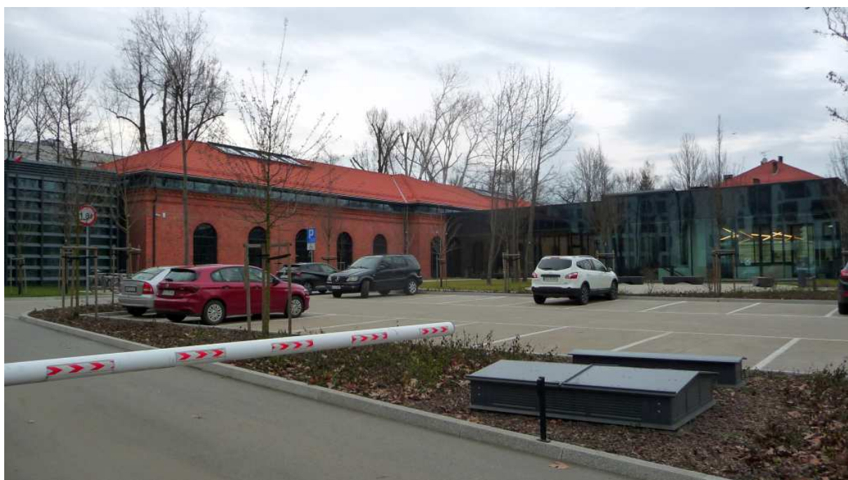
Fot. nr 455. Nowa siedziba Muzeum Fotografii (MuFo) przy ulicy Rakowickiej 22A, która powstała z wykorzystaniem budynku dawnej zbrojowni. (24.03.2023)
