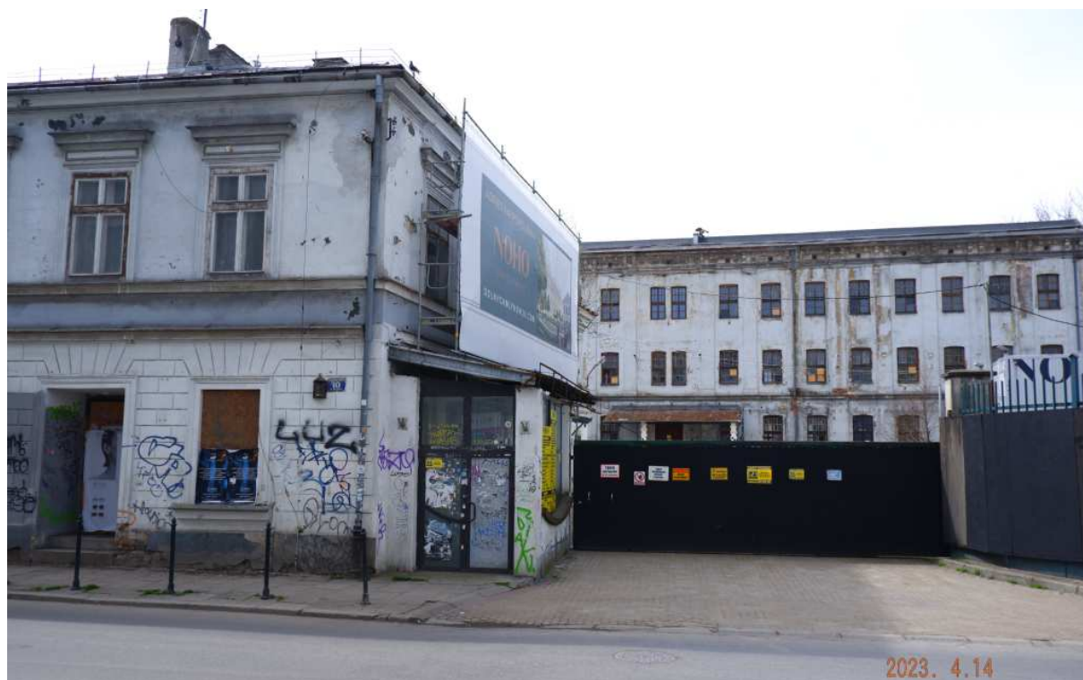
Fot. nr 159. Brama wjazdowa na teren KZT. Jaki los czeka 150-letni kompleks fabryczny?
