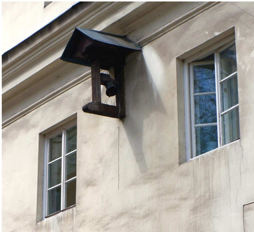
Fot. nr 26. Dzwonek za konających na ścianie klasztoru. (14.04.2023)
