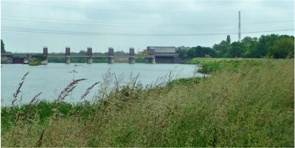
Fot. nr 500. Zapora na Dąbiu w ujęciu od strony Mostu Kotlarskiego. (08.06.2023)
