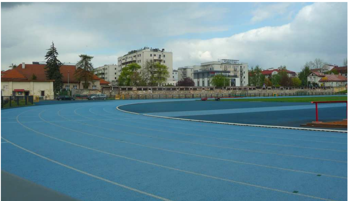
Fot. nr 292 (292-295). Stadion WKS Wawel już bez niedawno rozebranej drewnianej trybuny od strony ulicy Głowackiego. (27.04.2023)
