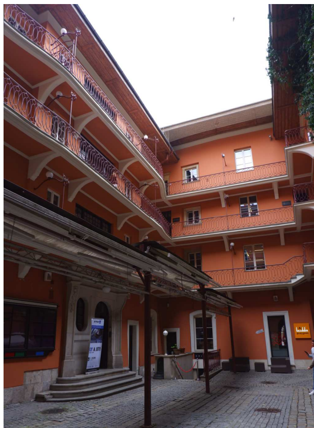
Fot. nr 58. Na dziedzińcu. (14.04.2023)
