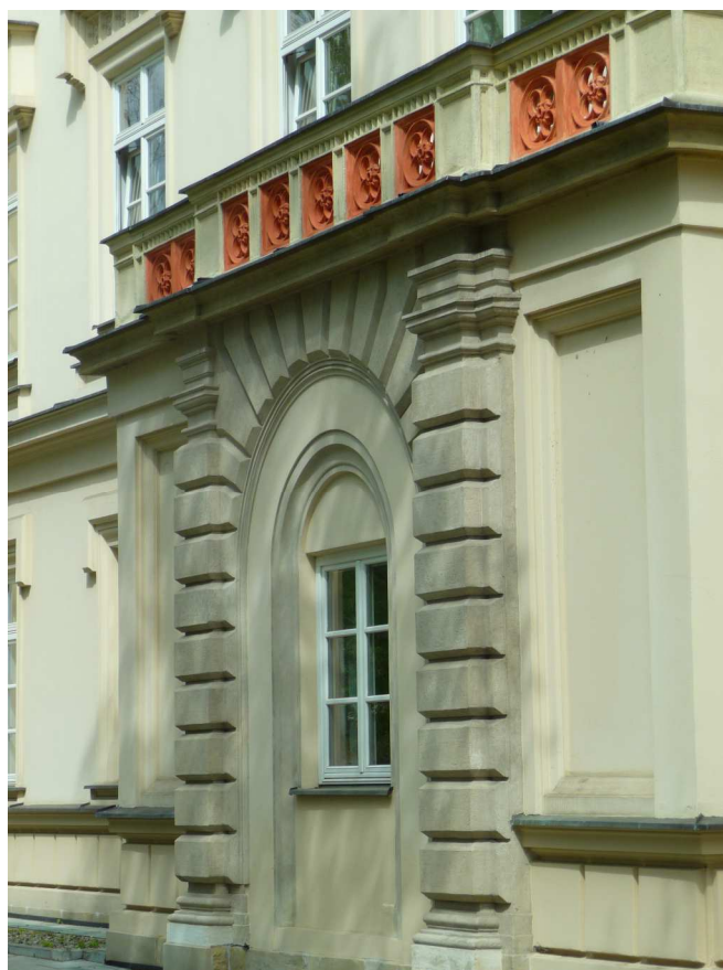
Fot. nr 300. Lewy wykusz z wykorzystaniem boniowanego portalu pałacu. (27.04.2023)
