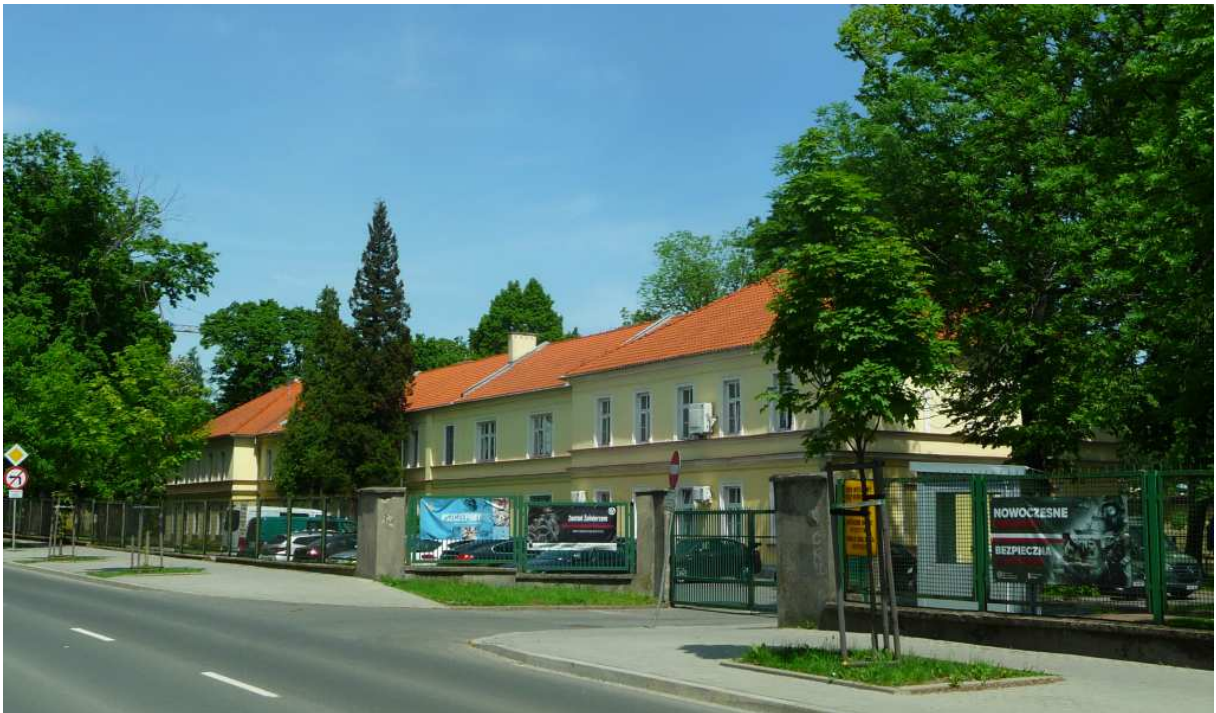
Fot. nr 284 (284-285). Budynek kompleksu koszar przy ulicy Głowackiego 11. (22.05.2023)
