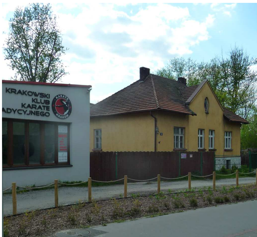
Fot. nr 226 (226-229). Willa przy Młynówce Królewskiej z ul. Grottgera 66. (23.04.2023)
