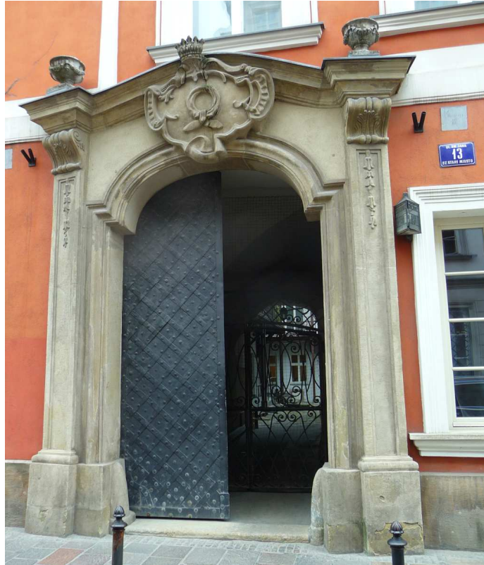
Fot. nr 17. Portal w pałacu Chwalibogowskich z ulicy św. Jana 13. (25.05.2023)
