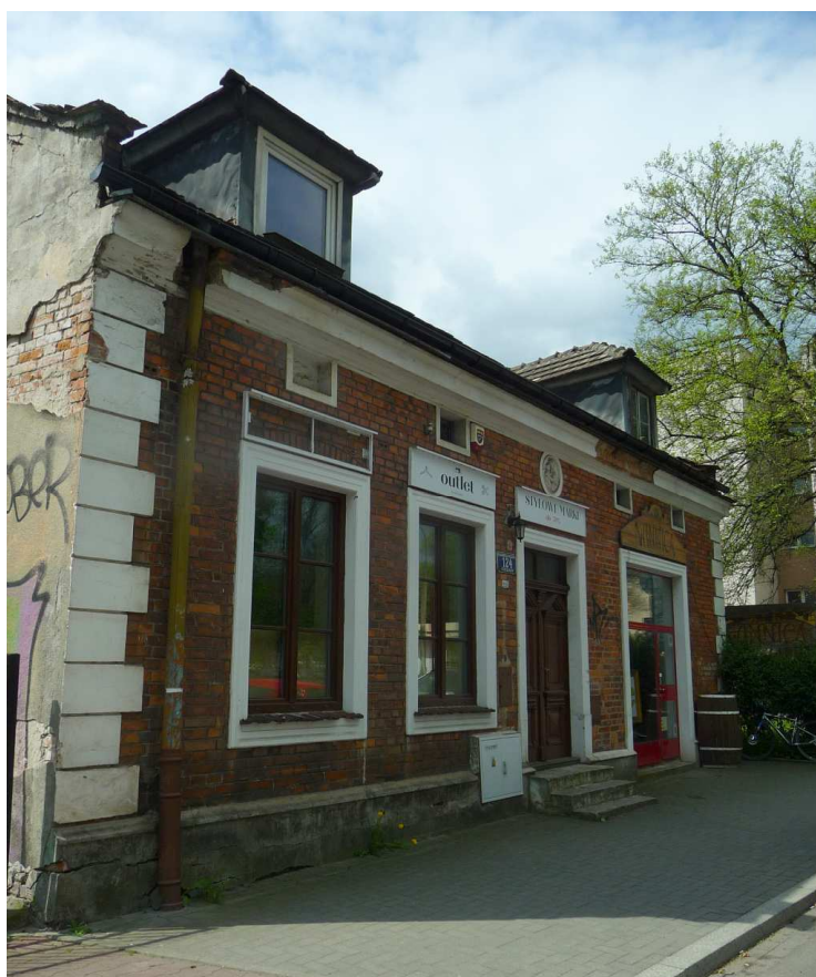
Fot. nr 312. Fasada domu z nowymi oknami. (27.04.2023)
