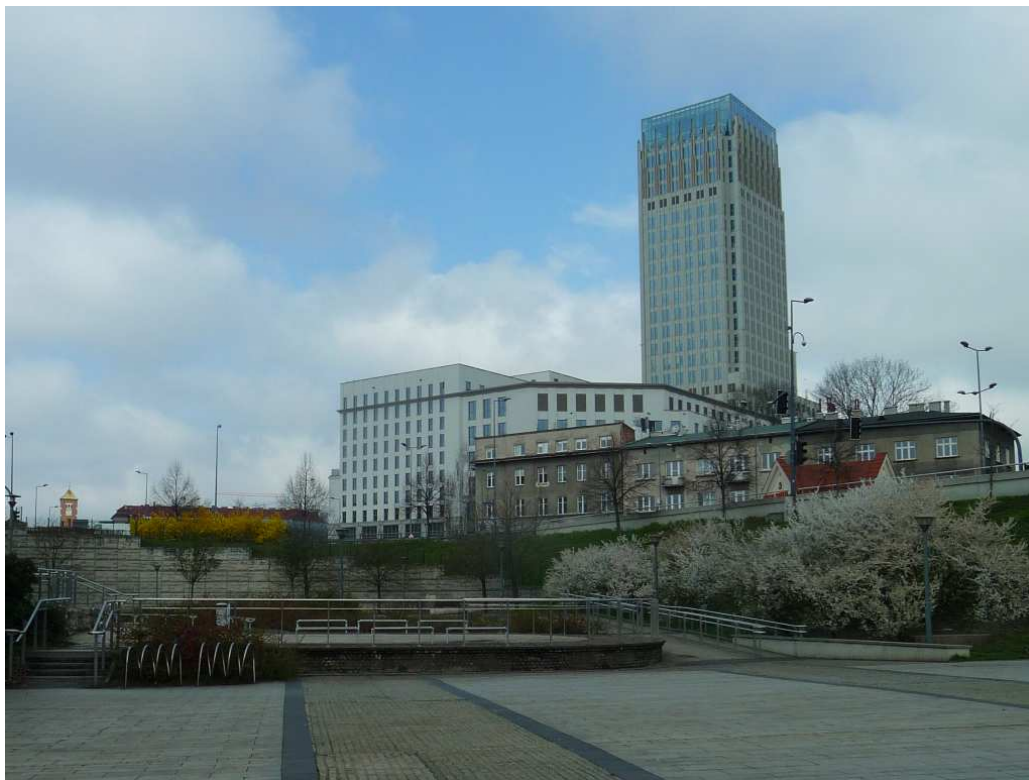
Fot. nr 458 (458-460). Obudowany nowymi blokami „szkieletor”. Widok spod ruin fortu mogilskiego. (08.04.2023)
