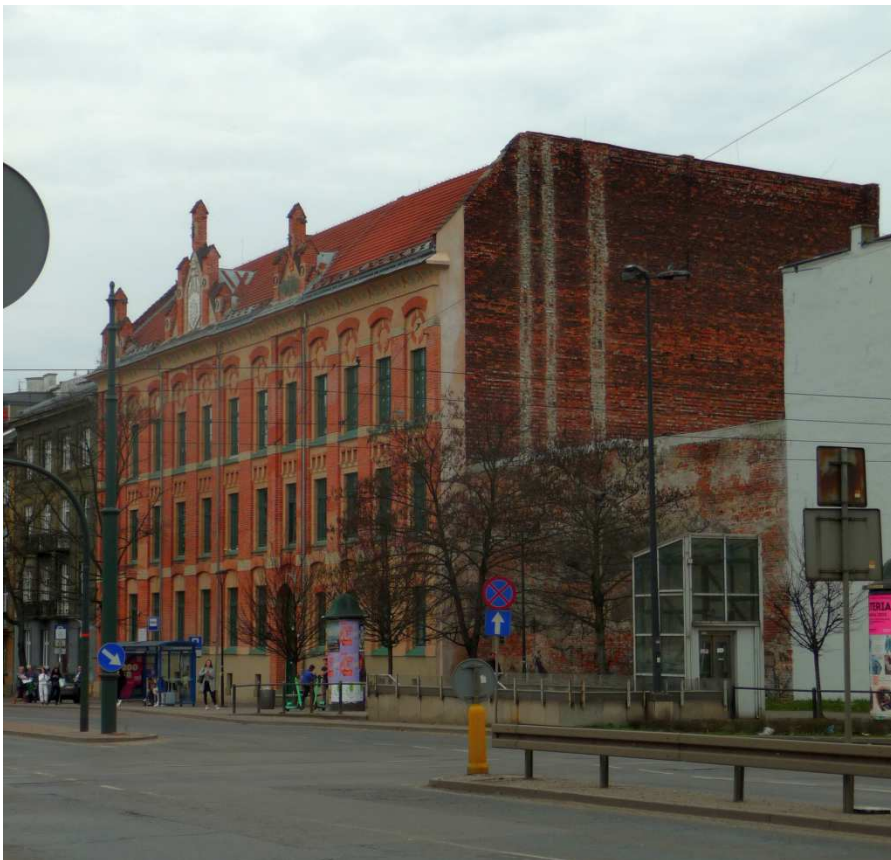
Fot. nr 441. Budynek szkolny spod nr 19 z I. dekady XX wieku, dzieło Jana Zawiejskiego. (24.03.2023)
