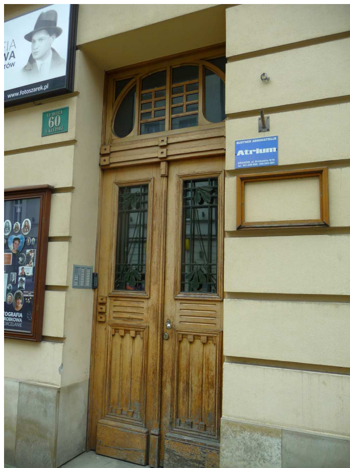
Fot. nr 450. Secesyjne drzwi kamienicy z ulicy Długiej 60. (25.05.2023)
