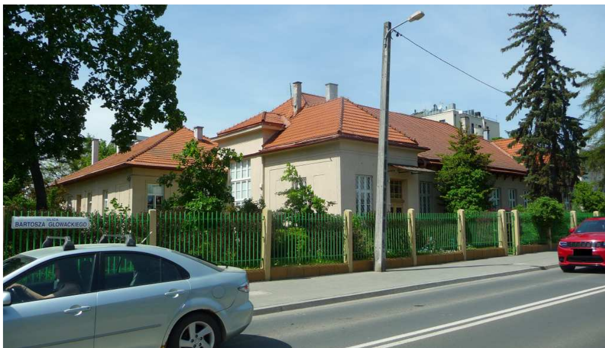
Fot. nr 288. Zapewne przedwojenny budynek przedszkolny z ulicy Głowackiego 2, w narożu z ulicą Bronowicką 1. (22.05.2023)
