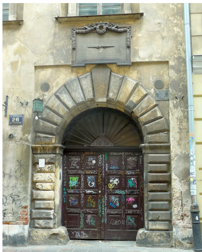
Fot. nr 88 (88-89). Renesansowy portal kamienicy pod nr 26. (25.05.2023)
