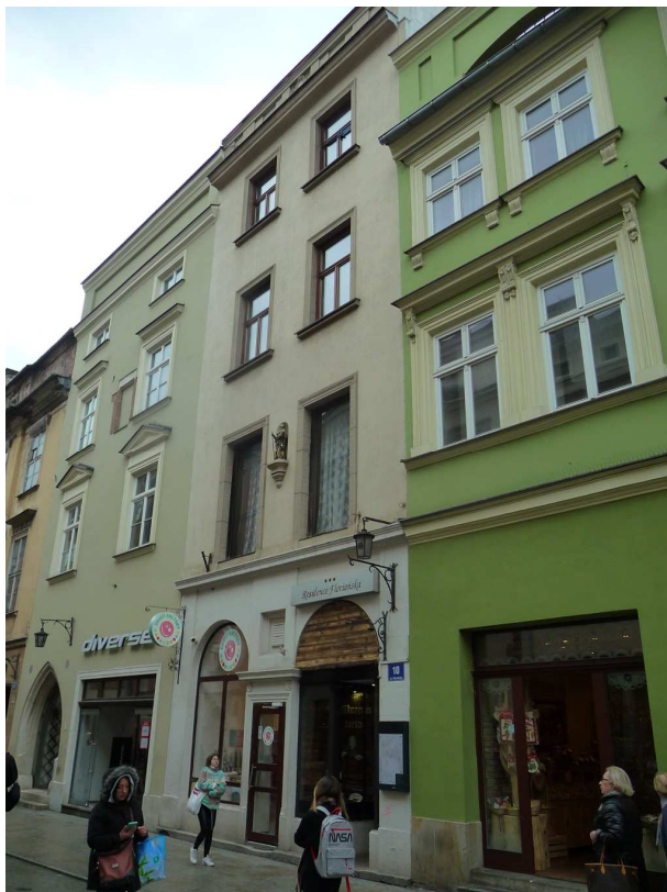
Fot. nr 105 (105-106). Kamienica pod nr 10 i jej detale. (21.03.2023)
