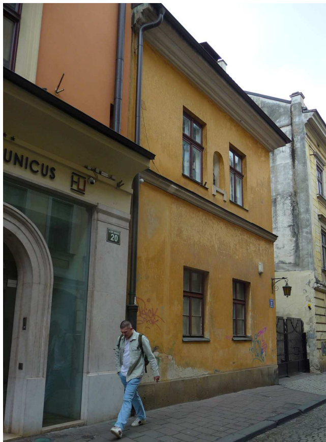
Fot. nr 112 (112-113). Klimatyczna kamieniczka pod nr 22. (21.03.2023)
