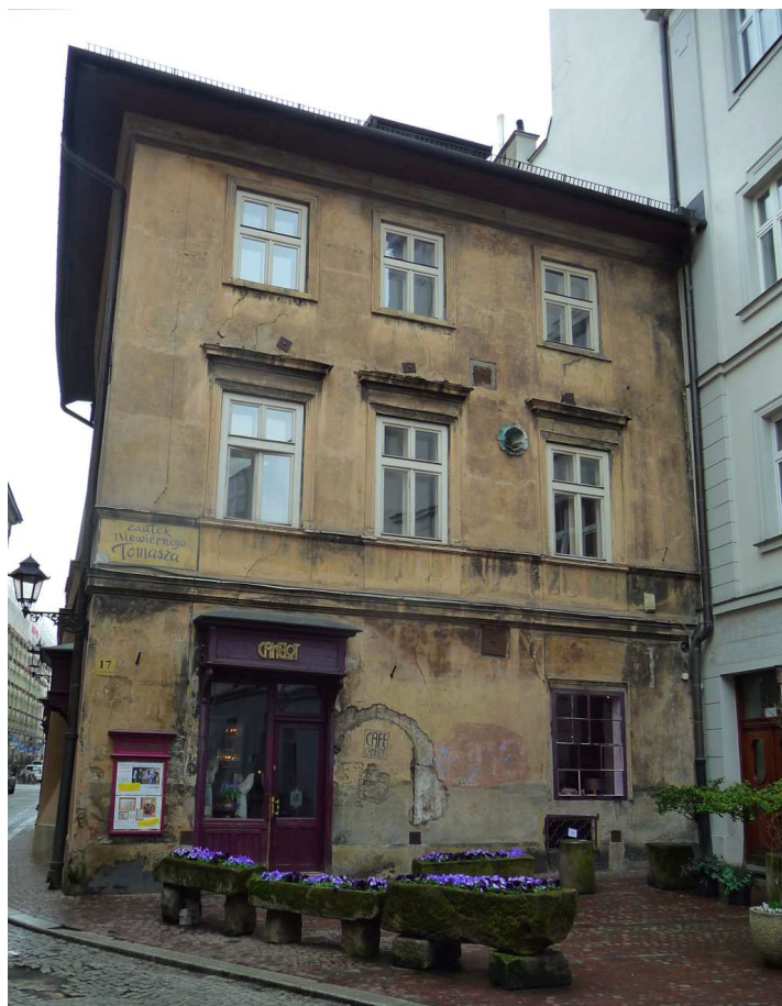
Fot. nr 103. Zaulek św. Tomasza i kawiarnia Loch Camelot. (21.03.2023)
