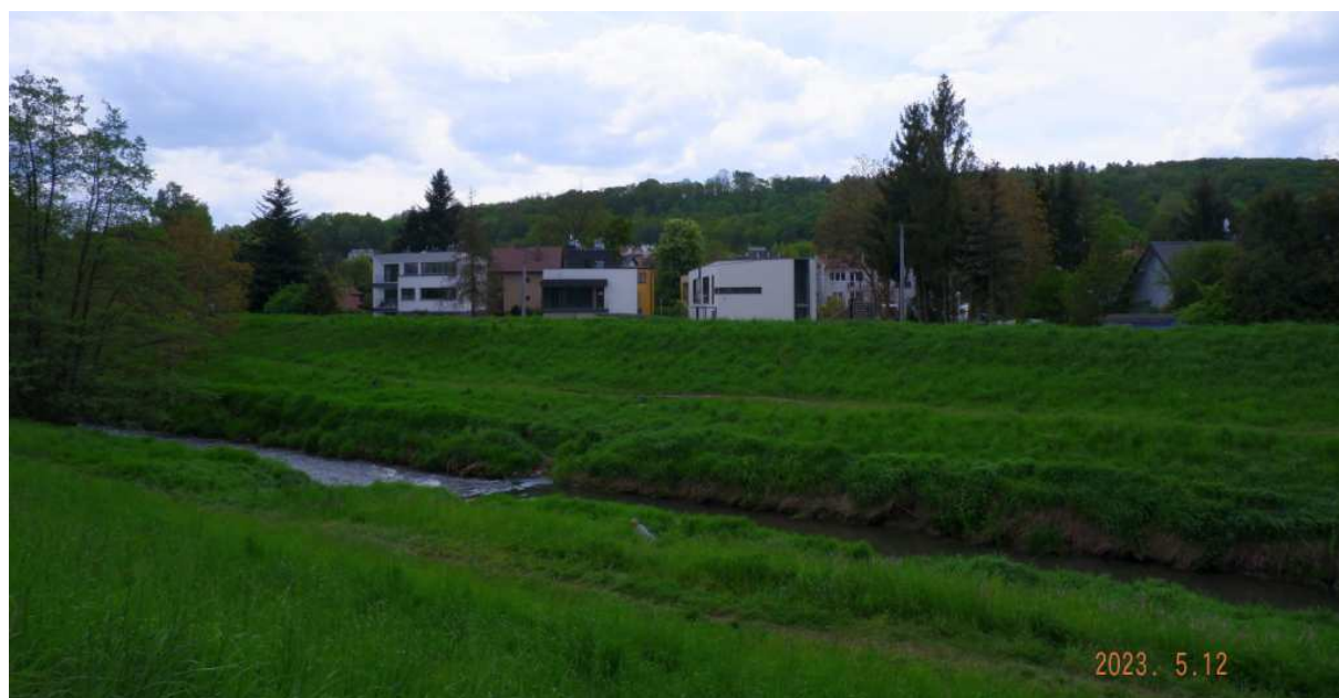
Fot. nr 368 (368-370). Nowa zabudowa zwierzynieckiego nadbrzeża Rudawy w rejonie ulic: Borowego i Pększyca-Grudzińskiego.
