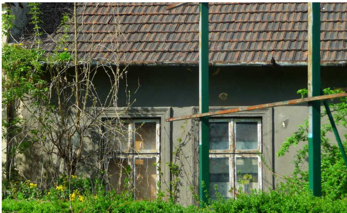
Fot. nr 247. Okna typu skrzynkowego w domu pod nr 45. (23.04.2023)
