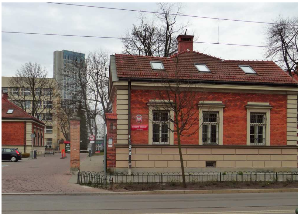
Fot. nr 460. Widok z ulicy Rakowickiej spod budynku UE. (24.03.2023)
