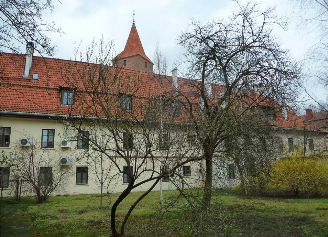
Fot. nr 117. Tył domu z kompleksu duchackiego z placu św. Ducha 3. (21.03.2023)
