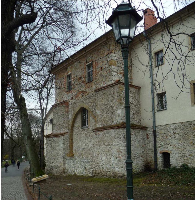
Fot. nr 123 (123-125). Przedbramie dawnej Bramy Rzeźniczej w murach klasztoru Dominikanek na Gródku. (21.03.2023)
