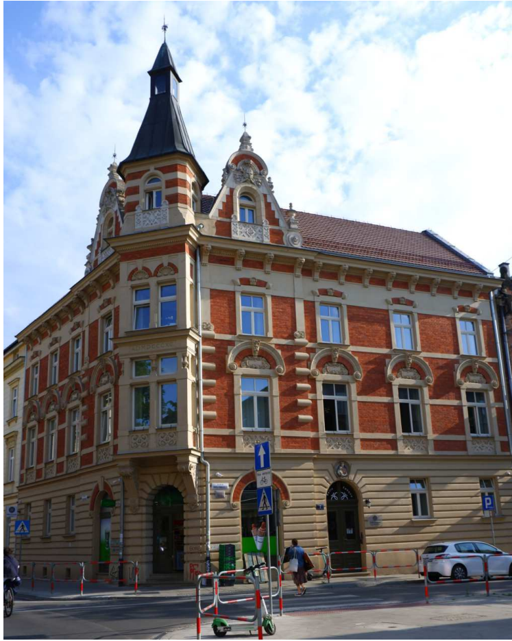
Fot. nr 187. Eklektyczna kamienica (nr 2), dzieło Jana Zawiejskiego (1891). (30.05.2023)
