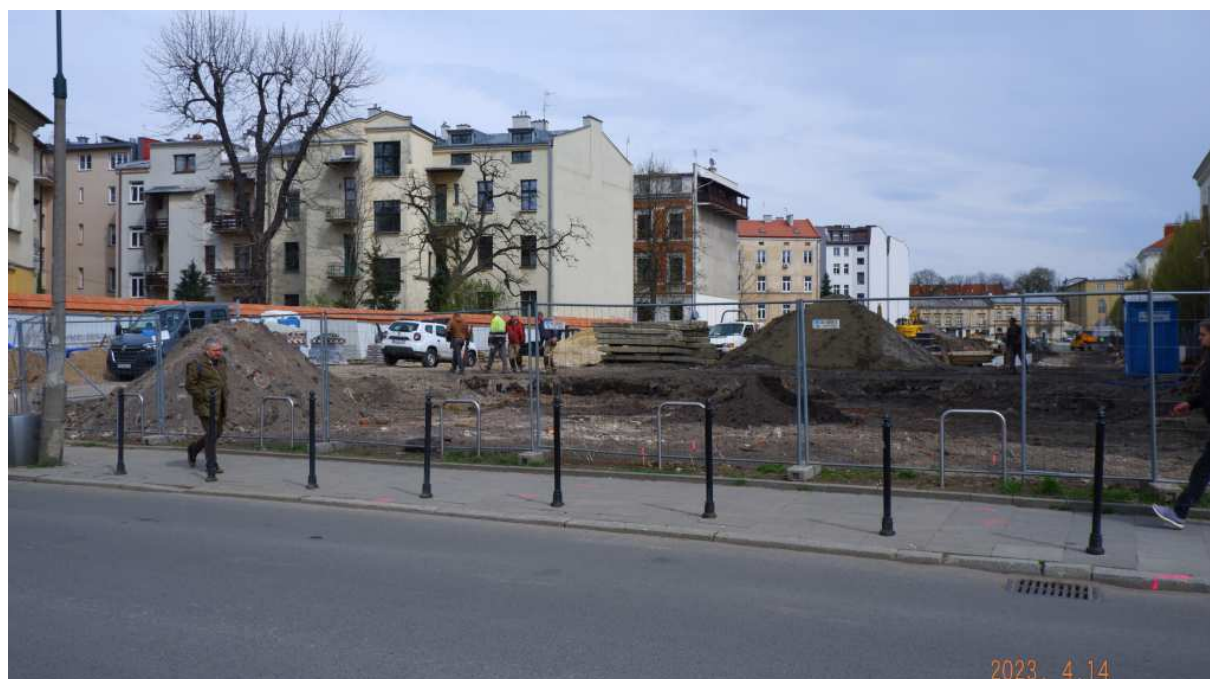
Fot. nr 160. Prace ziemne przy nowo powstającym Parku Wisławy Szymborskiej.
