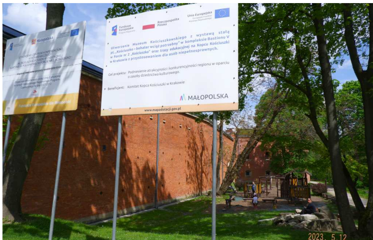
Fot. nr 384. W stronę bastionu nr 5.
