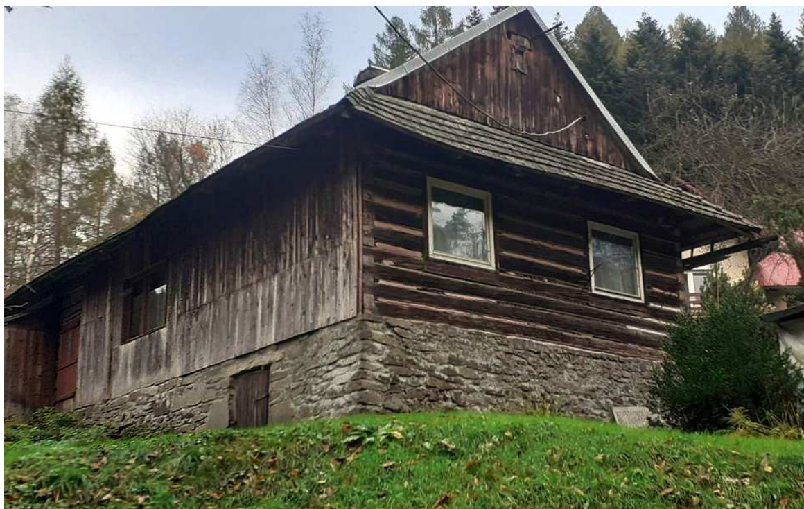
Fot. nr 361. Ściana szczytowa. (01.11.2020)
