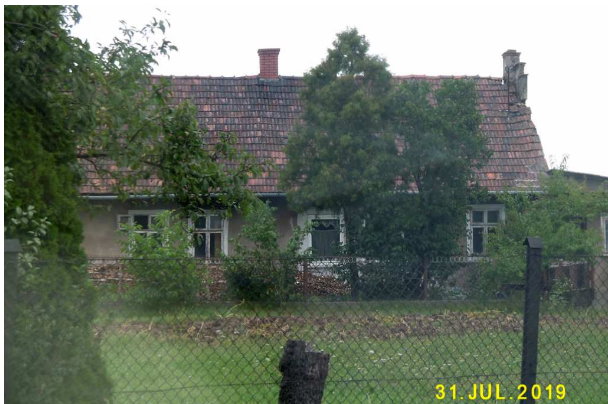
Fot. nr 137 (137-138). Oryginalny jeszcze, zapewne ok. 90-letni dom pod nr 160. Zdjęcie wykonane z jadącego samochodu.
