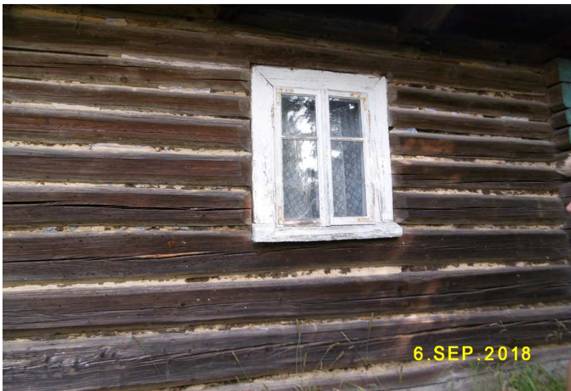
Fot. nr 195 (195-196). Belkowana faktura z wypełnieniami i oryginalne okno.
