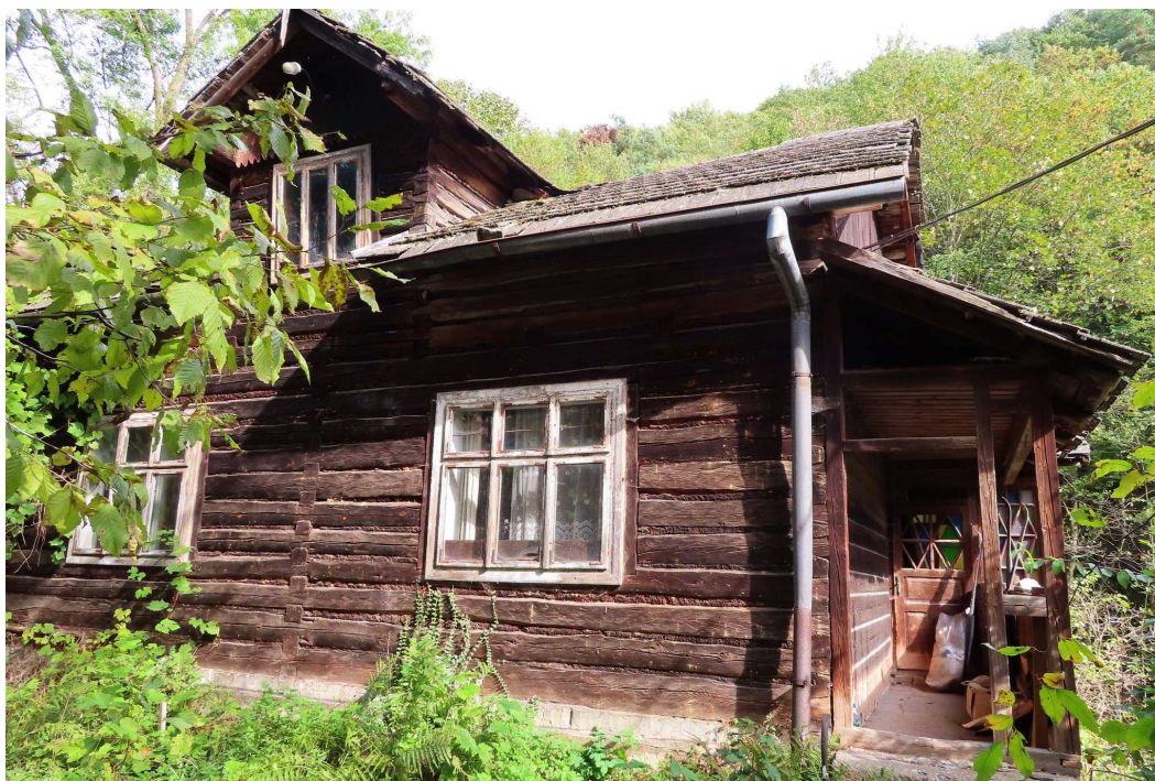
Fot. nr 377 (377-382). Fot. Ewa Skoplak. Przedwojenny dom z Paczółtowiec, zlokalizowany przy końcu doliny Raclawki. Obiekt drewniany, uszczelniany warkoczami ze słomy, z facjatą i oknami typu weneckiego. Częściowo odkryty przedsionek jest zamknięty pomieszczeniem zdobionym mozaiką z kolorowych szybek. (15.10.2023)
