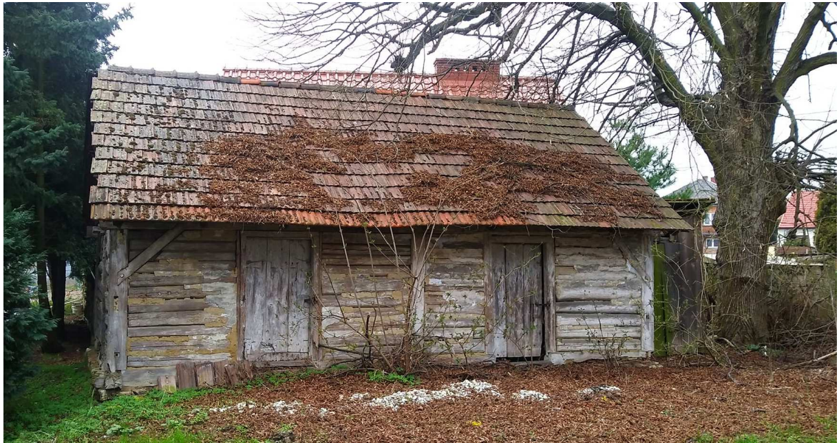
Fot. nr 383 (383-388). Zapewne jeszcze XIX-wieczny budynek gospodarczy, kiedyś zapewne bielony. Widać pozostałości wypełnienia między belkami gliną.
