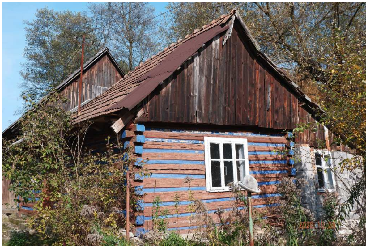
Fot. nr 103 (102-103). Ściana szczytowa i dobudowany do niej z pustaków tylny fragment.
