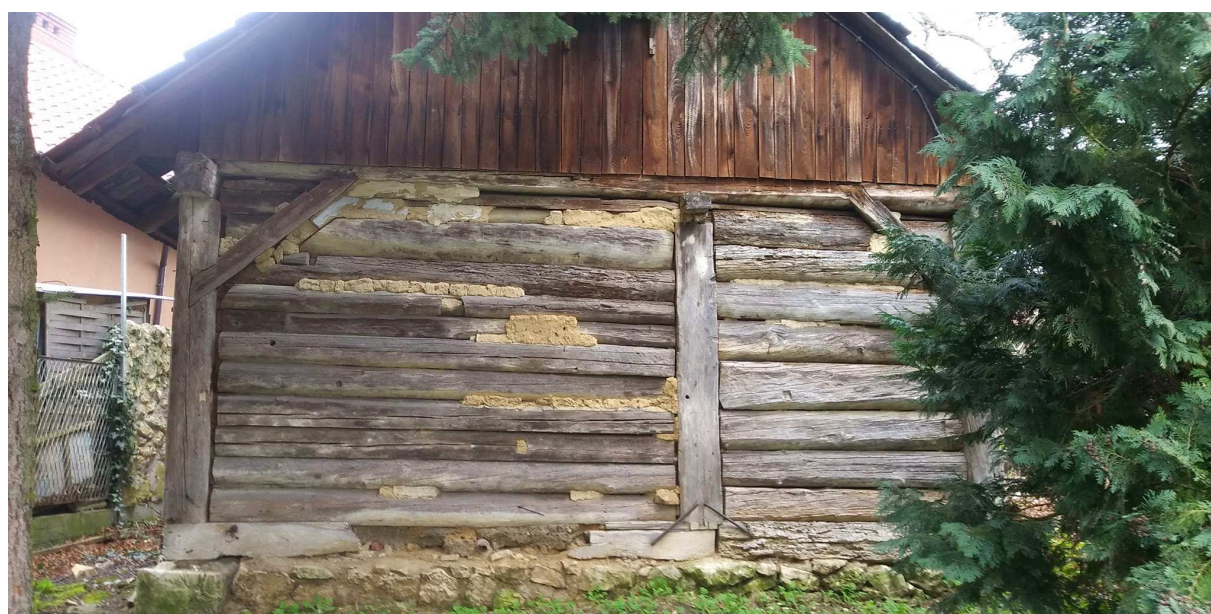
Fot. nr 386. Lewa boczna ściana.
