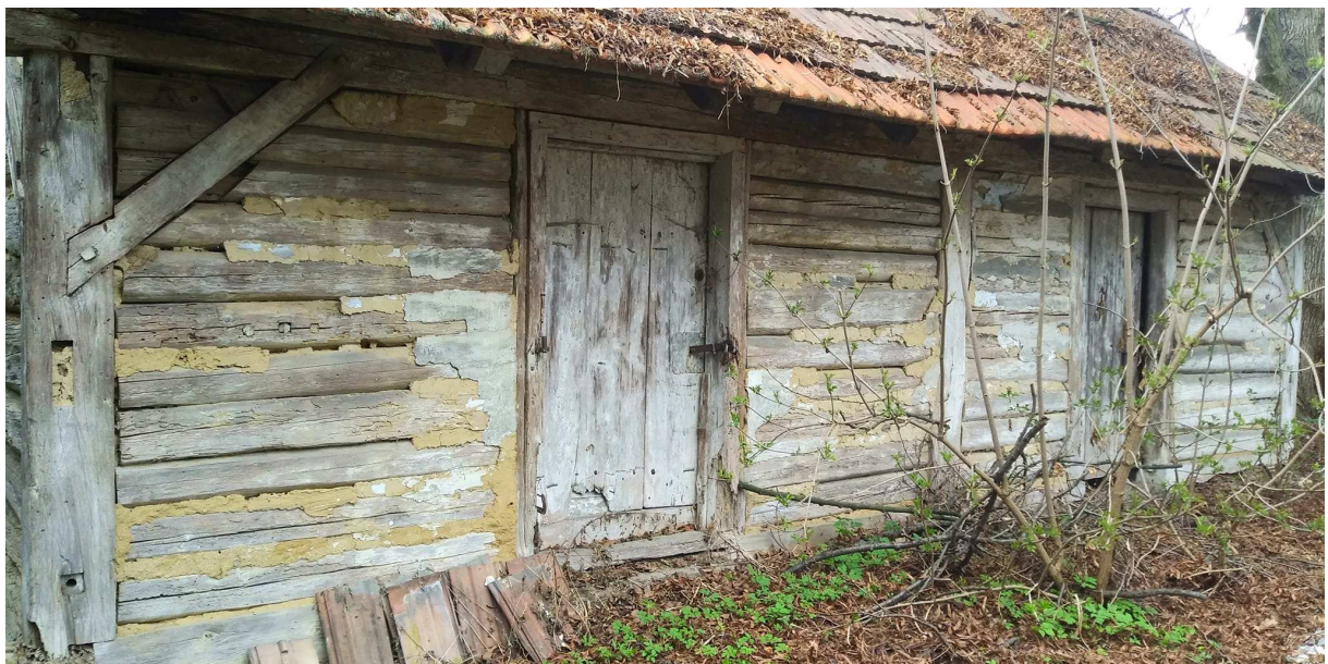
Fot. nr 384 (383-384). Widoki od strony podwórka.
