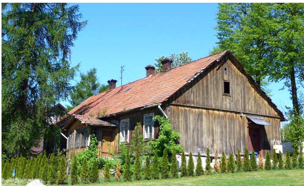
Fot. nr 266 (265-266). Fasada z kryty gankiem.
