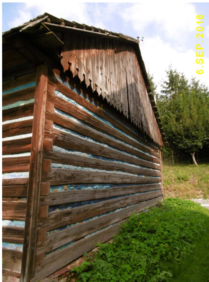
Fot. nr 207. Oryginalna, lewa ściana szczytowa.
