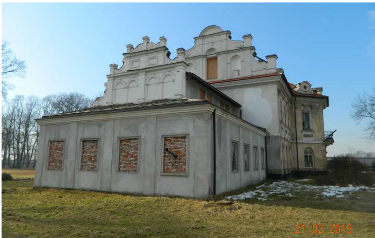
Fot. nr 20. Lewa, boczna ściana.
