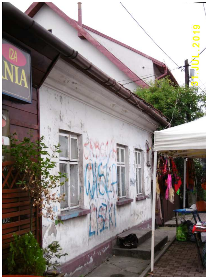
Fot. nr 42. Oryginalna fasada zapewne przedwojennego domu.
