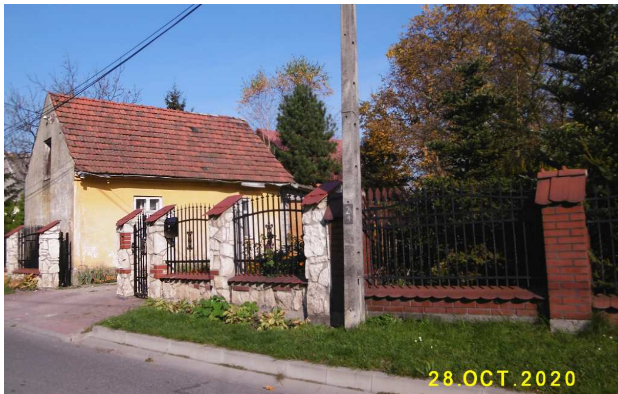
Fot. nr 89 (89-90). Murowany dom z okolic połowy XX. wieku pod nr 167.
