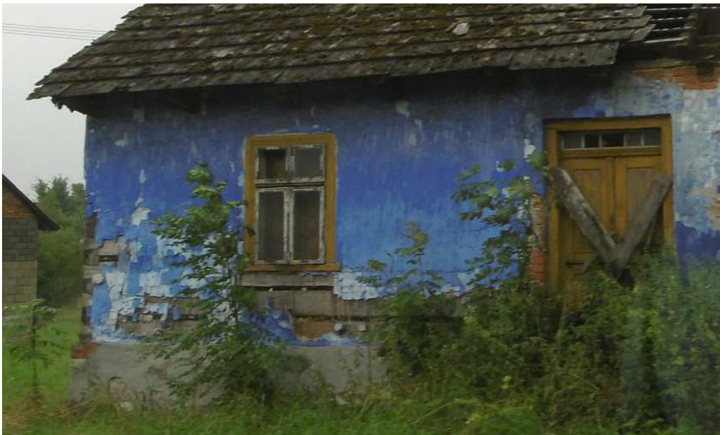
Fot. nr 140. Drewniana część mieszkalna. (31.07.2019)
