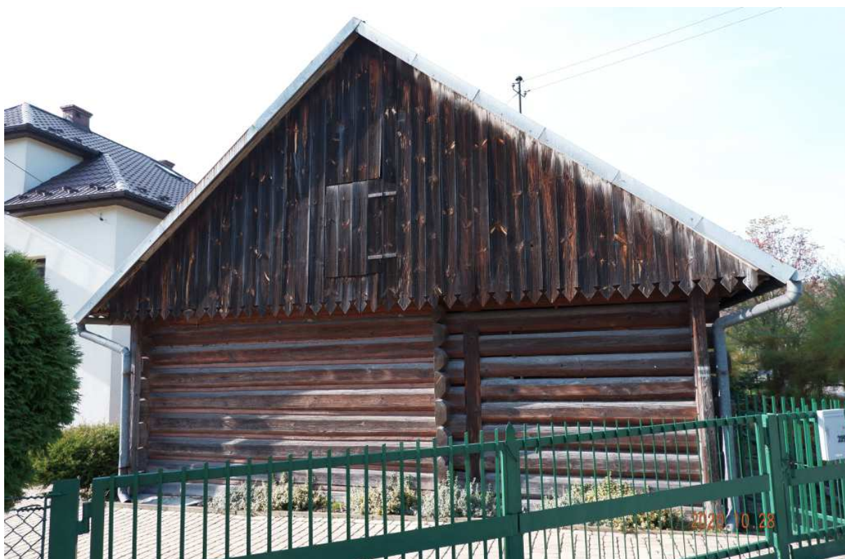
Fot. nr 98. Ściana szczytowa.
