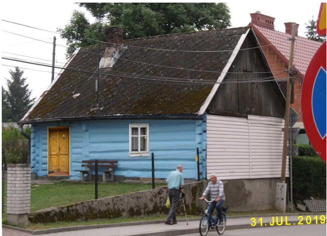
Fot. nr 48. Próba rekonstrukcji fasady.
