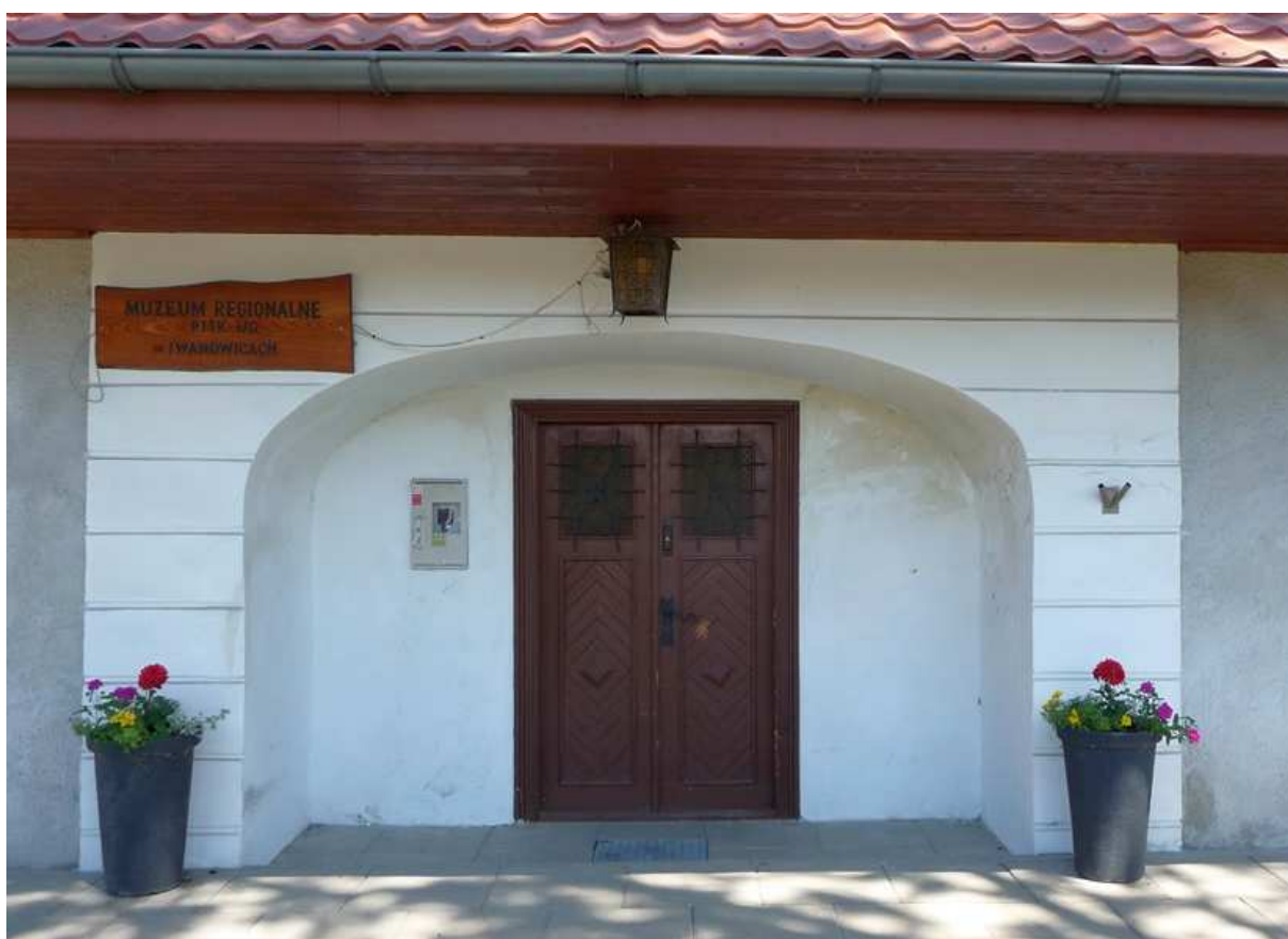
Fot. nr 217. Drzwi wejściowe.
