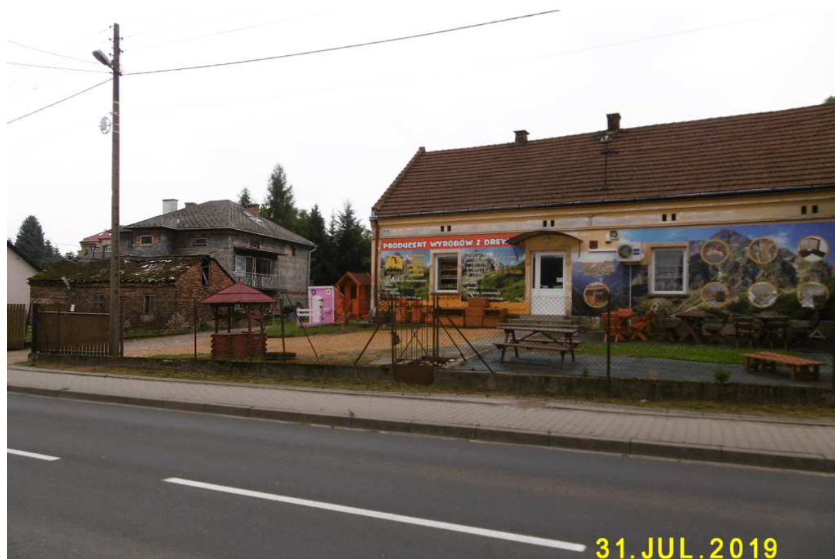
Fot. nr 58 (58-60). Ruina murowanego domu, zapewne przedwojennego, spod nr 54.
