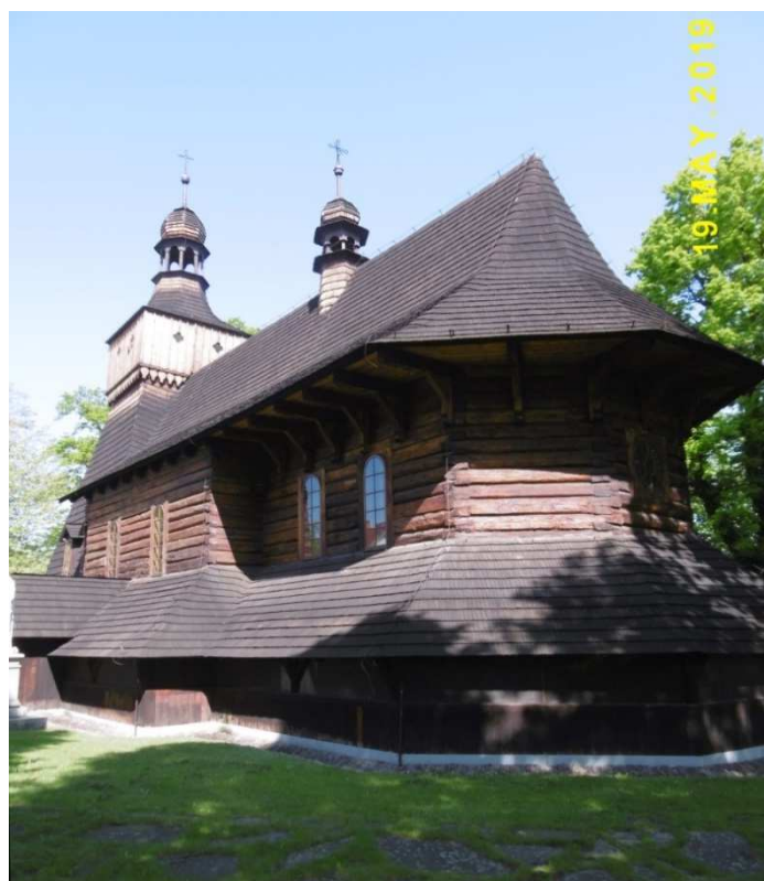
Fot. nr 313. Widok od strony prezbiterium nakrytego gontowym, wielopłociowym dachem.
