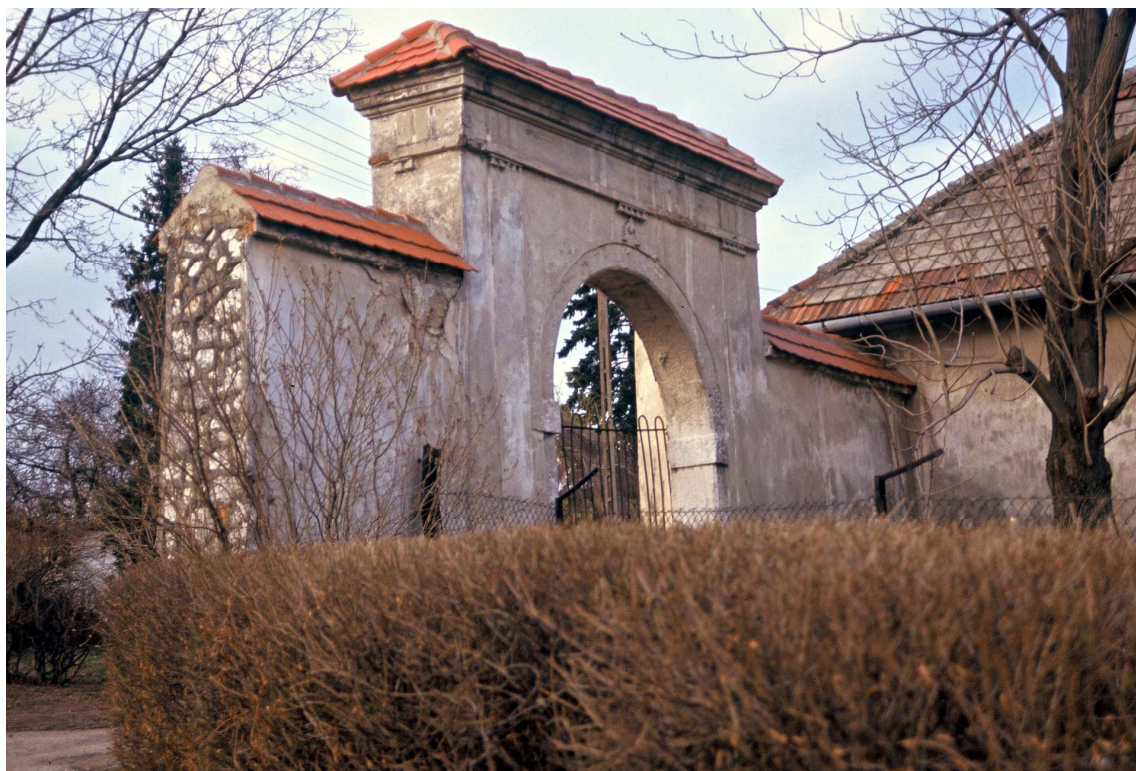
Fot. nr 262 (262-262a). Klasycystyczna brama wjazdowa do dworu, którego fragmenty trwały jeszcze w połowie lat 80. XX wieku (fot. nr 263) w kształcie czytelnej ruiny. Stan z połowy lat 80. – fot. Ewa Panek
