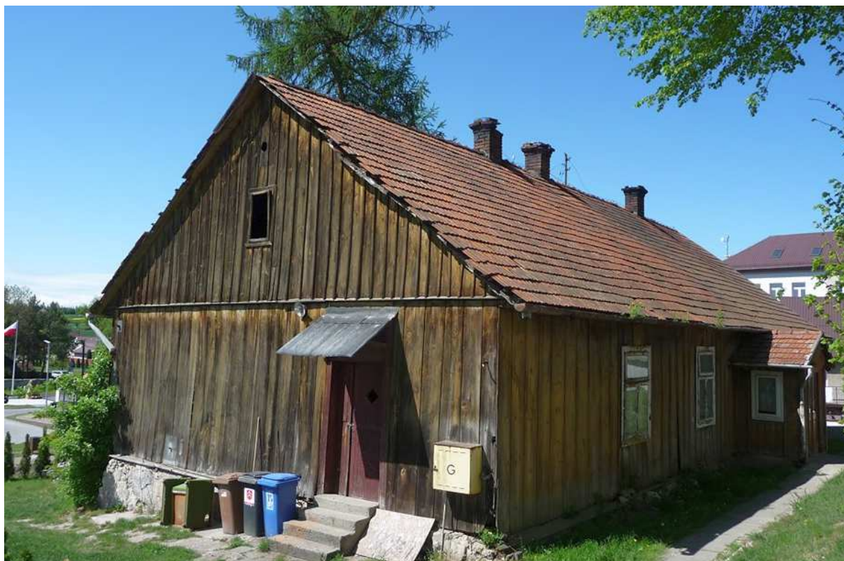
Fot. nr 267 (267-268). Tylny fragment obiektu; tu ze ścianą szczytową.
