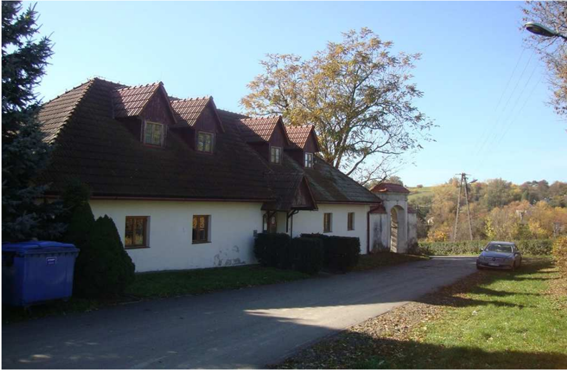
Fot. nr 261 (261-264). Pozostałości po zespole dworskim, XIX-wiecznym majątku rodu Baderów. Tu widok od strony drogi dojazdowej. Dziś majątkiem zarządza UR w Krakowie.
