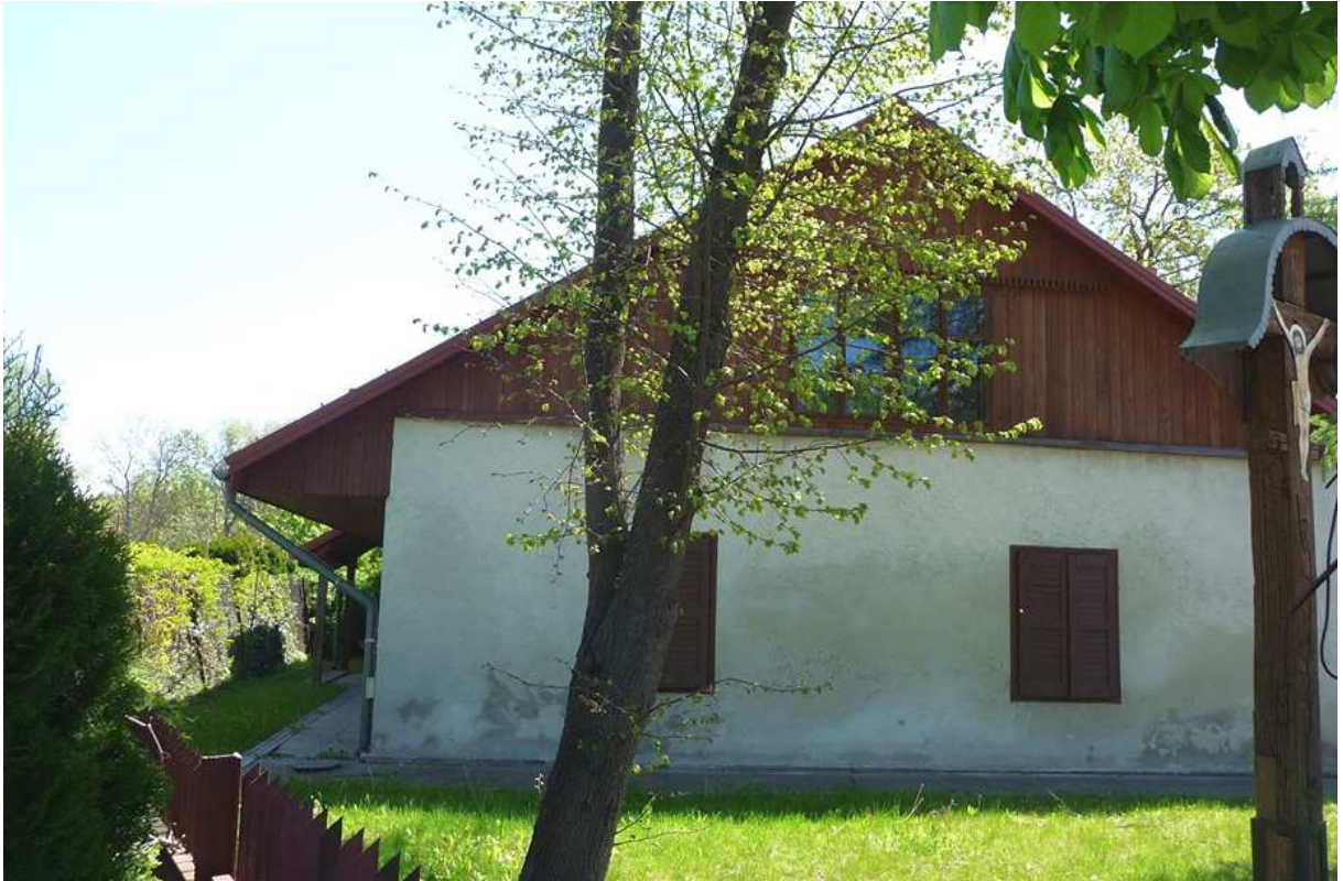
Fot. nr 307. Prawa ściana szczytowa i tylny fragment.
