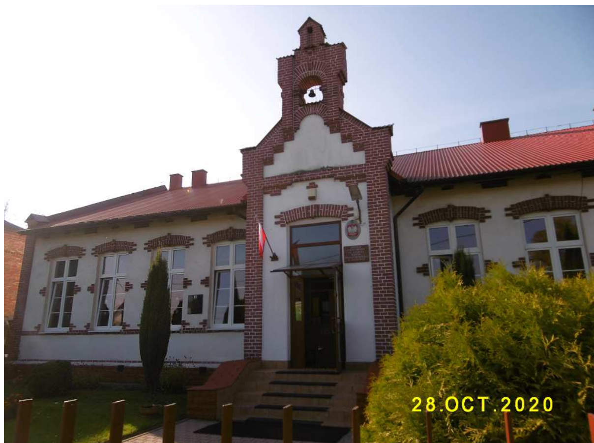
Fot. nr 87. Fasada ponad stuletniego obiektu.
