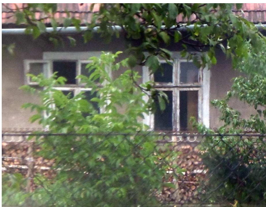
Fot. nr 138. Okna typu skrzynkowego.
