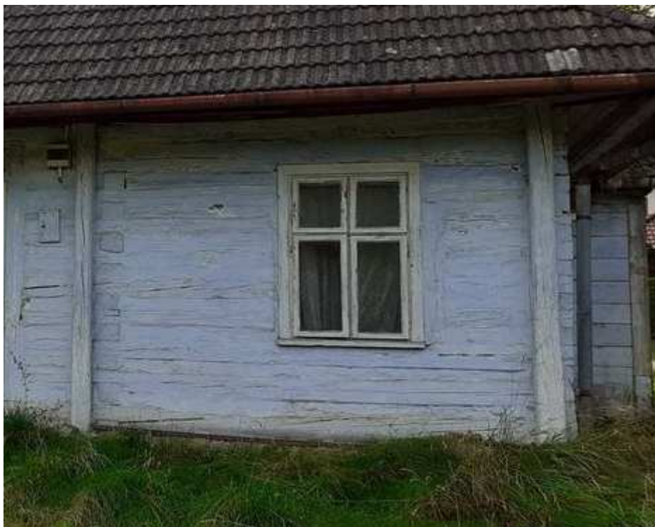
Fot. nr 358. Nieco wcześniejsze okno typu skrzynkowego z prawej części chałupy. (04.10.2020)
