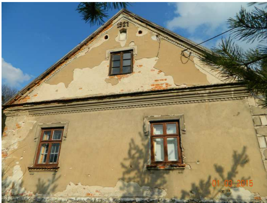
Fot. nr 156. Oryginalna boczna ściana z oknami typu skrzynekowego.
