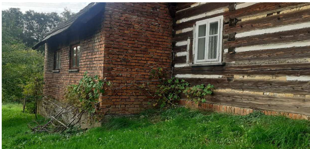
Fot. nr 369. Lewy narożnik i ceglana dobudówka. (02.07.2023)
