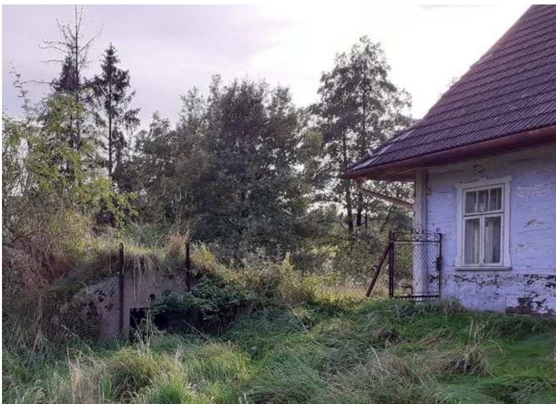
Fot. nr 357. Lewy narożnik z charakterystycznym oknem trójkwatrowym. (04.10.2020)
