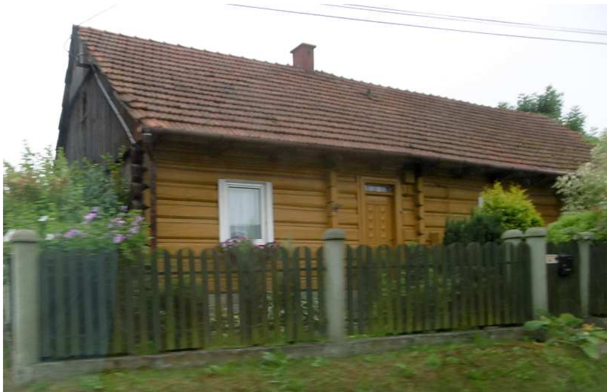
Fot. nr 79. Fragment chałupy spod nr 28. Okno plastikowe, bezpodziałowe, współczesne. (31.07.2019).
