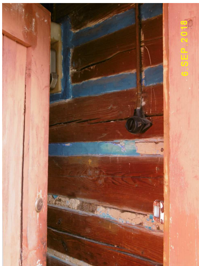
Fot. nr 212. Oryginalne malowanie sieni.
