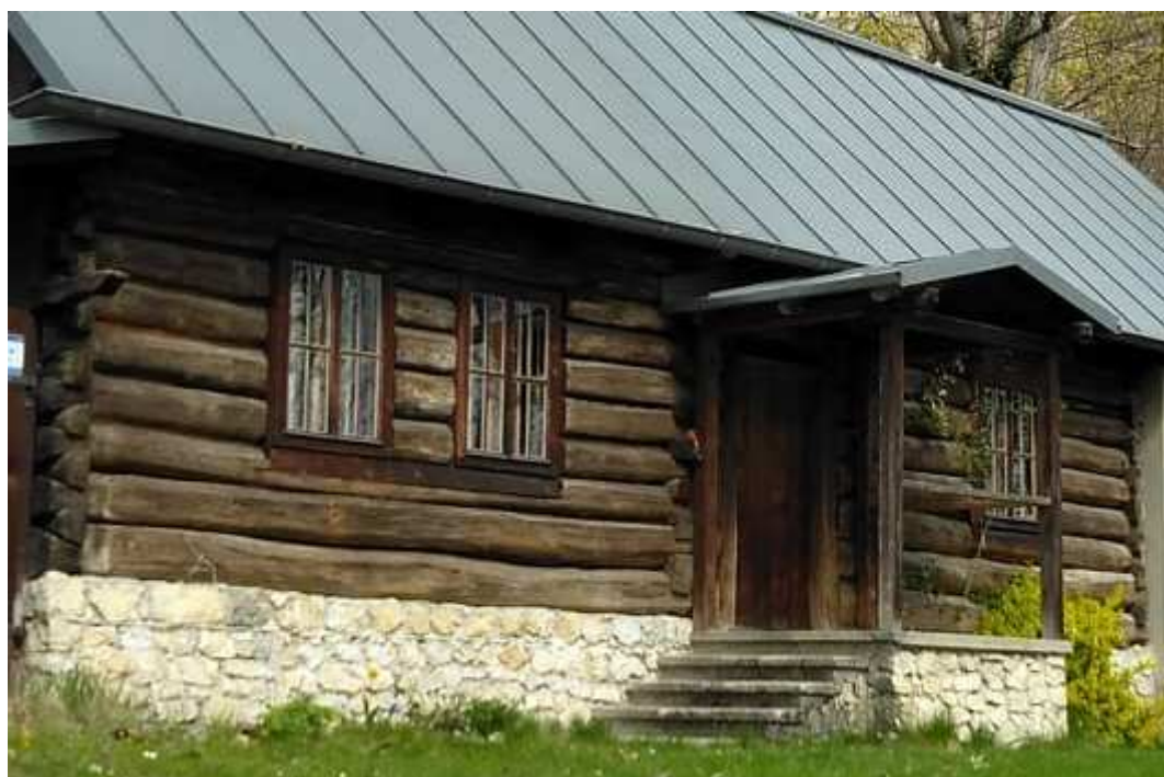
Fot. nr 234. Detale fasady. (19.04.2022)
