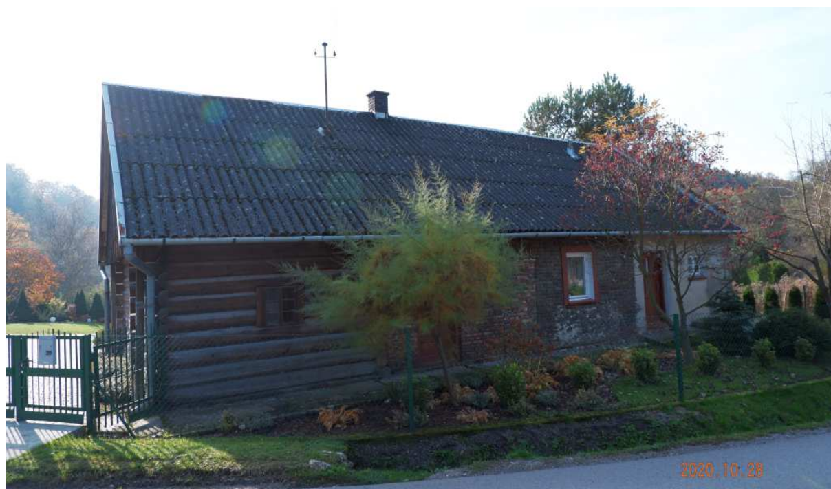
Fot. nr 100. Prawy fragment domu został dobudowany bądź przebudowany na murowany.
