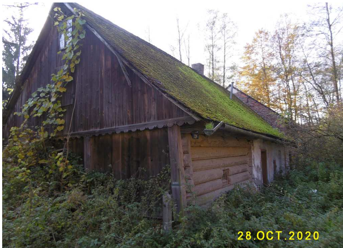
Fot. nr 114 (114-123). Chałupa w zagrodzie pod nr 129. Fot. nr: 114-116. Tylnej jej części.
