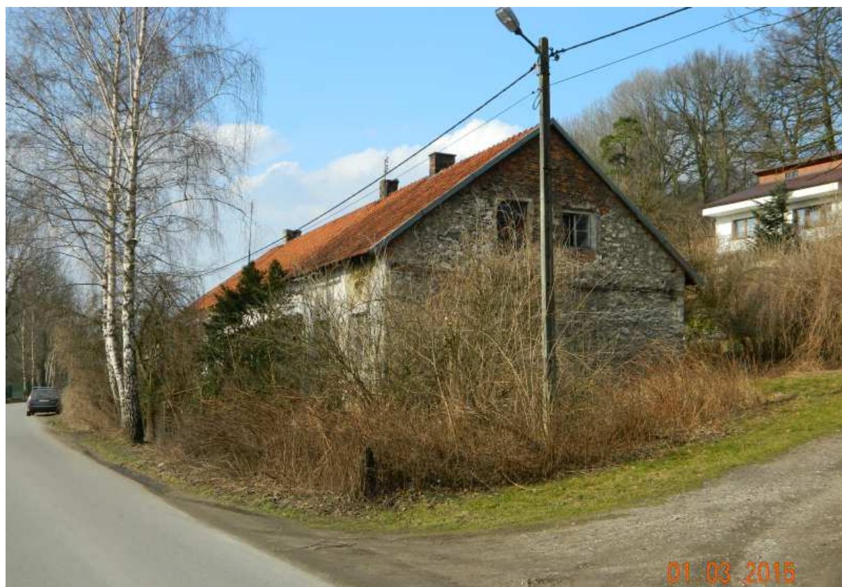
Fot. nr 152 (152-154). Wybudowany w okruchów wapiennych, kiedyś popularnych w okolicy, budynek spod nr 1b, zapewne też przynależny do dawnego dworu.
