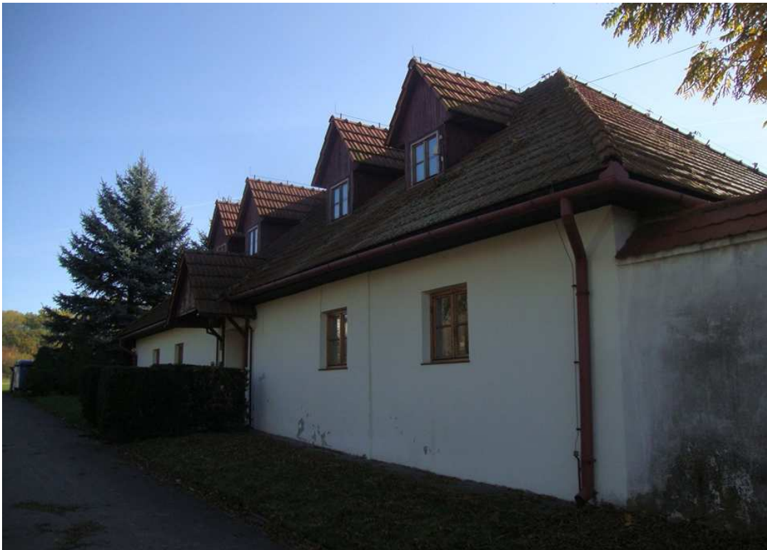
Fot. nr 261a (260-261a). Dawny spichlerz dworski, przerobiony pod koniec XX. wieku na pomieszczenia biurowe.
