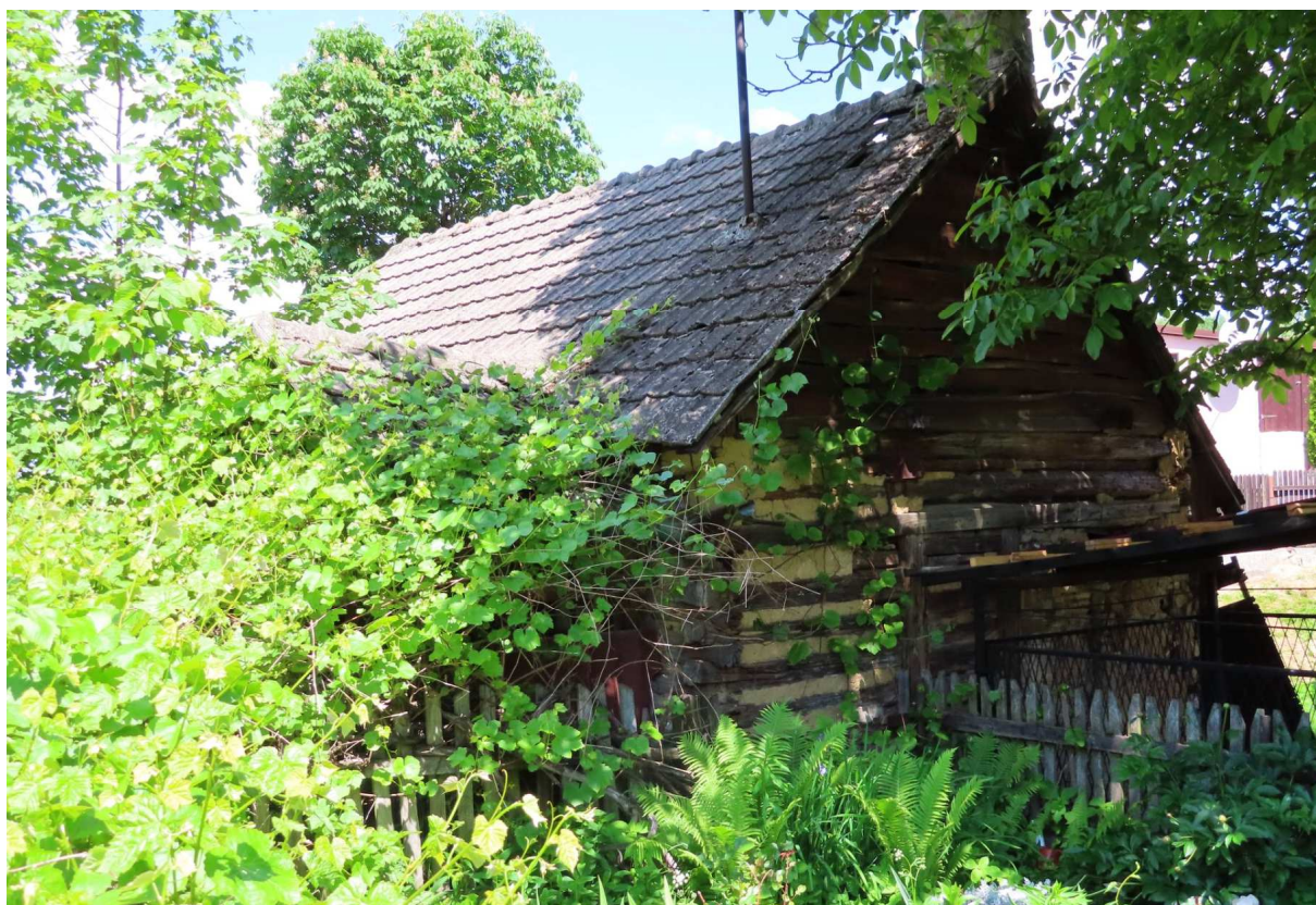
Fot. nr 244. Prawa ściana szczytowa (11.06.2021)
