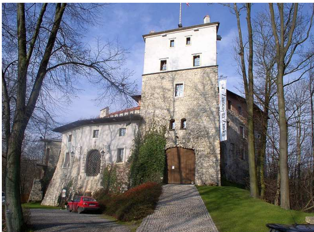
Fot. nr 256. Wieża bramna i brama wjazdowa do zamku. (11.11.2010)
