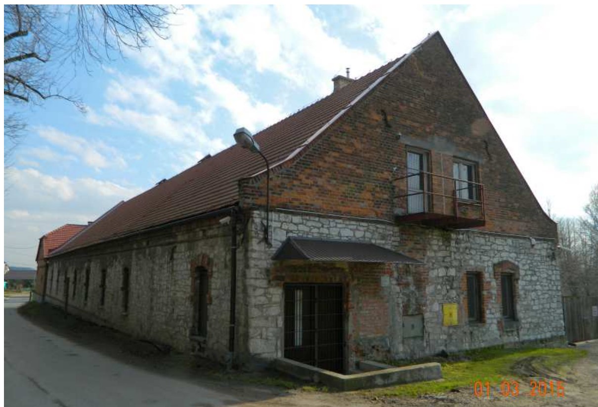
Fot. nr 150. Wybudowany z kostek wapiennych budynek gospodarczy, przylegający do domu pod nr 31, być może też związany z dawnym dworem.
