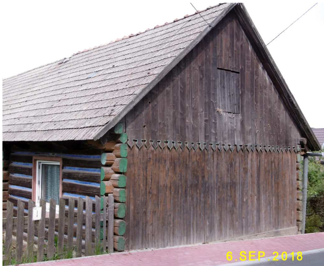
Fot. nr 180. Ściana szczytowa.
