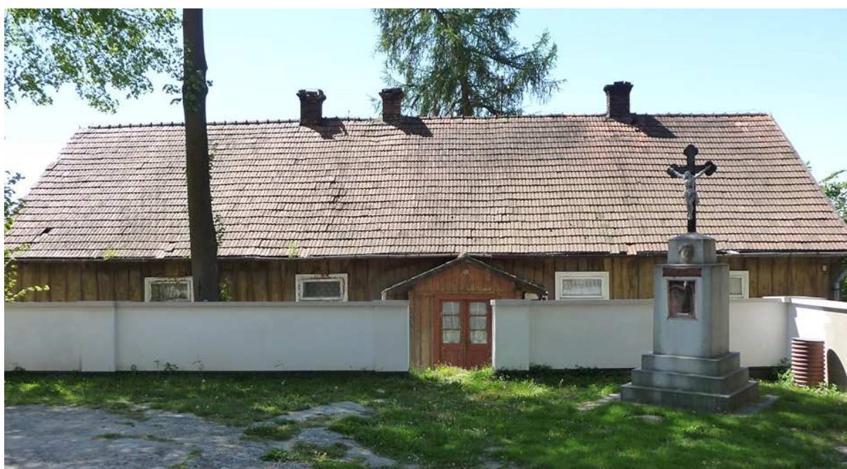
Fot. nr 268. Widok od strony cmentarza.
