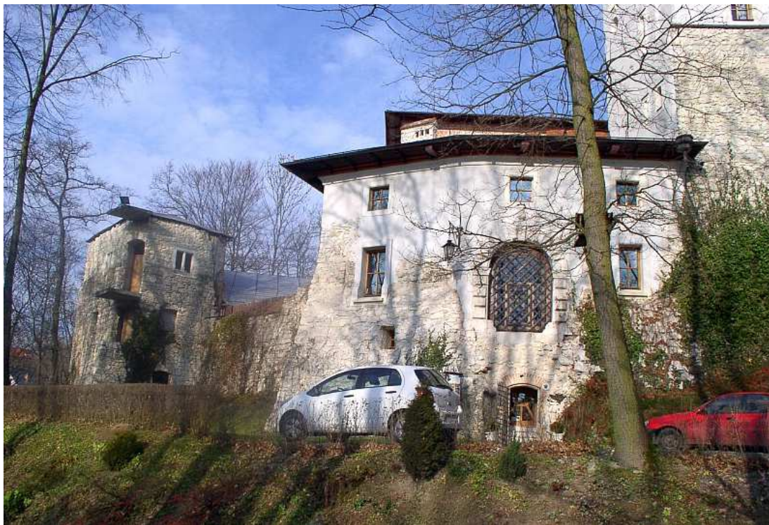
Fot. nr 257 (257-258). Rekonstrukcja części mieszkalnej dawnej warowni. (11.11.2010)
