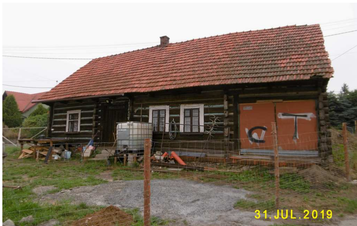
Fot. nr 33 (33-34). Widoki od strony podwórka.
