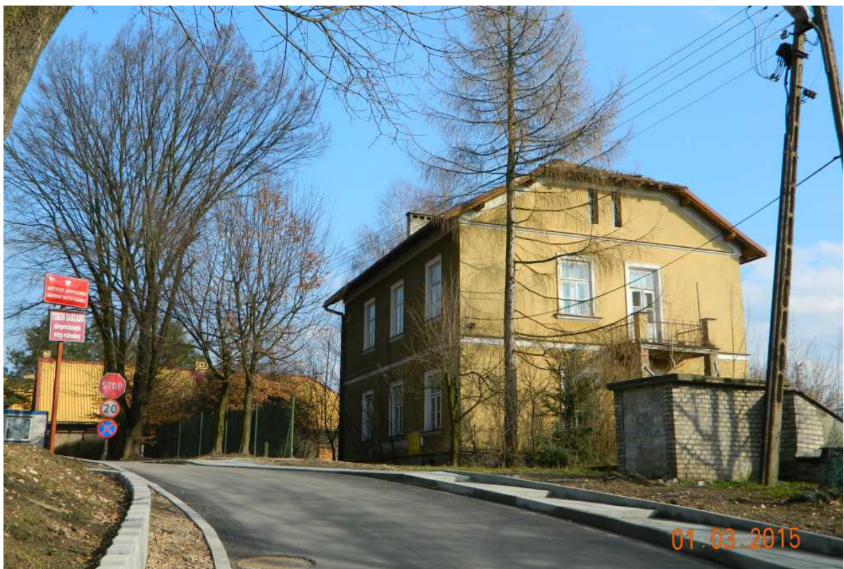
Fot. nr 146 (146-149). Ponad stuletnie budynki dawnego dworu aleksandrowickiego pod nr 1 i jego zaplecza, które dziś wykorzystuje Instytut Zootechniki - Państwowy Instytut Badawczy z Balic. Tu (zapewne) dawna dworska oficyna z początku XX. wieku.
