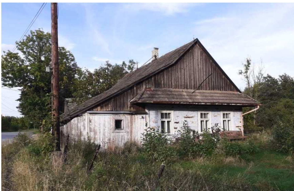
Fot. nr 359. Ściana szczytowa z okapowym dachem. (04.10.2020)
