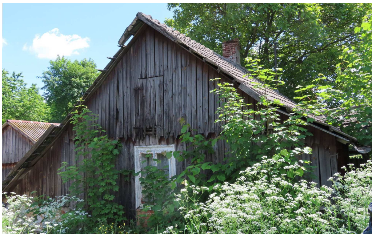
Fot. nr 242. Lewa ściana szczytowa. (11.06.2021)
