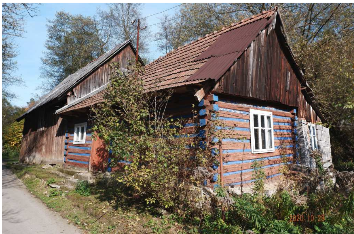
Fot. nr 102 (102-110). Niezwykłej urody, zapewne jeszcze XIX-wieczna, jednotraktowa chałupa pod nr 205, do której we wspólnym korpusie przylega stodoła.
