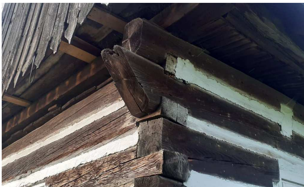
Fot. nr 370. Detale więźby dachowej. (02.07.2023)
