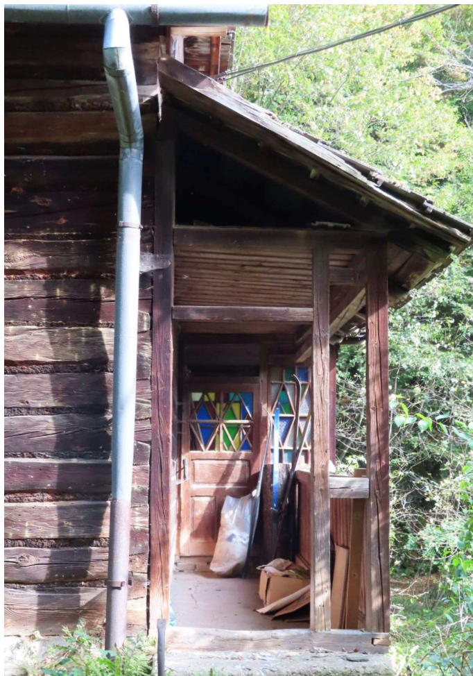
Fot. nr 381 (381-382). Częściowo odkryty przedsionek.
