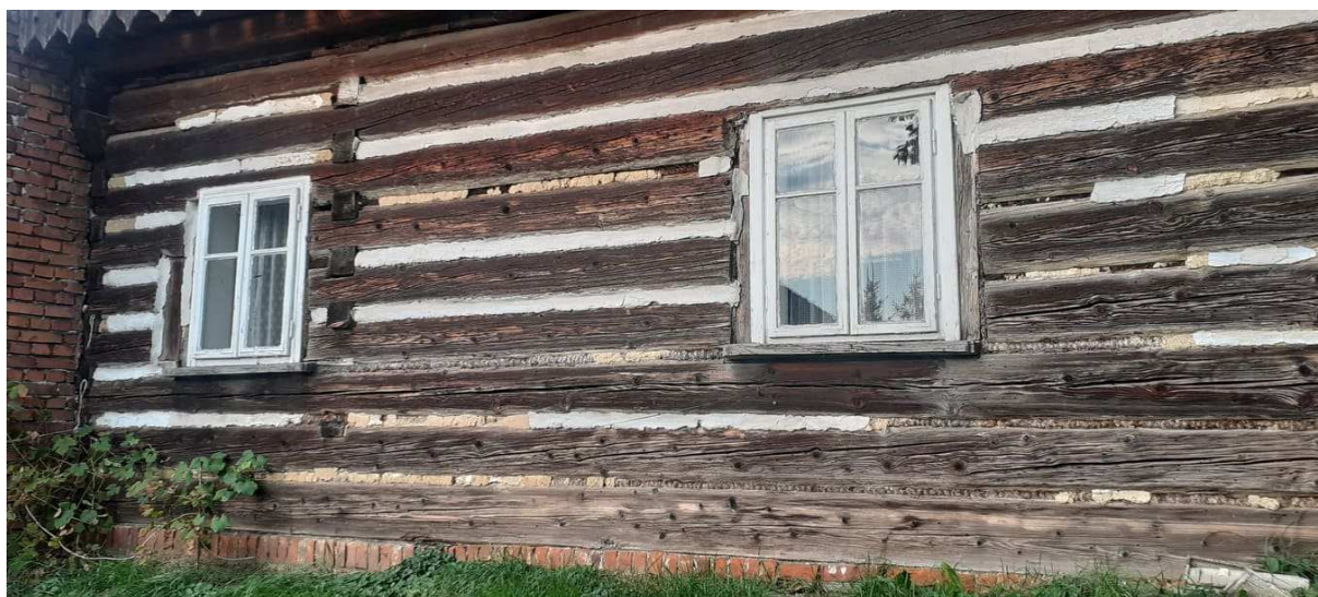
Fot. nr 365. Archaiczne okienka typu ościeżnicowego w lewej części fasady. (02.07.2023)
