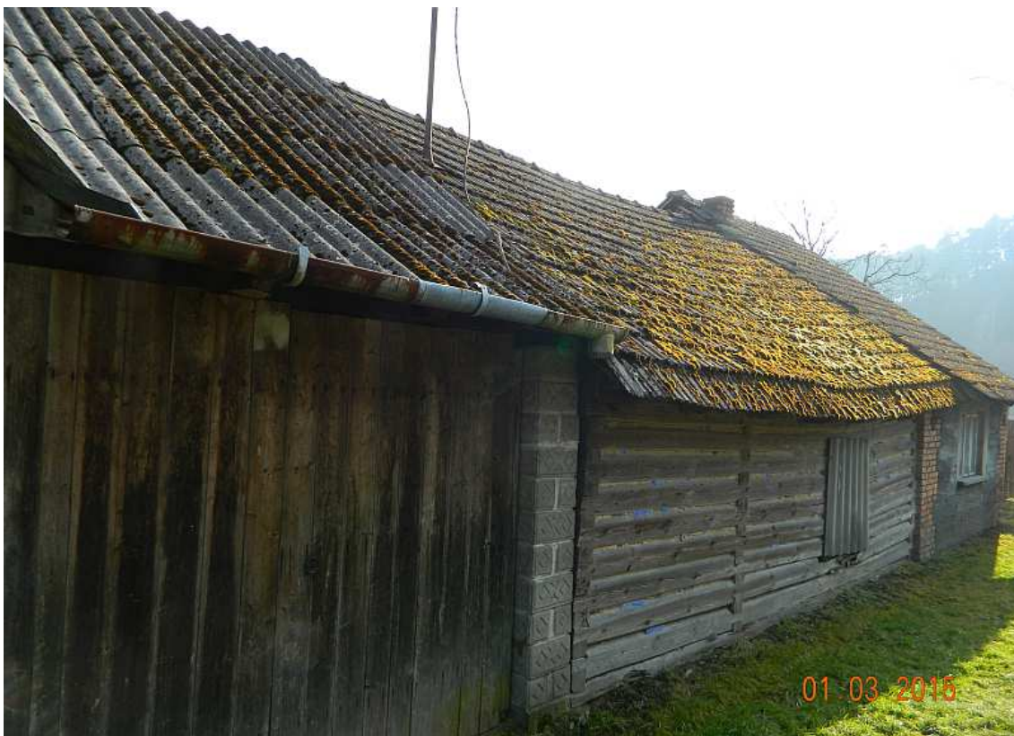
Fot. nr 163 (163-164). Tylna część chałupy o archaicznym, poprzecznym belkowaniu.
