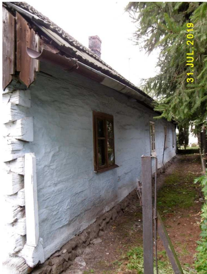
Fot. nr 44 (44-46). Stara chałupa w zaułku niedaleko Rynku, pod nr 201. Widok od strony ogrodu.
