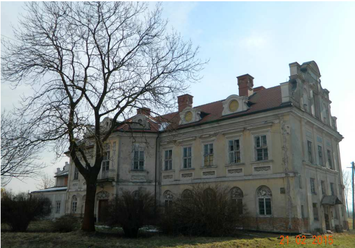
Fot. nr 15 (15-25). Będący w prywatnych rękach i czekający na rewaloryzację eklektyczny pałac Skirlińskich w Kryspinowie, gdzie w czasach PRL siedzibę miał POM. Stan z roku 2015.
