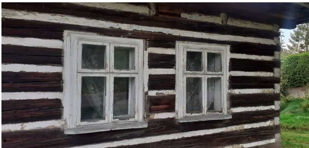
Fot. nr 366 (366-368). Okna typu skrzynkowego w prawej części fasady i w lewej ścianie szczytowej (poza skrajnym). (02.07.2023)
