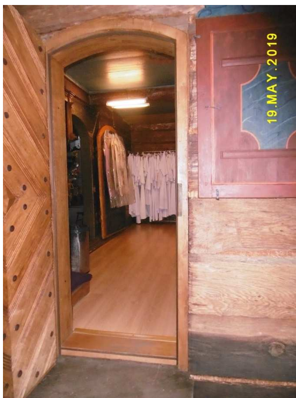
Fot. nr 323. Wejście do zakrystii w północnej ścianie prezbiterium
