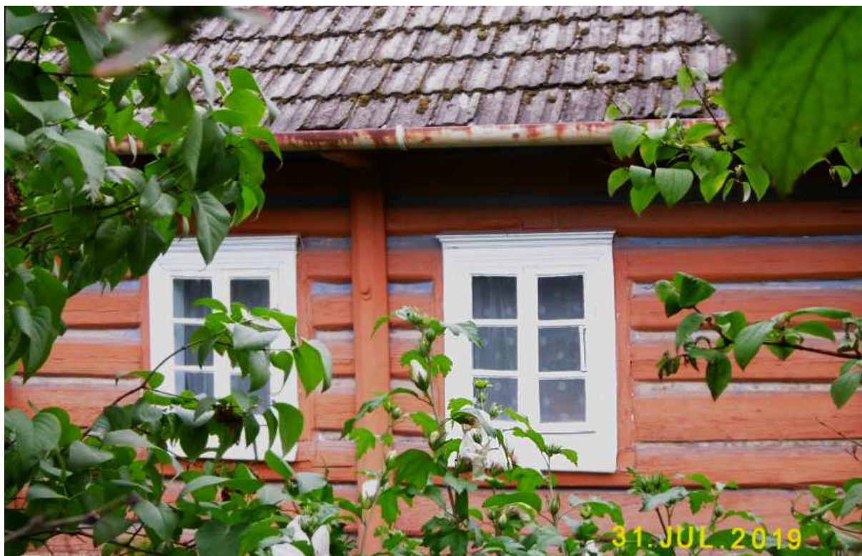
Fot. nr 65. Okna o oryginalnych podziałach dla starych chałup.
