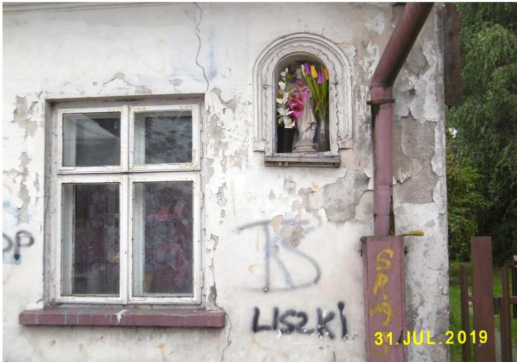
Fot. nr 43. Oryginalne okno typu skrzynkowego i kapliczka w ścianie fasady.
