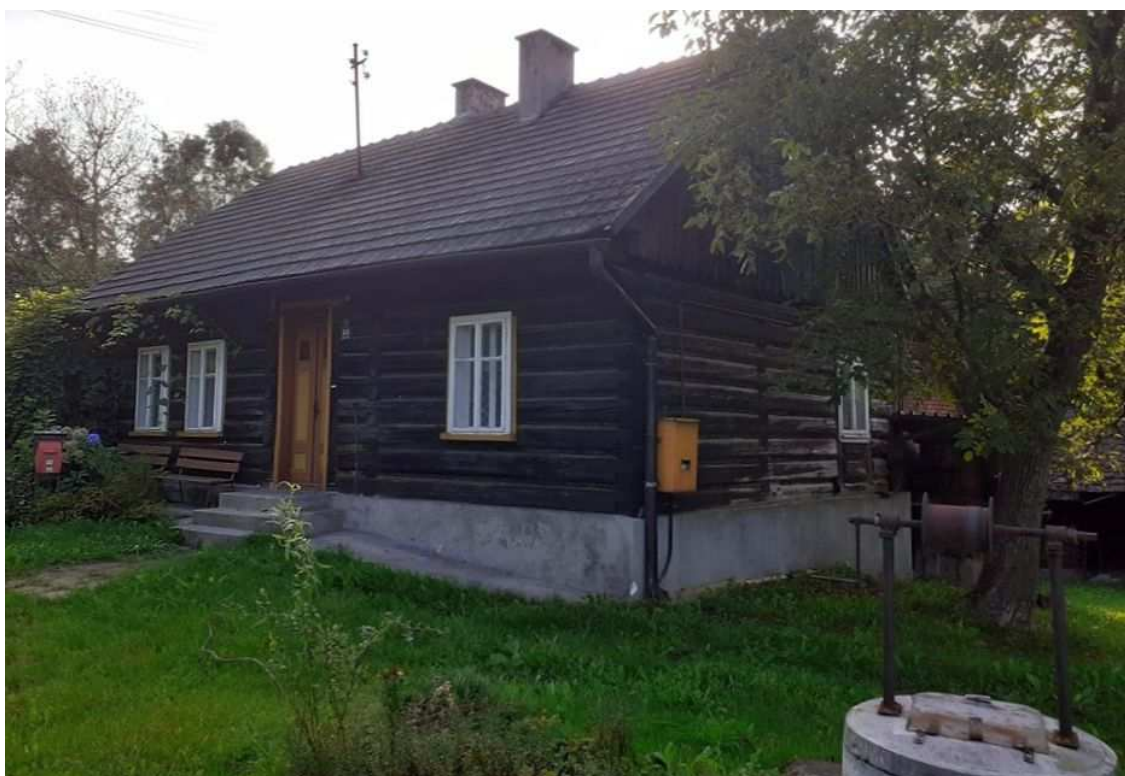
Fot. nr 354 (354-355). Chałupa zapewne z początku XX wieku z ulicy Bukowskiej. (20.09.2020)
