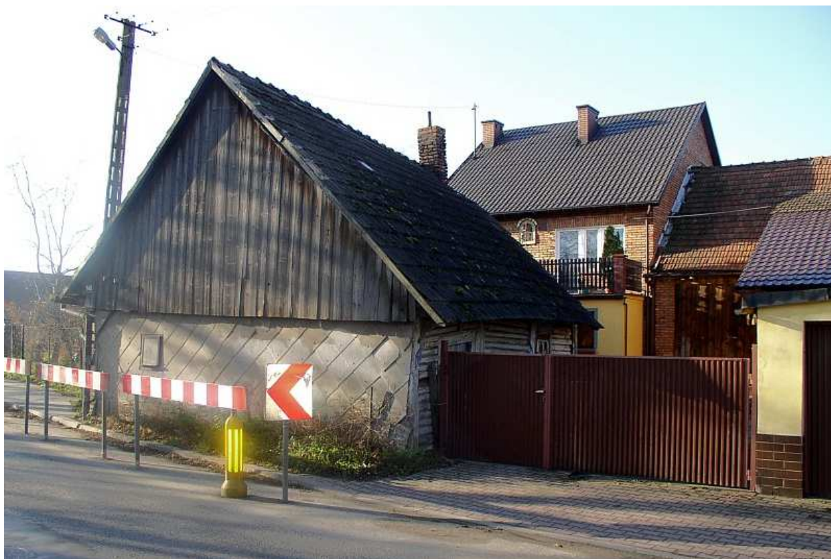
Fot. nr 249. Pokryta szalunkiem ściana szczytowa i ledwo widoczny tylny, oryginalny fragment. (11.11.2010)
