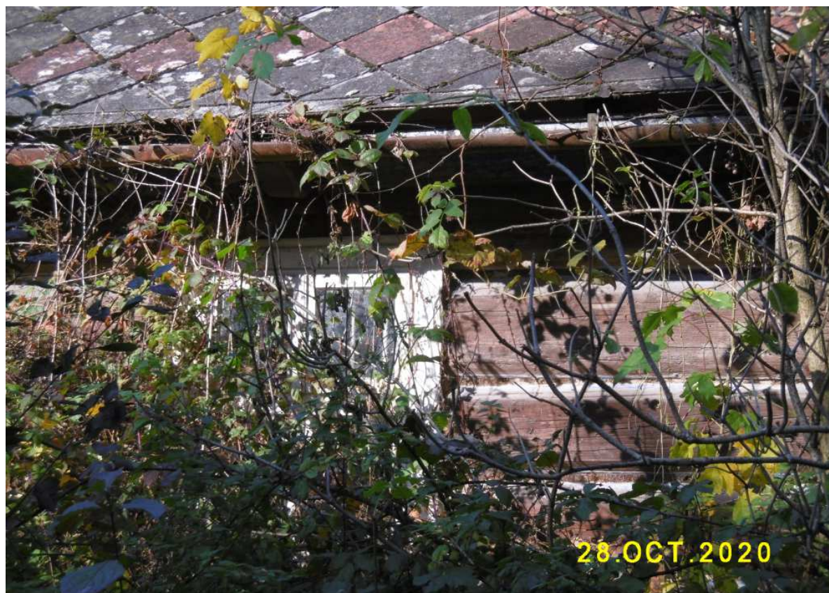
Fot. nr 118. Oryginalne okno w prawym fragmencie.
