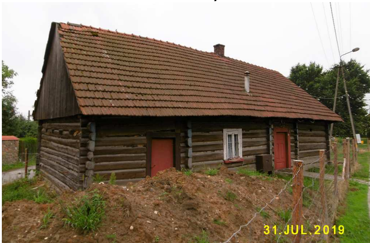
Fot. nr 29 (29-38). Zagroda w Cholerzynie pod nr 2, która już nie istnieje. Fot. nr: 29-34. Zapewne jeszcze XIX-wieczna chałupa i jej detale.
