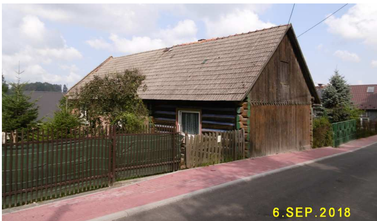
Fot. nr 178 (177-179). Widoki fasady.
