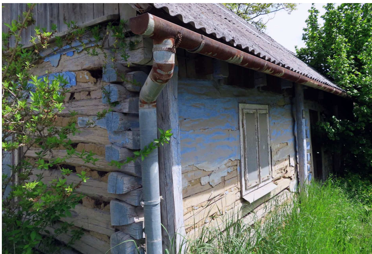
Fot. nr 236 (236-237). Detale fasady. Obiekt o konstrukcji zrębowej, bielony (01.06.2021)
