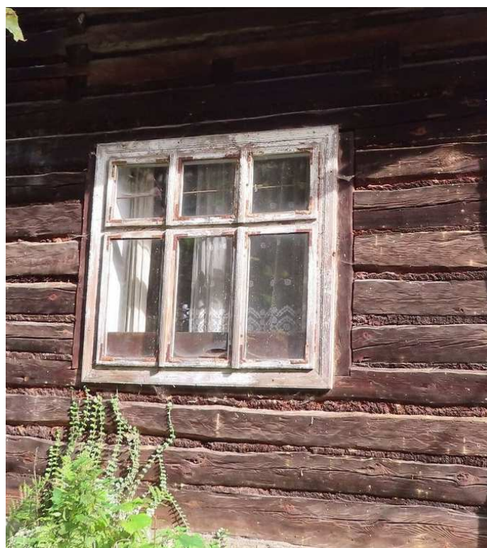
Fot. nr 380. Okno typu weneckiego w fasadzie.
