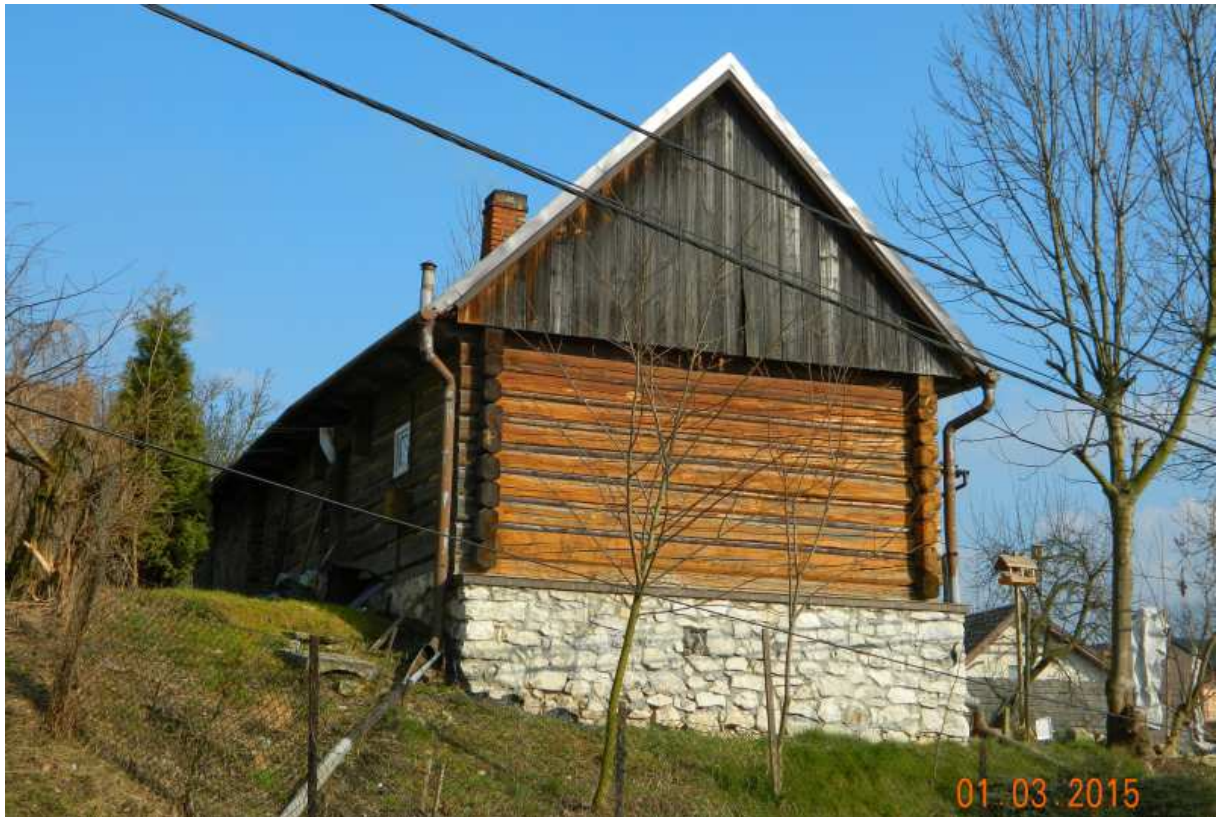
Fot. nr 145. Boczny i tylny fragment z oryginalnym belkowaniem poprzecznym.
