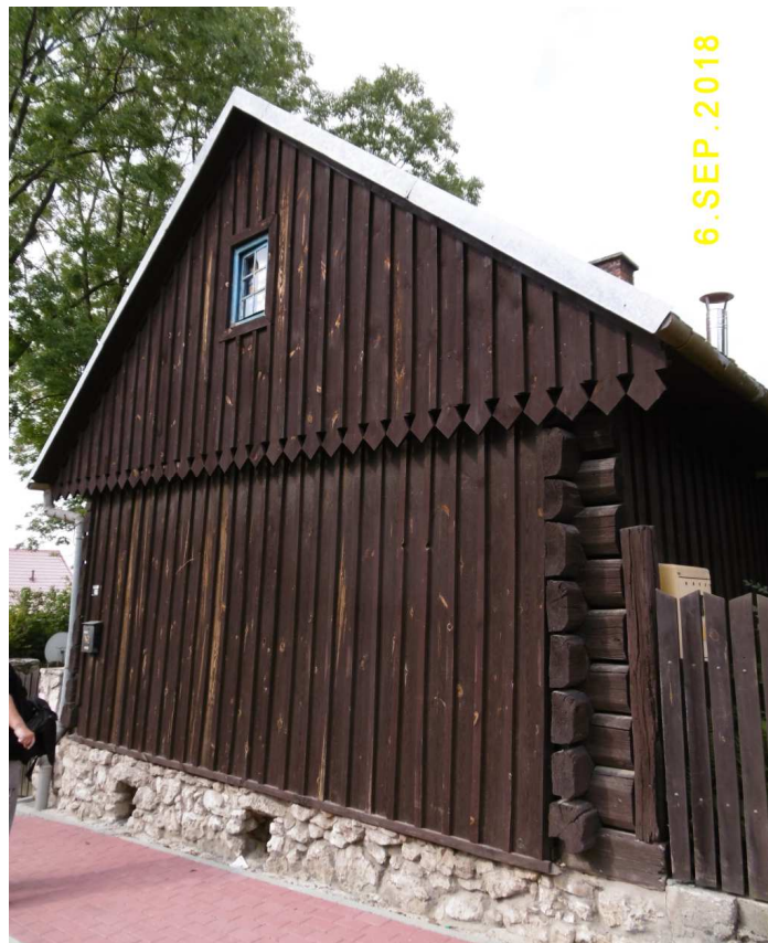
Fot. nr 168. Boczna ściana szczytowa
