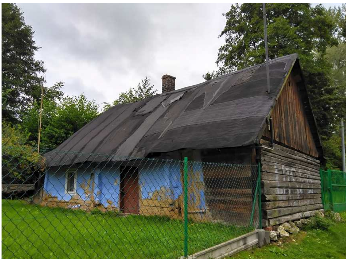
Fot. nr 230 (230-232). Chałupa przy wejściu do Doliny Kobyłańskiej przy ulicy Turystycznej 10A. Fasada. Fot. E. Skoplak. (07.09.2020)
