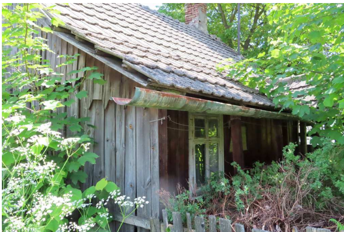
Fot. nr 240 (240-244). Ruina dawnej chałupy o konstrukcji zrębowej, z otwartym gankiem, z Dębника pod nr 9(?). Próby uchwycenia detali. (11.06.2021)
