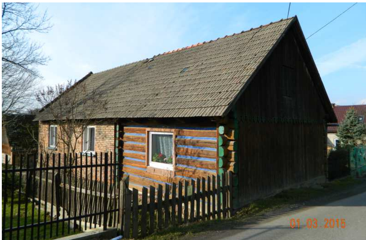
Fot. nr 177 (177-183). Bliski oryginałowi fragment chałupy (z prawej) pod nr 53. I tylko współczesne okno zaburza dawny wygląd.
