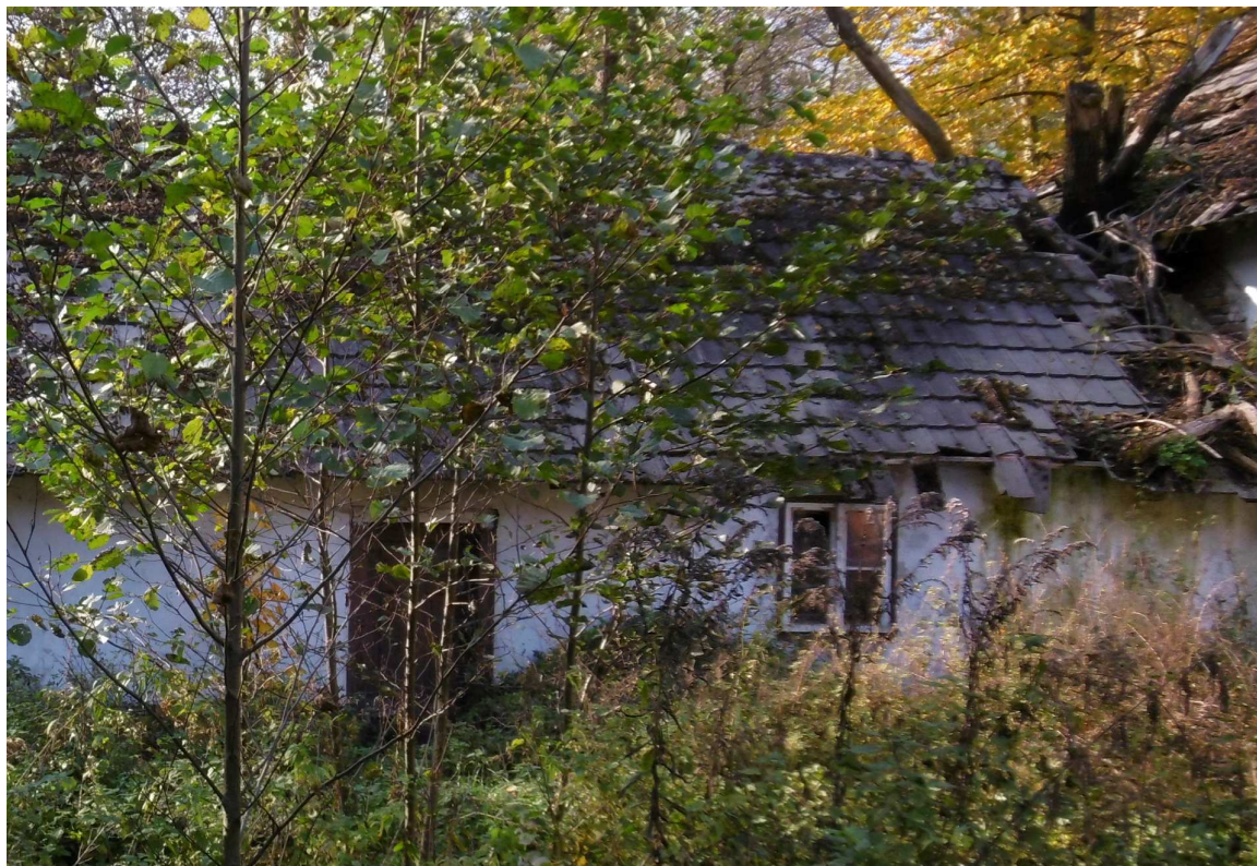
Fot. nr 123. Część mieszkalna. (28.11.2020)
