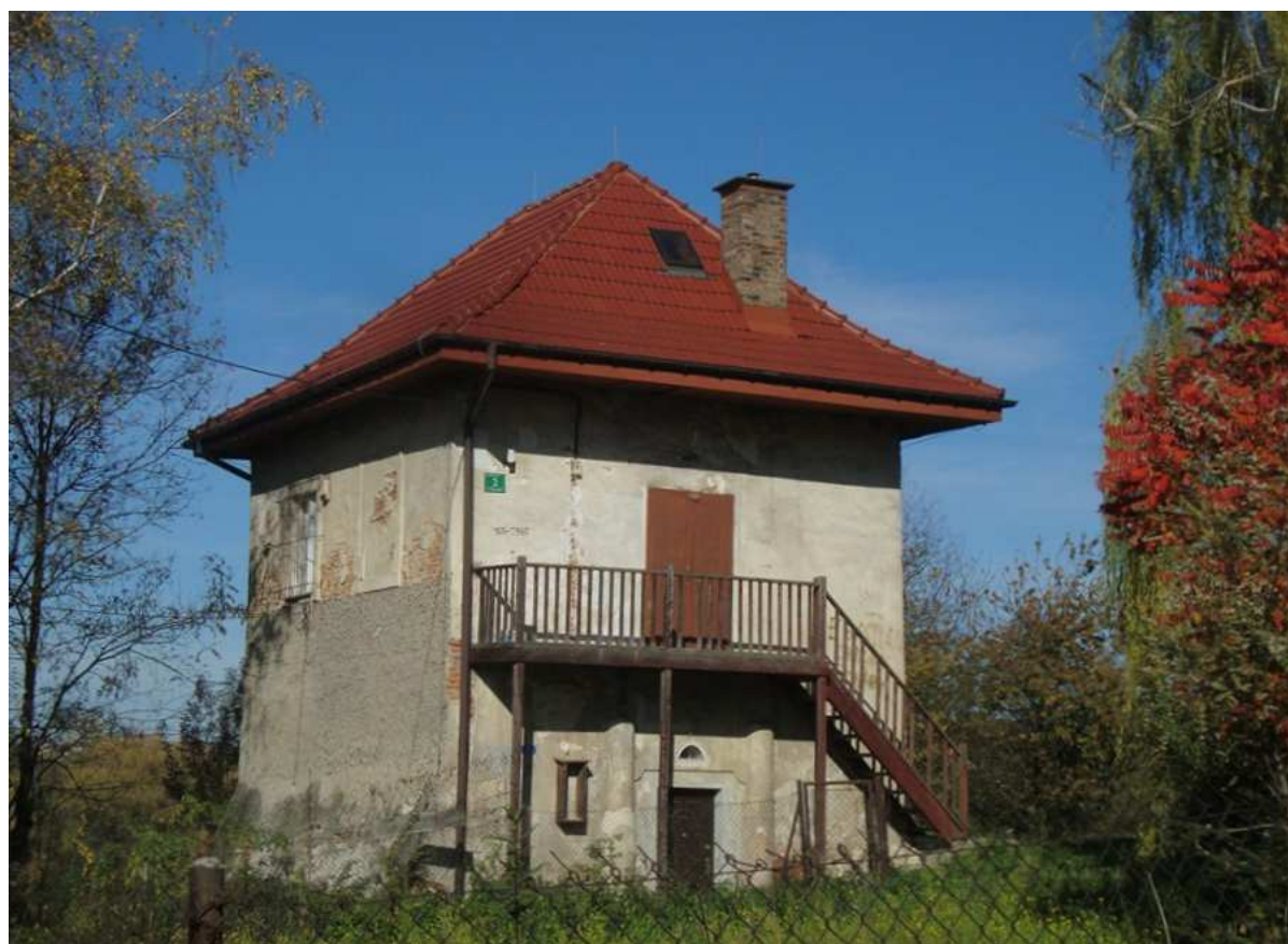
Fot. nr 264. Wybudowany w XVII. wieku lamus dworski, który posiada drewniane zewnętrzne schody i galeryjkę na piętrze.
