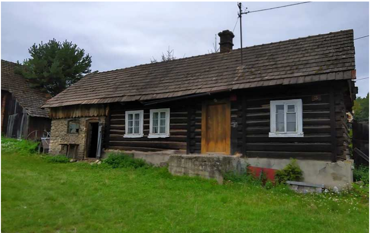
Fot. nr 228 (228-229). Chałupa, zapewne z początku XX wieku, w jednym korpusie z murowaną stajnią, z ulicy Turystycznej 3. Zagrodę kompletuje stodoła ustawiona w poprzek do chałupy (fragment z lewej). Fot. Ewa Skoplak. (07.09.2020)
