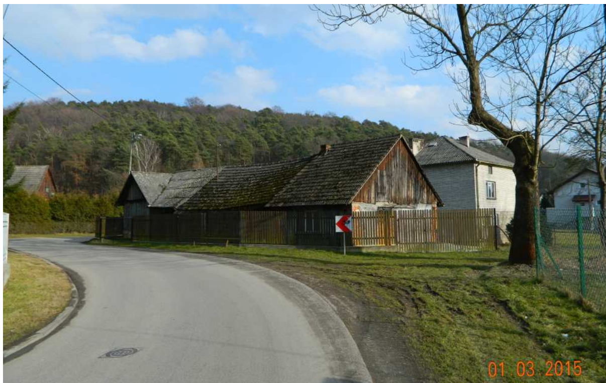
Fot. nr 161 (161-164). Widok kompleksu z drogi wiodącej do Kleszczowa.
