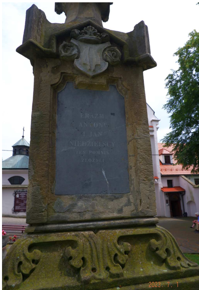
Fot. nr 22 (22-23). Tylna część.
