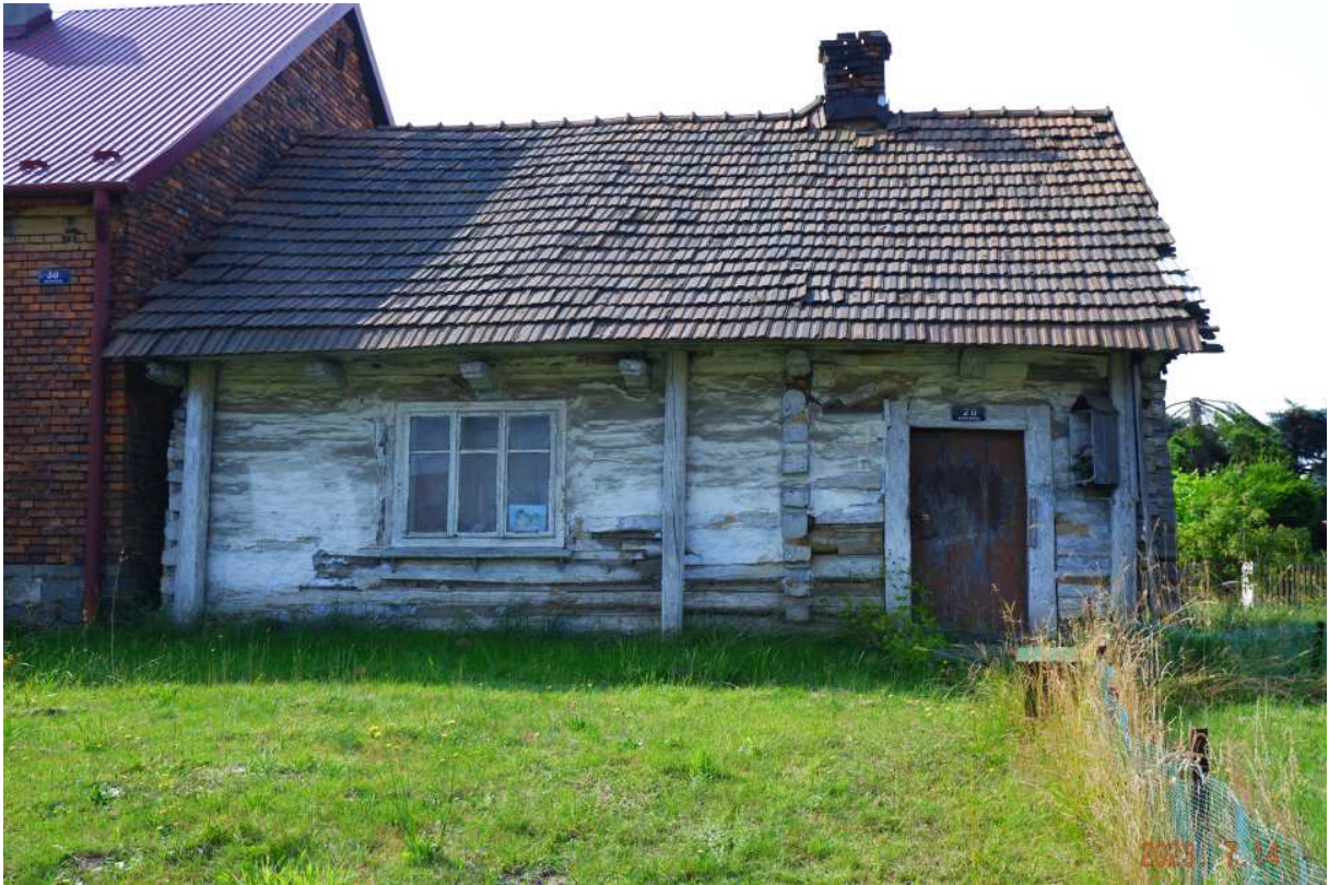
Fot. nr 176 (176-181). Archaiczna chałupa, zapewne z II połowy XIX wieku, spod nr 28. Choć to cenny zabytek etnograficzny nie ma jej nawet w GEZ. Można przypuszczać, że z prawej strony pierwotnie przylegała do niej stajnia, na jakimś etapie wyburzona.
