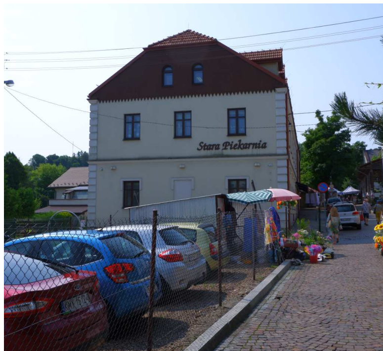
Fot. nr 69 (69-71). Współcześnie odnowiony i zmodyfikowany budynek dawnej Starej Piekarni spod nr 6, zapewne jeszcze XIX-wieczny. (14.07.2023)
