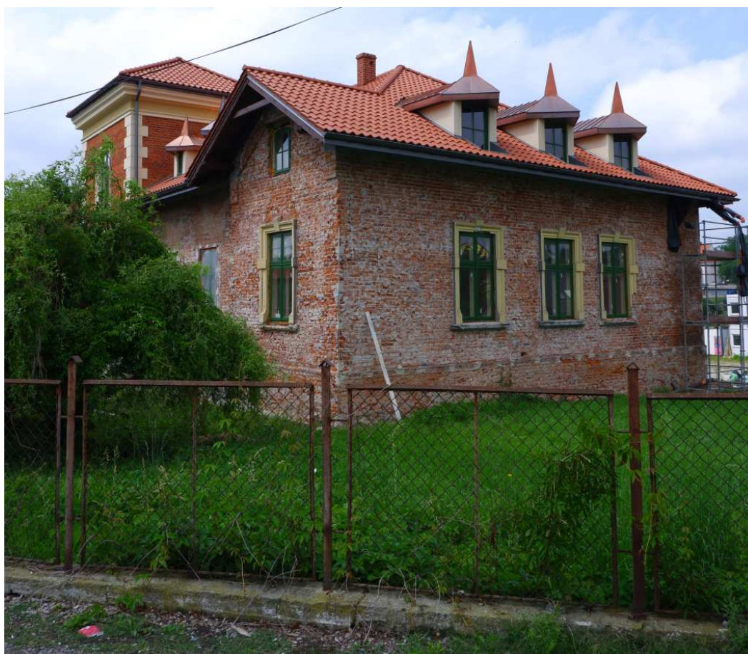
Fot. nr 145 (145-147). Efektowna willa spod nr 15, pochodząca z przełomu XIX i XX wieku, na etapie remontu. Do poddasza zostały dobudowane lukarny. (01.07.2023)
