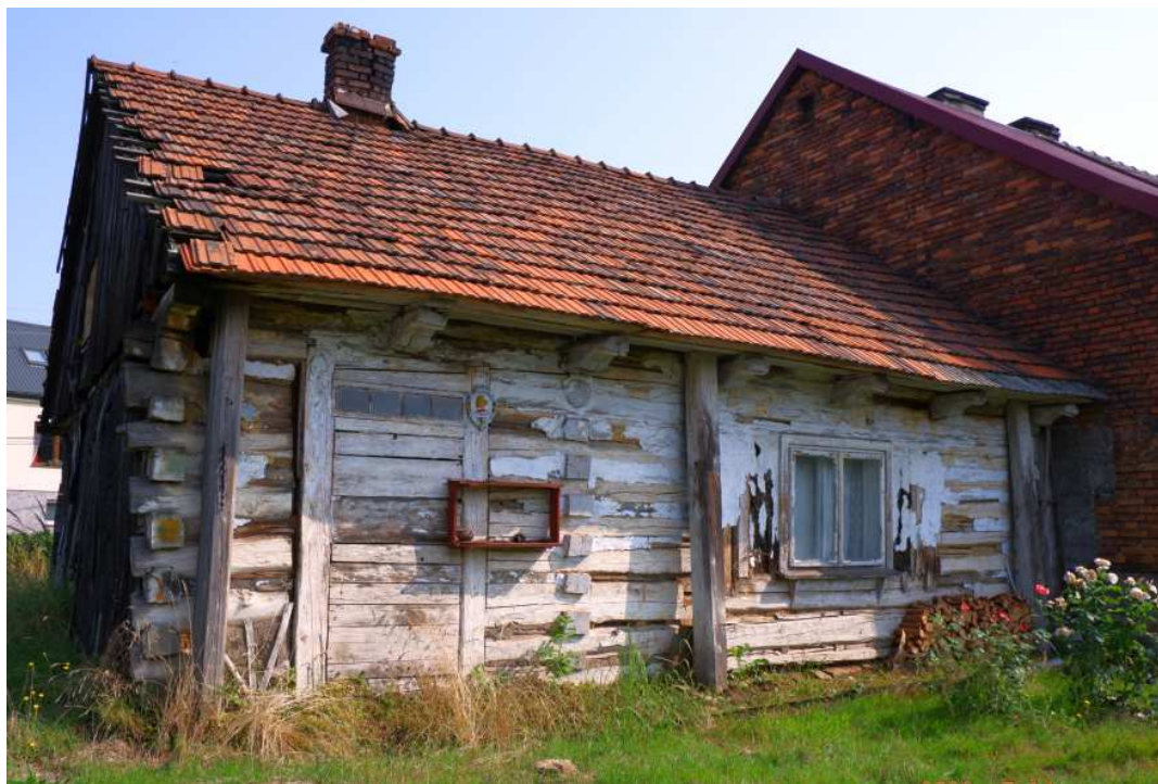
Fot. nr 181. Tylny fragment z nieoryginalnym już oknem. (14.07.2023)
