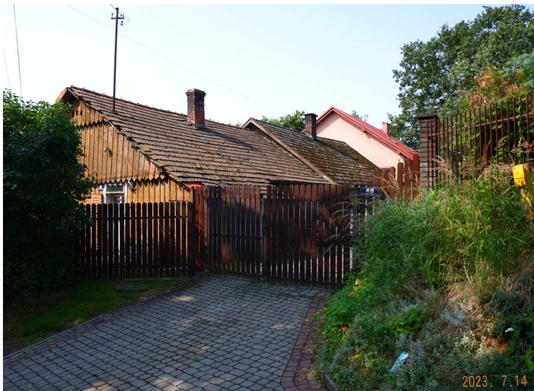
Fot. nr 194 (194-195). Kolejna zagroda, zapewne z I ćwierci XX wieku, spod nr 40.
