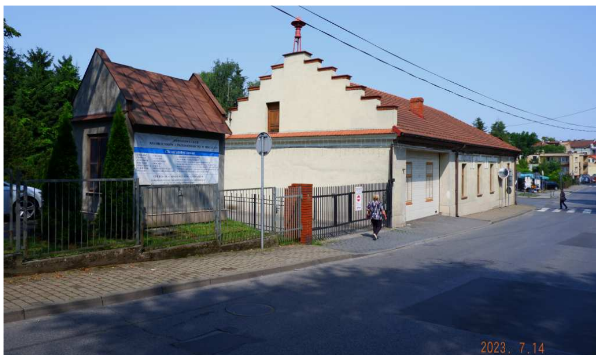
Fot. nr 73 (73-75). Ujęcia od strony ulicy Limanowskiego.
