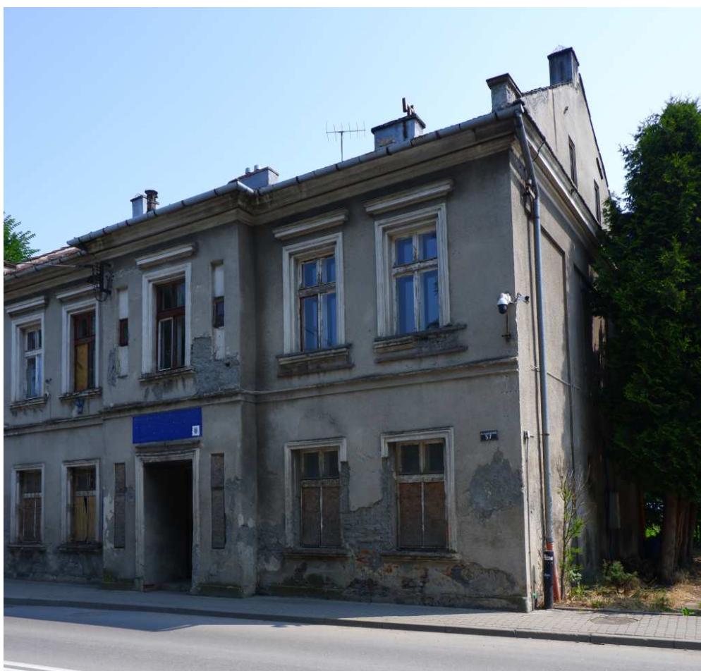
Fot. nr 149. Stacyjny budynek z przełomu XIX i XX wieku spod nr 57. (14.07.2023)
