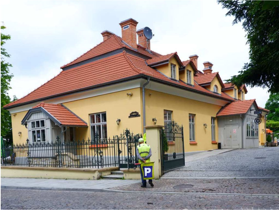
Fot. nr 112 (111-112). Elewacja południowa. (01.07.2023)
