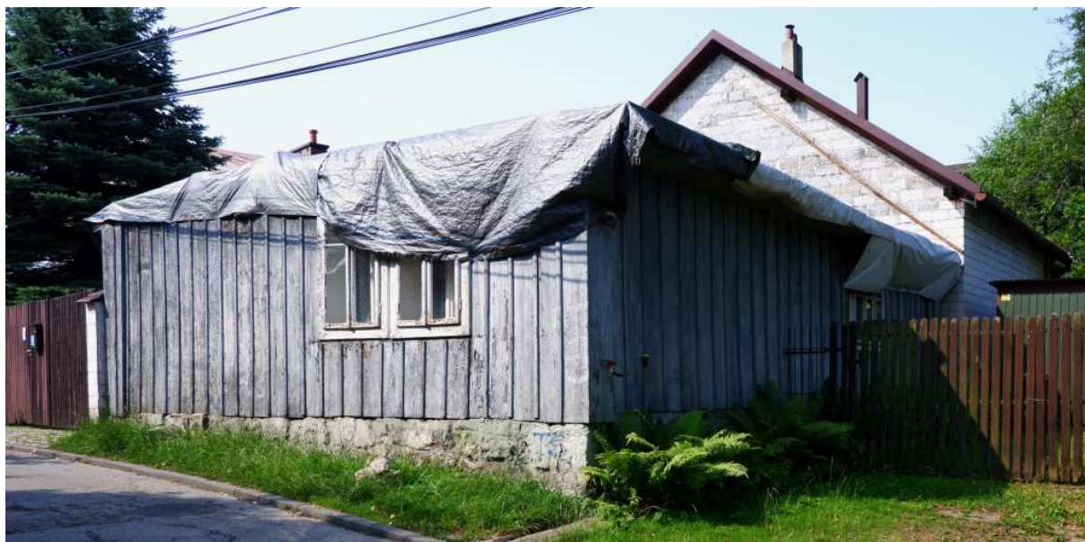
Fot. nr 190 (190-197). Wzdłuż ulicy Reformackiej. Fot. nr: 190-193. Chałupa spod 44, być może z przełomu XIX i XX wieku, zapewne na etapie rozbiórki. (14.07.2023)
