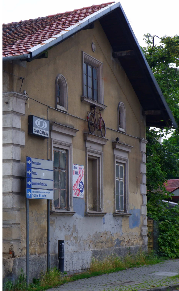
Fot. nr 58 (58-60). Widoki od strony ulicy Legionów. Ściana szczytowa. (01.07.2023)
