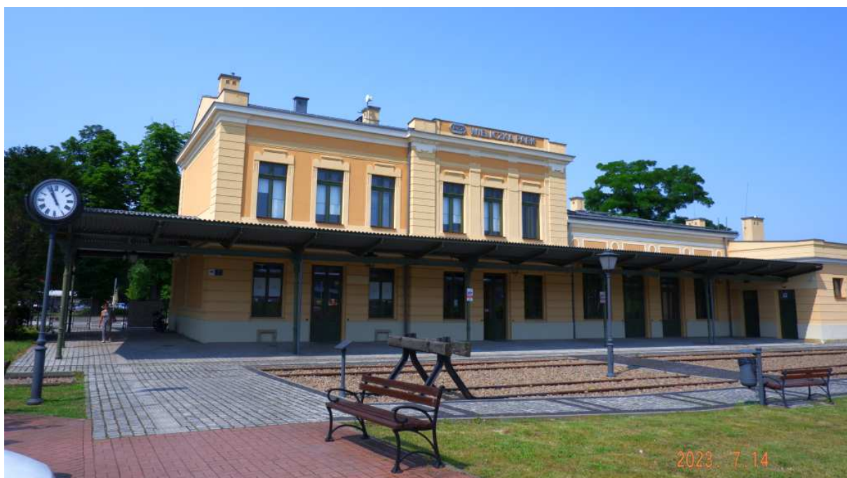
Fot. nr 151. Widok od strony peronów.
