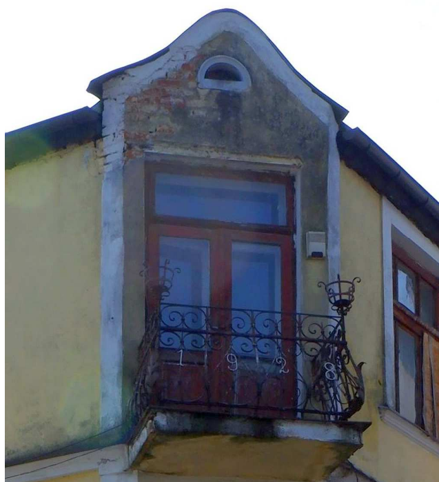
Fot. nr 67. Data budowy na balkonie II. piętra. (14.07.2023)
