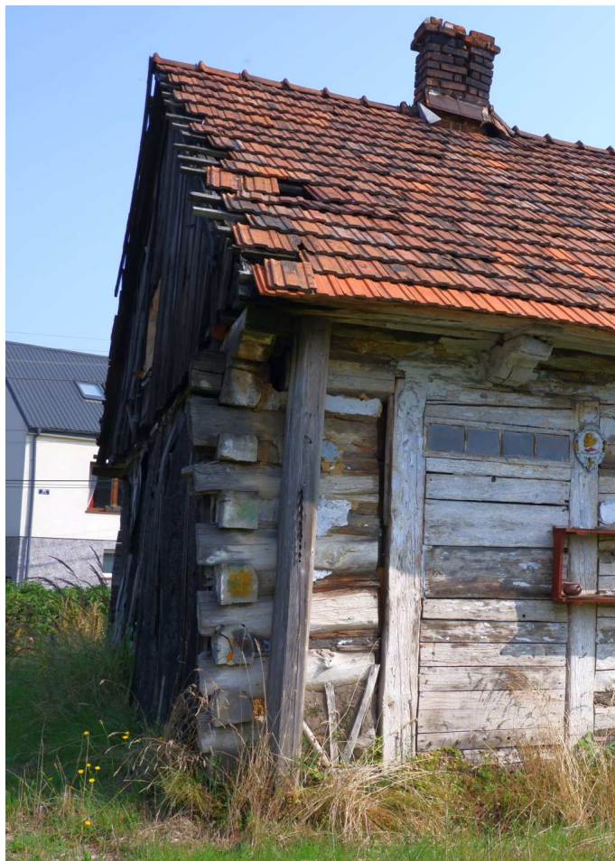
Fot. nr 180. Boczna ściana, jakby sztucznie zaślepiona i zamurowane oryginalne drzwi ze świetlikiem w przelotowej sieni. (14.07.2023)
