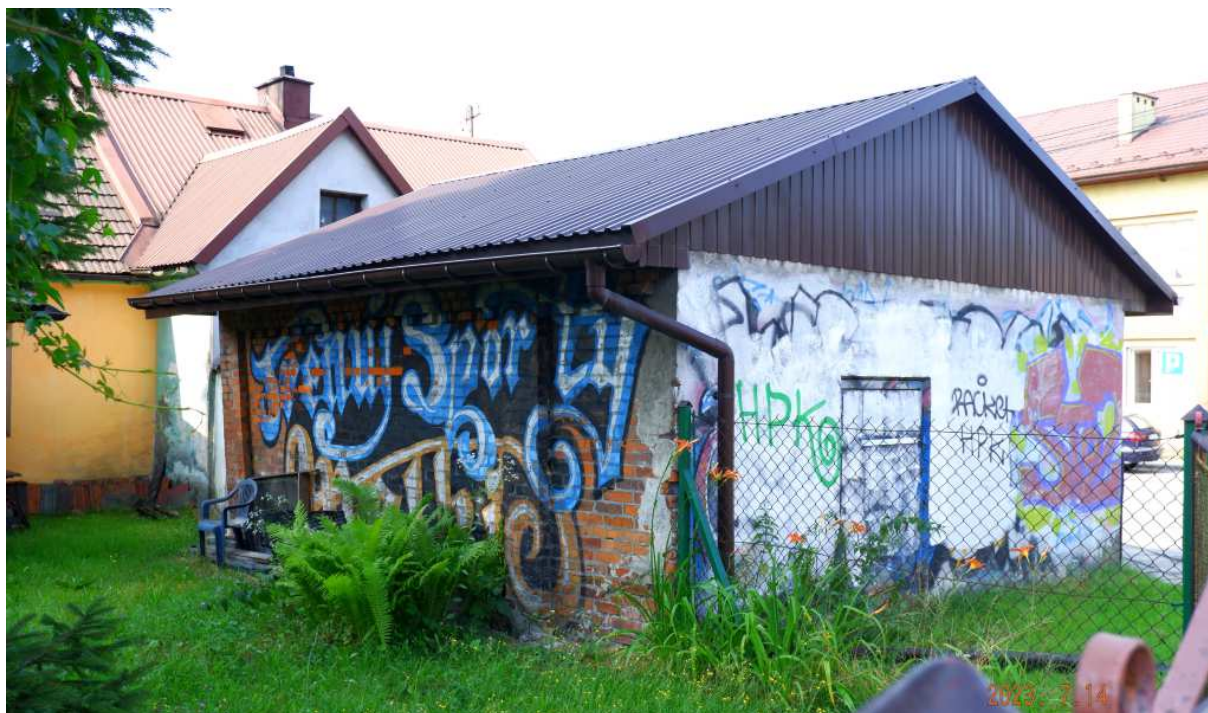
Fot. nr 165. Widok z ulicy Długiej.
