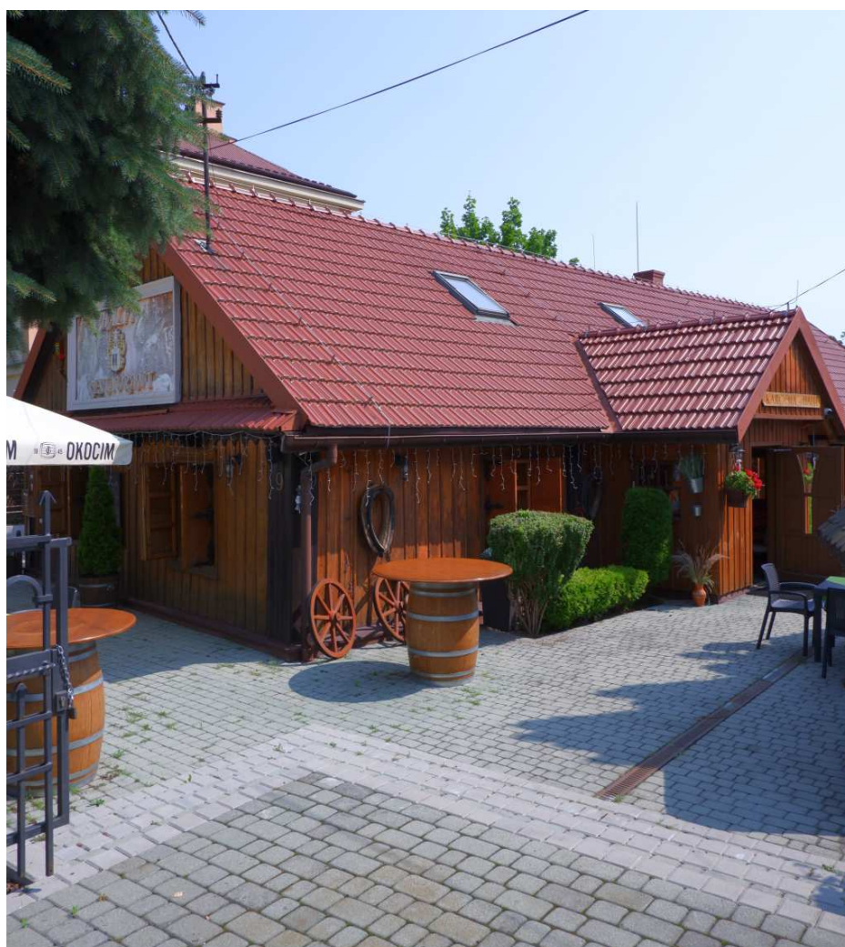
Fot. nr 101. Widok z ulicy. (14.07.2023)
