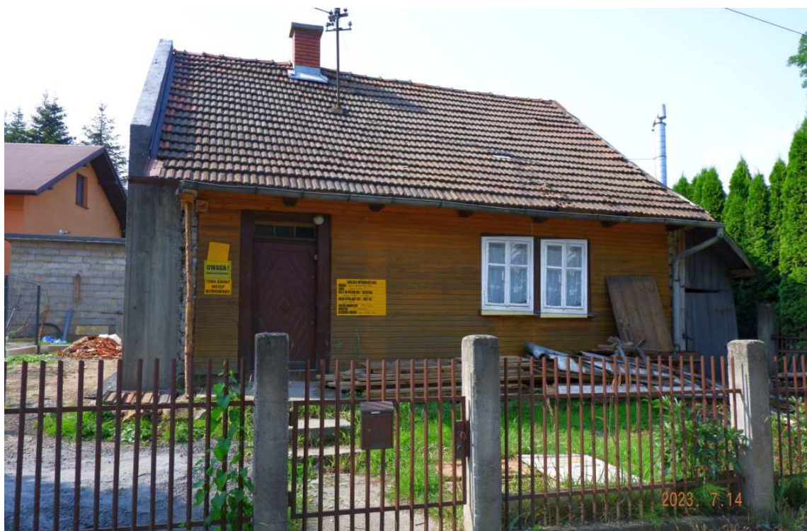
Fot. nr 169. Próba rekonstrukcji fasady z oryginalnymi oknami.
