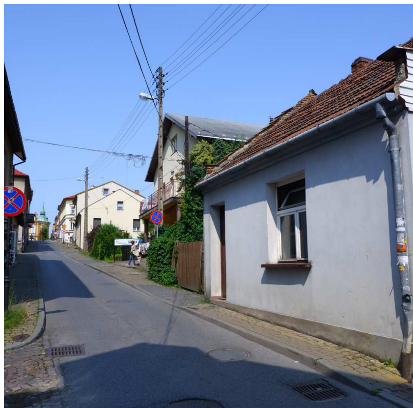
Fot. nr 82. Pierzeja ulicy o parzystych numerach poniżej domu o nr 10. (14.07.2023)
