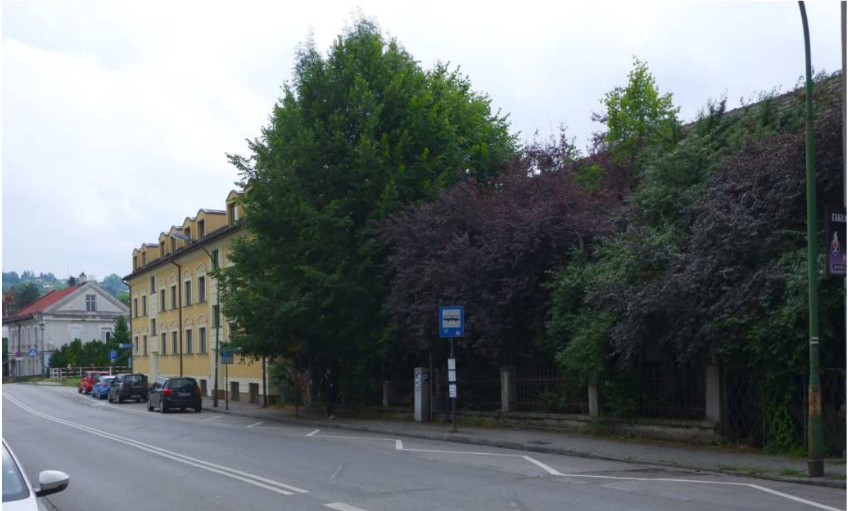
Fot. nr 46. Fragment zabudowy ulicy Mickiewicza o nr: 10 i 12. Budynek w zespole dawnego starostwa po nr 12 (z prawej) całkowicie popadł w ruinę i zarósł. (01.07.2023)
