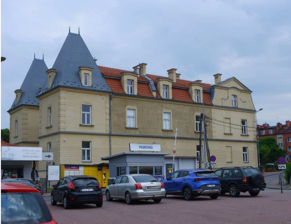
Fot. nr 138. Lewy bok w ujęciu od strony dworca autobusowego. (01.07.2023)
