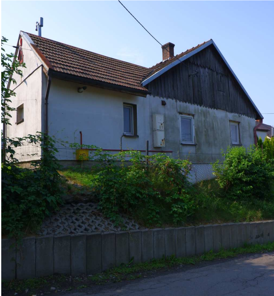
Fot. nr 188. Widok z ulicy Długiej. (14.07.2023)
