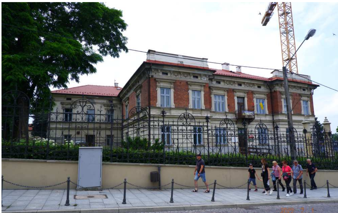
Fot. nr 115 (115-117). Gmach dawnego Sądu Grodzkiego pod nr 12, wybudowany pod koniec XIX wieku. Jeszcze nie tak dawno mieścił się tutaj to budynek szkolny Zespołu Szkół Zawodowych, a dziś swą siedzibę mają tu biura Muzeum Żup Krakowskich.
