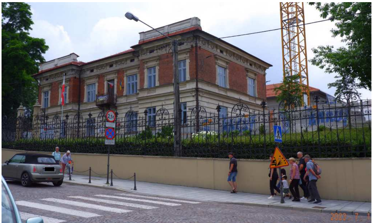
Fot. nr 117. Z prawej trwa dobudowa nowego skrzydła.
