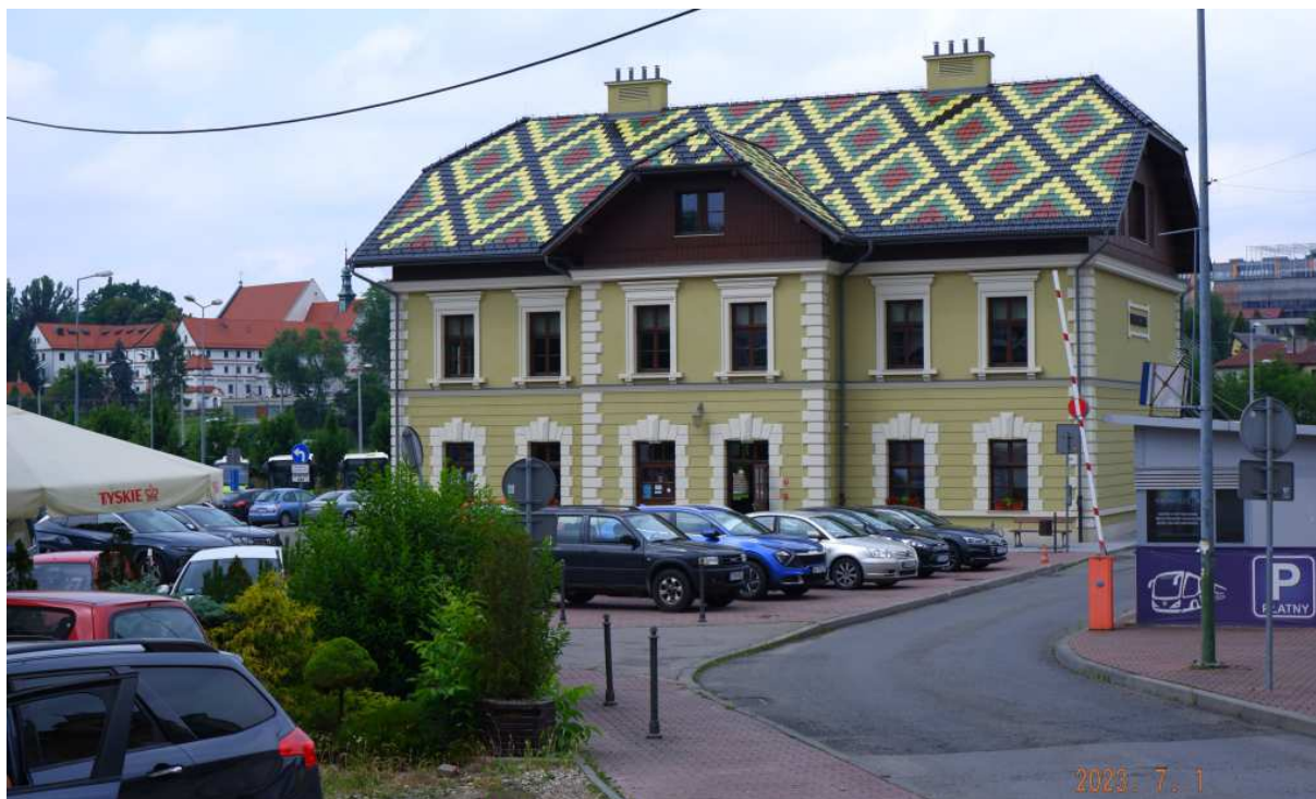
Fot. nr 140 (140-143). Nowo wybudowany pod nr 7 w roku 2021 budynek dworca autobusowego, który nawiązuje do solidnej architektury z czasów galicyjskich. Nie wszystko co powstaje współcześnie musi być wykonane z betonu, żelaza i szkła.
