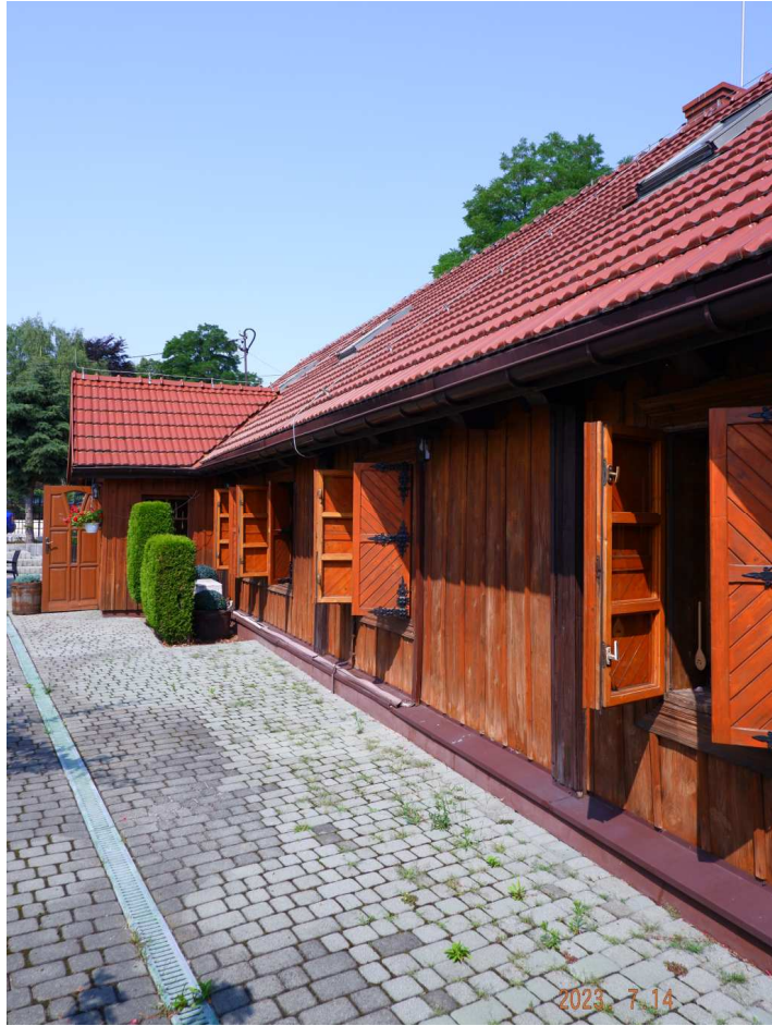
Fot. nr 102 (102-104). Elewacja południowa i jej detale.
