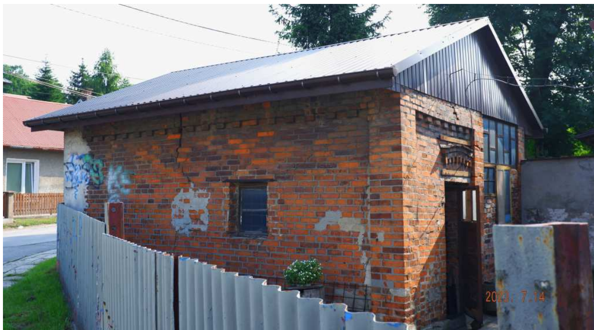
Fot. nr 164 (164-165). Pomieszczenie gospodarcze na posesji pod nr 2 – widok z ulicy Boguckiej
