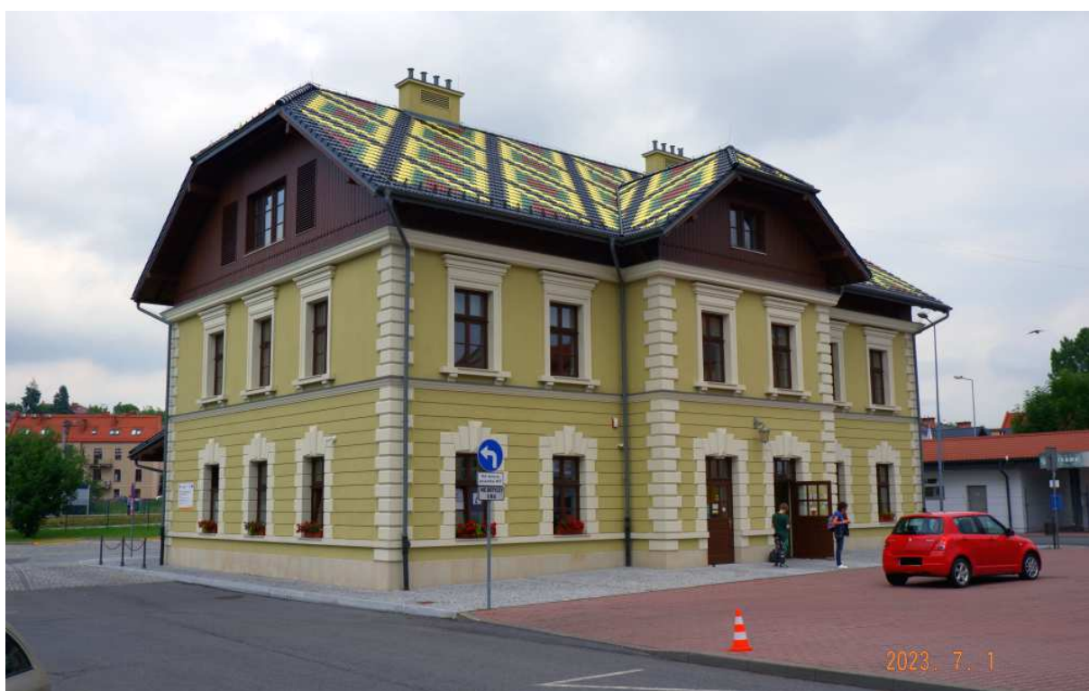
Fot. nr 141 (140-141). Widoki od strony ulicy Dembowskiego. Dach nieco szokujący swym kolorytem.
