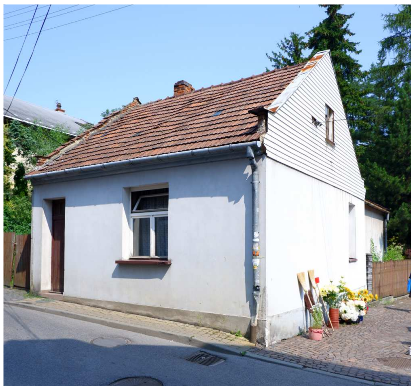
Fot. nr 83. Murowany domek pod nr 10 z początku XX wieku. (14.07.2023)
