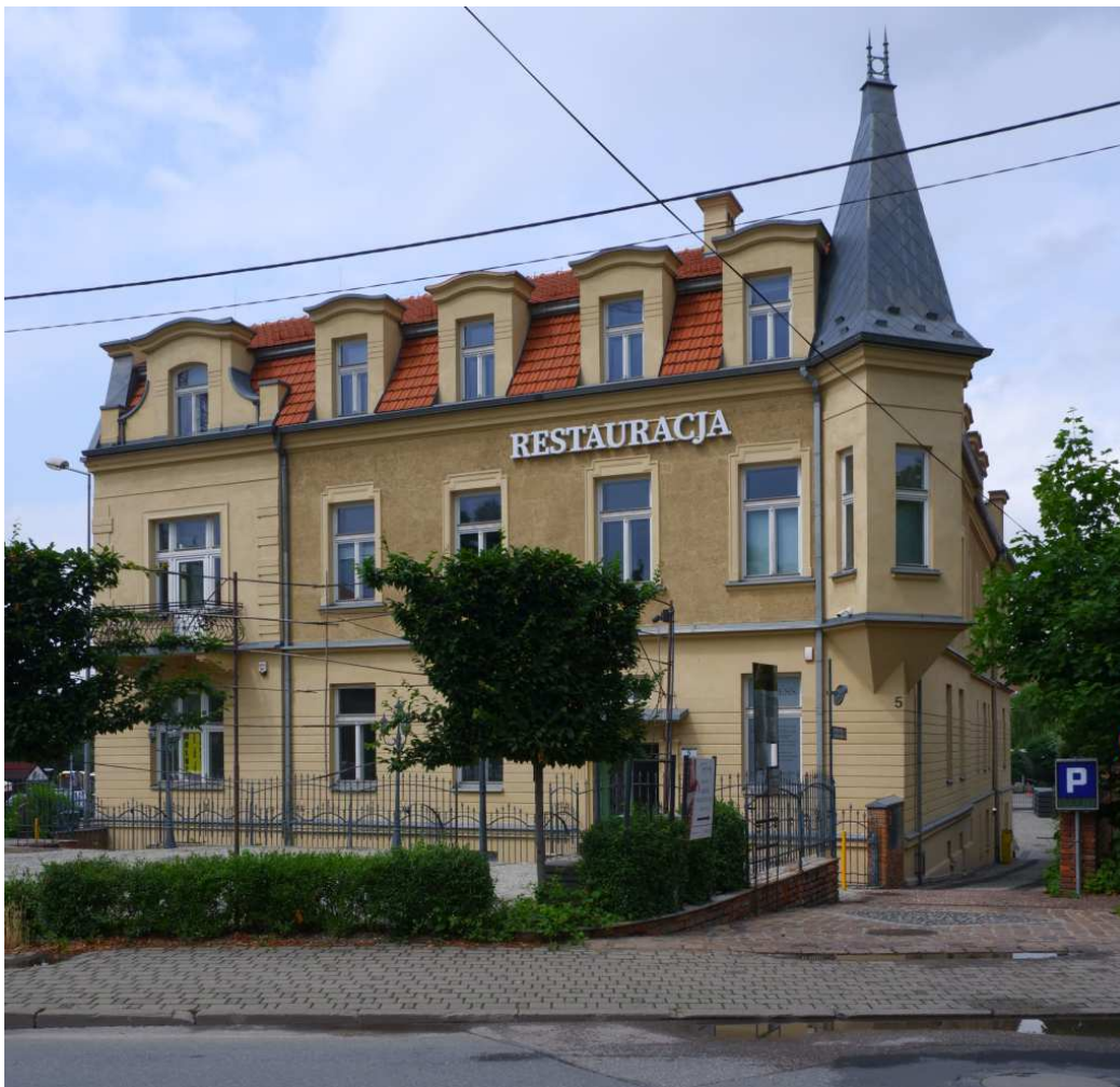
Fot. nr 135 (137-137). Fasada od strony ulicy Dembowskiego. (01.07.2023)
