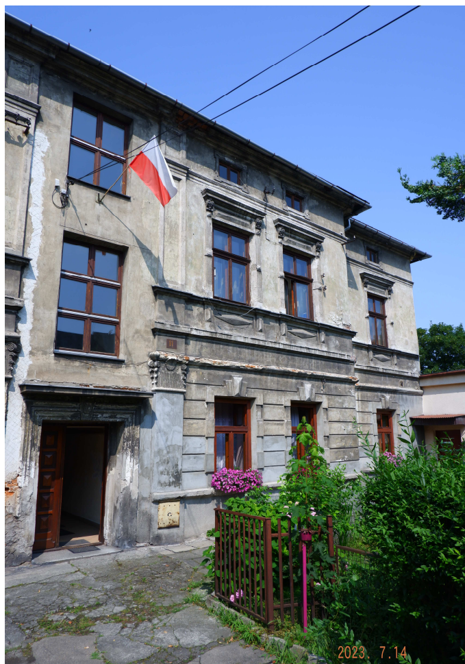
Fot. nr 94. Prawe skrzydło.
