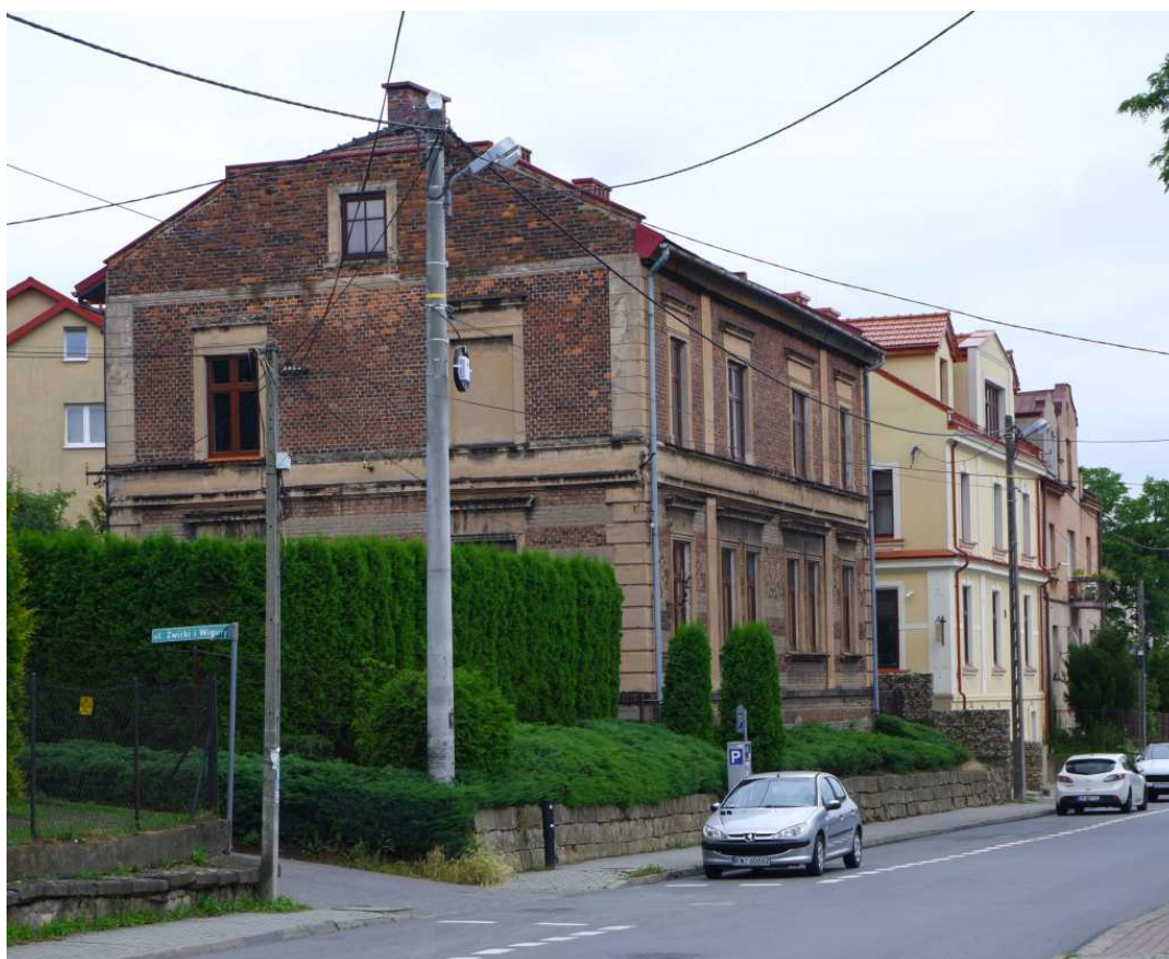
Fot. nr 39 (39-41). Domy spod nr: 6 i 8. (01.07.2023)
