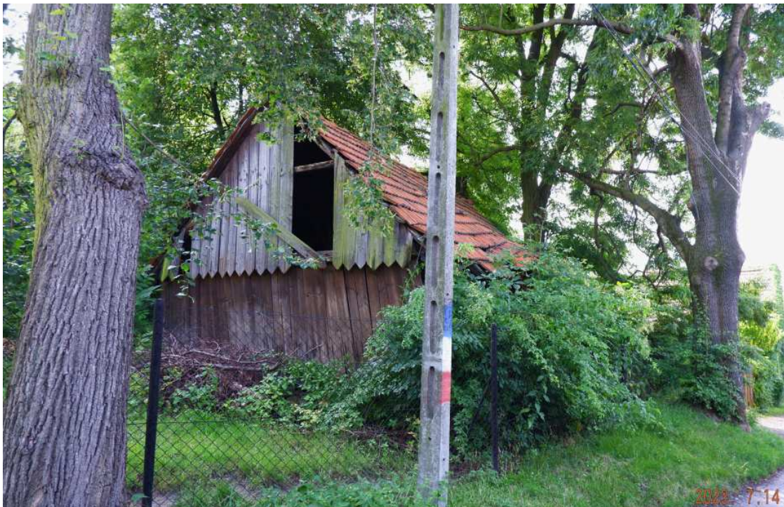
Fot. nr 189. Widoczny z ulicy Źródlanej fragment zabudowy pod nr 6, ujętej w GEZ.
