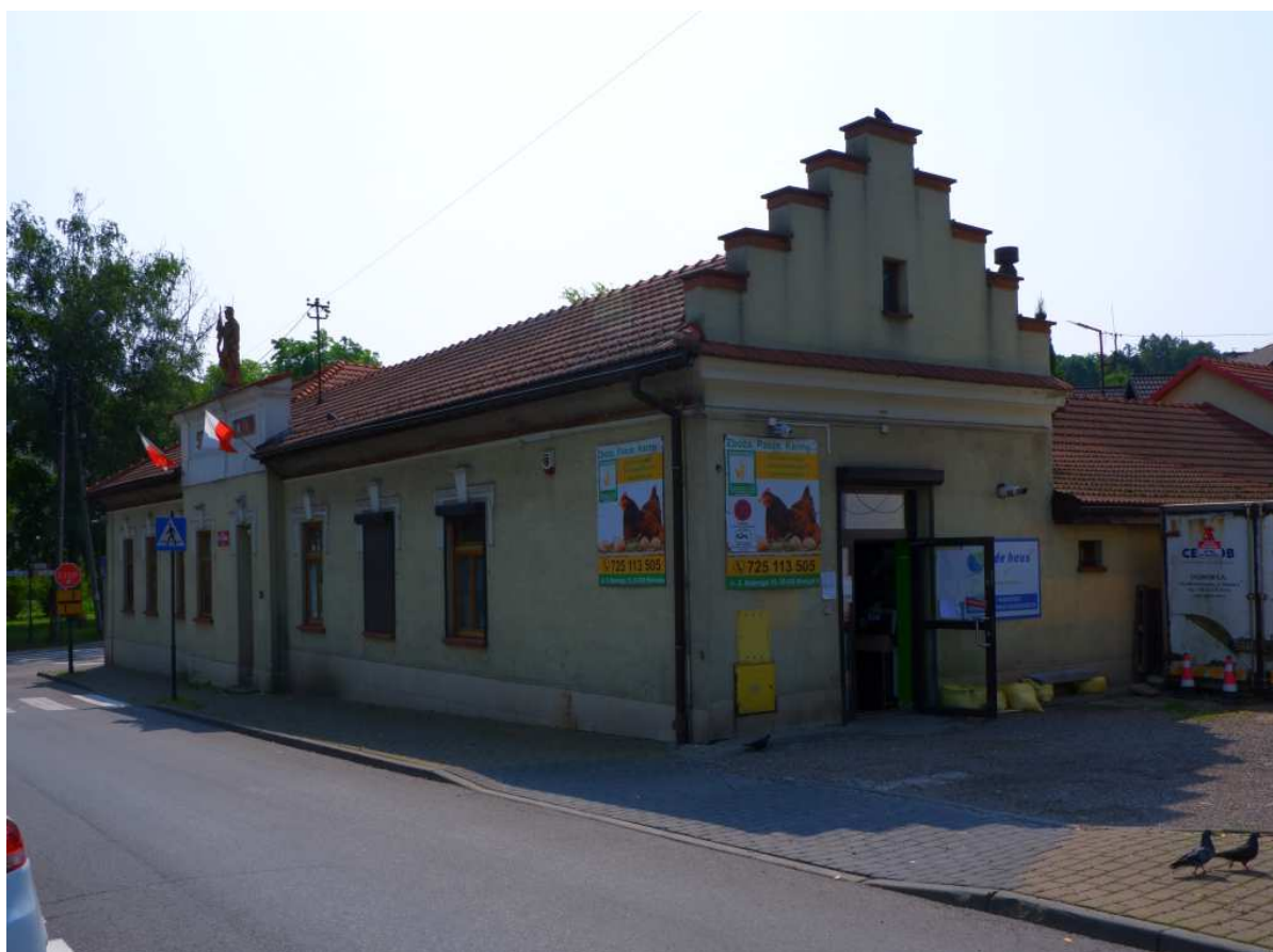
Fot. nr 72 (72-75). Budynek Straży Ogniowej pod nr 15, wybudowany na przełomie XIX i XX wieku, obecnie zajmowany przy Ochocticzą Straż Pożarna. (14.07.2023)
