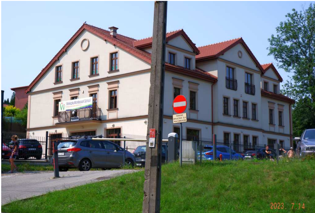
Fot. nr 98. Budynek pod nr 2, gdzie mieści się siedziba Wieliczka Montessori School.
