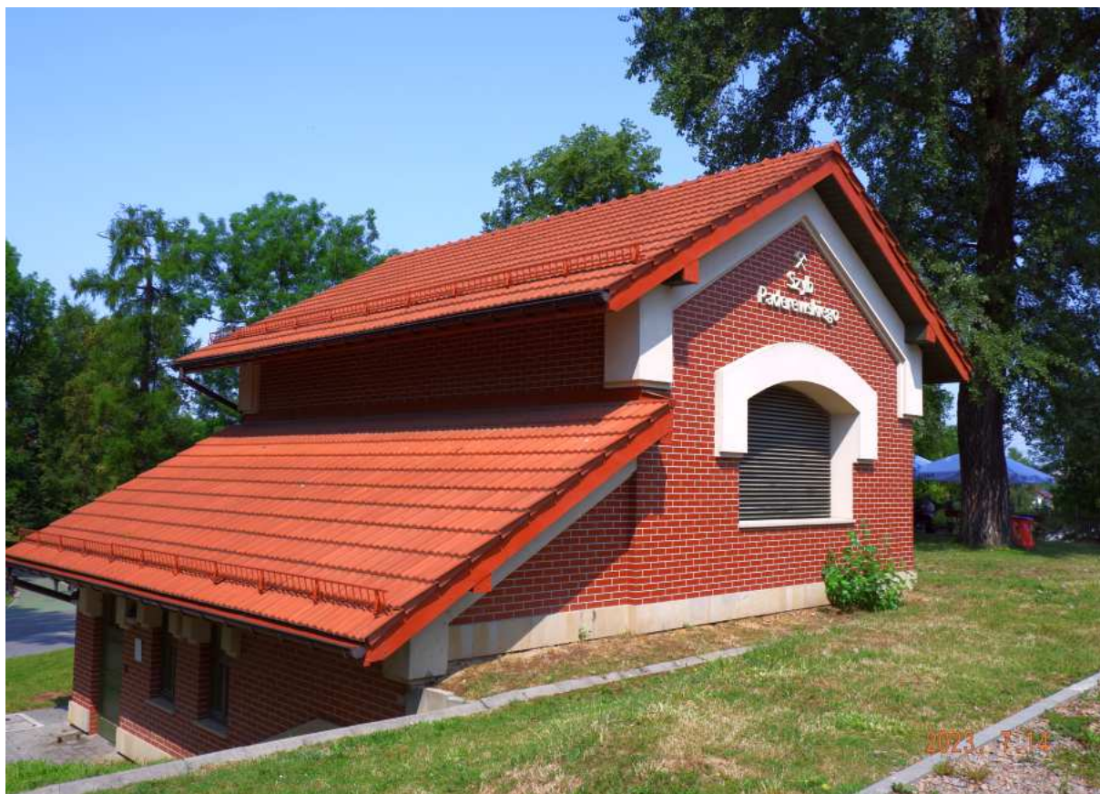
Fot. nr 108 (108-110). Szyb Paderewskiego na zapleczu szybu Daniłowicza.
