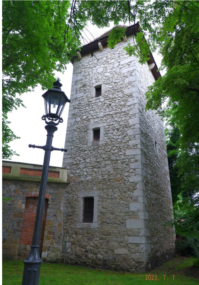
Fot. nr 124. Gotycka baszta przylegając do Zamku Żupnego.
