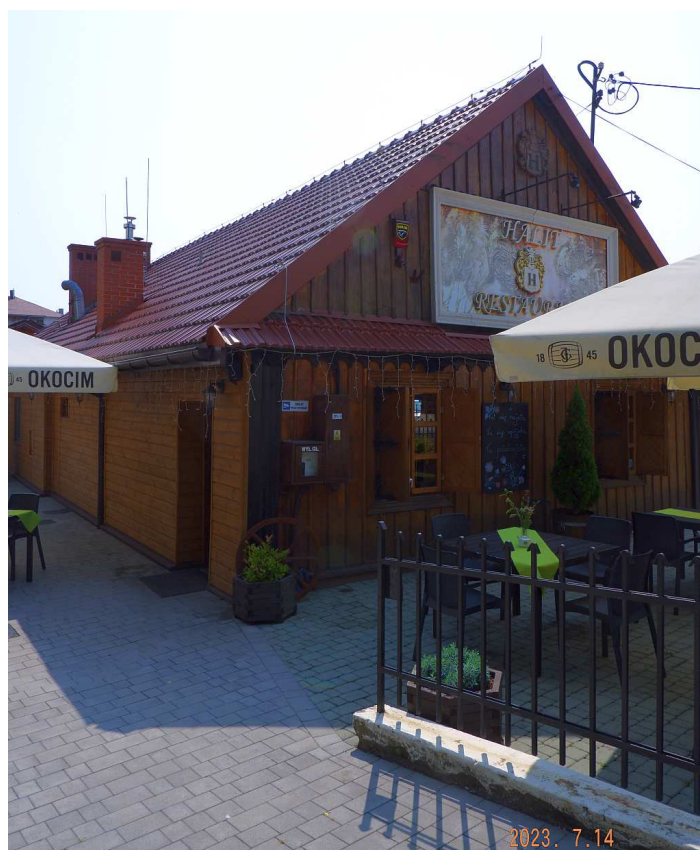
Fot. nr 105. Ściana szczytowa i fragment elewacji północnej.
