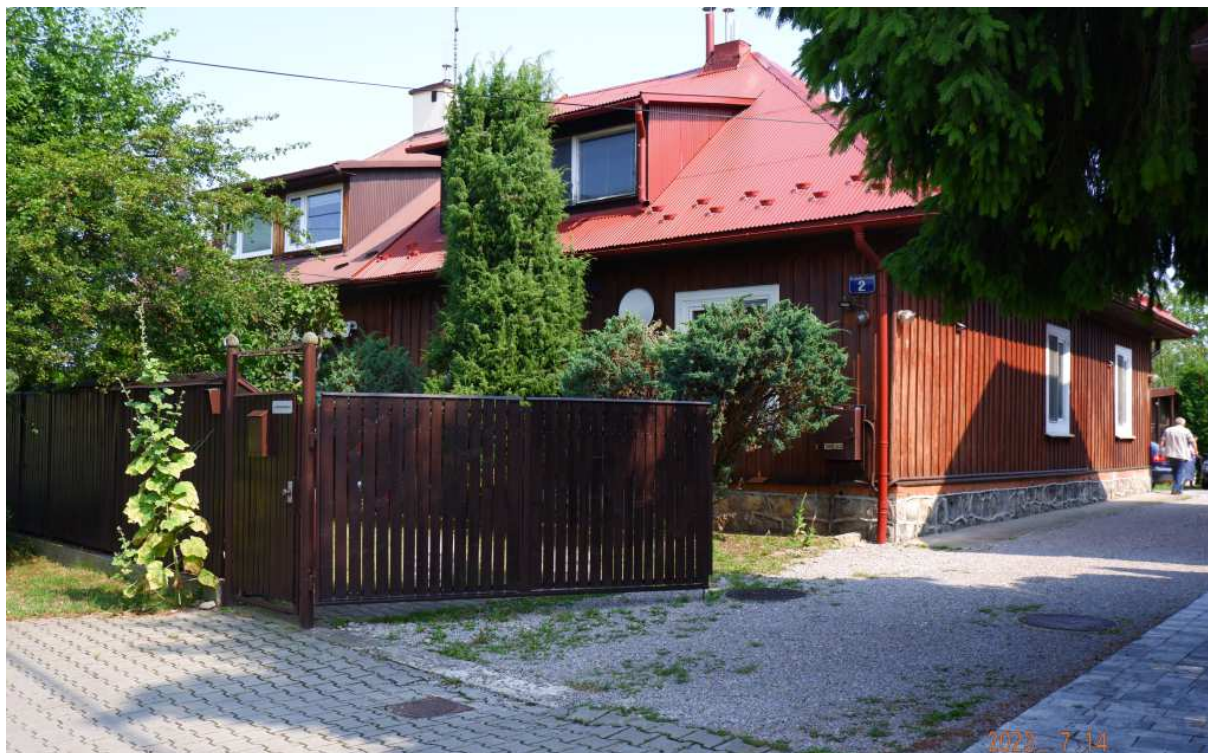
Fot. nr 210 (210-211). Współcześnie zniekształcony dom spod nr 2, wybudowany na przełomie XIX i XX wieku, ujęty w GEZ. (14.07.2023)
