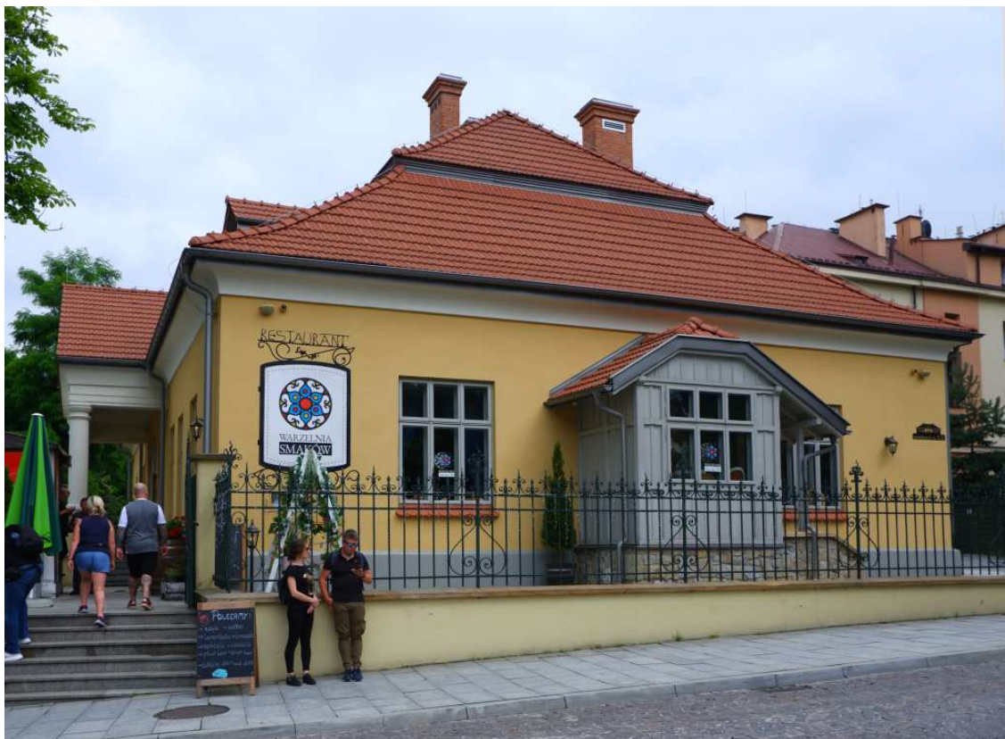
Fot. nr 113. Ściana szczytowa od strony ulicy. (01.07.2023)
