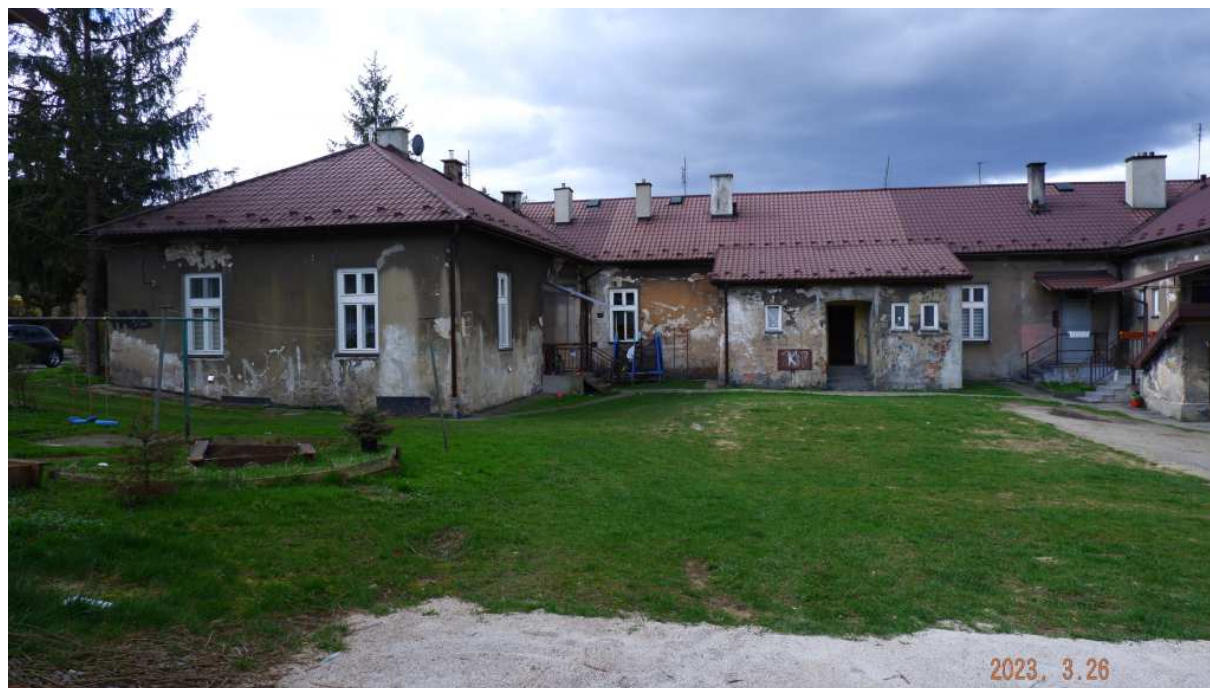
Fot. nr 254 (254-255). Widoki na zaplecze od strony podwórka.
