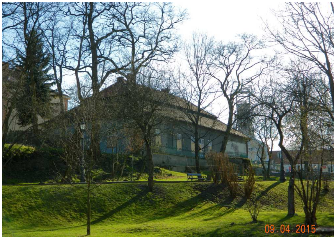
Fot. nr 214 (214-220). Zmiany w wyglądzie tzw. „Markszajdrówki” spod nr 13, czyli siedziby dawnych mierniczych górniczych (markszajderów). Ten stylowy dom, z łamanym dachem, wg GEZ) powstał przed rokiem 1783, pierwotnie zapewne w stylu barokowym.
