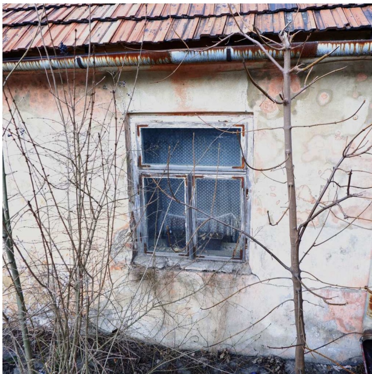
Fot. nr 460. Oryginalne okno trójskrzydłowe w prawym budynku. (14.03.2023)
