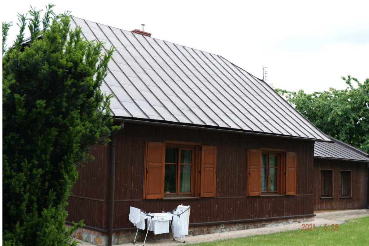
Fot. nr 352 (352-353). Elewacja południowa.
