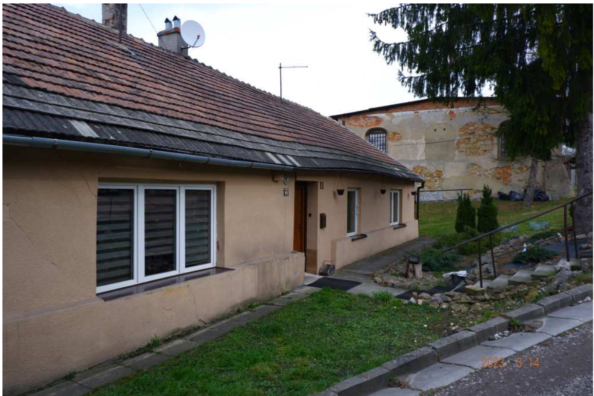
Fot. nr 401. Widok spod domu o numerze 11.
