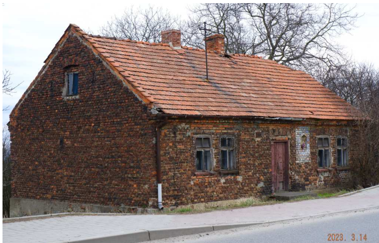
Fot. nr 455. Próba rekonstrukcji fasady.
