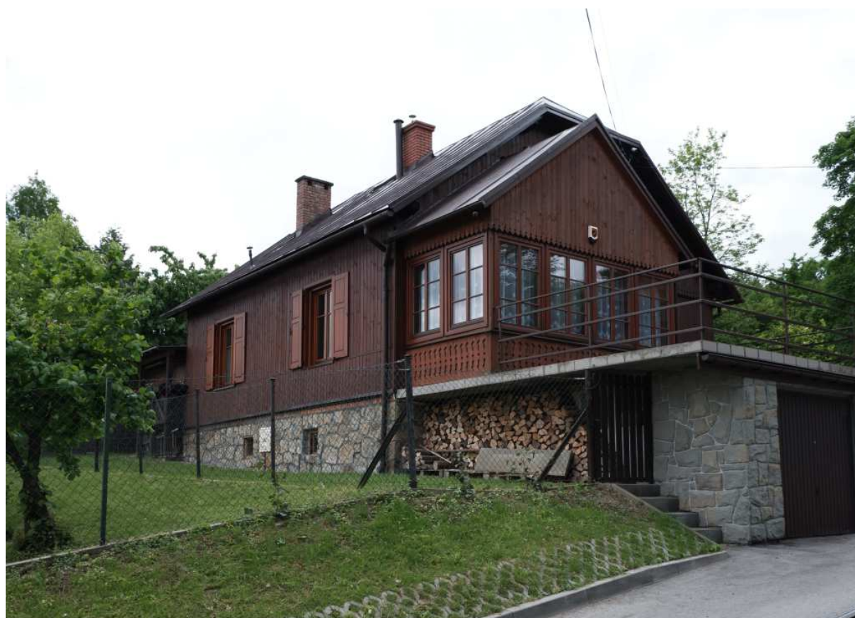
Fot. nr 349. Elewacja północna. (28.05.2021)
