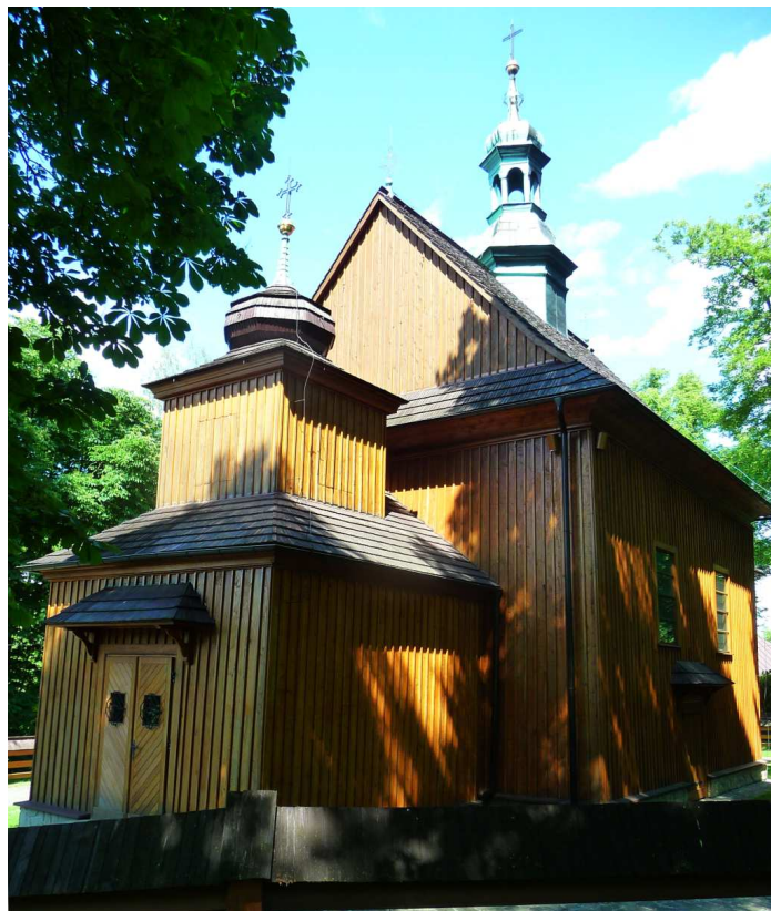
Fot. nr 336 (336-340). Elewacja południowa. (30.05.2022)
