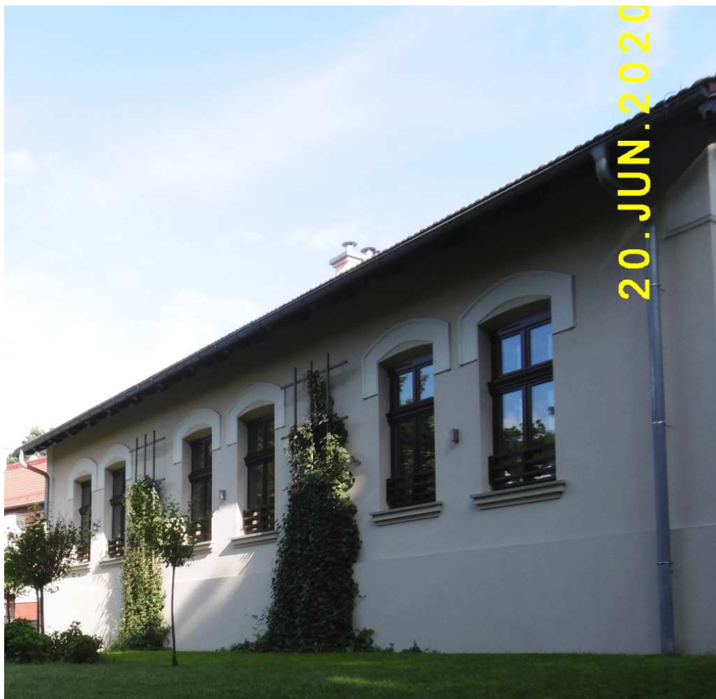
Fot. nr 85 (85-86). Zrekonstruowany budynek czy raczej wybudowany od nowa, jak dawna Turówka. Ale wygląda to dobrze.
