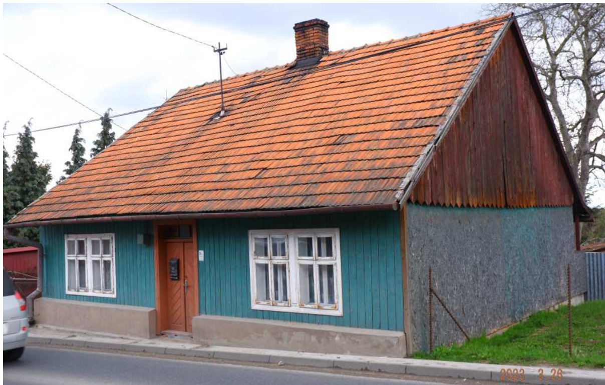
Fot. nr 322. Obita szalunkiem fasada z oknami typu skrzynkowego.
