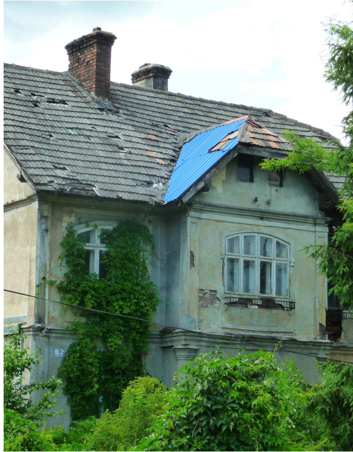
Fot. nr 129. Ryzalit z oryginalnym oknem. (14.06.2022)
