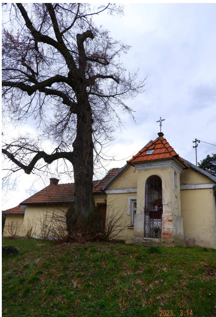
Fot. nr 473 (473-476). Przylegająca do budynku kapliczka typu domkowego.
