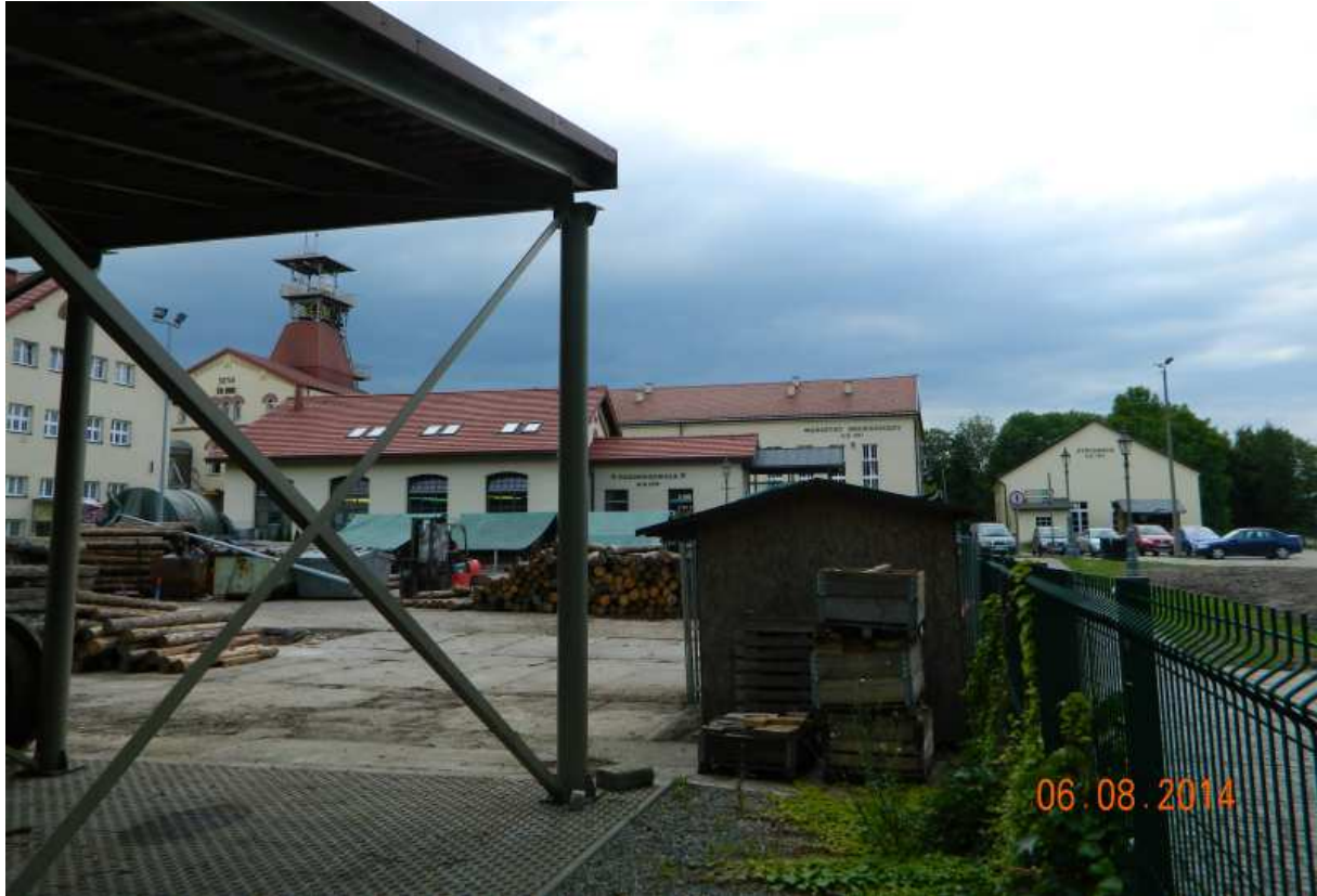
Fot. nr 68. Z fragmentem młyna solnego z lewej. Pośrodku budynki: dawnej parowozowni, a za nim dawnego przyszybowego warsztatu mechanicznego. Z prawej budynek dawnej stolarni.
