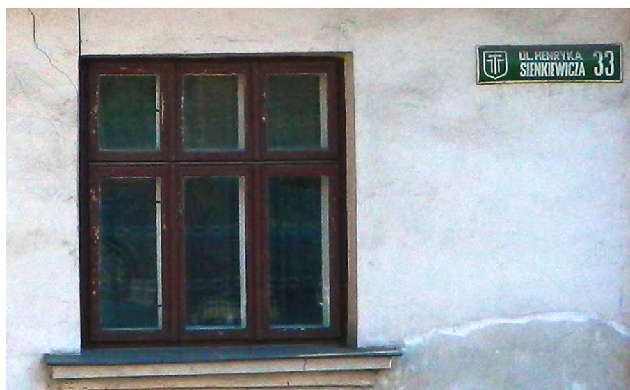
Fot. nr 277. Oryginalne okno typu weneckiego.
