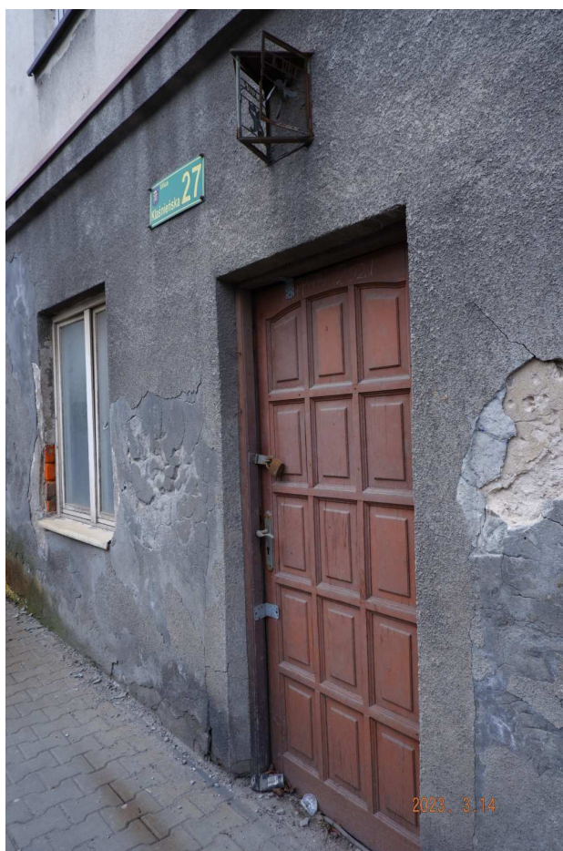
Fot. nr 385. Fragment elewacji domu pod nr 27.
