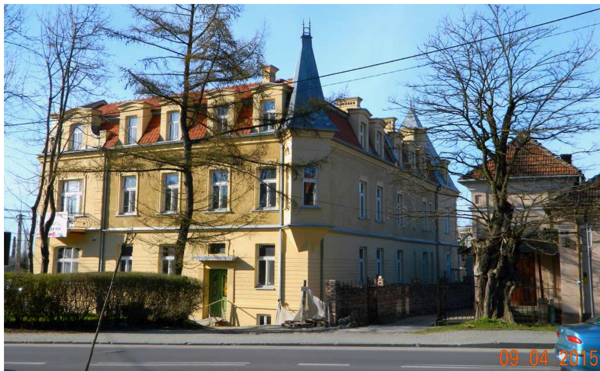
Fot. nr 208 (208-209). Odnowiona, eklektyczna kamienica spod nr 5, pochodząca zapewne z I. ćwierci XX wieku.
