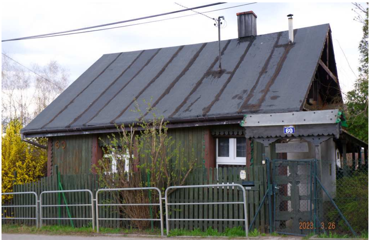
Fot. nr 315. Współczesne okna w zniekształconej fasadzie.
