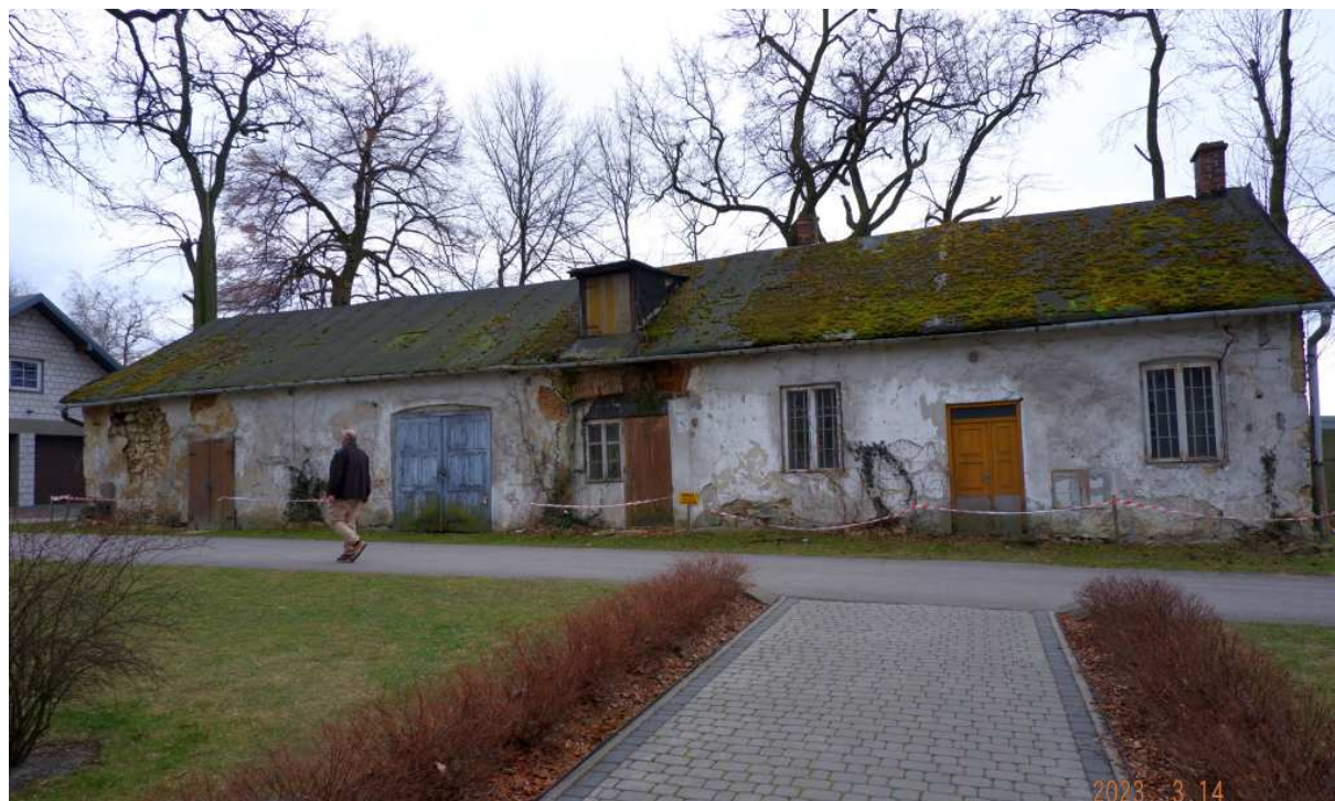
Fot. nr 445. Widok od strony dworu.
