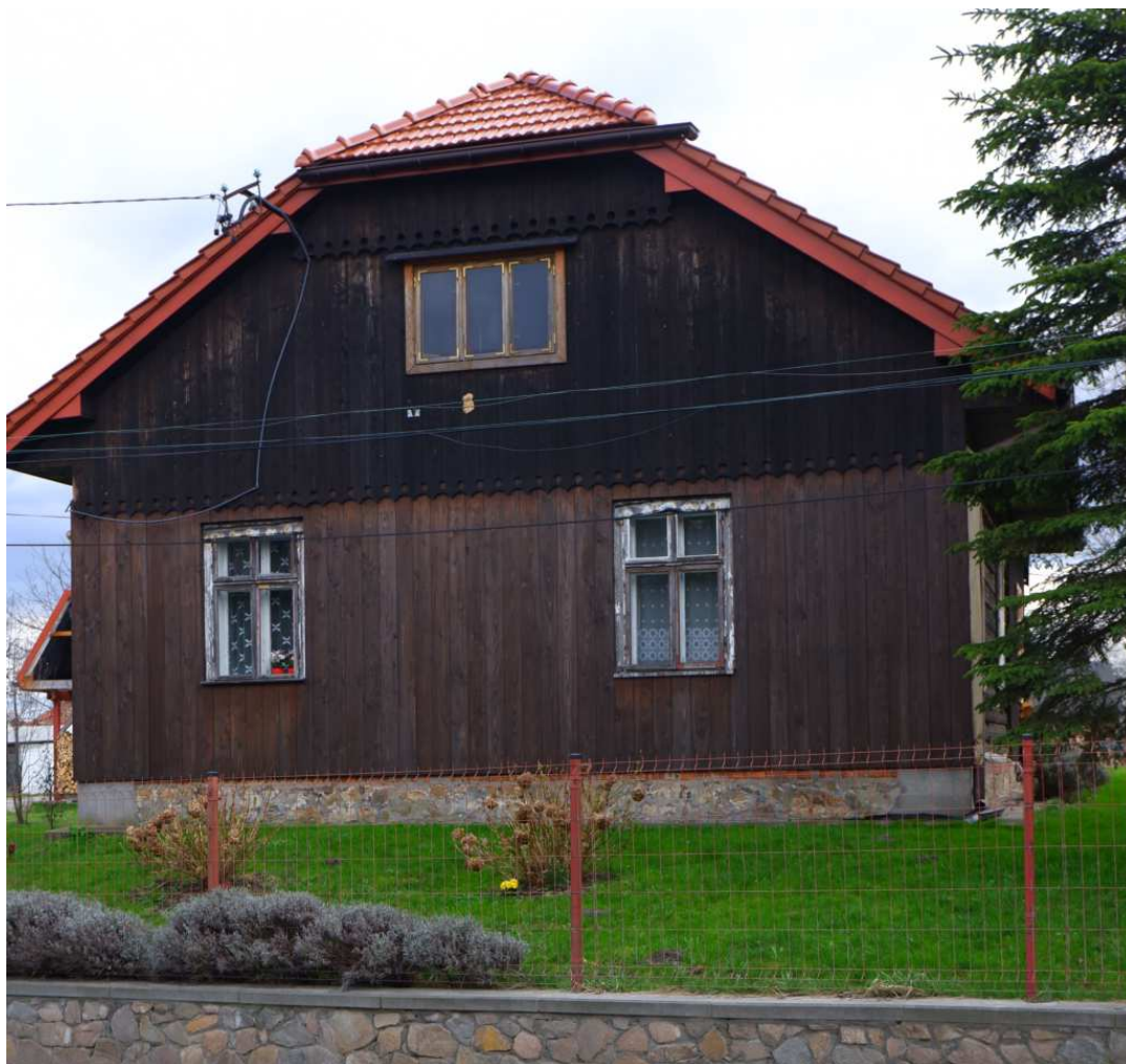
Fot. nr 282 (282-283). Ściana szczytowa z oknami typu skrzynkowego. (26.03.2023)
