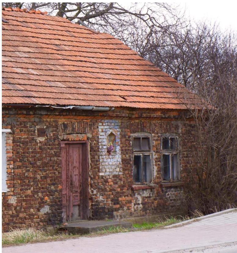
Fot. nr 456. Zachowany do dziś oryginalny fragment. (14.03.2023)
