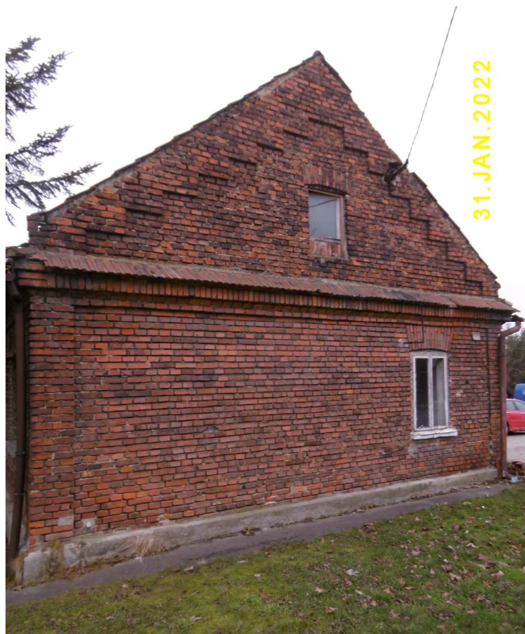
Fot. nr 126. Oryginalna ściana szczytowa.
