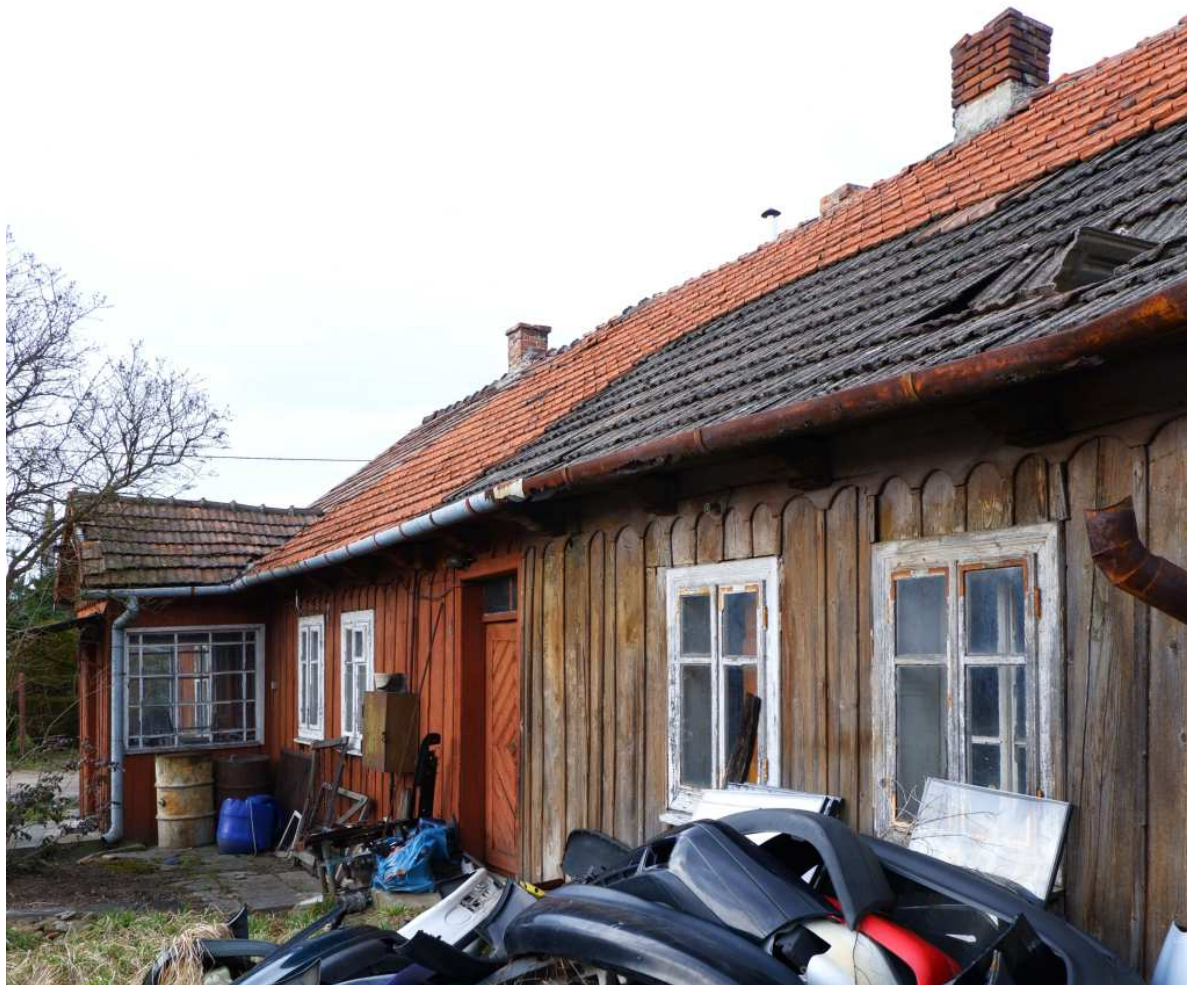
Fot. nr 464. Widok od strony podwórka. (14.03.2023)
