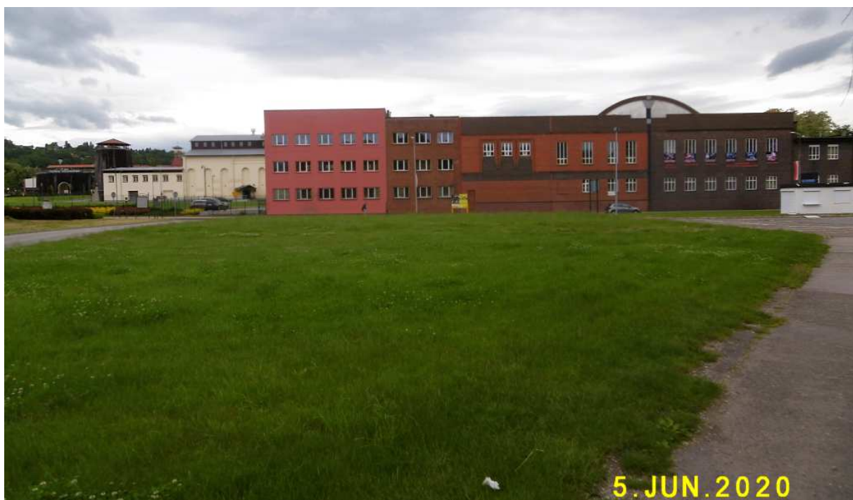
Fot. nr 203. Widok w stronę zabudowań KSW. Z prawej dawny budynek warsztatu mechanicznego, zaś z lewej elektrycznego; w głębi fragment warzelni.
