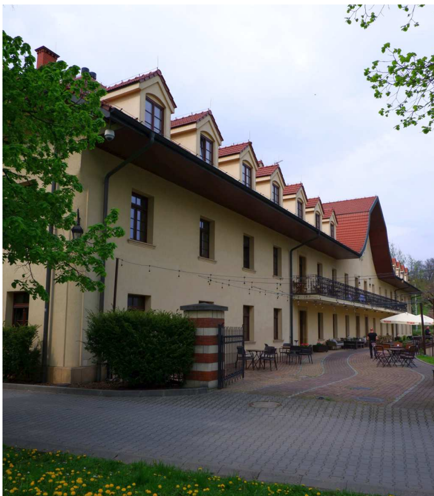
Fot. nr 191. Tylna część. (07.05.2022)
