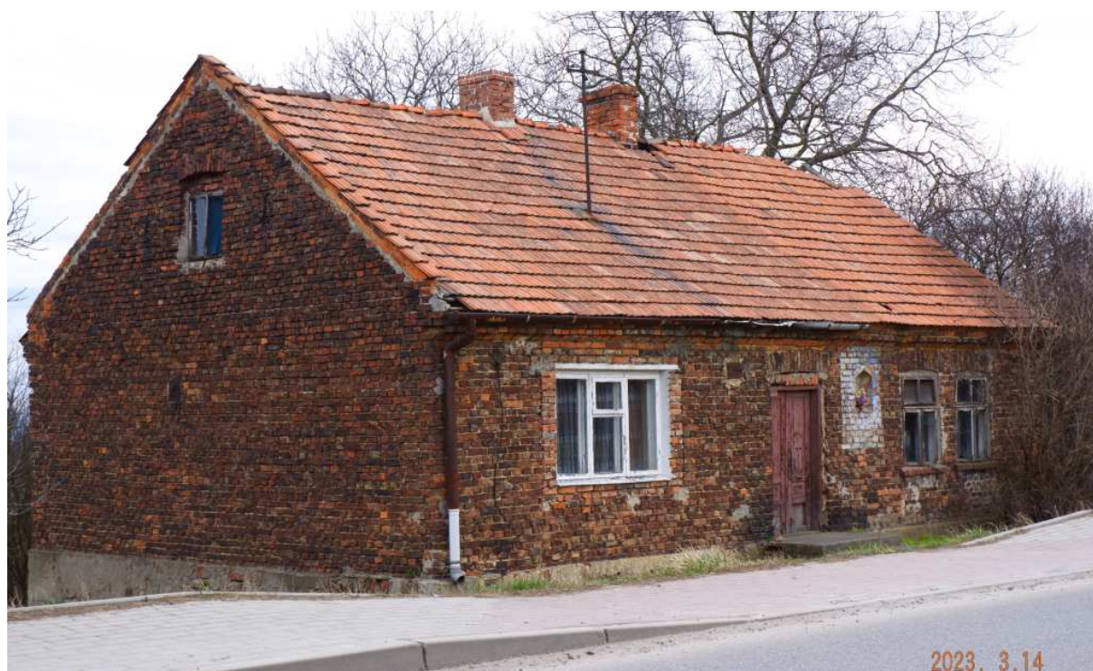
Fot. nr 454 (454-456). Murowany, zapewne międzywojenny dom spod nr 144. Stan obecny.
