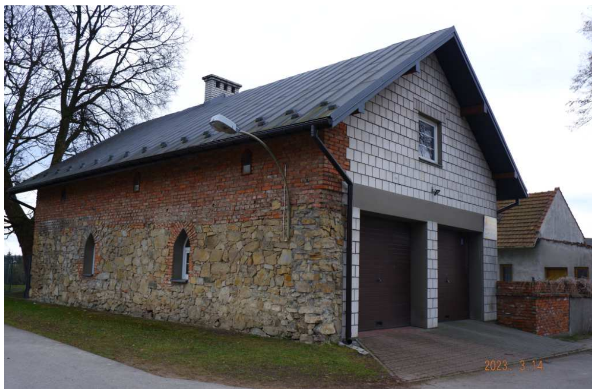
Fot. nr 446. Budynek gospodarczy po prawej stronie dziedzińca.
