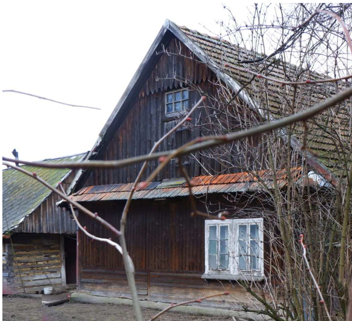
Fot. nr 467. Ściana szczytowa i oryginalne okna typu ościeżnicowego. (14.03.2023)
