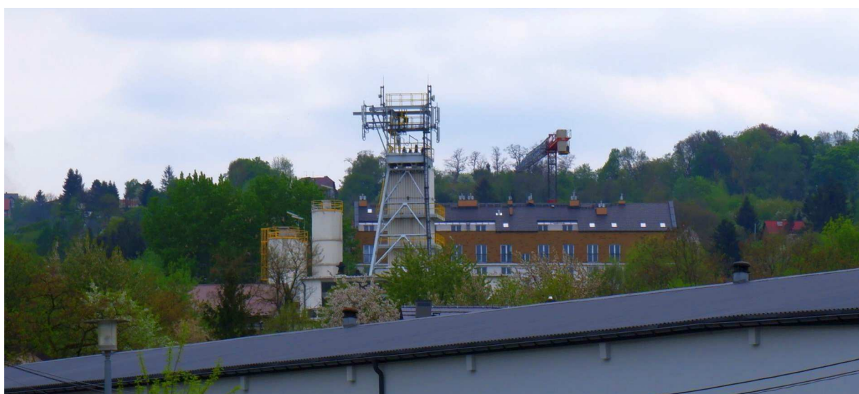
Fot. nr 233. Szyb Kościuszko ponad zabudowaniami KS Wieliczka. (07.05.2022)
