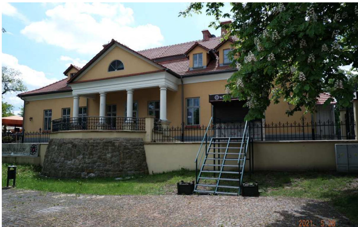
Fot. nr 216 (216-222) Widoki po odnowie, połączonej z częściową rekonstrukcją. Widok z alei Jana Pawła II, z dobudowanym portykiem.
