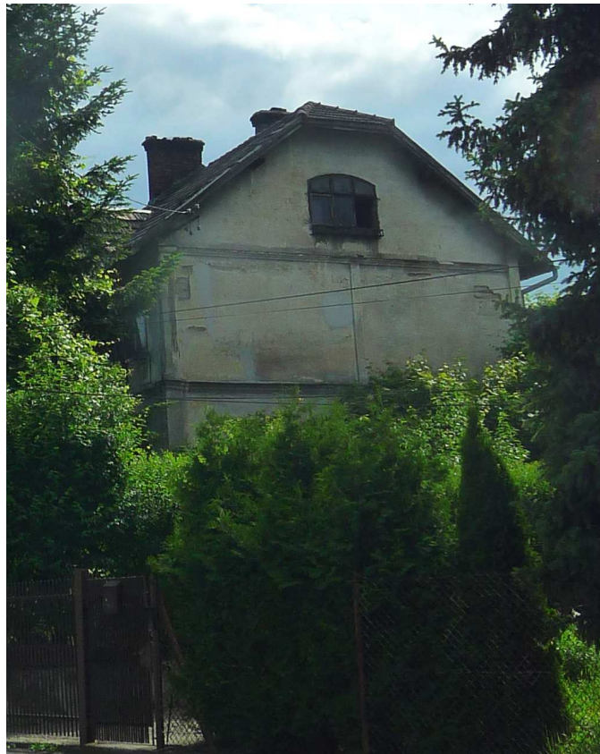
Fot. nr 130. Boczna ściana szczytowa z oryginalnym oknem na poddaszu. (14.06.2022)
