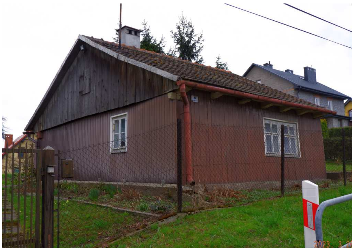
Fot. nr 326 (326-327). Obity blachą dom pod nr 6. W fasadzie tego zapewne ok. 100-letniego obiektu zachowały się jedynie oryginalne okna typu skrzynkowego.
