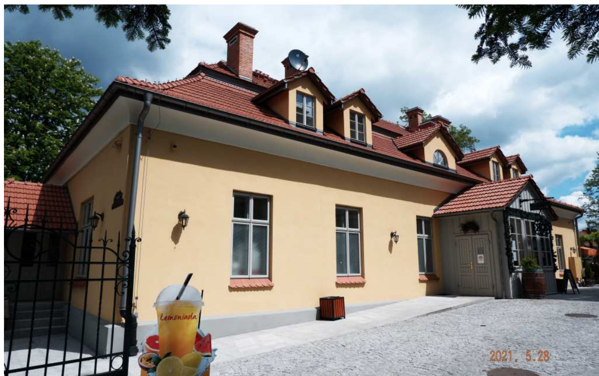
Fot. nr 220. Elewacja północna.
