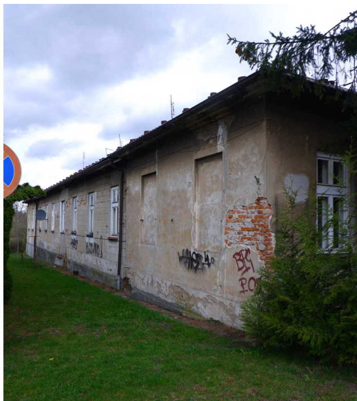
Fot. nr 253. Fasada od strony ulicy. (26.03.2023)
