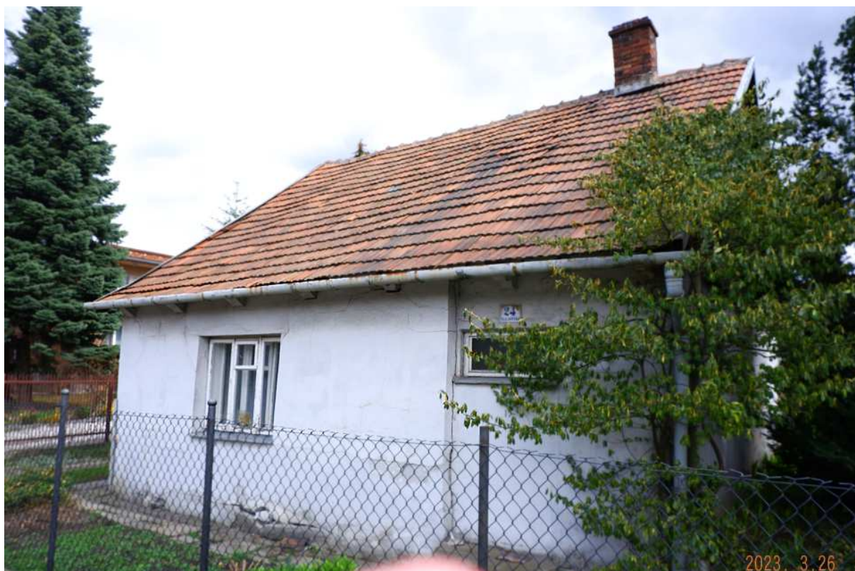
Fot. nr 286. Tynk zapewne przykrył drewnianą fakturę.
