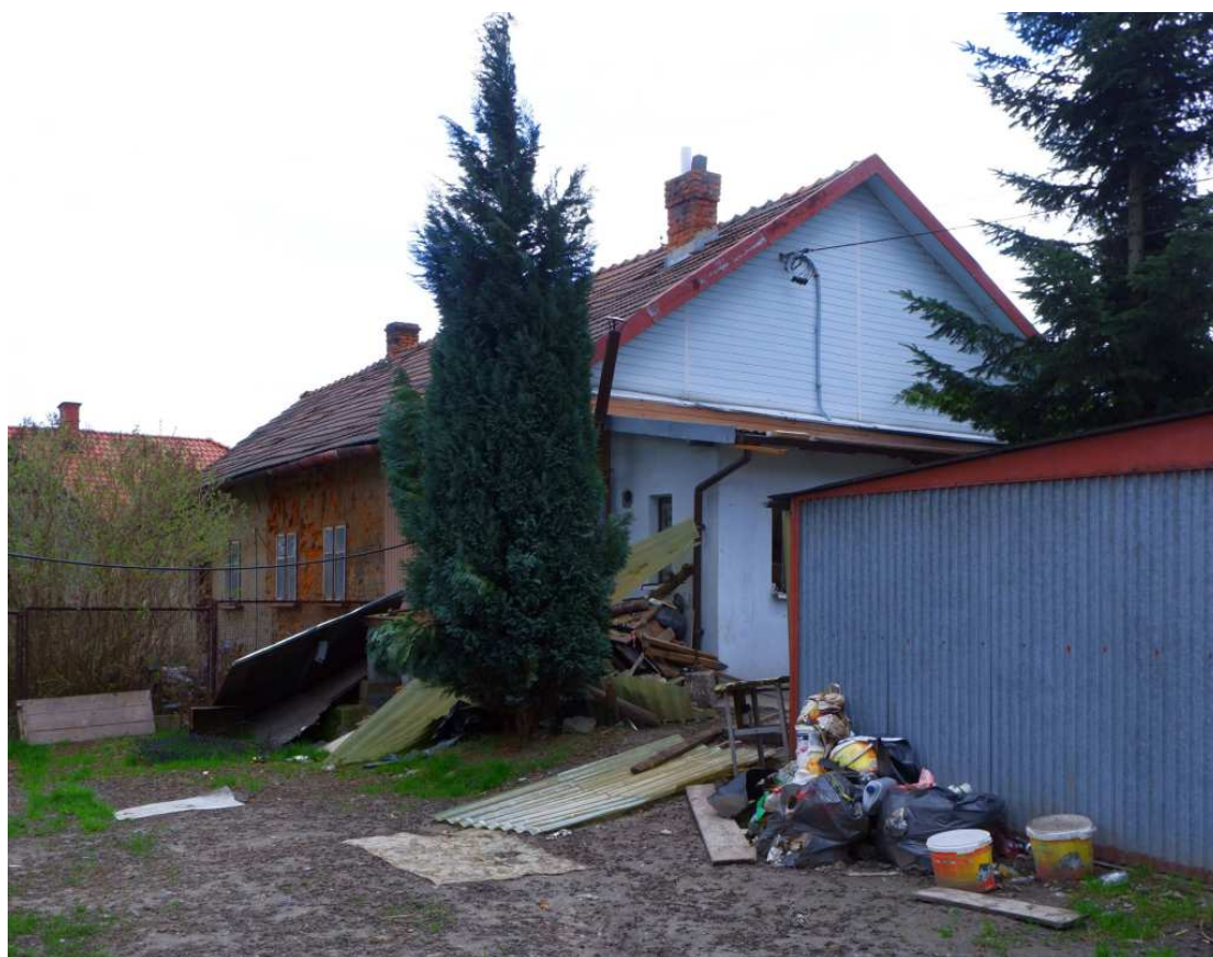
Fot. nr 307 (307-308). Zapewne dawna chałupa pod nr 24 na etapie współczesnej przebudowy.
