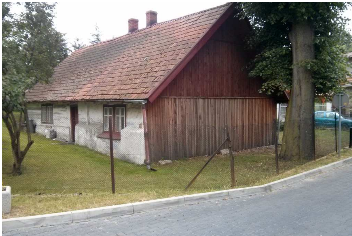
Fot. nr 248 (248-249). Fragment od strony podwórka. (29.06.2015)
