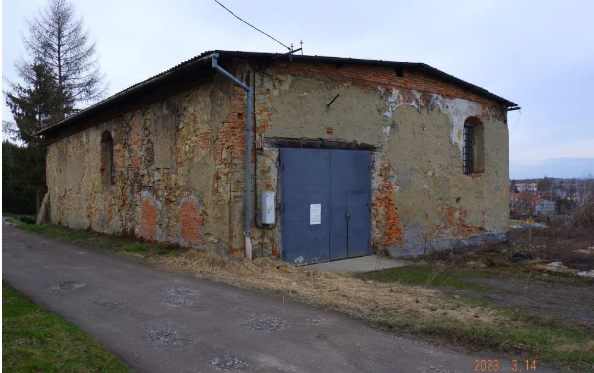
Fot. nr 398 (398-400). Ruina bożnicy pod nr 9, powstałej pod koniec XVIII. wieku.
