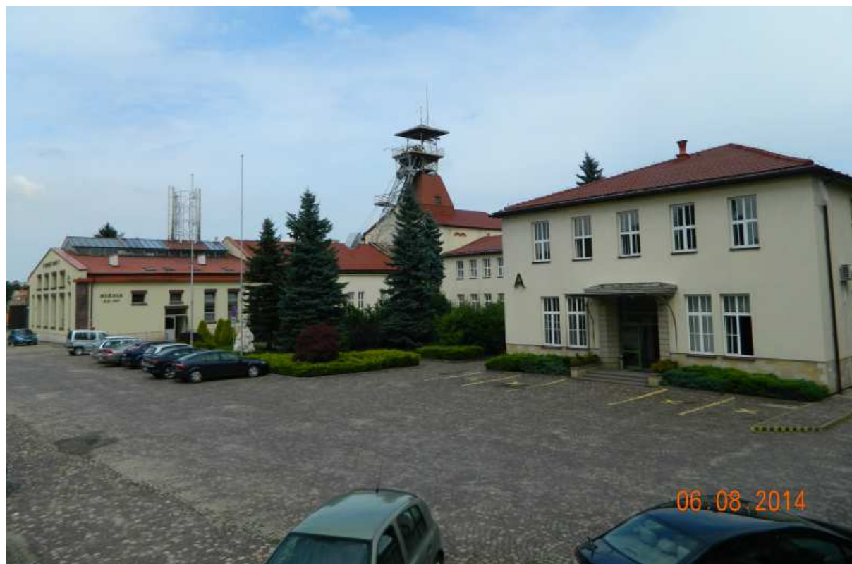
Fot. nr 64 (64-65). Serce Kopalni Soli Wieliczka – szyb św. Kingi (w tle), a obok budynki: dawnej kuźni (z lewej) i dyrekcji (z prawej).
