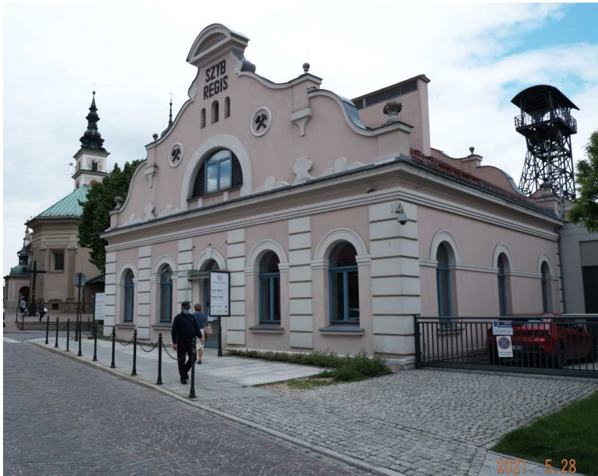
Fot. nr 32. Odnowiona fasada.
