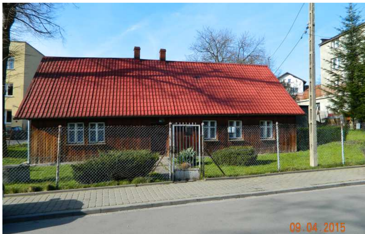
Fot. nr 247 (247-249). Nieistniejącej już stara chałupa spod nr 22. Fasada od strony ulicy, przykryta drewnianym szalunkiem.
