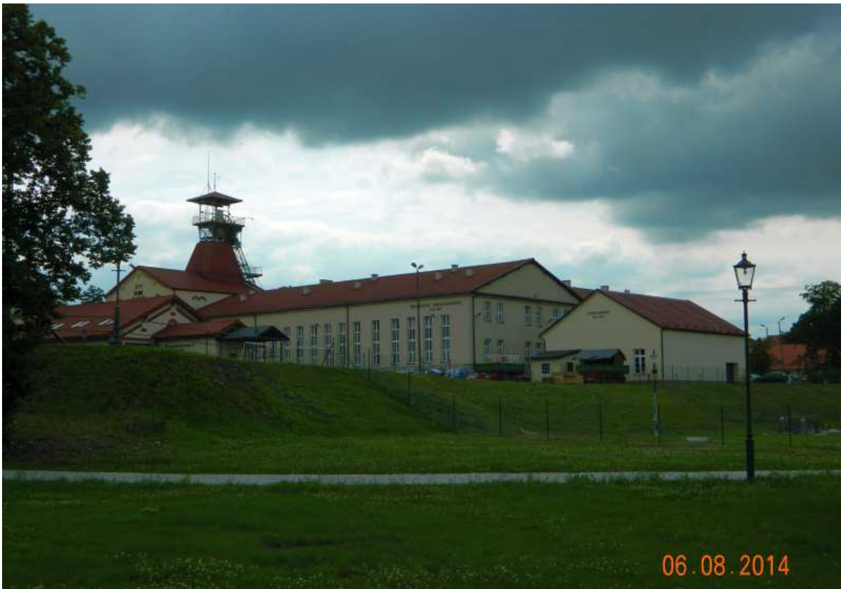
Fot. nr 67. Budynek KSW: pośrodku szybu św. Kingi i przylegającego do niego przyszybowego warsztatu mechanicznego, z lewej parowozowni, a z prawej stolarni – widok z parku św. Kingi.
