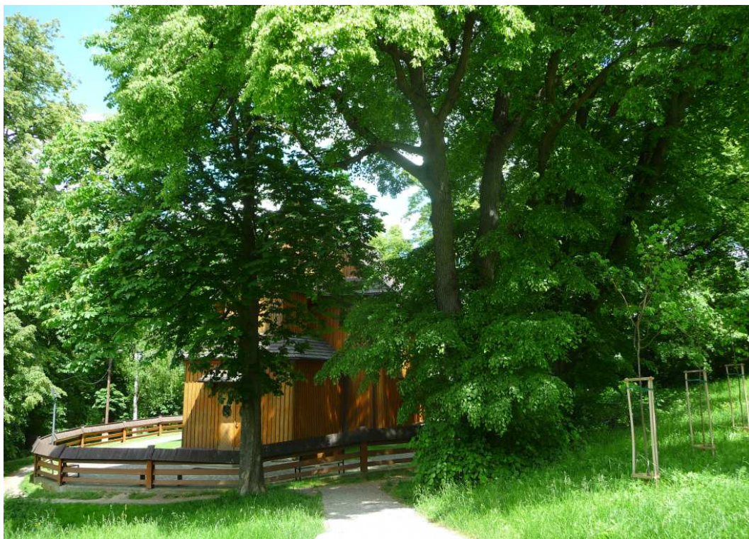
Fot. nr 332 (332-347). Wokół kościoła św. Sebastiana. Widok z parkowego zbocza na kruchtę zachodnią. (30.05.2022)
