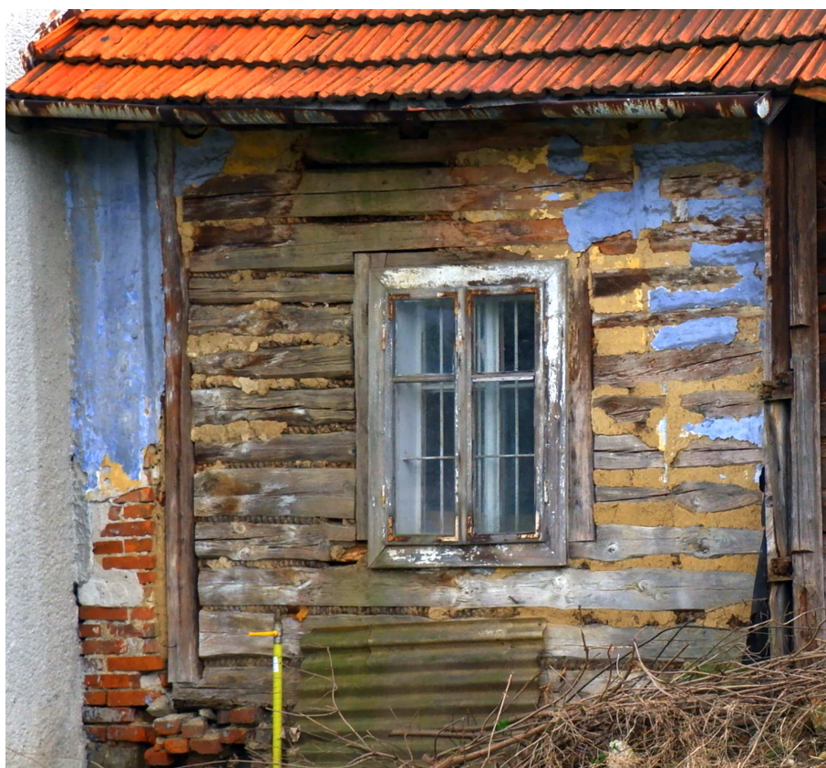
Fot. nr 319. Oryginalny detale chałupy: okno typu ościeżnicowego, drewniane belki uszczelnione warkoczami ze słomy i gliną oraz fragmenty bielienia.
