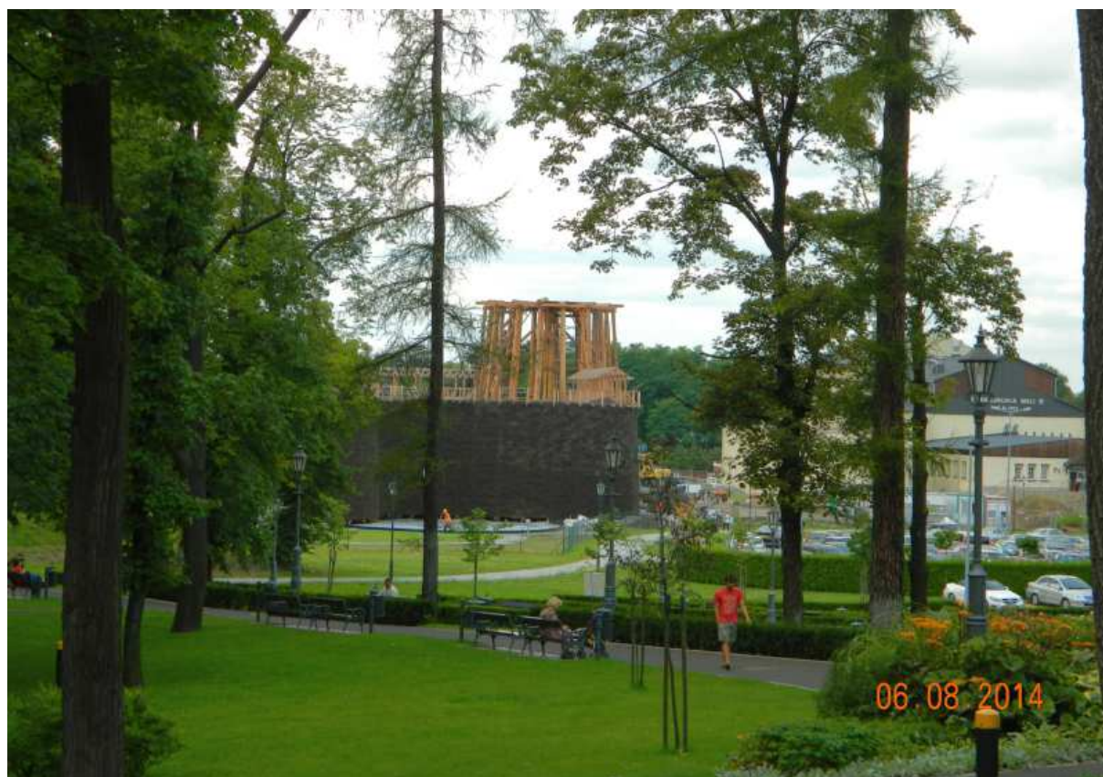
Fot. nr 90 (90-96). Wokół tężni, która powstała na styku Kopalni i parku św. Kingi. Fot. nr: 90-91. Etap budowy.
