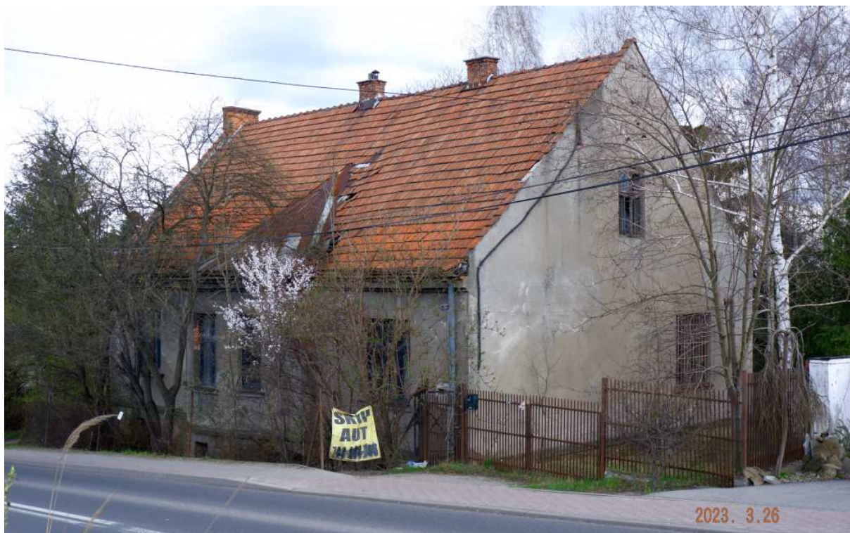
Fot. nr 311 (311-313). Opuszczony, zapewne międzywojenny dom murowany pod nr 56.
