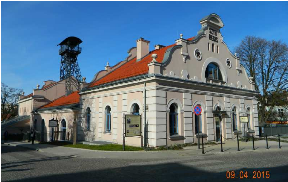
Fot. nr 31 (31-32). Odnowiony szyb Regis KSW spod nr 9 – tu widok z ulicy Sikorskiego. Nadszybie powstało w latach: 1860-61. Do lat 30. zeszłego wieku działał tu młyn solny.
