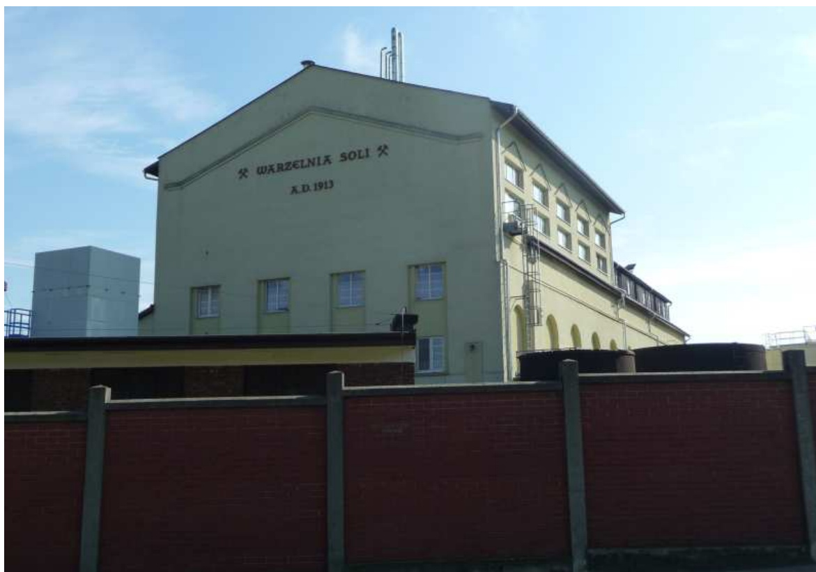
Fot. nr 61. Odnowiony budynek dawnej warzelni soli. (01.10.13)
