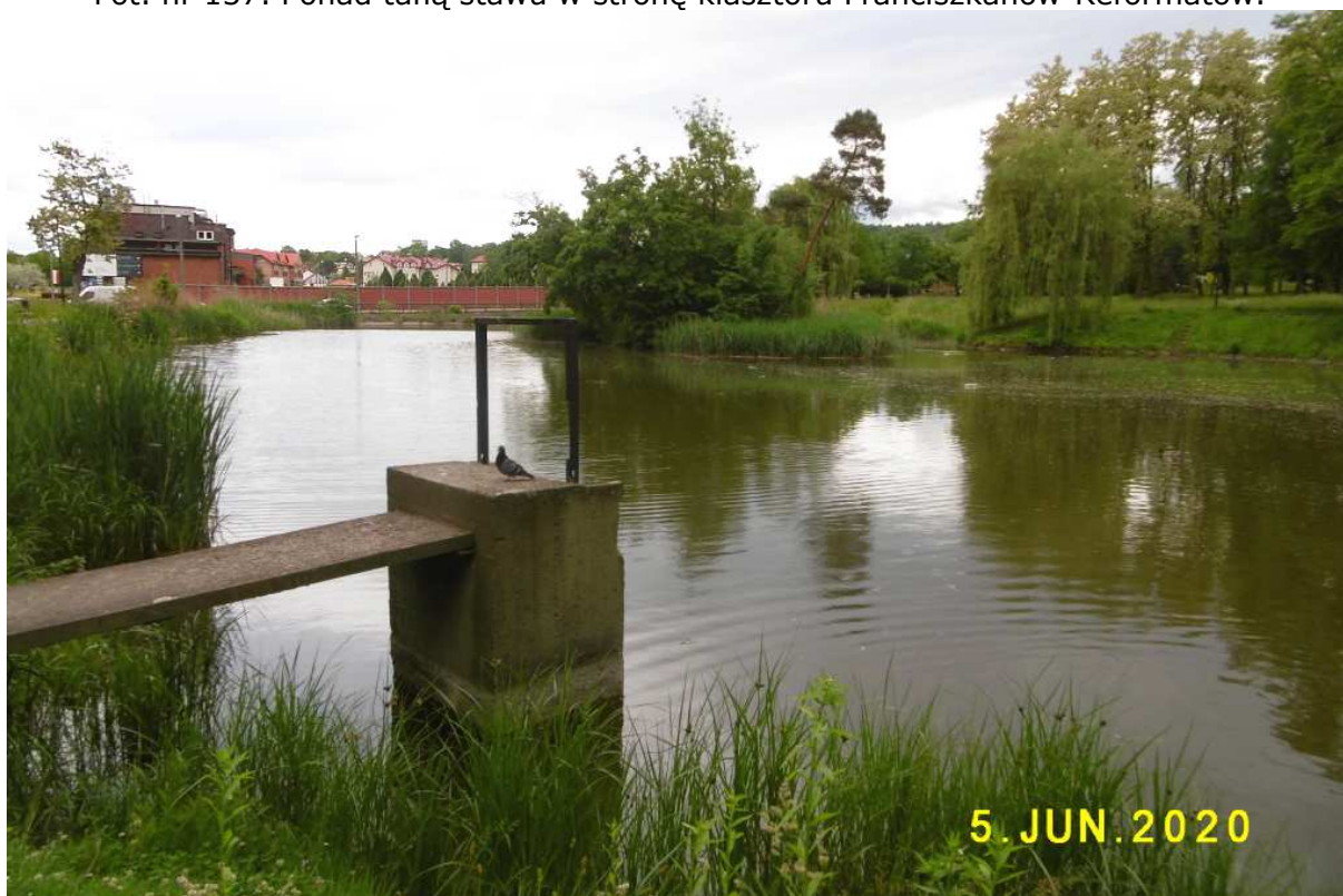
Fot. nr 138 (138-140). Przy studzience odpływowej.
