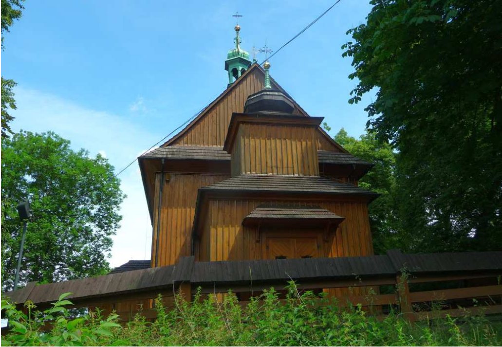
Fot. nr 334. Ta zabytkowa, drewniana świątynia o konstrukcji zrębowej, na zewnątrz oszalowana, była konsekrowana w roku 1598, ale jej bryła została przebudowana w XVII i XVIII wieku. W barokowo wyposażonym wnętrzu znajdują się polichromie Włodzimierza Tetmajera z początku XX wieku. (14.06.2022)
