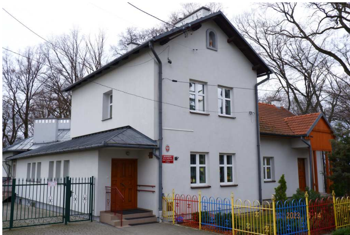
Fot. nr 440 (440-441). Przedszkole sióstr Urszulanek na terenie dawnego zespołu dworskiego Lubomirskich pod nr 1.
