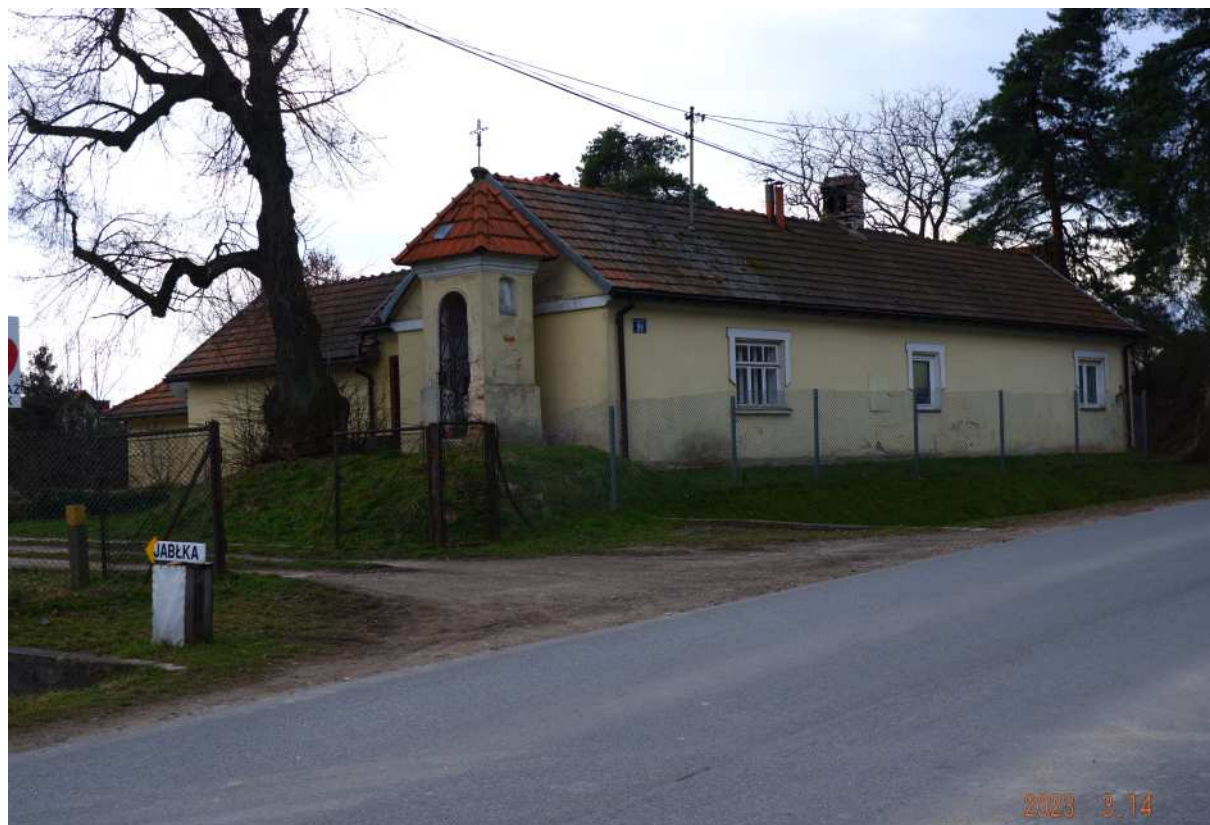
Fot. nr 470 (470-477). Zespół XIX-wiecznego dworu spod nr 91 i przylegająca do niego kapliczka typu domkowego. Stan obecny.
