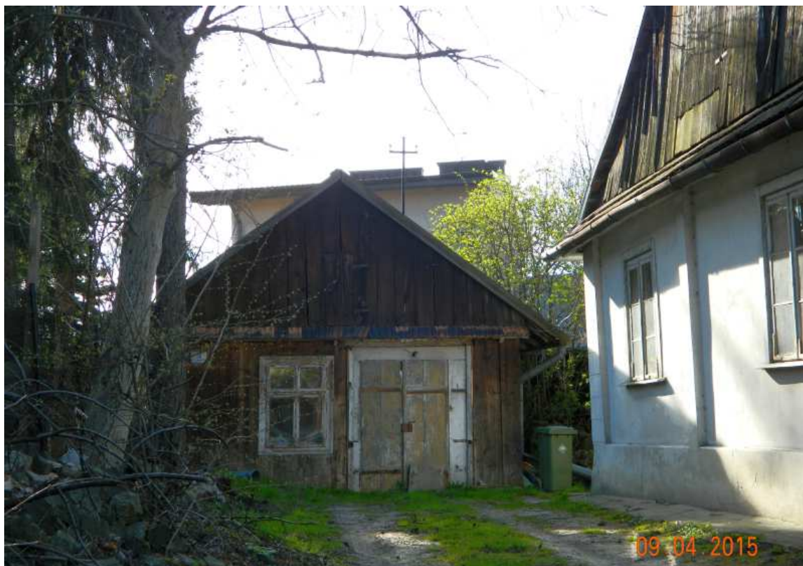
Fot. nr 274 (274-275). Niewielki domek pod 5, zapewne dawne zaplecze dworku.
