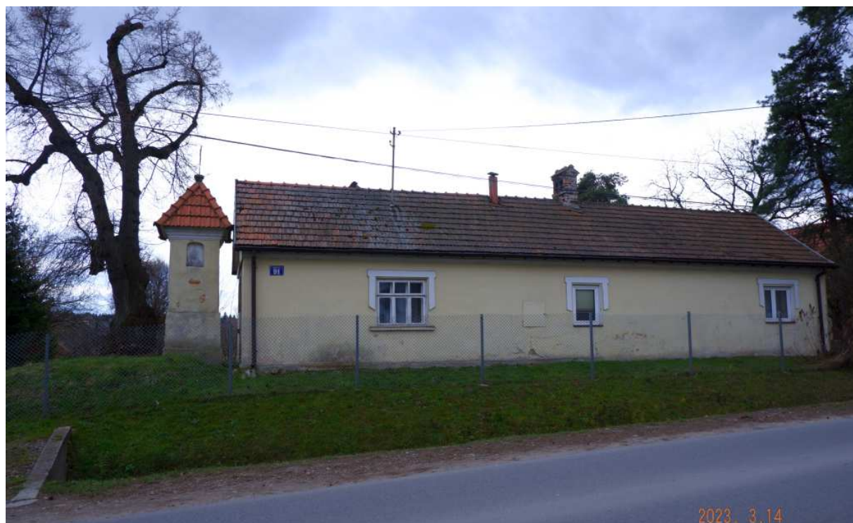
Fot. nr 471. Widok na fasadę.
