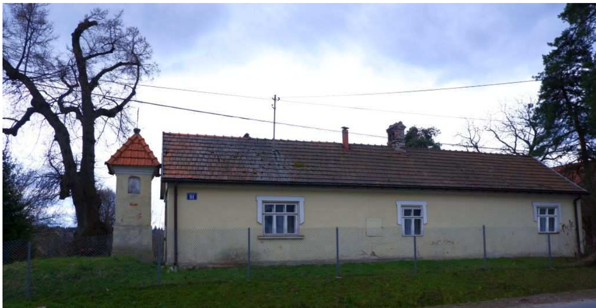
Fot. nr 472. Próba rekonstrukcji fasady przez dodanie oryginalnych okien w środkowym i prawym fragmencie. (14.03.2023)
