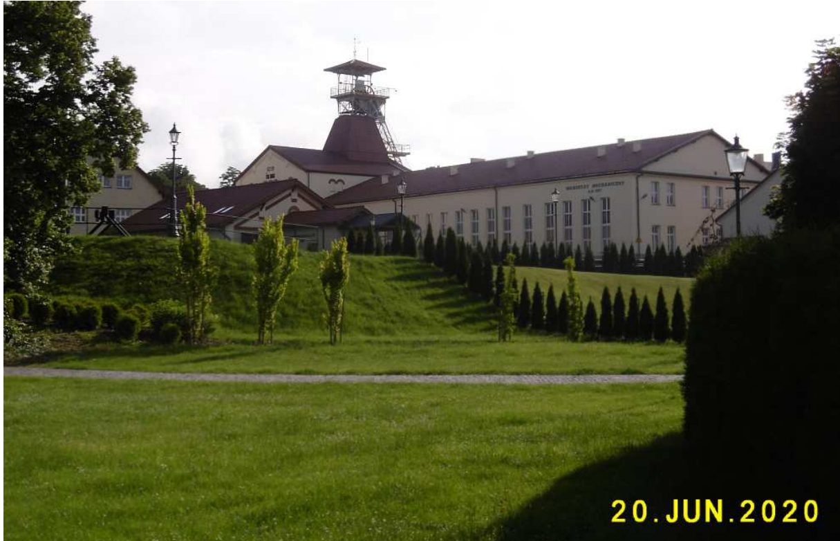
Fot. nr 107. Budynki przy szybie św. Kingi (od lewej): parowozowni, warsztatu mechanicznego i stolarni.
