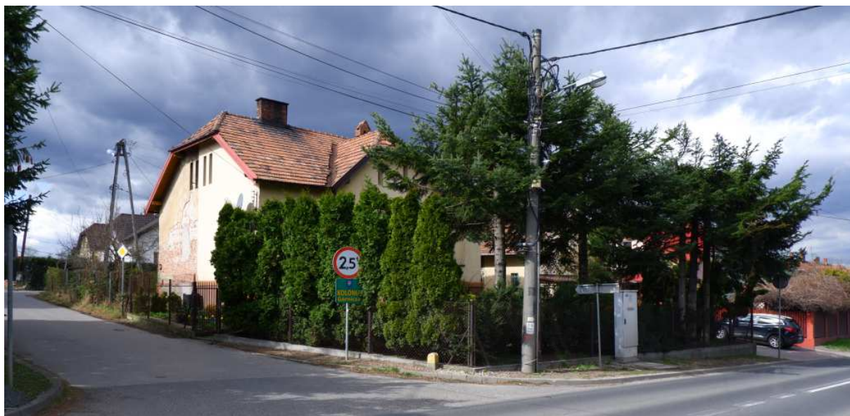
Fot. nr 310. Dom pod nr 13 w narożu z ulicą Sowińskiego.
