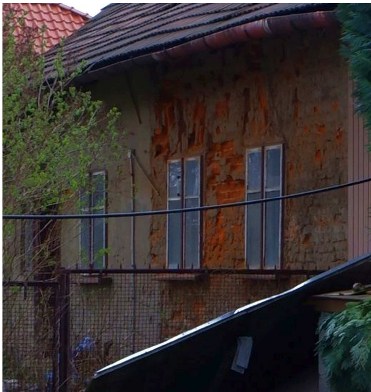
Fot. nr 308. Ostałe jeszcze w fasadzie oryginalne okna.
