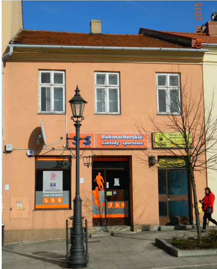
Fot. nr 12. Dom pod nr 13 z oryginalnymi oknami typu skrzynkowego. (09.04.2015)
