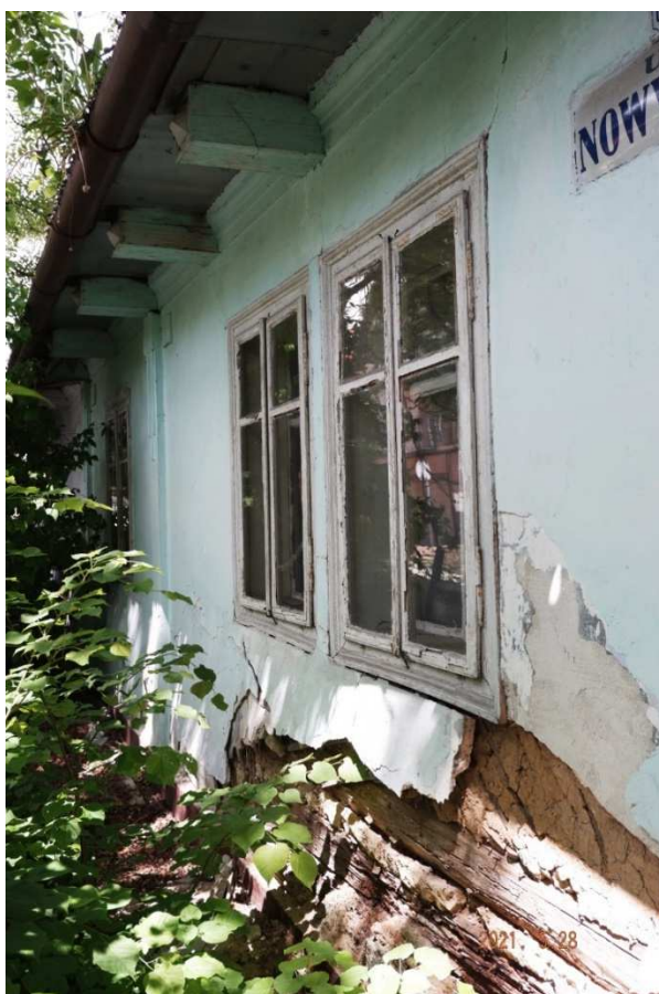
Fot. nr 177. Ściana fasadowa z oryginalnymi oknami typu ościeżnicowego. Spod bielonej polepy wyłania się drewniana faktura typu zrębowego. Szanse na jej przetrwanie maleją. (28.05.2021)
