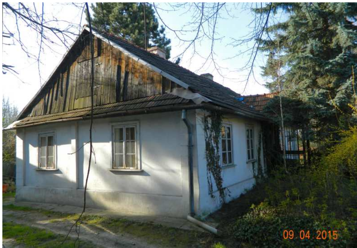
Fot. nr 270 (270-272). Lewa ściana szczytowa.
