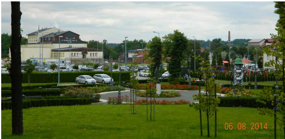
Fot. nr 108 (108-109). Budynki: warzelni (z lewej), warsztatu mechanicznego i przylegającego do niego warsztatu elektrycznego. Z prawej komin dawnej cegielni.
