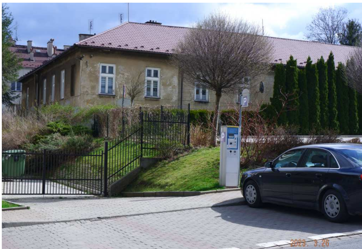
Fot. nr 252 (252-255). Dawny szpital pod 34a, wybudowany w latach 1838-39.
