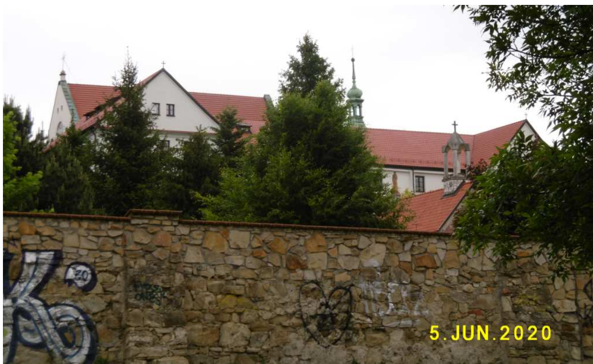
Fot. nr 199 (199-200). Widoki spod torów kolejowych.
