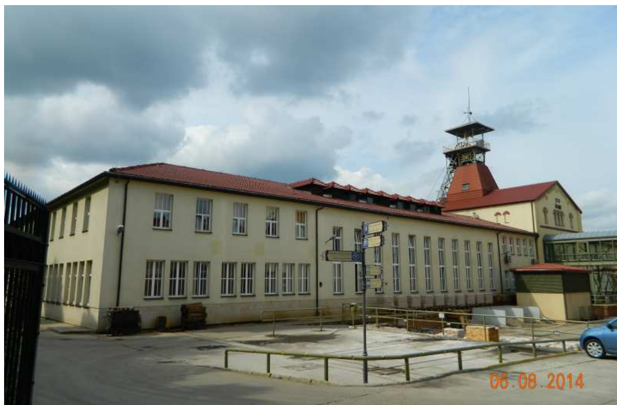
Fot. nr 65. Szyb św. Kingi w ujęciu od strony dawnego młyna solnego.
