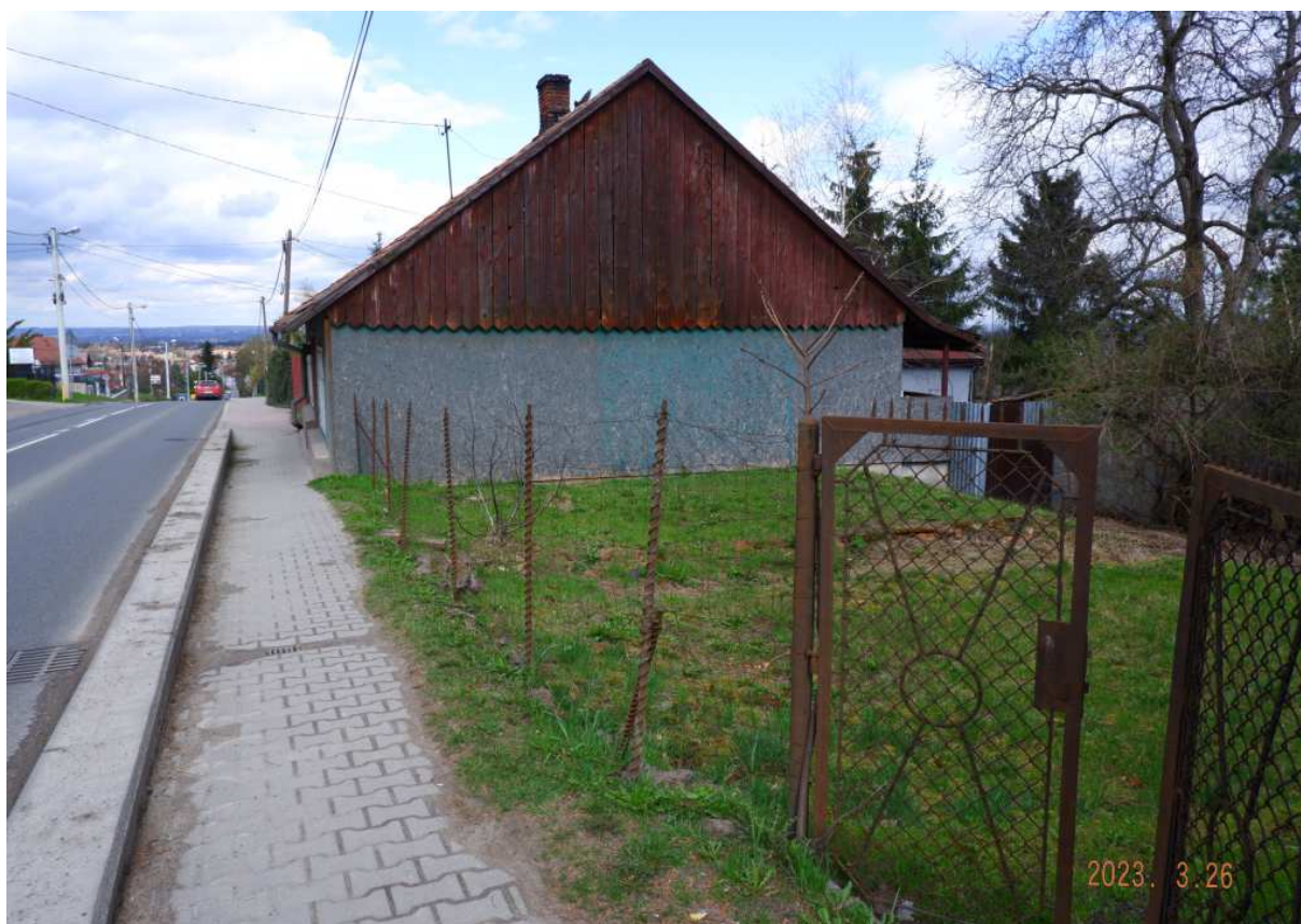
Fot. nr 323. Posesje pod nr: 72 i 74. Na tej drugiej nie ma już śladu po niedawno wyburzonym domu z I połowy XIX wieku, który widniał jeszcze w GEZ z roku 2018.
