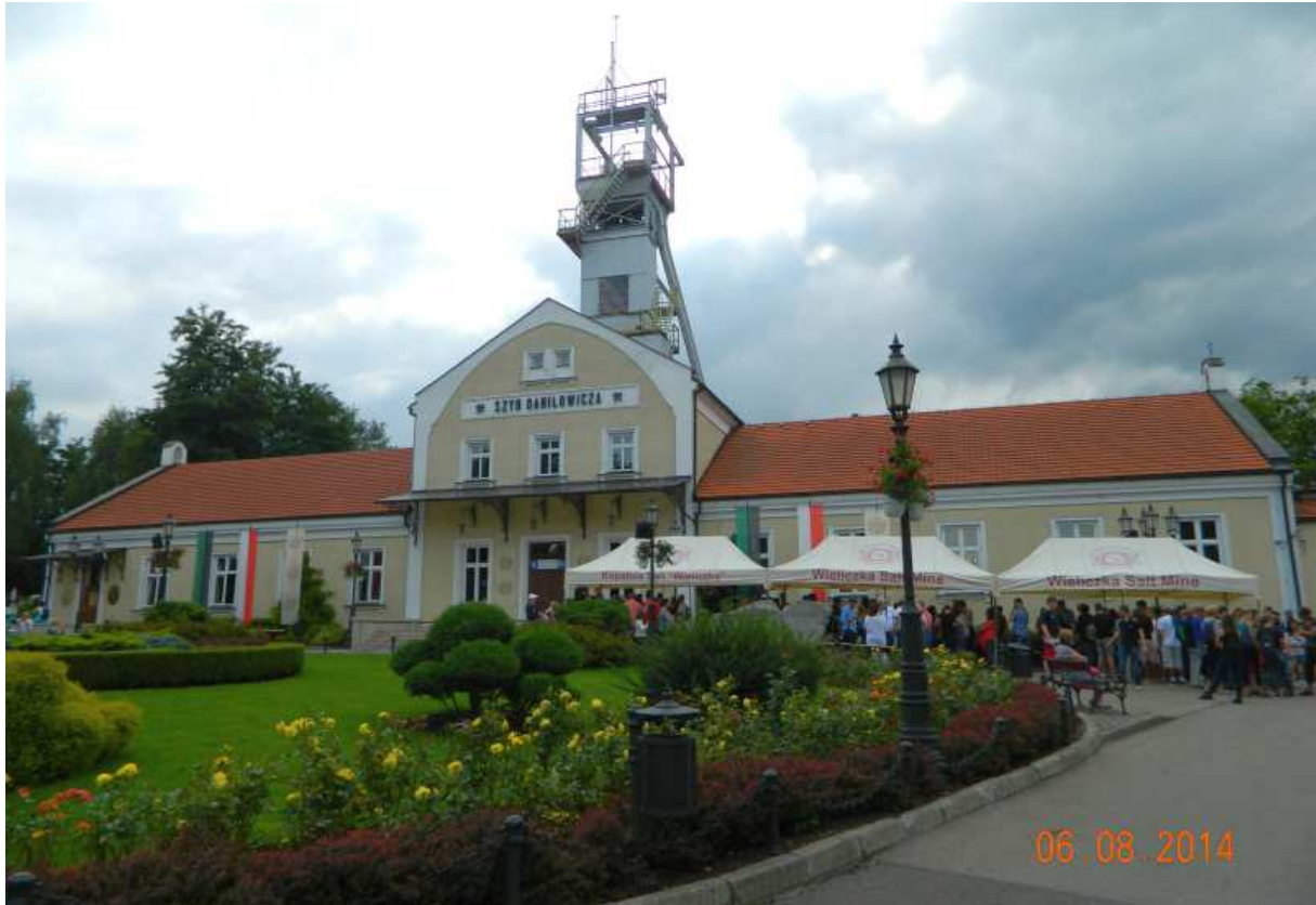
Fot. nr 70 (70-73). Wokół szybu Daniłowicza, z nadszybiem z roku 1898, który stanowi centrum obsługi ruchu turystycznego kopalni. Tu zaczyna się słynna Trasa Turystyczna. Fot. nr: 70-71. Widoki z ulicy Daniłowicza.
