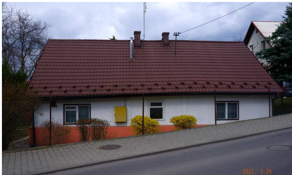
Fot. nr 256 (256-257). Przebudowana dawna chałupa z ulicy Boża Wola 27.
