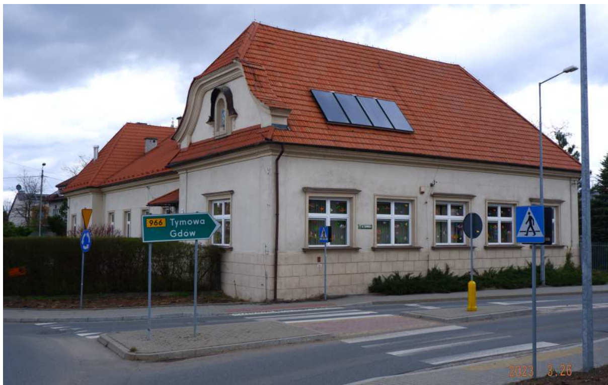
Fot. nr 288. Widok od strony ulicy Gdowskiej.
