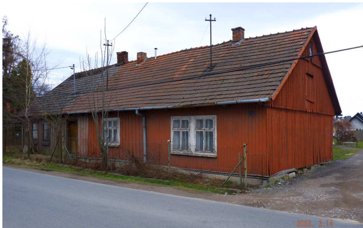
Fot. nr 462. Widok na fasadę.
