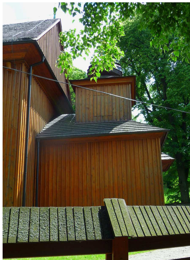
Fot. nr 341 (341-344). Elewacja północna. Kruchta. (30.05.2022)
