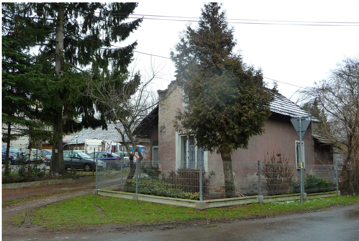
Fot. nr 41. Budynek dawnej straży ogniowej przy ulicy Kaczeńcowej 5. (03.02.2023)
