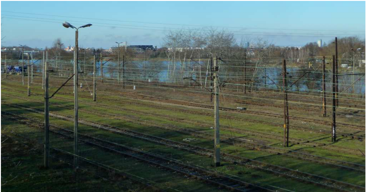
Fot. nr 225 (225-228). Zimowe panoramy z kładki nad torami kolejowymi stacji rozrządowej w Prokocimiu. (12.01.2023)
