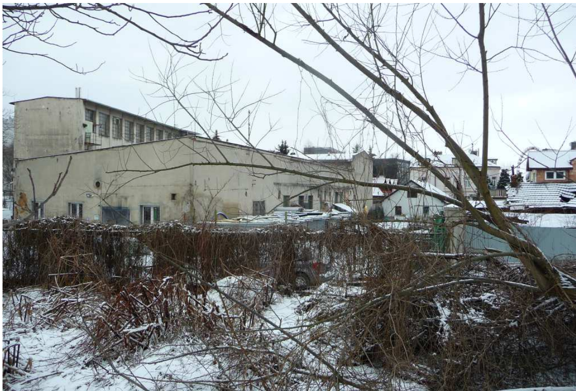
Fot. nr 132 (131-132). Widok z wału Wilgi. (05.02.2023)
