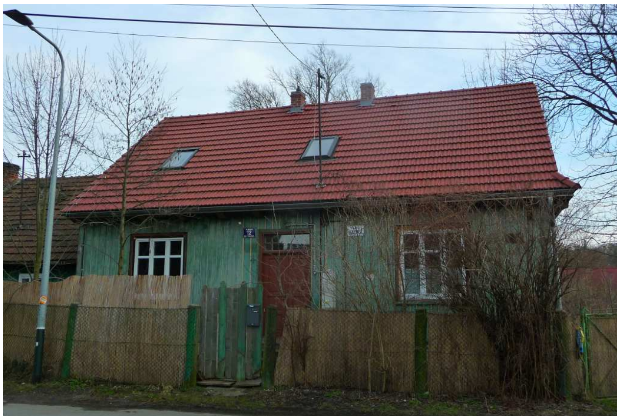
Fot. nr 351. Fasada od strony ulicy. (07.03.2023)
