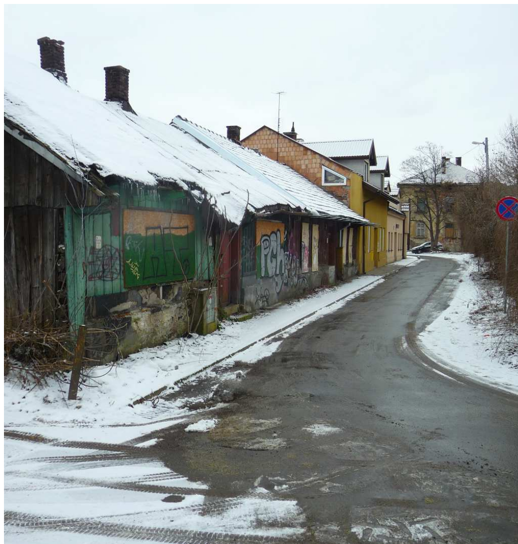
Fot. nr 121 (121-130). Wzdłuż ulicy Tureckiej. Zabudowa pon. nr 21. (05.02.2023)
