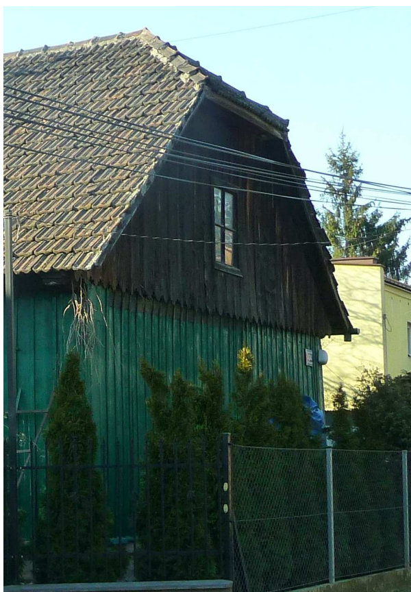
Fot. nr 207. Ściana szczytowa. (28.02.2023)
