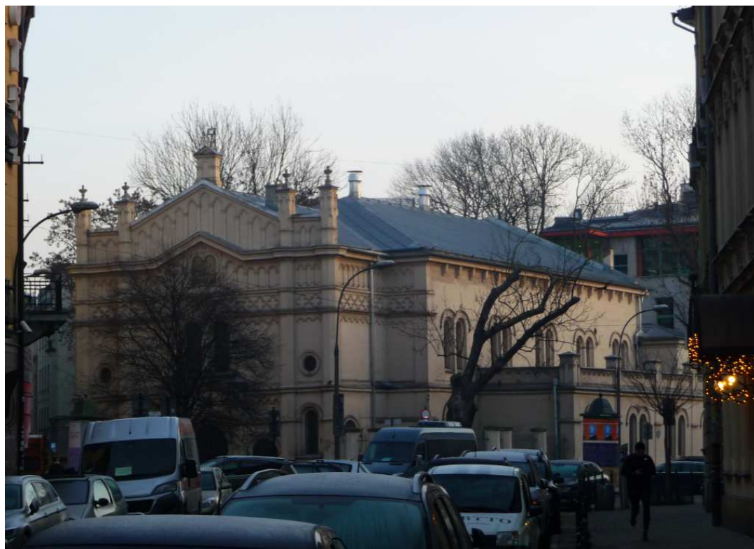
Fot. nr 63. Nowa synagoga Tempel z ulicy Miodowej 24. (02.01.2023)
