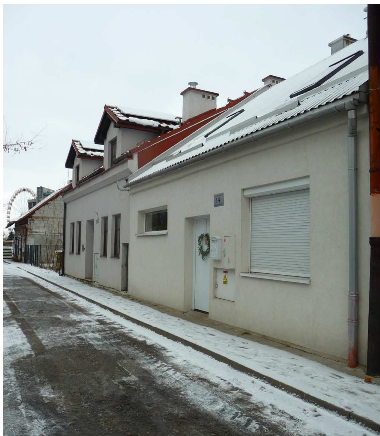
Fot. nr 135 (135-138). Ciąg dalszy ulicy Tureckiej, poniżej domu o nr 14. (05.02.2023)
