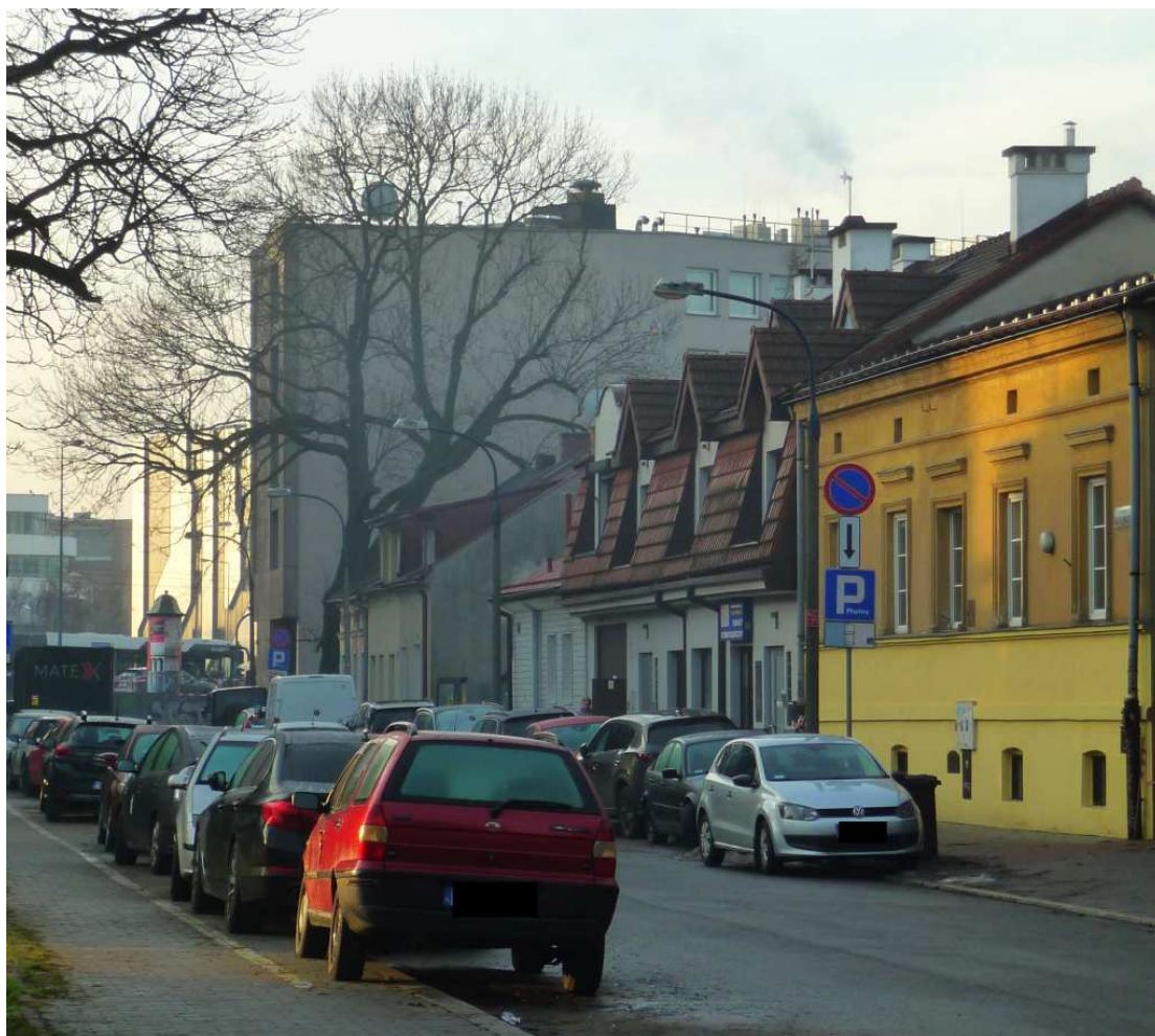
Fot. nr 74. Fragment zabudowy z początku XX wieku powyżej domu o numerze 3. (02.01.2023)
