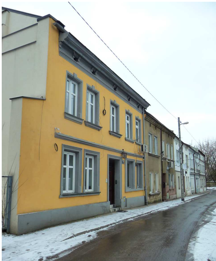
Fot. nr 116. Zabudowa ulicy poniżej domu o numerze 21. (05.02.2023)
