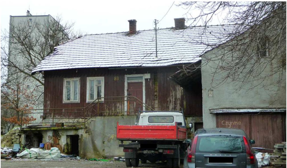
Fot. nr 24. Oryginalne detale fasady. (03.02.2023)
