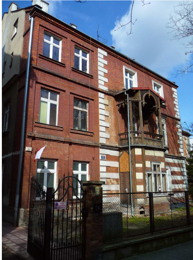
Fot. nr 143 (143-144). Kamienica w kształcie willi przy ulicy Zamojskiego 21, która powstała w roku 1889 wg projektu Aleksandra Serkowskiego. (08.03.2023)
