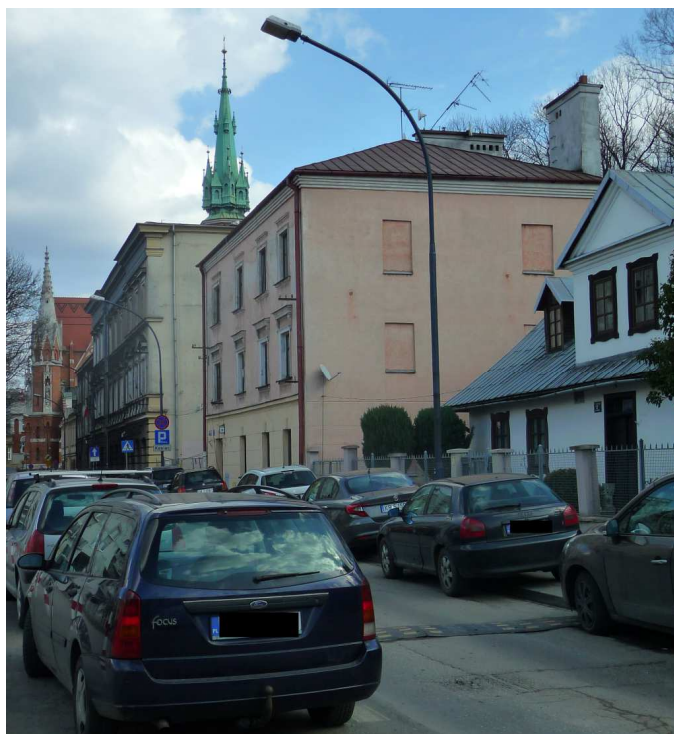
Fot. nr 146. Zabudowa ulicy Zamojskiego poniżej dworku o numerze 12. (08.03.2023)
