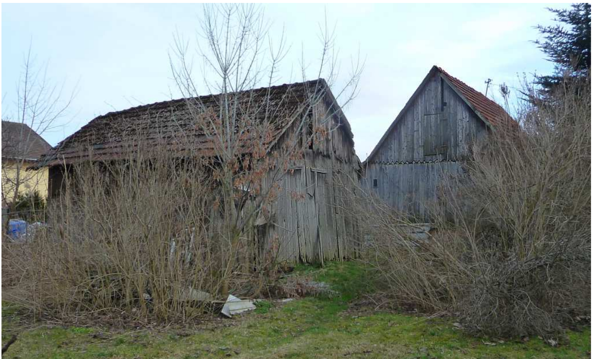
Fot. nr 396. Ściana szczytowa domu i poprzecznie ustawiona stodoła. (07.03.2023)
