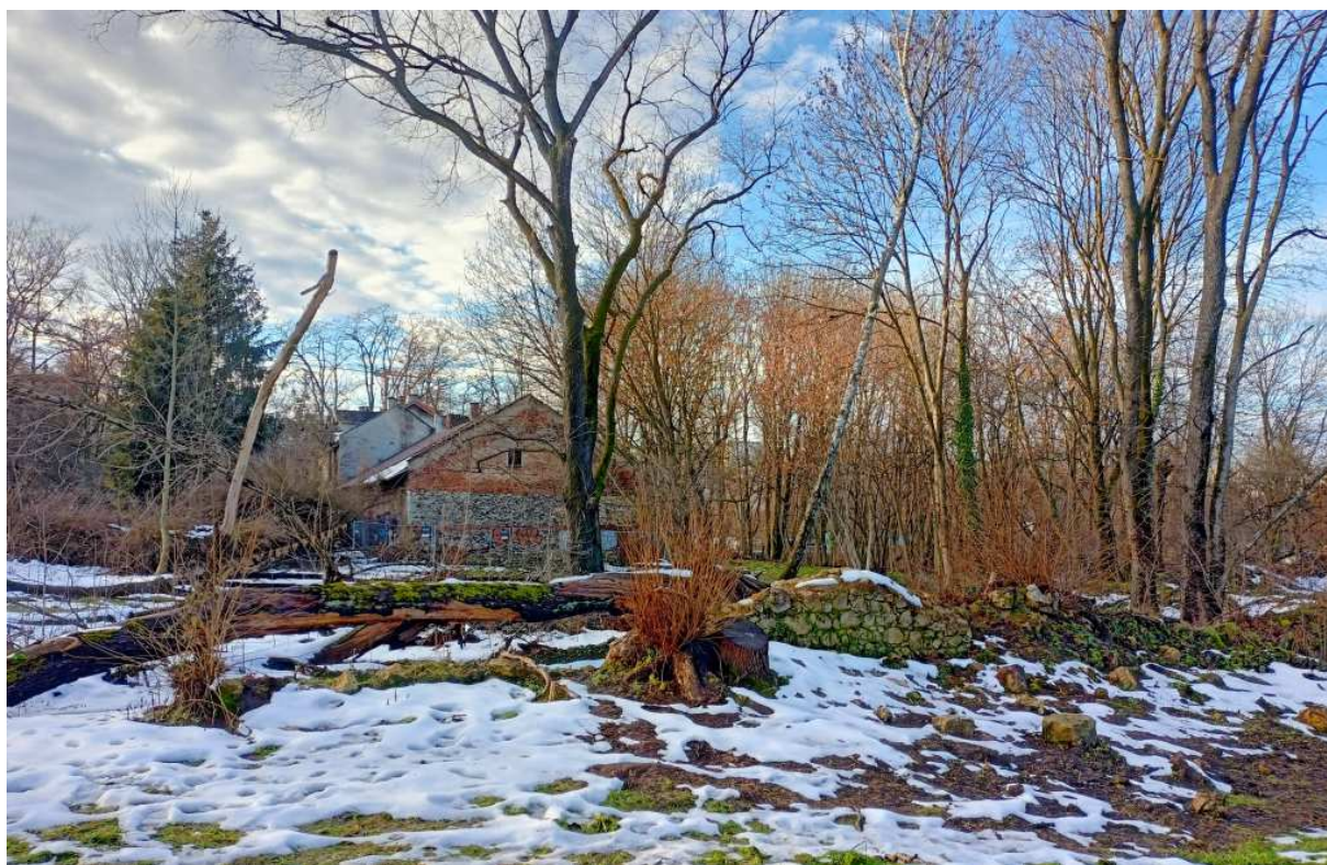
Fot. nr 173 (173-175). Kolejna ruina budynku gospodarczego z otoczenia dworu Bemów, która oczekuje na rewitalizację (26.12.w 2022)
