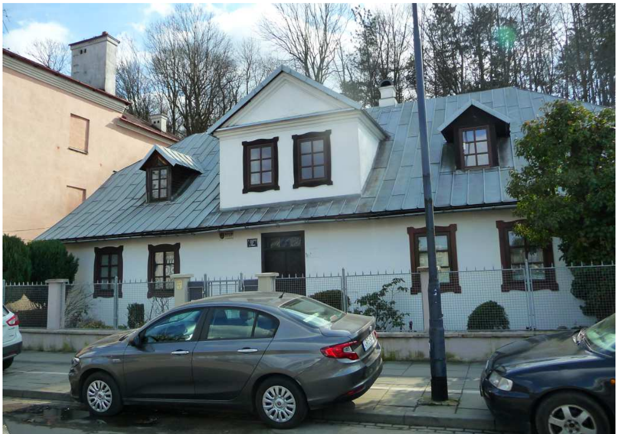
Fot. nr 148. Fasada dworku. (08.03.2023)
