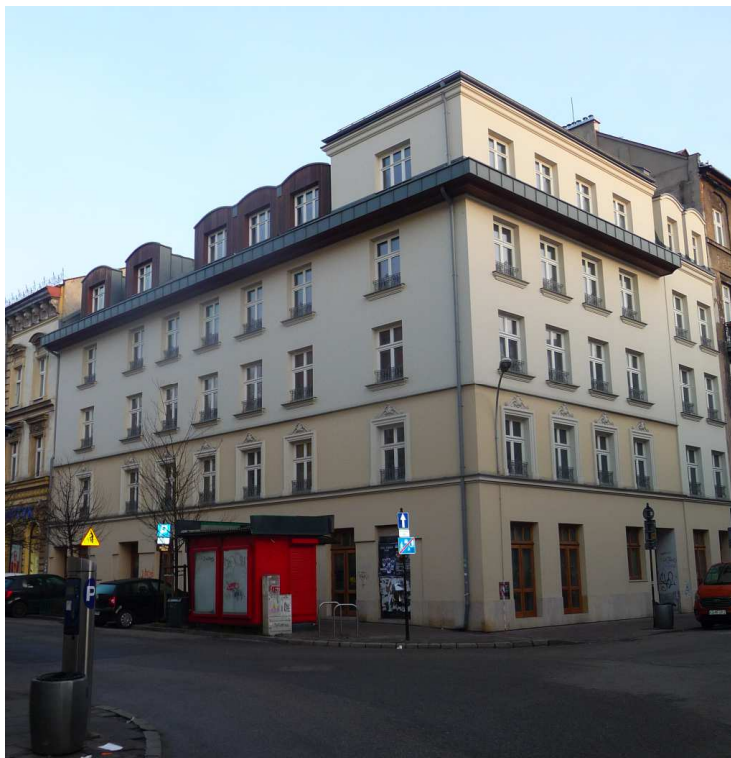
Fot. nr 64 (64-65). Nadbudowany o dwa piętra dom z naroża ulic: Bożego Ciała 4/ Miodowa 10. (02.01.2023)
