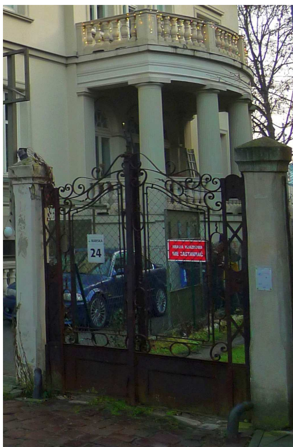
Fot. nr 83. Wjazd z ulicy Zduńskiej. (02.01.2023)
