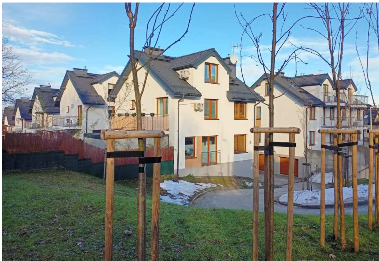
Fot. nr 167. Nowa zabudowa ulicy Wolności na skraju skweru Wolności. (26.12.2022)
