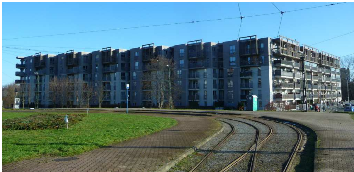
Fot. nr 255. Słynny „alcatraz” przy ulicy Górników 50-66. (25.12.2022)
