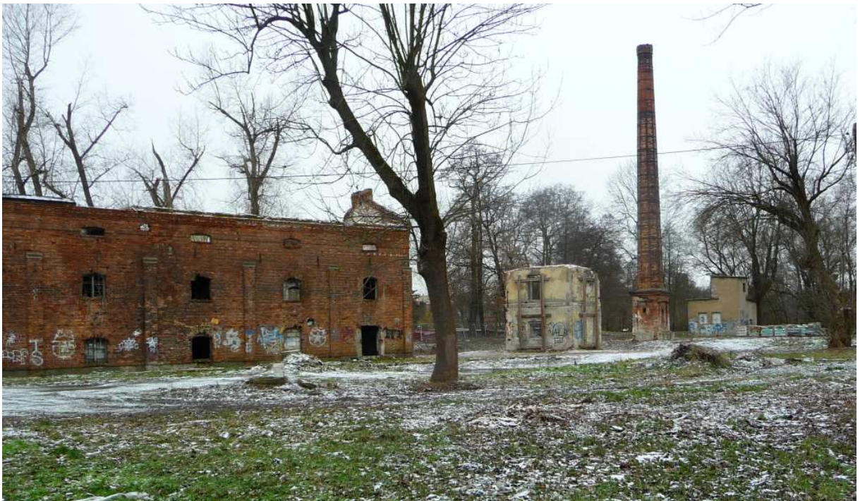
Fot. nr 48 (48-50). Widoki od strony ulicy Podrzecze po częściowych wyburzeniach. (03.02.2023)
