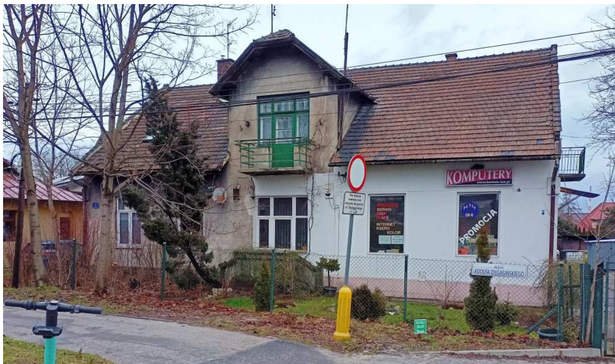
Fot. nr 303. Zapewne ok. 90-letni dom Dygasińskiego 3 z zachowaną, oryginalną facjată. (19.02.2023)
