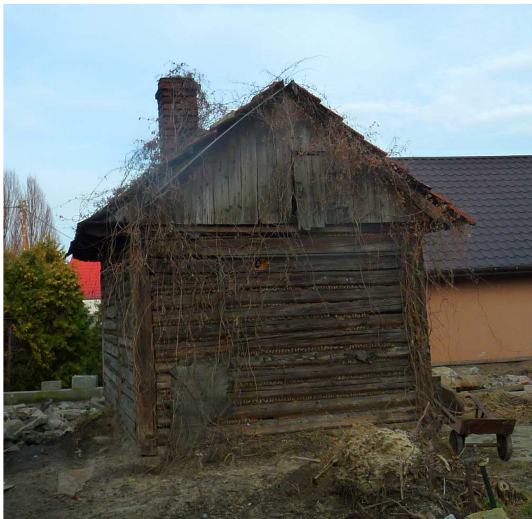
Fot. nr 355 (355-356). Zapewne dawna stajnia na skraju zagrody. (07.03.2023)
