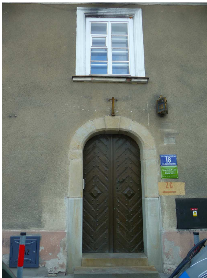
Fot. nr 145 (145-151). Detale 200-letniego domu Pod Lipkami z ostatniej ćwierci XVIII. wieku z ulicy Zamojskiego 18. To własność znanej podgórskiej rodziny Rehmanów. Dom został odnowiony po pożarze, który wybuchł tu dnia 20.02.2018. (08.03.2023)
