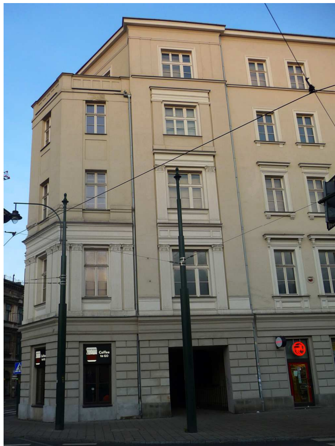
Fot. nr 55 (55-56). Nadbudowana w okresie międzywojennym o dwa piętra kamienica z ulicy Dietla 44. (02.01.2023)
