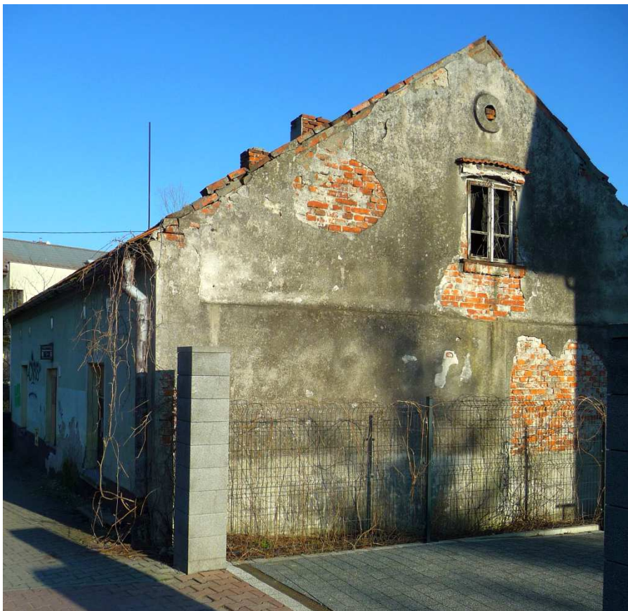
Fot. nr 201. Murowany dom pod nr 83. (28.02.2023)
