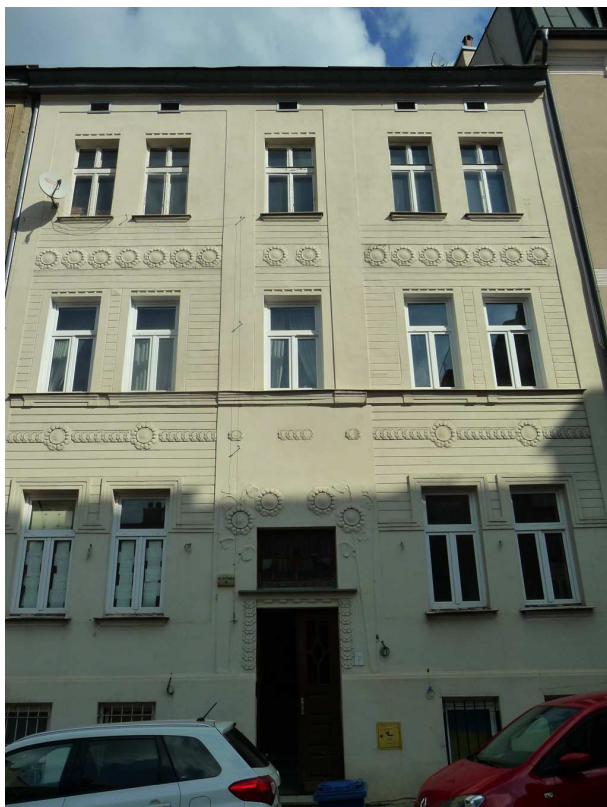
Fot. nr 141 (141-142). Odnowiony dom ze zdobnictwem secesyjnym z ulicy Stromej 4. Budynek powstał w roku 1912 wg projektu Aleksandra Sołtysa. (08.03.2023)
