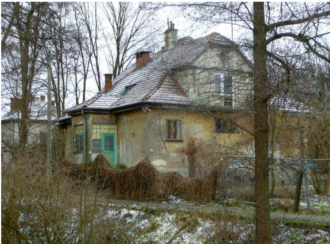
Fot. nr 51. Willa w kompleksie młyna przy ulicy Kocmyrzowskiej 5. (03.02.2023)
