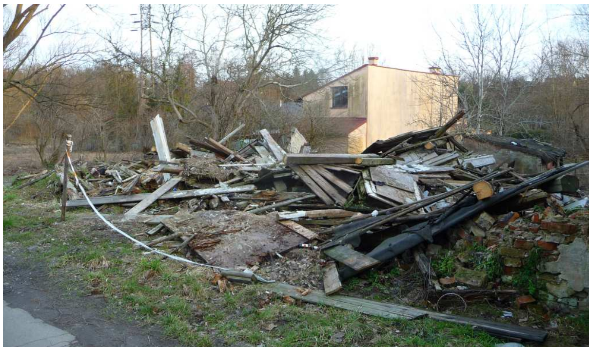
Fot. nr 361 (361-362). Smutne pozostałości po drewnianym domu z gankiem z ulicy Mokrej 26. (07.03.2023)
