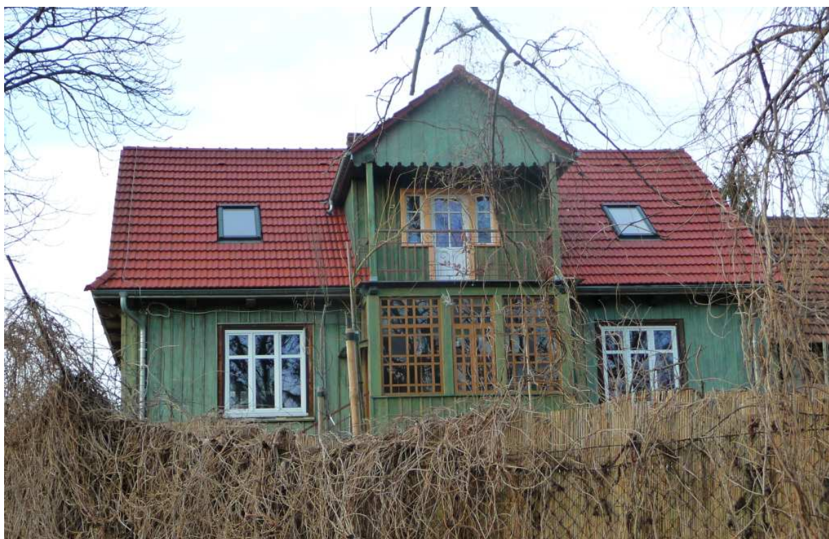
Fot. nr 352. Kryty ganek z loggią widokową od strony ogrodu. (07.03.2023)
