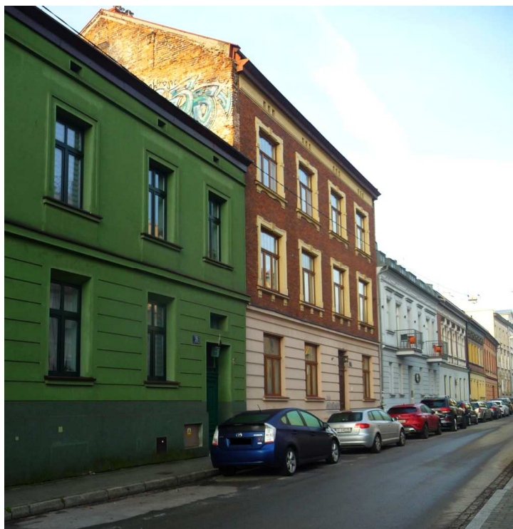
Fot. nr 104. Fragment zabudowy ulicy Różanej poniżej domu o nr 25. (02.01.2023)
