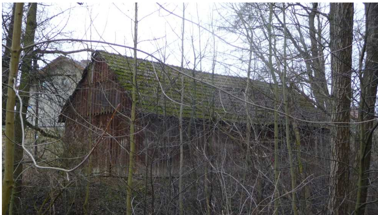
Fot. nr 375. Tradycyjna stodoła przy ulicy Tyranowskiego obok domu nr 30. (05.03.2023)
