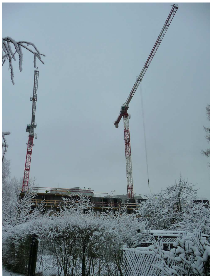
Fot. nr 322 (322-323). Nowo powstający blok przy ulicy Podęworce 9. (20.01.2023)
