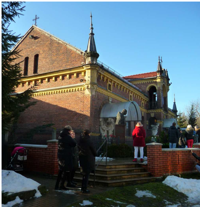
Fot. nr 259. Kaplica Augustianów, przerobiona w roku 1911 z dawnej wozowni. (25.12.2022)
