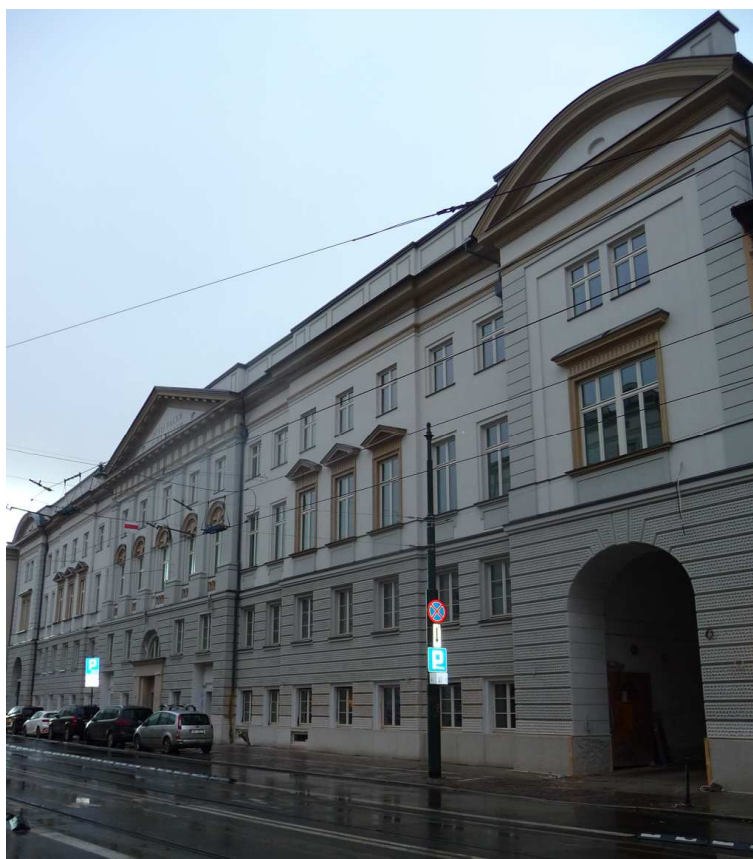
Fot. nr 57 (57-61). Odnowiony gmach dawnego Urzędu Celnego, potem, po połowie XIX wieku Dowództwa Twierdzy Kraków z ulicy Stradomskiej 12-14. W XIV stanął w tym miejscu klasztor Bożogrobców z kościołem św. Jadwigi na zapleczu. (05.01.2023)
