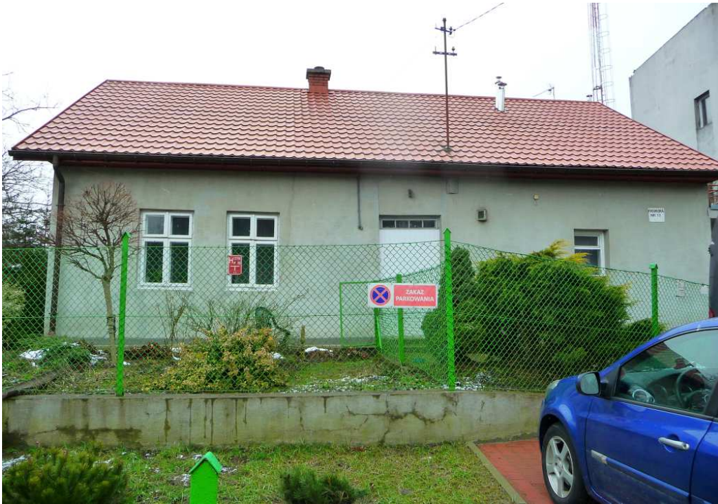
Fot. nr 31. Zapewne jeszcze międzywojenny dom murowany z ulicy Fatimskiej 13, gdzie w fasadzie zachowały się okna typu skrzynkowego. (03.02.2023)
