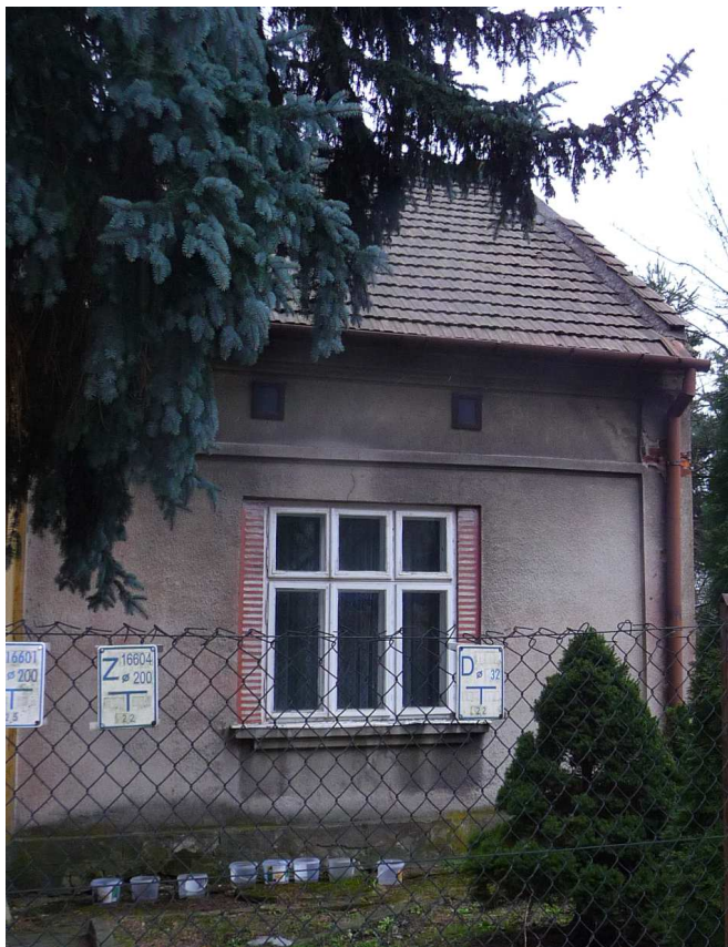
Fot. nr 389. Oryginalny detal przedwojennego domu z ulicy Szpakowej 15. (05.03.2023)
