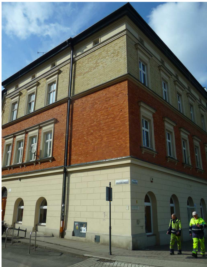
Fot. nr 151. Odnowiona kamienica z Rynku Podgórskiego pod nr 4a. (08.03.2023)
