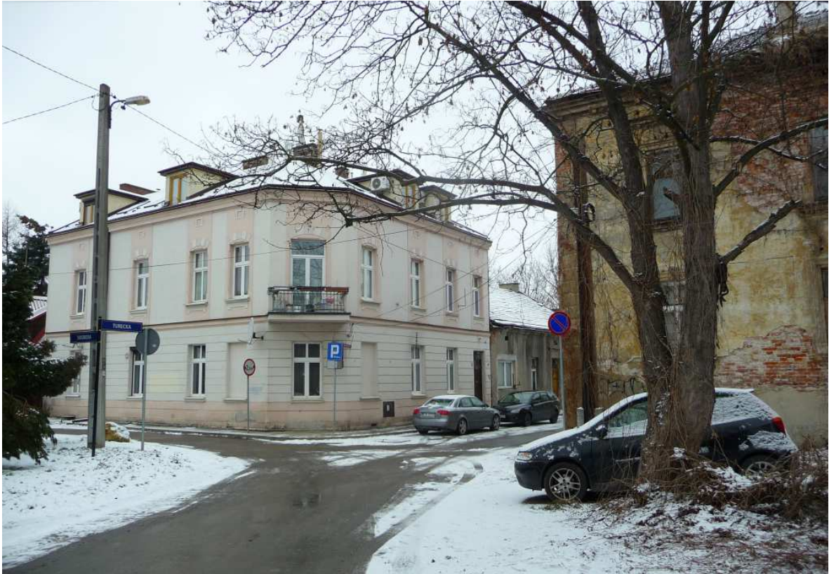
Fot. nr 128. Kamieniczka z roku 1906 pod nr 9, w narożu z ulicą Swoboda. (05.02.2023)
