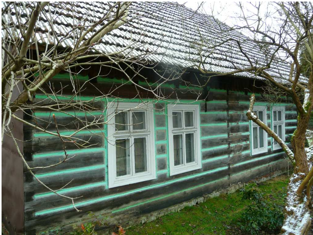
Fot. nr 53. Przykładnie malowana fasada i tylko okna nie są już oryginalne. (03.02.2023)
