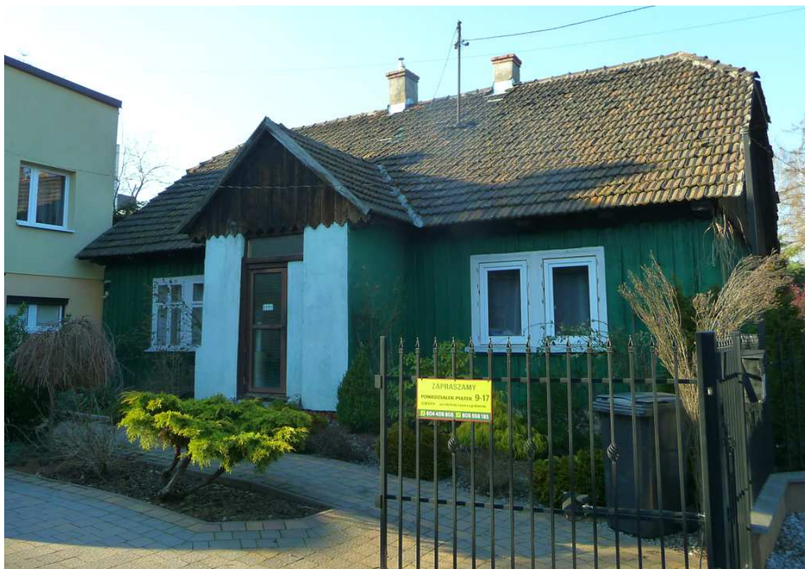
Fot. nr 206 (206-207). Oryginalny w lewym fragmencie, zapewne ok. 90-letni dom z ulicy Mochneckiego 34. (28.02.2023)
