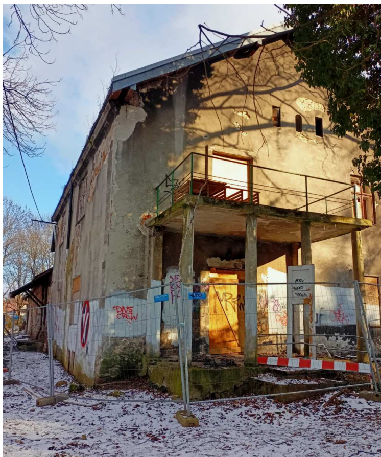
Fot. nr 179. Ściana szczytowa od strony ulicy Estońskiej. (08.02.2023)
