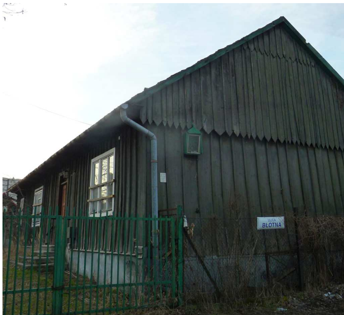
Fot. nr 348. Fasada i ściana szczytowa. (07.03.2023)
