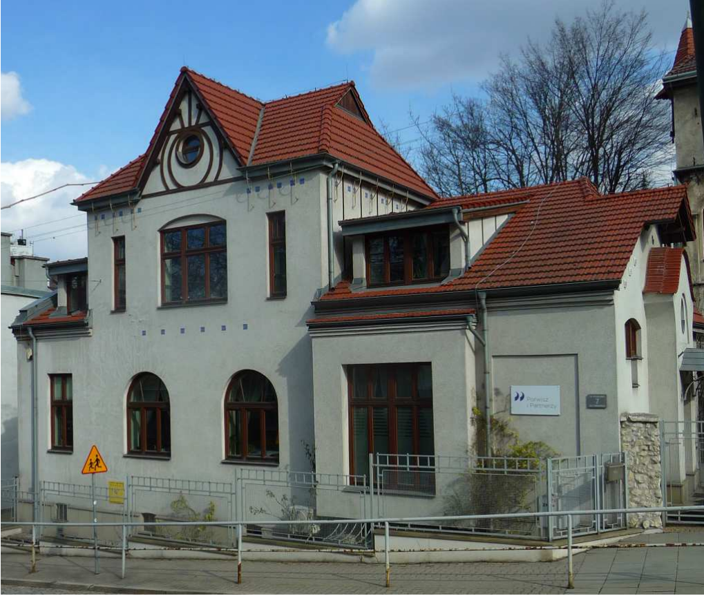
Fot. nr 153. Willa autorstwa Józefa Kryłowskiego z ulicy Parkowej 7, wybudowana w latach 1906-1907. (08.03.2023)
