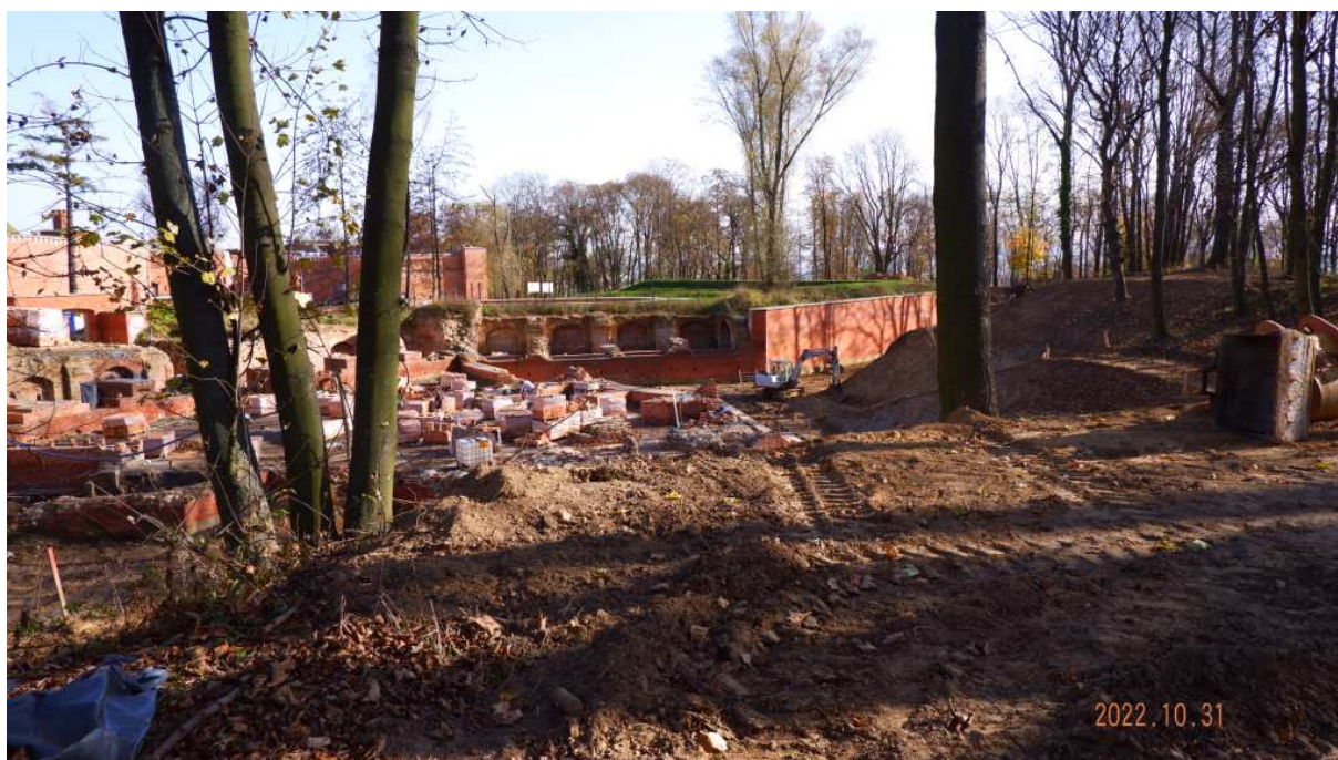
Fot. nr 87 (87-90). Odkopywanie przyziemia i rekonstrukcja narysu bastionu nr I.
