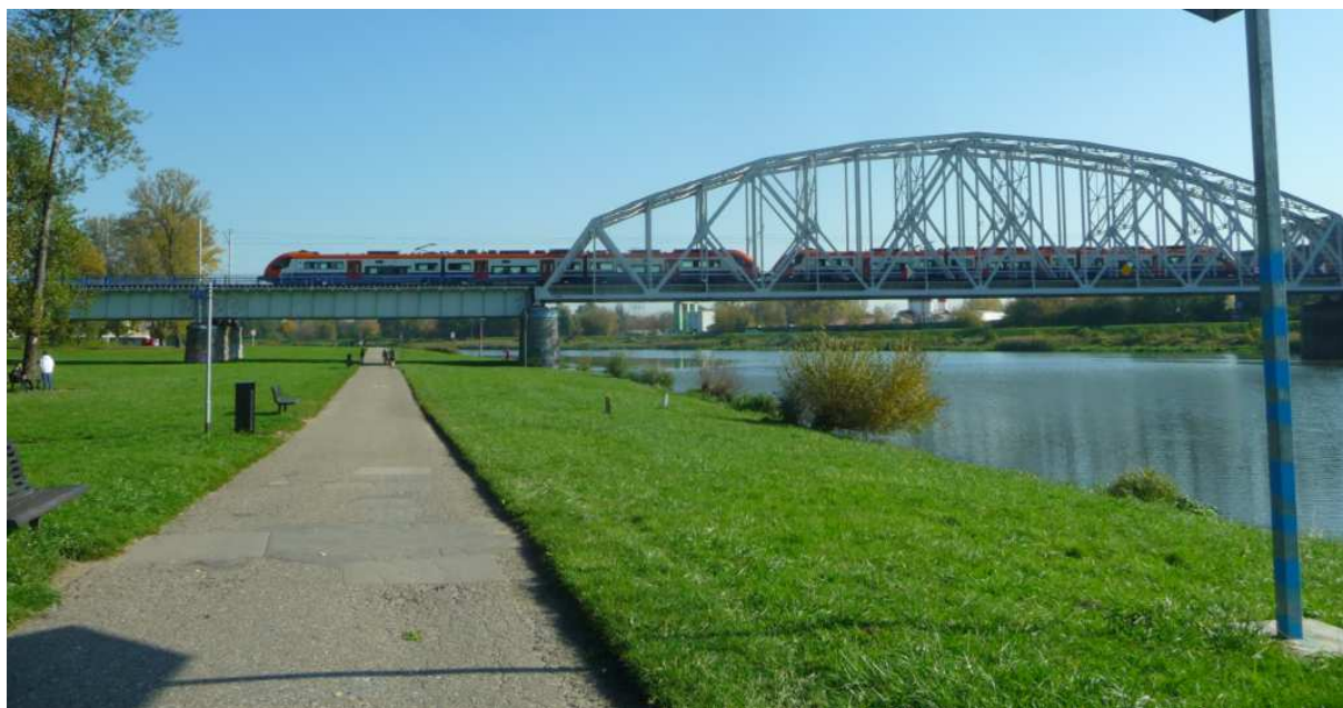
Fot. nr 56. Z mostem kolejowym w tle. (13.10.2022)
