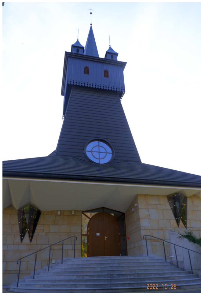
Fot. nr 125. Na kamiennej osnowie podjęto próbę stylizacji górnej partii na wzór poprzedniego obiektu, w mojej opinii nieudaną; drewnianego oryginału nie da się zastąpić.
