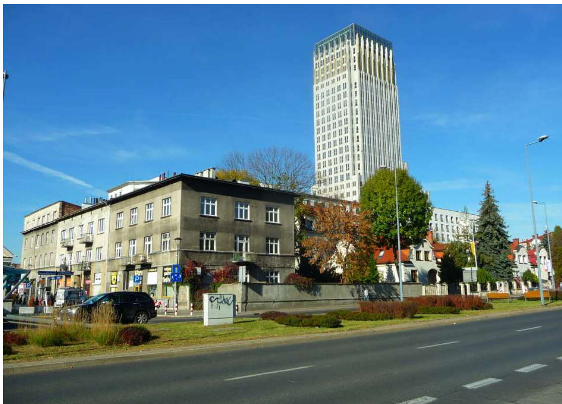
Fot. nr 72. Z międzywojenną zabudową ulicy Lubomirskiego na przedpolu „szkieletora”. (18.10.2022)
