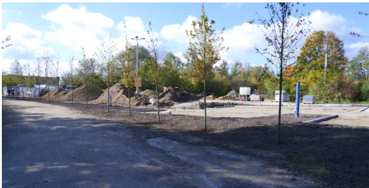
Fot. nr 197 (197-198). Rewitalizowany fragment ulicy Wyłom przy zalewie. (09.10.2022)
