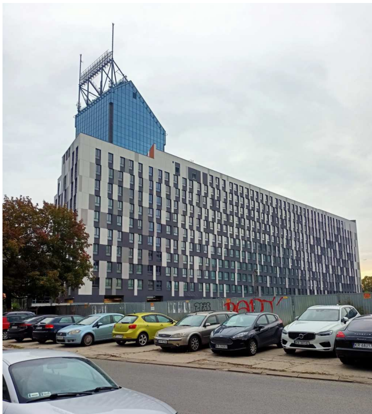
Fot. nr 42 (42-47). Wokół „błękitka” PKO, który obrósł nowym gigantem. (25.09.2022)
