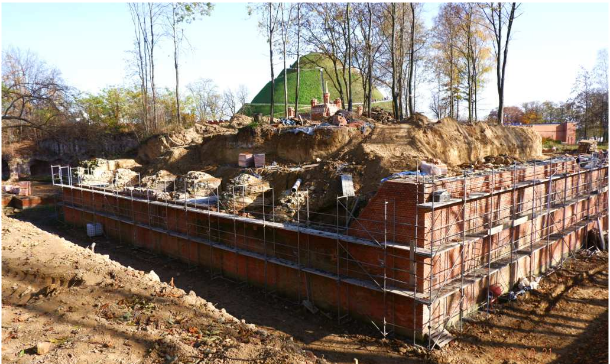
Fot. nr 91 (91-92). Obwarowania zachodniej części fortu w e fragmencie od bastionu nr I do bastionu nr II, gdzie trwają prace rekonstrukcyjne, dla mnie wreszcie, bo czekałem na to od dziecka.
