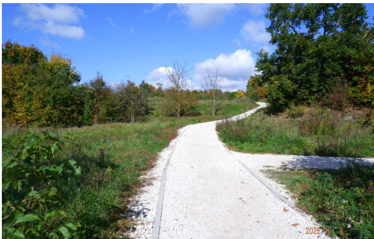
Fot. nr 210. Wasypana zbyt grubym żwirem ścieżka przy baterii FB 28.
