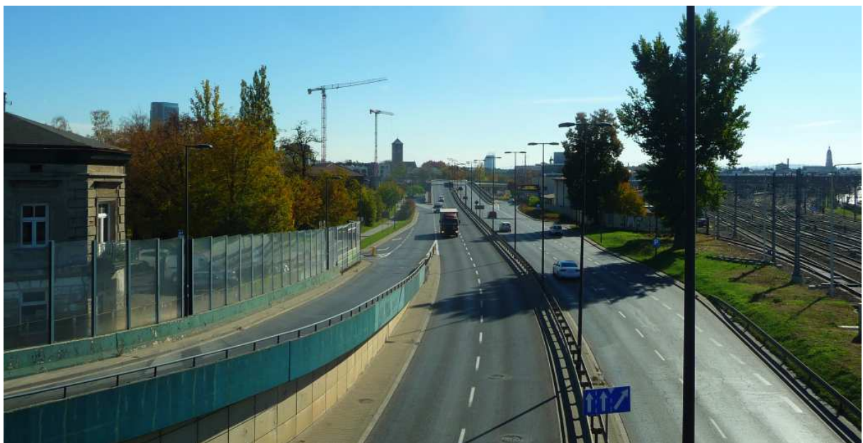
Fot. nr 76. Z Wesolą w tle – widok z wiaduktu nad ulicą Warszawską. (18.10.2022)
