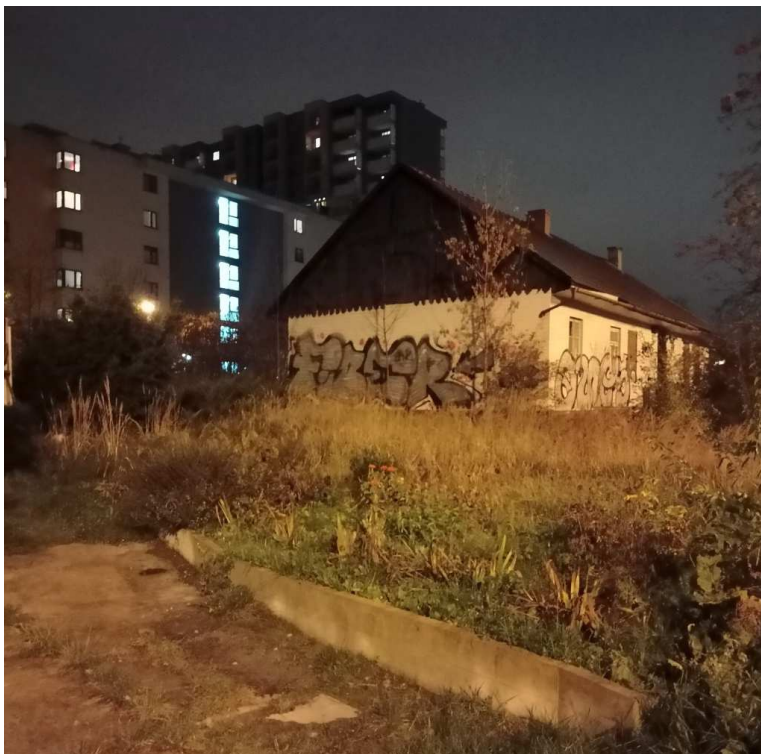
Fot. nr 336. Dogorywający dawna chałupa przy ulicy Wielickiej pod nr 249. (06.11.2022)
