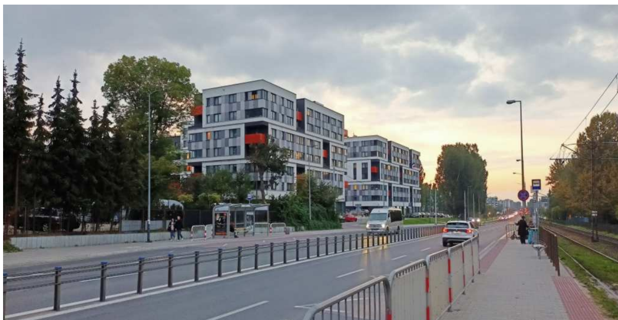
Fot. nr 304. Nowe giganty mieszkaniowe przy ulicy Wielickiej 113, powstałe w miejsce rozebranej niedawno niskiej zabudowy. (25.09.2022)
