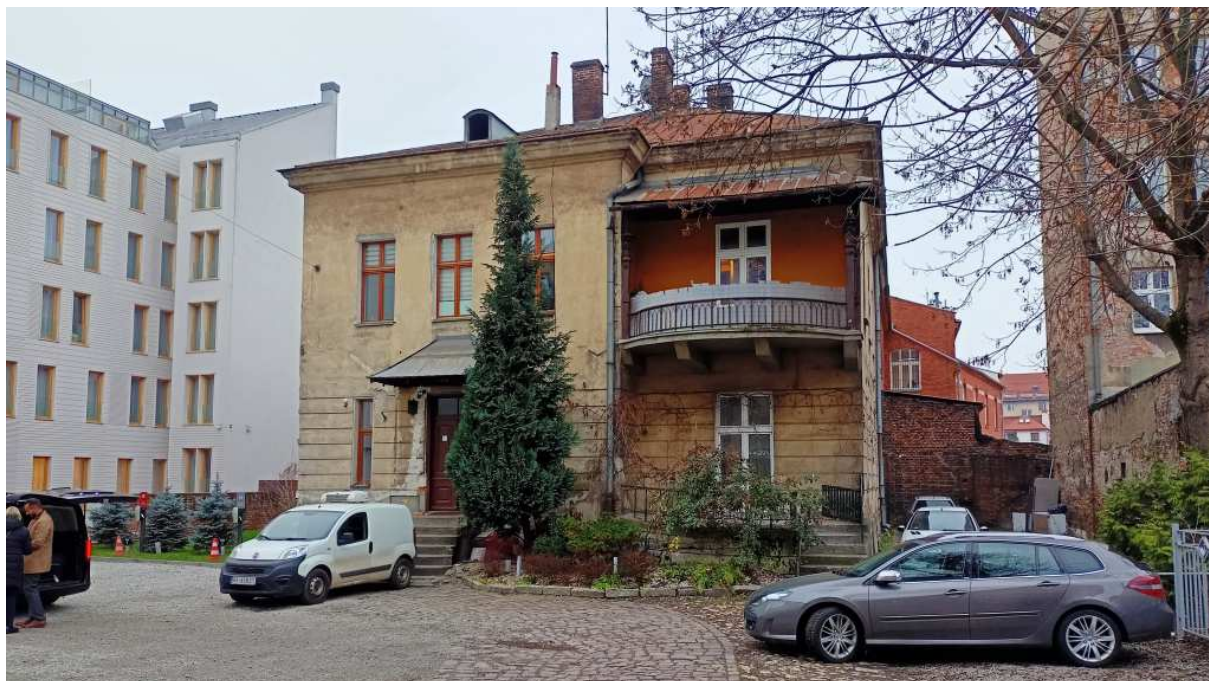
Fot. nr 179 (179-180). Willa Stryjeńskich (Pod Stańczykiem) przy ulicy Starowiślnej 89, która wg GEZ powstała w latach 1890-91 wg projektu Jana Zawiejskiego. Budynek przylega do dawnej fabryki artystyczno-stolarskiej Joachima Steinberga, usytuowanej przy ulicy Dajwór. (01.12.2022)
